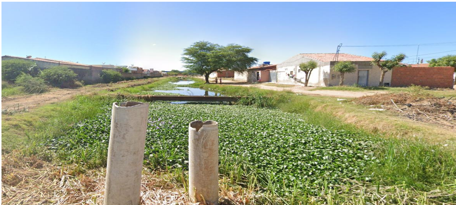
Figura 23. Zona de Risco (Rua Nove – Jardim Flórida)
