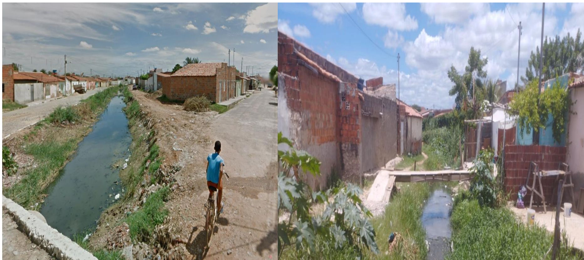
Figura 33. Zona de Risco (Rua Onze – Alto do Cruzeiro)
