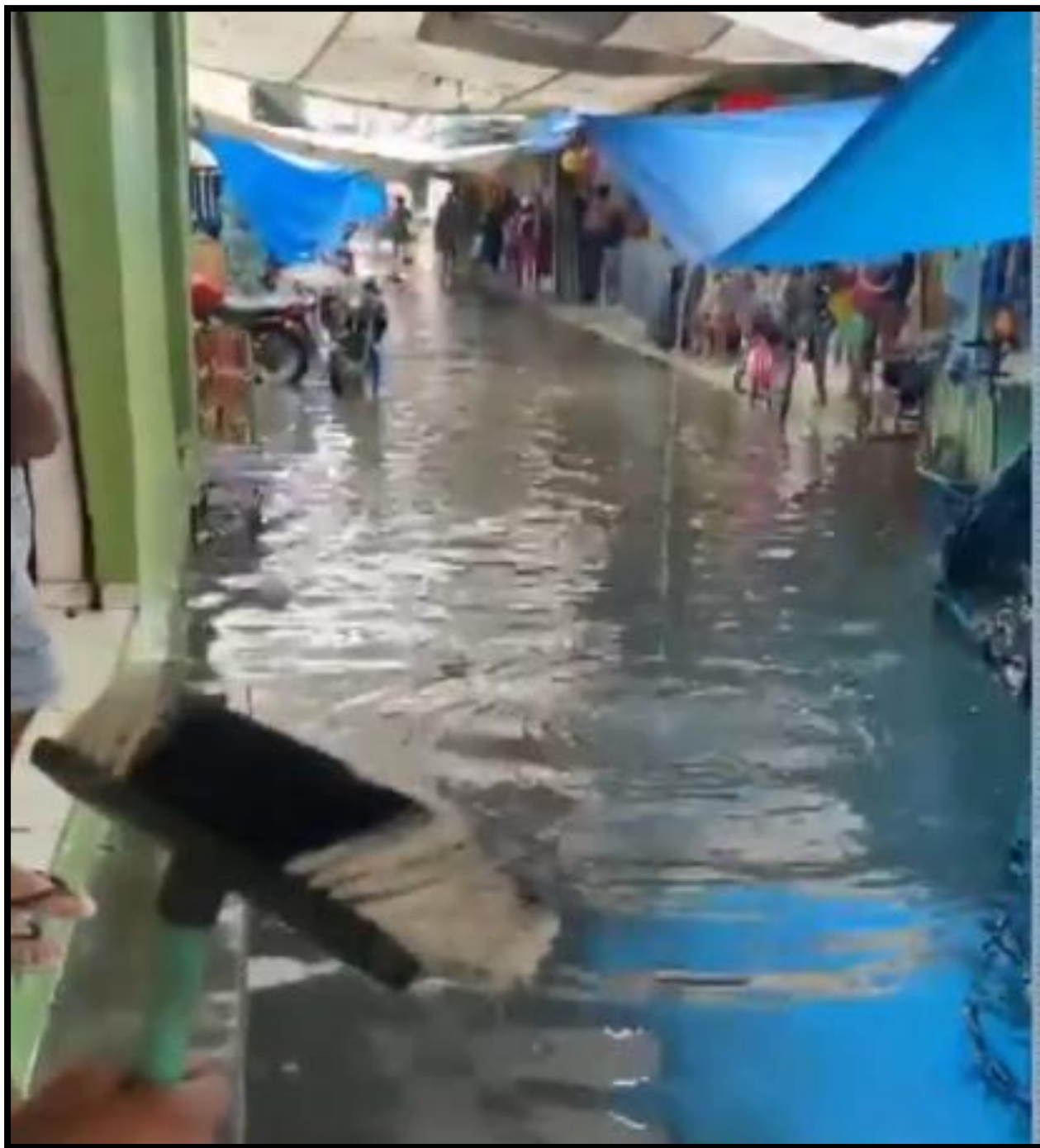
Figura 12. Inundação no Centro Comercial
