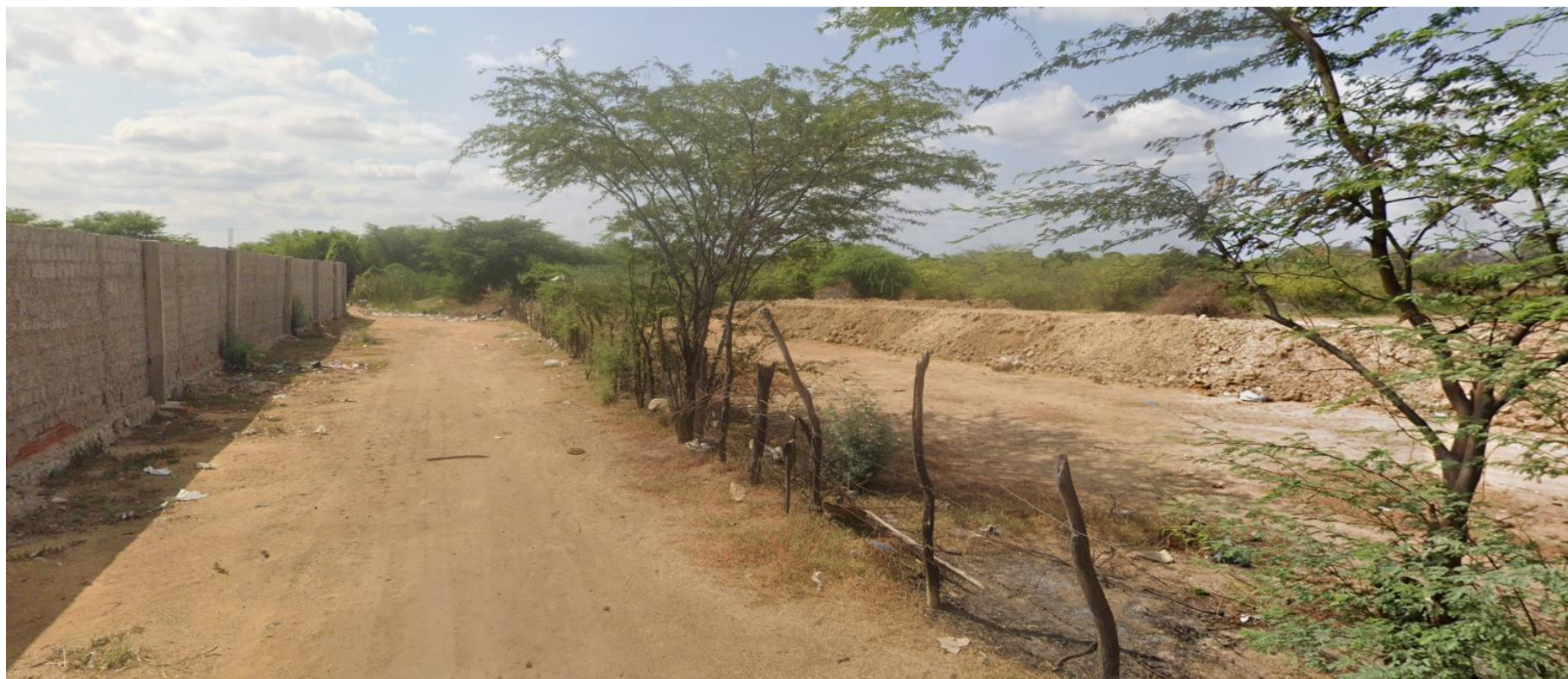
Figura 5. Canal próximo à Rua Marquês – Tabuleiro
