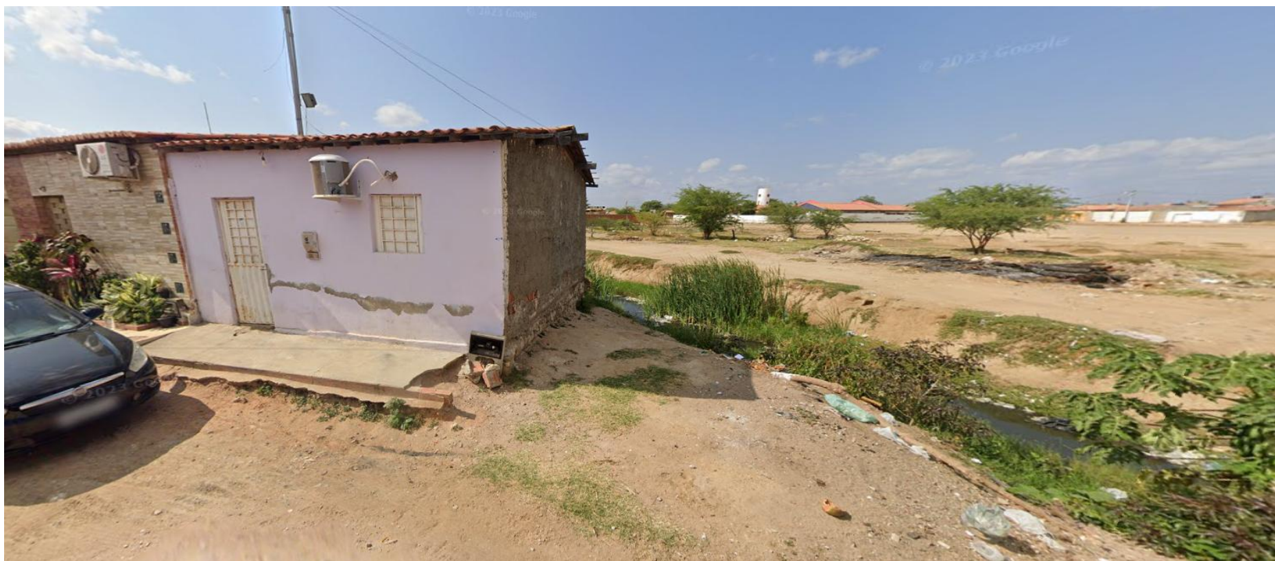
Figura 6. Zona de Risco (Rua Nova Iguaçu – Itaberaba)
