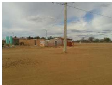
Figura 8 – Vias dos distritos sem pavimentação
