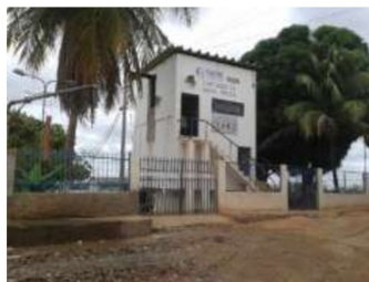
Figura 27 – Estação elevatória de água bruta do SAA da sede
