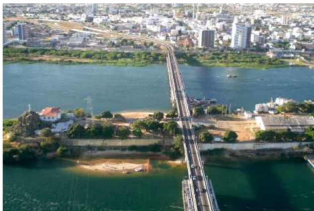
Figura 23 – Ponte Presidente Eurico Gaspar Dutra sobre a Ilha do Fogo ligando Juazeiro/BA e Petrolina/PE
