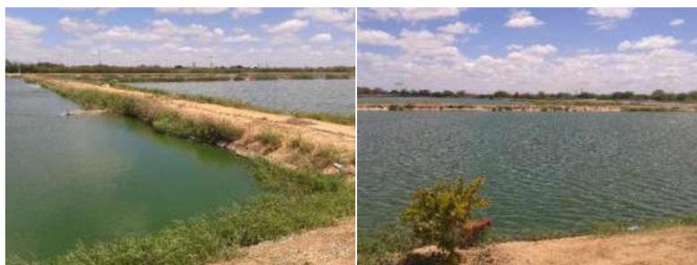
Figura 38 – Lagoas de estabilização da ETE São Geraldo
