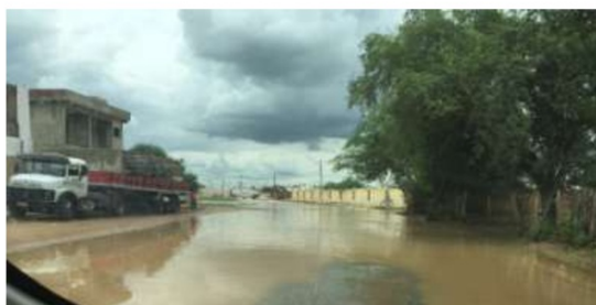
Figura 58 – Ponto de Alagamento na Av. Pedra do Lorde, Juazeiro-BA.
