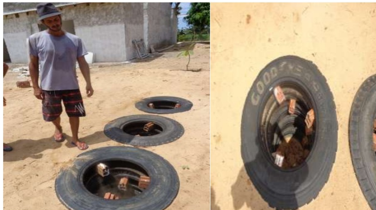
Figura 22 – Fossas utilizando pneus
