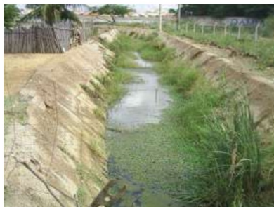
Figura 52 – Canalização do Riacho Macarrão
