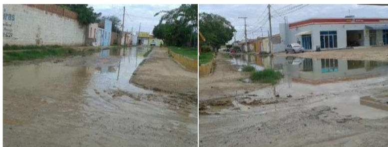
Figura 51 – Ruas alagadas no bairro da Piranga
