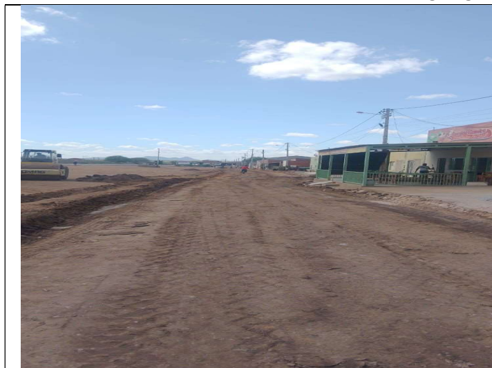
CONSTRUÇÃO DE BASE E SUB-BASE PARA PAVIMENTAÇÃO DE SOLO ESTABILIZADO GRANULOMETRICAMENTE
