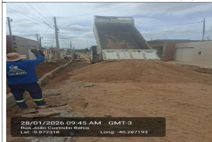
CONSTRUÇÃO DE BASE E SUB-BASE PARA PAVIMENTAÇÃO DE SOLO ESTABILIZADO GRANULOMETRICAMENTE
