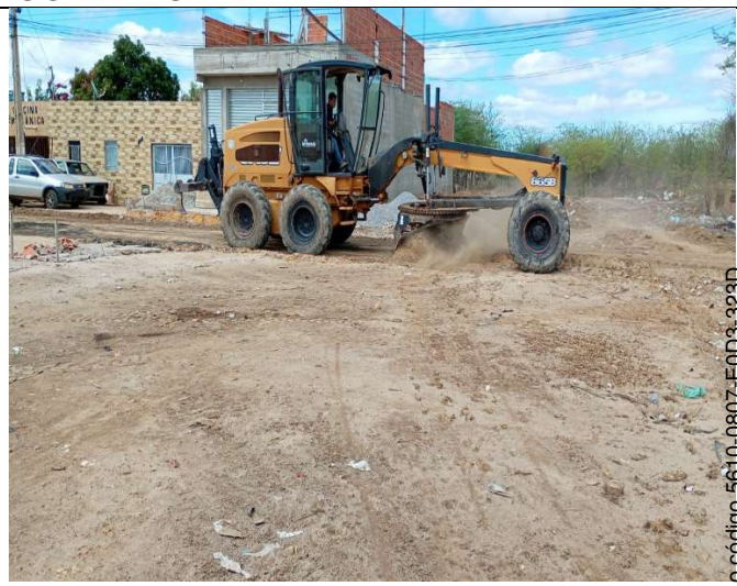
CONSTRUÇÃO DE BASE E SUB-BASE PARA PAVIMENTAÇÃO DE SOLO ESTABILIZADO GRANULOMETRICAMENTE
