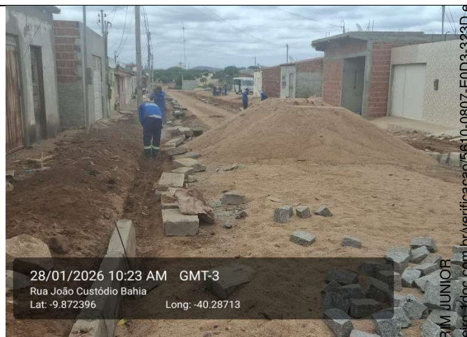
CONSTRUÇÃO DE BASE E SUB-BASE PARA PAVIMENTAÇÃO DE SOLO ESTABILIZADO GRANULOMETRICAMENTE
