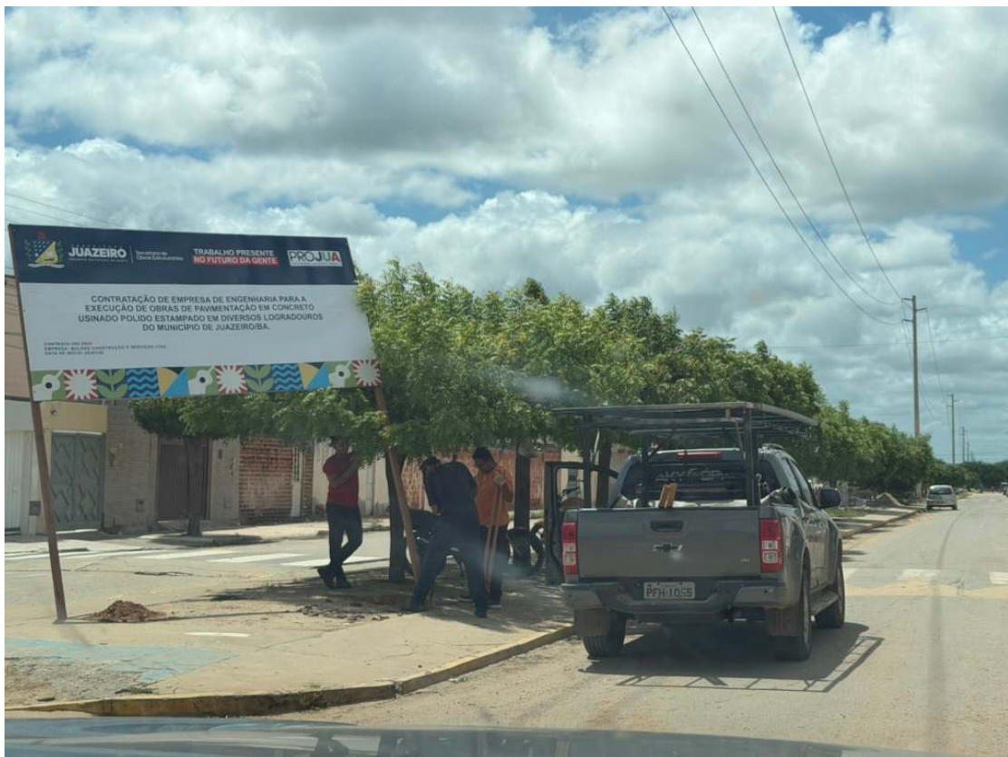
Foto 82: Instalação de placa de obra.
