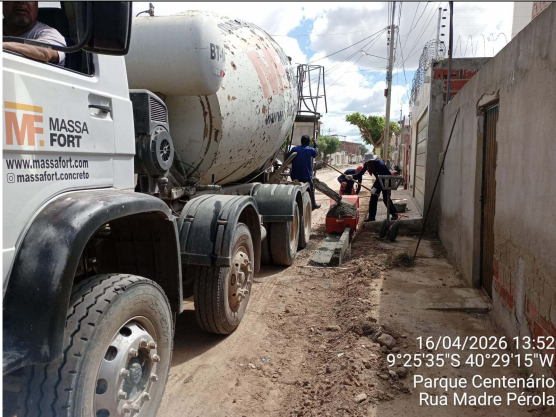
Foto 63: Execução de meio fio extrusado na Rua Madre Pérola.
