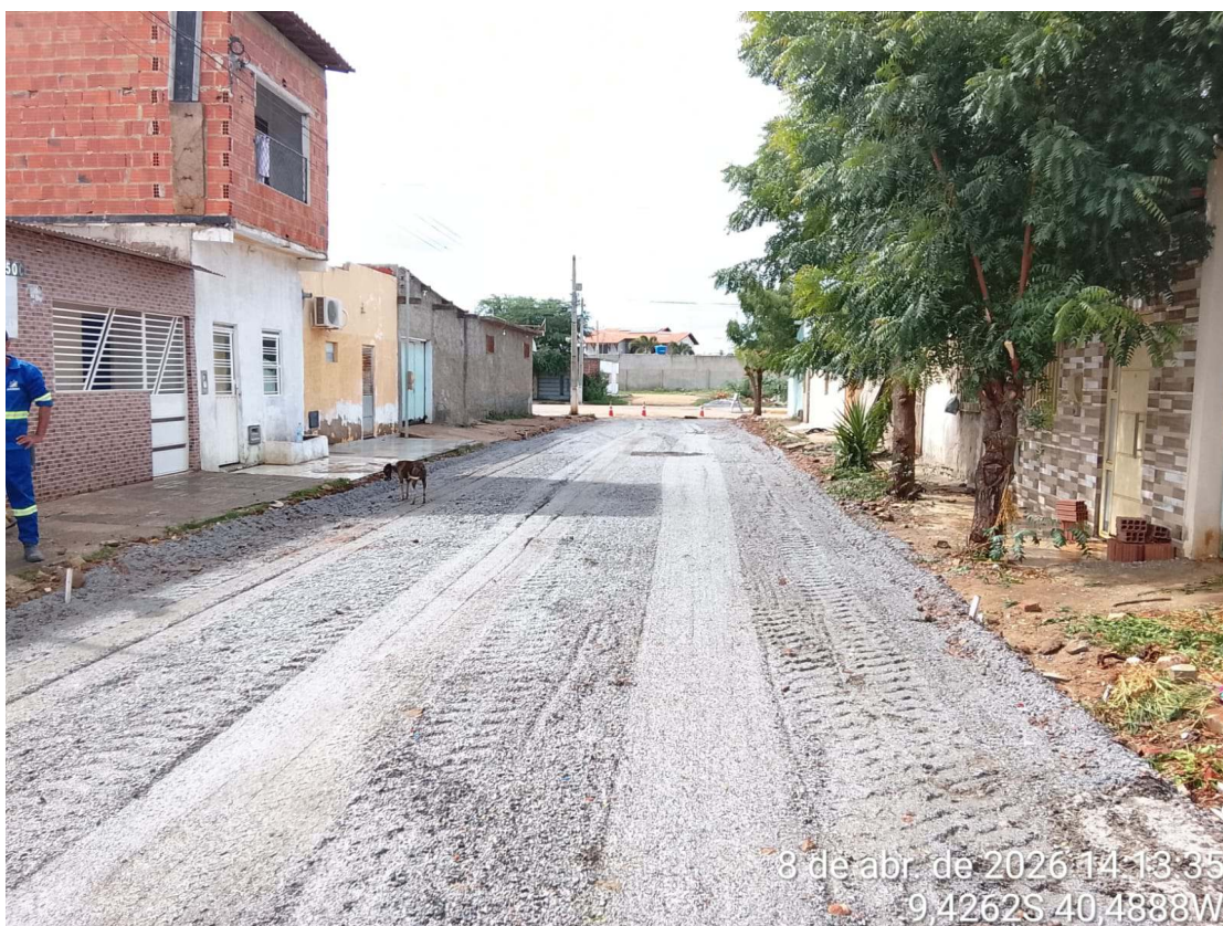
Foto 36: Execução de base em solo brita na Rua Projetada 3.
