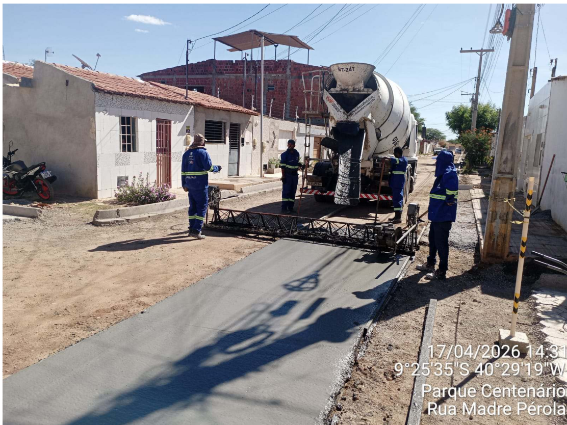
Foto 78: Execução de piso sextavado moldado in loco na Rua Madre Pérola.
