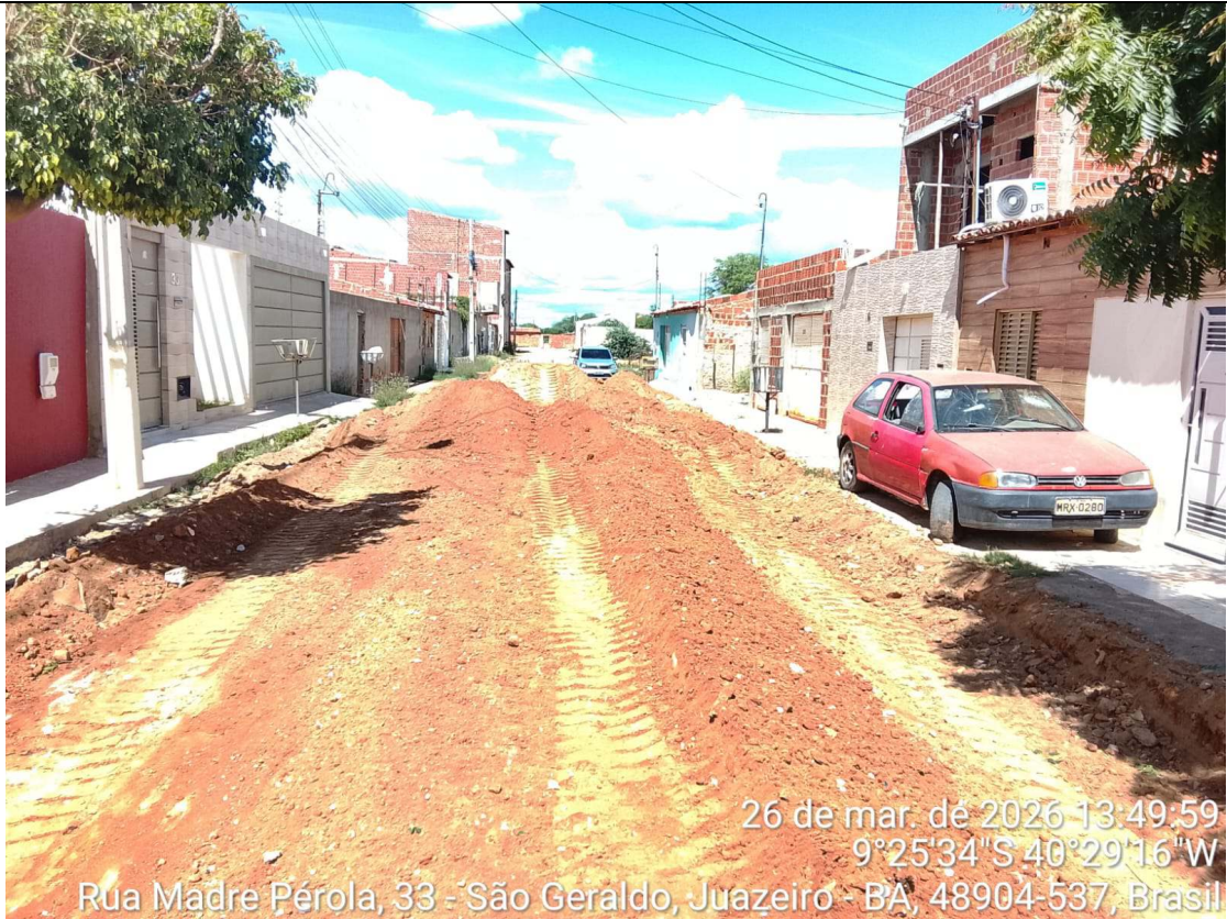
Foto 19: Escavação horizontal de solo na Rua Madre Pérola.
