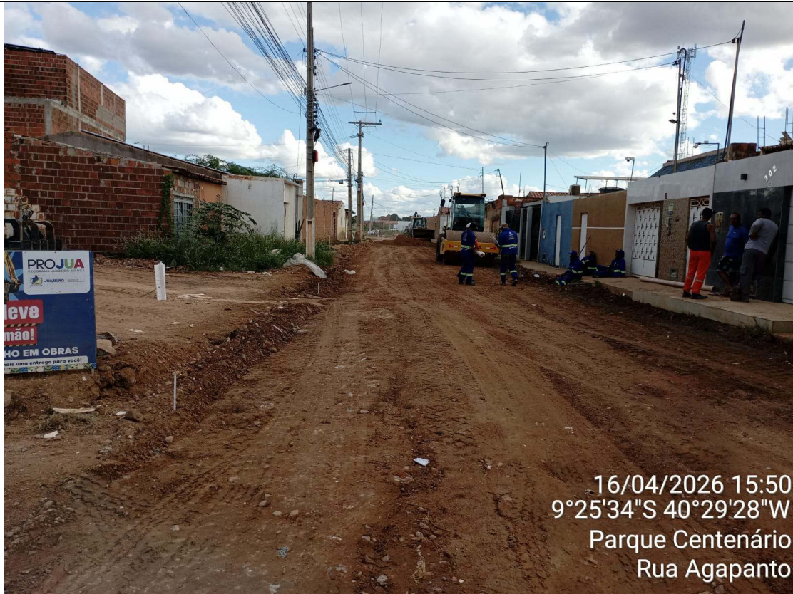
Foto 67: Execução de meio fio extrusado na Rua Agapanto.
