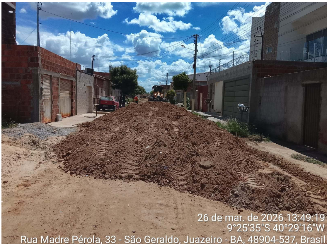
Foto 20: Escavação horizontal de solo na Rua Madre Pérola.
