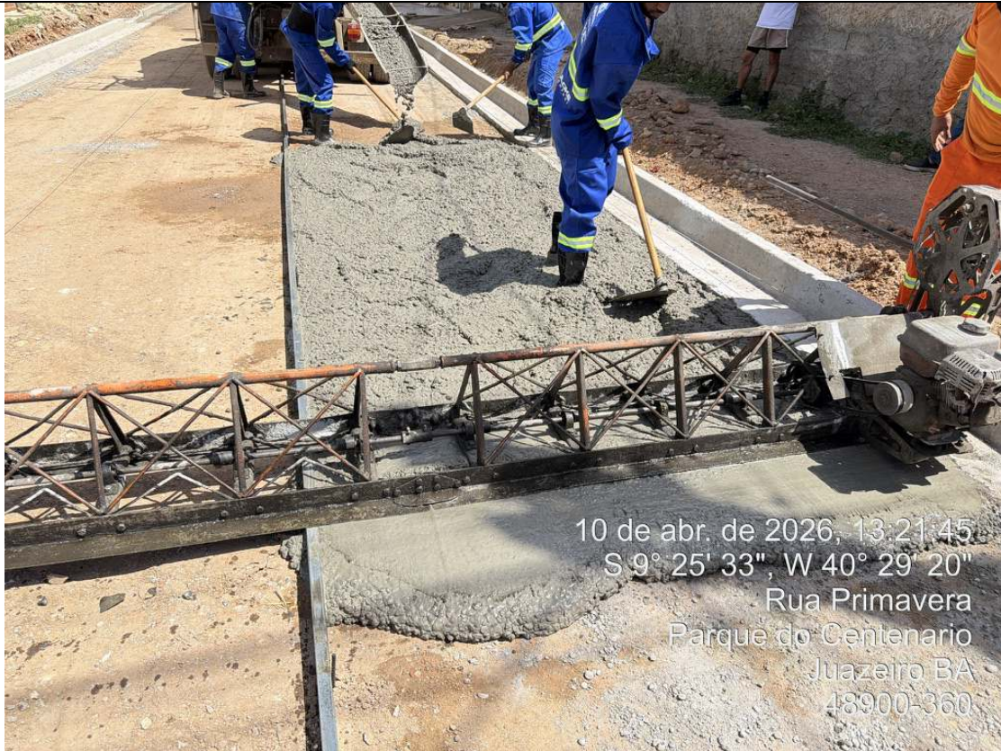
Foto 57: Execução de piso sextavado moldado in loco.
