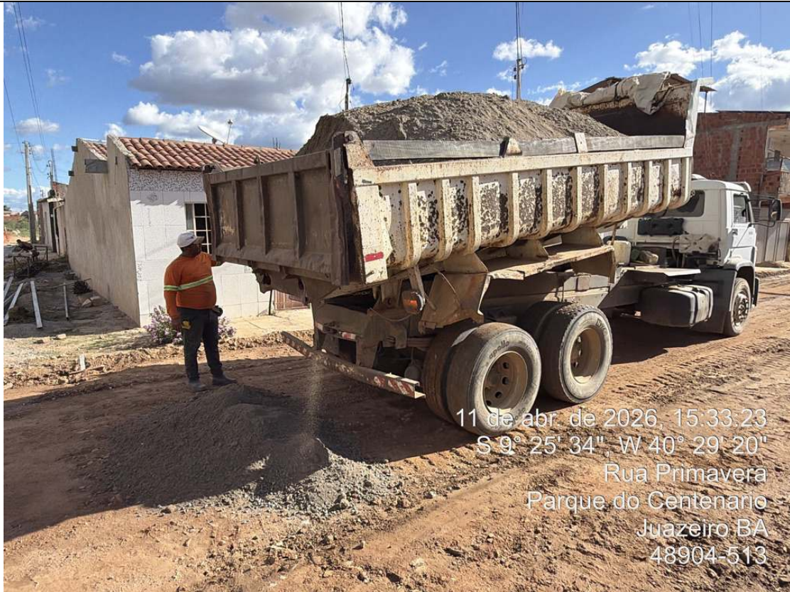
Foto 55: Execução de base na Rua Madre Pérola.
