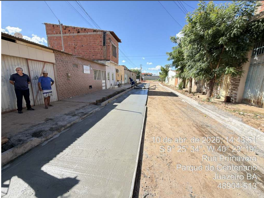
Foto 51: Execução piso em concreto sextavado moldado in loco.
