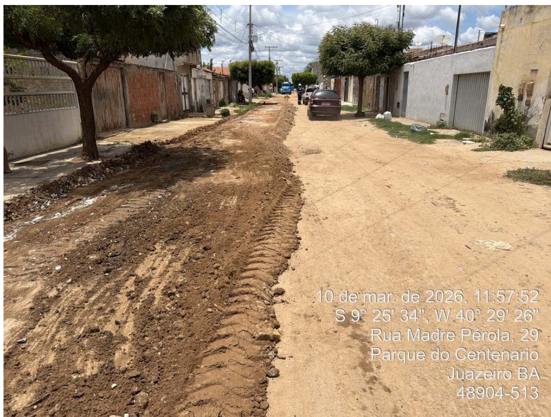
Foto 6: Execução de escavação horizontal na Rua Madre.
