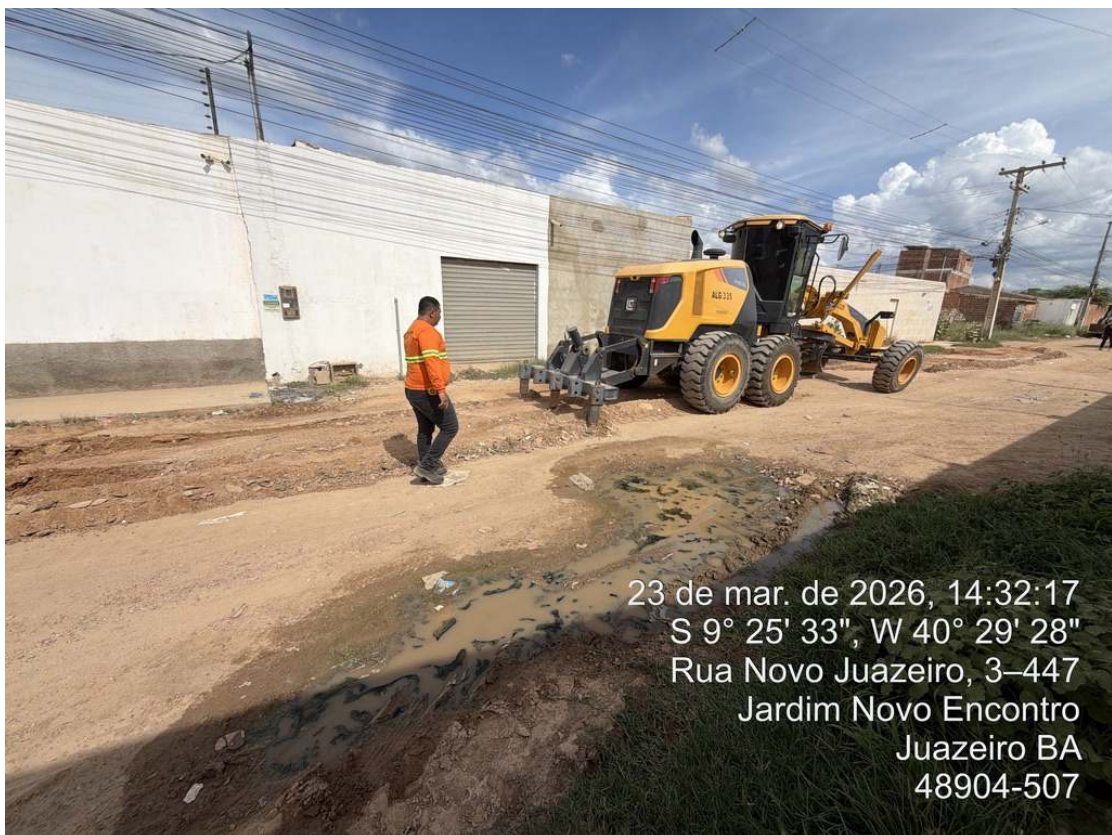
Foto 8: Execução de escavação horizontal na Rua Agapanto
