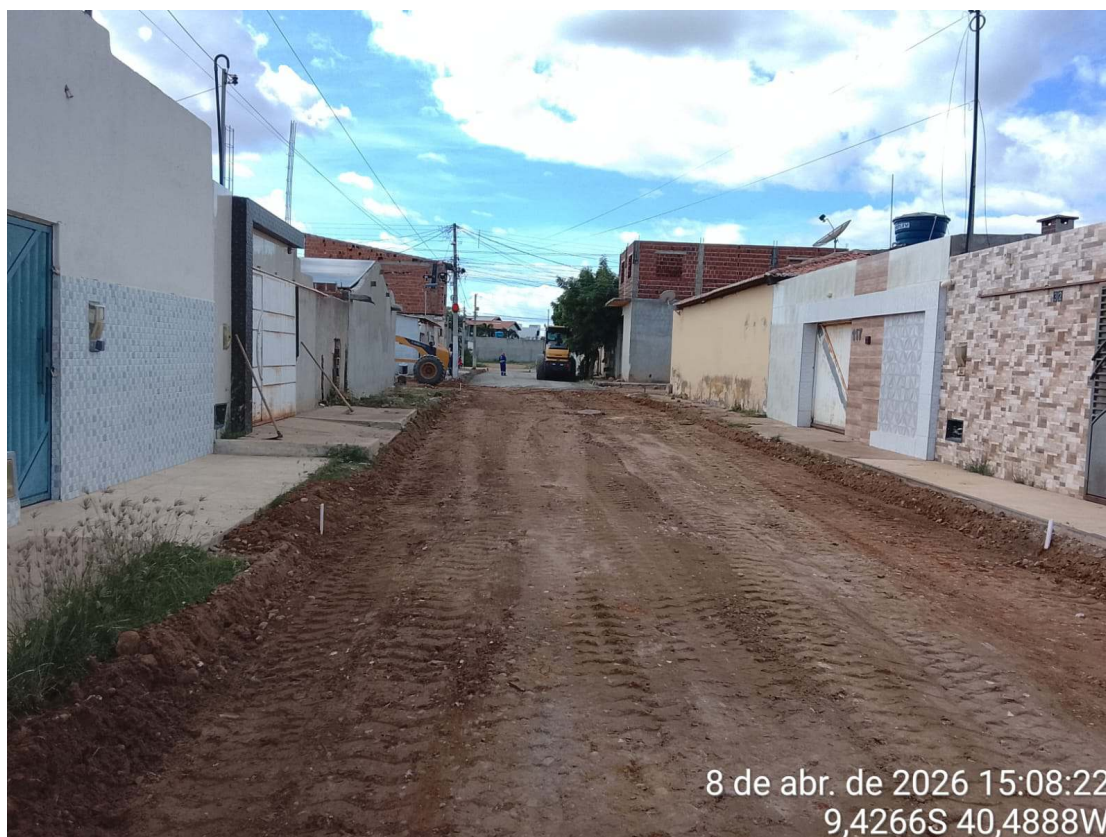
Foto 34: Execução de base em solo brita na Rua Projetada 3.
