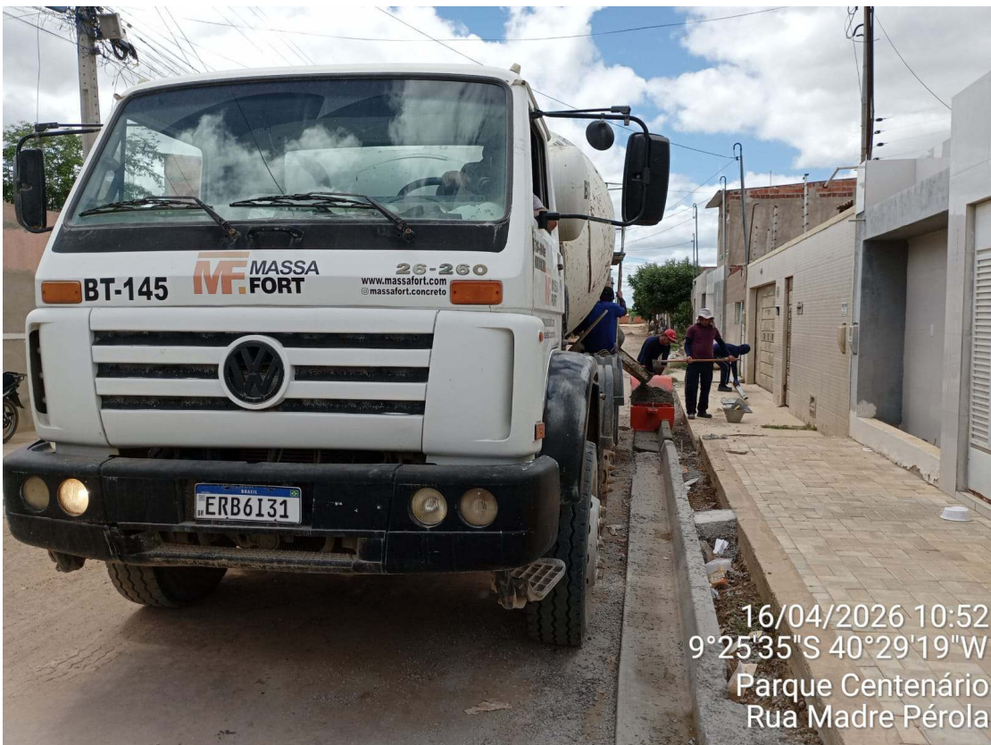
Foto 66: Execução de meio fio extrusado na Rua Madre Pérola
