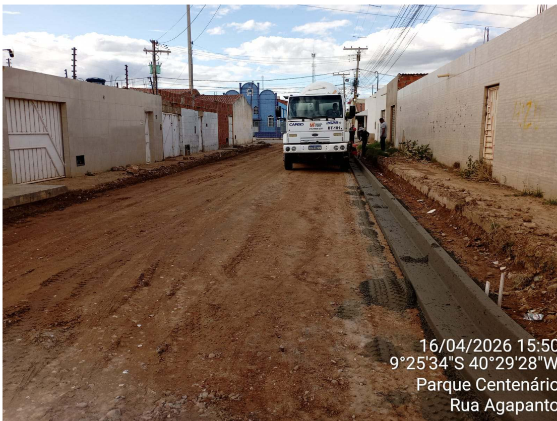
Foto 70: Execução de meio fio extrusado na Rua Agapanto.
