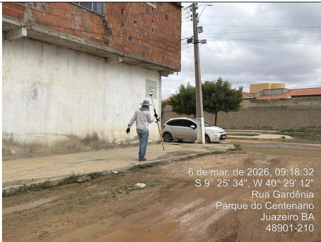
Foto 3: Levantamento planialtimétrico na Rua I.
