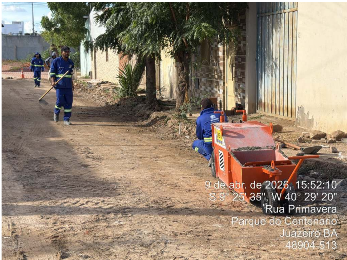
Foto 60: Execução de meio fio extrusado na Rua Projetada 3.
