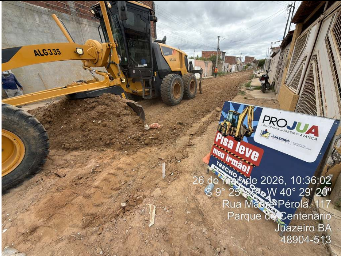
Foto 15: Execução de escavação horizontal na Rua Madre Pérola.
