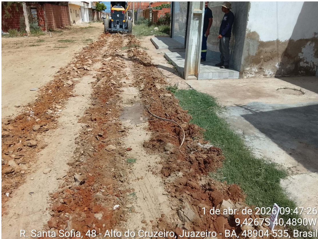
Foto 28: Escavação horizontal de solo na Rua Madre Pérola.
