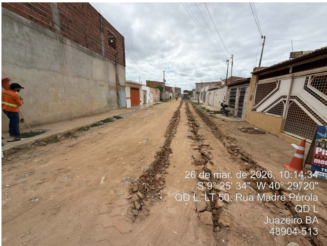
Foto 12: Execução de escavação horizontal na Rua Madre Pérola.
