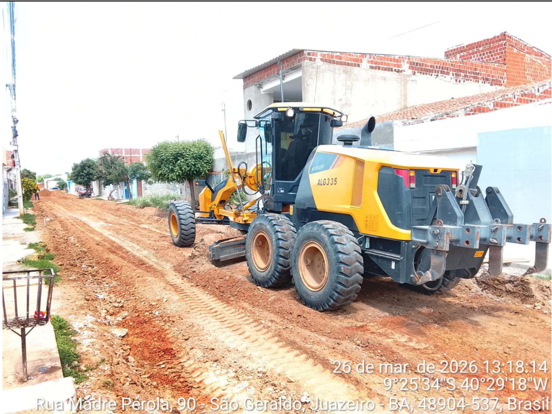
Foto 21: Escavação horizontal de solo na Rua Madre Pérola.
