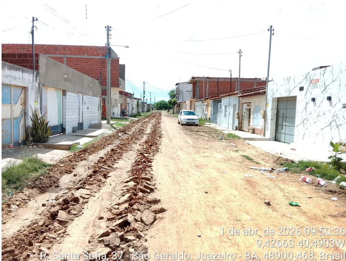
Foto 26: Escavação horizontal de solo na Rua Santa Sofia.
