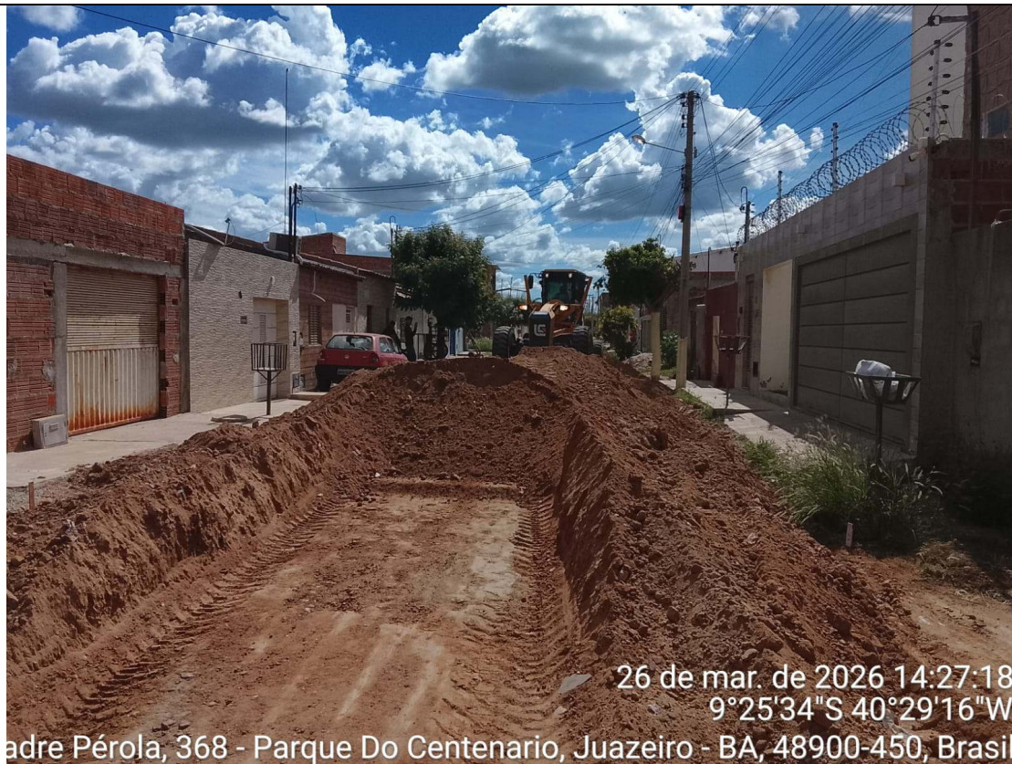
Foto 17: Escavação horizontal de solo na Rua Madre Pérola.
