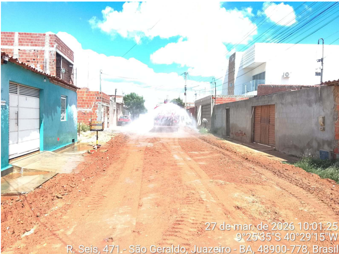
Foto 24: Umidificação de base na Rua Madre Pérola.
