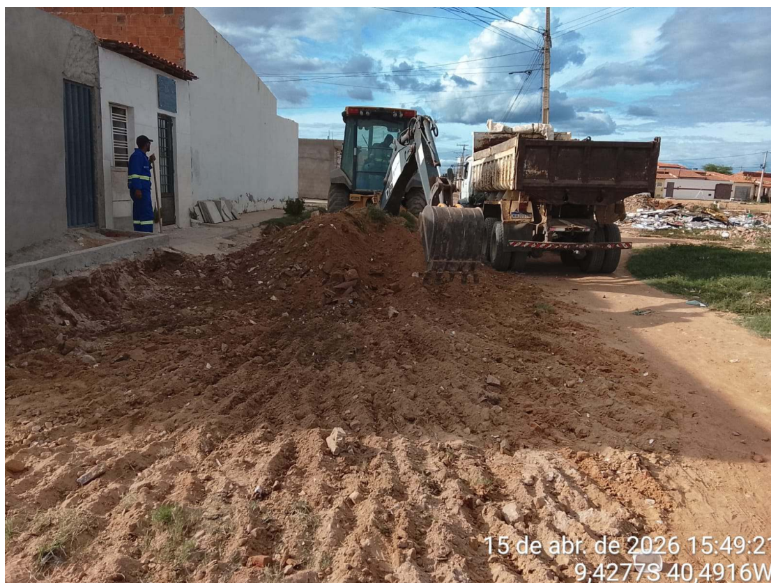
Foto 40: Escavação na Rua Agapanto.
