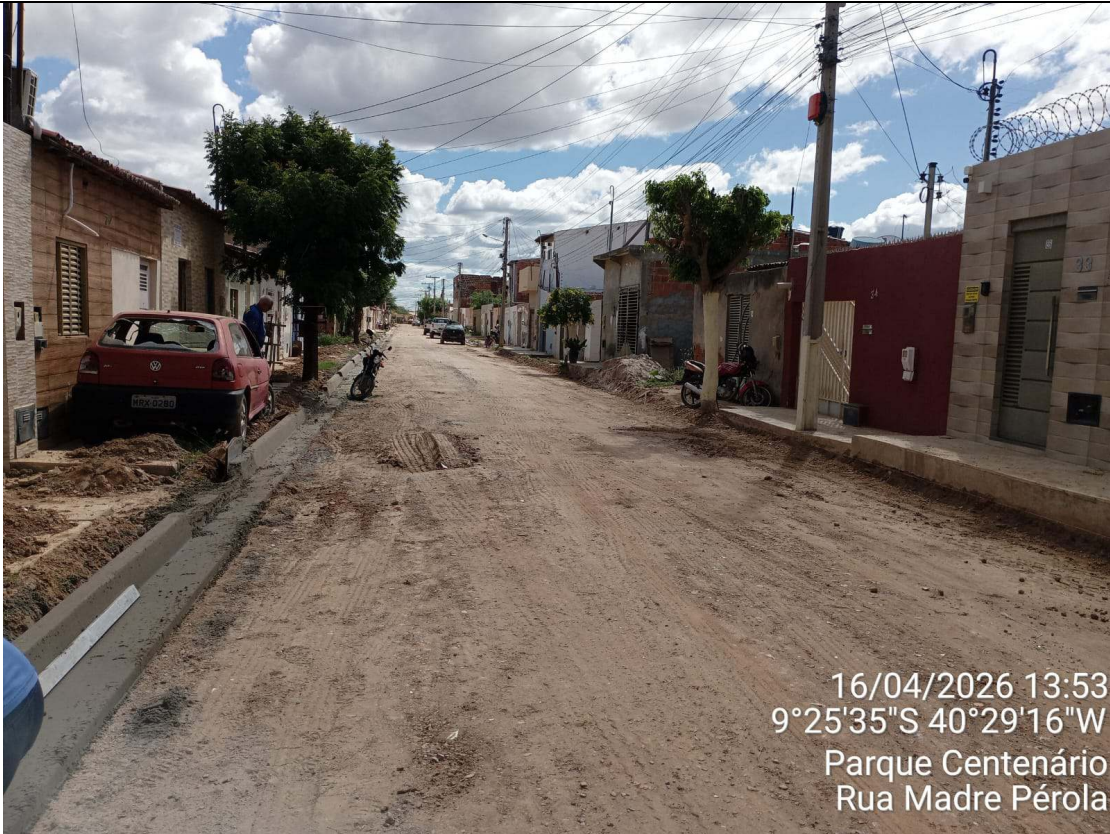
Foto 65: Execução de meio fio extrusado na Rua Madre Pérola
