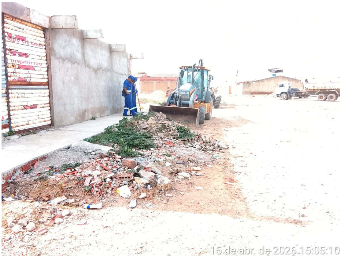
Foto 42: Escavação na Rua Agapanto.
