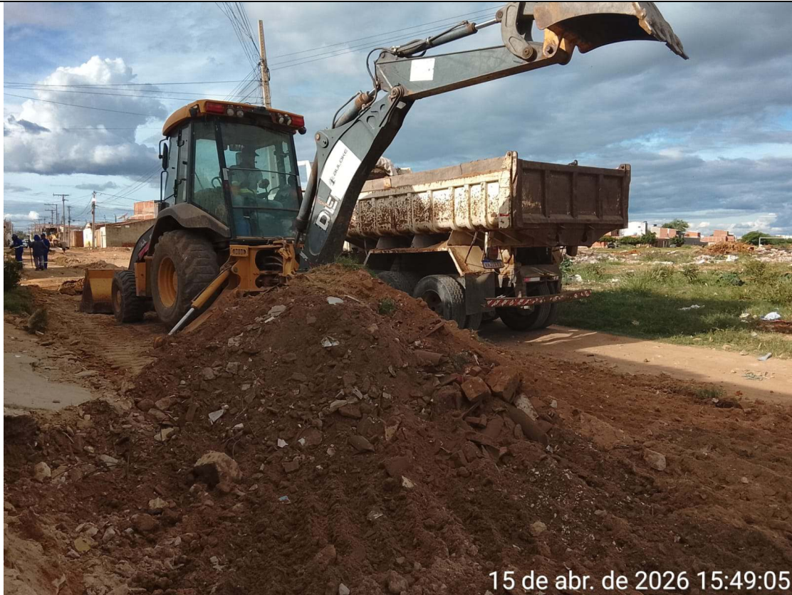
Foto 41: Escavação na Rua Agapanto.
