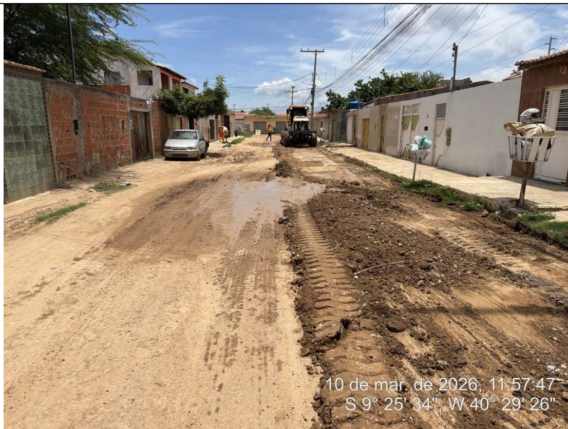
Foto 5: Execução de escavação horizontal na Rua Madre Pérola.
