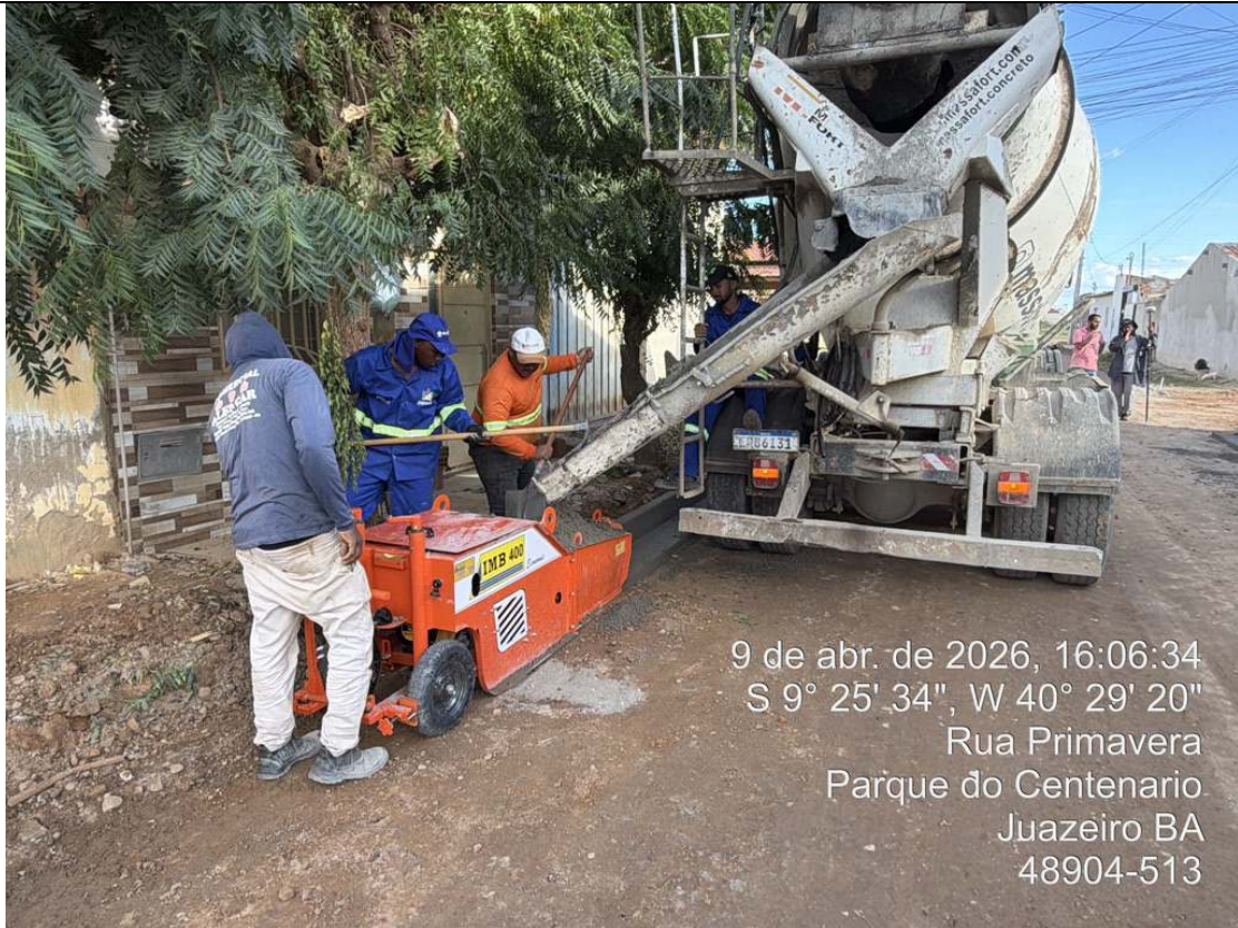
Foto 59: Execução de meio fio extrusado na Rua Projetada 3.
