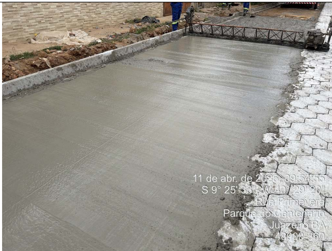
Foto 47: Execução de piso sextavado moldado in loco
