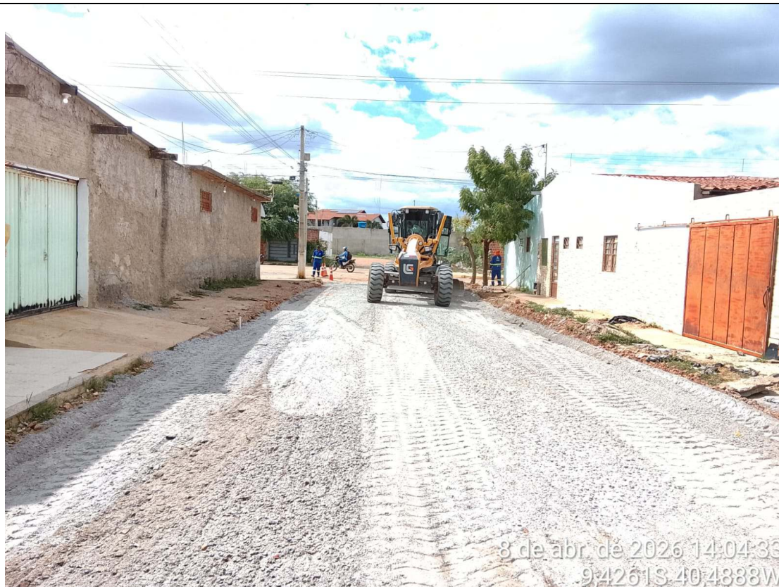
Foto 37: Execução de base em solo brita na Rua Projetada 3.
