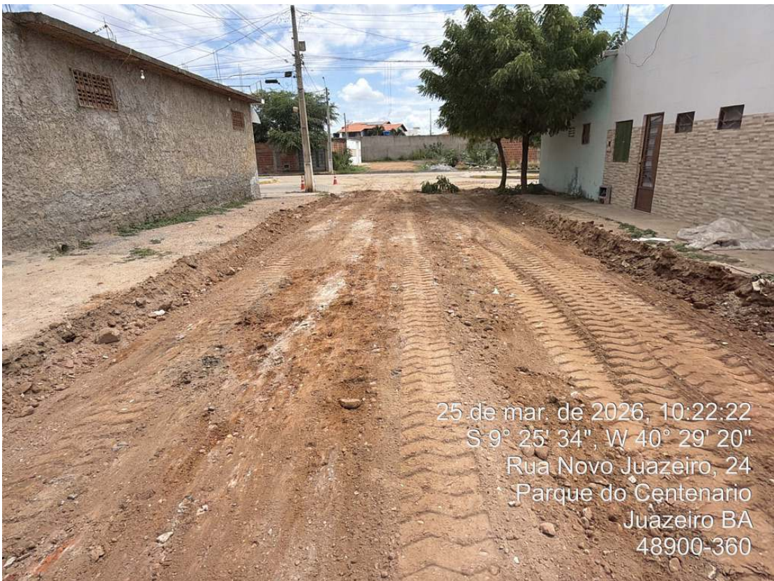
Foto 10: Execução de escavação horizontal na Rua Projetada 3.
