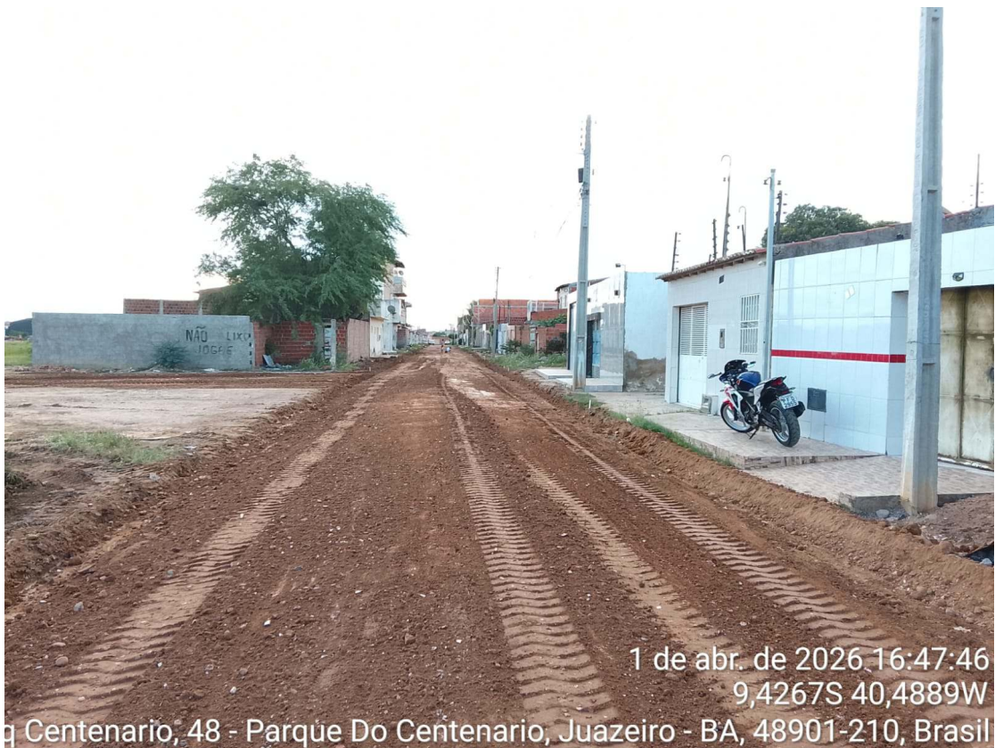
Foto 30: Escavação horizontal de solo na Rua Madre Pérola.
