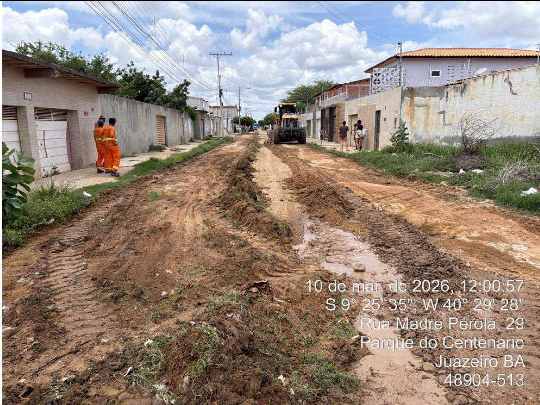
Foto 7: Execução de escavação horizontal na Rua Madre.
