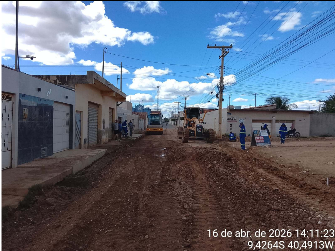
Foto 43: Escavação na Rua Agapanto.
