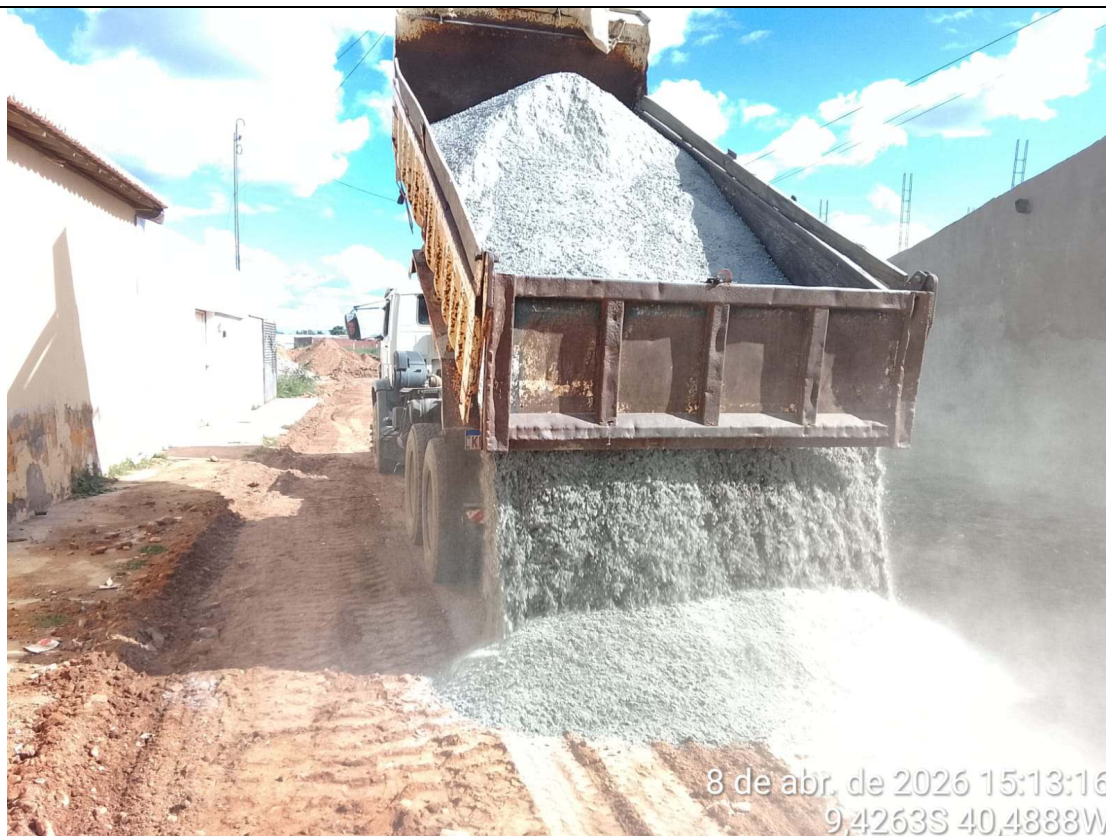
Foto 33: Execução de base em solo brita na Rua Projetada 3.
