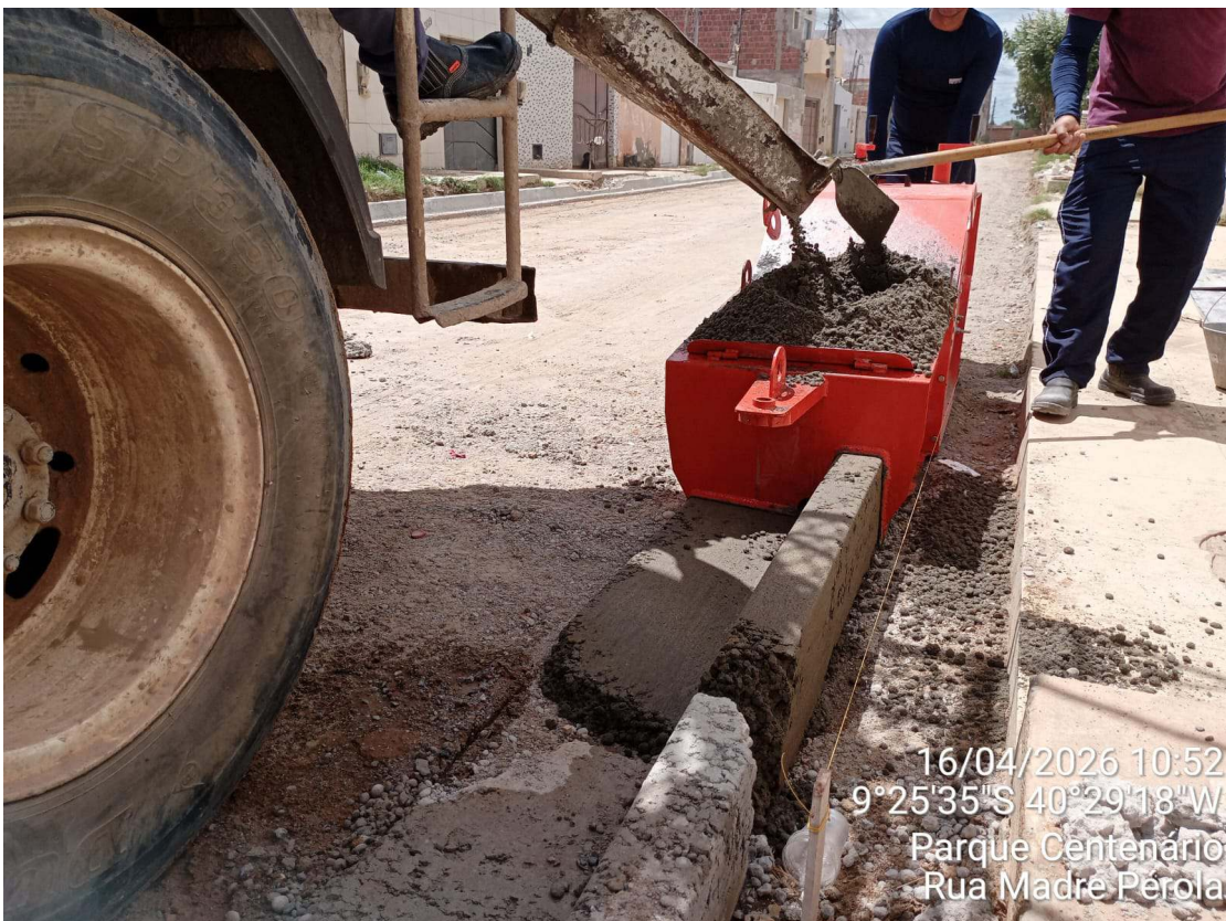
Foto 62: Execução de meio fio extrusado na Rua Projetada 3.
