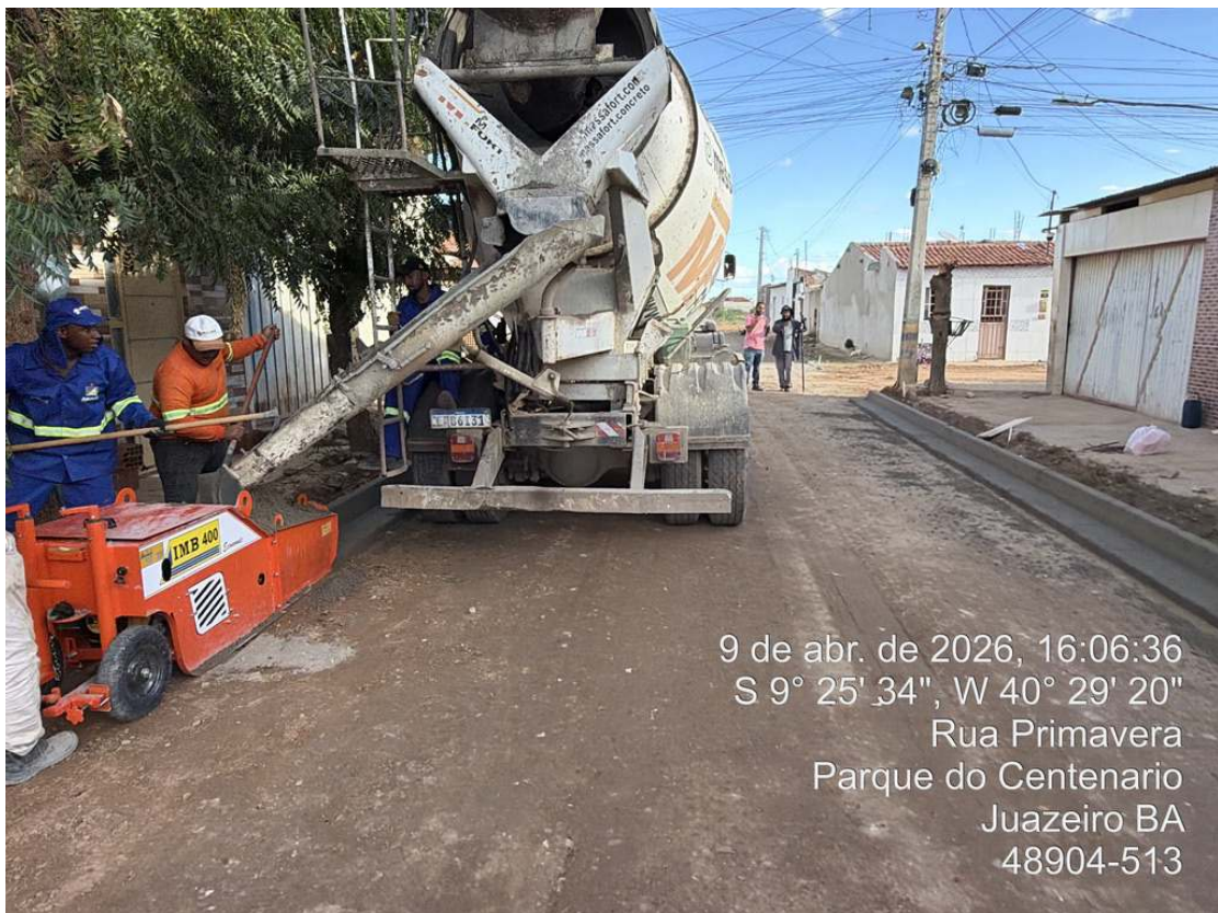
Foto 58: Execução de piso sextavado moldado in loco.
