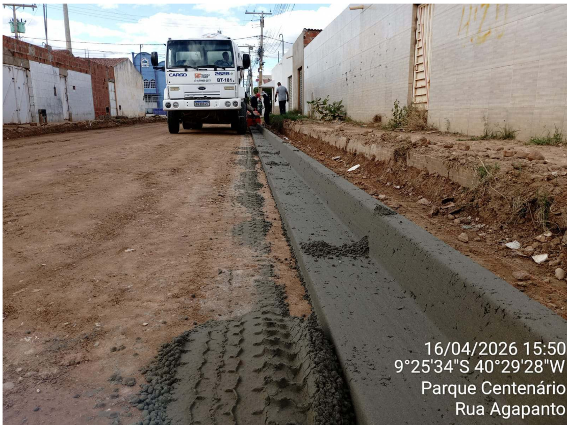
Foto 68: Execução de meio fio extrusado na Rua Agapanto.
