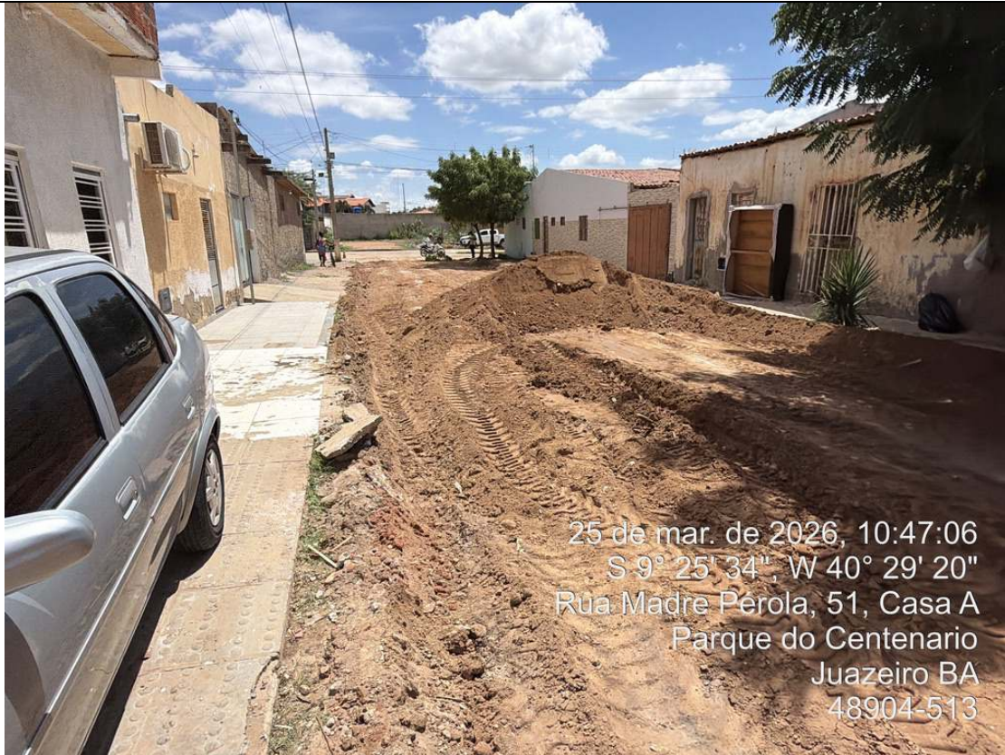
Foto 11: Execução de escavação horizontal na Rua Projetada 3.
