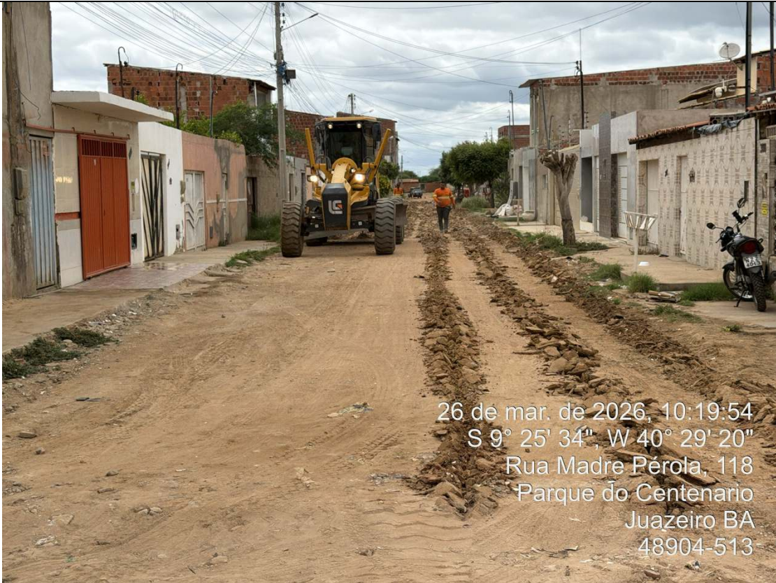
Foto 13: Execução de escavação horizontal na Rua Madre Pérola.
