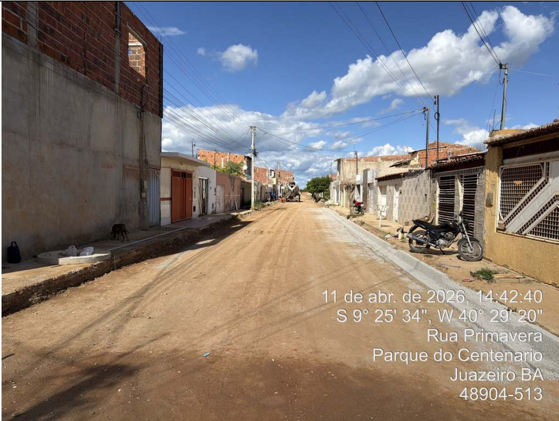
Foto 83: Instalação de placa de obra.
