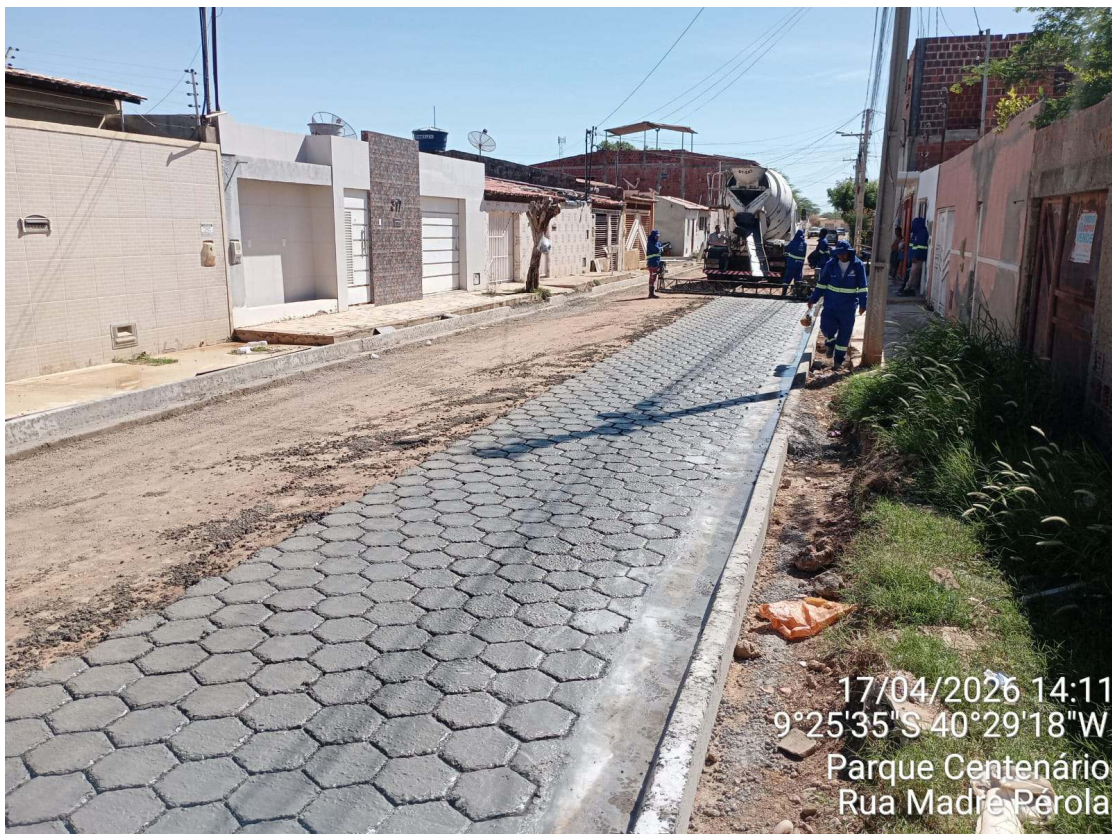
Foto 74: Execução de piso sextavado moldado in loco na Rua Madre Pérola.
