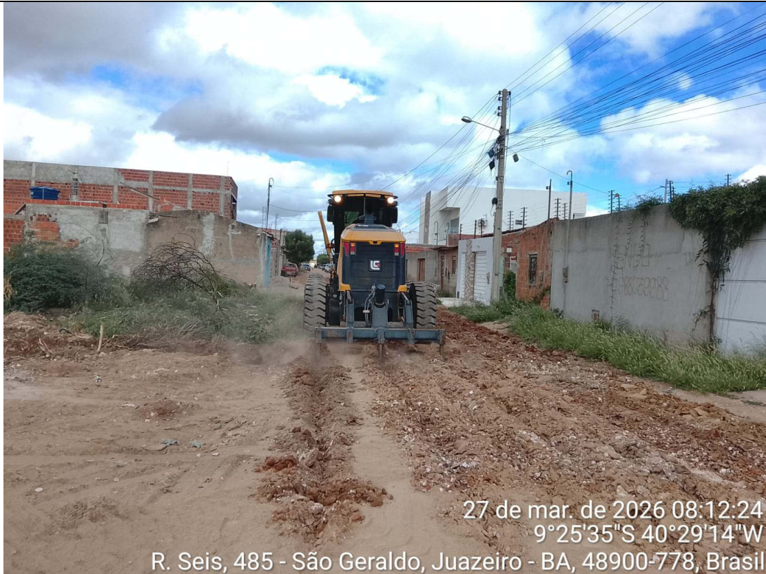
Foto 25: Escavação horizontal de solo na Rua Madre Pérola.
