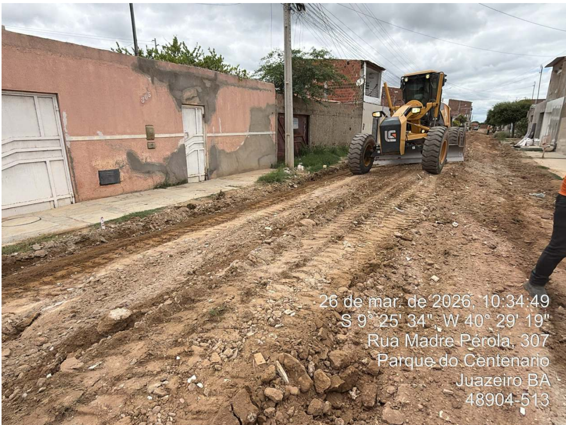
Foto 14: Execução de escavação horizontal na Rua Madre Pérola.
