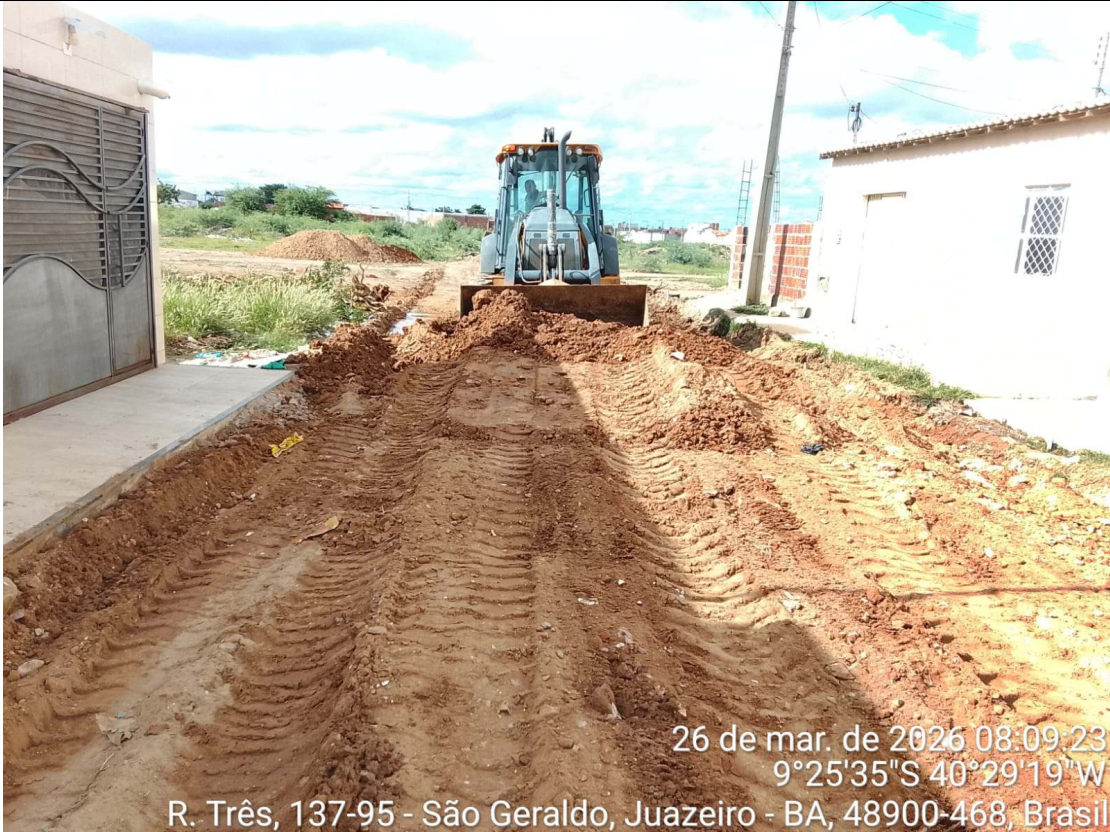
Foto 23: Escavação horizontal de solo na Rua Madre Pérola.
