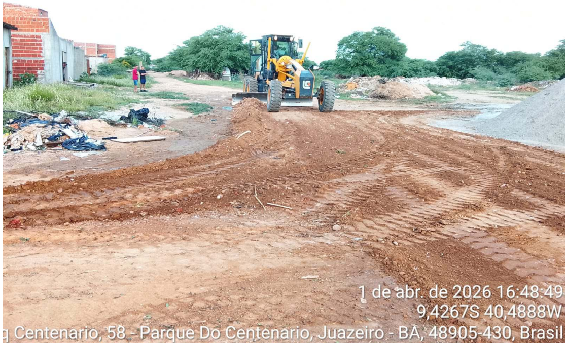
Foto 29: Escavação horizontal de solo na Rua Madre Pérola.
