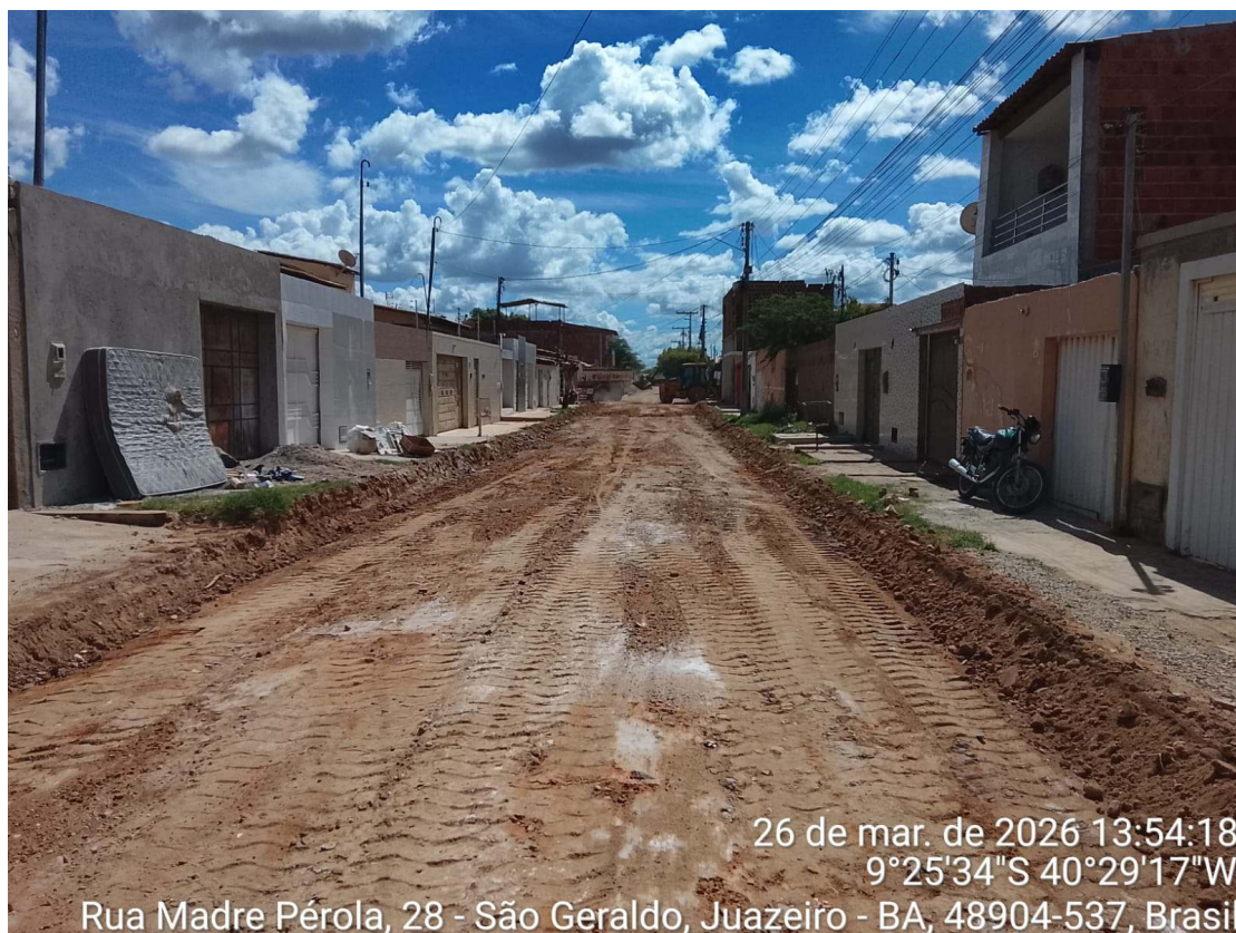
Foto 18: Escavação horizontal de solo na Rua Madre Pérola.
