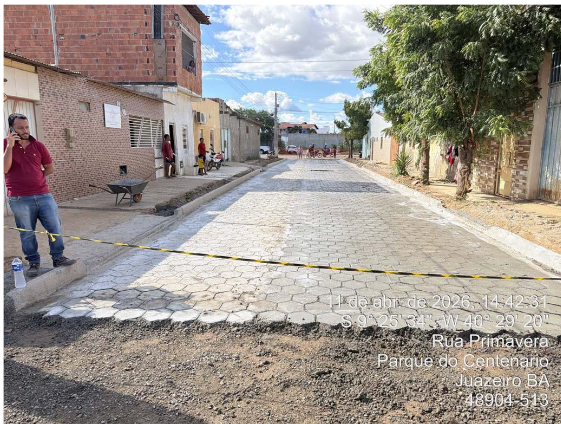
Foto 46: Execução de piso sextavado moldado in loco.
