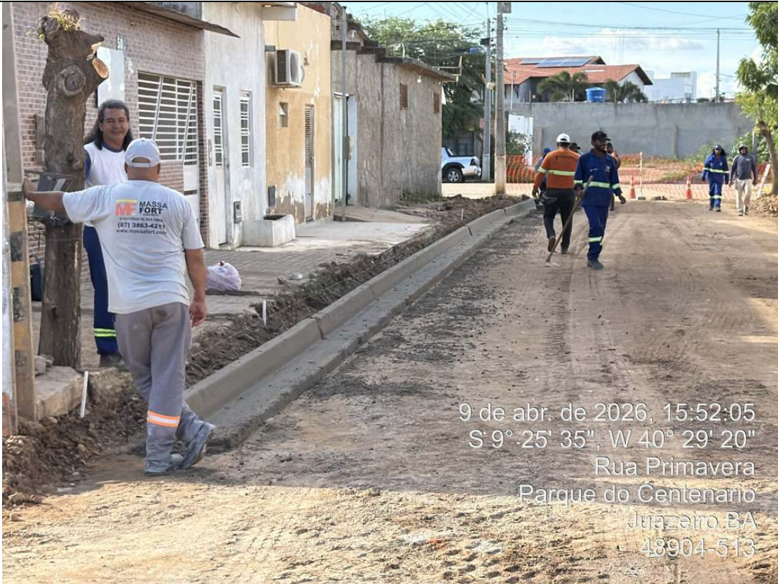
Foto 61: Execução de meio fio extrusado na Rua Projetada 3.
