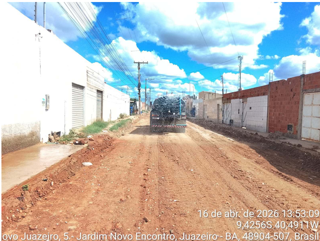
Foto 44: Umidificação de solo na Rua Agapanto.
