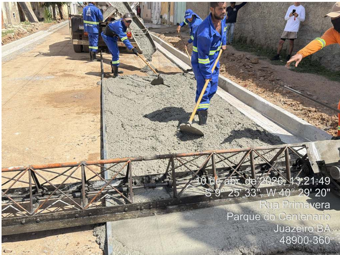
Foto 56: Execução de piso sextavado moldado in loco.
