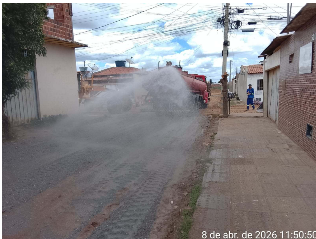
Foto 38: Umidificação de solo para compactação.
