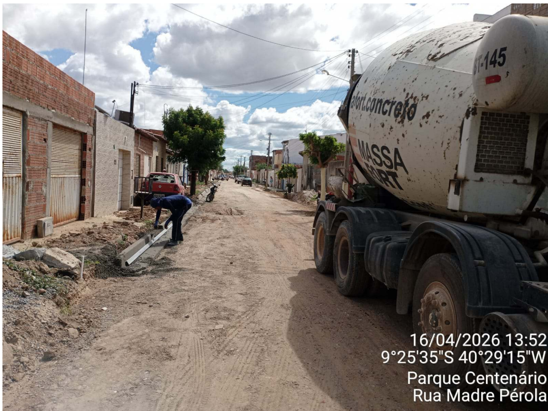
Foto 64: Execução de meio fio extrusado na Rua Madre Pérola.
