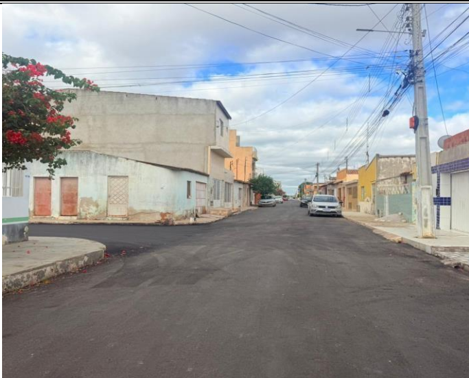
Foto 15: RUA DA LIBERDADE
