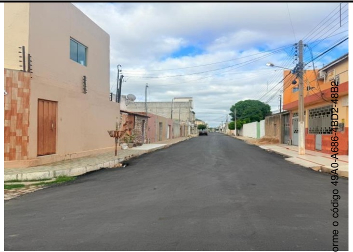
Foto 14: RUA DA LIBERDADE
