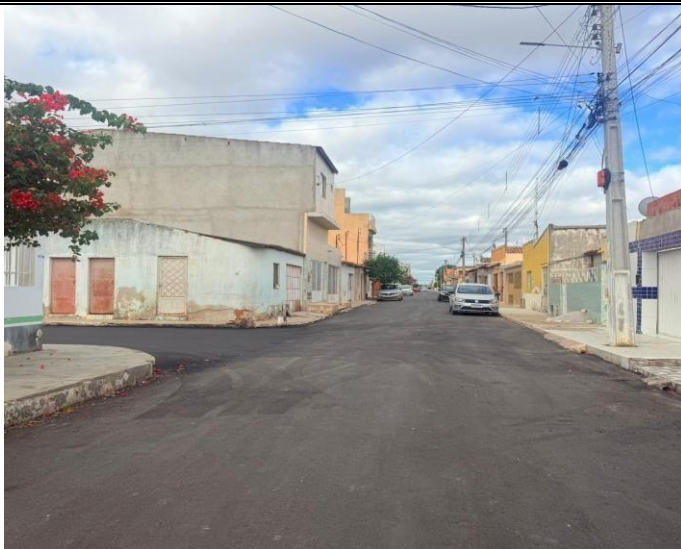
Foto 15: RUA DA LIBERDADE
