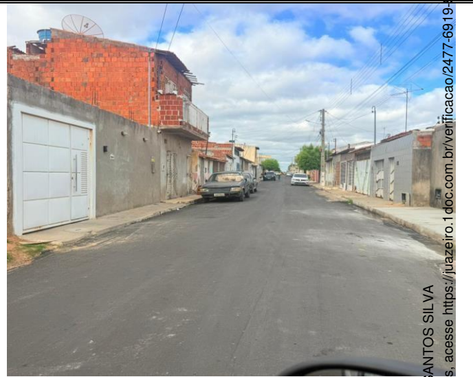
Foto 16: RUA DA LIBERDADE
