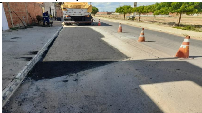
FOTO 12: Aplicação de CBUQ
