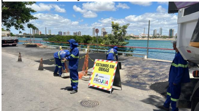
FOTO 09: Aplicação de CBUQ
