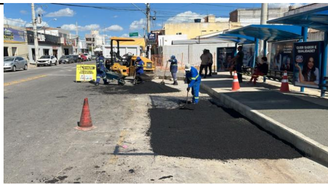
FOTO 08: Aplicação de CBUQ
