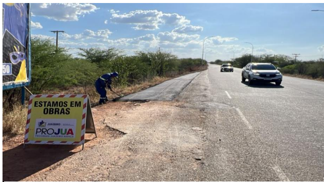
FOTO 07: Aplicação de CBUQ
