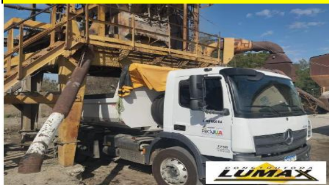
FOTO 01: Usinagem de CBUQ
