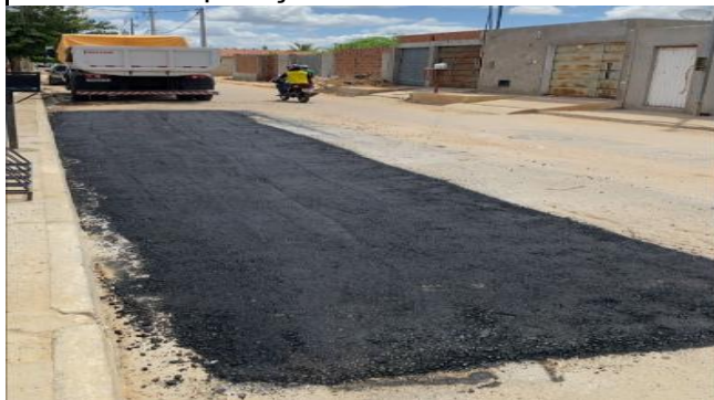
FOTO 11: Aplicação de CBUQ
