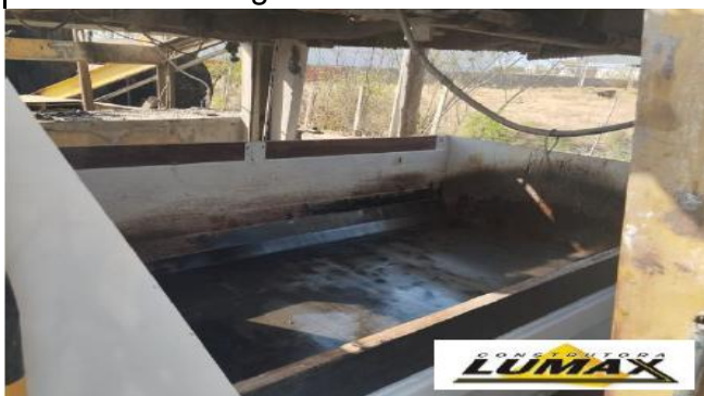
FOTO 03: Usinagem de CBUQ
