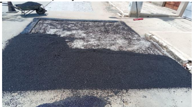
FOTO 10: Aplicação de CBUQ
