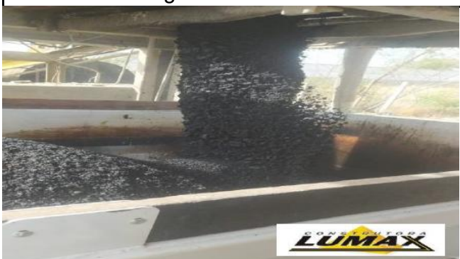
FOTO 05: Usinagem de CBUQ
