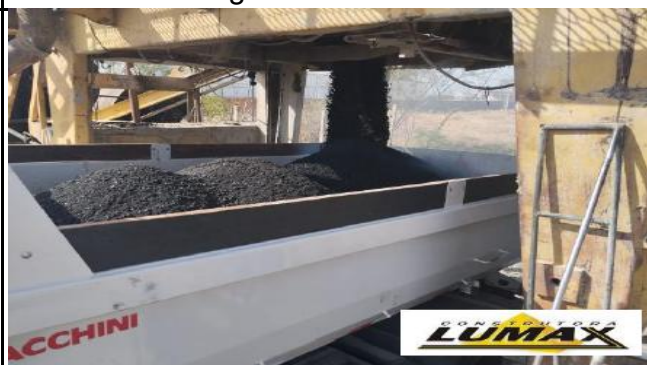
FOTO 04: Usinagem de CBUQ
