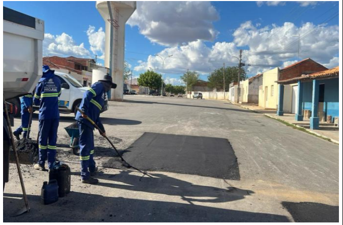
FOTO 14: Aplicação de CBUQ
