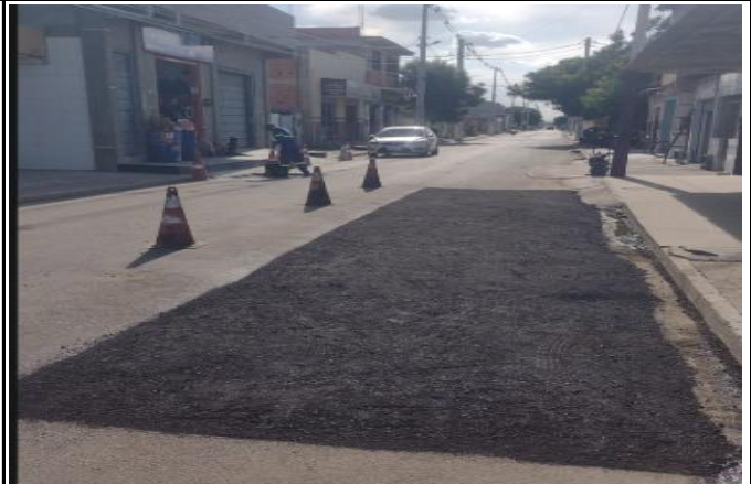
FOTO 08: Aplicação de CBUQ
