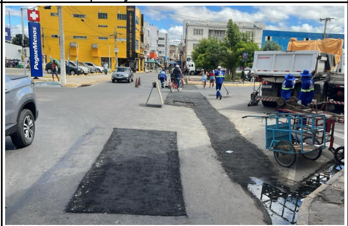
FOTO 12: Aplicação de CBUQ
