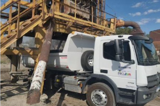
FOTO 01: Usinagem de CBUQ
