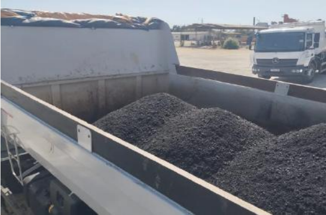
FOTO 05: Usinagem de CBUQ
