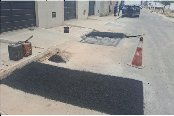
FOTO 09: Aplicação de CBUQ
