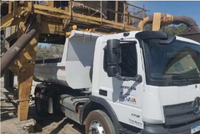
FOTO 03: Usinagem de CBUQ
