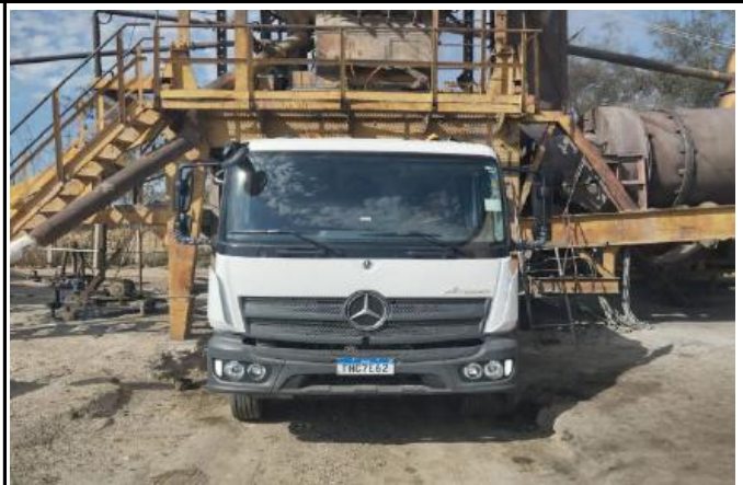
FOTO 02: Usinagem de CBUQ
