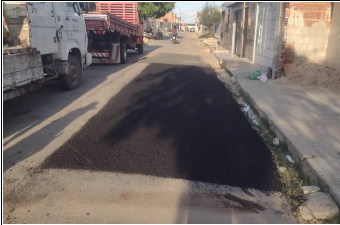
FOTO 07: Aplicação de CBUQ
