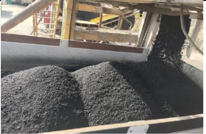
FOTO 06: Usinagem de CBUQ
