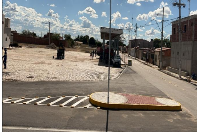
FOTO 13: Aplicação de CBUQ
