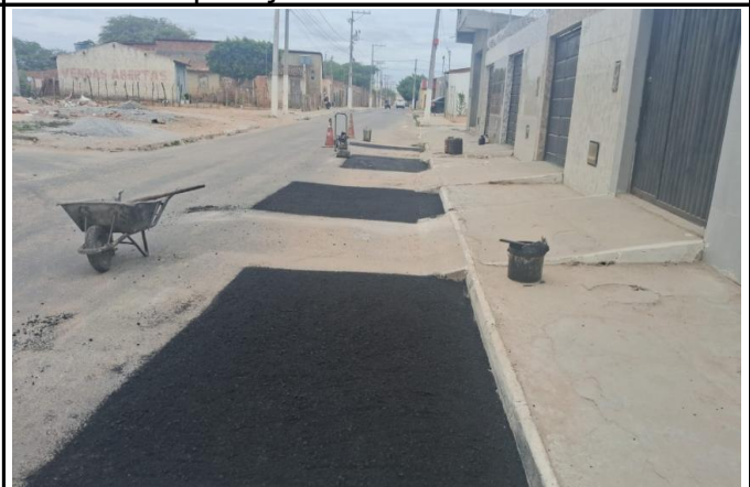
FOTO 10: Aplicação de CBUQ
