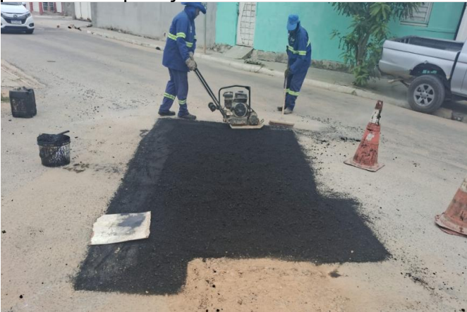
FOTO 11: Aplicação de CBUQ
