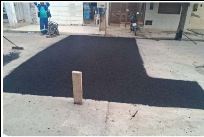
FOTO 15: Usinagem de CBUQ
