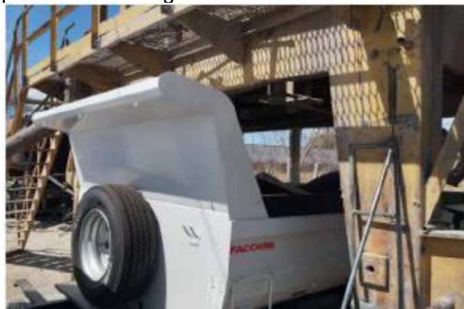
FOTO 05: Usinagem de CBUQ
