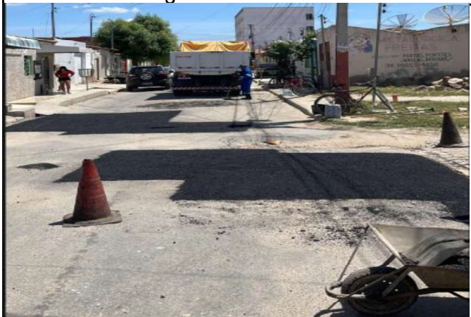
FOTO 11: Usinagem de CBUQ
