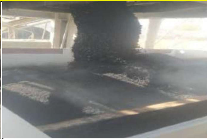
FOTO 08: Usinagem de CBUQ
