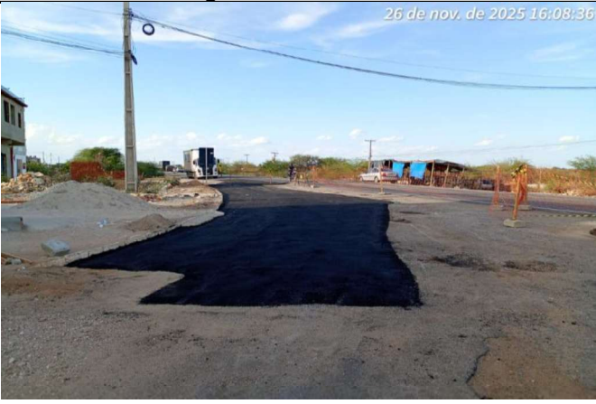
FOTO 16: Usinagem de CBUQ
