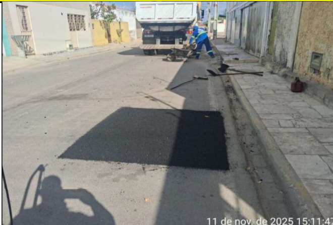
FOTO 14: Usinagem de CBUQ
