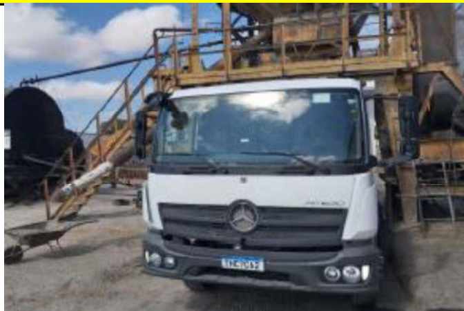
FOTO 02: Usinagem de CBUQ
