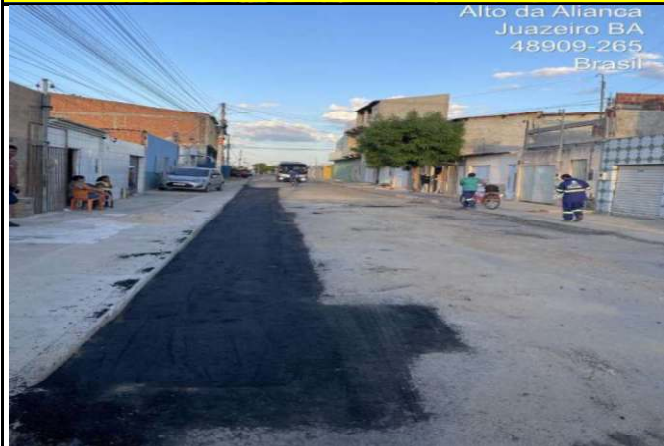
FOTO 13: Usinagem de CBUQ
