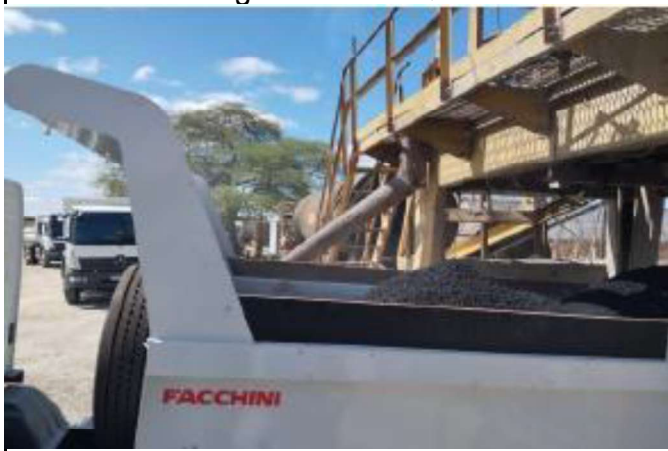
FOTO 03: Usinagem de CBUQ
