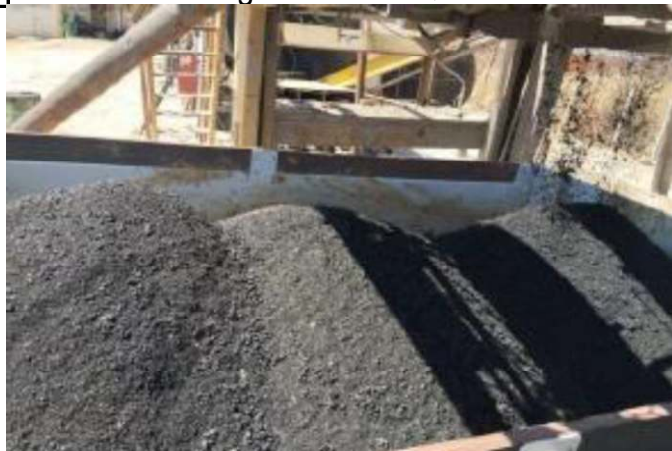
FOTO 04: Usinagem de CBUQ
