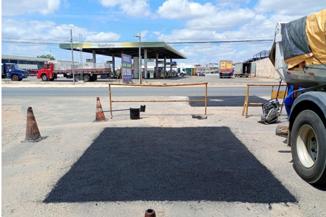
FOTO 13: Usinagem de CBUQ
