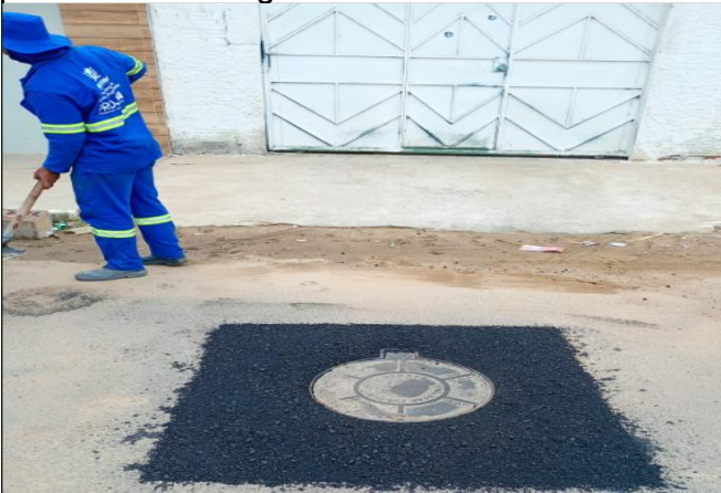
FOTO 11: Usinagem de CBUQ
