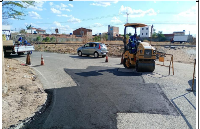
FOTO 16: Usinagem de CBUQ
