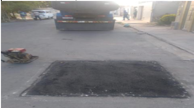
FOTO 11: Aplicação de CBUQ
