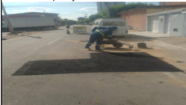
FOTO 13: Aplicação de CBUQ
