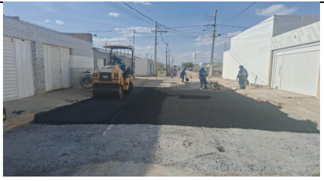
FOTO 08: Aplicação de CBUQ
