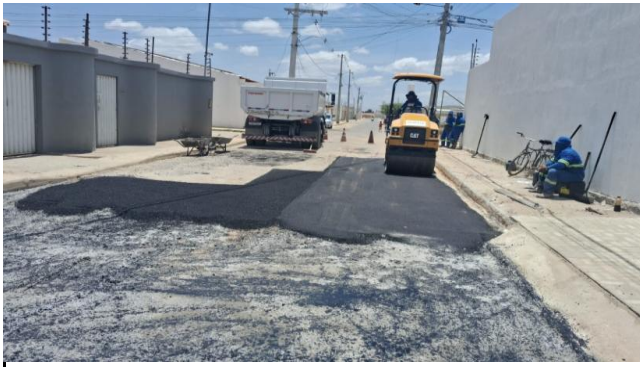
FOTO 07: Aplicação de CBUQ
