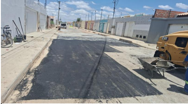
FOTO 09: Aplicação de CBUQ
