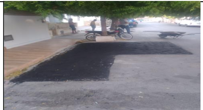
FOTO 12: Aplicação de CBUQ
