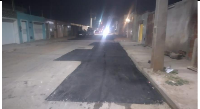
FOTO 10: Aplicação de CBUQ
