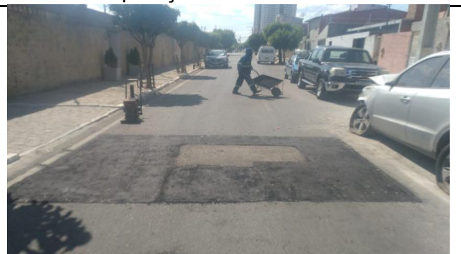
FOTO 14: Aplicação de CBUQ
