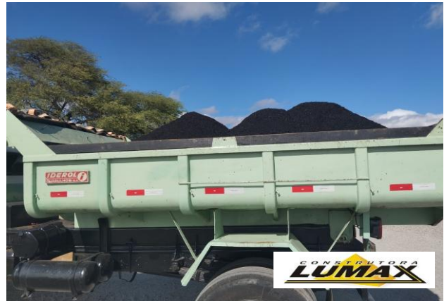
FOTO 06: Usinagem de CBUQ
