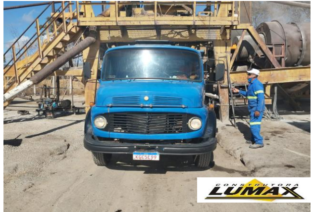
FOTO 04: Usinagem de CBUQ
