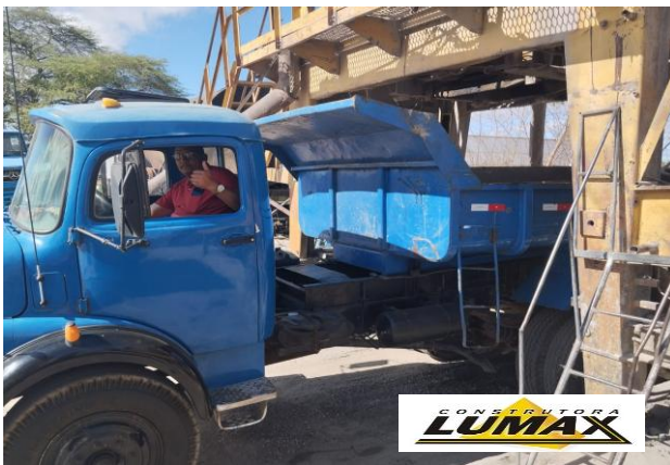
FOTO 03: Usinagem de CBUQ
