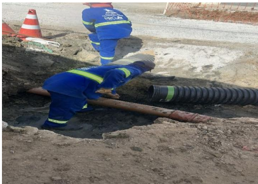
AV PROPRIÁ - EXECUÇÃO DE REDE
