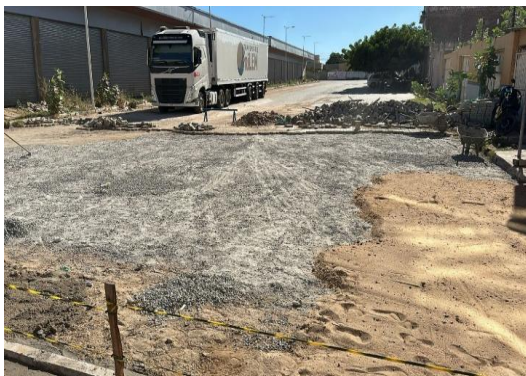
RUA ADOALTO MATOS - APLICAÇÃO DE BGS
