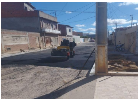
RUA SÃO JOÃO - TAPA BURACO CBUQ
