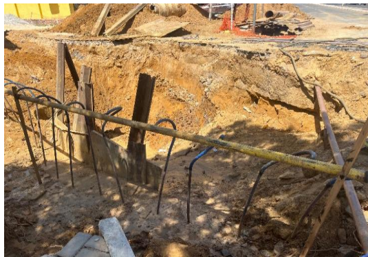
AV ADOLFO VIANA - MANUTENÇÃO DE REDE
