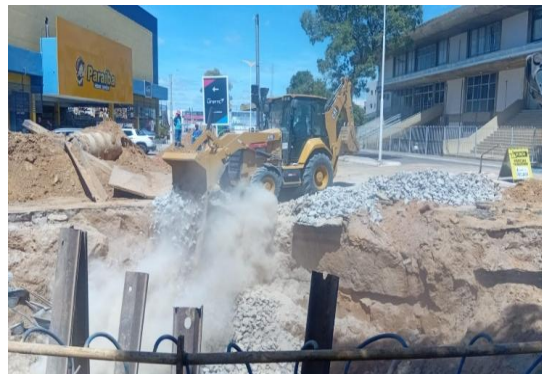
AV ADOLFO VIANA - APLICAÇÃO DE PEDRA
