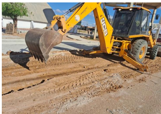
AV CHEFIC KHOURY - ESCAVAÇÃO MECANIZADA
