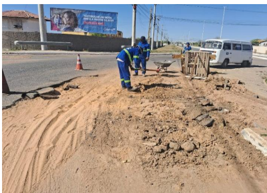
AV JOÃO PAULO II - PREPARAÇÃO DE TRECHO
