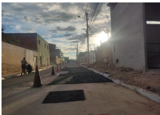
RUA SÃO JOÃO - TAPA BURACO CBUQ
