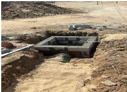
AV PROPRIÁ - EXECUÇÃO DE CAIXA
