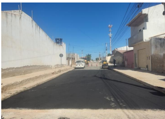
AV PROPRIÁ - APLICAÇÃO DE CBUQ
