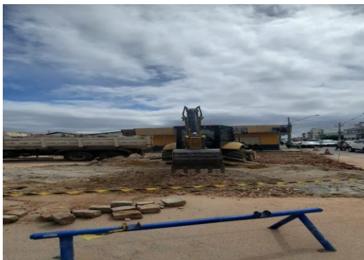
RUA ADOALTO MATOS - APLICAÇÃO DE BGS
