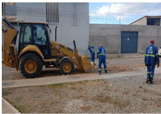
RUA MATATU - LIMPEZA DE ÁREA
