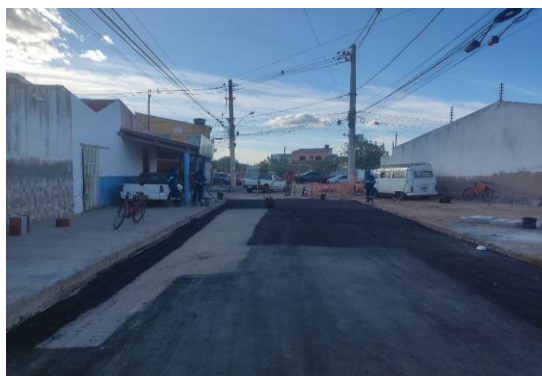
AV PROPRIÁ - APLICAÇÃO DE CBUQ
