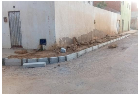
RUA SÃO JOÃO - ASSENTAMENTO DE MEIO FIO
