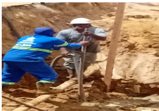
AV ADOLFO VIANA - MICROESTACA DE CONCRETO
