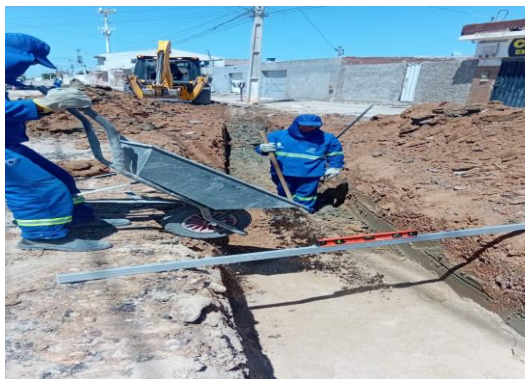
AV PROPRIÁ - ATERRO COM AREIA
