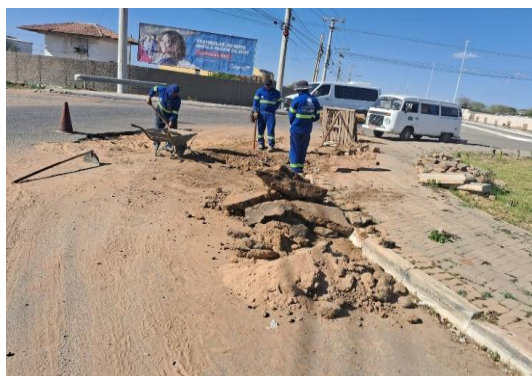
AV JOÃO PAULO II - PREPARAÇÃO DE TRECHO
