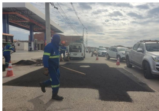
AV PROPRIÁ - APLICAÇÃO DE CBUQ
