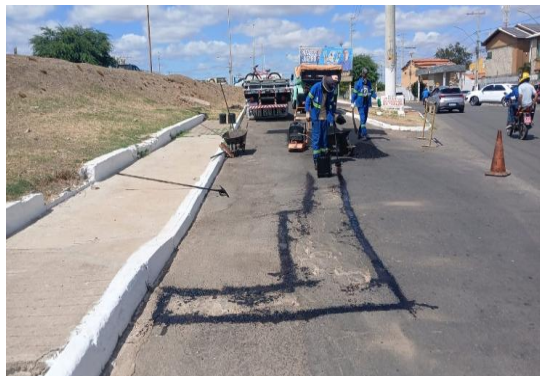
AV RAUL NEVES - PREPARAÇÃO DE EMULSÃO
