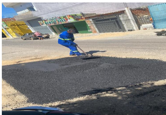
AV PAULO AFONSO - APLICAÇÃO DE CBUQ
