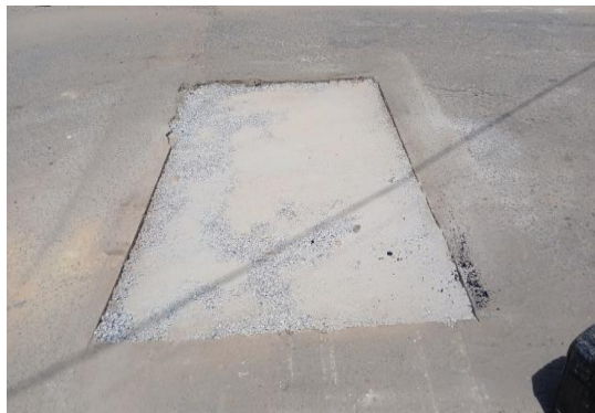
RUA MATATU - APLICAÇÃO DE BGS
