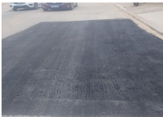
AV PROPRIÁ - APLICAÇÃO DE CBUQ
