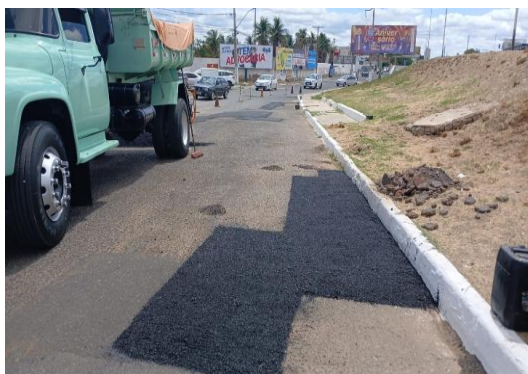
AV RAUL NEVES - APLICAÇÃO DE CBUQ
