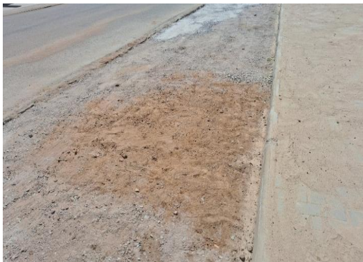
AV JOÃO PAULO II - PREPARAÇÃO DE TRECHO
