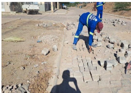
PINHÕES - PAVIMENTAÇÃO DE RUA EM PARALELO
