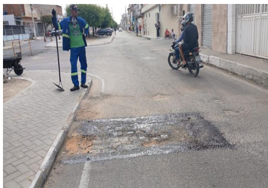
AV PAULO AFONSO - APLICAÇÃO DE EMULSÃO
