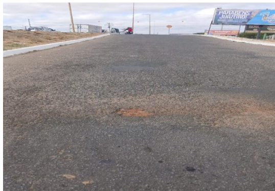
AV RAUL NEVES - PREPARAÇÃO DE TRECHO
