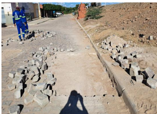
PINHÕES - PAVIMENTAÇÃO DE RUA EM PARALELO
