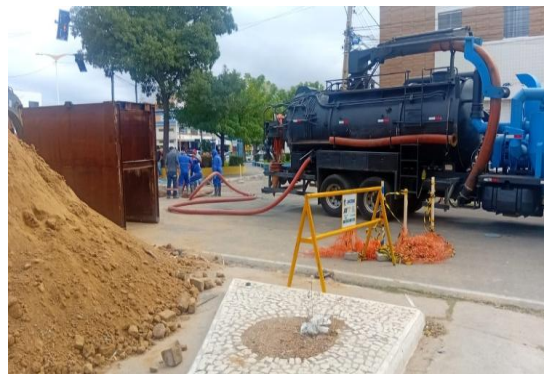
AV ADOLFO VIANA - LIMPEZA COM SEWERJET
