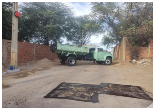
RUA SÃO JOÃO - TAPA BURACO CBUQ
