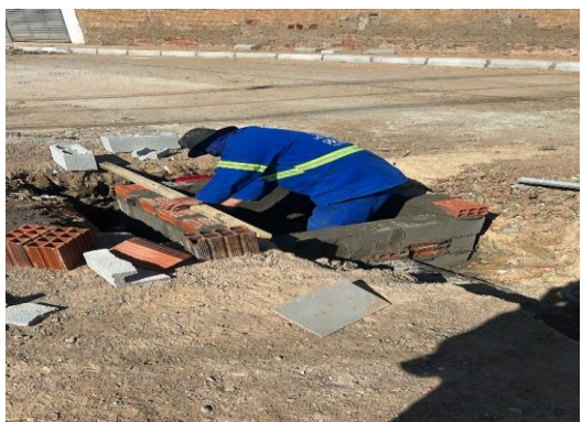
AV PROPRIÁ - EXECUÇÃO DE CAIXA
