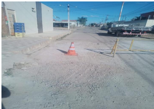
RUA SÃO JOÃO - APLICAÇÃO DE BGS
