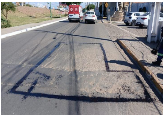
AV RAUL NEVES - APLICAÇÃO DE CBUQ
