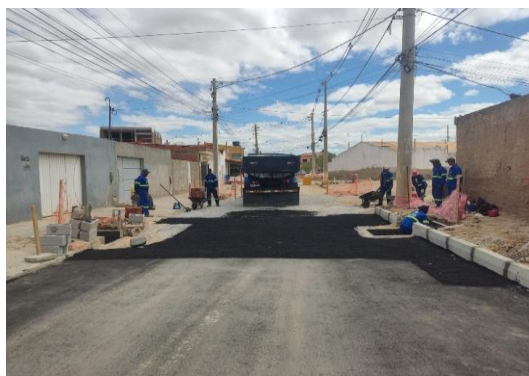
AV PROPRIÁ - APLICAÇÃO DE CBUQ
