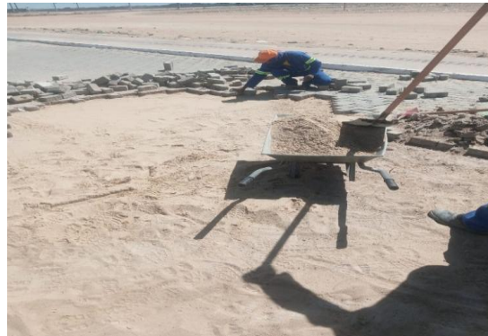
DR HUMBERTO - PAVIMENTAÇÃO EM INTERTRAVADO
