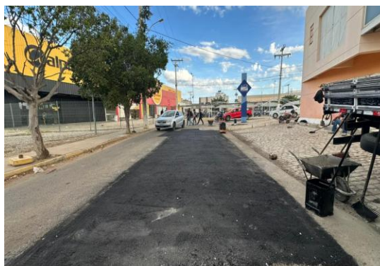
RUA MATATU - APLICAÇÃO DE CBUQ
