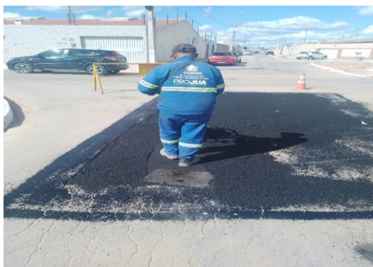
AV PROPRIÁ - APLICAÇÃO DE CBUQ
