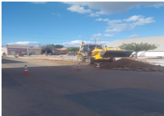
AV CHEFIC KHOURY - ESCAVAÇÃO MECANIZADA
