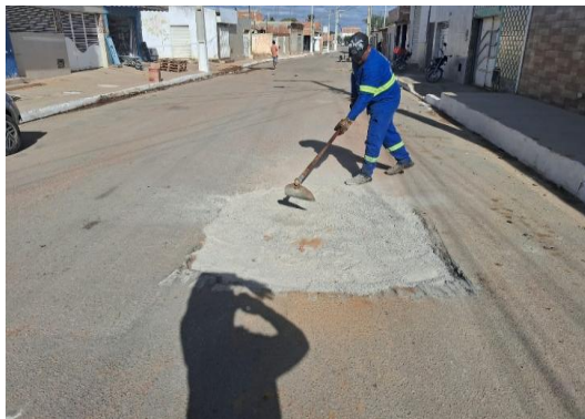
AV ENG MANOEL BORGES - APLICAÇÃO DE BGS
