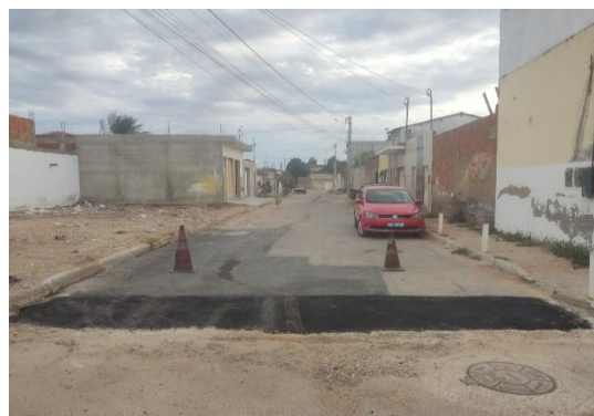
AV PROPRIÁ - APLICAÇÃO DE CBUQ
