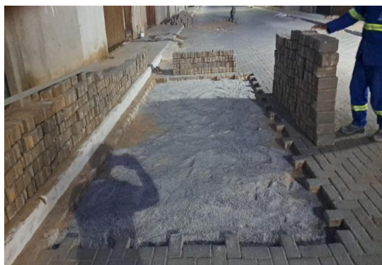
DR HUMBERTO - PAVIMENTAÇÃO EM INTERTRAVADO
