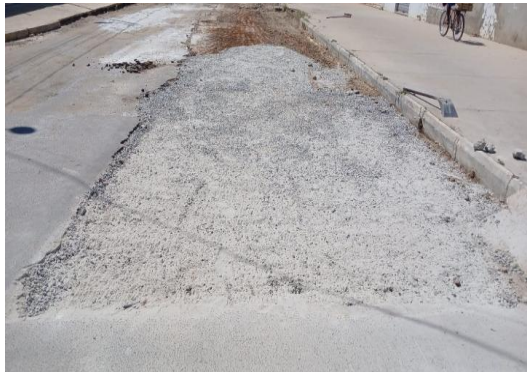
RUA MATATU - APLICAÇÃO DE BGS
