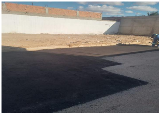
AV PROPRIÁ - APLICAÇÃO DE CBUQ
