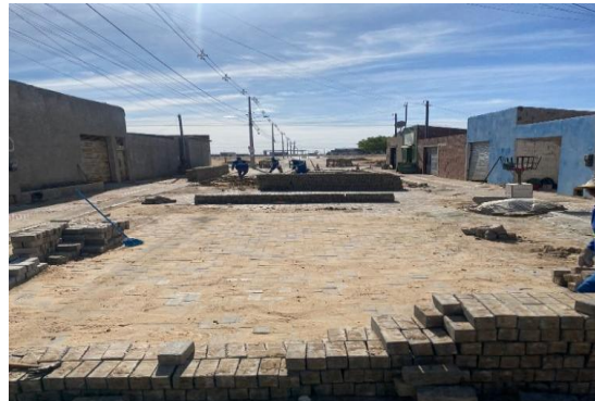
DR HUMBERTO - PAVIMENTAÇÃO EM INTERTRAVADO
