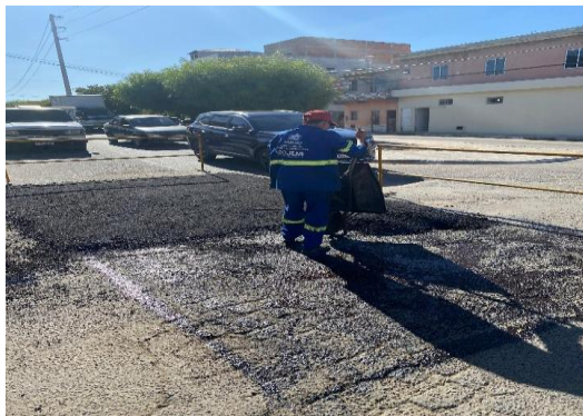
AV PAULO AFONSO - APLICAÇÃO DE CBUQ
