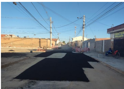
AV PROPRIÁ - APLICAÇÃO DE CBUQ
