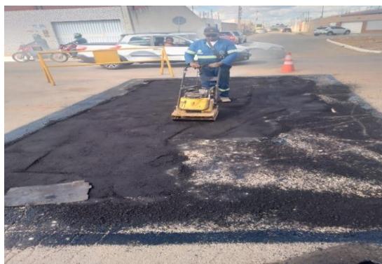
AV PROPRIÁ - APLICAÇÃO DE CBUQ
