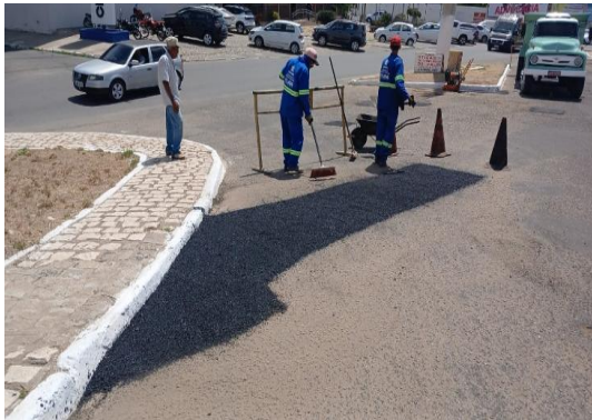
AV RAUL NEVES - APLICAÇÃO DE CBUQ
