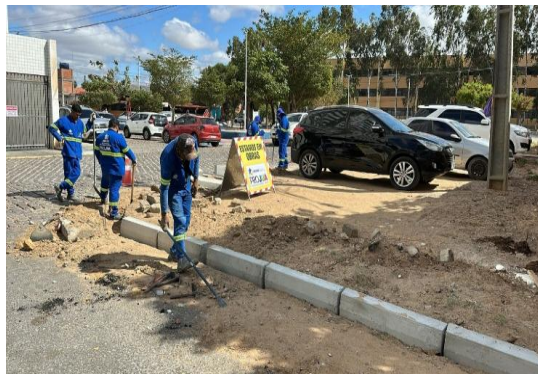
RUA PEDRO BANDURA - APLICAÇÃO DE MEIO FIO
