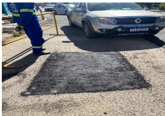
AV PAULO AFONSO - APLICAÇÃO DE CBUQ
