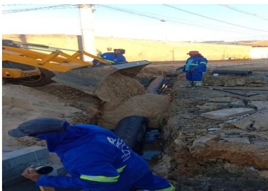
AV PROPRIÁ - ATERRO COM AREIA
