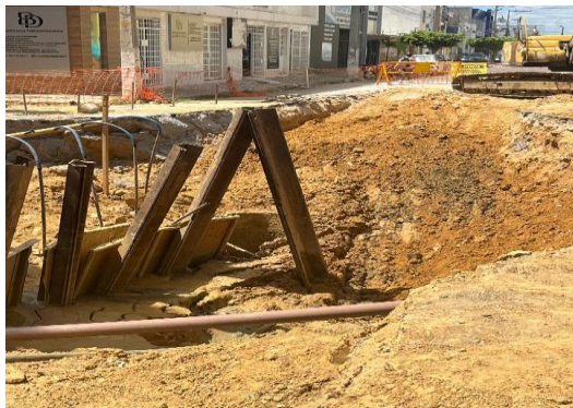
AV ADOLFO VIANA - SINALIZAÇÃO COM PLACAS
