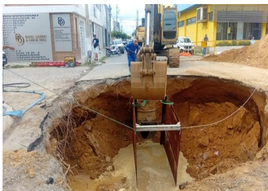
AV ADOLFO VIANA - MANUTENÇÃO DE DRENAGEM
