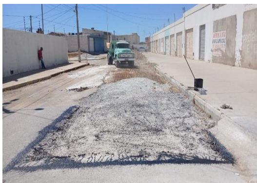
RUA MATATU - APLICAÇÃO DE EMULSÃO
