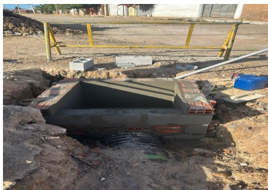
AV PROPRIÁ - EXECUÇÃO DE CAIXA
