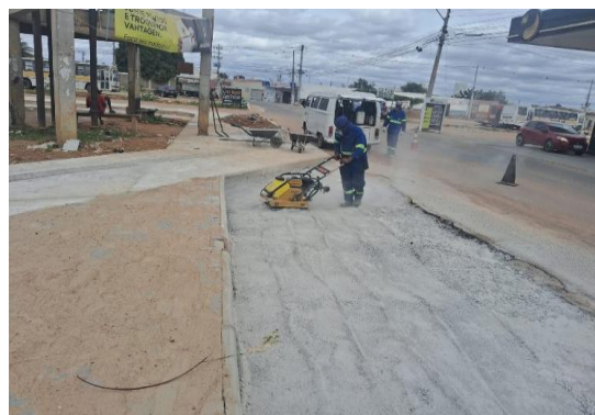
AV CHEFIC KHOURY - COMPACTAÇÃO DE TRECHO
