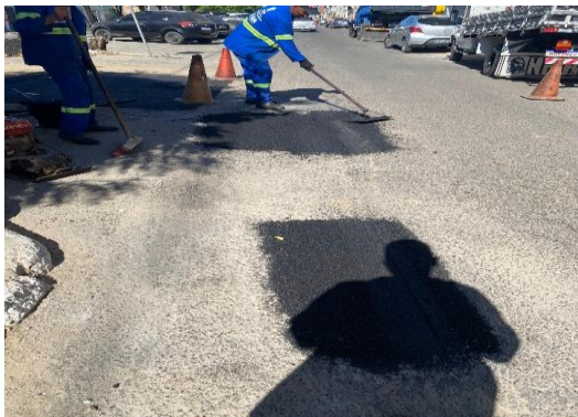
AV PAULO AFONSO - APLICAÇÃO DE CBUQ
