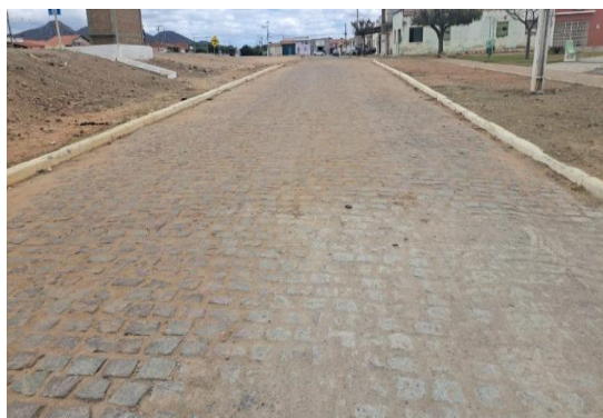
PINHÕES - EXECUÇÃO DE RUA EM PARALELO
