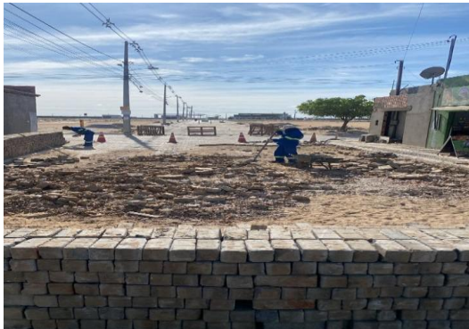
DR HUMBERTO - PAVIMENTAÇÃO EM INTERTRAVADO
