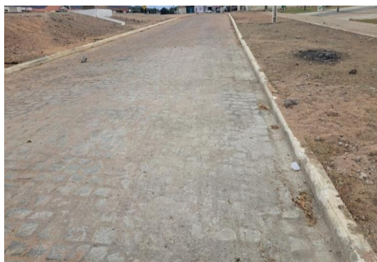
PINHÕES - EXECUÇÃO DE RUA EM PARALELO
