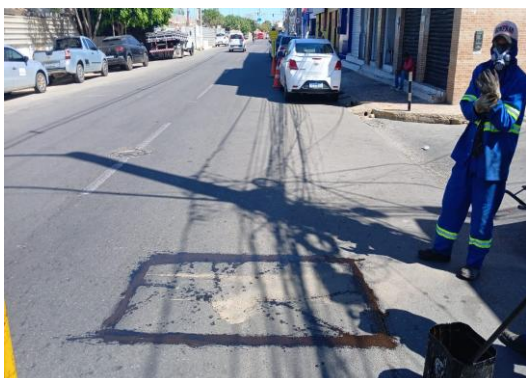
AV SANTOS DUMONT - APLICAÇÃO DE EMULSÃO
