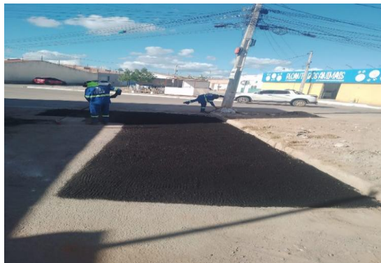
AV PROPRIÁ - APLICAÇÃO DE CBUQ
