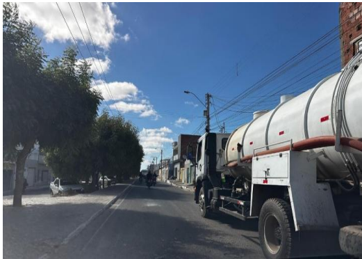
ALTO DA MARAVILHA - LIMPEZA COM SEWERJET
