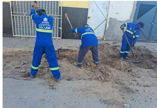
AV ENG MANOEL BORGES - ESCAVAÇÃO MANUAL
