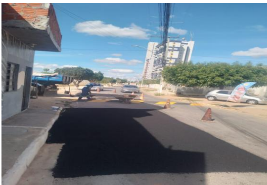
RUA SÃO JOÃO - TAPA BURACO CBUQ
