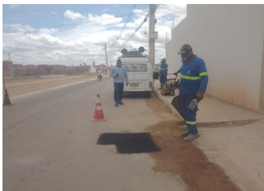
AV PROPRIÁ - APLICAÇÃO DE CBUQ
