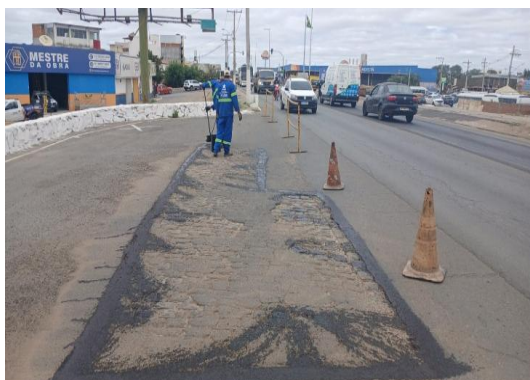
AV SANTOS DUMONT - APLICAÇÃO DE EMULSÃO
