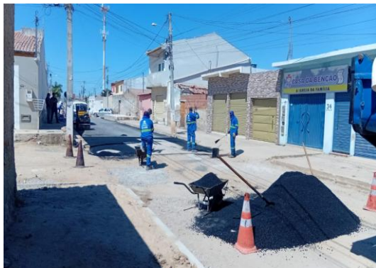
AV PROPRIÁ - APLICAÇÃO DE CBUQ
