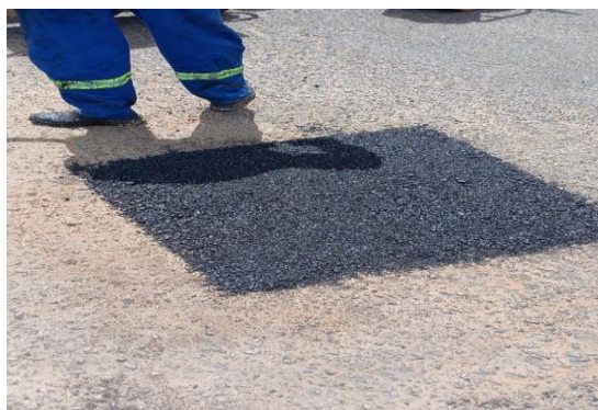
AV RAUL NEVES - APLICAÇÃO DE CBUQ
