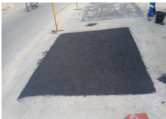
AV PAULO AFONSO - APLICAÇÃO DE CBUQ
