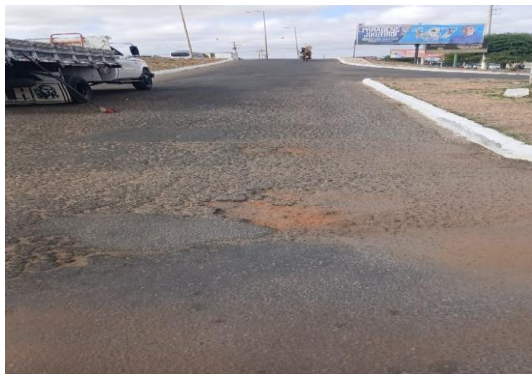
AV RAUL NEVES - PREPARAÇÃO DE TRECHO
