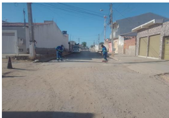
AV PROPRIÁ - APLICAÇÃO DE CBUQ
