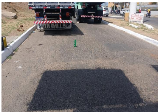
AV RAUL NEVES - APLICAÇÃO DE CBUQ
