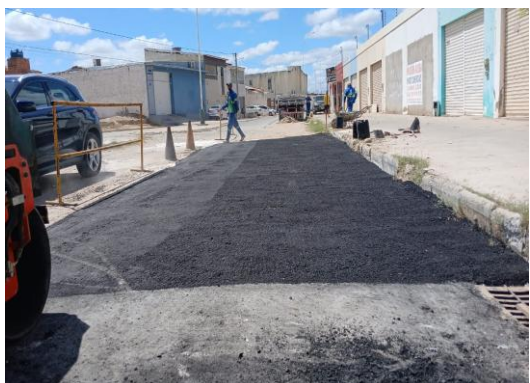
RUA MATATU - APLICAÇÃO DE CBUQ
