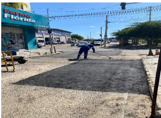
AV PAULO AFONSO - APLICAÇÃO DE CBUQ
