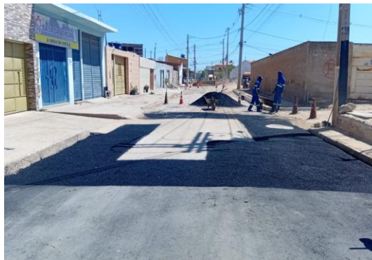
AV PROPRIÁ - APLICAÇÃO DE CBUQ
