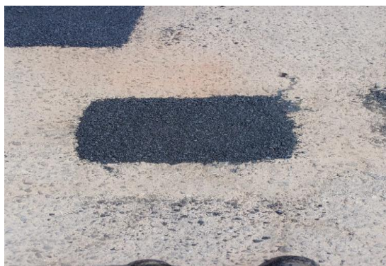
AV RAUL NEVES - APLICAÇÃO DE CBUQ
