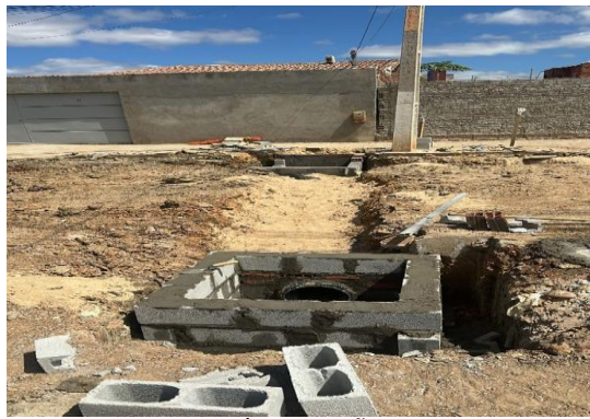
AV PROPRIÁ - EXECUÇÃO DE CAIXA
