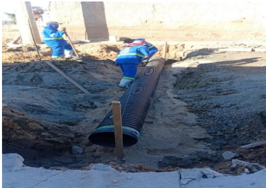
AV PROPRIÁ - EXECUÇÃO DE REDE
