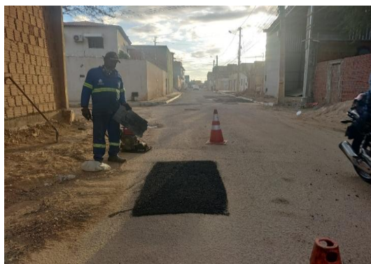
RUA SÃO JOÃO - TAPA BURACO CBUQ
