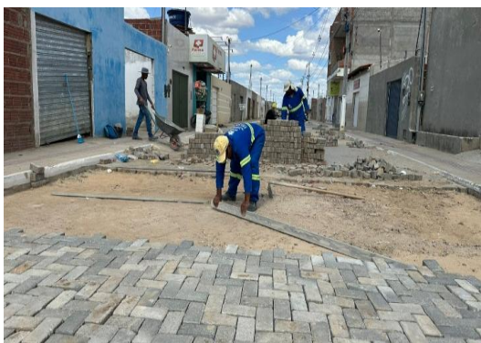
DR HUMBERTO - PAVIMENTAÇÃO EM INTERTRAVADO
