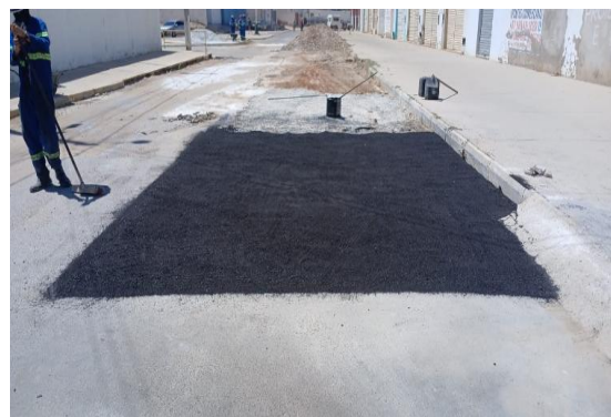
RUA MATATU - APLICAÇÃO DE CBUQ
