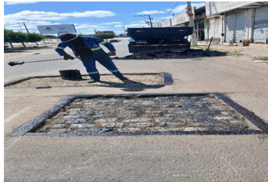
AV SANTOS DUMONT - APLICAÇÃO DE EMULSÃO
