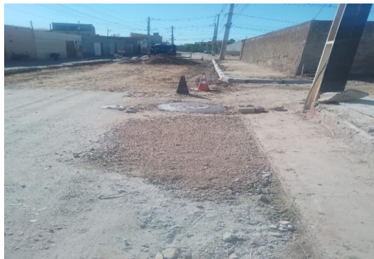
RUA SÃO JOÃO - APLICAÇÃO DE BGS
