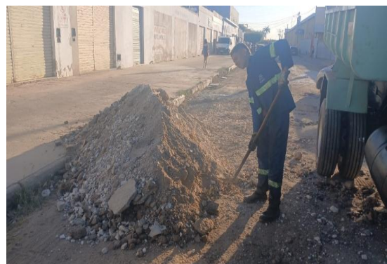
RUA MATATU - LIMPEZA DE ÁREA
