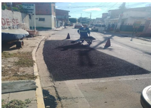
RUA SÃO JOÃO - TAPA BURACO CBUQ
