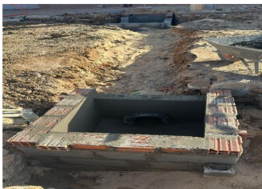
AV PROPRIÁ - EXECUÇÃO DE CAIXA
