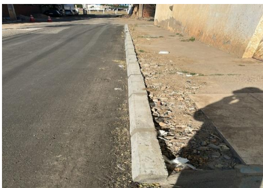
RUA SÃO JOÃO - ASSENTAMENTO DE MEIO FIO
