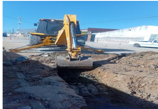
AV PROPRIÁ - ESCAVAÇÃO DE VALA
