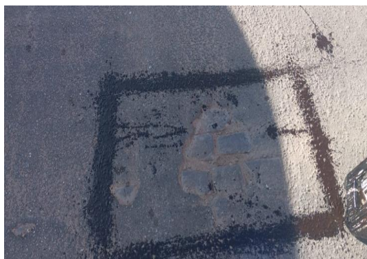
AV SANTOS DUMONT - APLICAÇÃO DE EMULSÃO
