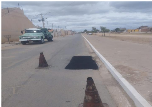
AV PROPRIÁ - APLICAÇÃO DE CBUQ
