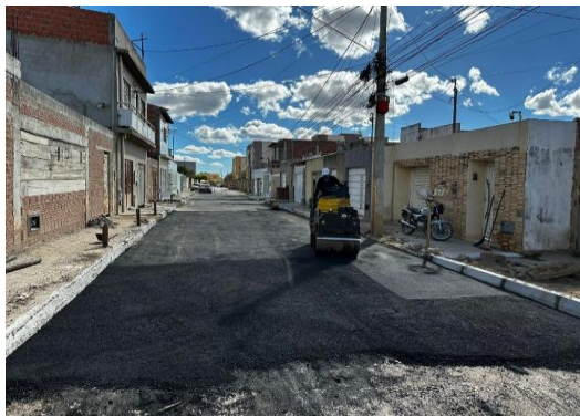
RUA SÃO JOÃO - TAPA BURACO CBUQ
