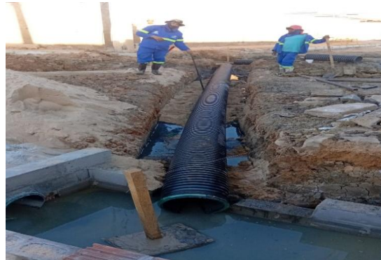
AV PROPRIÁ - EXECUÇÃO DE REDE
