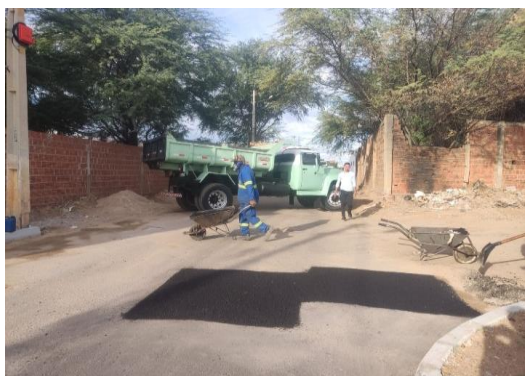
RUA SÃO JOÃO - TAPA BURACO CBUQ
