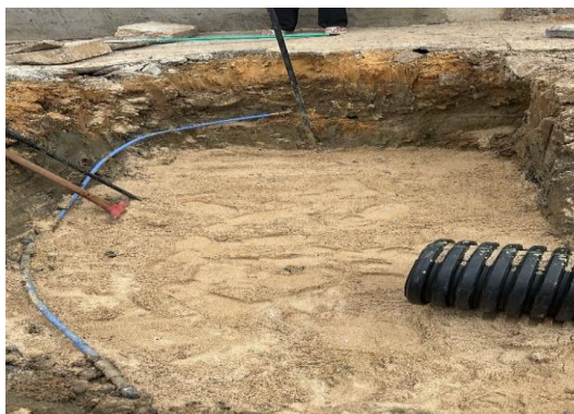
AV PROPRIÁ - REGULARIZAÇÃO DE VALA
