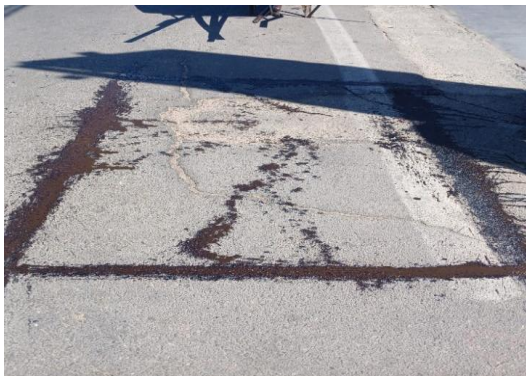
AV SANTOS DUMONT - APLICAÇÃO DE EMULSÃO
