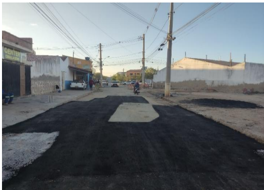
AV PROPRIÁ - APLICAÇÃO DE CBUQ
