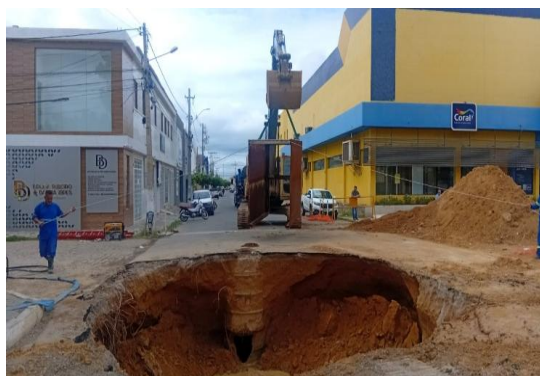
AV ADOLFO VIANA - MANUTENÇÃO DE DRENAGEM
