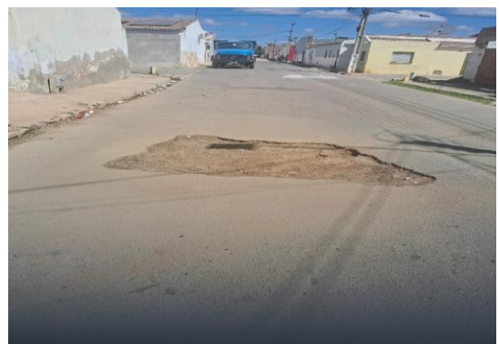
AV PROPRIÁ - APLICAÇÃO DE BGS
