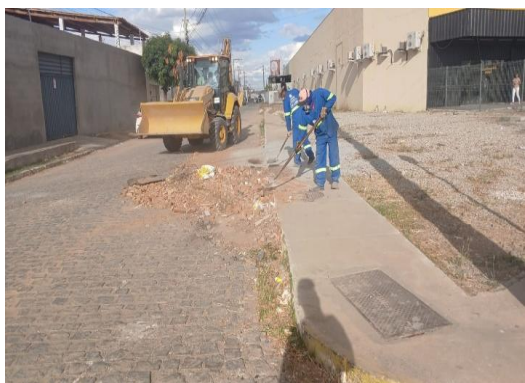
RUA MATATU - LIMPEZA DE ÁREA
