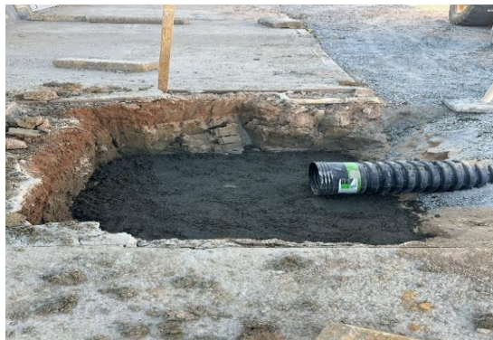
AV PROPRIÁ - EXECUÇÃO DE REDE
