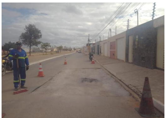
AV PROPRIÁ - APLICAÇÃO DE BGS
