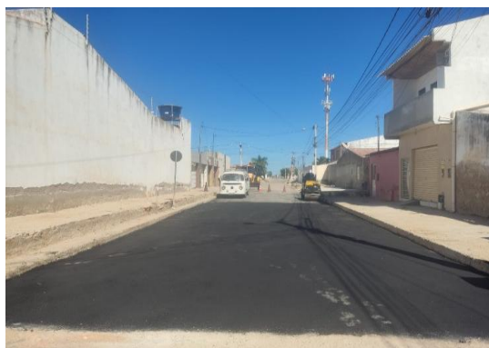
AV PROPRIÁ - APLICAÇÃO DE CBUQ
