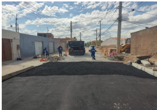
AV PROPRIÁ - APLICAÇÃO DE CBUQ
