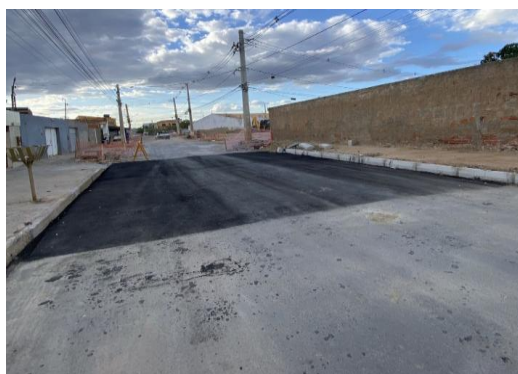
AV PROPRIÁ - APLICAÇÃO DE CBUQ
