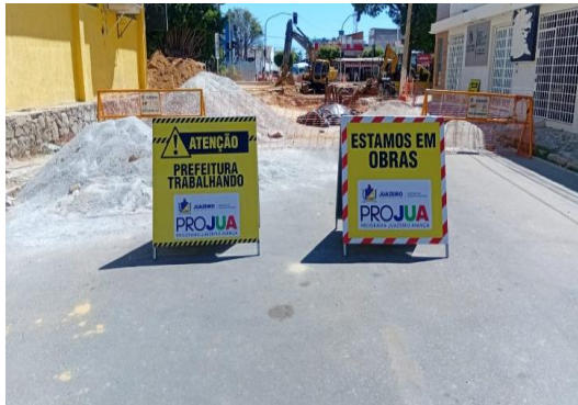
AV ADOLFO VIANA - SINALIZAÇÃO COM PLACAS
