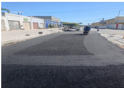
RUA MATATU - APLICAÇÃO DE CBUQ
