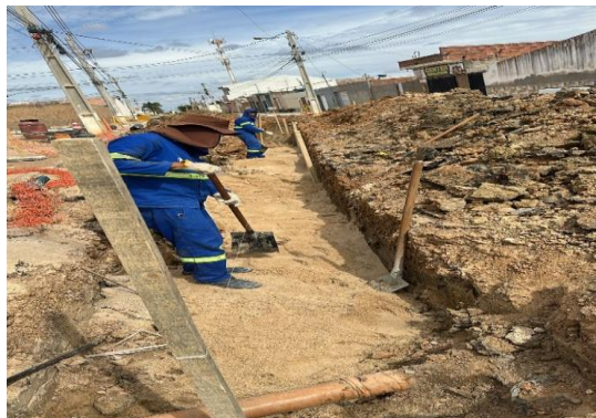
AV PROPRIÁ - ATERRO COM AREIA
