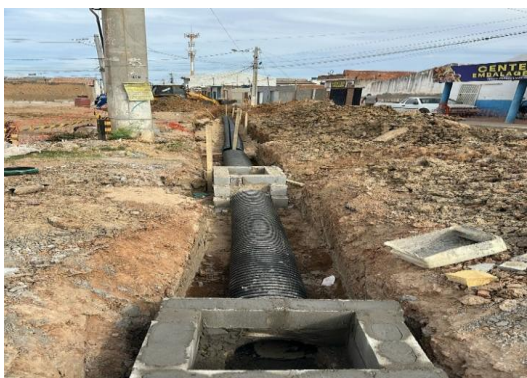
AV PROPRIÁ - DISPOSITIVOS DE DRENAGEM
