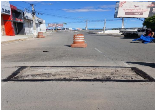
AV SANTOS DUMONT - APLICAÇÃO DE EMULSÃO
