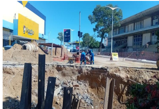
AV ADOLFO VIANA - MANUTENÇÃO DE REDE
