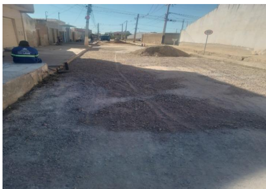
RUA SÃO JOÃO - APLICAÇÃO DE BGS
