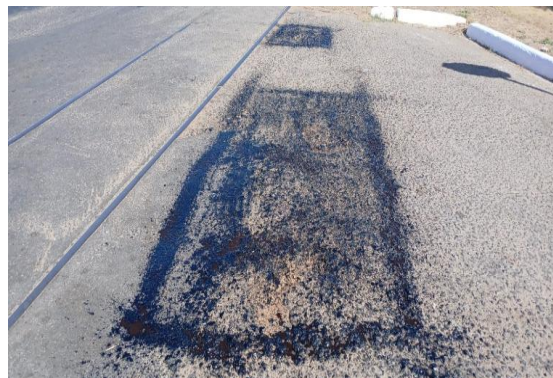
AV RAUL NEVES - APLICAÇÃO DE EMULSÃO
