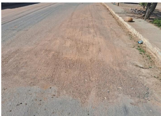
AV JOÃO PAULO II - PREPARAÇÃO DE TRECHO
