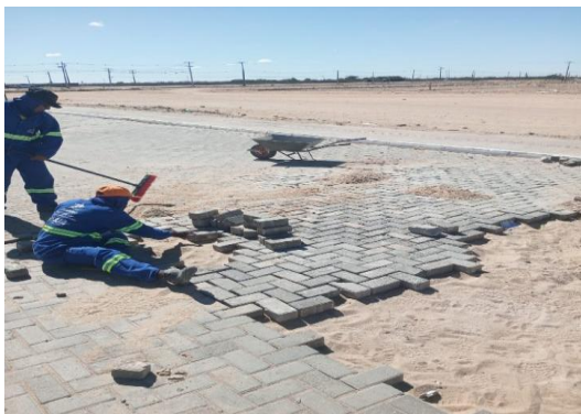
DR HUMBERTO - PAVIMENTAÇÃO EM INTERTRAVADO
