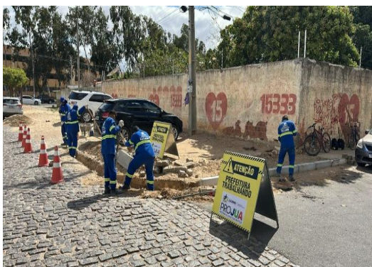
RUA PEDRO BANDURA - APLICAÇÃO DE MEIO FIO
