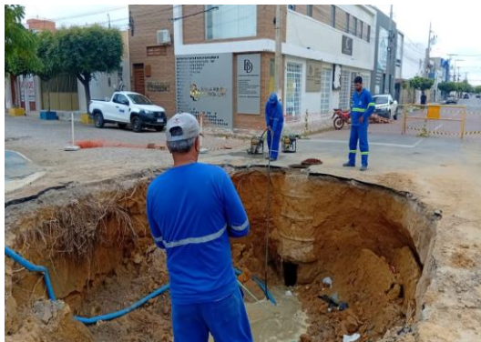
AV ADOLFO VIANA - MANUTENÇÃO DE DRENAGEM
