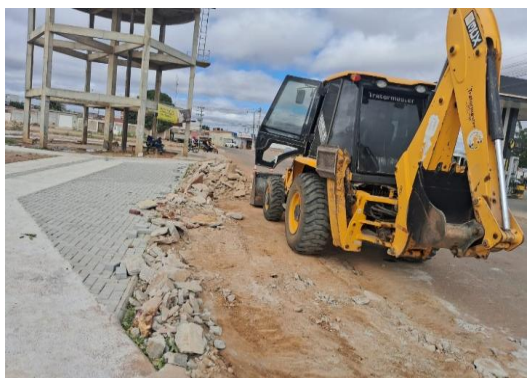
AV CHEFIC KHOURY - ESCAVAÇÃO MECANIZADA
