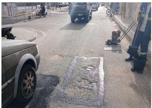
AV PAULO AFONSO - APLICAÇÃO DE EMULSÃO
