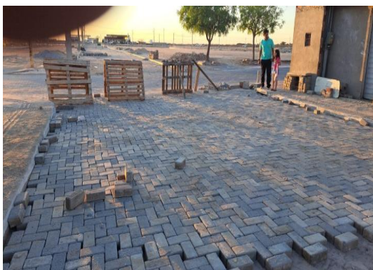
DR HUMBERTO - PAVIMENTAÇÃO EM INTERTRAVADO
