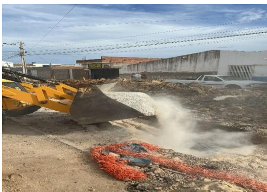
AV PROPRIÁ - APLICAÇÃO DE BGS
