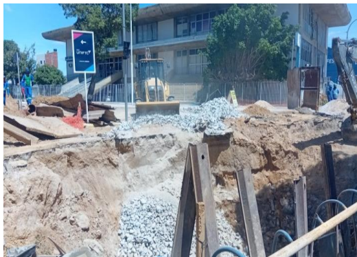
AV ADOLFO VIANA - APLICAÇÃO DE PEDRA
