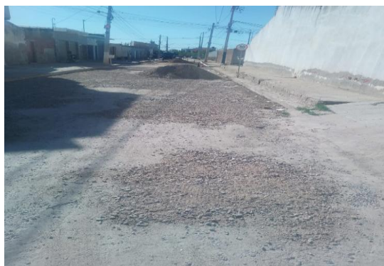
RUA SÃO JOÃO - APLICAÇÃO DE BGS
