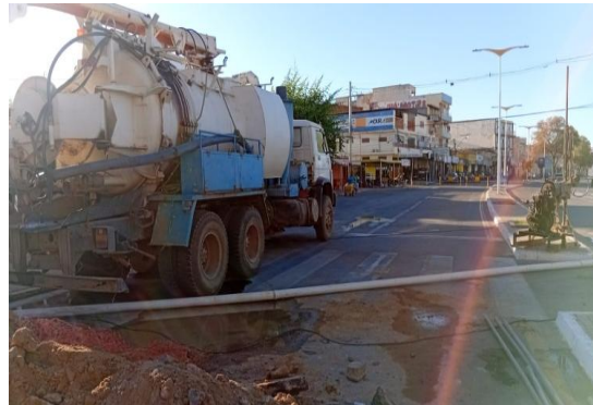
AV ADOLFO VIANA - LIMPEZA COM SEWERJET
