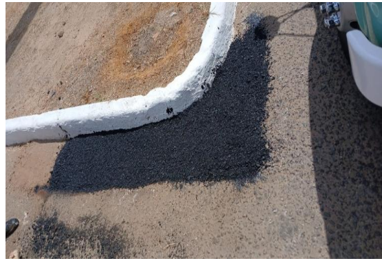
AV RAUL NEVES - APLICAÇÃO DE CBUQ
