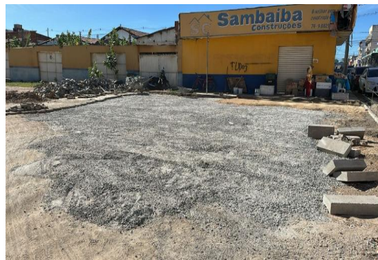
RUA ADOALTO MATOS - APLICAÇÃO DE BGS
