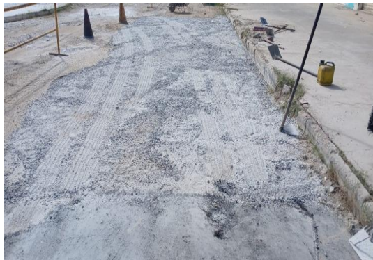
RUA MATATU - APLICAÇÃO DE BGS
