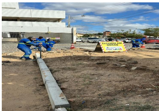
RUA PEDRO BANDURA - APLICAÇÃO DE MEIO FIO
