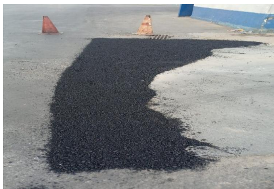
AV RAUL NEVES - APLICAÇÃO DE CBUQ
