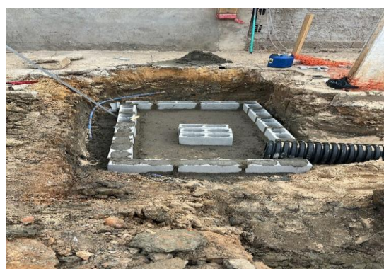
AV PROPRIÁ - EXECUÇÃO DE CAIXA
