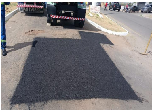
AV RAUL NEVES - APLICAÇÃO DE CBUQ
