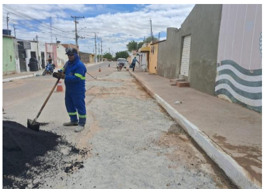
AV ENG MANOEL BORGES - APLICAÇÃO DE BGS
