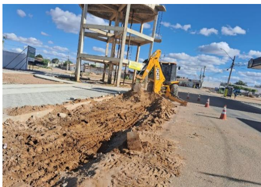
AV CHEFIC KHOURY - ESCAVAÇÃO MECANIZADA
