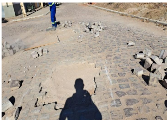
PINHÕES - PAVIMENTAÇÃO DE RUA EM PARALELO
