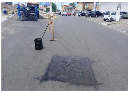
AV RAUL NEVES - APLICAÇÃO DE CBUQ
