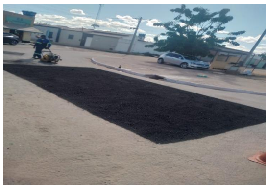
AV PROPRIÁ - APLICAÇÃO DE CBUQ
