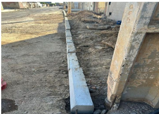
RUA SÃO JOÃO - ASSENTAMENTO DE MEIO FIO
