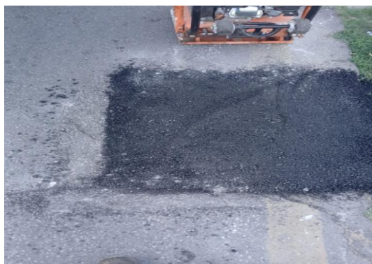
AV RAUL NEVES - APLICAÇÃO DE CBUQ
