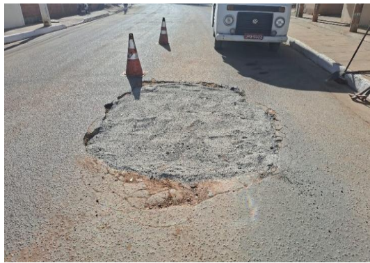
AV ENG MANOEL BORGES - APLICAÇÃO DE BGS
