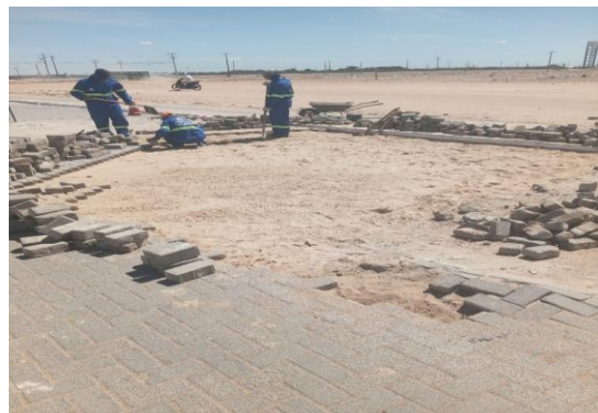
DR HUMBERTO - PAVIMENTAÇÃO EM INTERTRAVADO
