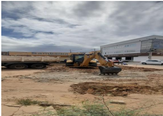
RUA ADOALTO MATOS - ESCAVAÇÃO MECANIZADA
