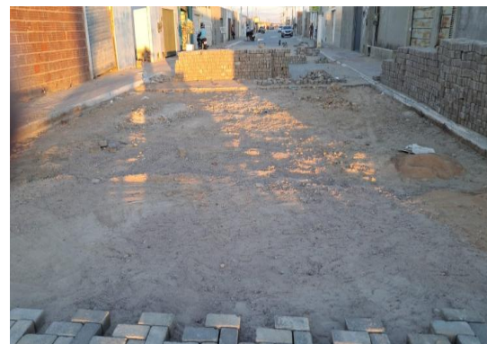
DR HUMBERTO - PAVIMENTAÇÃO EM INTERTRAVADO
