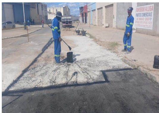
RUA MATATU - APLICAÇÃO DE EMULSÃO
