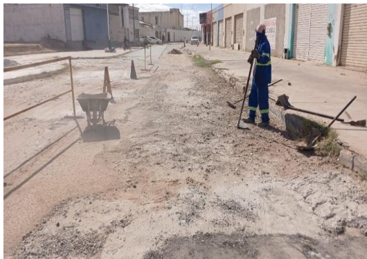
RUA MATATU - LIMPEZA DE ÁREA
