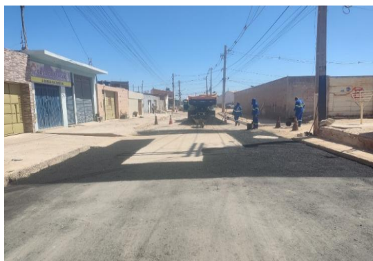
AV PROPRIÁ - APLICAÇÃO DE CBUQ
