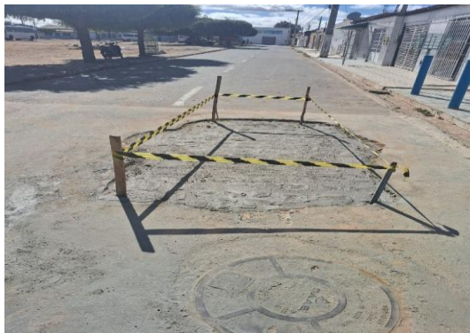
AV JOÃO PAULO II - PREPARAÇÃO DE TRECHO
