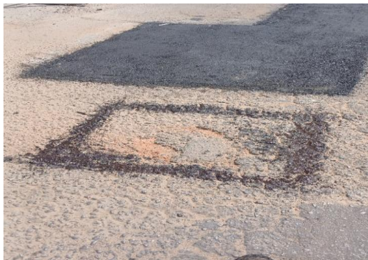
AV RAUL NEVES - PREPARAÇÃO DE EMULSÃO
