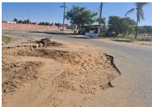
AV JOÃO PAULO II - PREPARAÇÃO DE TRECHO
