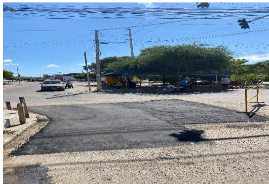
AV PAULO AFONSO - APLICAÇÃO DE CBUQ
