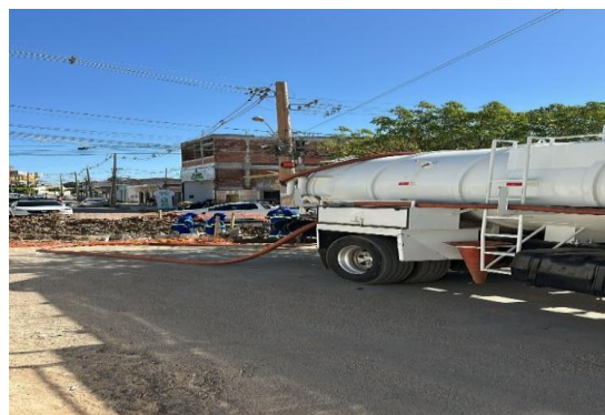
AV PROPRIÁ - LIMPEZA COM SEWERJET
