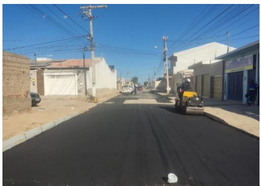
AV PROPRIÁ - ROLO COMPACTADOR
