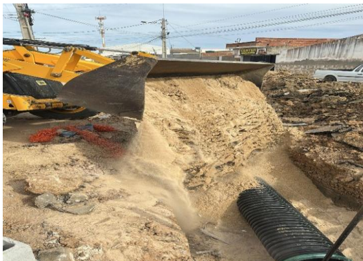
AV PROPRIÁ - ATERRO COM AREIA
