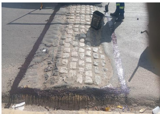
AV SANTOS DUMONT - APLICAÇÃO DE EMULSÃO
