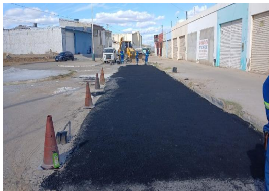
RUA MATATU - APLICAÇÃO DE CBUQ
