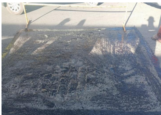
AV SANTOS DUMONT - APLICAÇÃO DE EMULSÃO
