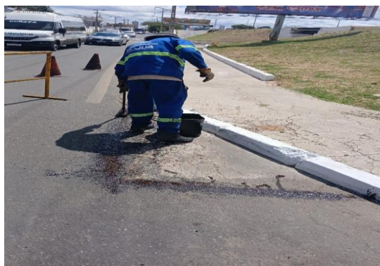
AV RAUL NEVES - APLICAÇÃO DE CBUQ
