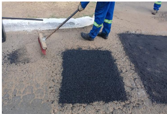
AV RAUL NEVES - PREPARAÇÃO DE CBUQ
