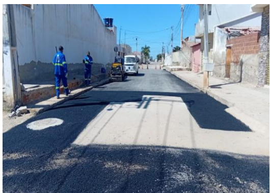
AV PROPRIÁ - APLICAÇÃO DE CBUQ
