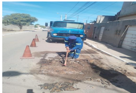
AV PROPRIÁ - PREPARAÇÃO DE TRECHO
