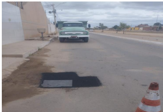
AV PROPRIÁ - APLICAÇÃO DE CBUQ
