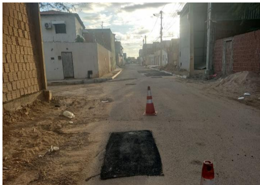
RUA SÃO JOÃO - TAPA BURACO CBUQ
