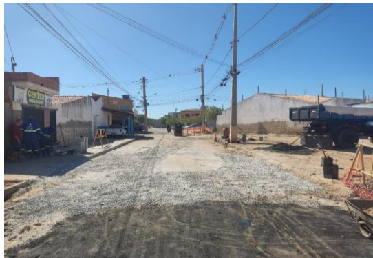
AV PROPRIÁ - APLICAÇÃO DE BGS
