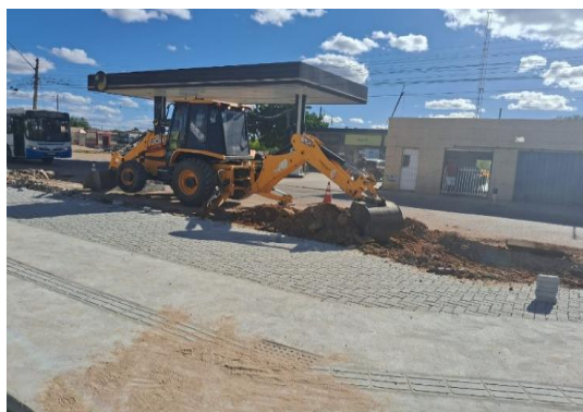
AV CHEFIC KHOURY - ESCAVAÇÃO MECANIZADA
