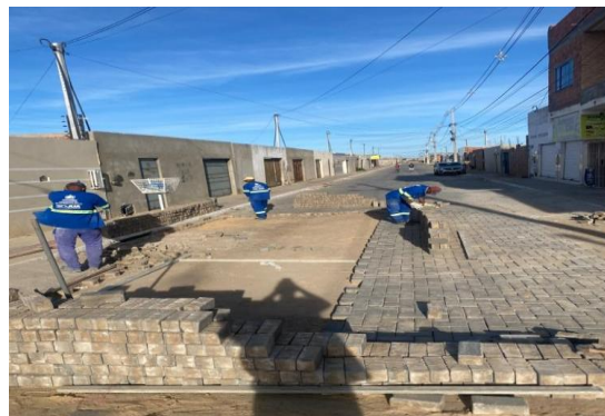
DR HUMBERTO - PAVIMENTAÇÃO EM INTERTRAVADO
