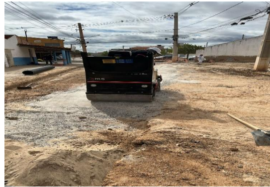
AV PROPRIÁ - COMPACTAÇÃO DE BGS
