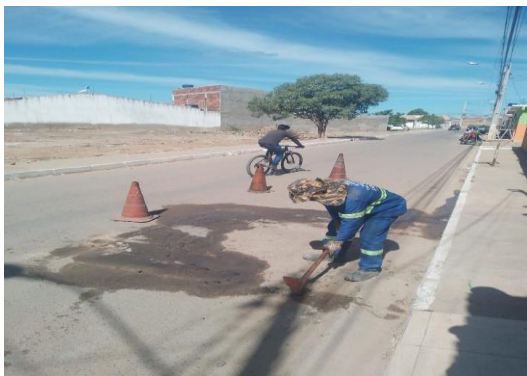
AV PROPRIÁ - PREPARAÇÃO DE TRECHO
