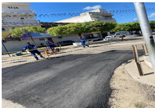
AV PAULO AFONSO - APLICAÇÃO DE CBUQ
