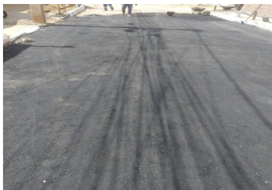
RUA SÃO JOÃO - TAPA BURACO CBUQ
