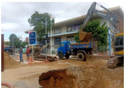
AV ADOLFO VIANA - MANUTENÇÃO DE DRENAGEM
