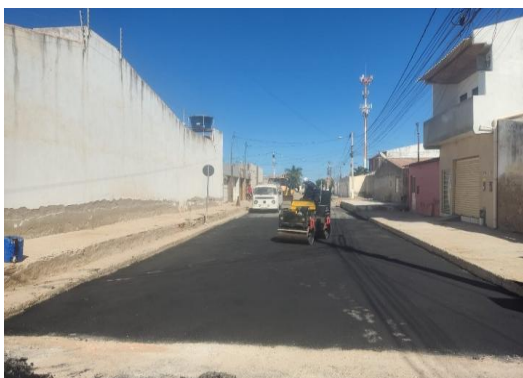
AV PROPRIÁ - APLICAÇÃO DE CBUQ
