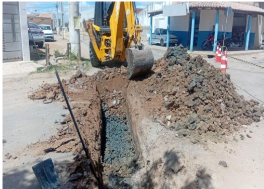
AV PROPRIÁ - ESCAVAÇÃO DE VALA
