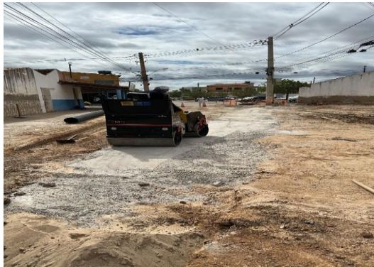
AV PROPRIÁ - COMPACTAÇÃO DE BGS
