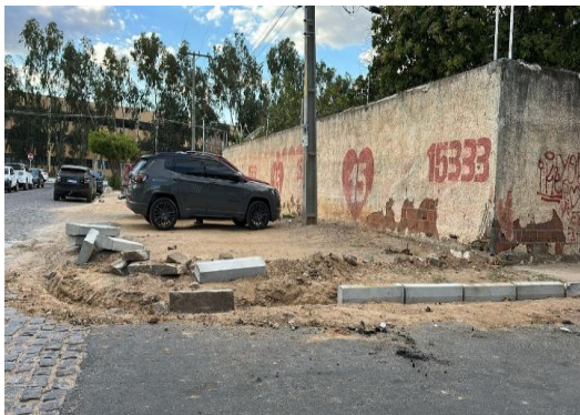
RUA PEDRO BANDURA - APLICAÇÃO DE MEIO FIO
