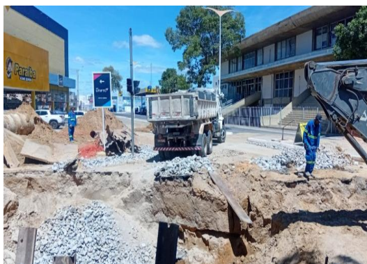
AV ADOLFO VIANA - APLICAÇÃO DE PEDRA
