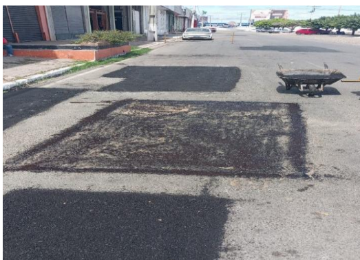
AV SANTOS DUMONT - APLICAÇÃO DE EMULSÃO
