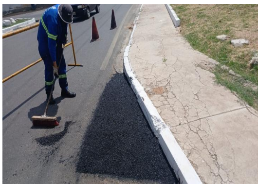
AV RAUL NEVES - APLICAÇÃO DE CBUQ
