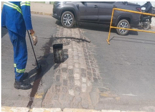
AV SANTOS DUMONT - APLICAÇÃO DE EMULSÃO
