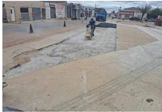
AV CHEFIC KHOURY - COMPACTAÇÃO DE TRECHO
