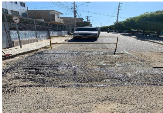
AV PAULO AFONSO - APLICAÇÃO DE EMULSÃO
