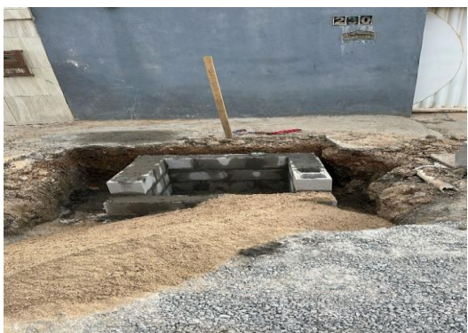
AV PROPRIÁ - EXECUÇÃO DE REDE
