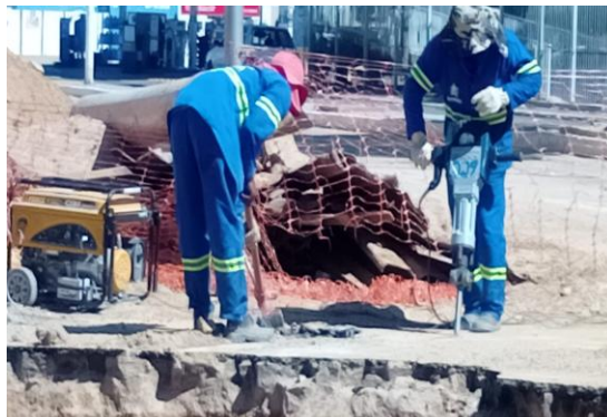
AV ADOLFO VIANA - MICROESTACA DE CONCRETO
