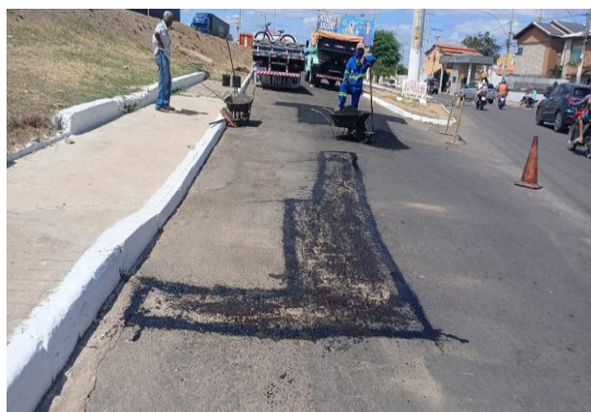
AV RAUL NEVES - APLICAÇÃO DE EMULSÃO
