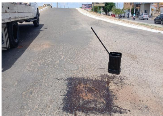
AV RAUL NEVES - APLICAÇÃO DE EMULSÃO
