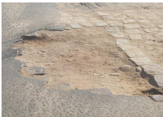
AV SANTOS DUMONT - LIMPEZA DE ÁREA
