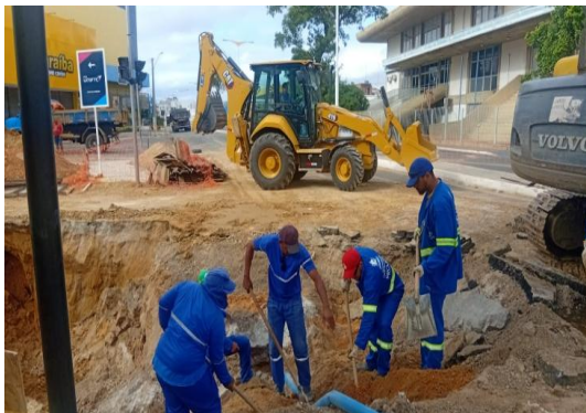
AV ADOLFO VIANA - MICROESTACA DE CONCRETO
