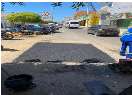
AV PAULO AFONSO - APLICAÇÃO DE CBUQ
