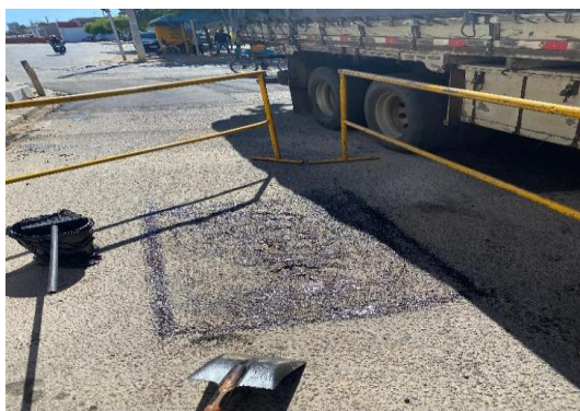
AV PAULO AFONSO - APLICAÇÃO DE EMULSÃO
