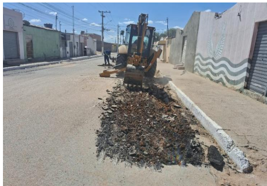
AV ENG MANOEL BORGES - ESCAVAÇÃO MECANIZADA
