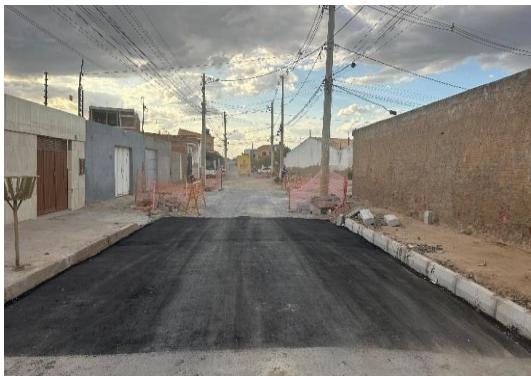
AV PROPRIÁ - APLICAÇÃO DE CBUQ
