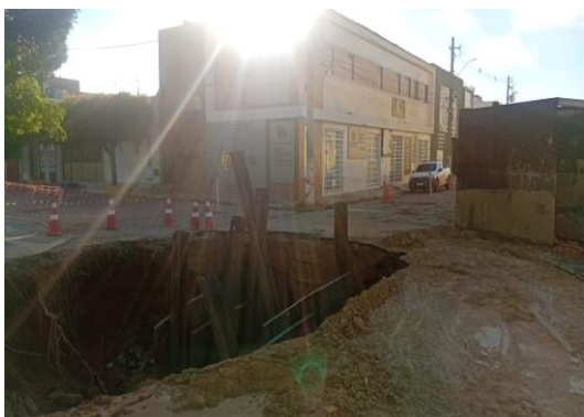
AV ADOLFO VIANA - MANUTENÇÃO DE DRENAGEM
