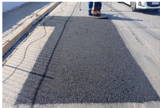
AV RAUL NEVES - APLICAÇÃO DE CBUQ
