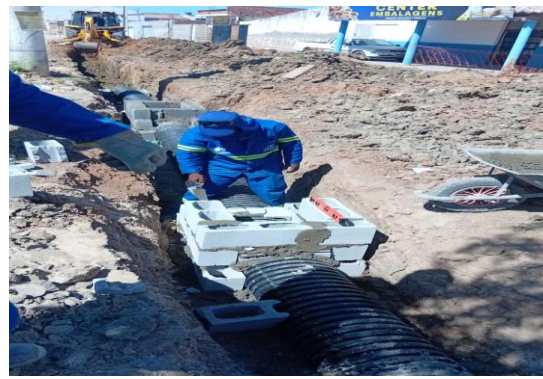
AV PROPRIÁ - EXECUÇÃO DE CAIXA
