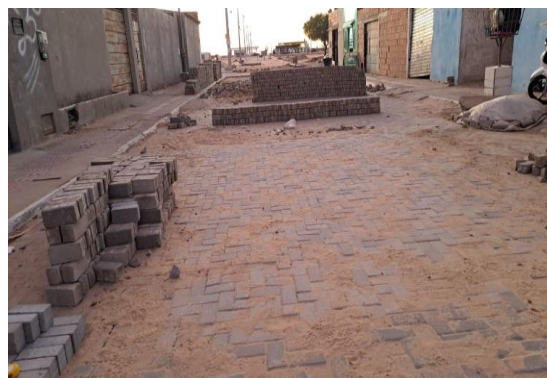
DR HUMBERTO - PAVIMENTAÇÃO EM INTERTRAVADO
