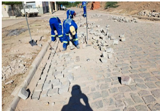
PINHÕES - PAVIMENTAÇÃO DE RUA EM PARALELO
