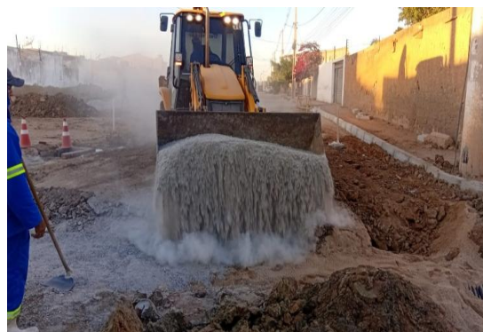
AV PROPRIÁ - APLICAÇÃO DE BGS
