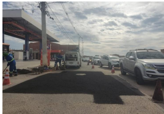
AV PROPRIÁ - APLICAÇÃO DE CBUQ
