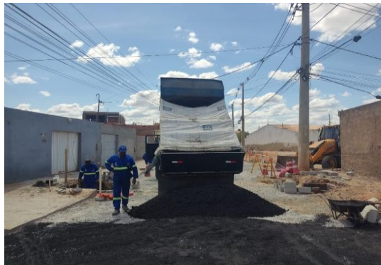
AV PROPRIÁ - APLICAÇÃO DE CBUQ
