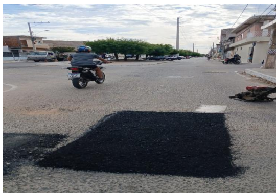
AV PAULO AFONSO - APLICAÇÃO DE CBUQ
