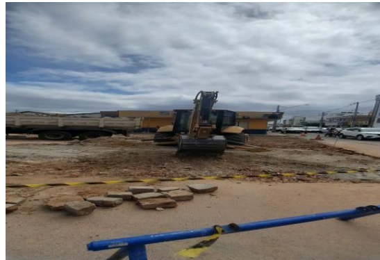
RUA ADOALTO MATOS - ESCAVAÇÃO MECANIZADA
