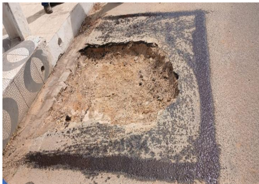
AV PAULO AFONSO - APLICAÇÃO DE EMULSÃO
