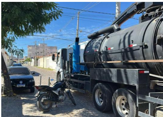
RUA JOALINA - LIMPEZA COM SEWERJET
