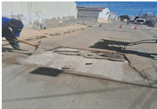
AV JOÃO PAULO II - PREPARAÇÃO DE TRECHO
