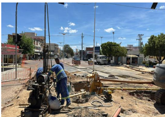
AV ADOLFO VIANA - MICROESTACA DE CONCRETO
