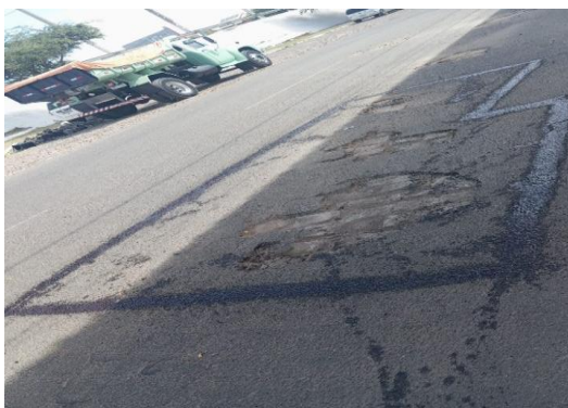
AV SANTOS DUMONT - APLICAÇÃO DE EMULSÃO
