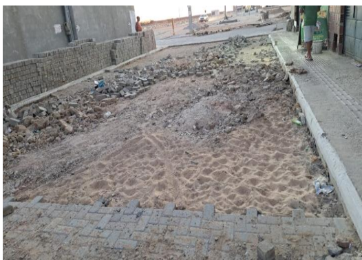
DR HUMBERTO - PAVIMENTAÇÃO EM INTERTRAVADO
