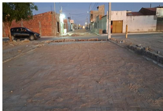
DR HUMBERTO - PAVIMENTAÇÃO EM INTERTRAVADO
