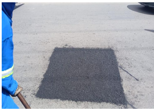
AV RAUL NEVES - APLICAÇÃO DE CBUQ
