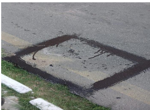
AV RAUL NEVES - APLICAÇÃO DE EMULSÃO
