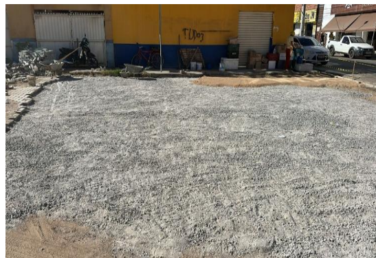
RUA ADOALTO MATOS - APLICAÇÃO DE BGS
