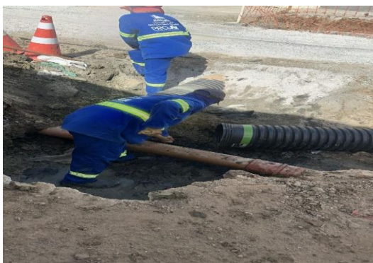
AV PROPRIÁ - EXECUÇÃO DE REDE
