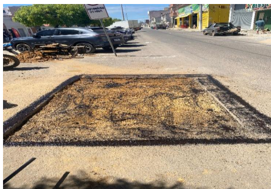
AV PAULO AFONSO - APLICAÇÃO DE EMULSÃO
