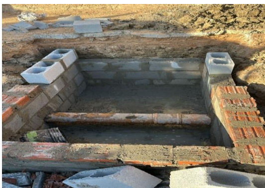
AV PROPRIÁ - EXECUÇÃO DE CAIXA
