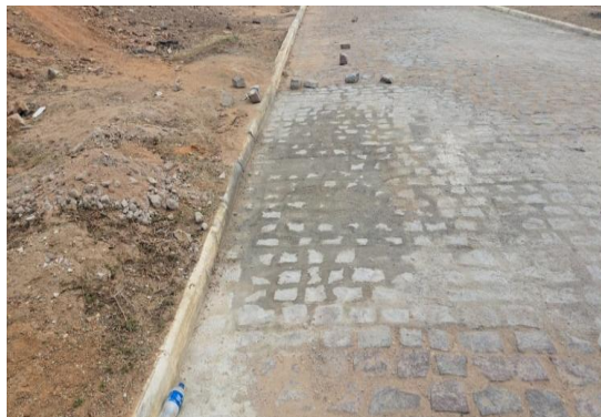
PINHÕES - EXECUÇÃO DE RUA EM PARALELO
