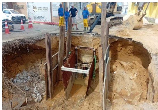
AV ADOLFO VIANA - MANUTENÇÃO DE DRENAGEM
