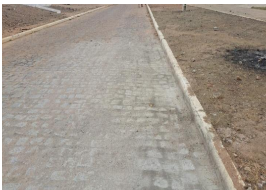
PINHÕES - EXECUÇÃO DE RUA EM PARALELO
