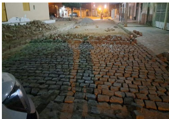
PINHÕES - PAVIMENTAÇÃO DE RUA EM PARALELO
