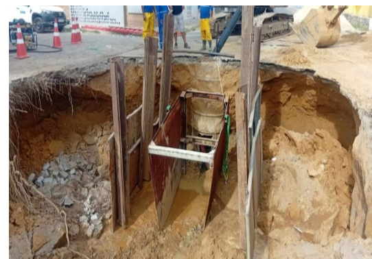
AV ADOLFO VIANA - MANUTENÇÃO DE DRENAGEM
