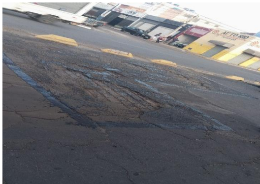
AV SANTOS DUMONT - APLICAÇÃO DE EMULSÃO
