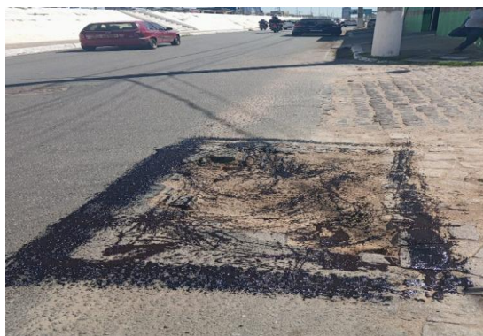
AV SANTOS DUMONT - APLICAÇÃO DE EMULSÃO
