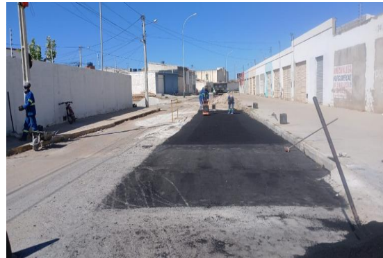
RUA MATATU - APLICAÇÃO DE CBUQ
