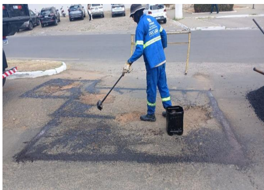
AV RAUL NEVES - APLICAÇÃO DE EMULSÃO
