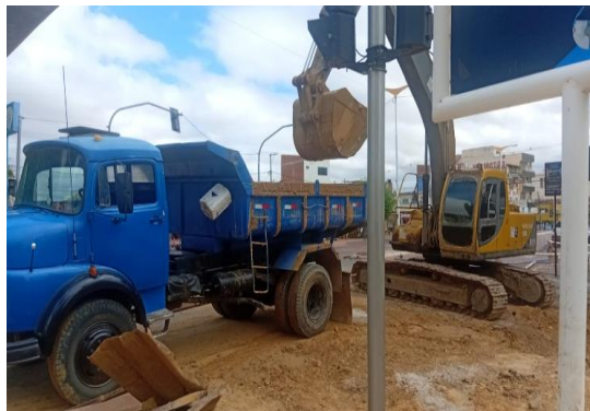
AV ADOLFO VIANA - MANUTENÇÃO DE DRENAGEM
