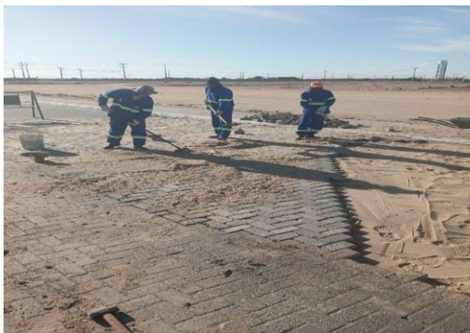
DR HUMBERTO - PAVIMENTAÇÃO EM INTERTRAVADO
