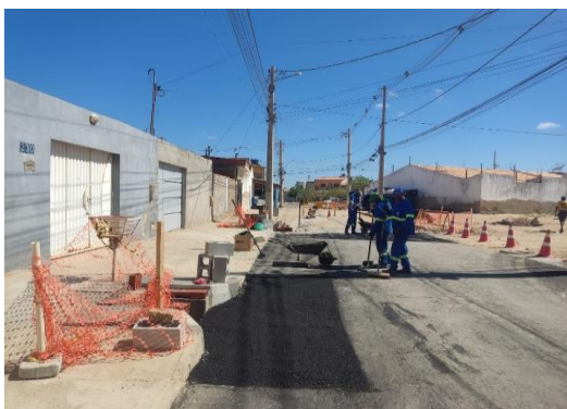
AV PROPRIÁ - APLICAÇÃO DE CBUQ
