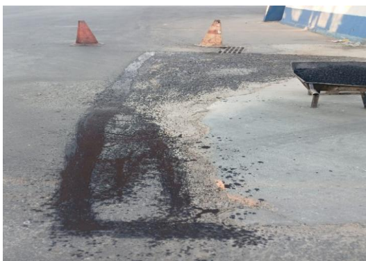
AV RAUL NEVES - APLICAÇÃO DE CBUQ
