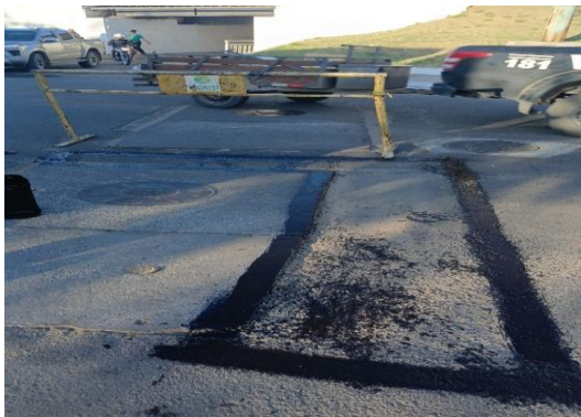
AV RAUL NEVES - APLICAÇÃO DE EMULSÃO
