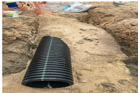
AV PROPRIÁ - ATERRO COM AREIA
