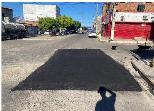
AV PAULO AFONSO - APLICAÇÃO DE CBUQ
