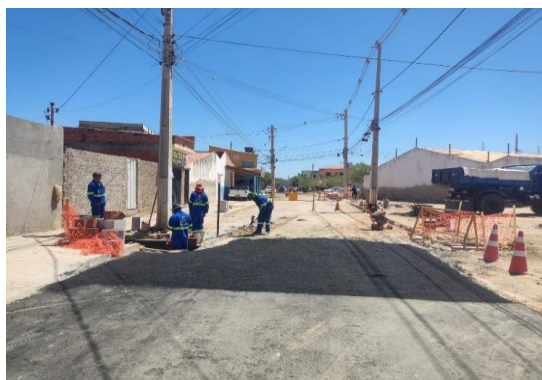
AV PROPRIÁ - APLICAÇÃO DE CBUQ
