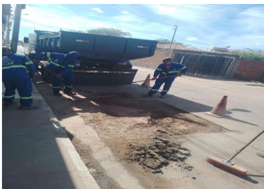
AV PROPRIÁ - APLICAÇÃO DE BGS
