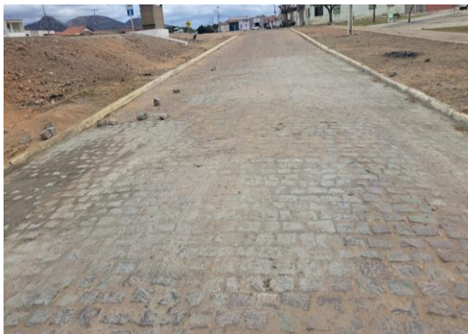
PINHÕES - EXECUÇÃO DE RUA EM PARALELO
