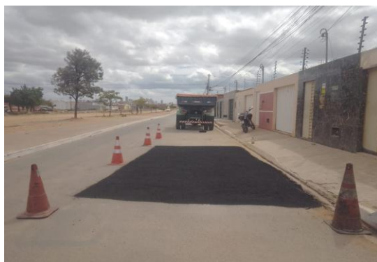
AV PROPRIÁ - APLICAÇÃO DE CBUQ
