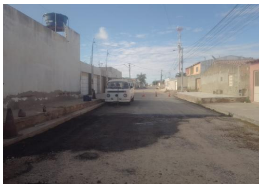
AV PROPRIÁ - APLICAÇÃO DE CBUQ
