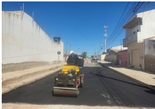
AV PROPRIÁ - ROLO COMPACTADOR
