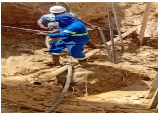
AV ADOLFO VIANA - MICROESTACA DE CONCRETO
