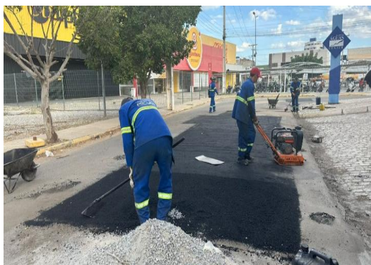
RUA MATATU - APLICAÇÃO DE CBUQ
