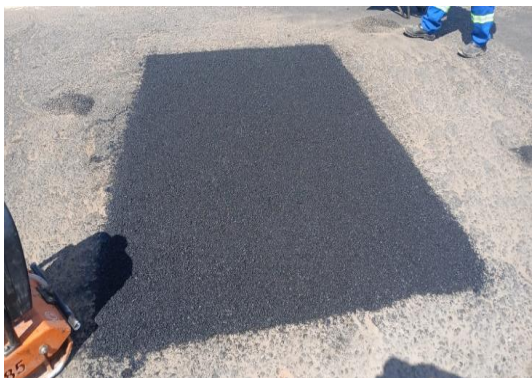
AV RAUL NEVES - APLICAÇÃO DE CBUQ
