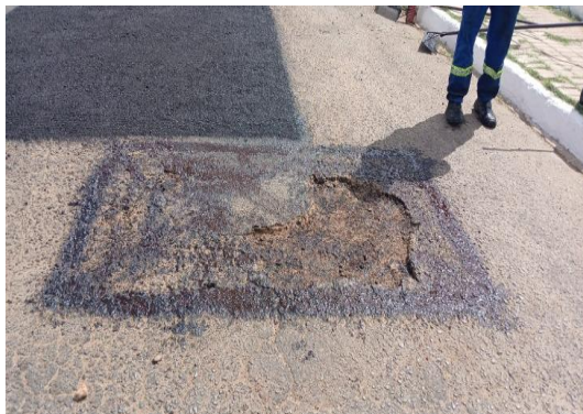
AV RAUL NEVES - PREPARAÇÃO DE TRECHO
