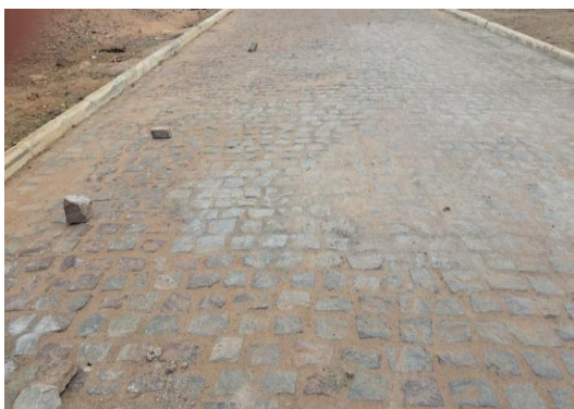
PINHÕES - EXECUÇÃO DE RUA EM PARALELO
