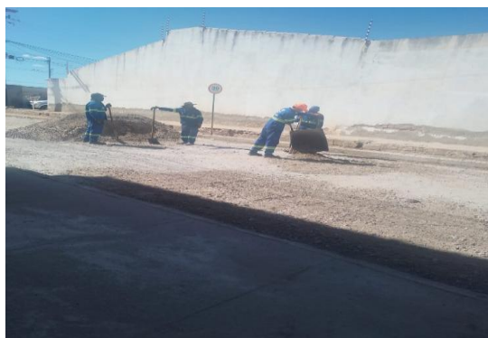
RUA SÃO JOÃO - APLICAÇÃO DE BGS
