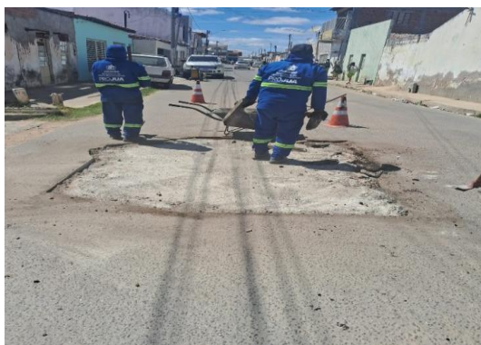
AV JOÃO PAULO II - PREPARAÇÃO DE TRECHO
