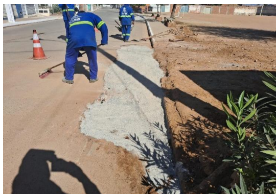
AV ENG MANOEL BORGES - APLICAÇÃO DE BGS
