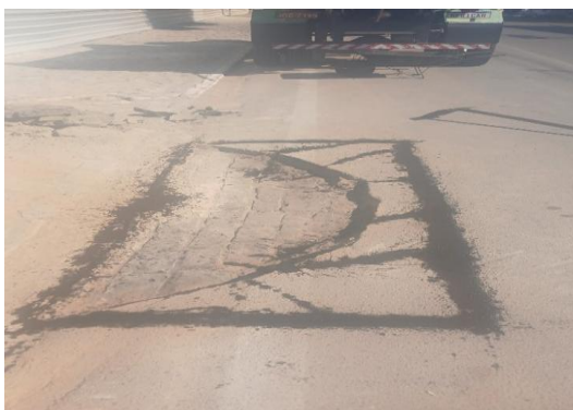
AV SANTOS DUMONT - APLICAÇÃO DE EMULSÃO
