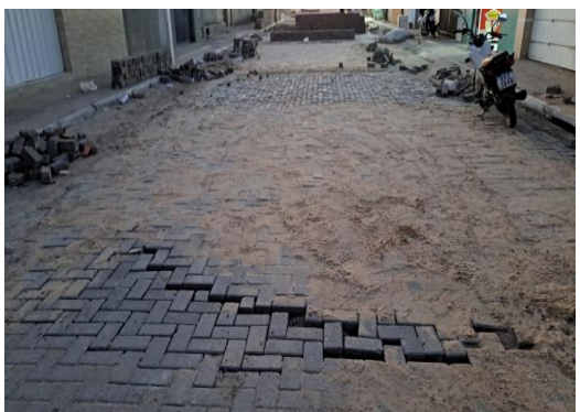
DR HUMBERTO - PAVIMENTAÇÃO EM INTERTRAVADO
