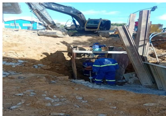
AV ADOLFO VIANA - APLICAÇÃO DE PEDRA
