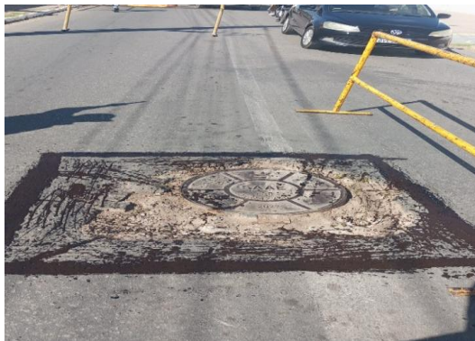
AV SANTOS DUMONT - APLICAÇÃO DE EMULSÃO
