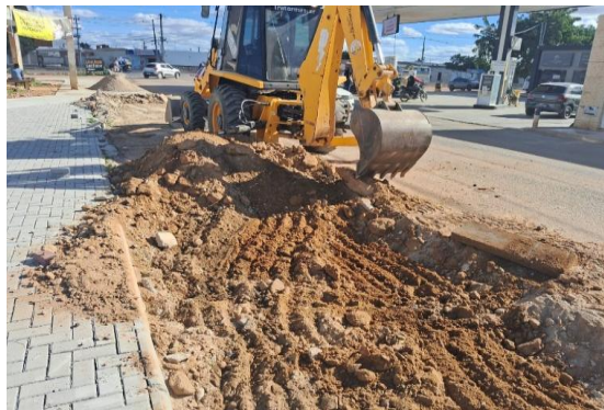
AV CHEFIC KHOURY - ESCAVAÇÃO MECANIZADA
