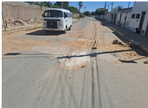
AV JOÃO PAULO II - PREPARAÇÃO DE TRECHO
