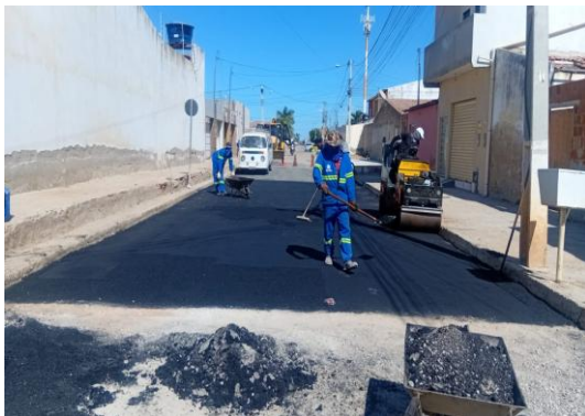
AV PROPRIÁ - ROLO COMPACTADOR
