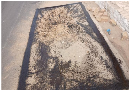
AV PAULO AFONSO - APLICAÇÃO DE EMULSÃO
