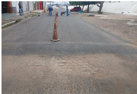
AV SANTOS DUMONT - LIMPEZA DE ÁREA
