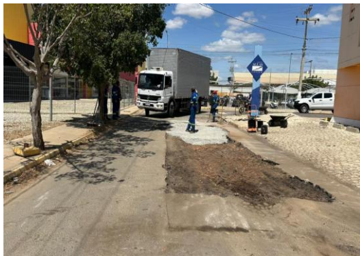
RUA MATATU - CORTE E PREPARAÇÃO DE TRECHO
