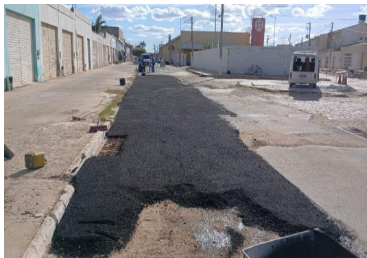
RUA MATATU - APLICAÇÃO DE CBUQ
