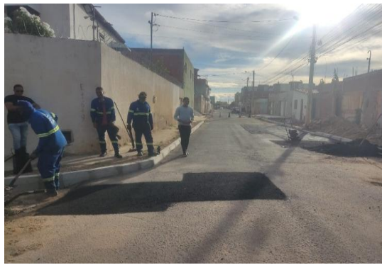
RUA SÃO JOÃO - TAPA BURACO CBUQ
