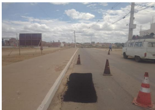
AV PROPRIÁ - APLICAÇÃO DE CBUQ
