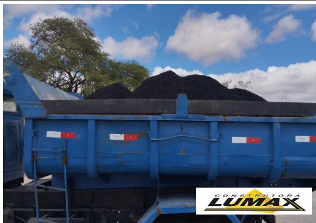
FOTO 06: Usinagem de CBUQ
