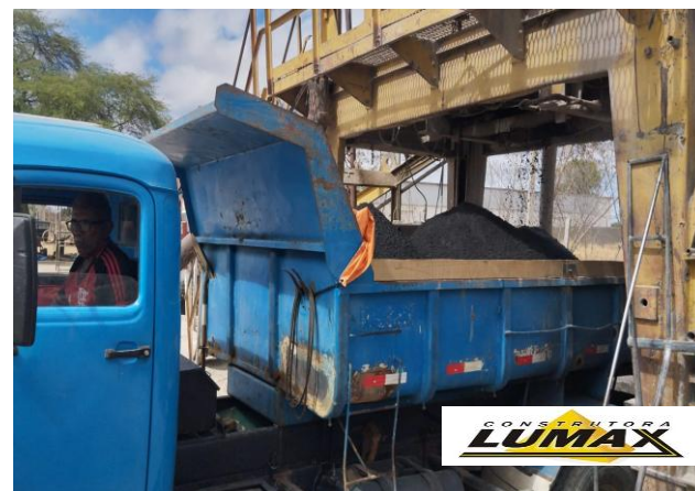
FOTO 04: Usinagem de CBUQ
