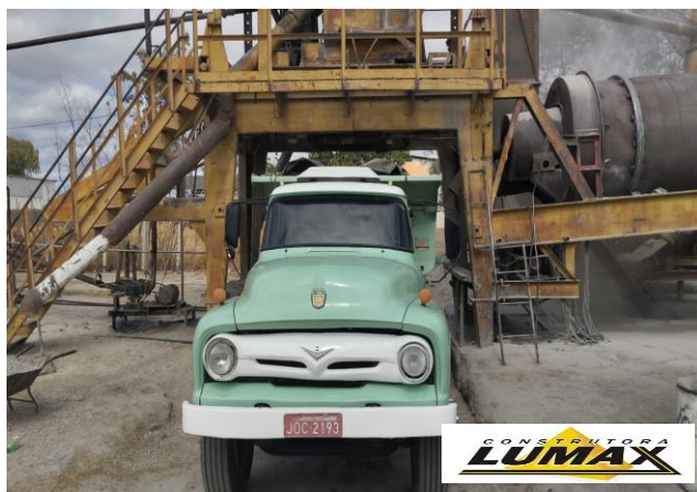
FOTO 01: Usinagem de CBUQ
