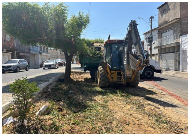
FOTO 10: Carga de Material.
