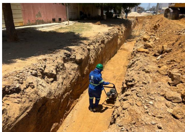
FOTO 02: Regularização e Compactação de Fundo de Vala.
