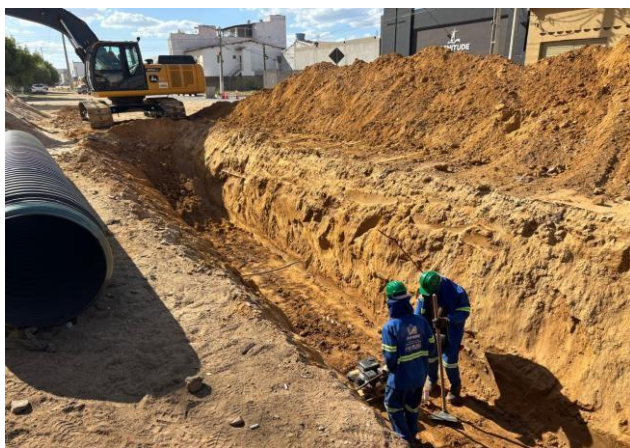
FOTO 01: Regularização e Compactação de Fundo de Vala.
