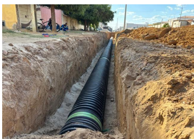
FOTO 04: Assentamento de Tubo PEAD 600mm.
