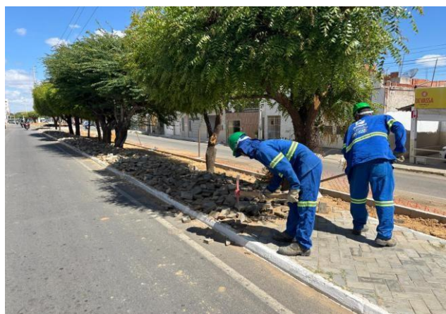
FOTO 09: Remoção de Intertravado.
