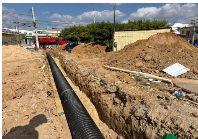
FOTO 05: Assentamento de Tubo PEAD 600mm.
