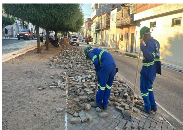
FOTO 08: Remoção de Intertravado.
