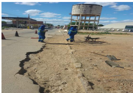
R. PRINCIPAL - APLICAÇÃO DE CBUQ
