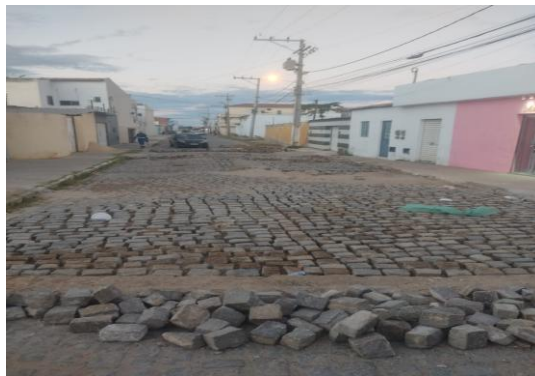
RUA TOBIAS BARRETO - PAVIMENTAÇÃO EM PARALELO
