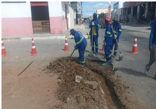
AV SÃO JOÃO - CORTE PARA MEIO FIO
