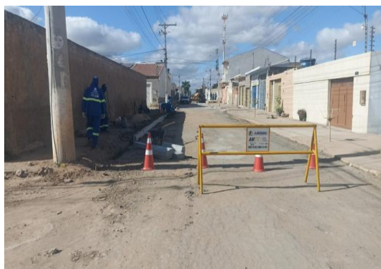
AV PROPRIÁ - ASSENTAMENTO DE MEIO FIO
