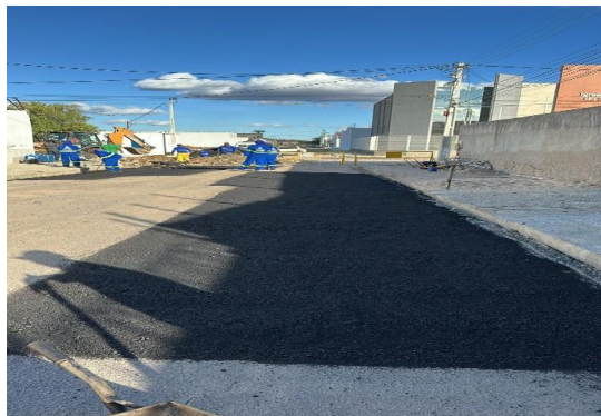
AV PROPRIÁ - APLICAÇÃO DO CBUQ
