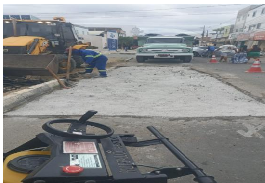
RUA SÃO JOÃO - APLICAÇÃO DE CBUQ
