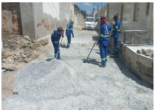
RUA SÃO LUIZ - PAVIMENTAÇÃO EM PARALELO
