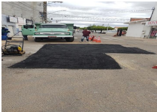
RUA DA CRECHE - APLICAÇÃO DE CBUQ
