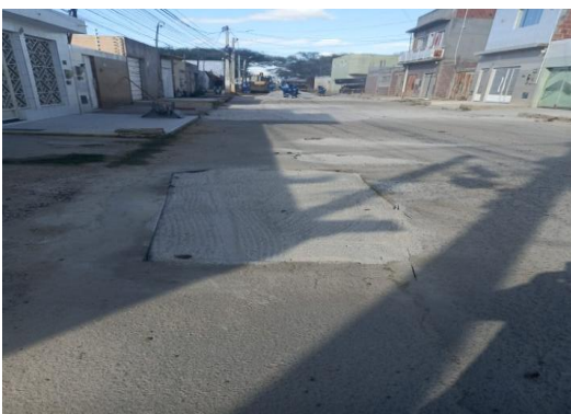
RUA SÃO JOÃO - APLICAÇÃO DE BGS
