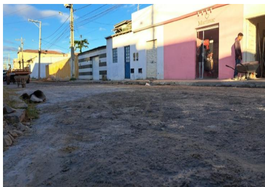
RUA TOBIAS BARRETO - PAVIMENTAÇÃO EM PARALELO
