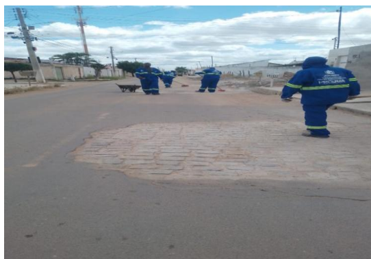
AV PROPRIÁ - LIMPEZA DE ÁREA
