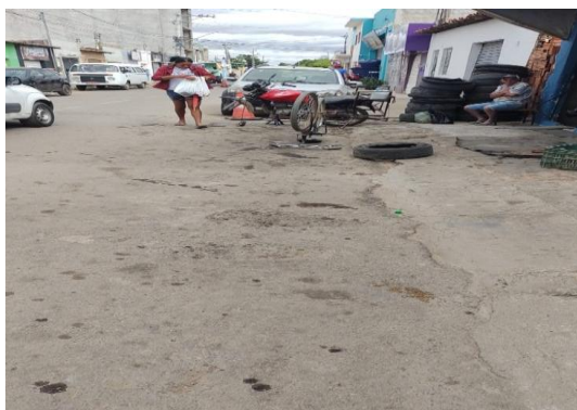
RUA DA CRECHE - CORTE DE ASFALTO
