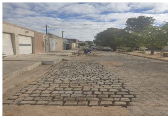
AV BAHIA - PAVIMENTAÇÃO EM PARALELO
