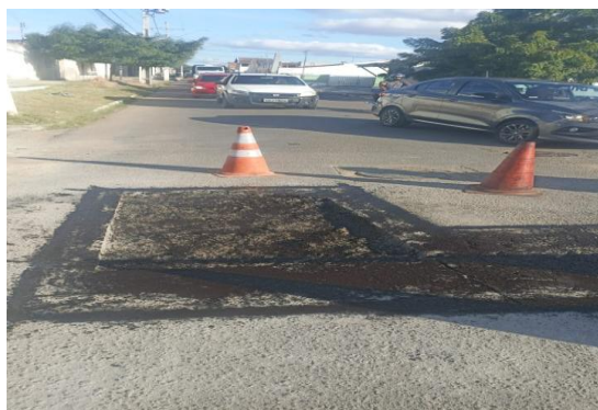
AV AIRTON SENA - PAVIMENTAÇÃO COM CBUQ
