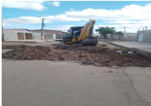
AV PROPRIÁ - ESCAVAÇÃO MECANIZADA
