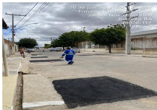
RUA BELA VISTA - APLICAÇÃO DO CBUQ
