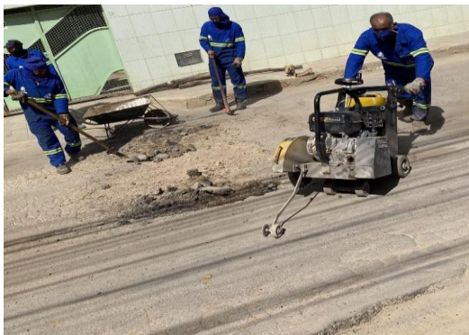
RUA SÃO JOÃO - CORTE DE PAVIMENTO
