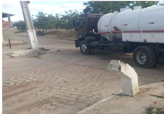
RUA CARDEAL ARCOVERDE - DESOBSTRUÇÃO COM
