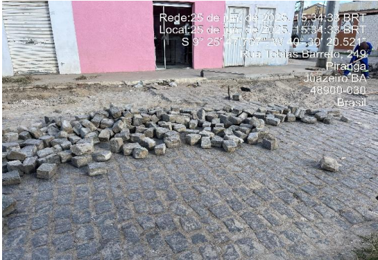
RUA TOBIAS BARRETO - PAVIMENTAÇÃO EM PARALELO
