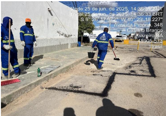
AV PROPRIÁ - IMPRIMAÇÃO COM EMULSÃO ASFAL
