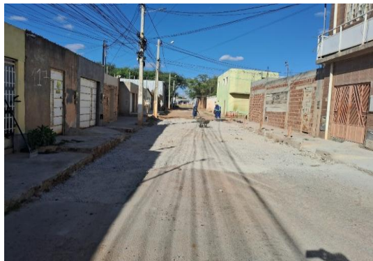
RUA SÃO JOÃO - APLICAÇÃO DE BGS
