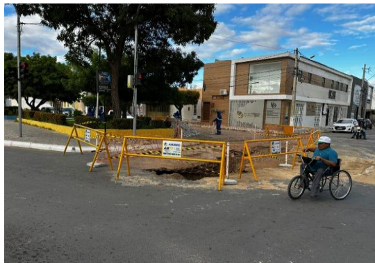
AV ADOLFO VIANA - SERVIÇO DE DRENAGEM
