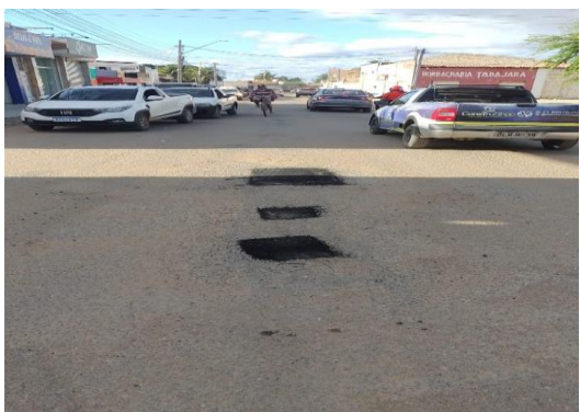
R. PRINCIPAL - APLICAÇÃO DE CBUQ
