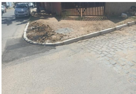
AV SÃO JOÃO - APLICAÇÃO DE MEIO FIO
