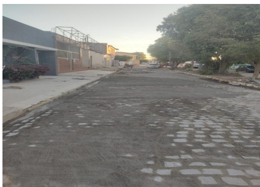
AV BAHIA - PAVIMENTAÇÃO EM PARALELO
