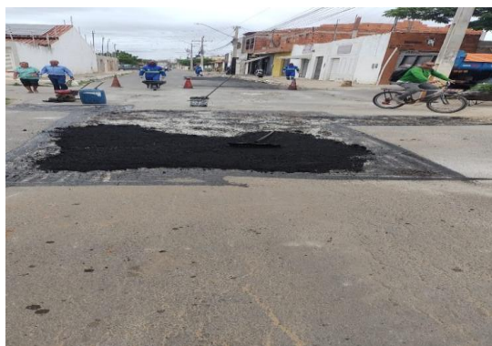
AV AIRTON SENA - PAVIMENTAÇÃO COM CBUQ
