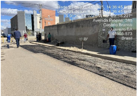
AV PROPRIÁ - IMPRIMAÇÃO COM EMULSÃO ASFAL
