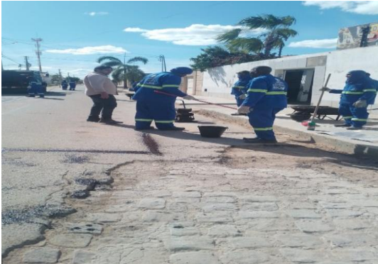
AV PROPRIÁ - IMPRIMAÇÃO COM EMULSÃO ASFAL
