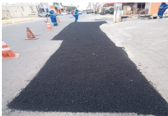
RUA SÃO JOÃO - APLICAÇÃO DE CBUQ
