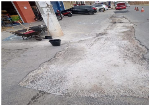
RUA SÃO JOÃO - APLICAÇÃO DE CBUQ
