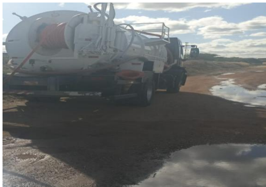
RUA EPITÁCIO PESSOA - DESOBSTRUÇÃO COM SEWER
