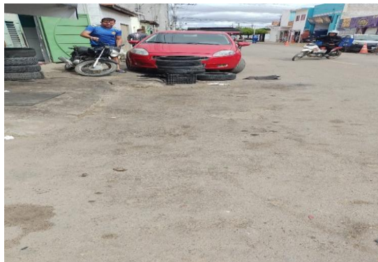
RUA DA CRECHE - CORTE DE ASFALTO
