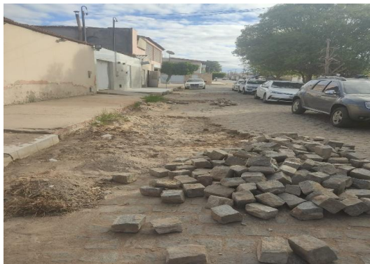
AV BAHIA - PAVIMENTAÇÃO EM PARALELO
