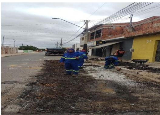
AV AIRTON SENA - DEMOLIÇÃO ASFÁLTICA
