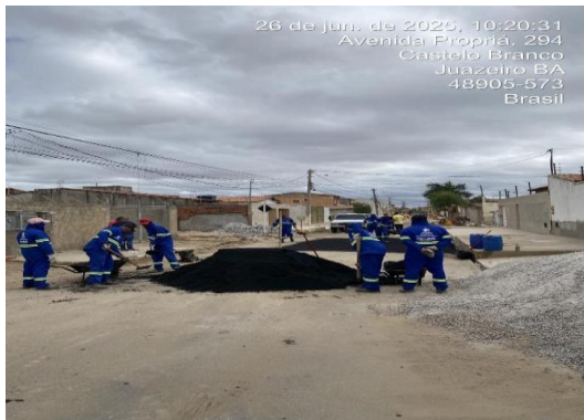
AV PROPRIA - APLICAÇÃO DE CBUQ
