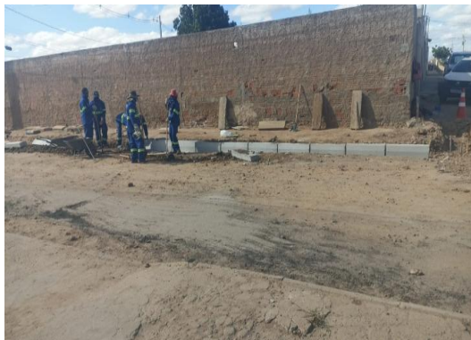
AV PROPRIÁ - ASSENTAMENTO DE MEIO FIO
