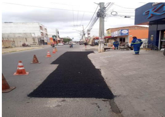
RUA SÃO JOÃO - APLICAÇÃO DE CBUQ
