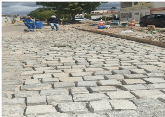
AV BAHIA - PAVIMENTAÇÃO EM PARALELO
