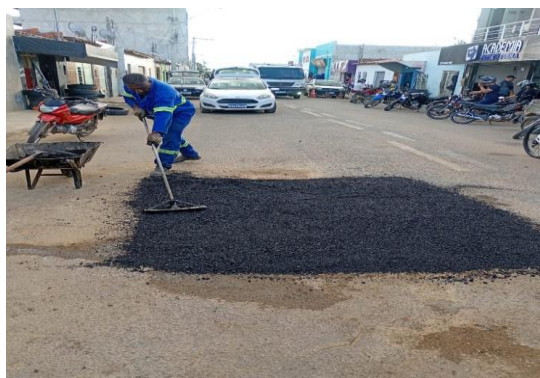
RUA DA CRECHE - APLICAÇÃO DE CBUQ
