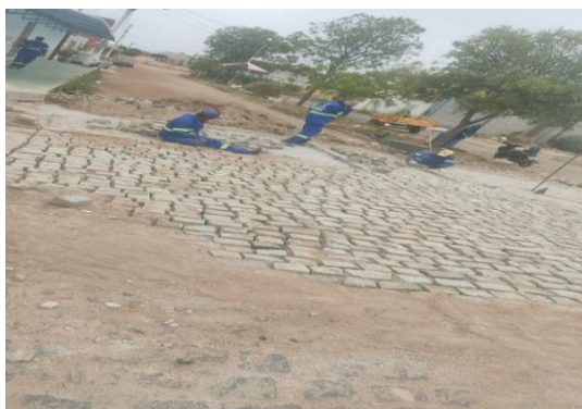
AV BAHIA - PAVIMENTAÇÃO EM PARALELO
