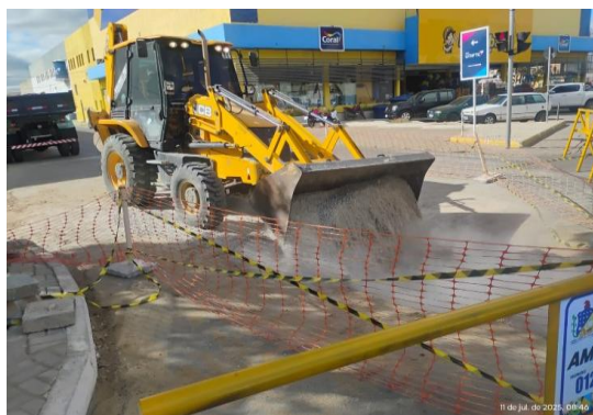
AV ADOLFO VIANA - SERVIÇO DE DRENAGEM
