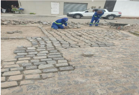
RUA TOBIAS BARRETO - PAVIMENTAÇÃO EM PARALELO
