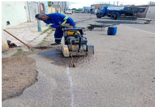
RUA DA CRECHE - CORTE DE ASFALTO
