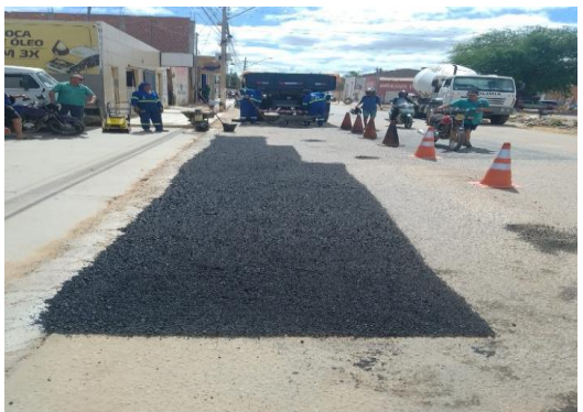
R. PRINCIPAL - APLICAÇÃO DE CBUQ
