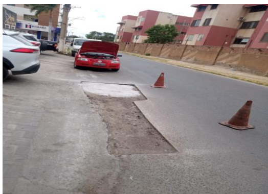
RUA SÃO JOÃO - APLICAÇÃO DE CBUQ
