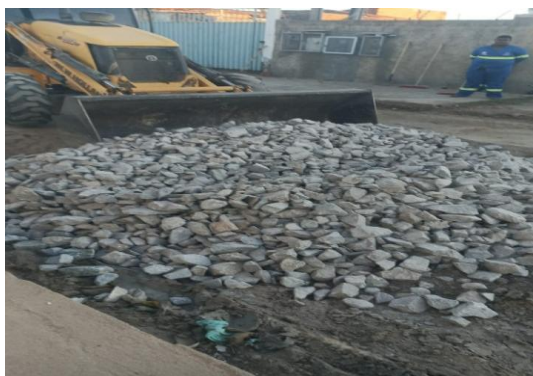
AV PROPRIÁ - REFORÇO DE BASE COM PEDRA
