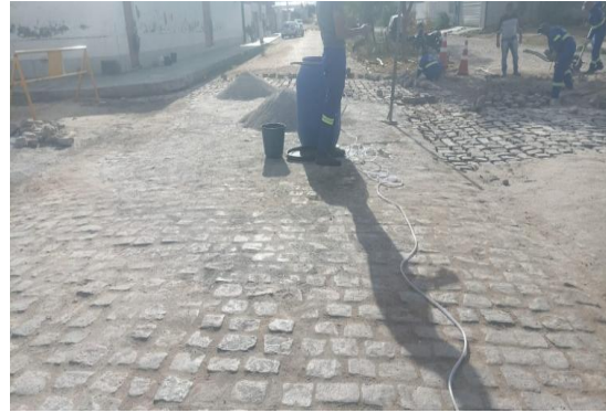
AV BAHIA - PAVIMENTAÇÃO EM PARALELO
