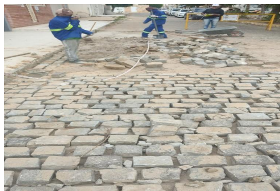
AV BAHIA - PAVIMENTAÇÃO EM PARALELO
