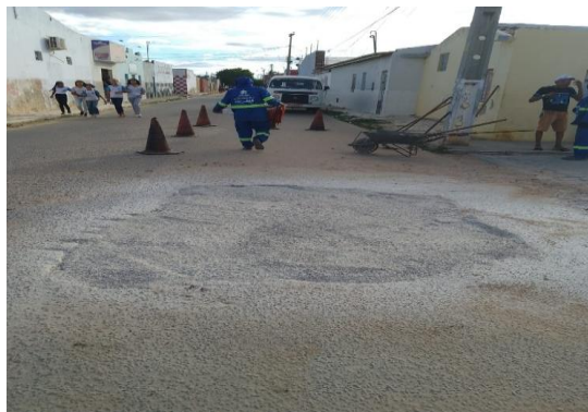
AV SÃO JOÃO - APLICAÇÃO DE BGS
