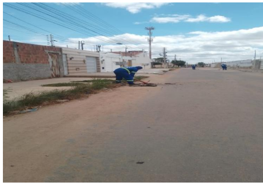
AV PROPRIÁ - DEMOLIÇÃO DE PAV ASFÁLTICO
