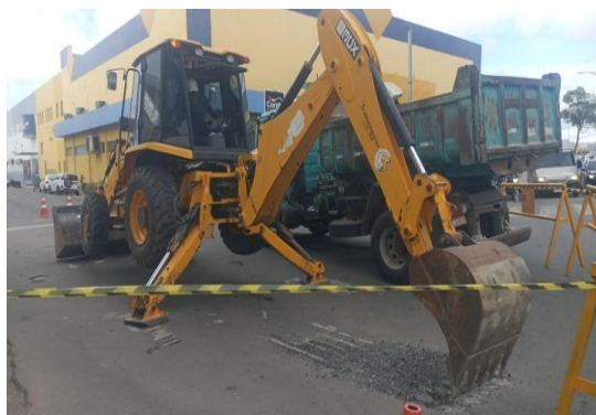
AV ADOLFO VIANA - SERVIÇO DE DRENAGEM
