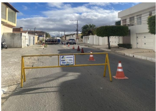
AV SÃO JOÃO - APLICAÇÃO DE BGS
