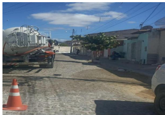
RUA RAUL SEIXAS - DESOBSTRUÇÃO COM SEWER JET
