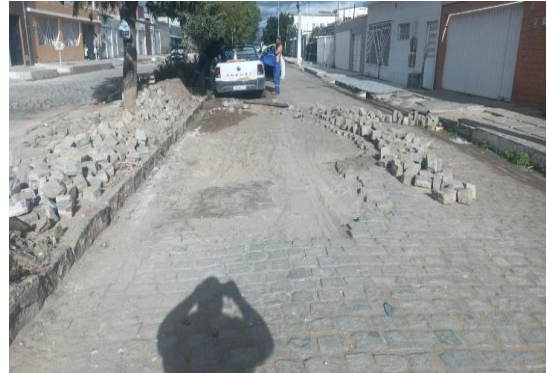
AV BAHIA - PAVIMENTAÇÃO EM PARALELO
