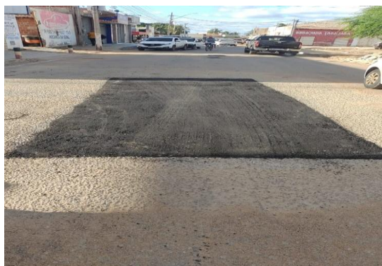
R. PRINCIPAL - APLICAÇÃO DE CBUQ
