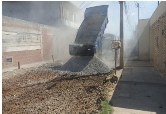
AV SÃO JOÃO - APLICAÇÃO DE BGS
