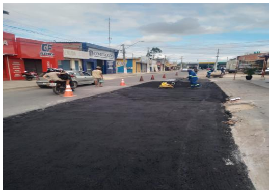
RUA SÃO JOÃO - APLICAÇÃO DE CBUQ
