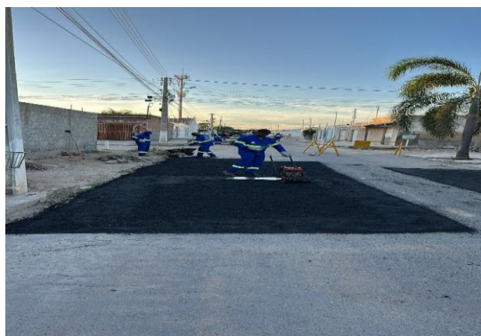
AV PROPRIÁ - APLICAÇÃO DO CBUQ
