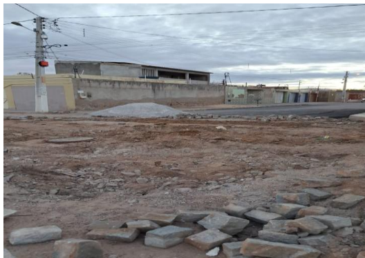
AV BAHIA - PAVIMENTAÇÃO EM PARALELO
