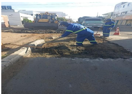
AV AIRTON SENA - PAVIMENTAÇÃO COM CBUQ
