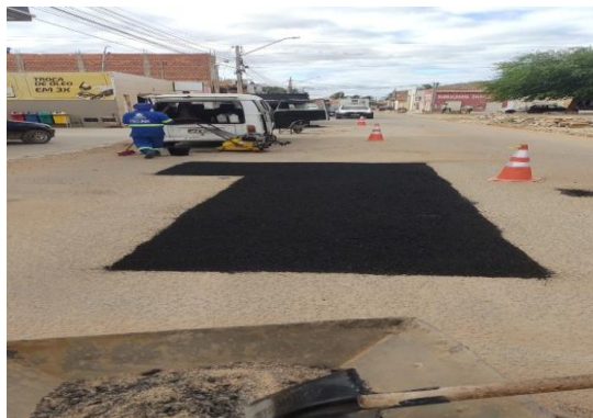
R. PRINCIPAL - APLICAÇÃO DE CBUQ
