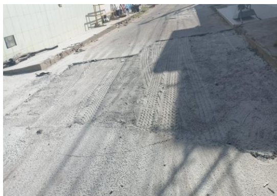
RUA SÃO JOÃO - APLICAÇÃO DE BGS
