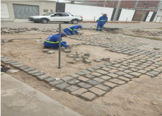
RUA TOBIAS BARRETO - PAVIMENTAÇÃO EM PARALELO
