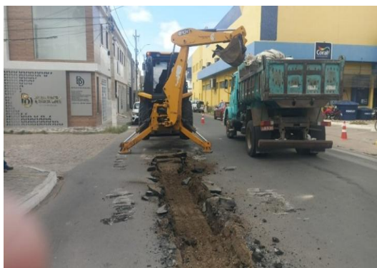
AV ADOLFO VIANA - SERVIÇO DE DRENAGEM
