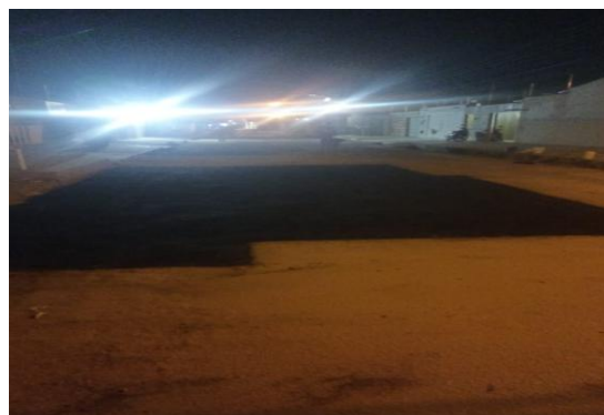
AV PROPRIÁ - APLICAÇÃO DO CBUQ
