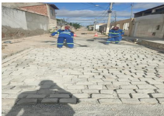
RUA SÃO LUIZ - PAVIMENTAÇÃO EM PARALELO
