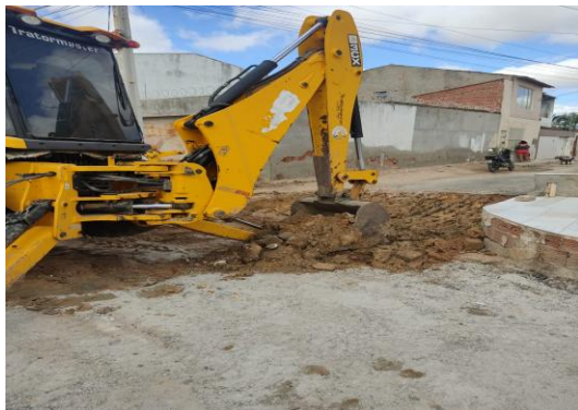
RUA SÃO LUIZ - ESCAVAÇÃO MECANIZADA
