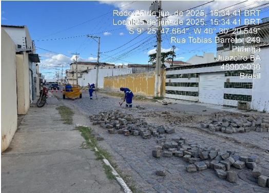
RUA TOBIAS BARRETO - PAVIMENTAÇÃO EM PARALELO
