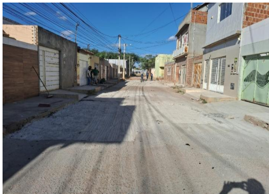
RUA SÃO JOÃO - CORTE DE PAVIMENTO
