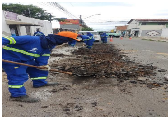
AV AIRTON SENA - DEMOLIÇÃO ASFÁLTICA
