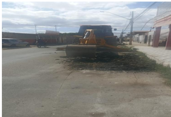
AV AIRTON SENA - PAVIMENTAÇÃO COM CBUQ
