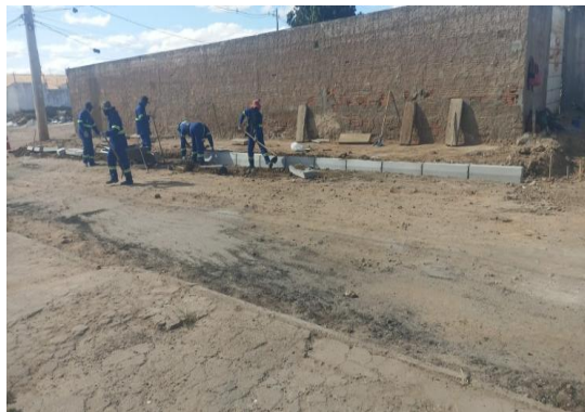
AV PROPRIÁ - ASSENTAMENTO DE MEIO FIO
