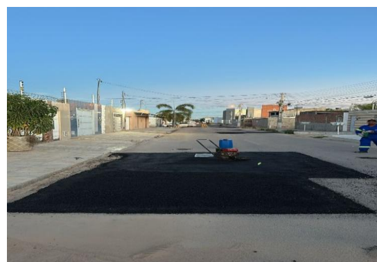
AV PROPRIÁ - APLICAÇÃO DO CBUQ
