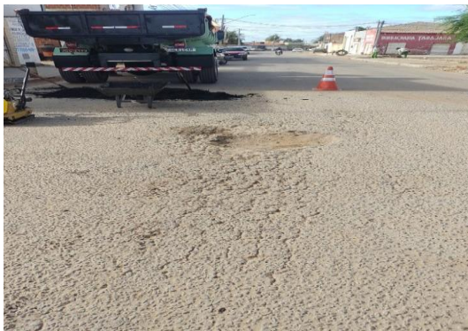
R. PRINCIPAL - APLICAÇÃO DE CBUQ
