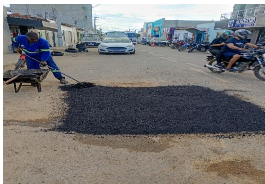
AV AIRTON SENA - DEMOLIÇÃO ASFÁLTICA
