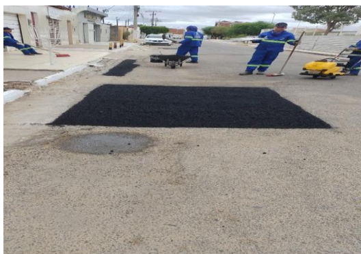
RUA BELA VISTA - APLICAÇÃO DE CBUQ
