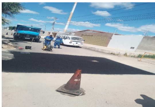
RUA PROPRIÁ - APLICAÇÃO DE CBUQ
