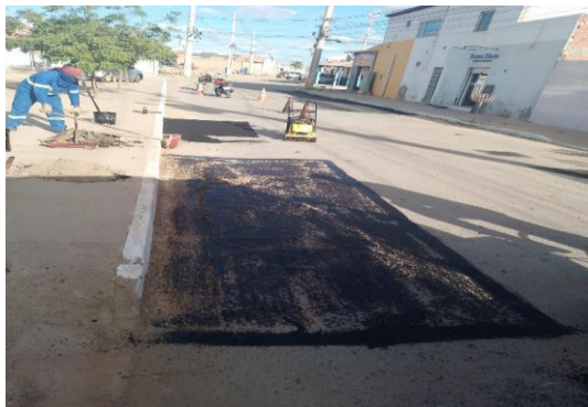
RUA PROPRIÁ - APLICAÇÃO DE CBUQ
