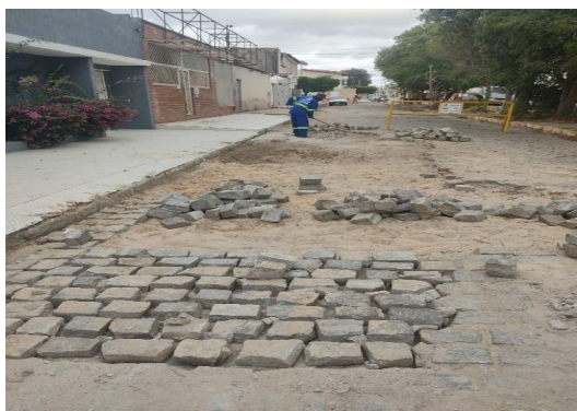
AV BAHIA - PAVIMENTAÇÃO EM PARALELO
