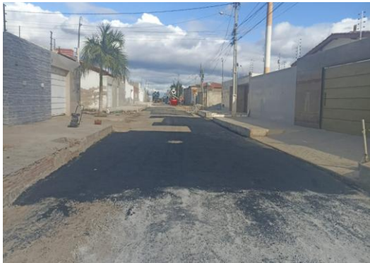
AV PROPRIÁ - APLICAÇÃO DO CBUQ
