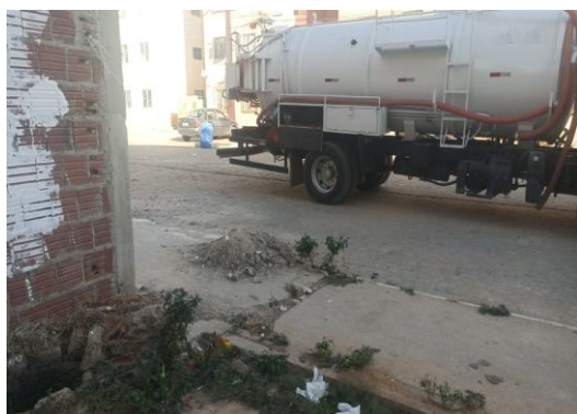
RUA DOS LIMOEIROS - DESOBSTRUÇÃO COM SEWER
