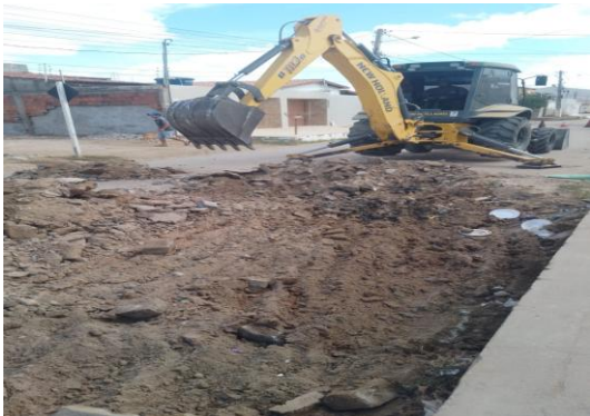
AV PROPRIÁ - ESCAVAÇÃO MECANIZADA
