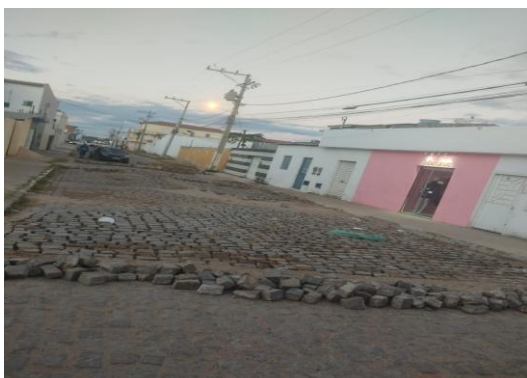
RUA TOBIAS BARRETO - PAVIMENTAÇÃO EM PARALELO
