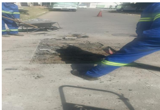
AV AIRTON SENA - PAVIMENTAÇÃO COM CBUQ
