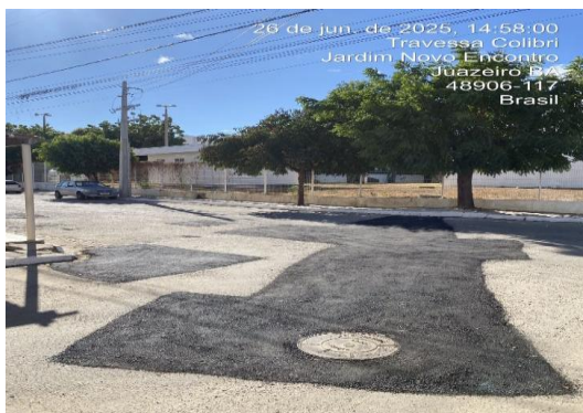
RUA BELA VISTA - APLICAÇÃO DO CBUQ
