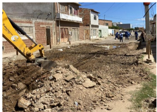
RUA SÃO JOÃO - ESCAVAÇÃO MECANIZADA
