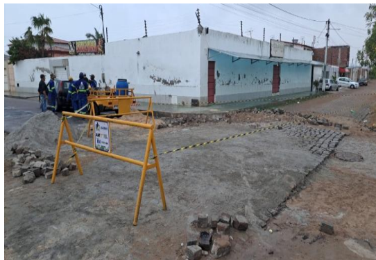
AV BAHIA - PAVIMENTAÇÃO EM PARALELO
