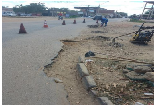
R. PRINCIPAL - APLICAÇÃO DE CBUQ
