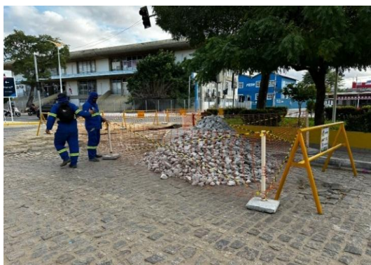
AV ADOLFO VIANA - SERVIÇO DE DRENAGEM
