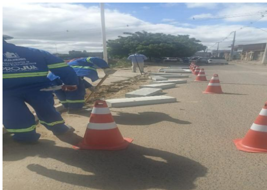
AV LUIZ INACIO - APLICAÇÃO DE MEIO FIO
