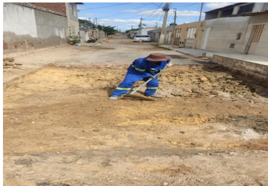
RUA SÃO LUIZ - ESCAVAÇÃO MECANIZADA
