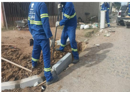
AV SÃO JOÃO - APLICAÇÃO DE MEIO FIO
