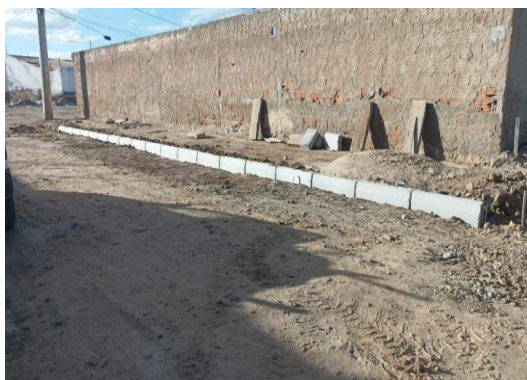
AV PROPRIÁ - ASSENTAMENTO DE MEIO FIO
