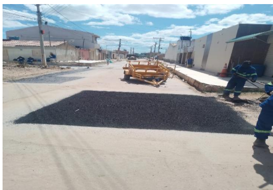
RUA PROPRIÁ - APLICAÇÃO DE CBUQ
