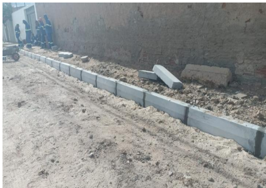
AV PROPRIÁ - ASSENTAMENTO DE MEIO FIO
