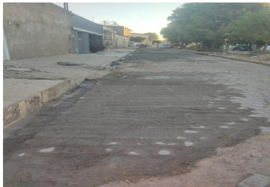
AV BAHIA - PAVIMENTAÇÃO EM PARALELO
