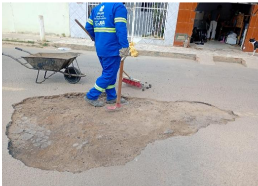
RUA DA CRECHE - CORTE DE ASFALTO
