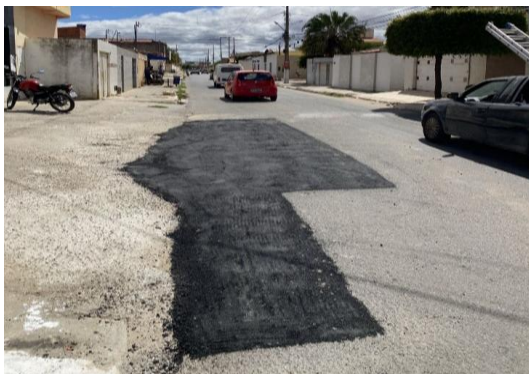
AV SÃO JOÃO - APLICAÇÃO DE ASFALTO
