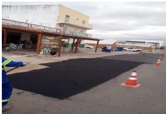
RUA SÃO JOÃO - APLICAÇÃO DE CBUQ
