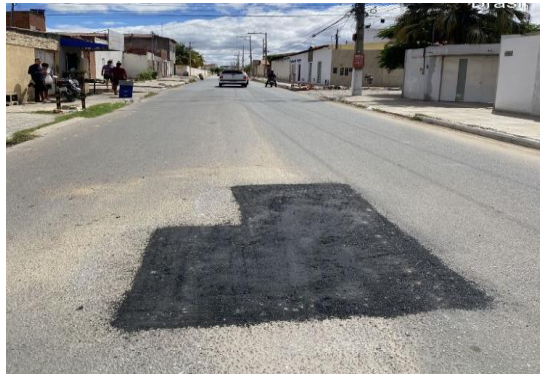
AV SÃO JOÃO - APLICAÇÃO DE ASFALTO
