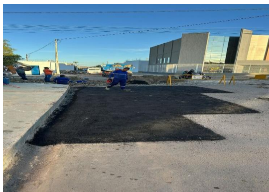
AV PROPRIÁ - APLICAÇÃO DO CBUQ
