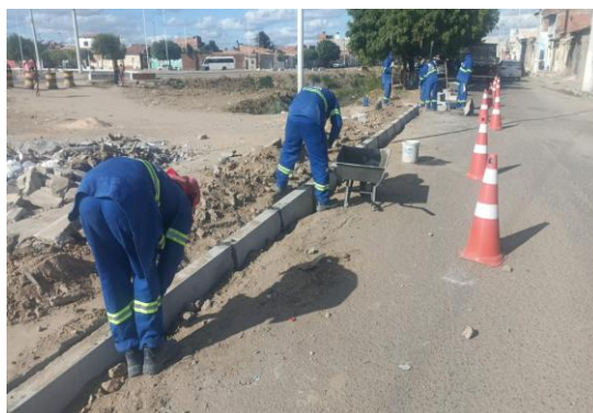
AV LUIZ INACIO - APLICAÇÃO DE MEIO FIO
