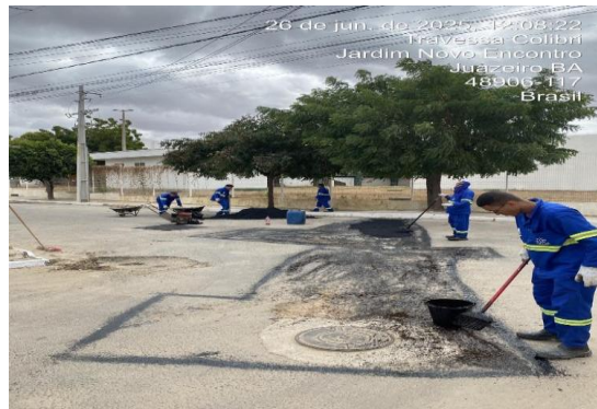
RUA BELA VISTA - APLICAÇÃO DO CBUQ
