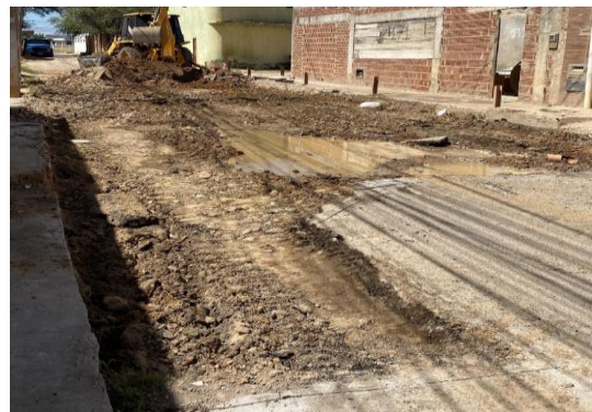
RUA SÃO JOÃO - ESCAVAÇÃO MECANIZADA
