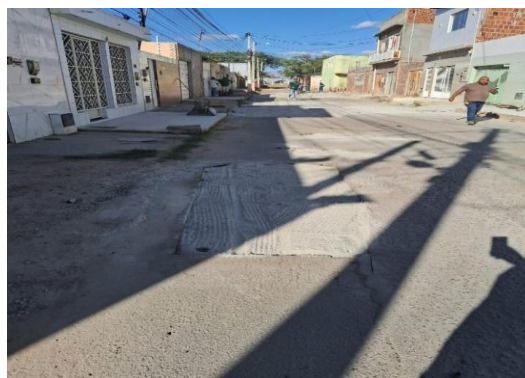
RUA SÃO JOÃO - APLICAÇÃO DE BGS
