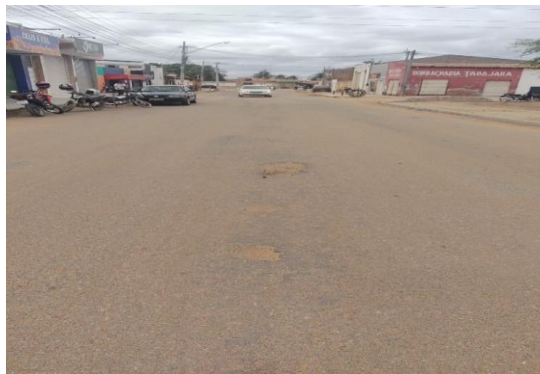
R. PRINCIPAL - APLICAÇÃO DE CBUQ
