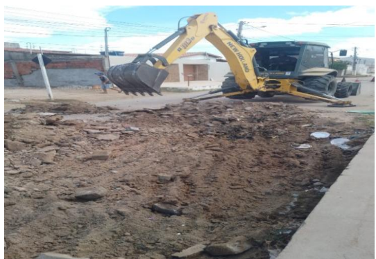
AV PROPRIÁ - ESCAVAÇÃO MECANIZADA
