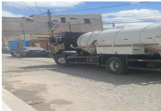
RUA JOÃO FERREIRA - DESOBSTRUÇÃO COM SEWER JET
