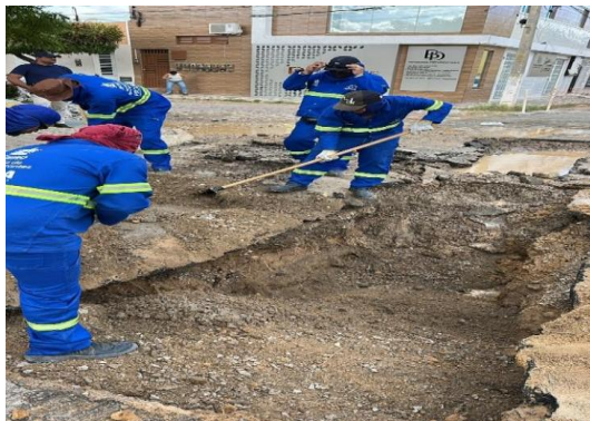
AV ADOLFO VIANA - SERVIÇO DE DRENAGEM
