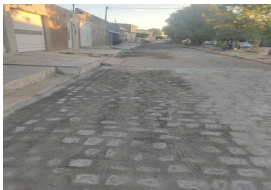
AV BAHIA - PAVIMENTAÇÃO EM PARALELO
