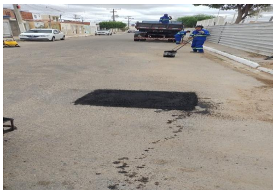
RUA BELA VISTA - APLICAÇÃO DE CBUQ
