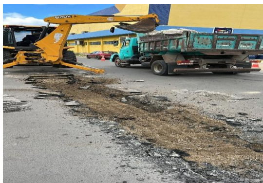
AV ADOLFO VIANA - SERVIÇO DE DRENAGEM
