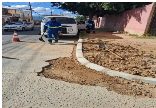
AV SÃO JOÃO - APLICAÇÃO DE MEIO FIO
