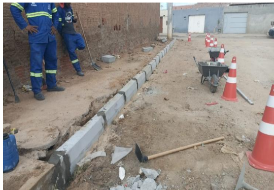
AV PROPRIÁ - ASSENTAMENTO DE MEIO FIO
