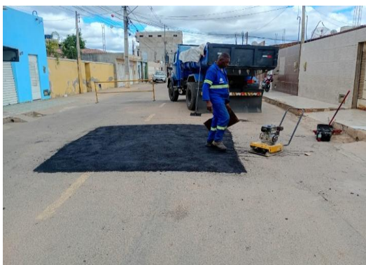
RUA DA CRECHE - APLICAÇÃO DE CBUQ
