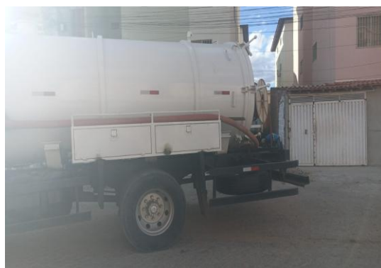
RUA DOS LIMOEIROS - DESOBSTRUÇÃO COM SEWER
