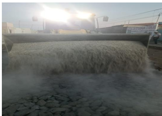
AV PROPRIÁ - APLICAÇÃO DE BGS
