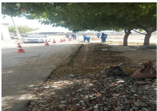
AV LUIZ INACIO - APLICAÇÃO DE MEIO FIO
