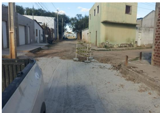
RUA SÃO JOÃO - APLICAÇÃO DE BGS
