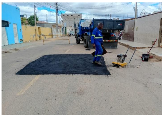
AV AIRTON SENA - DEMOLIÇÃO ASFÁLTICA
