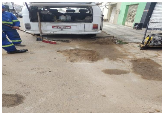
RUA DA CRECHE - CORTE DE ASFALTO
