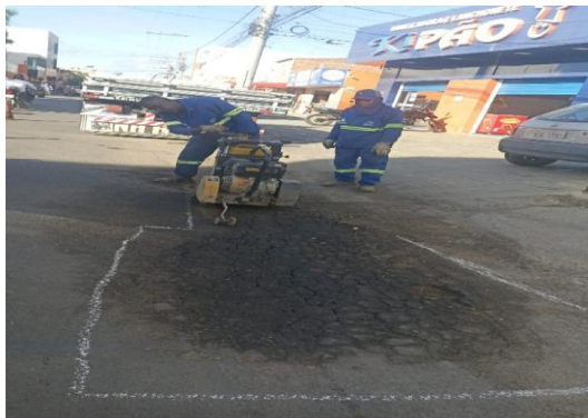
AV AIRTON SENA - DEMOLIÇÃO ASFÁLTICA
