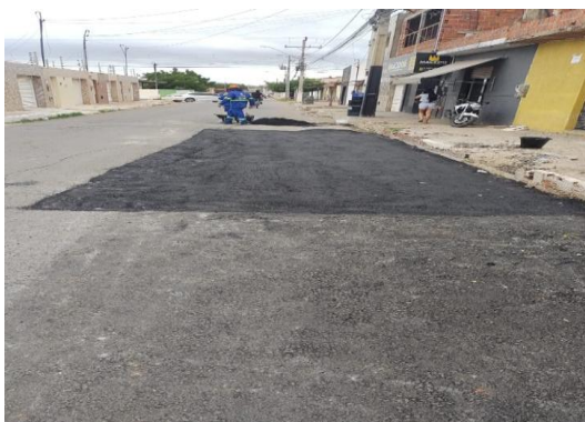
AV AIRTON SENA - PAVIMENTAÇÃO COM CBUQ
