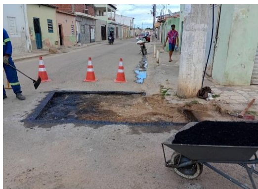
RUA DA CRECHE - APLICAÇÃO DE CBUQ
