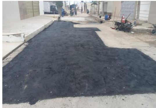
AV PROPRIÁ - APLICAÇÃO DO CBUQ
