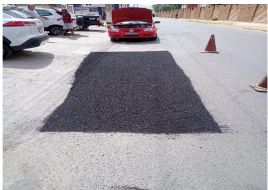
RUA SÃO JOÃO - APLICAÇÃO DE CBUQ
