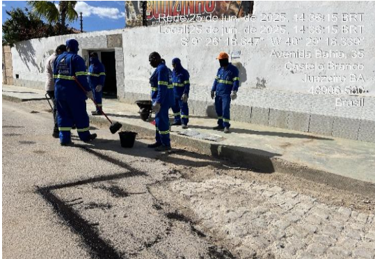
AV PROPRIÁ - IMPRIMAÇÃO COM EMULSÃO ASFAL
