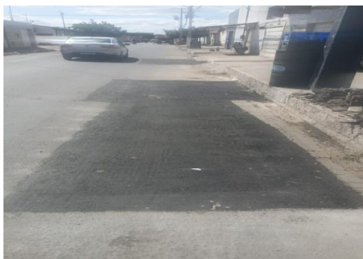
AV AIRTON SENA - PAVIMENTAÇÃO COM CBUQ
