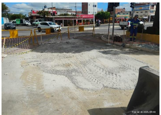
AV ADOLFO VIANA - SERVIÇO DE DRENAGEM
