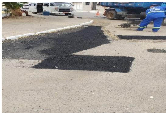
RUA BELA VISTA - APLICAÇÃO DE CBUQ
