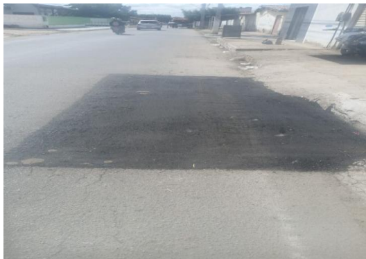
AV AIRTON SENA - PAVIMENTAÇÃO COM CBUQ
