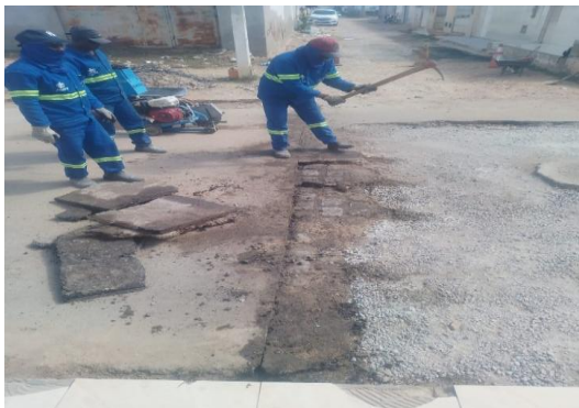
AV PROPRIÁ - CORTE DE PAVIMENTO
