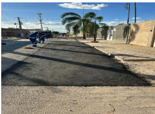
AV PROPRIÁ - APLICAÇÃO DO CBUQ
