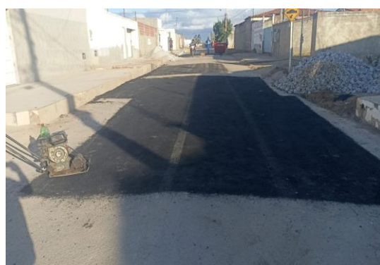
AV PROPRIÁ - APLICAÇÃO DO CBUQ
