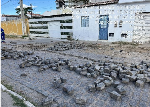
RUA TOBIAS BARRETO - PAVIMENTAÇÃO EM PARALELO
