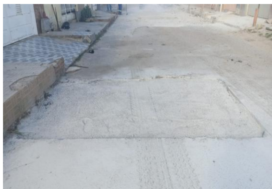
RUA SÃO JOÃO - APLICAÇÃO DE BGS
