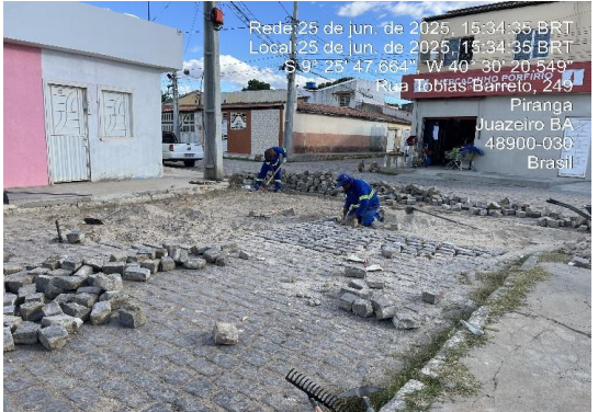
RUA TOBIAS BARRETO - PAVIMENTAÇÃO EM PARALELO
