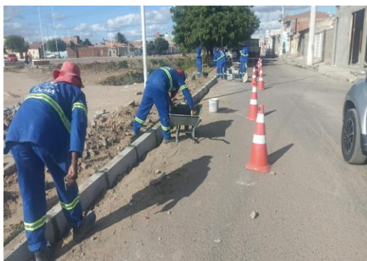
AV LUIZ INACIO - APLICAÇÃO DE MEIO FIO
