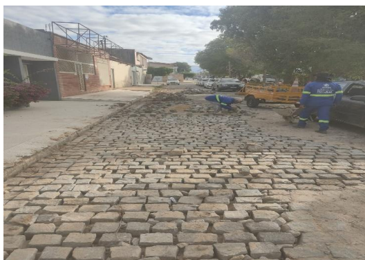
AV BAHIA - PAVIMENTAÇÃO EM PARALELO
