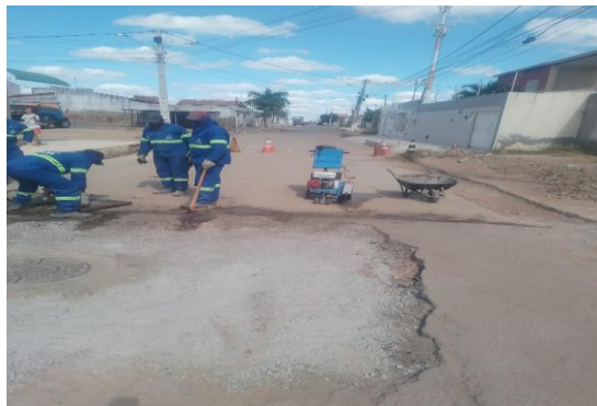
AV PROPRIÁ - CORTE DE PAVIMENTO
