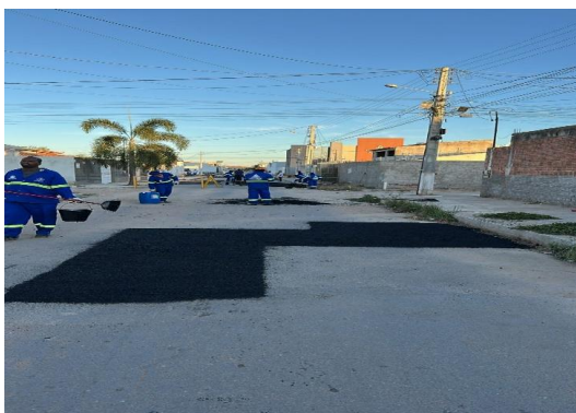
AV PROPRIÁ - APLICAÇÃO DO CBUQ
