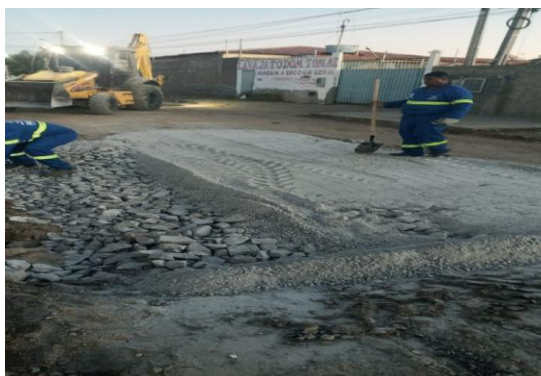
AV PROPRIÁ - APLICAÇÃO DE BGS
