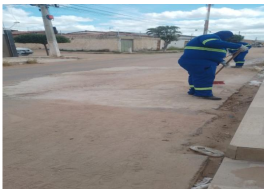
AV PROPRIÁ - LIMPEZA DE ÁREA
