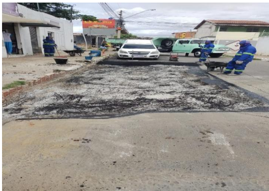
AV AIRTON SENA - DEMOLIÇÃO ASFÁLTICA
