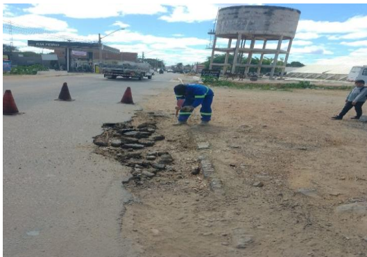
R. PRINCIPAL - APLICAÇÃO DE CBUQ
