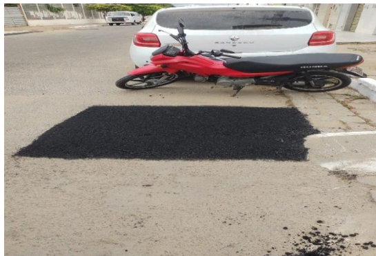
RUA BELA VISTA - APLICAÇÃO DE CBUQ
