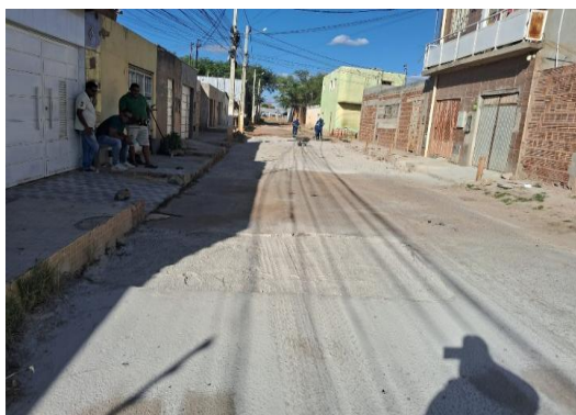
RUA SÃO JOÃO - APLICAÇÃO DE BGS
