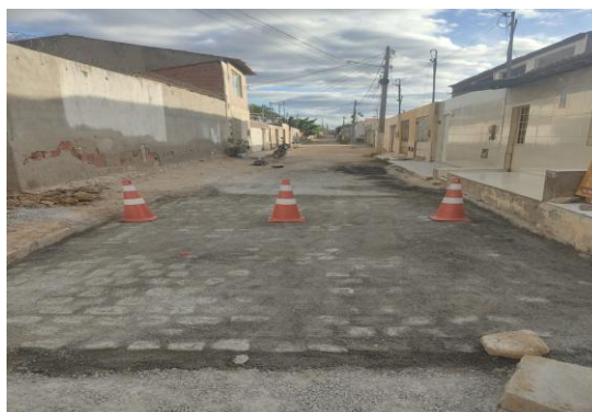
RUA SÃO LUIZ - PAVIMENTAÇÃO EM PARALELO
