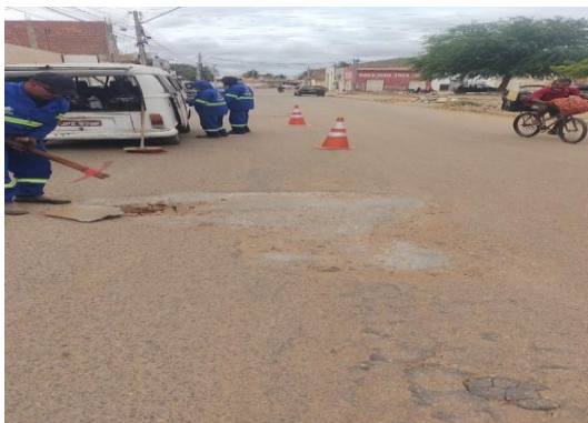
R. PRINCIPAL - APLICAÇÃO DE CBUQ
