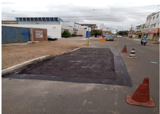
RUA SÃO JOÃO - APLICAÇÃO DE CBUQ
