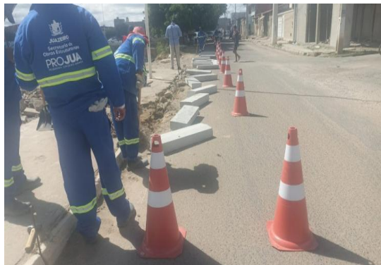
AV LUIZ INÁCIO - APLICAÇÃO DE MEIO FIO
