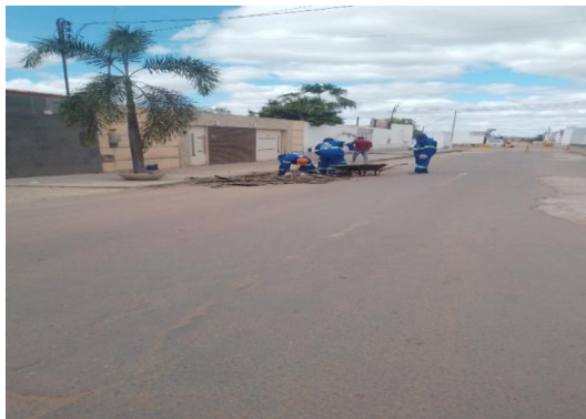
AV PROPRIÁ - DEMOLIÇÃO DE PAV ASFÁLTICO
