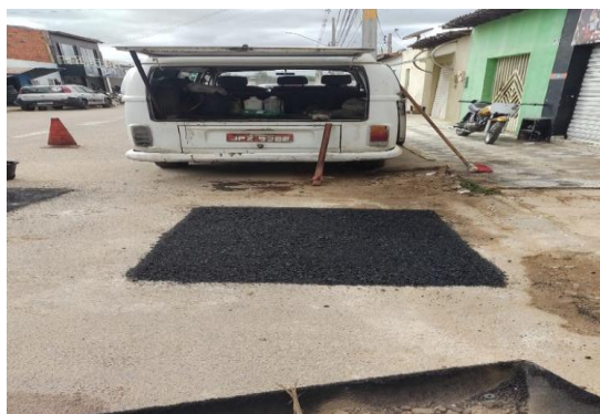
RUA DA CRECHE - APLICAÇÃO DE CBUQ
