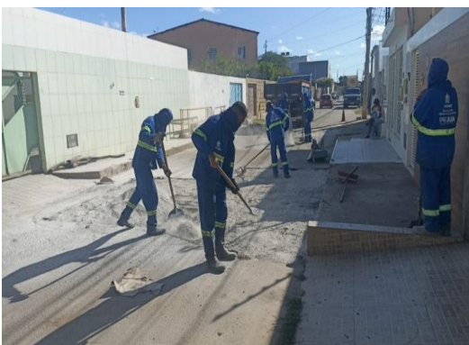
RUA SÃO JOÃO - APLICAÇÃO DE BGS
