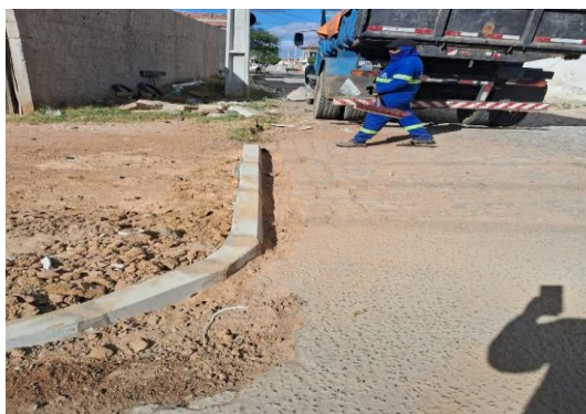
AV SÃO JOÃO - APLICAÇÃO DE MEIO FIO
