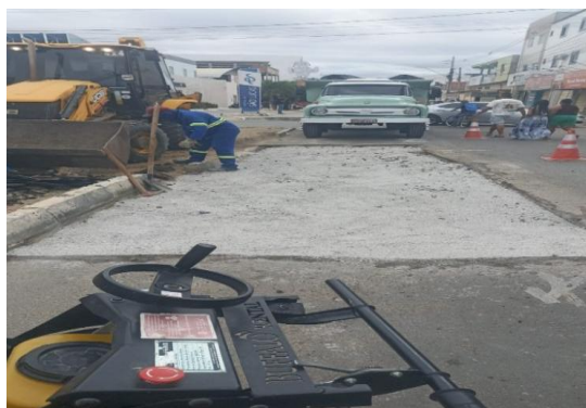
AV AIRTON SENA - PAVIMENTAÇÃO COM CBUQ
