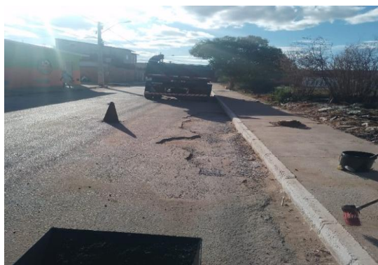
RUA PROPRIÁ - APLICAÇÃO DE CBUQ
