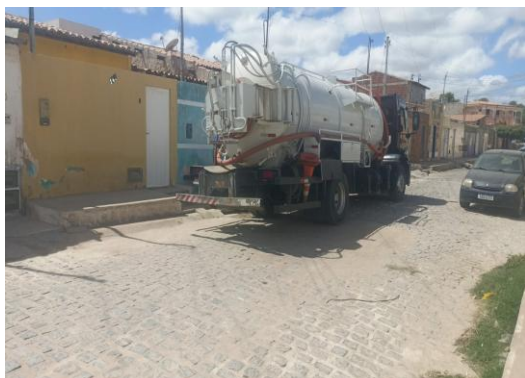
RUA JOB MARQUES - DESOBSTRUÇÃO COM SEWER
