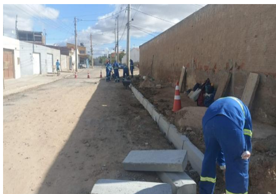
AV PROPRIÁ - ASSENTAMENTO DE MEIO FIO
