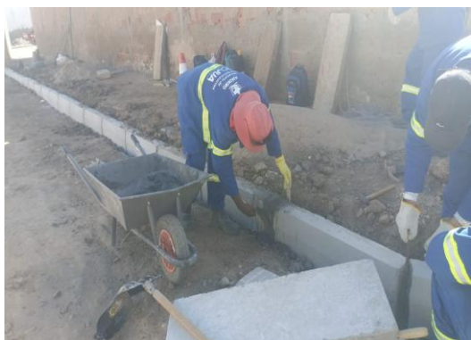
AV PROPRIÁ - ASSENTAMENTO DE MEIO FIO
