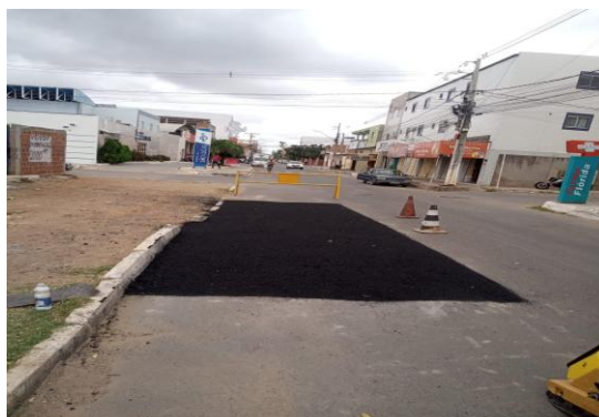
RUA SÃO JOÃO - APLICAÇÃO DE CBUQ
