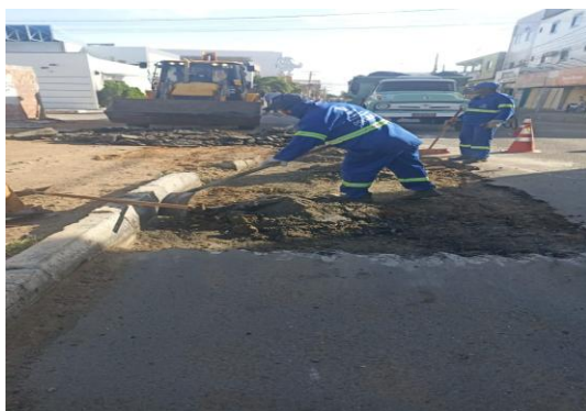
RUA SÃO JOÃO - APLICAÇÃO DE CBUQ
