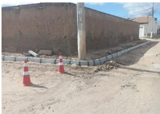
AV PROPRIÁ - ASSENTAMENTO DE MEIO FIO
