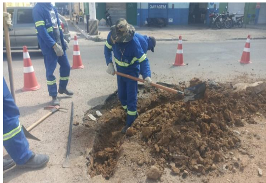
AV SÃO JOÃO - CORTE PARA MEIO FIO
