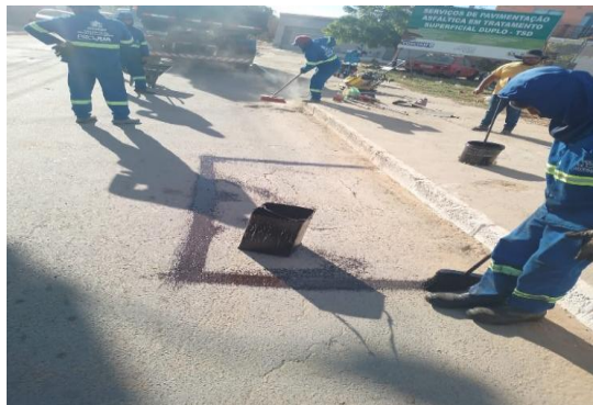
RUA PROPRIÁ - APLICAÇÃO DE CBUQ
