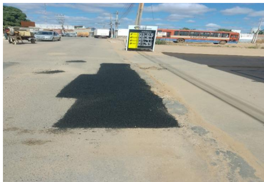
R. PRINCIPAL - APLICAÇÃO DE CBUQ
