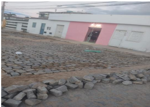
RUA TOBIAS BARRETO - PAVIMENTAÇÃO EM PARALELO
