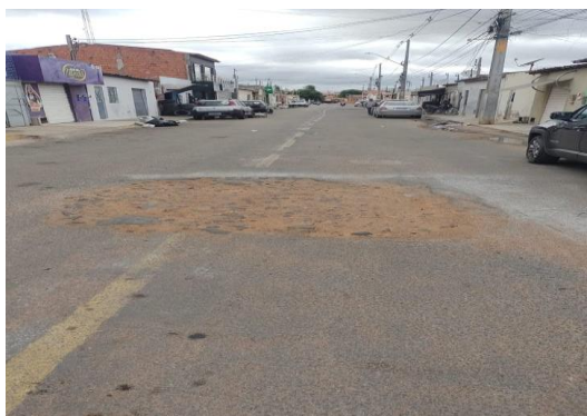
RUA DA CRECHE - CORTE DE ASFALTO
