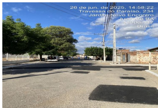
RUA BELA VISTA - APLICAÇÃO DO CBUQ
