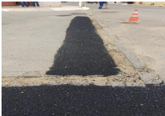
RUA BELA VISTA - APLICAÇÃO DE CBUQ
