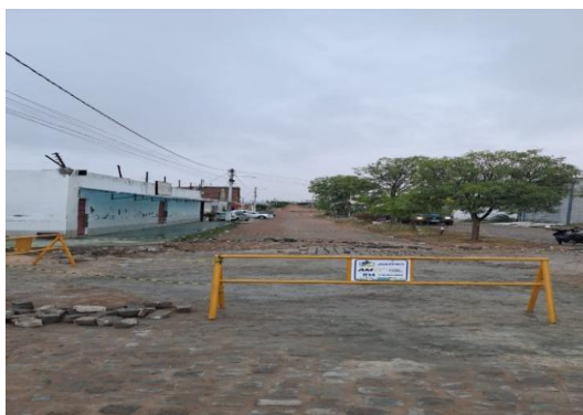
AV BAHIA - PAVIMENTAÇÃO EM PARALELO
