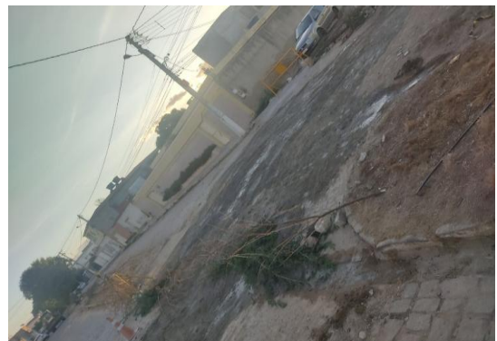
AV BAHIA - PAVIMENTAÇÃO EM PARALELO
