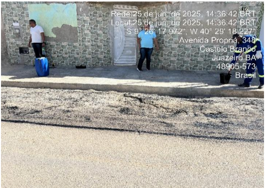
AV PROPRIÁ - IMPRIMAÇÃO COM EMULSÃO ASFAL
