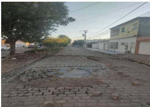
AV BAHIA - PAVIMENTAÇÃO EM PARALELO
