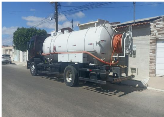
RUA BELA VISTA - DESOBSTRUÇÃO COM SEWER JET
