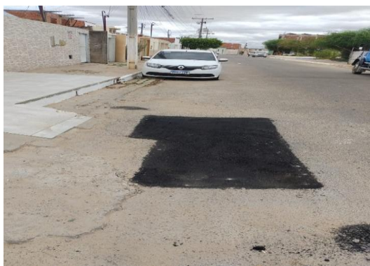
RUA BELA VISTA - APLICAÇÃO DE CBUQ
