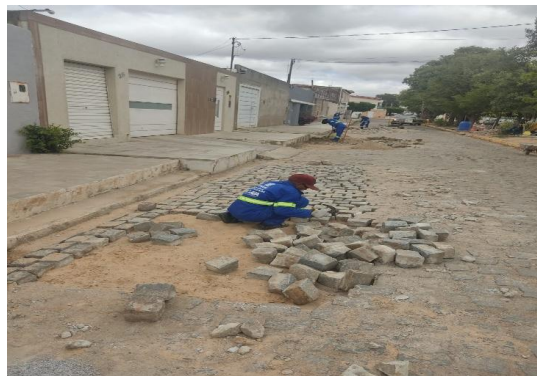
AV BAHIA - PAVIMENTAÇÃO EM PARALELO
