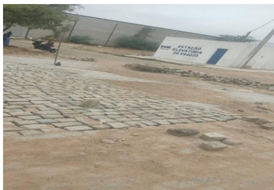
AV BAHIA - PAVIMENTAÇÃO EM PARALELO
