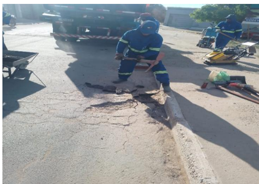
RUA PROPRIÁ - APLICAÇÃO DE CBUQ
