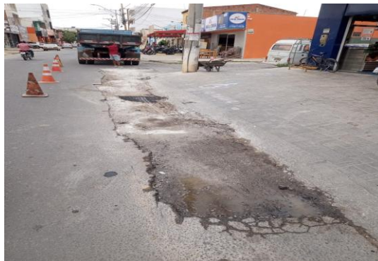
RUA SÃO JOÃO - APLICAÇÃO DE CBUQ
