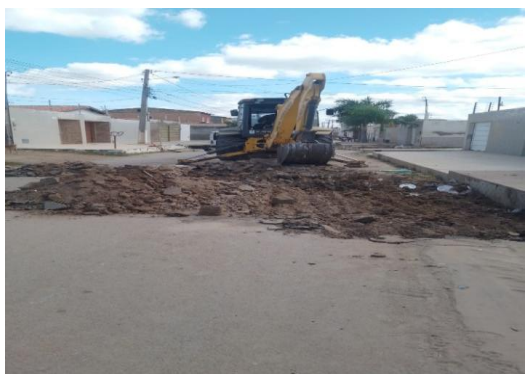
AV PROPRIÁ - ESCAVAÇÃO MECANIZADA
