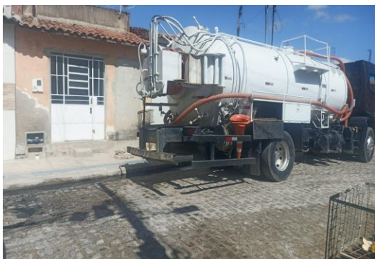
RUA RAUL SEIXAS - DESOBSTRUÇÃO COM SEWER JET
