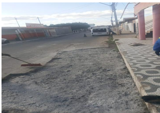
AV AIRTON SENA - PAVIMENTAÇÃO COM CBUQ
