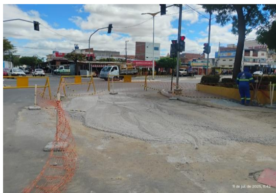
AV ADOLFO VIANA - SERVIÇO DE DRENAGEM
