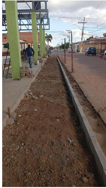
- Escavação e nivelamento
