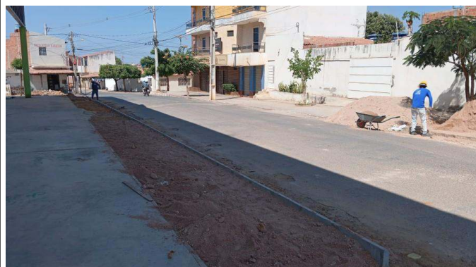
- Assentamento de meio fio. - Colocação de entulho na calçada. - Descarregamento de material.
