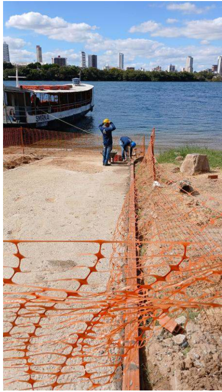
- Assentamento de alvenaria
