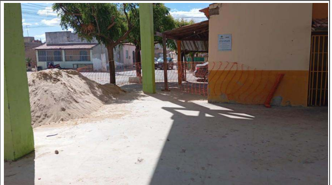
- Colocação de tela
