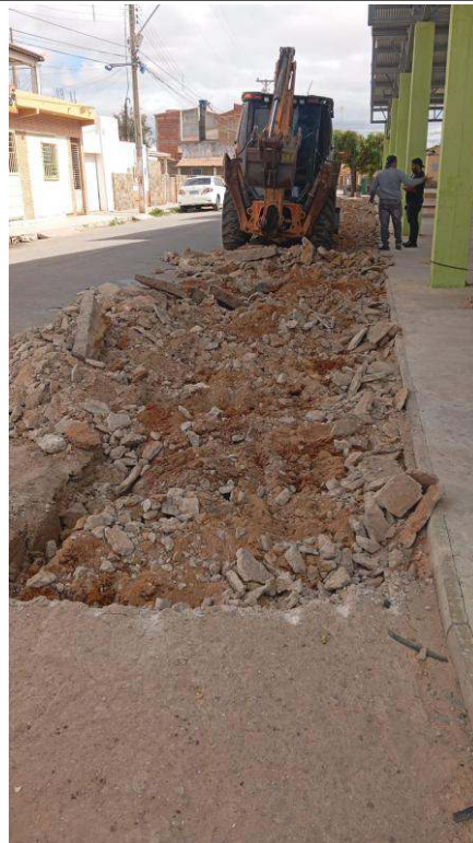
- Remoção do concreto
