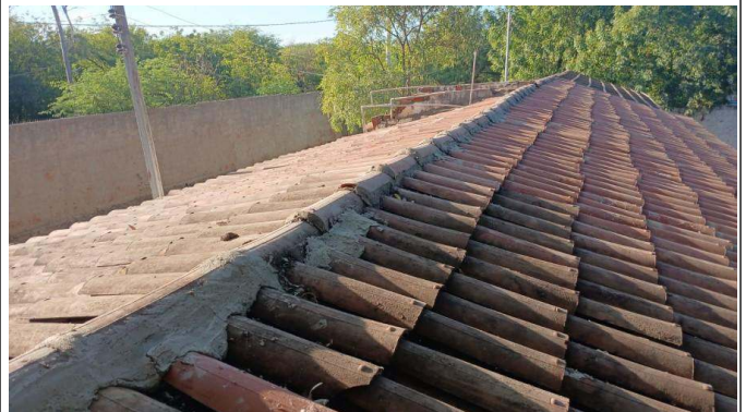
- Remoção de telhado para reparos
