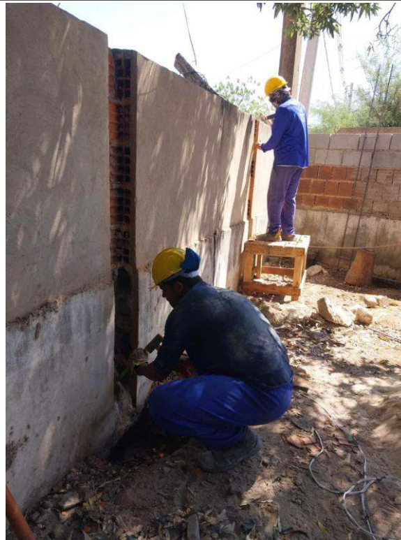
- Colocação de ferragem
