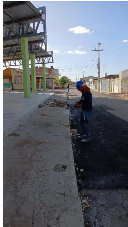
- Colocação de concreto na sarjeta
