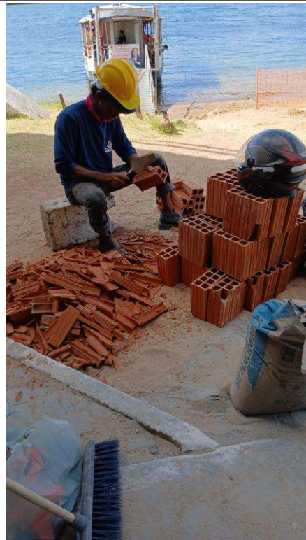
- Assentamento de alvenaria
