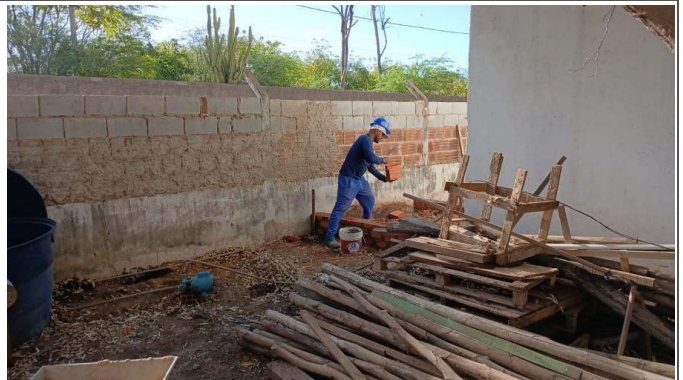
- Fabricação de base pra caixa d'água do chão.- Limpeza da área. - Colocação de aterro na base da caixa.
