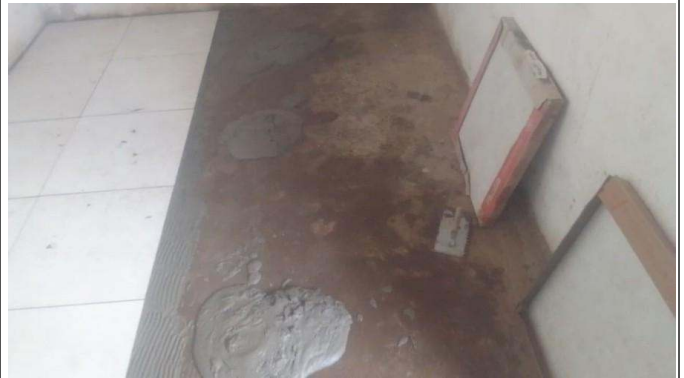
- Assentamento de cerâmica
