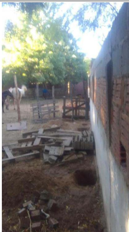
- Escavação de buracos para os pilares
