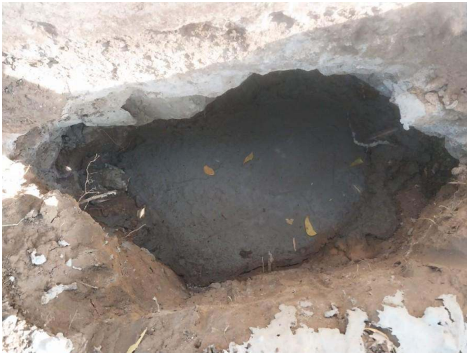
- Colocação de concreto em buracos
