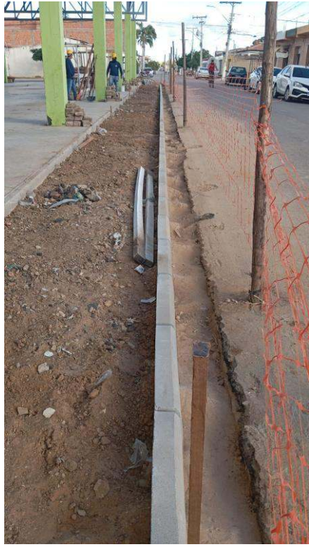
- Escavação e nivelamento - Assentamento de meio fio
