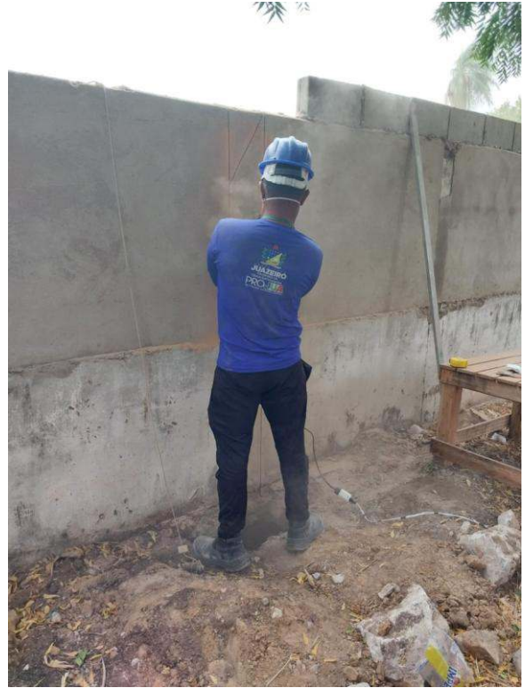
- Escavação de buracos.
