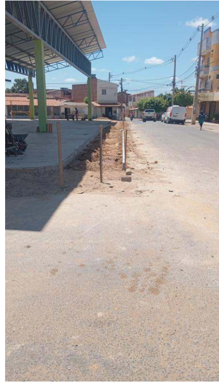
- Colocação e chumbamento de meio fio
