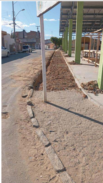
- Escavação para colocação de meio-fio
