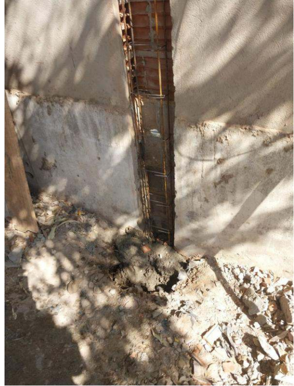
- Colocação de ferragem
