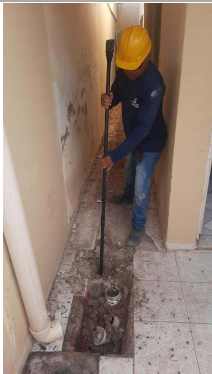
- Escavação para rede de esgoto
