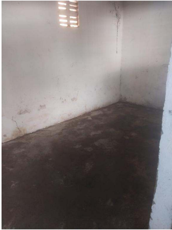
- Limpeza de quarto para assentamento de cerâmica
