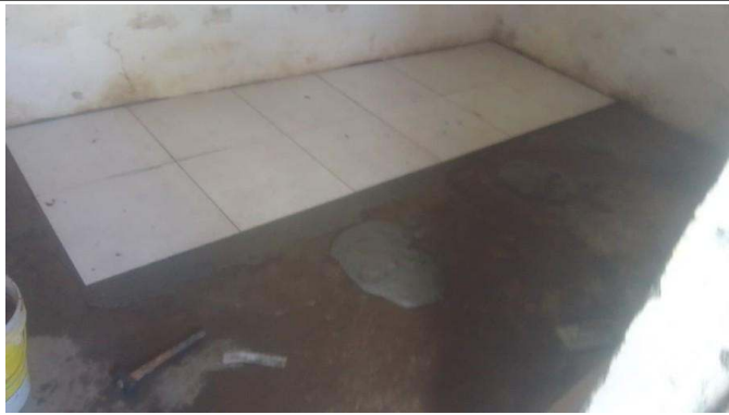
- Assentamento de cerâmica
