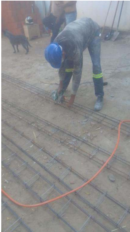
- Preparação de ferragem do muro
