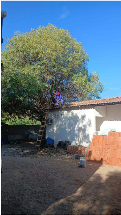
- Remoção de telhado para reparos
