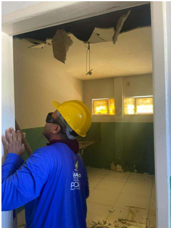
- Demolição do forro de gesso da copa
