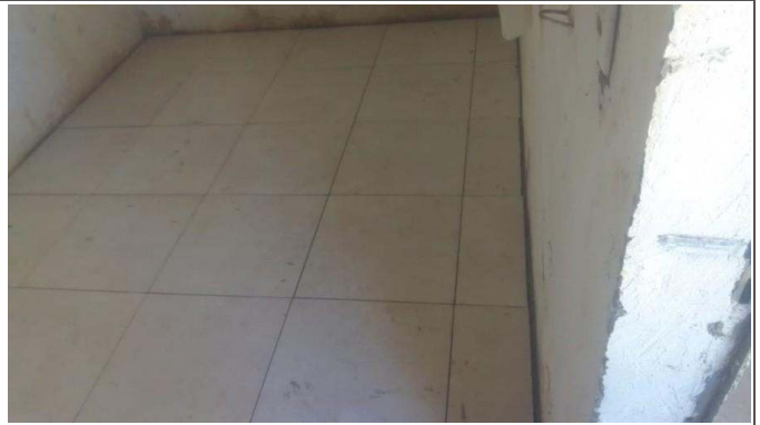
- Assentamento de cerâmica
