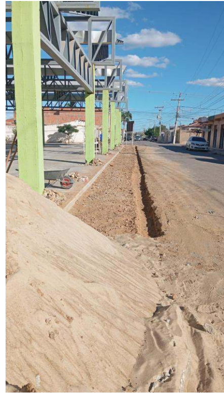
- Escavação para colocação de meio-fio
