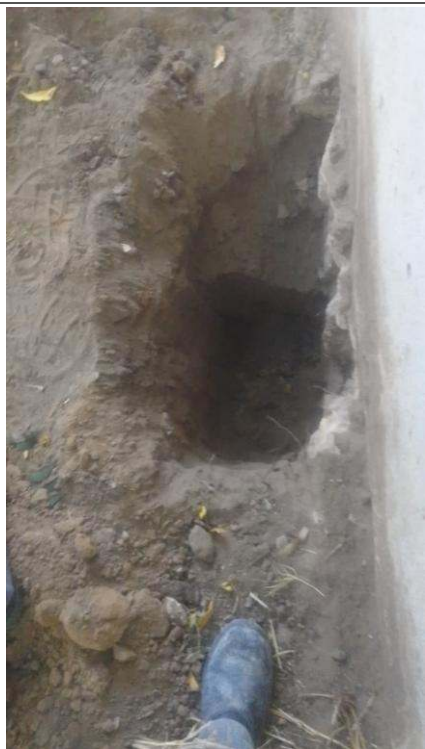
- Escavação de buracos para os pilares
