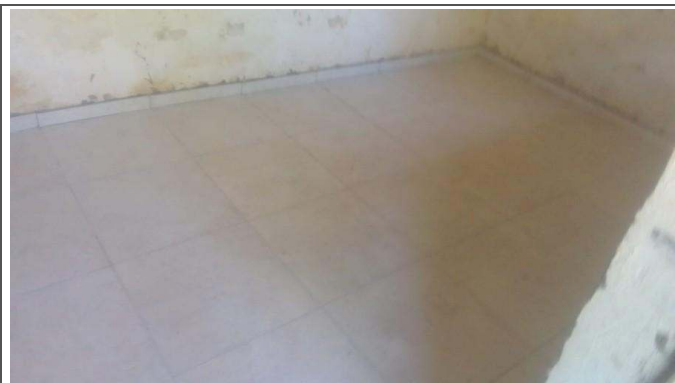
- Finalização de rodapé
