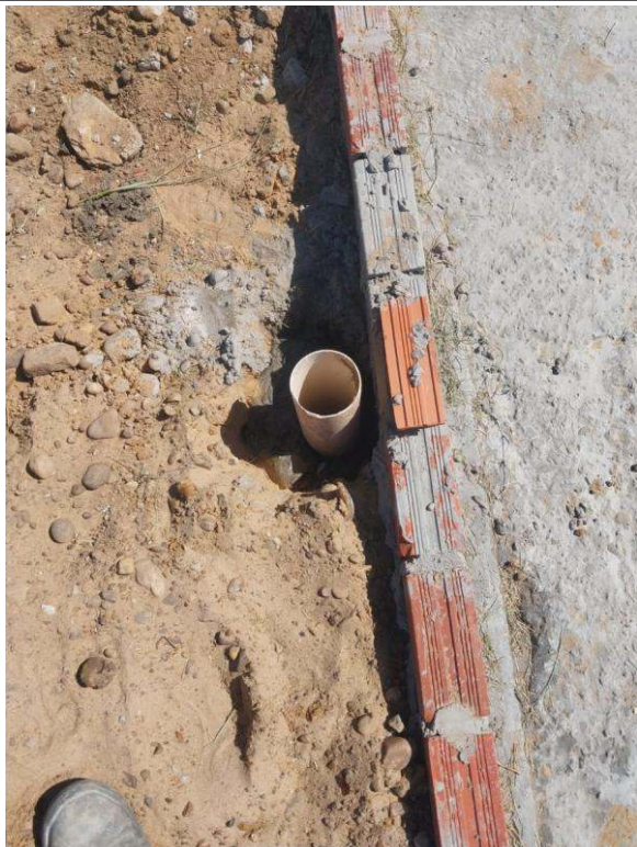
- Chumbamento - Colocação de mestra Limpeza geral da área
