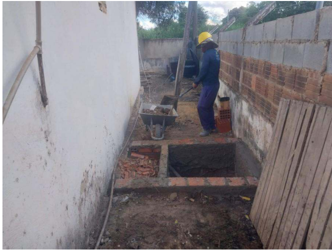
- Recuperação da Base da fossa
