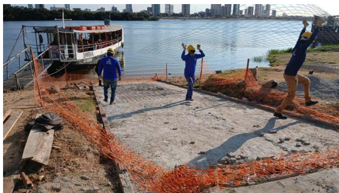
- Colocação de tela
