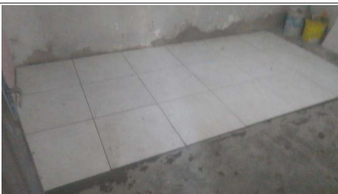
- Assentamento de cerâmica
