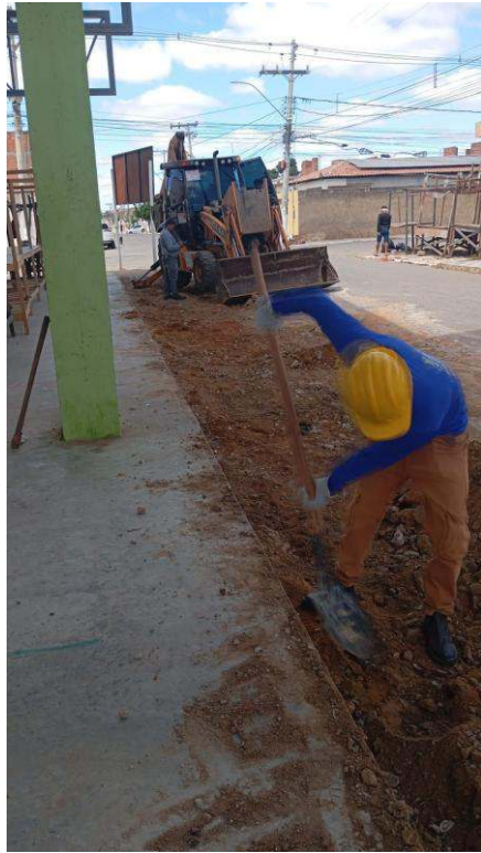
- Nivelção do piso para colocar novo concreto
