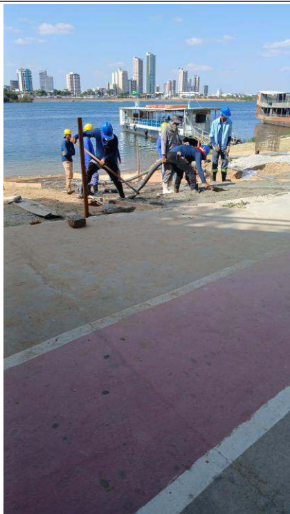
- Concretamento de rampa
