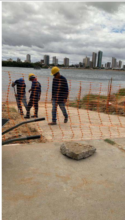
- Escavação de buracos- Limpeza da área
