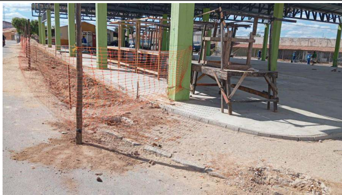
- Nivelamento de terreno
