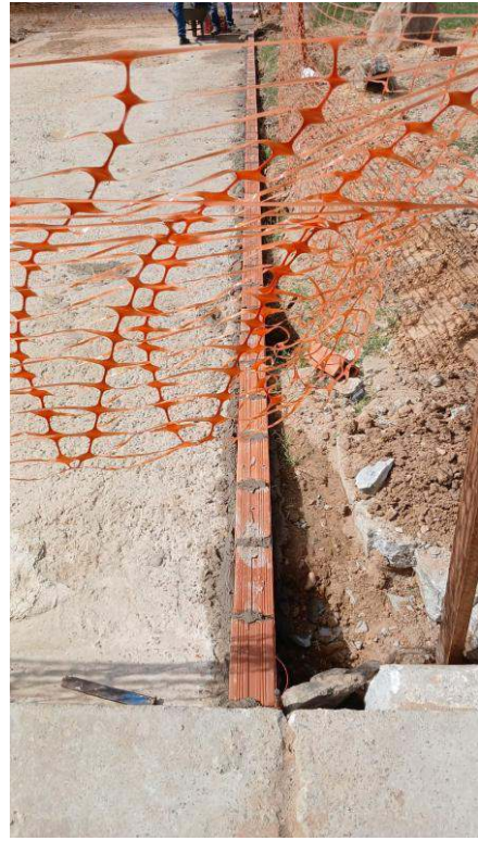
- Assentamento de alvenaria
