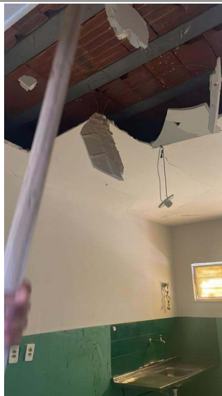
- Demolição do forro de gesso da copa
