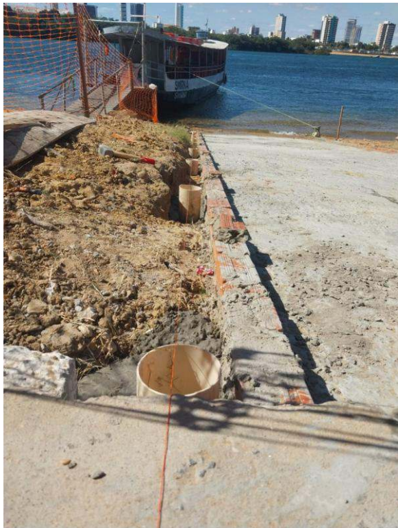
- Colocação de mestra Limpeza geral da área
