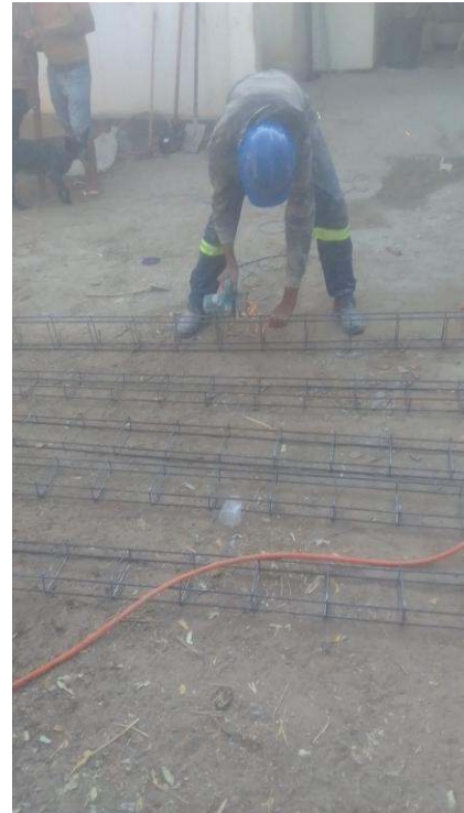
- Preparação de ferragem do muro
