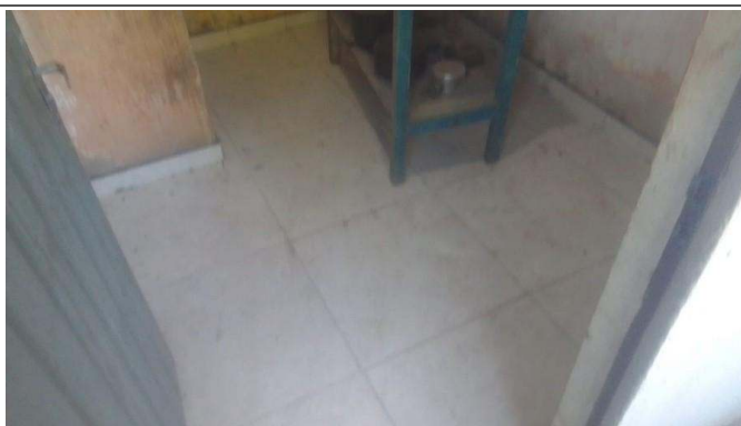
- Rejuntes de cerâmica
