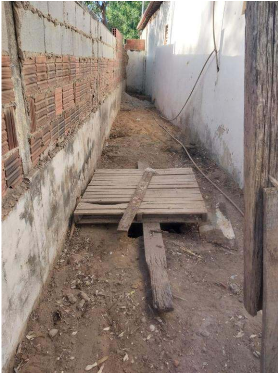
- Recuperação da Base da fossa
