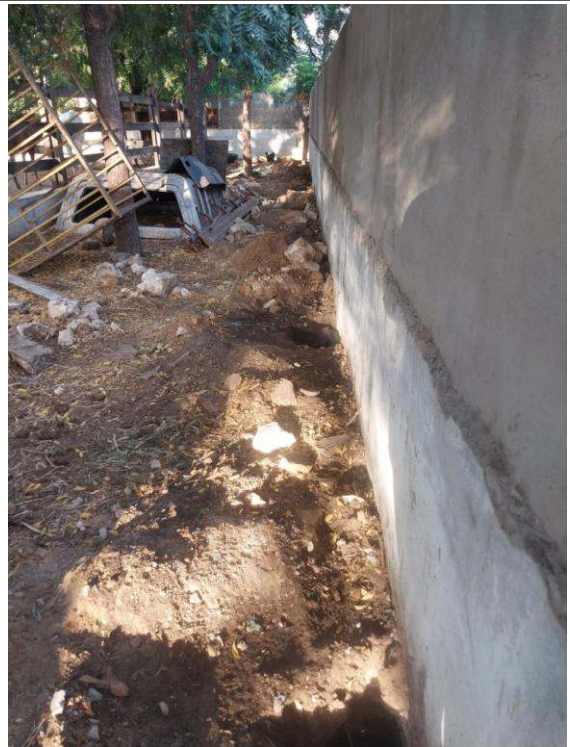
- Colocação de concreto em buracos
