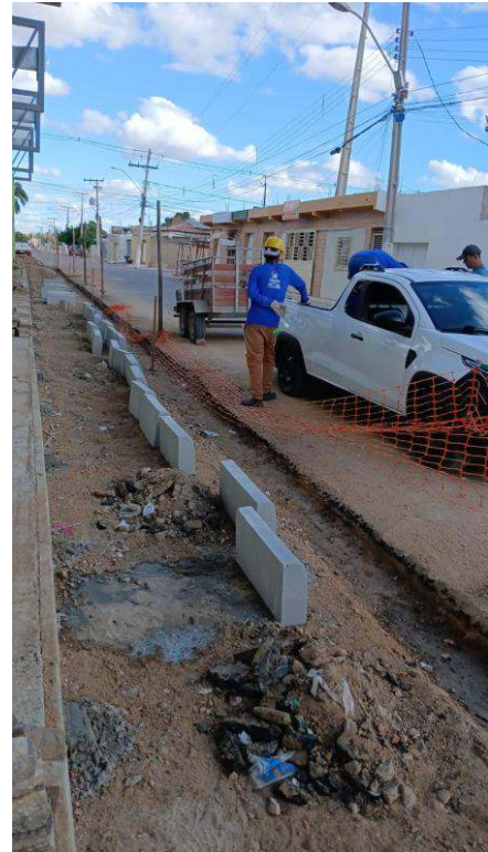
- Descarregamento de meio-fio
