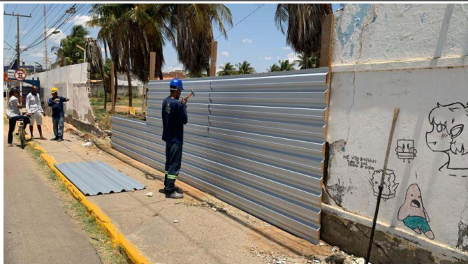
- Fechamento de muro com telhas
