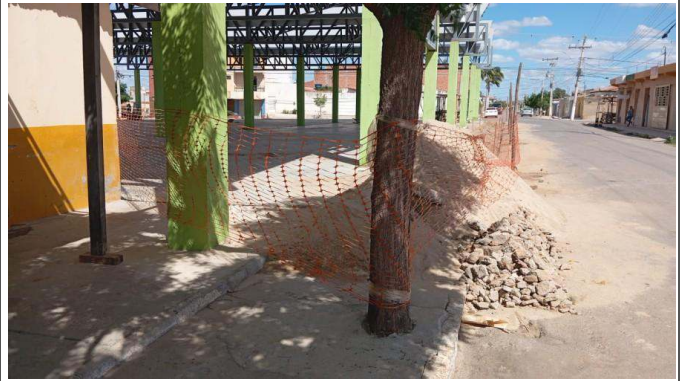
- Colocação de tela
