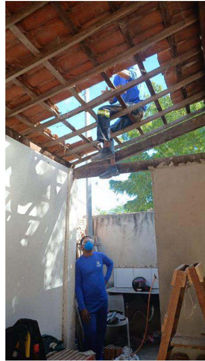
- Remoção de telhado para reparos
