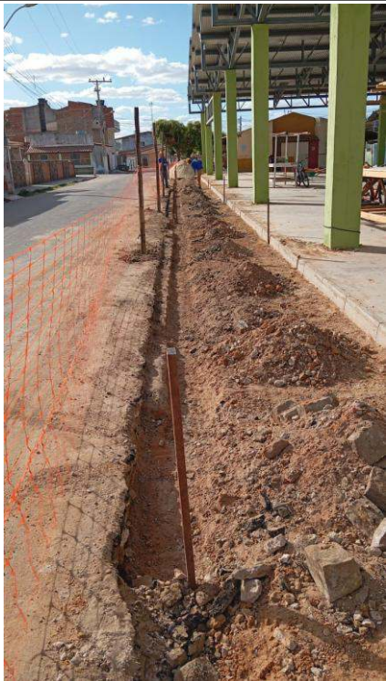
- Nivelamento de terreno
