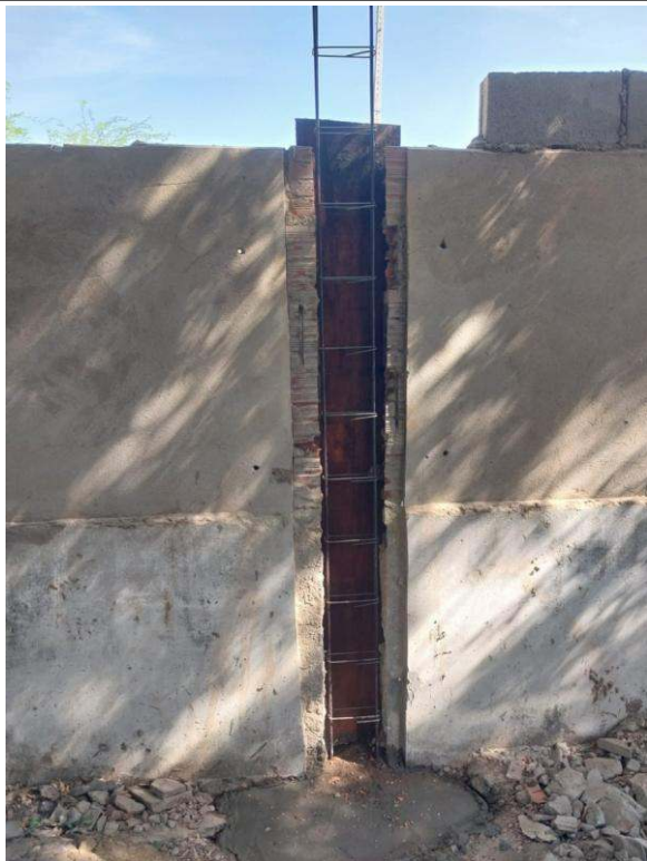
- Colocação de ferragens no muro.
