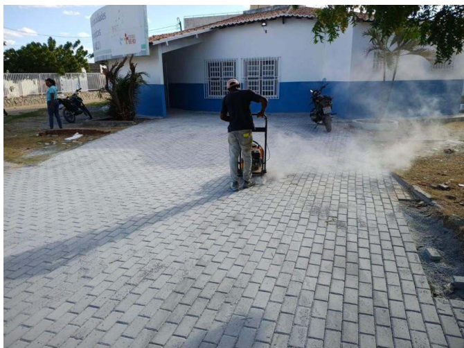
- Assentamento de piso intertravado.- Compactação do piso.- Rejunte.
