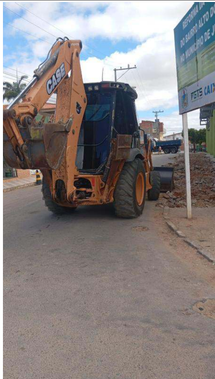
- Remoção do concreto
