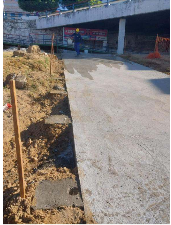
- Confeção de base nos tubos
