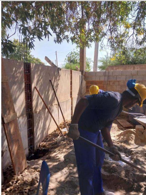
- Colocação de ferragem
