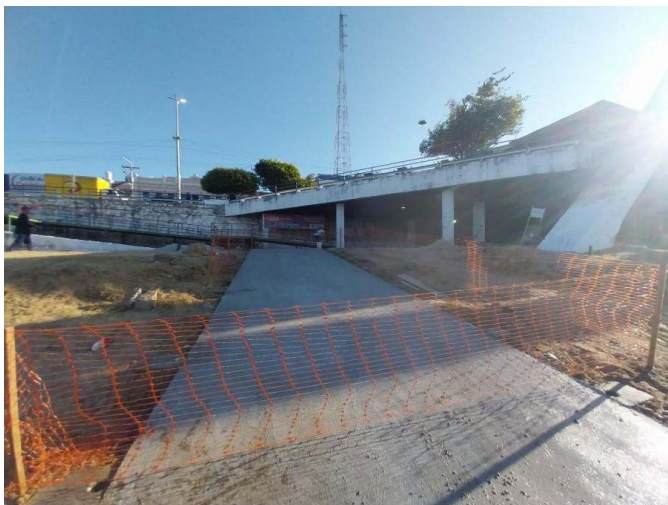
- Confeção de base nos tubos
