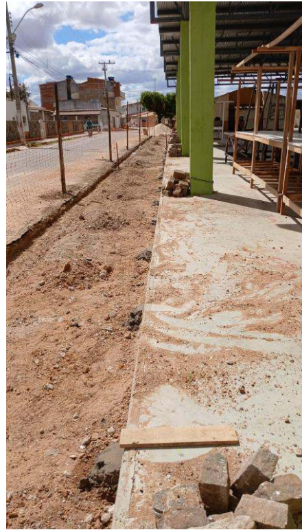
- Recolocação de tela na área
