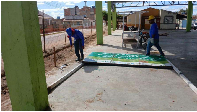
- Regularização de terreno
