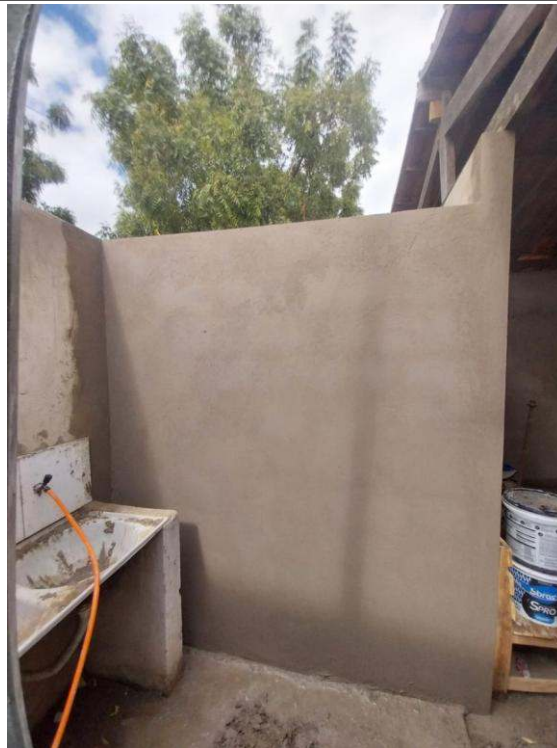
- Reboco de paredes
