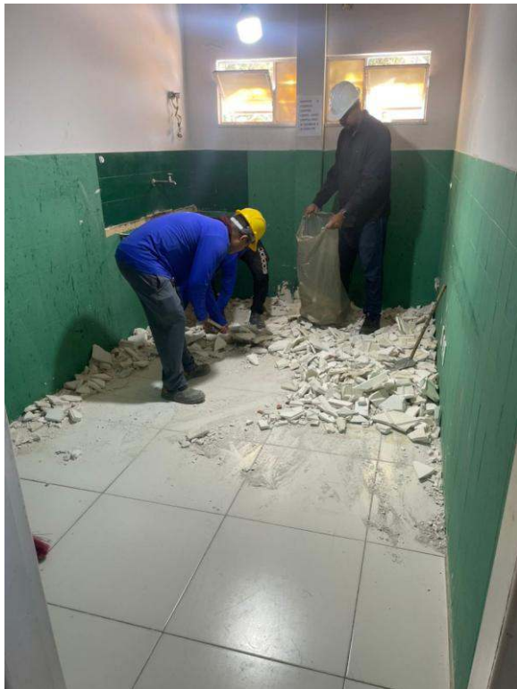
- Demolição do forro de gesso da copa
