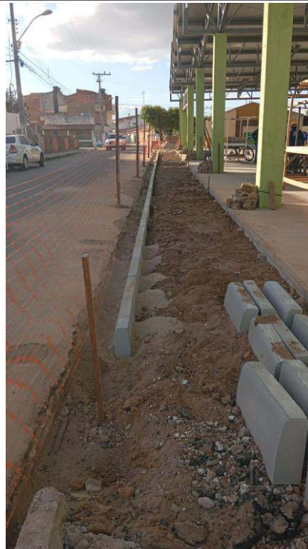
- Assentamento de meio fio
