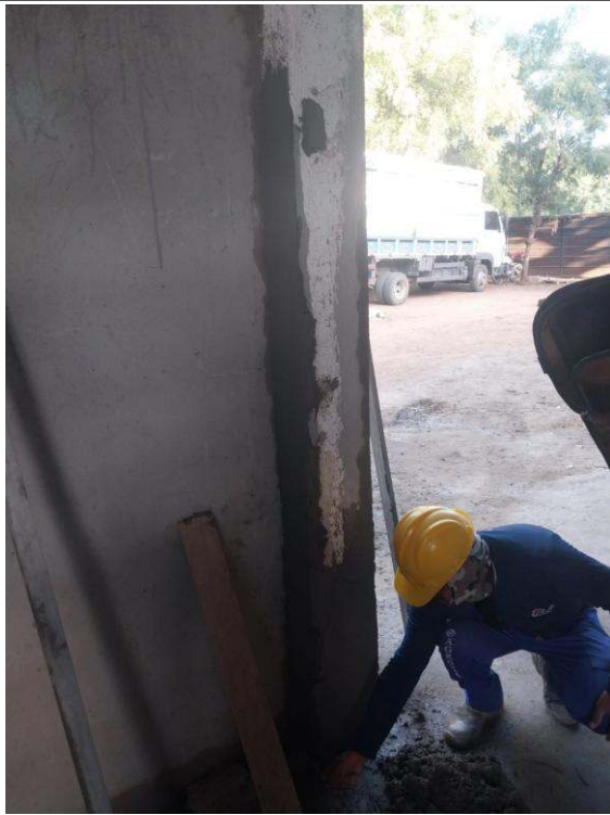
- Acabamento de paredes
