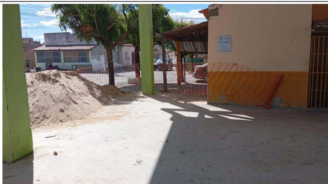
- Colocação de tela
