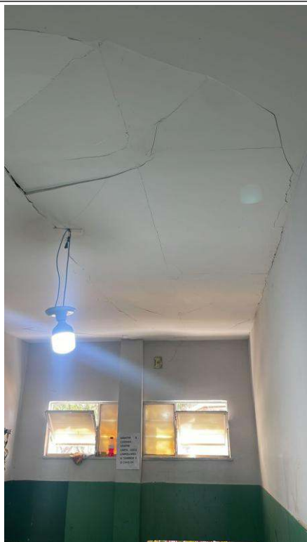
- Demolição do forro de gesso da copa
