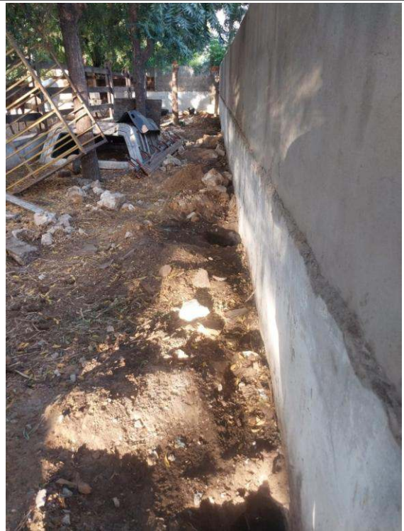
- Colocação de concreto em buracos
