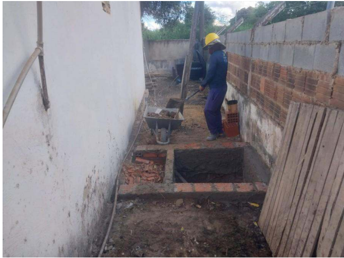
- Recuperação da Base da fossa
