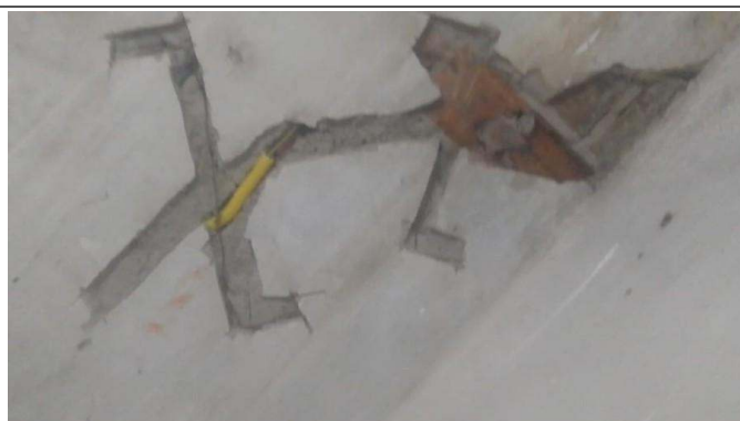
- Colocação de condute
