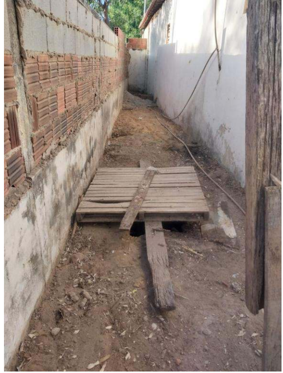
- Limpeza de corredor pra reparos na fossa
