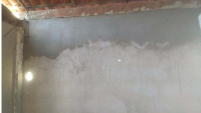
- Finalização de reboco nas paredes
