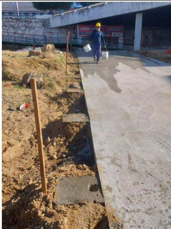
- Confeção de base nos tubos
