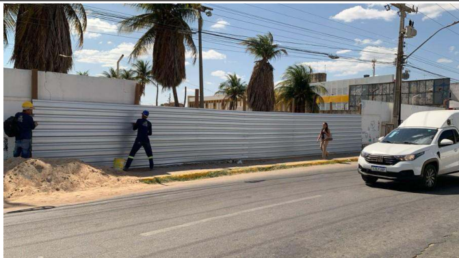
- Fechamento de muro com telhas
