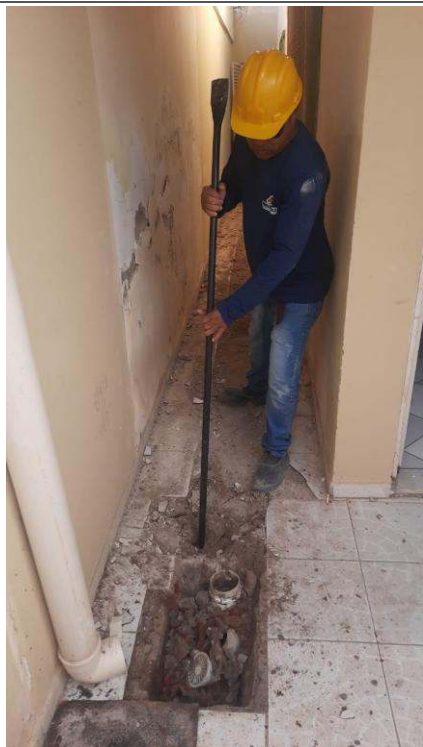
- Escavação para rede de esgoto
