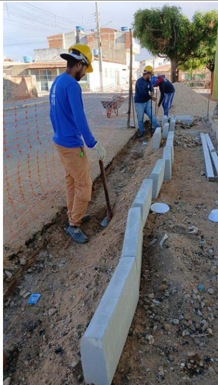
- Escavação e nivelamento - Assentamento de meio fio
