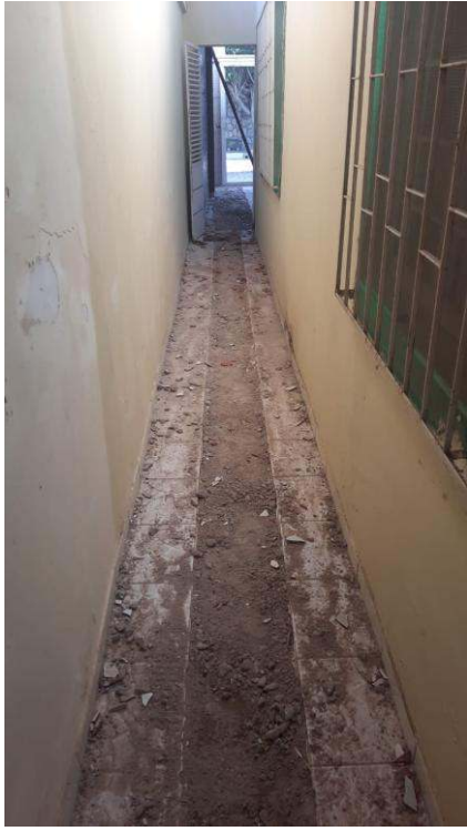
- Escavação para rede de esgoto
