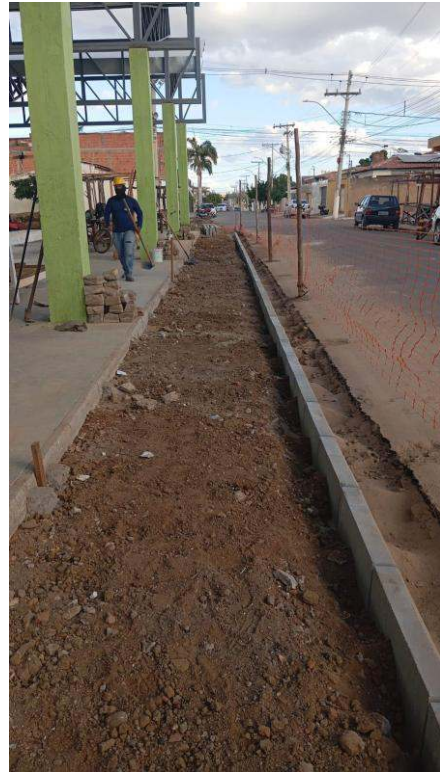
- Escavação e nivelamento
