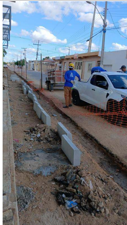
- Descarregamento de meio-fio
