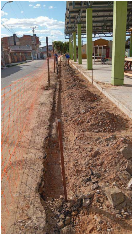
- Nivelamento de terreno
