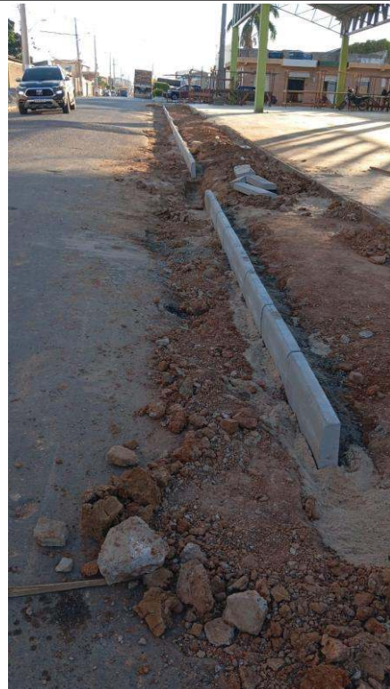
- Colocação de meio fio - Nivelamento da área - Chumbamento de meio fio
