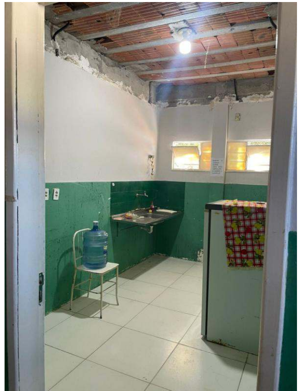
- Demolição do forro de gesso da copa concluída
