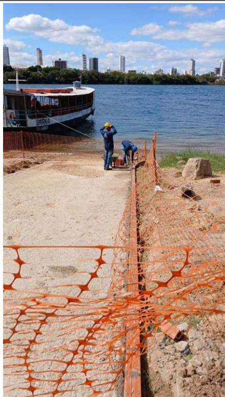
- Assentamento de alvenaria
