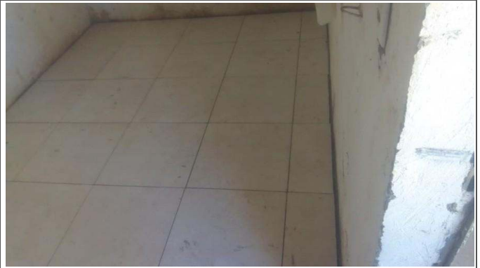
- Assentamento de cerâmica
