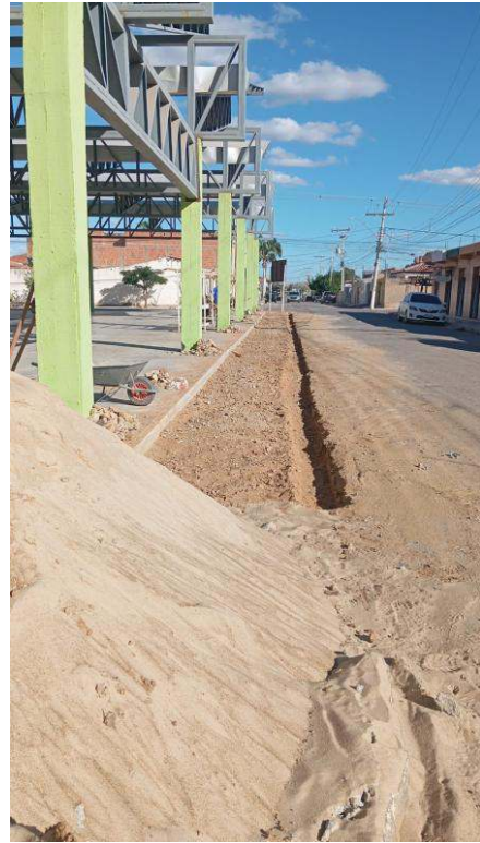
- Escavação para colocação de meio-fio
