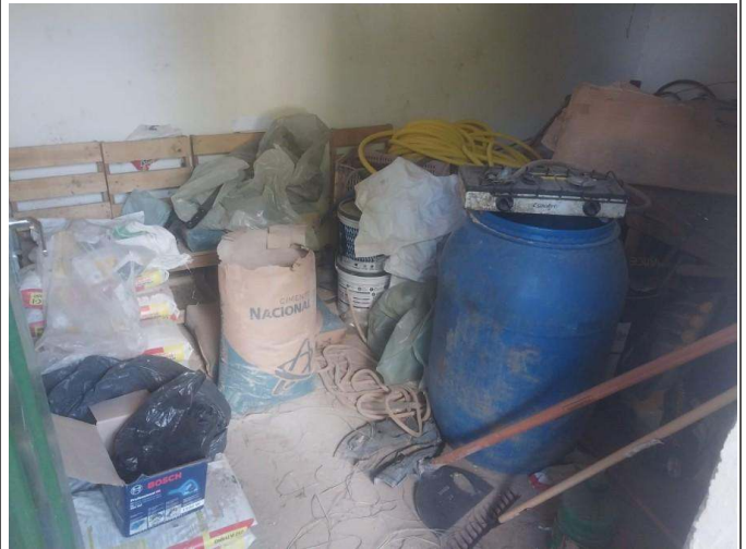
- Limpeza de quarto para assentamento de cerâmica
