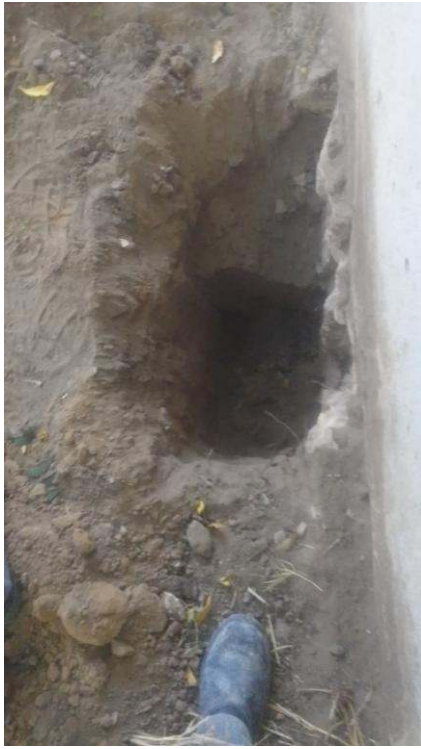
- Escavação de buracos para os pilares
