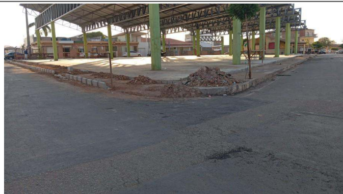
- Finalização de meio fio
