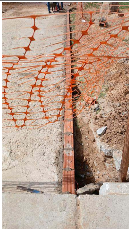
- Assentamento de alvenaria
