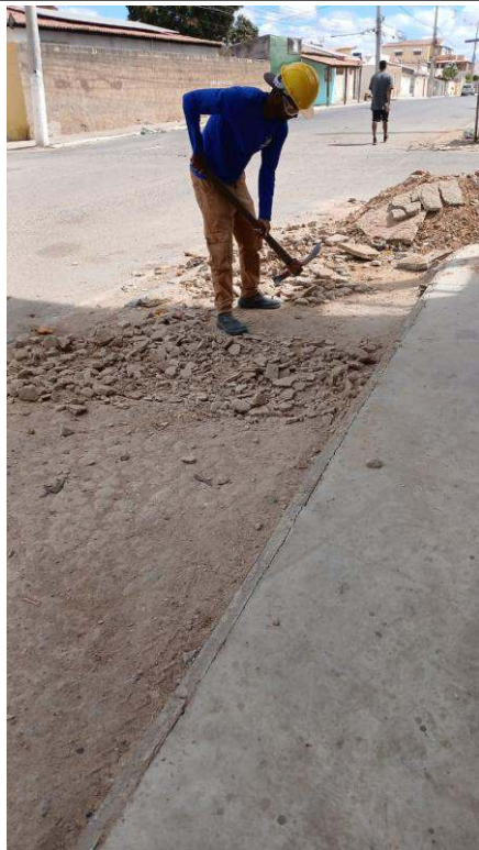
- Remoção de concreto da calçada da frente
