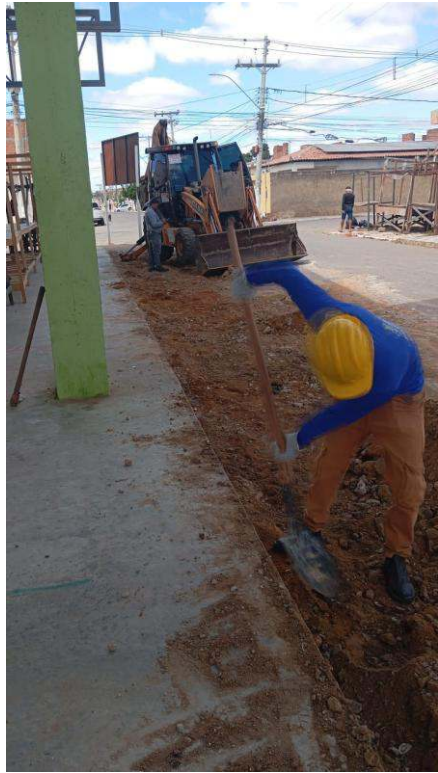
- Nivelção do piso para colocar novo concreto
