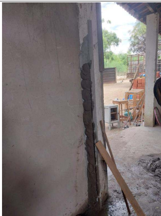
- Acabamento de paredes
