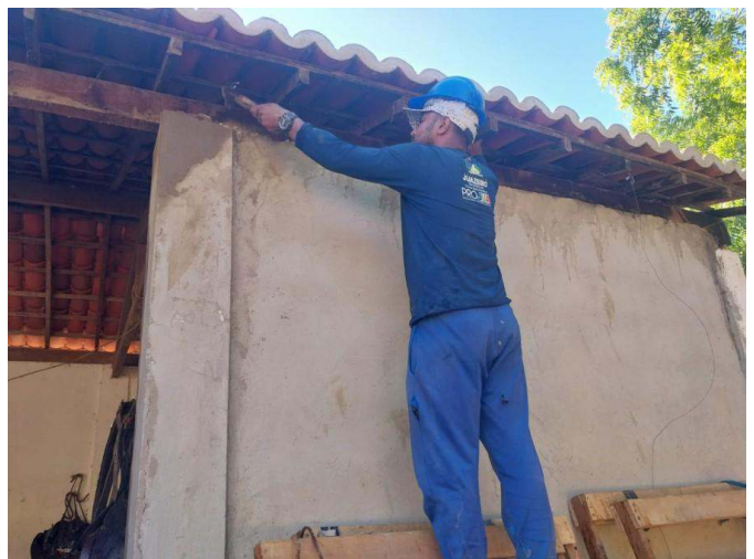
- Acabamento de paredes
