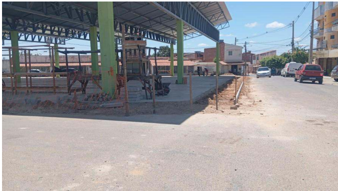
- Colocação de tela de proteção
