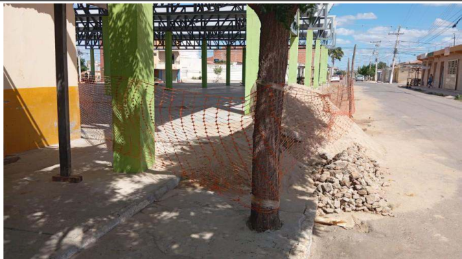
- Colocação de tela
