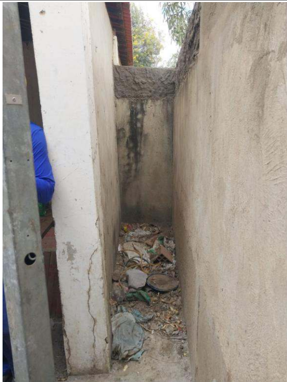
- Limpeza da área
