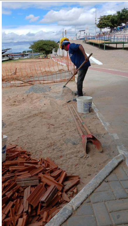
- Descarregamento de brita
