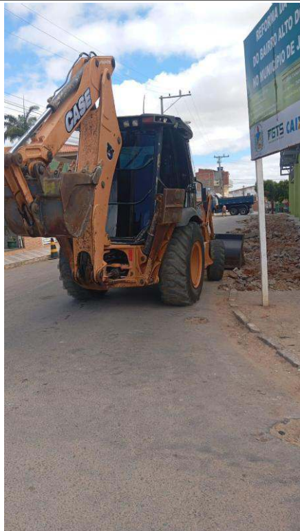
- Remoção do concreto
