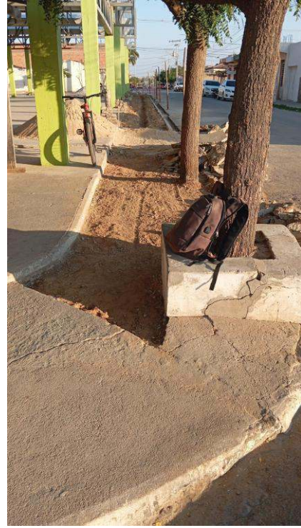
- Escavação de vala pra tubulação - Retirada de areia
