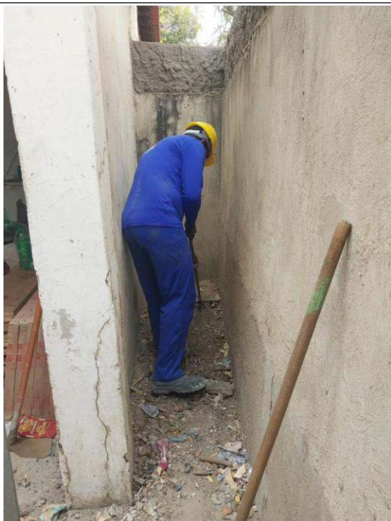
- Limpeza da área
