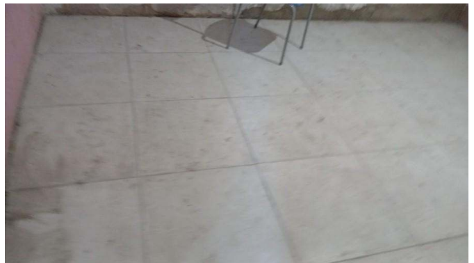
- Rejuntamento de cerâmicas
