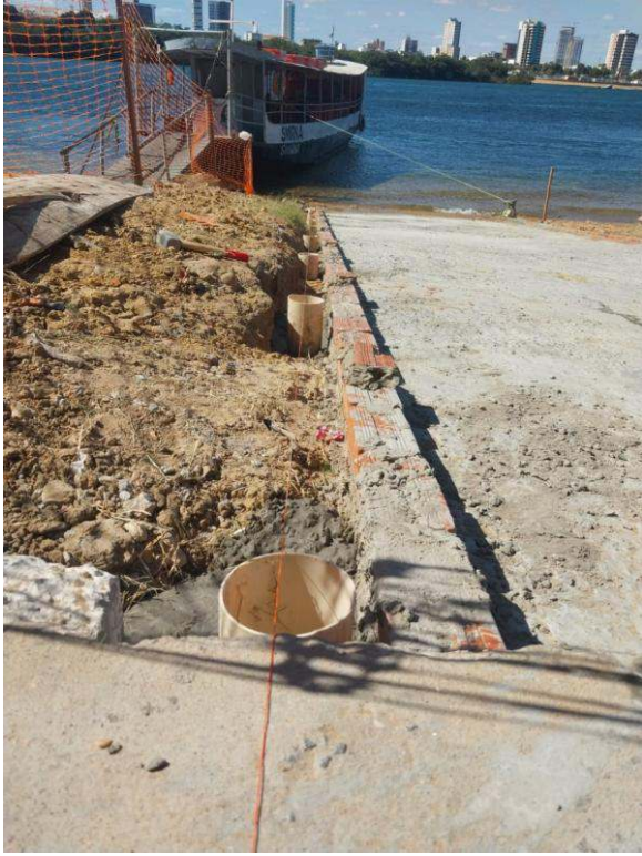
- Colocação de mestra Limpeza geral da área
