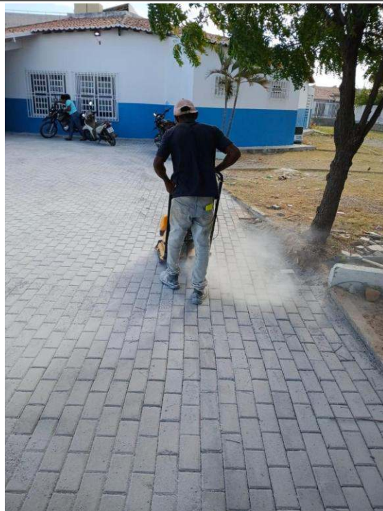
- Assentamento de piso intertravado.- Compactação do piso.- Rejunte.
