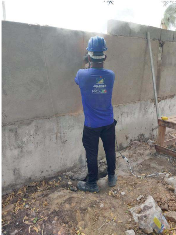
- Escavação de buracos.
