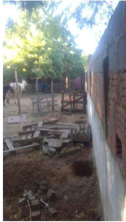
- Escavação de buracos para os pilares
