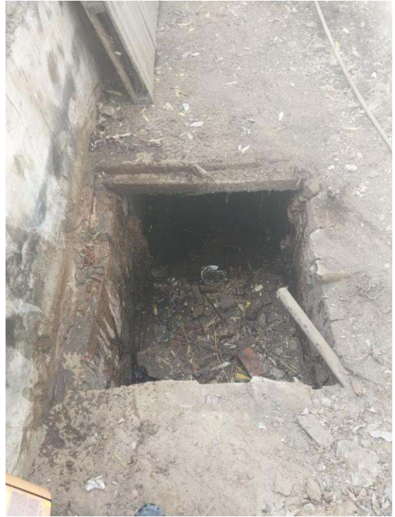
- Recuperação da Base da fossa
