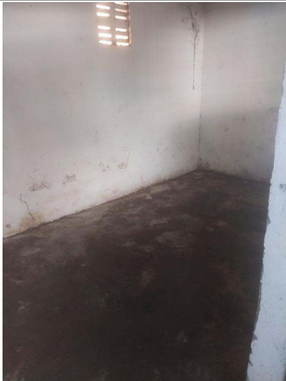
- Limpeza de quarto para assentamento de cerâmica
