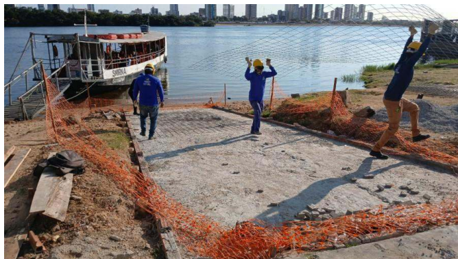
- Colocação de tela
