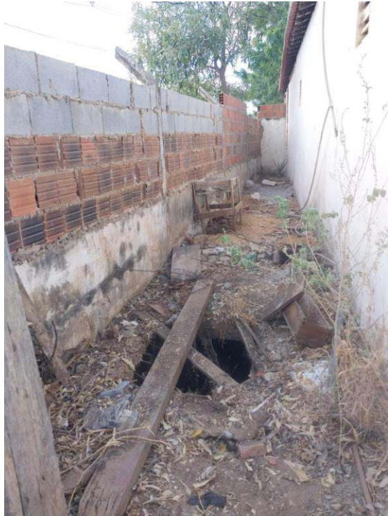
- Limpeza de corredor pra reparos na fossa
