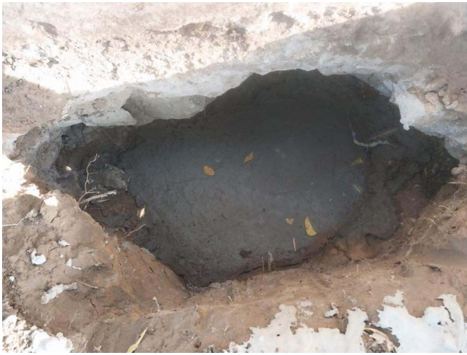
- Colocação de concreto em buracos
