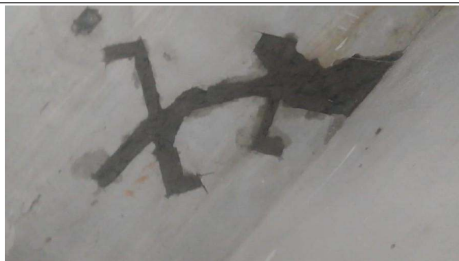
- Colocação de condute
