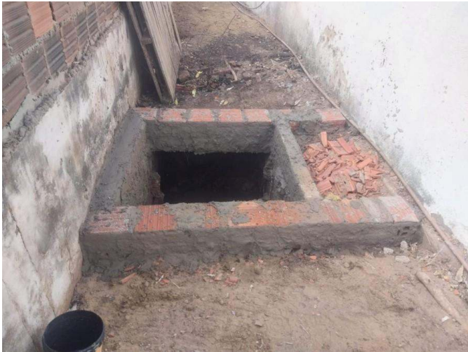
- Recuperação da Base da fossa
