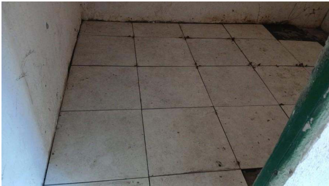
- Colocação de cerâmica
