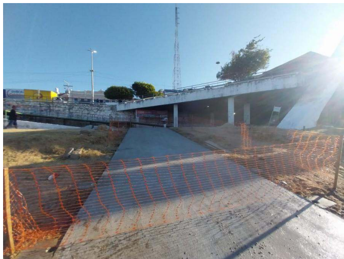
- Confeção de base nos tubos
