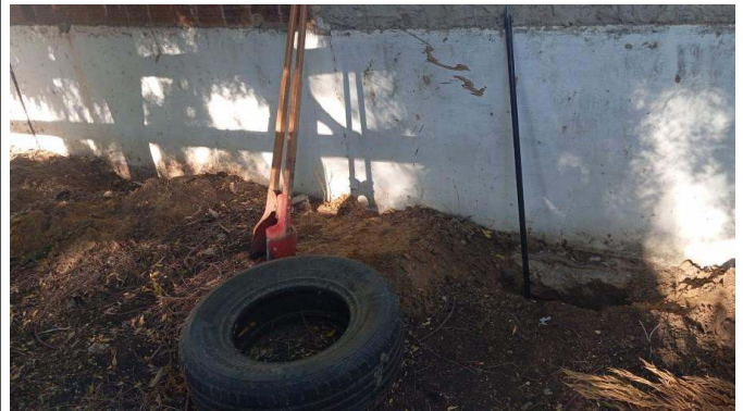
- Escavação para fixação de pilaretes para amarração do muro.
