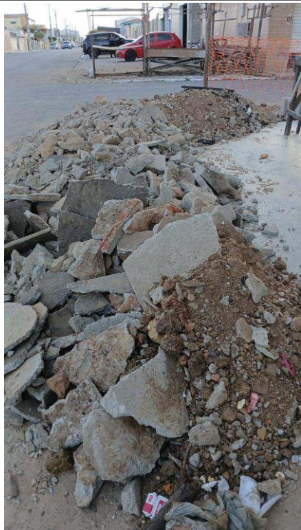
- Retirada de entulho- Limpeza da área
