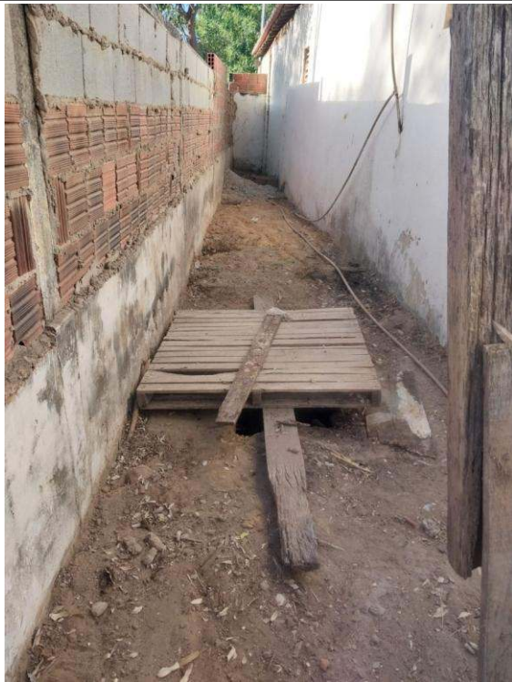
- Recuperação da Base da fossa
