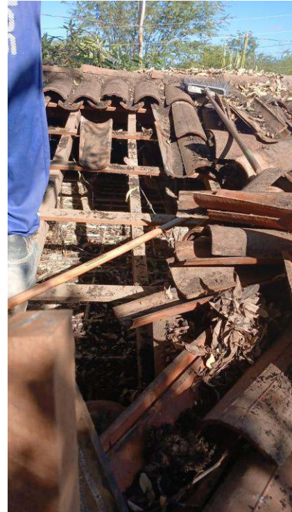
- Remoção de telhado para reparos
