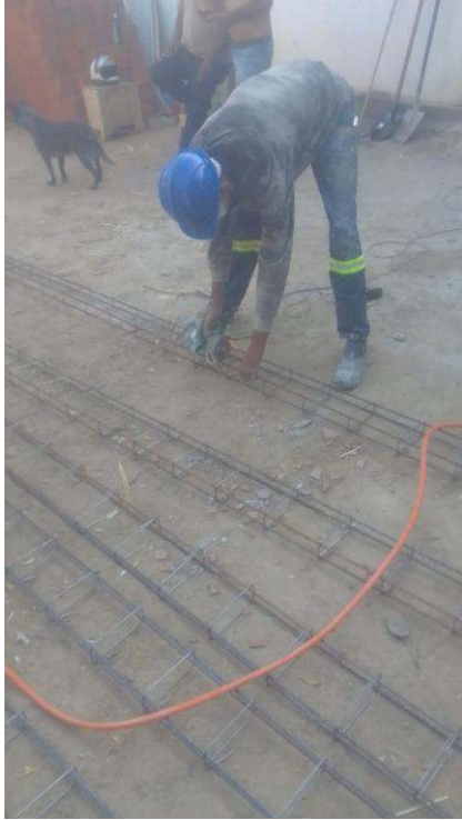
- Preparação de ferragem do muro
