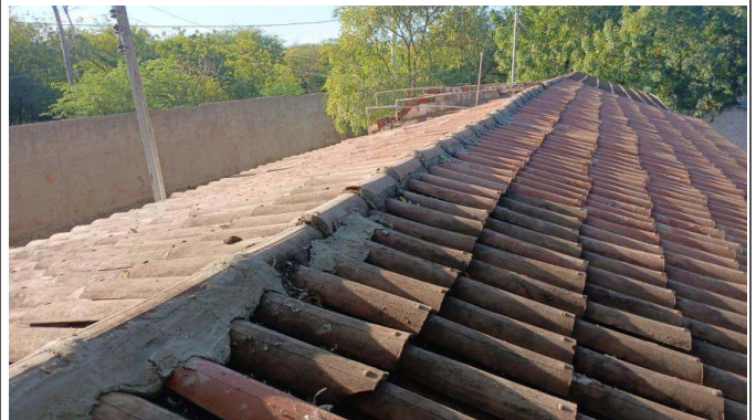
- Remoção de telhado para reparos
