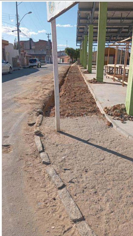
- Escavação para colocação de meio-fio
