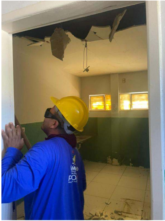
- Demolição do forro de gesso da copa
