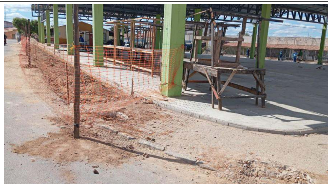
- Nivelamento de terreno
