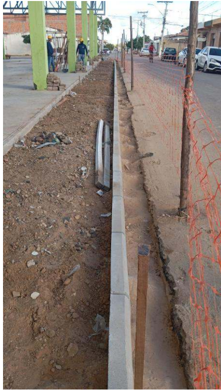
- Escavação e nivelamento - Assentamento de meio fio
