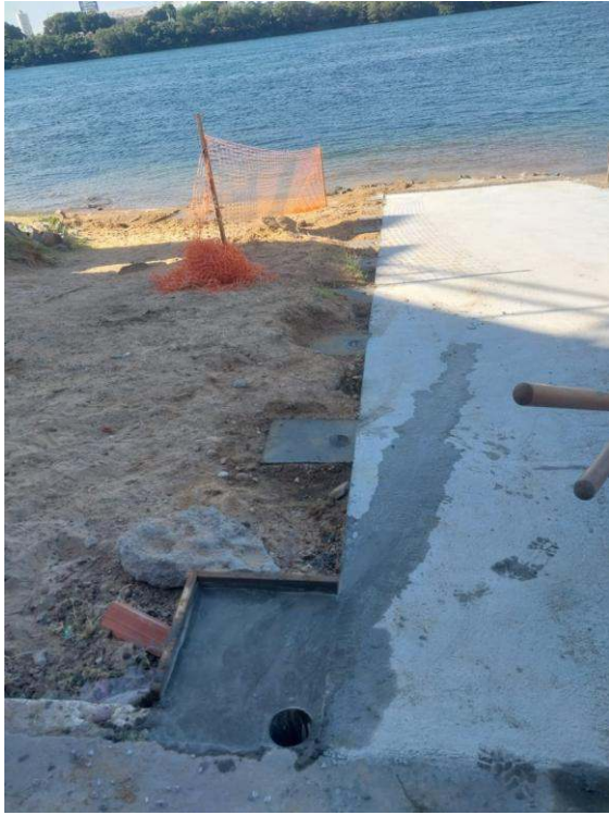
- Confeção de base nos tubos
