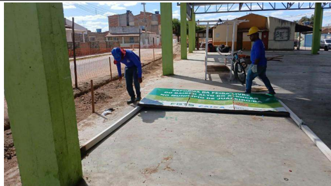
- Regularização de terreno
