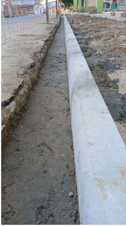
- Chumbamento de meio fio
