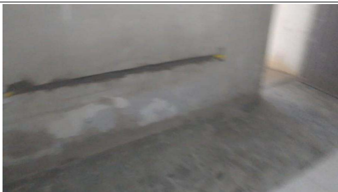
- Colocação de condute
