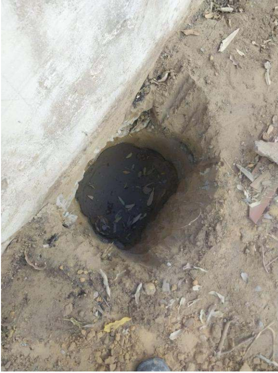
- Colocação de concreto em buracos
