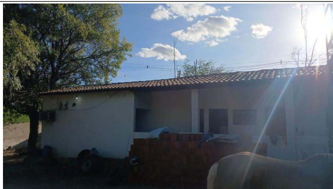
- Remoção de telhado para reparos
