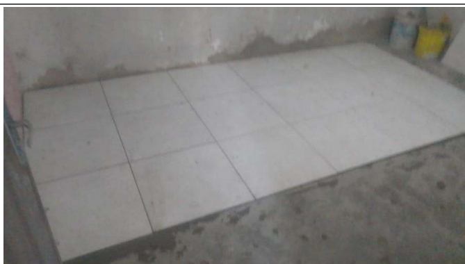
- Assentamento de cerâmica
