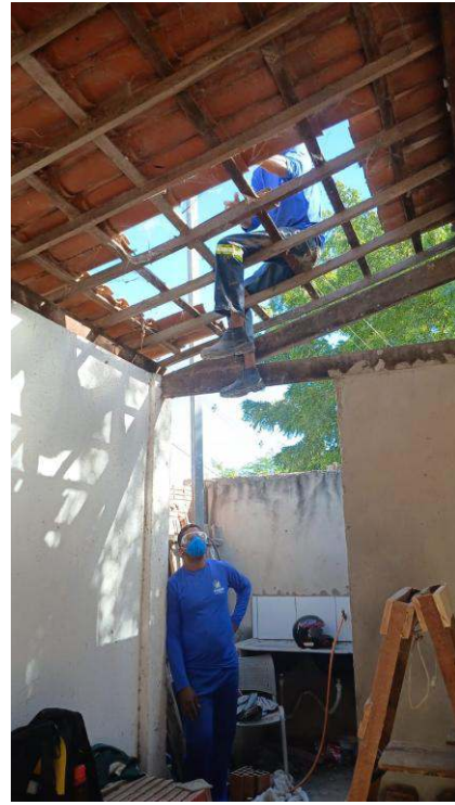
- Remoção de telhado para reparos
