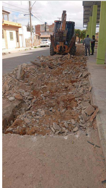
- Remoção do concreto
