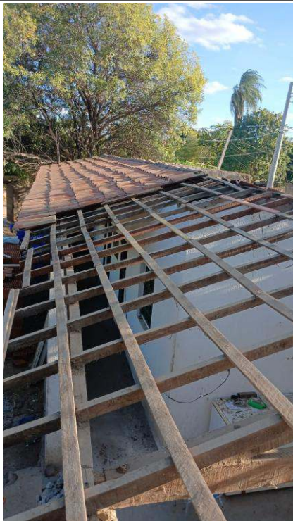
- Remoção de telhado para reparos
