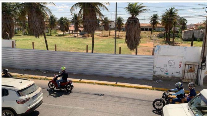
- Fechamento de muro com telhas
