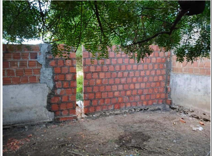
- Levante de muro com alvenaria de blocos cerâmicos.
