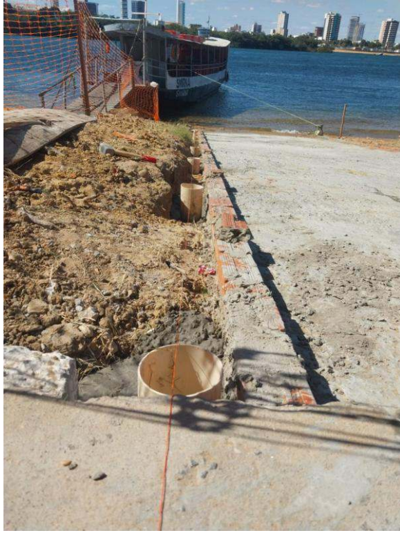
- Colocação de mestra Limpeza geral da área
