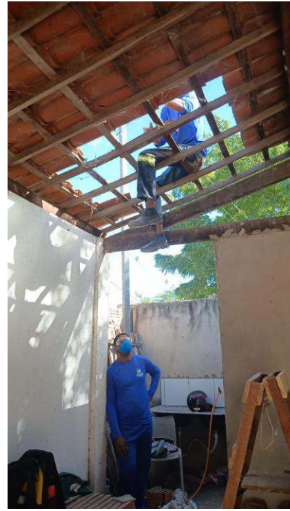
- Remoção de telhado para reparos
