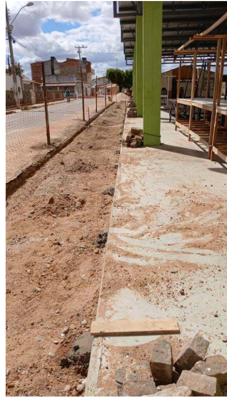
- Recolocação de tela na área
