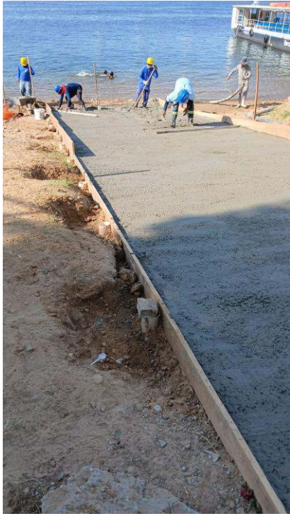
- Nivelamento de rampa
