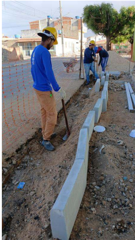
- Escavação e nivelamento - Assentamento de meio fio
