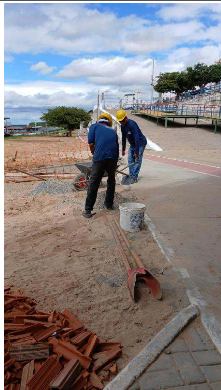
- Colocação de goda de cimento
