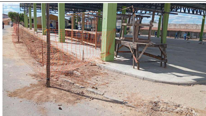
- Nivelamento de terreno
