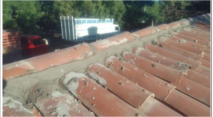
- Recalçamento do telhado
