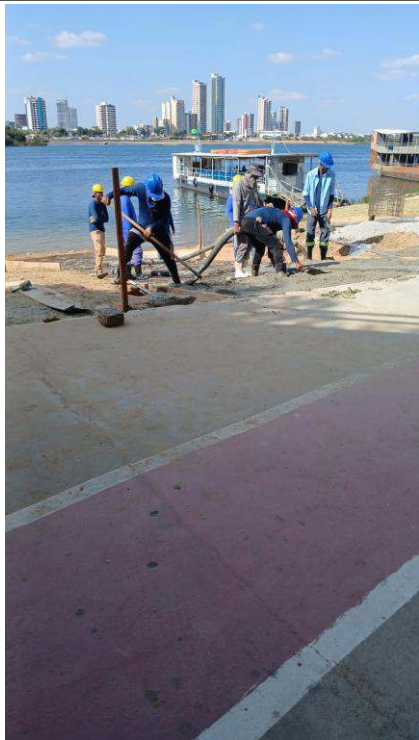
- Concretamento de rampa
