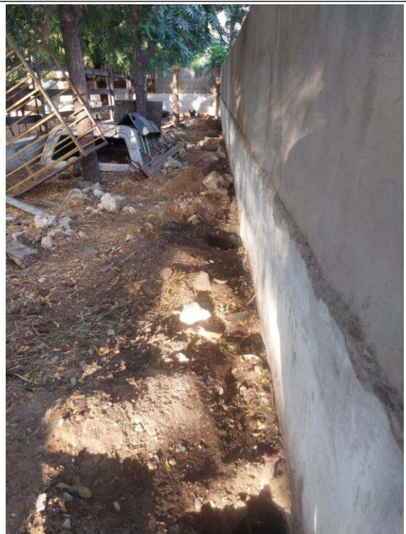
- Colocação de concreto em buracos
