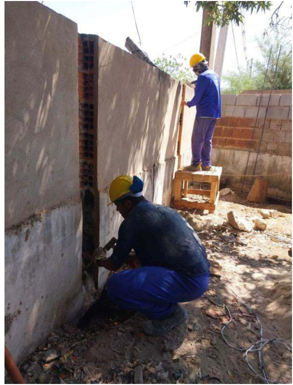
- Colocação de ferragem
