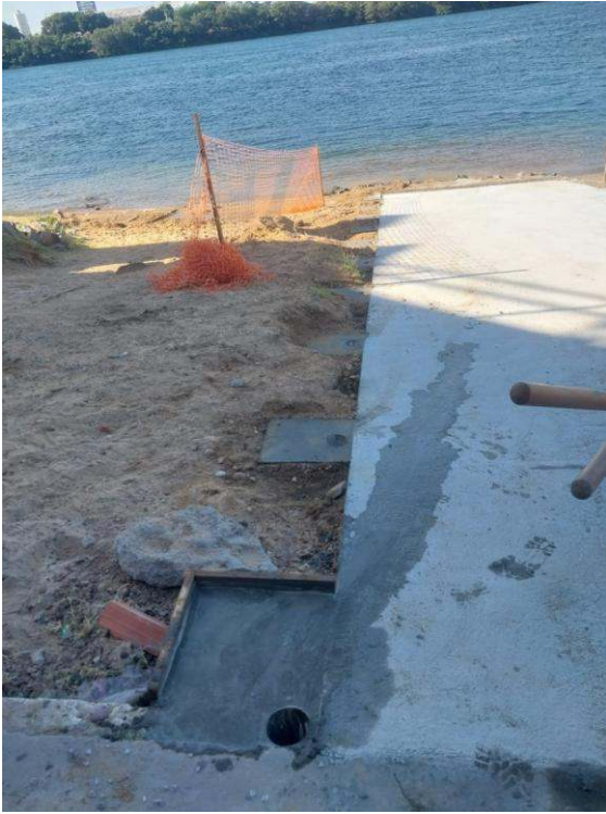
- Confeção de base nos tubos
