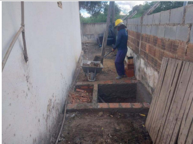
- Recuperação da Base da fossa
