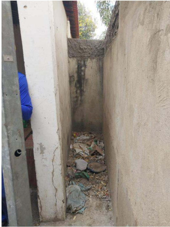
- Limpeza da área
