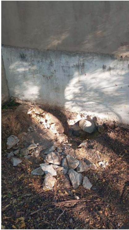
- Escavação para fixação de pilaretes para amarração do muro.
