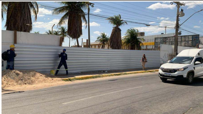
- Fechamento de muro com telhas
