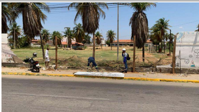
- Escavação de buracos. - Colocação de linhas e telhas.
