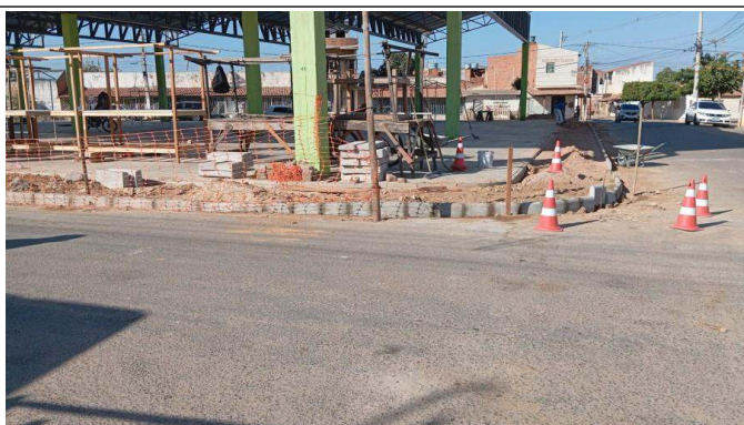
- Assentamento de meio fio. - Colocação de entulho na calçada. - Descarregamento de material.
