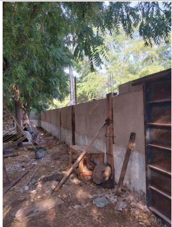
- Concretagem de ferragem.
