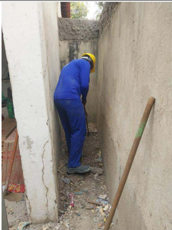
- Limpeza da área
