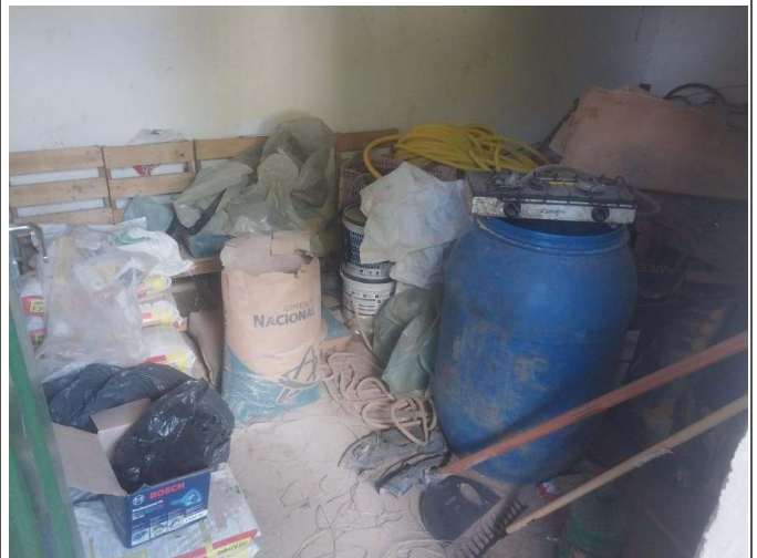
- Limpeza de quarto para assentamento de cerâmica
