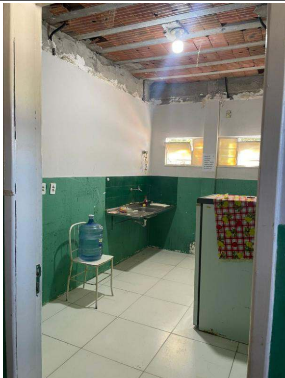
- Demolição do forro de gesso da copa concluída
