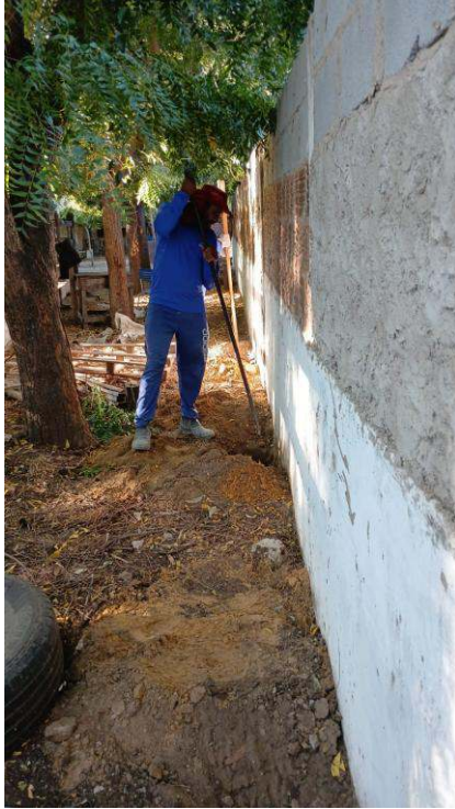
- Escavação para fixação de pilaretes para amarração do muro.
