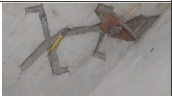
- Colocação de canudite
