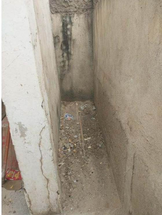
- Limpeza da área
