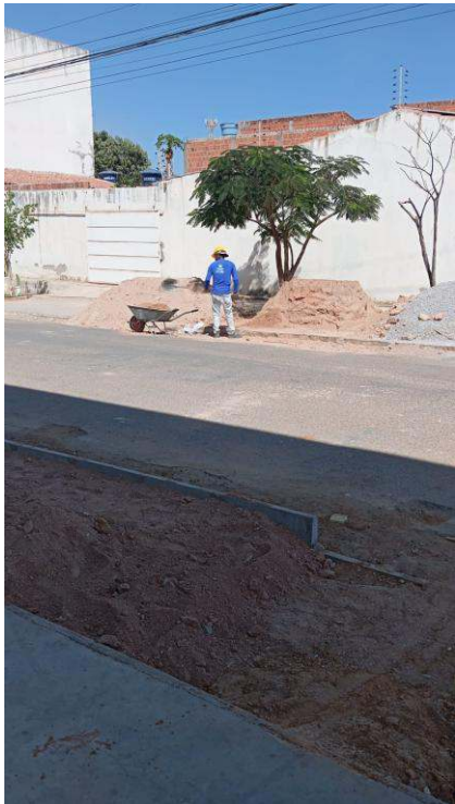
- Assentamento de meio fio. - Colocação de entulho na calçada. - Descarregamento de material.
