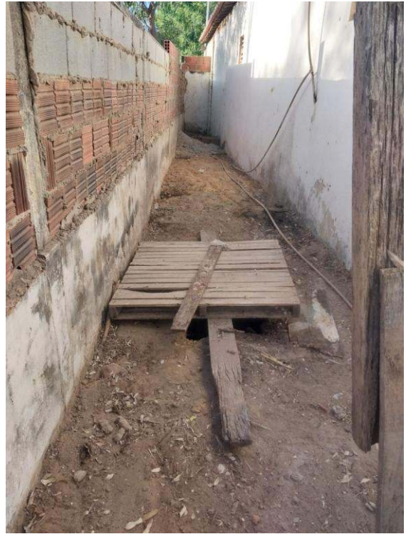
- Limpeza de corredor pra reparos na fossa
