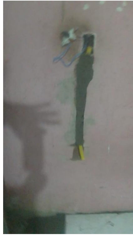
- Colocação de canudite
