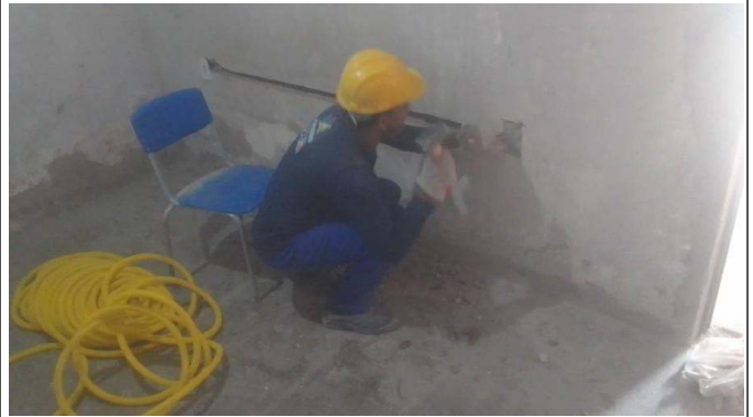
- Colocação de condute
