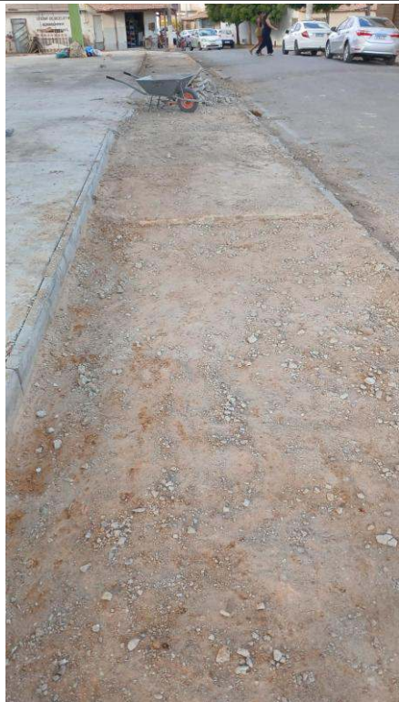
- Limpeza da área
