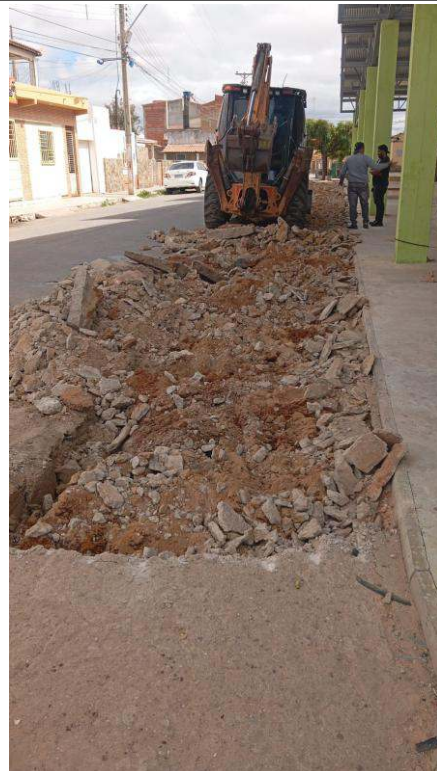
- Remoção do concreto
