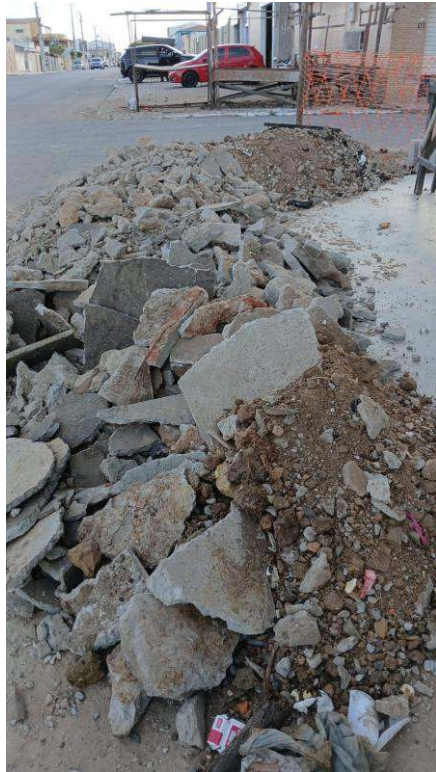
- Retirada de entulho- Limpeza da área
