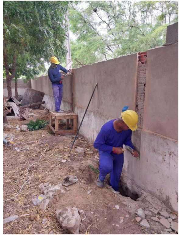
- Escavação de buracos.
