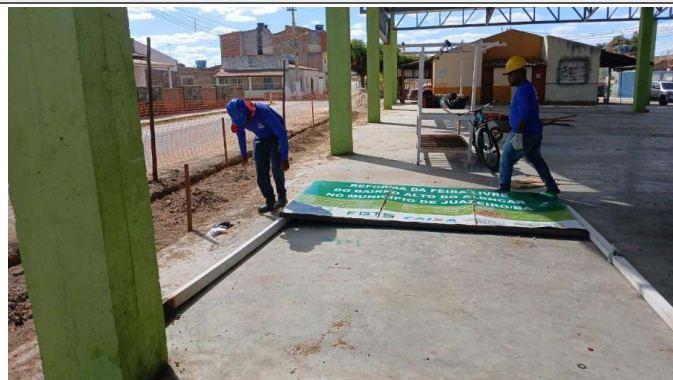
- Regularização de terreno
