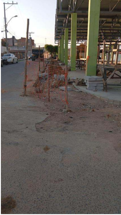
- Escavação de vala pra tubulação - Retirada de areia
