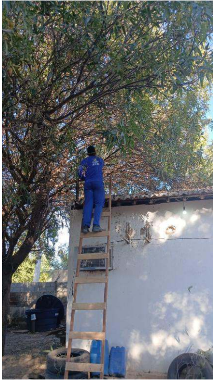
- Remoção de telhado para reparos
