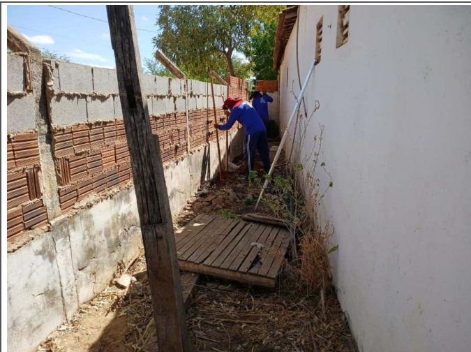
- Escavação para fixação de pilaretes para amarração do muro.
