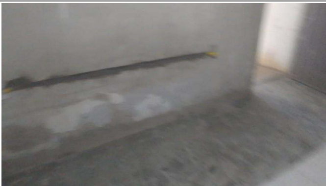
- Colocação de canudite
