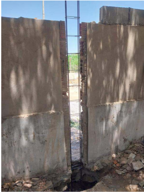
- Colocação de ferragens no muro.
