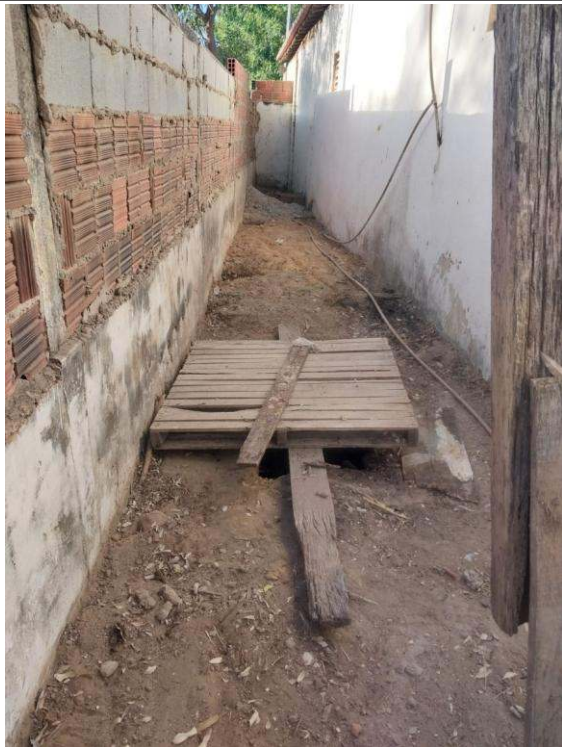
- Recuperação da Base da fossa
