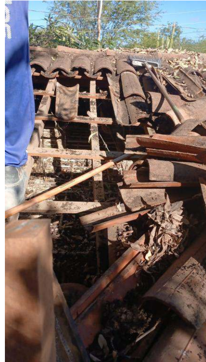
- Remoção de telhado para reparos
