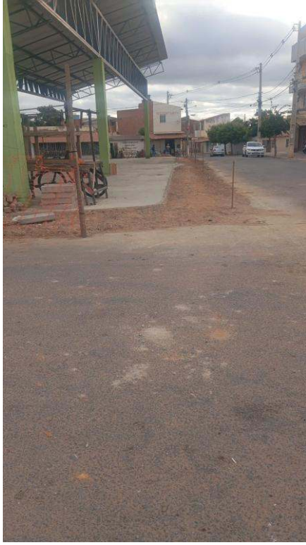
- Retirada de concreto da calçada. - Nivelamento da área
