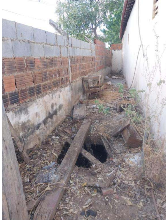
- Limpeza de corredor pra reparos na fossa
