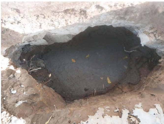
- Colocação de concreto em buracos
