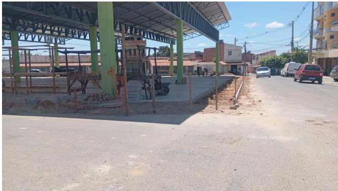
- Colocação de tela de proteção
