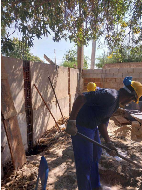
- Colocação de ferragem
