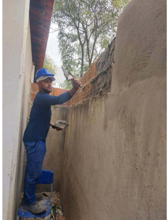
- Acabamento de paredes
