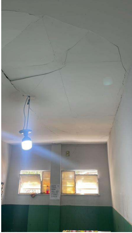
- Demolição do forro de gesso da copa
