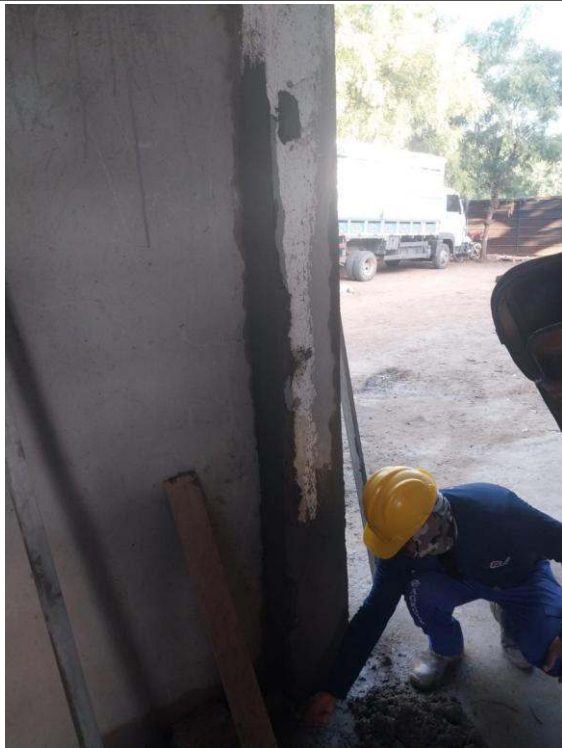
- Acabamento de paredes
