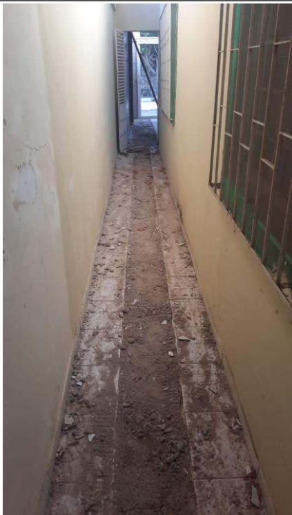
- Escavação para rede de esgoto
