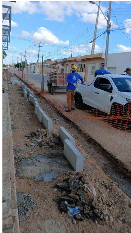
- Descarregamento de meio-fio
