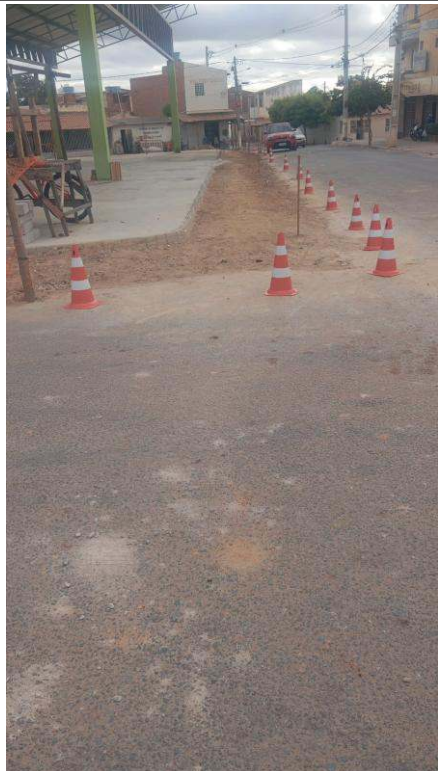
- Retirada de concreto da calçada. - Nivelamento da área
