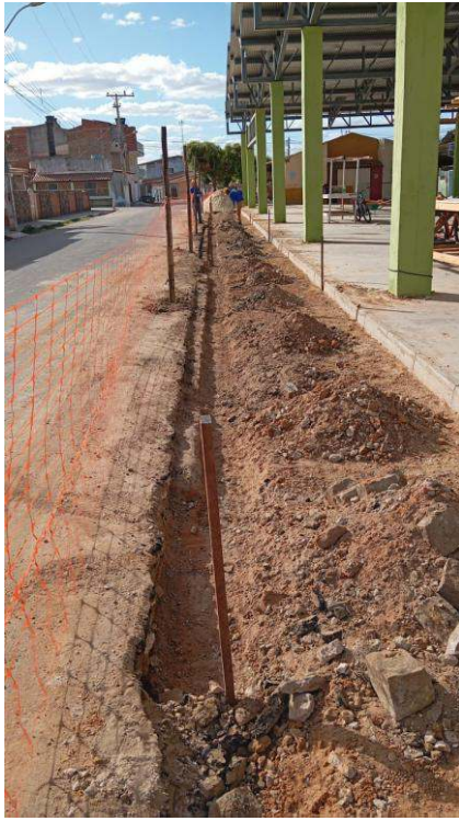
- Nivelamento de terreno
