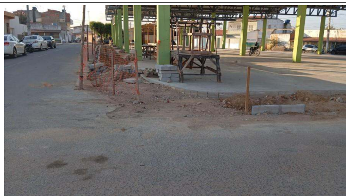
- Finalização de meio fio
