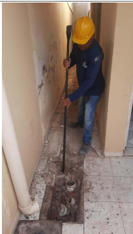
- Escavação para rede de esgoto
