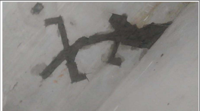
- Colocação de canudite
