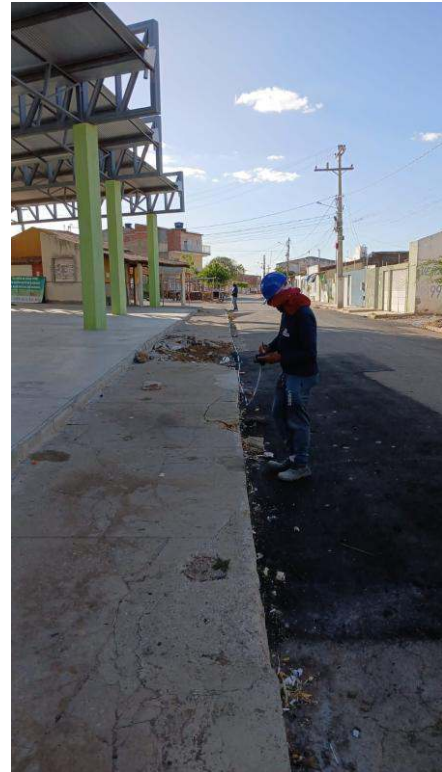
- Colocação de concreto na sarjeta
