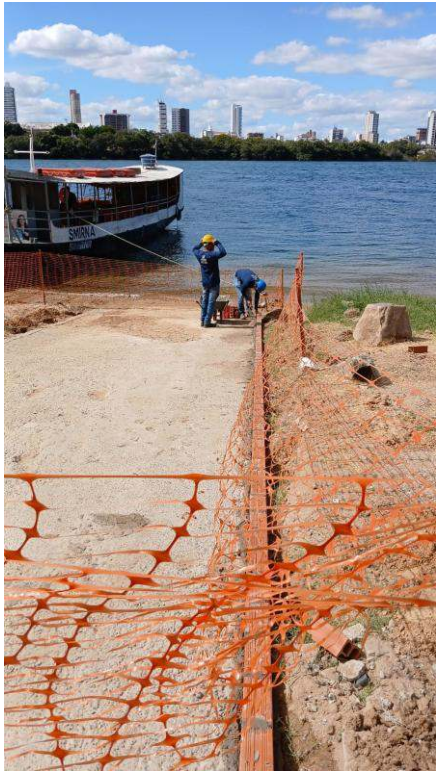
- Assentamento de alvenaria
