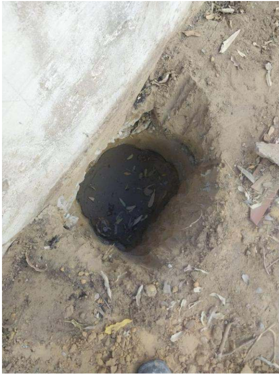
- Colocação de concreto em buracos
