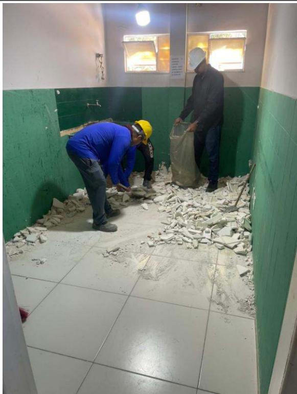
- Demolição do forro de gesso da copa
