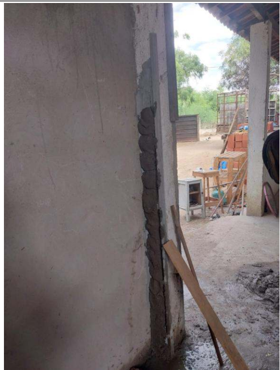
- Acabamento de paredes
