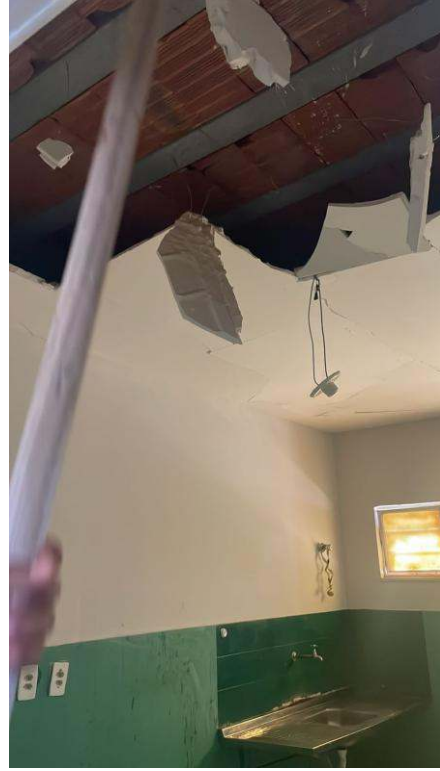
- Demolição do forro de gesso da copa
