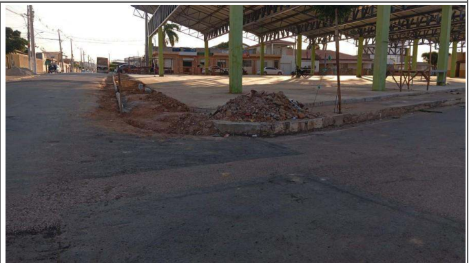
-Escavação de vala pra tubulação -Retirada de areia
