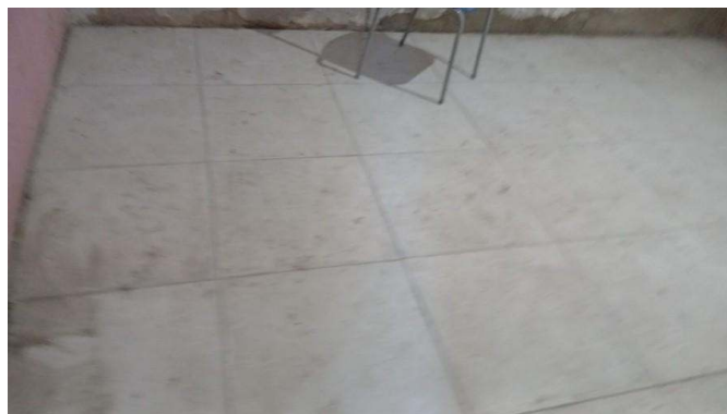
- Rejuntamento de cerâmicas
