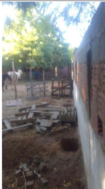
- Escavação de buracos para os pilares
