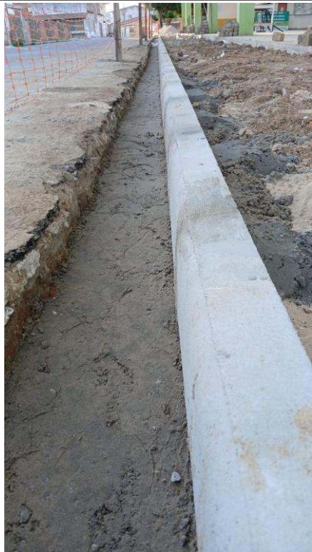
- Chumbamento de meio fio
