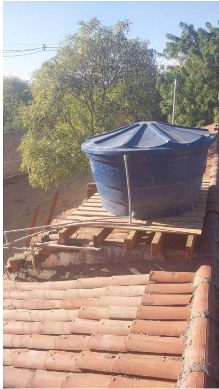
- Finalização de reparo no telhado com substituição de 500 telhas danificadas
