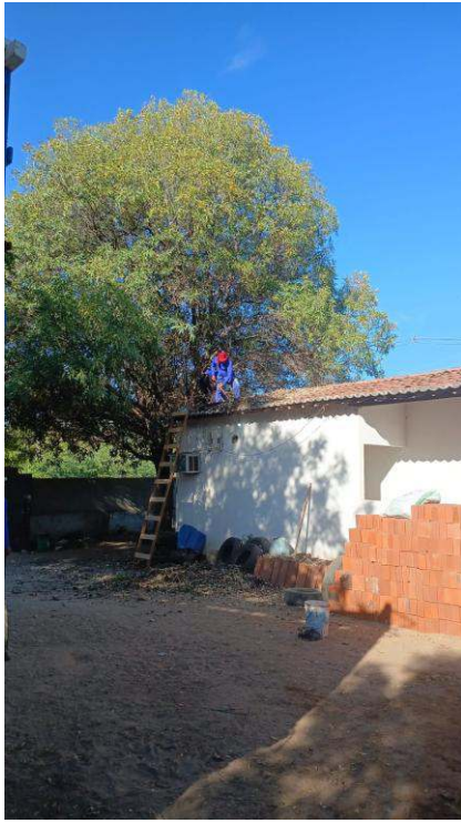
- Remoção de telhado para reparos
