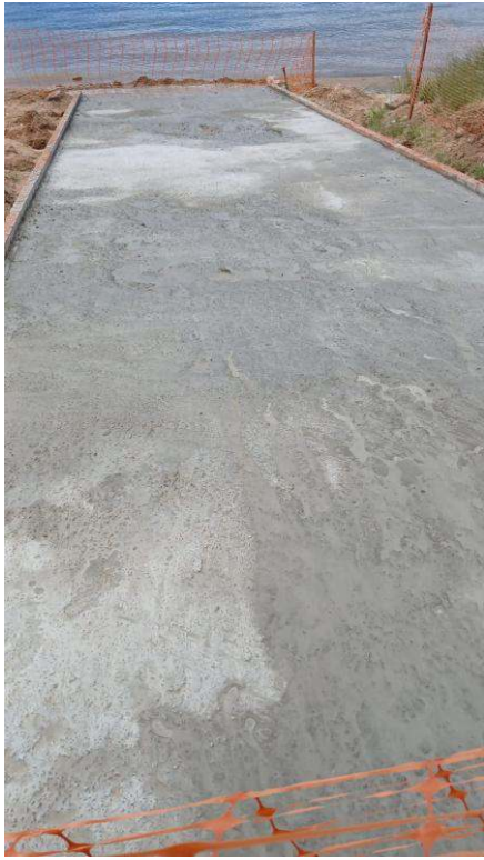
- Colocação de goda de cimento- Organização da área
