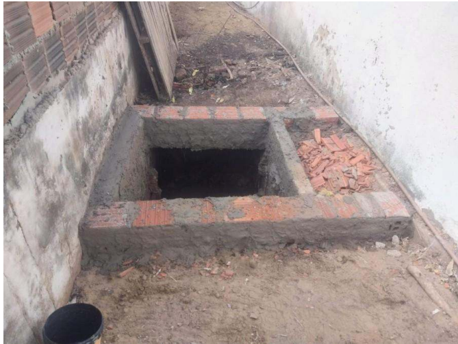
- Recuperação da Base da fossa
