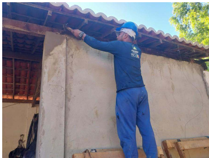
- Acabamento de paredes
