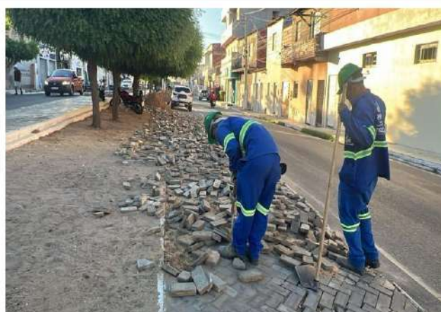
FOTO 08: Remoção de Intertravado.
