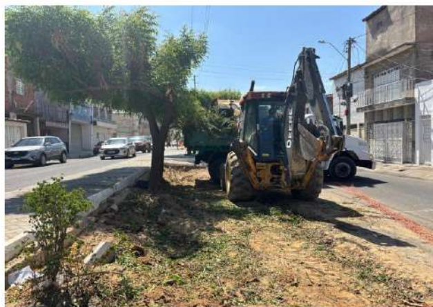
FOTO 10: Carga de Material.
