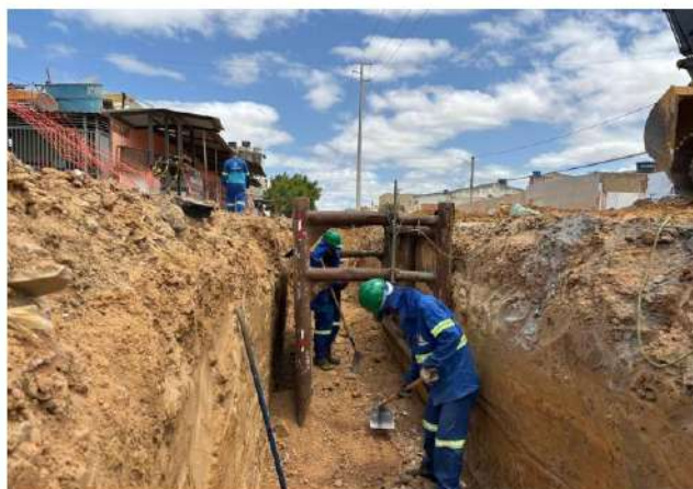
FOTO 03: Escoramento de vala.
