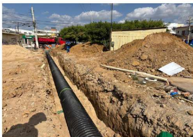
FOTO 05: Assentamento de Tubo PEAD 600mm.
