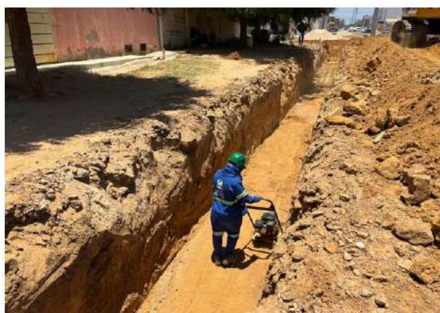
FOTO 02: Regularização e Compactação de Fundo de Vala.
