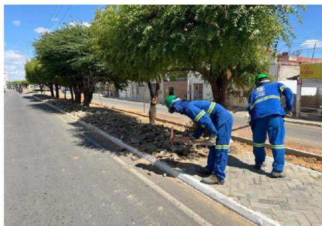
FOTO 09: Remoção de Intertravado.
