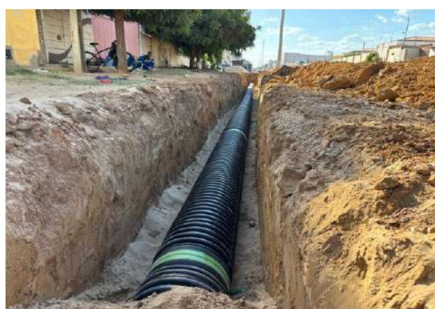
FOTO 04: Assentamento de Tubo PEAD 600mm.
