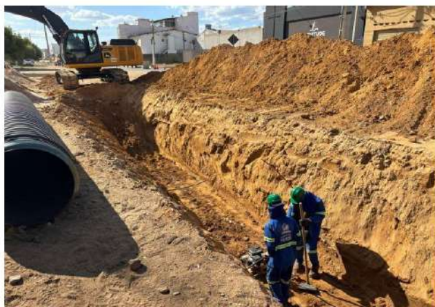
FOTO 01: Regularização e Compactação de Fundo de Vala.
