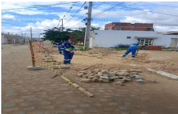
MANUTENÇÃO PAVIMENTO PARALELEPÍPEDO
