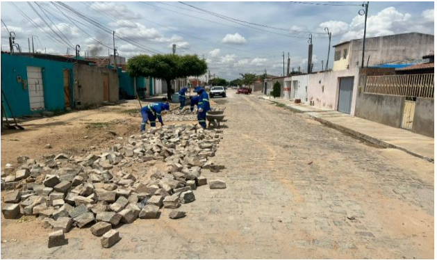
MANUTENÇÃO PAVIMENTO PARALELEPÍPEDO
