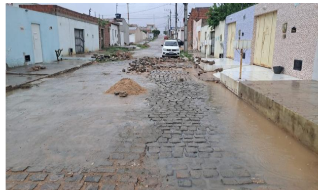
MANUTENÇÃO PAVIMENTO PARALELEPÍPEDO
