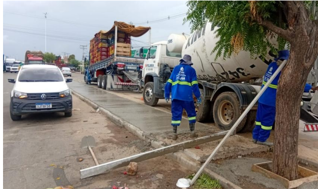
CEASA - CONCRETO USINADO
