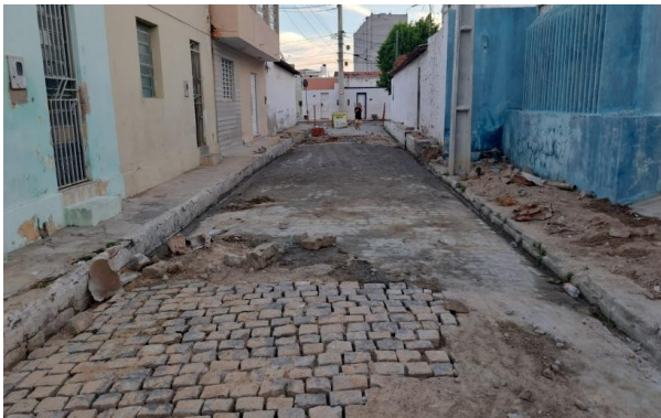
MANUTENÇÃO PAVIMENTO PARALELEPÍPEDO
