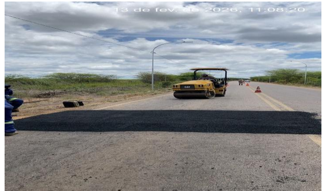
MANDACARU - MANUTENÇÃO PAV ASFÁLTICO
