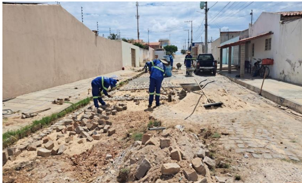
MANUTENÇÃO PAVIMENTO PARALELEPÍPEDO
