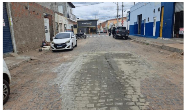
MANUTENÇÃO PAVIMENTO PARALELEPÍPEDO
