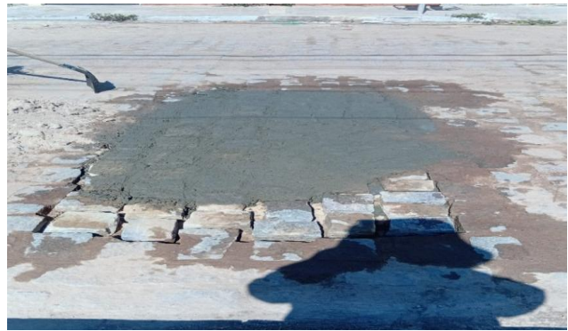
MANUTENÇÃO PAVIMENTO PARALELEPÍPEDO
