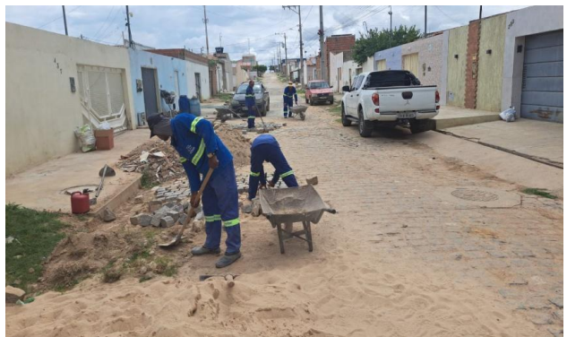
MANUTENÇÃO PAVIMENTO PARALELEPÍPEDO
