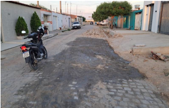
MANUTENÇÃO PAVIMENTO PARALELEPÍPEDO
