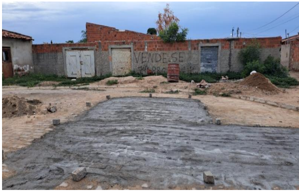
MANUTENÇÃO PAVIMENTO PARALELEPÍPEDO
