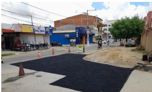
AV SÃO JOAO - MAN PAV ASFÁLTICO
