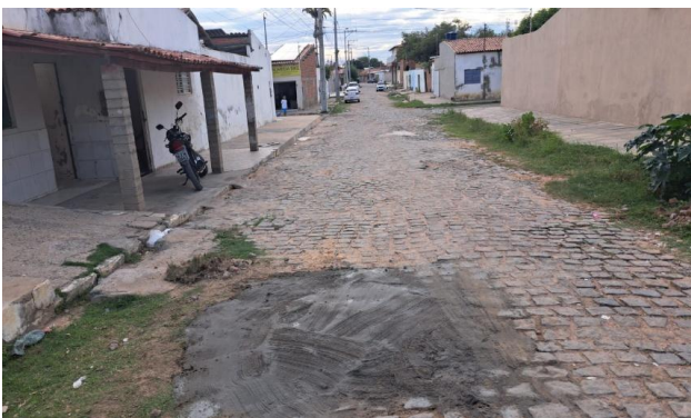
MANUTENÇÃO PAVIMENTO PARALELEPÍPEDO
