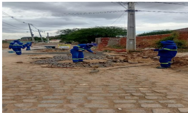
MANUTENÇÃO PAVIMENTO PARALELEPÍPEDO
