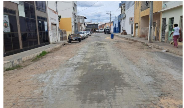
MANUTENÇÃO PAVIMENTO PARALELEPÍPEDO
