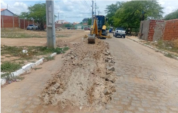
MANUTENÇÃO PAVIMENTO PARALELEPÍPEDO
