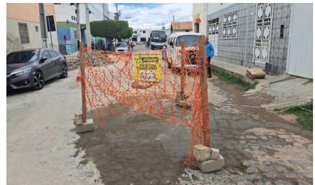
MANUTENÇÃO PAVIMENTO PARALELEPÍPEDO
