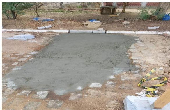
MANUTENÇÃO PAVIMENTO PARALELEPÍPEDO
