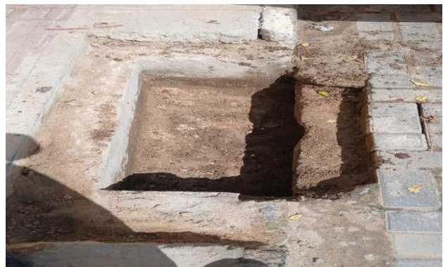
RES. DR HUMBERTO - DESOBSTRUÇÃO DE CAIXA
