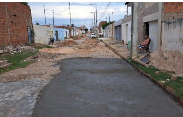
MANUTENÇÃO PAVIMENTO PARALELEPÍPEDO
