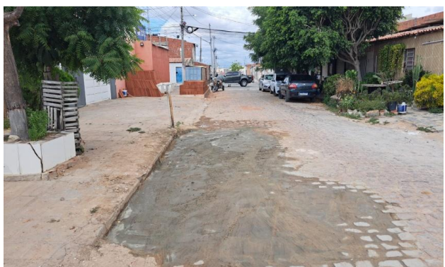
MANUTENÇÃO PAVIMENTO PARALELEPÍPEDO
