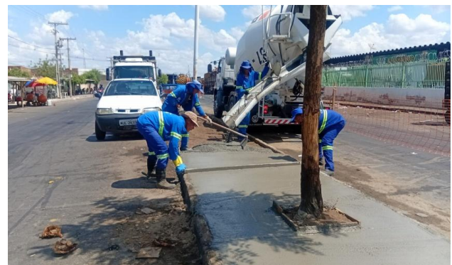
CEASA - CONCRETO USINADO
