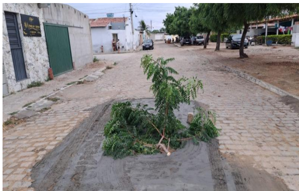
MANUTENÇÃO PAVIMENTO PARALELEPÍPEDO
