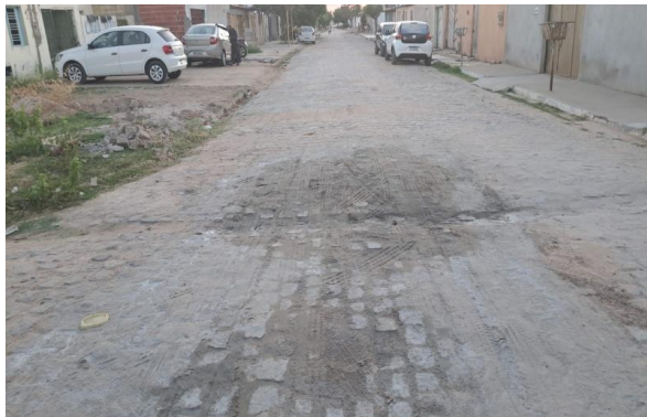
MANUTENÇÃO PAVIMENTO PARALELEPÍPEDO
