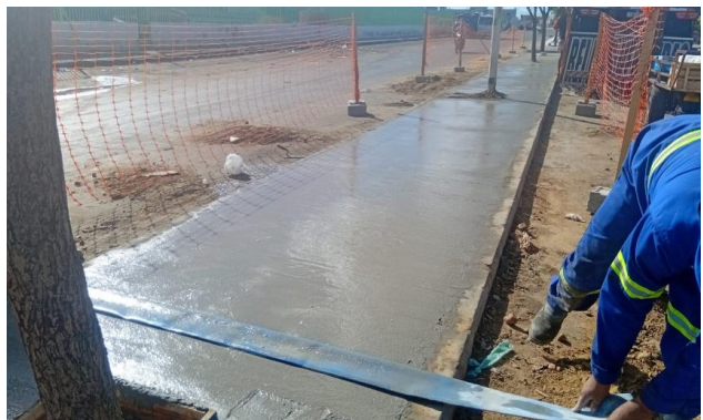
CEASA - CONCRETO USINADO
