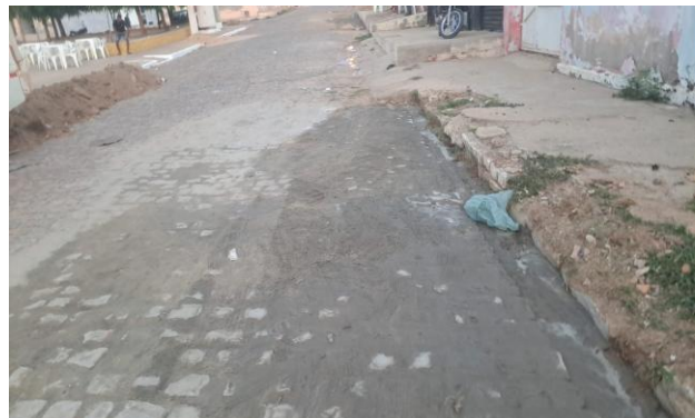
MANUTENÇÃO PAVIMENTO PARALELEPÍPEDO
