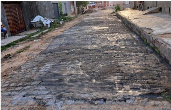
MANUTENÇÃO PAVIMENTO PARALELEPÍPEDO
