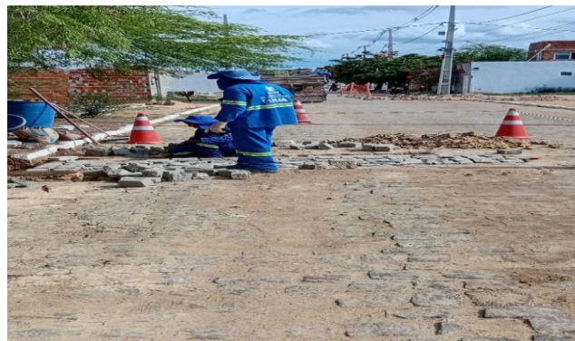
MANUTENÇÃO PAVIMENTO PARALELEPÍPEDO
