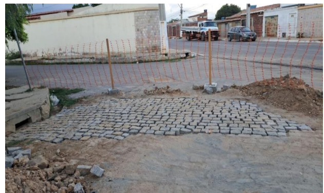
MANUTENÇÃO PAVIMENTO PARALELEPÍPEDO
