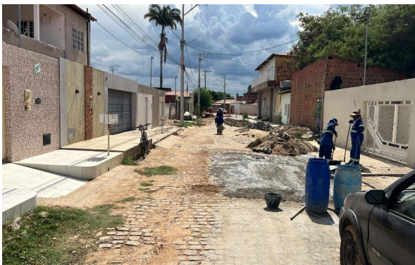
MANUTENÇÃO PAVIMENTO PARALELEPÍPEDO
