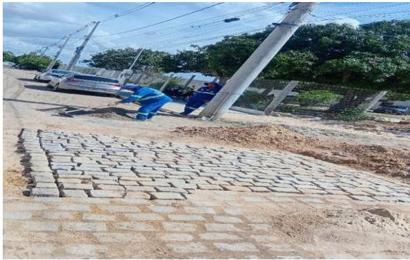
MANUTENÇÃO PAVIMENTO PARALELEPÍPEDO
