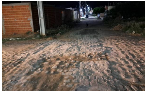
MANUTENÇÃO PAVIMENTO PARALELEPÍPEDO
