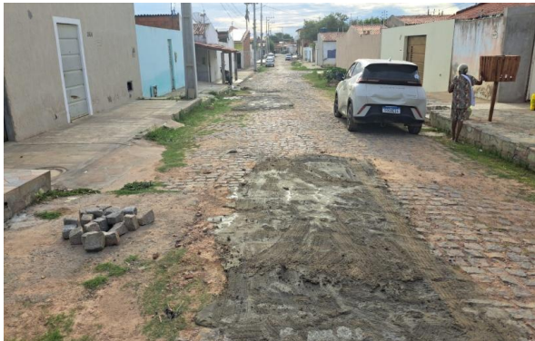
MANUTENÇÃO PAVIMENTO PARALELEPÍPEDO
