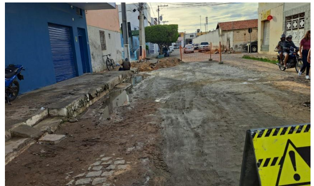
MANUTENÇÃO PAVIMENTO PARALELEPÍPEDO
