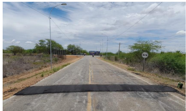
MANDACARU - MANUTENÇÃO PAV ASFÁLTICO
