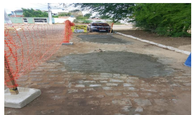
MANUTENÇÃO PAVIMENTO PARALELEPÍPEDO
