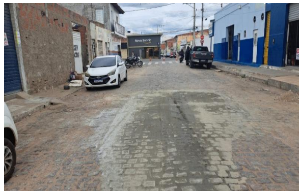
MANUTENÇÃO PAVIMENTO PARALELEPÍPEDO
