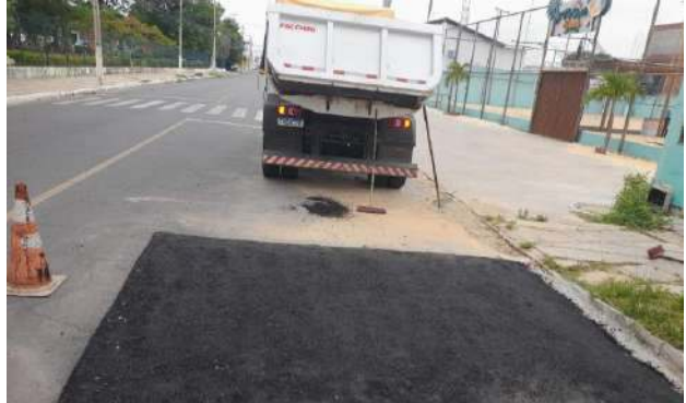
AV SÃO FRANCISCO - MAN. PAV. ASFÁLTICO
