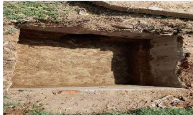
TRAVESSA DA VERDADE - DESOBSTRUÇÃO DE CAIXAS
