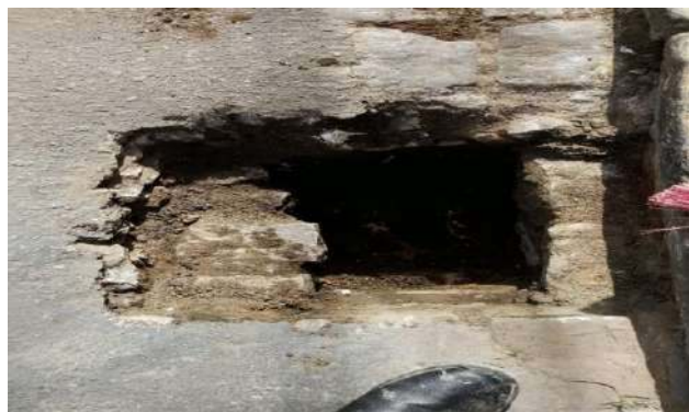
R EDSON RIBEIRO - DESOBSTRUÇÃO DE CAIXAS
