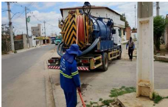
R SEBASTIÃO ALMEIDA - SERVIÇO DE SEWERKET
