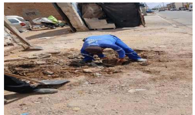
AV PEDRA DO LORD - DESOBSTRUÇÃO DE CAIXAS
