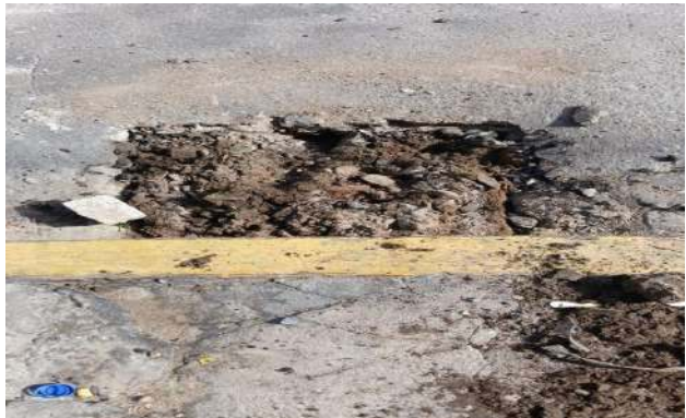
R EDSON RIBEIRO - DESOBSTRUÇÃO DE CAIXAS
