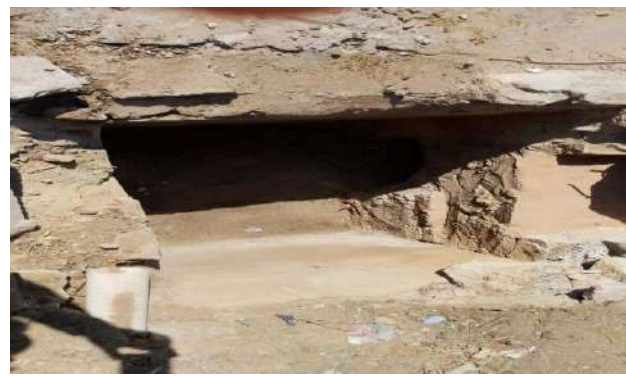
AV CRISTALINA - DESOBSTRUÇÃO DE CAIXAS
