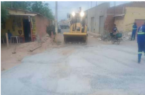
R JOSÉ ANCHEITA - MAN. PAVIMENTO ASFÁLTICO
