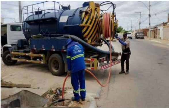
R SEBASTIÃO ALMEIDA - SERVIÇO DE SEWERKET
