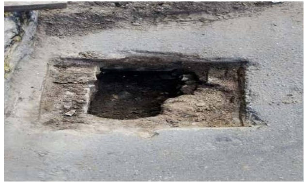
R EDSON RIBEIRO - DESOBSTRUÇÃO DE CAIXAS
