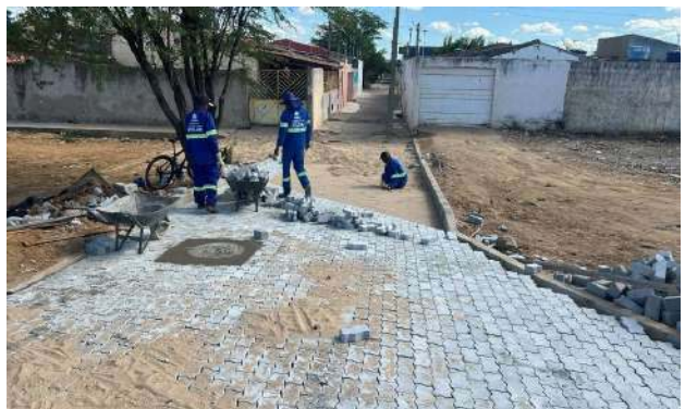
DOM JOSÉ RODRIGUES - MAN. PAV. INTERTRAVADO
