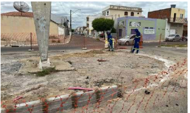
AV LUIS INÁCIO - ASSENTAMENTO DE MEIO FIO
