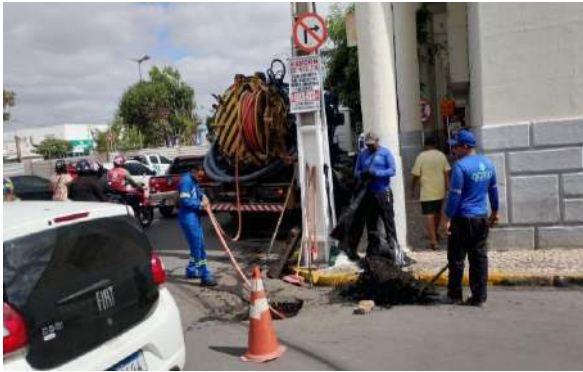
R EDSON RIBEIRO - SERVIÇO DE SEWERKET
