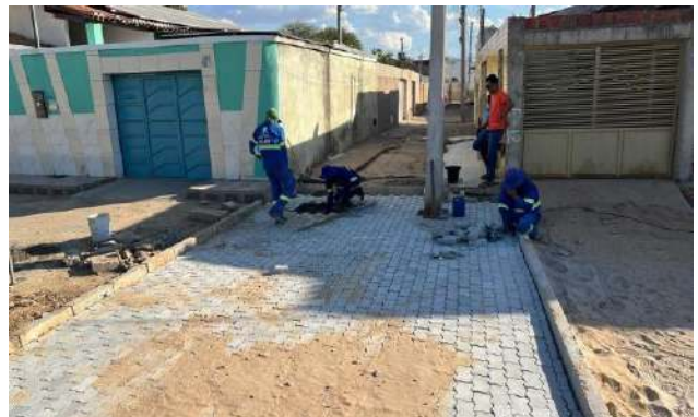
DOM JOSÉ RODRIGUES - MAN. PAV. INTERTRAVADO
