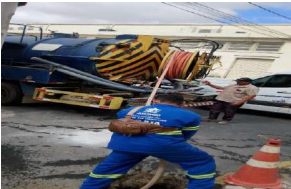
R EDSON RIBEIRO - SERVIÇO DE SEWERKET
