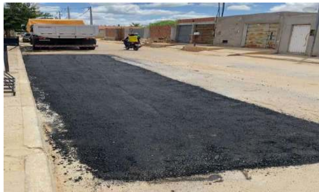
AV GIRASSOL - MANUTENÇÃO PAV ASFÁLTICO
