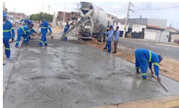
AV LUIS INÁCIO - CONCRETO ARMADO LAJE
