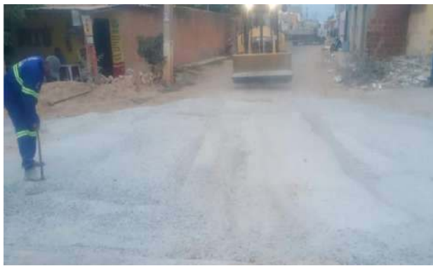
R JOSÉ ANCHEITA - MAN. PAVIMENTO ASFÁLTICO
