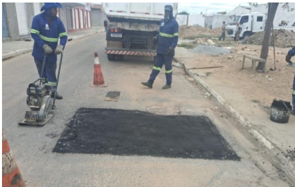
AV IRMÃ DULCE - MAN. PAVIMENTO ASFÁLTICO
