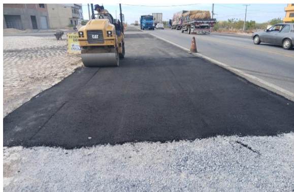
CARNAÍBA DO SERTÃO - MANUTENÇÃO PAV. ASFALTO
