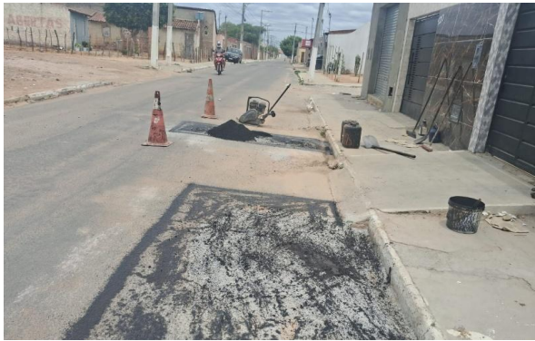
AV IRMÃ DULCE - MAN. PAVIMENTO ASFÁLTICO
