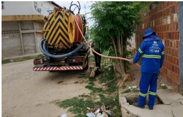
R SEBASTIÃO ALMEIDA - SERVIÇO DE SEWERKET
