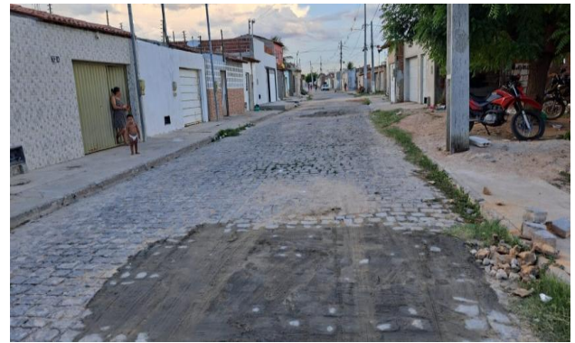
R BENTO GONÇALVES - MAN. PAV. PARALELEPÍPEDO
