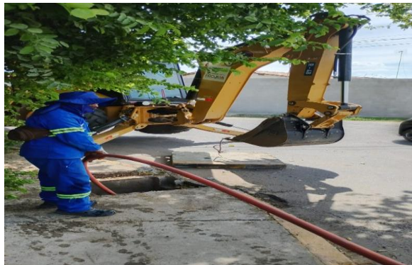
AV PEDRA DO LORD - SERVIÇO DE SEWERKET
