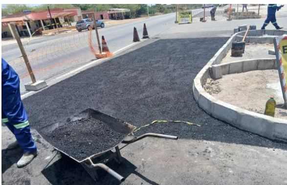
CARNAÍBA DO SERTÃO - MANUTENÇÃO PAV. ASFALTO
