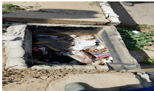
R SEVERO - DESOBSTRUÇÃO DE CAIXAS
