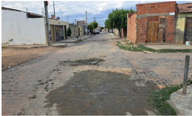
R BENTO GONÇALVES - MAN. PAV. PARALELEPÍPEDO
