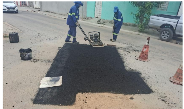
AV IRMÃ DULCE - MAN. PAVIMENTO ASFÁLTICO
