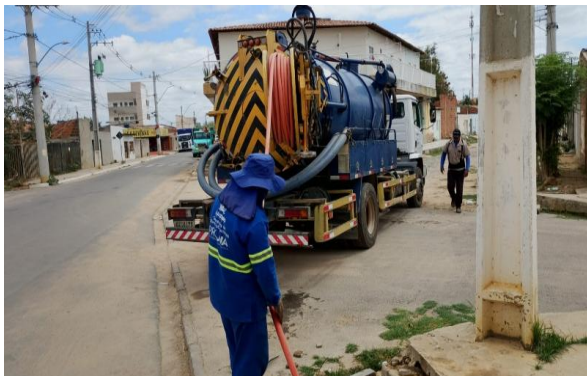
R SEBASTIÃO ALMEIDA - SERVIÇO DE SEWERKET
