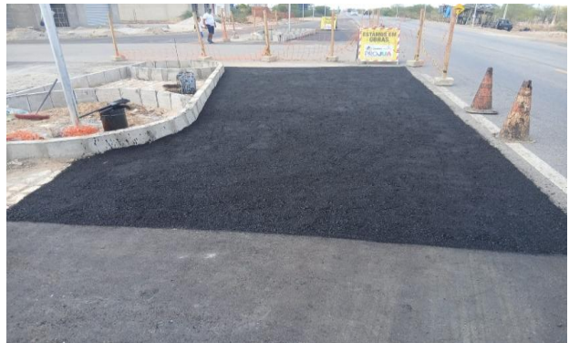
CARNAÍBA DO SERTÃO - MANUTENÇÃO PAV. ASFALTO
