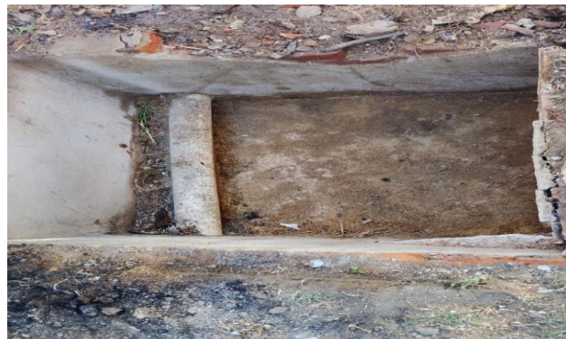
AV MALHADA DA AREIA - DESOBSTRUÇÃO DE CAIXAS
