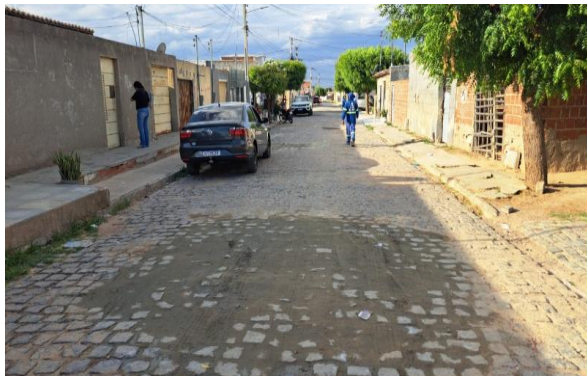
R BENTO GONÇALVES - MAN. PAV. PARALELEPÍPEDO
