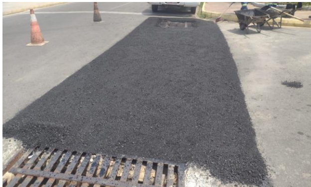
AV OSCAR RIBEIRO - MANUTENÇÃO PAV. ASFALTO
