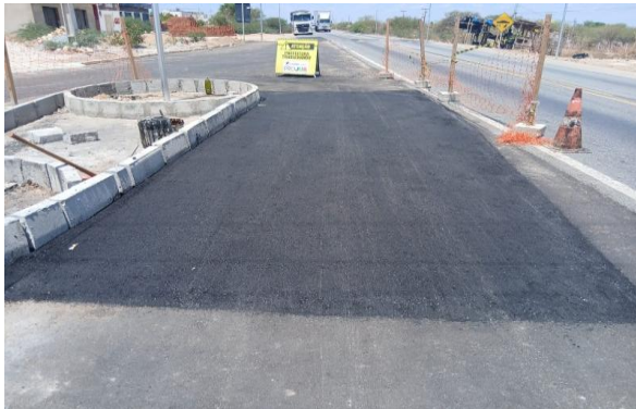
CARNAÍBA DO SERTÃO - MANUTENÇÃO PAV. ASFALTO
