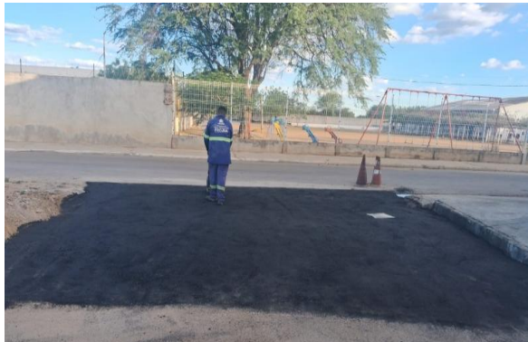
AV IRMÃ DULCE - MAN. PAVIMENTO ASFÁLTICO
