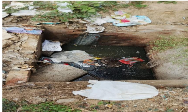
AV MALHADA DA AREIA - DESOBSTRUÇÃO DE CAIXAS
