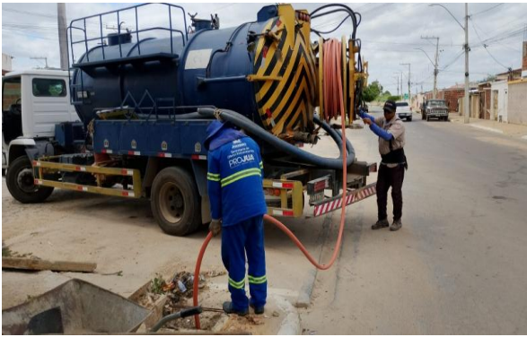
R SEBASTIÃO ALMEIDA - SERVIÇO DE SEWERKET
