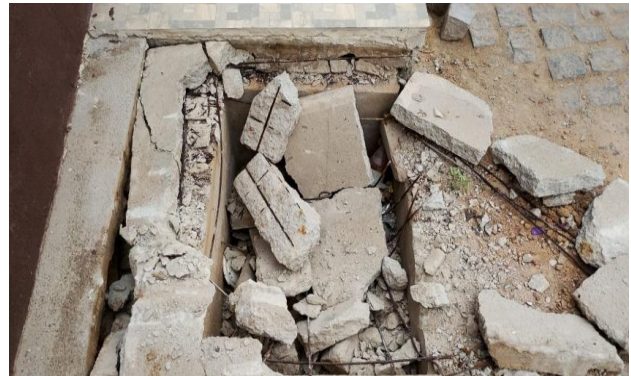
AV PEDRA DO LORD - DESOBSTRUÇÃO DE CAIXAS
