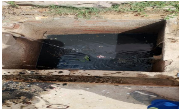
AV MALHADA DA AREIA - DESOBSTRUÇÃO DE CAIXAS
