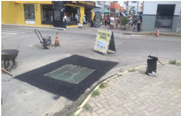
AV OSCAR RIBEIRO - MANUTENÇÃO PAV. ASFALTO
