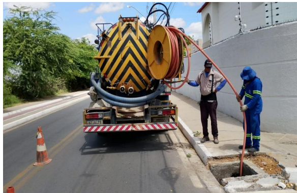
R SEVERO - SERVIÇO DE SEWERKET
