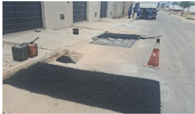
AV IRMÃ DULCE - MAN. PAVIMENTO ASFÁLTICO
