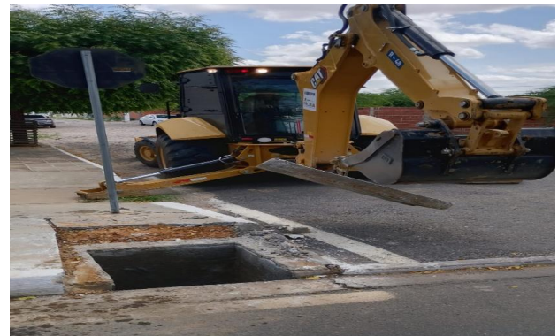
R SEVERO - DESOBSTRUÇÃO DE CAIXAS
