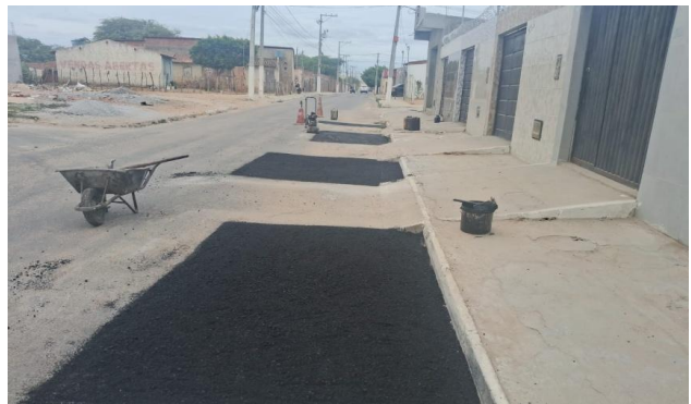
AV IRMÃ DULCE - MAN. PAVIMENTO ASFÁLTICO
