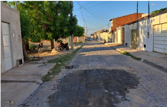
R BENTO GONÇALVES - MAN. PAV. PARALELEPÍPEDO
