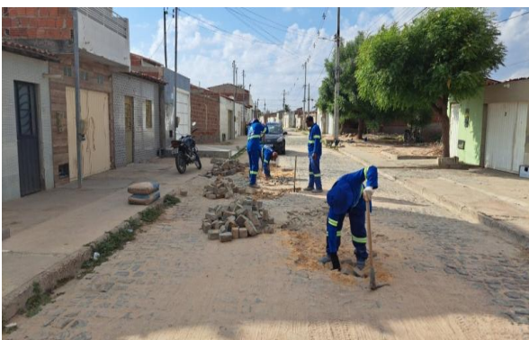
R BENTO GONÇALVES - MAN. PAV. PARALELEPÍPEDO
