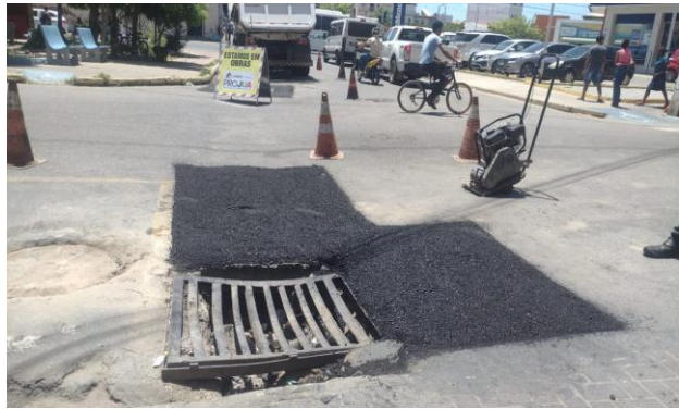
AV OSCAR RIBEIRO - MANUTENÇÃO PAV. ASFALTO
