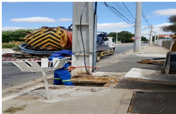
R SEVERO - SERVIÇO DE SEWERKET
