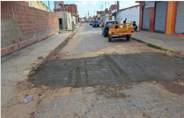
R BENTO GONÇALVES - MAN. PAV. PARALELEPÍPEDO
