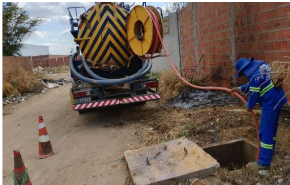
AV MALHADA DA AREIA - SERVIÇO DE SEWERKET
