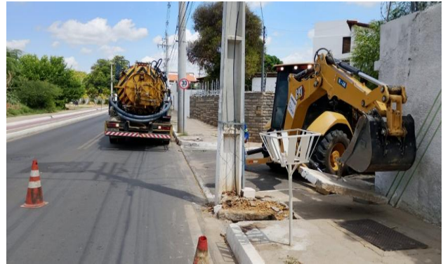
R SEVERO - DESOBSTRUÇÃO DE CAIXAS
