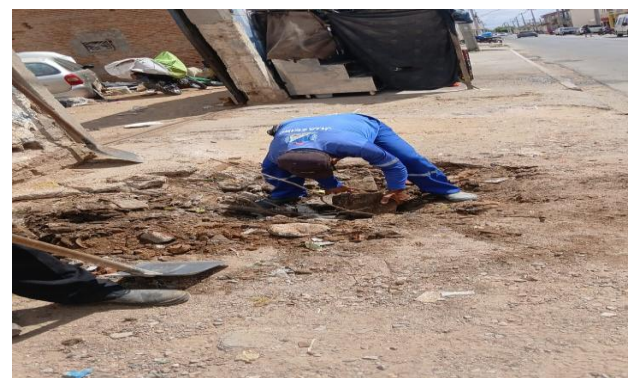
AV PEDRA DO LORD - DESOBSTRUÇÃO DE CAIXAS
