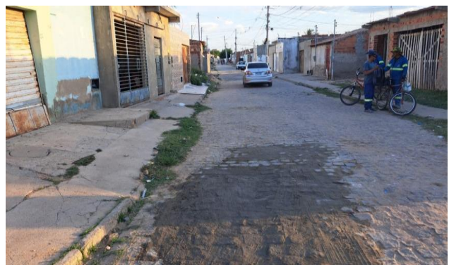
R BENTO GONÇALVES - MAN. PAV. PARALELEPÍPEDO
