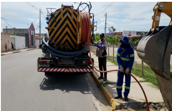
AV PEDRA DO LORD - SERVIÇO DE SEWERKET
