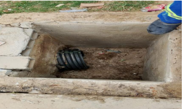
R SEBASTIÃO ALMEIDA - DESOBSTRUÇÃO DE CAIXAS
