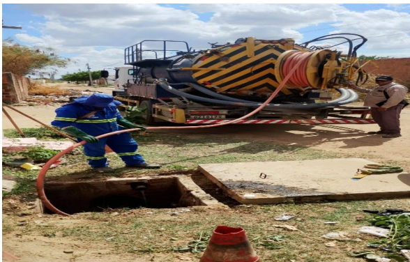
AV MALHADA DA AREIA - SERVIÇO DE SEWERKET
