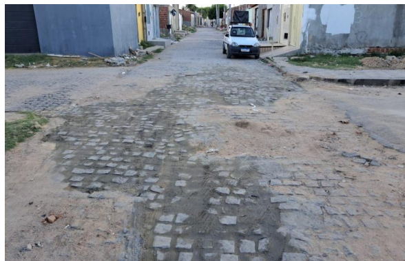
R BENTO GONÇALVES - MAN. PAV. PARALELEPÍPEDO
