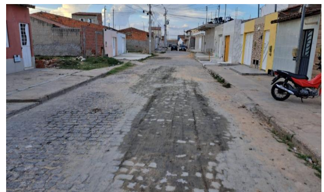
R BENTO GONÇALVES - MAN. PAV. PARALELEPÍPEDO
