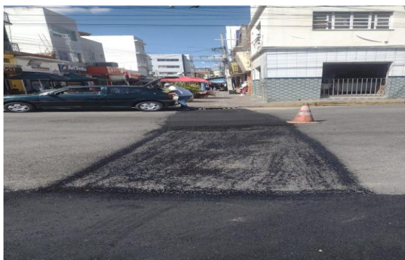
AV OSCAR RIBEIRO - MANUTENÇÃO PAV. ASFALTO
