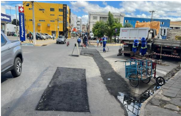
AV OSCAR RIBEIRO - MANUTENÇÃO PAV. ASFALTO
