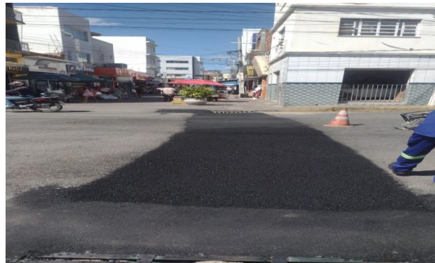
AV OSCAR RIBEIRO - MANUTENÇÃO PAV. ASFALTO
