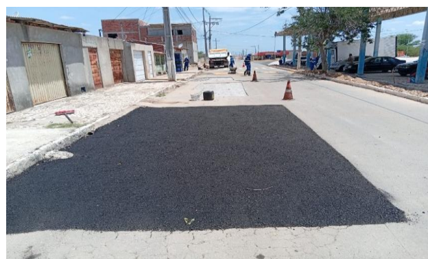
CARNAÍBA DO SERTÃO - MANUTENÇÃO PAV. ASFALTO
