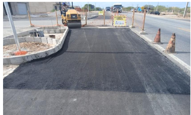
CARNAÍBA DO SERTÃO - MANUTENÇÃO PAV. ASFALTO
