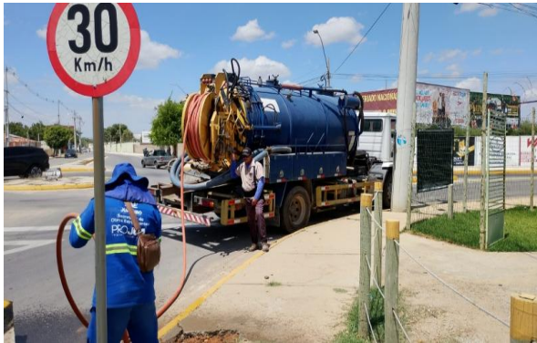
AV PEDRA DO LORD - SERVIÇO DE SEWERKET
