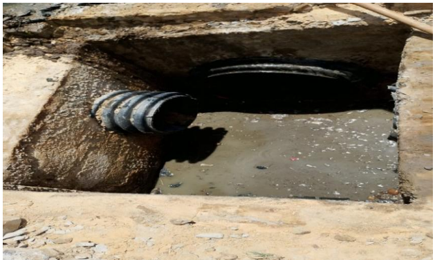
R SEBASTIÃO ALMEIDA - DESOBSTRUÇÃO DE CAIXAS
