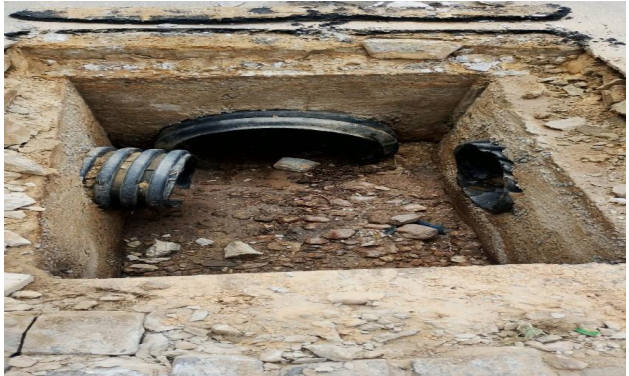
R SEBASTIÃO ALMEIDA - DESOBSTRUÇÃO DE CAIXAS
