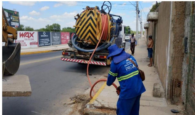
AV PEDRA DO LORD - DESOBSTRUÇÃO DE CAIXAS
