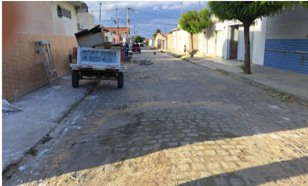
R BENTO GONÇALVES - MAN. PAV. PARALELEPÍPEDO
