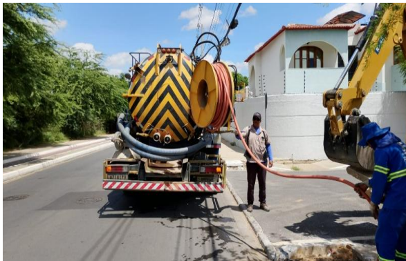
R SEVERO - SERVIÇO DE SEWERKET
