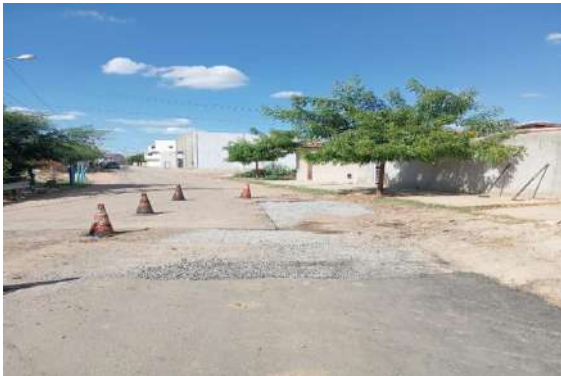
AV MARIA DA GLÓRIA - MAN. PAVIMENTO ASFÁLTICO
