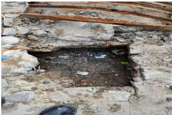
AV ADOLFO VIANA - DESOBSTRUÇÃO BOCA DE LOBO
