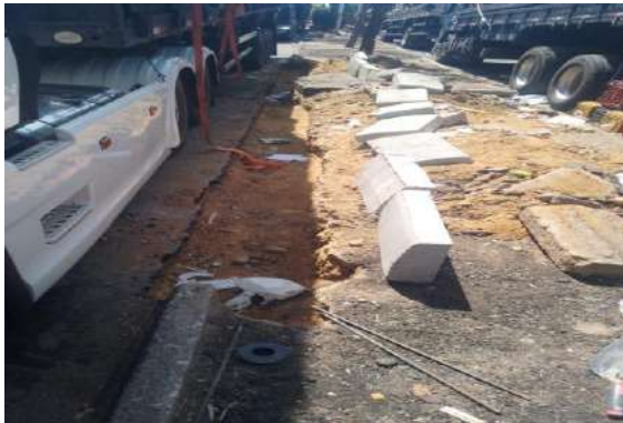
CEASA - ESCAVAÇÃO MANUAL
