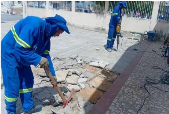
JUREMAL - DEMOLIÇÃO DE PISO DE CONCRETO
