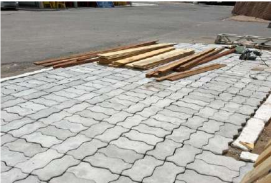
JUREMAL - MANUTENÇÃO PISO INTERTRAVADO
