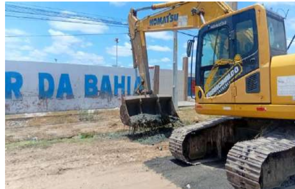
BA210 - DIÁRIA ESCAVADEIRA
