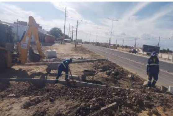
BA210 - ASSENTAMENTO DE MEIO FIO
