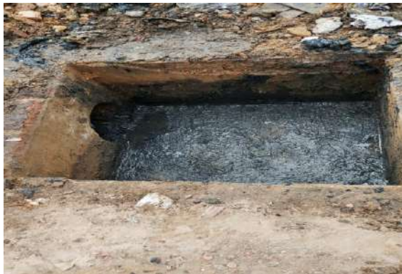
AV GIRASSOL - DESOBSTRUÇÃO BOCA DE LOBO
