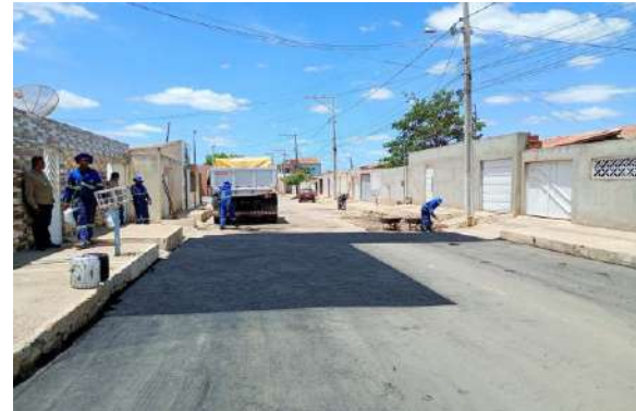
JARDIM PRIMAWEIRA - MAN. PAVIMENTO ASFÁLTICO
