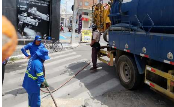
AV ADOLFO VIANA - SEWERJET
