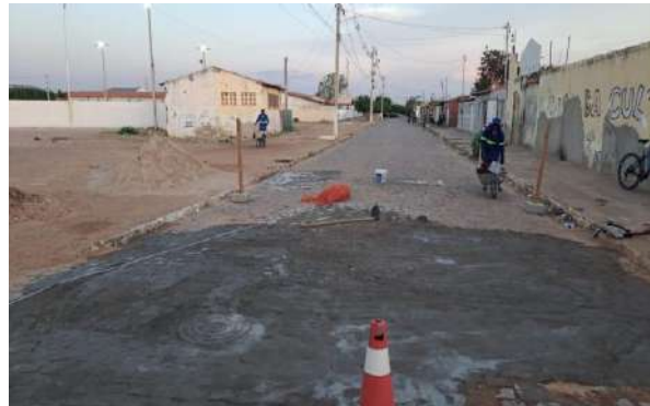
R DAS ALGAROBAS - MAN PAV PARALELEPÍPEDO
