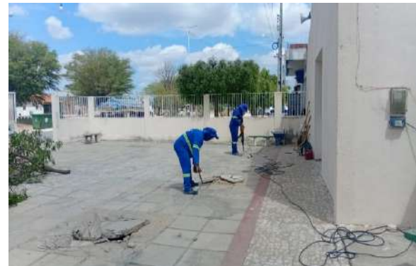
JUREMAL - DEMOLIÇÃO DE PISO DE CONCRETO
