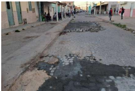
R. BENTO GONÇALVES - MAN. PAV PARALELEPÍPEDO
