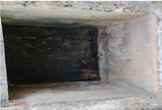
PIRANGA - DESOBSTRUÇÃO BOCA DE LOBO
