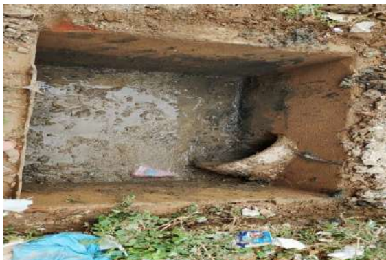
AV GIRASSOL - DESOBSTRUÇÃO BOCA DE LOBO
