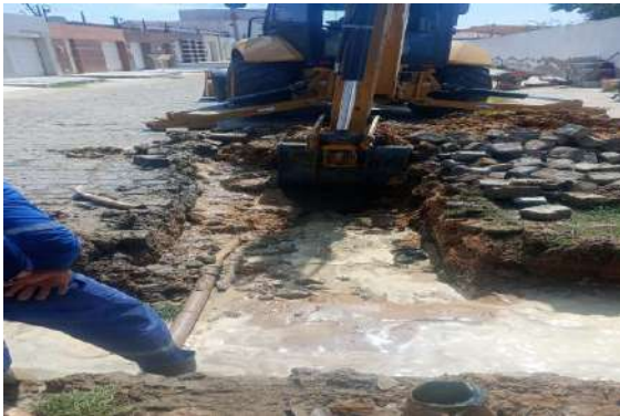
DEAN - ESCAVAÇÃO MECANIZADA
