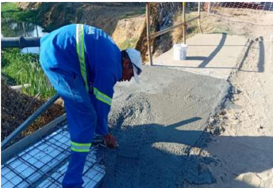
AV RAUL ALVES - LAJE DE CONCRETO ARMADO
