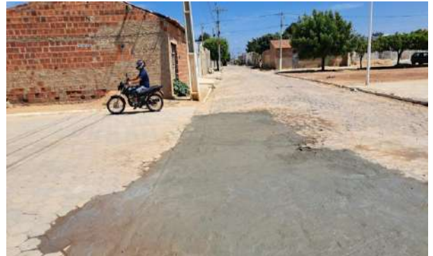
RUA G E RUA I - MANUT. PAV. PARALELEPÍPEDO
