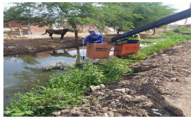
CANAL JUAZEIRO - SERVIÇO DE MUNCK
