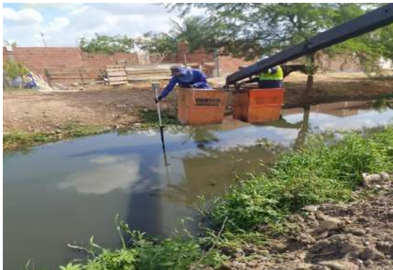
CANAL JUAZEIRO - SERVIÇO DE MUNCK
