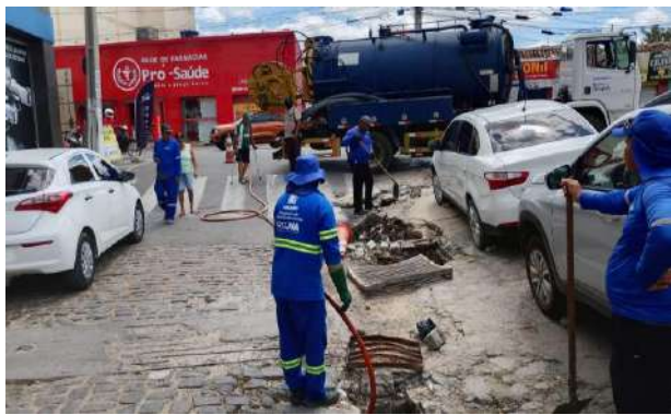
AV ADOLFO VIANA - SEWERJET
