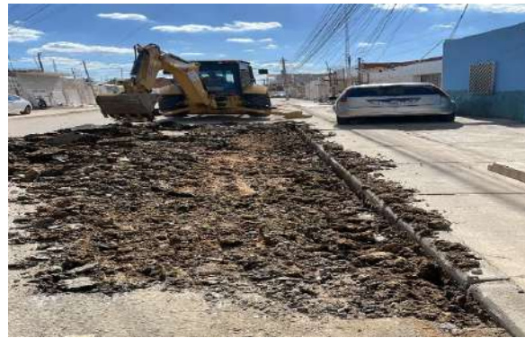
R. BENTO GONÇALVES - ESCAVAÇÃO MECANIZADA
