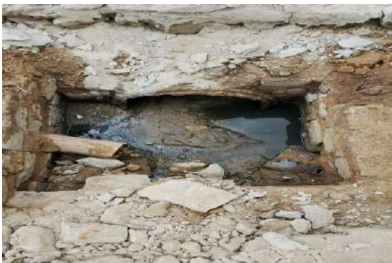
DEAN - DESOBSTRUÇÃO BOCA DE LOBO
