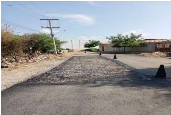
AV MARIA DA GLÓRIA - MAN. PAVIMENTO ASFÁLTICO
