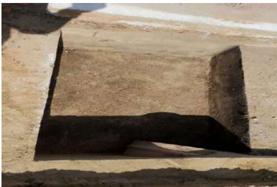
AV AMERICO TANURY - DESOBSTRUÇÃO DE BOCA DE LOBO
