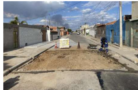
R RAUL ROSA - MAN. PAVIMENTO ASFÁLTICO
