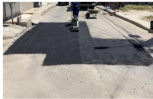
R RAUL ROSA - MAN. PAVIMENTO ASFÁLTICO
