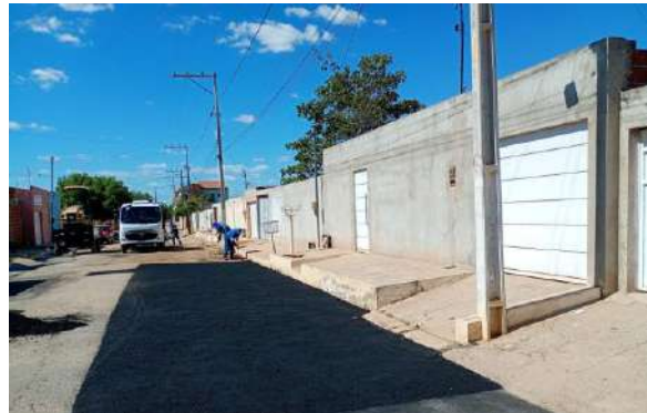
JARDIM PRIMAWEIRA - MAN. PAVIMENTO ASFÁLTICO
