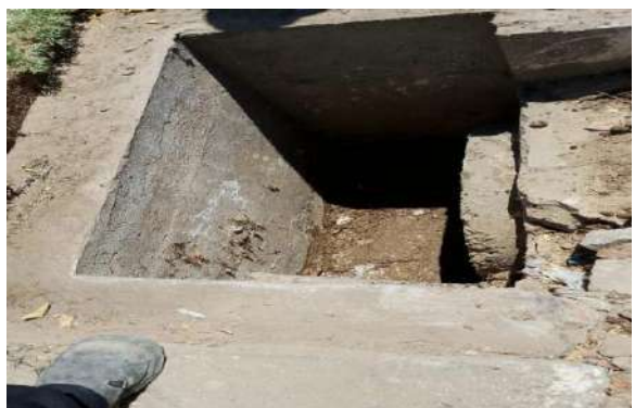
AV LUIZ INÁCIO - SEWERJET
