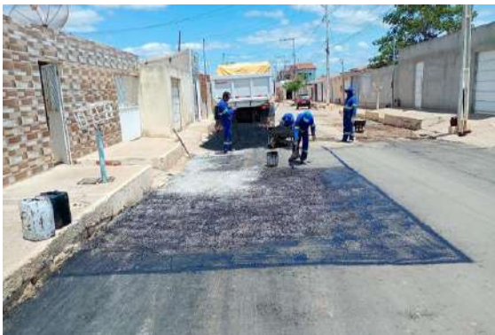
JARDIM PRIMAWEIRA - APLICAÇÃO DE BGS
