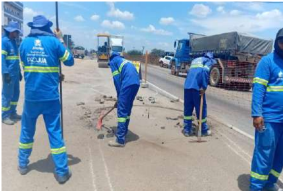
CARNAÍBA DO SERTÃO - CORTE DO ASFALTO
