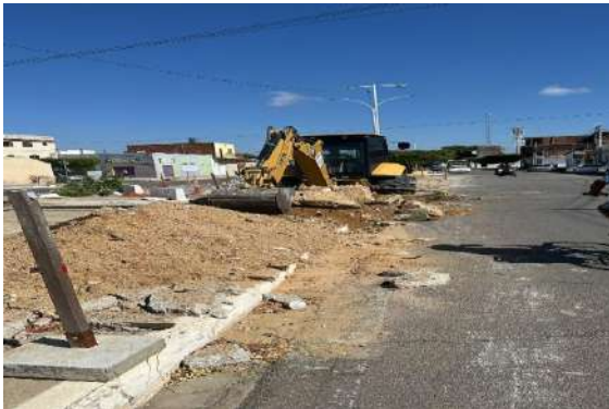
AV LUIZ INÁCIO - ESCAVAÇÃO MECANIZADA
