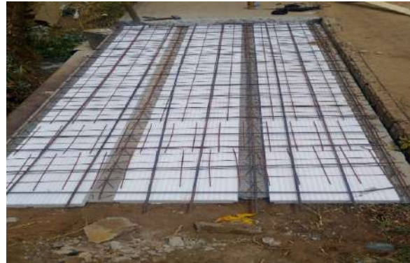
AV RAUL ALVES - LAJE DE CONCRETO ARMADO
