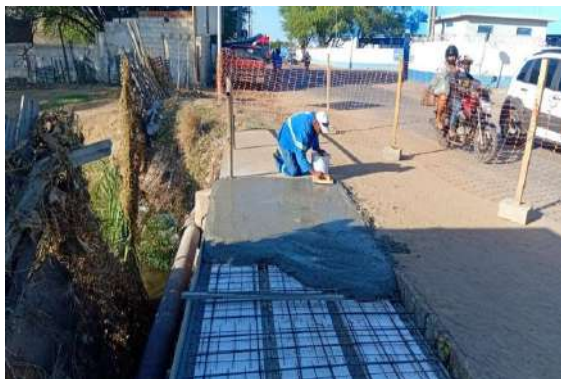
AV RAUL ALVES - LAJE DE CONCRETO ARMADO
