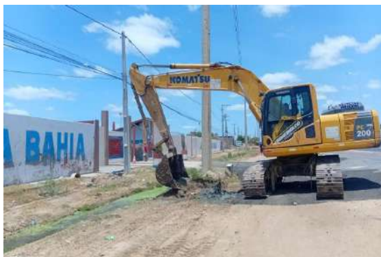
BA210 - DIÁRIA ESCAVADEIRA
