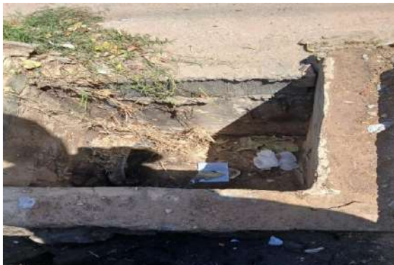
AV PEDRA DO LORD - DESOBSTRUÇÃO BOCA DE LOBO
