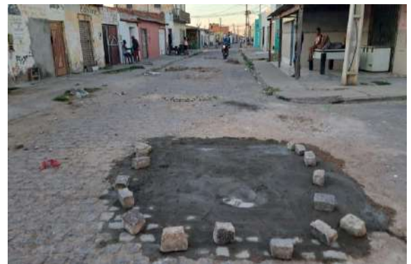
R. BENTO GONÇALVES - MAN. PAV PARALELEPÍPEDO
