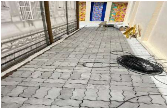
JUREMAL - MANUTENÇÃO PISO INTERTRAVADO
