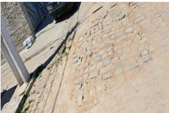
RUA G E RUA I - MANUT. PAV. PARALELEPÍPEDO
