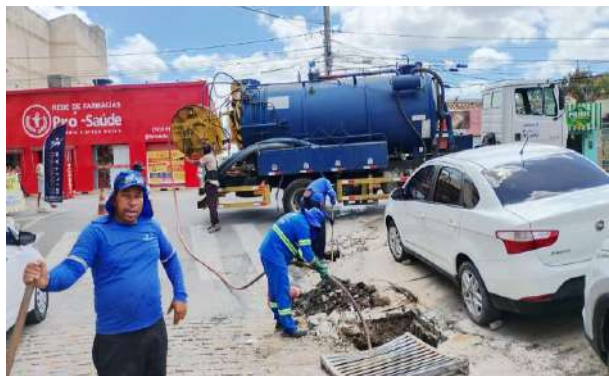
AV ADOLFO VIANA - SEWERJET
