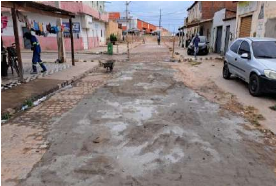
R. BENTO GONÇALVES - MAN. PAV PARALELEPÍPEDO
