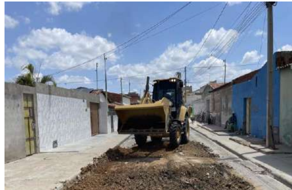
R. RAUL ROSA - ESCAVAÇÃO MECANIZADA
