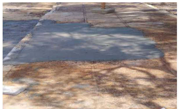
1º DE MAIO - CONCRETO PASSEIO
