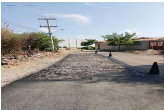
DISTRITO INDUSTRIAL - MAN. PAVIM. ASFÁLTICO
