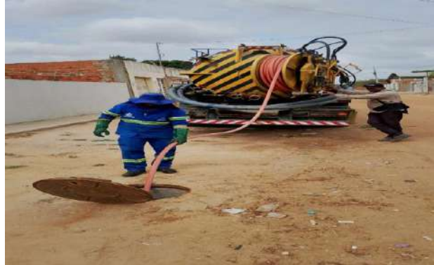
AV GIRASSOL - SEWERJET
