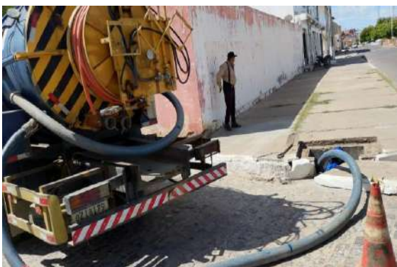
AV LUIZ INÁCIO - SEWERJET
