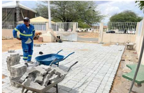
JUREMAL - MANUTENÇÃO PISO INTERTRAVADO
