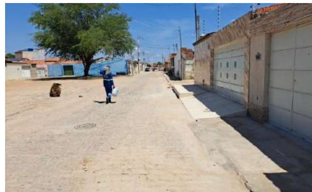
RUA G E RUA I - MANUT. PAV. PARALELEPÍPEDO
