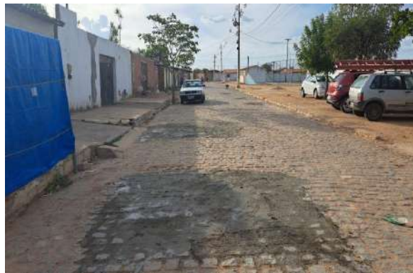
R DAS ALGAROBAS - MAN PAV PARALELEPÍPEDO
