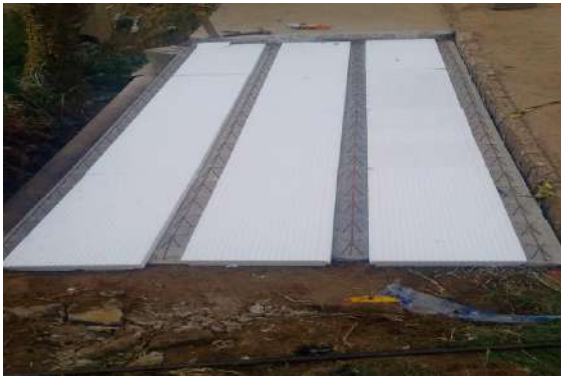
AV RAUL ALVES - LAJE DE CONCRETO ARMADO
