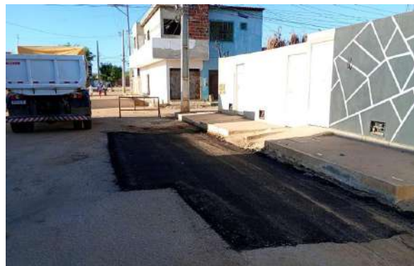
JARDIM PRIMAWEIRA - MAN. PAVIMENTO ASFÁLTICO
