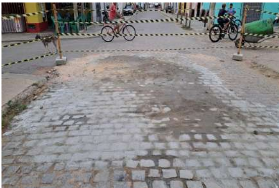
R. BENTO GONÇALVES - MAN. PAV PARALELEPÍPEDO
