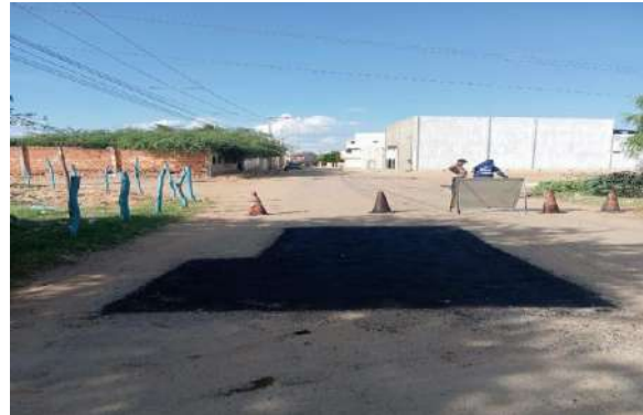
AV MARIA DA GLÓRIA - MAN. PAVIMENTO ASFÁLTICO
