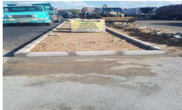
CEASA - ASSENTAMENTO DE MEIO FIO
