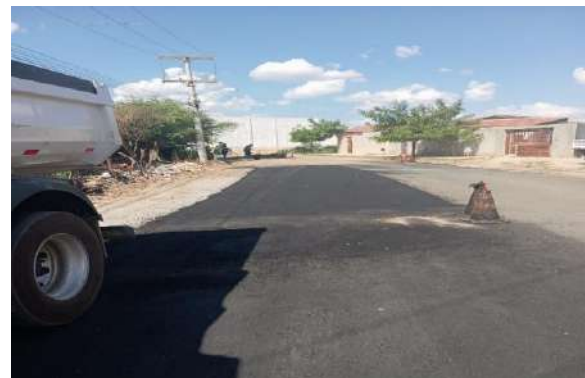
DISTRITO INDUSTRIAL - MAN. PAVIM. ASFÁLTICO
