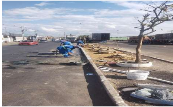
CEASA - ASSENTAMENTO DE MEIO FIO
