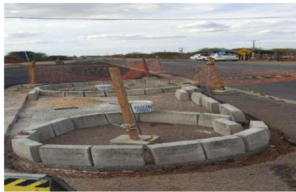
CARNAÍBA DO SERTÃO - ASSENTAMENTO DE MEIO FIO
