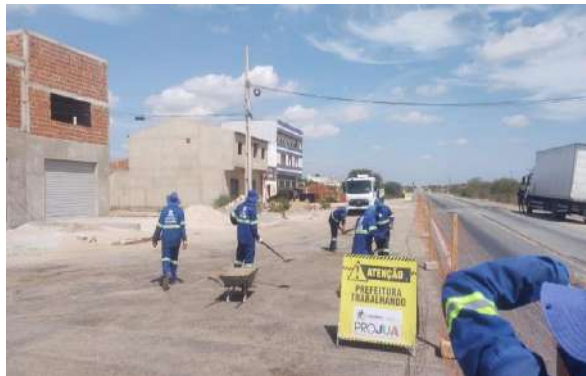
CARNAÍBA DO SERTÃO - MAN. PAVIMENTO ASFÁLTICO
