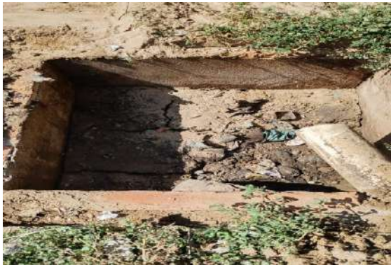
AV GIRASSOL - DESOBSTRUÇÃO BOCA DE LOBO
