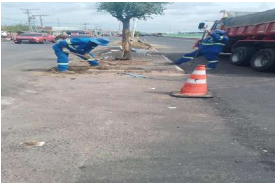
CEASA - ESCAVAÇÃO MANUAL
