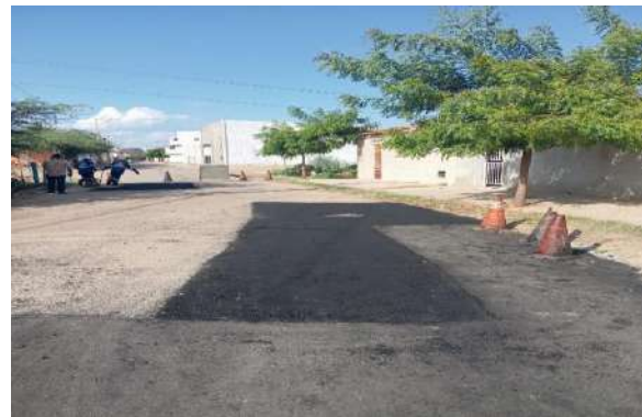
DISTRITO INDUSTRIAL - MAN. PAVIM. ASFÁLTICO
