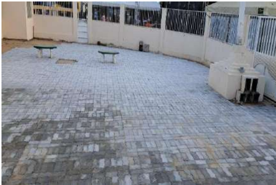
JUREMAL - MANUTENÇÃO PISO INTERTRAVADO
