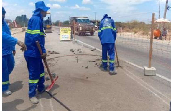
CARNAÍBA DO SERTÃO - CORTE DO ASFALTO
