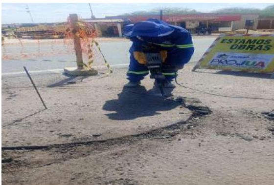
CARNAÍBA DO SERTÃO - DEMOLIÇÃO ASFÁLTICA
