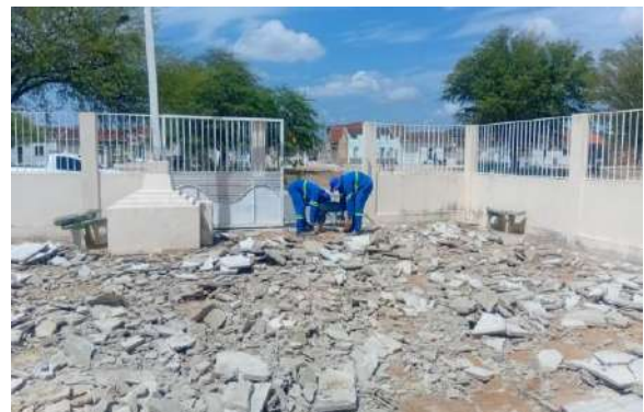
JUREMAL - DEMOLIÇÃO DE PISO DE CONCRETO
