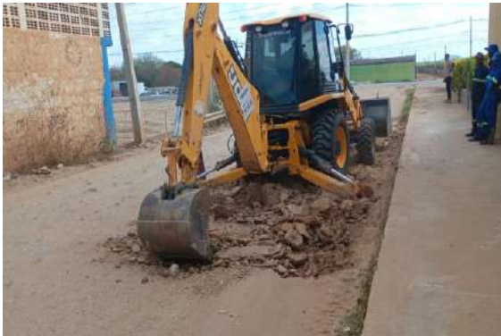
DISTRITO INDUSTRIAL - ESCAVAÇÃO MECANIZADA
