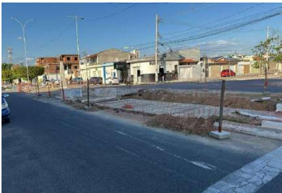
AV LUIZ INÁCIO - SINALIZAÇÃO DE ÁREA
