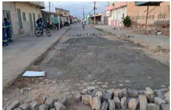
R. BENTO GONÇALVES - MAN. PAV PARALELEPÍPEDO
