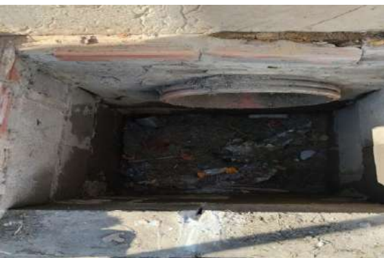
AV ANTONIO CARLOS - DESOBSTRUÇÃO BOCA DE LOBO
