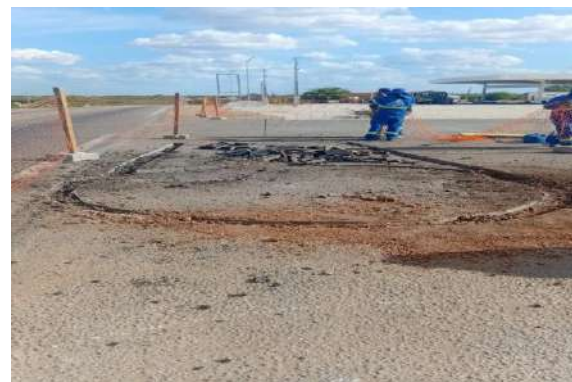
CARNAÍBA DO SERTÃO - DEMOLIÇÃO ASFÁLTICA
