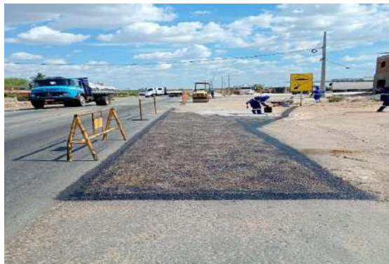
CARNAÍBA DO SERTÃO - MAN. PAVIMENTO ASFÁLTICO
