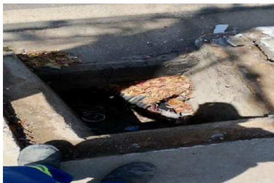
R MANOEL SEVERO - DESOBSTRUÇÃO BOCA DE LOBO
