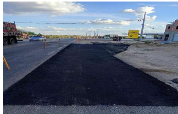
CARNAÍBA DO SERTÃO - MAN. PAVIMENTO ASFÁLTICO
