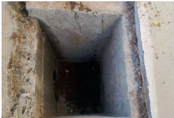
R MANOEL SEVERO - DESOBSTRUÇÃO BOCA DE LOBO
