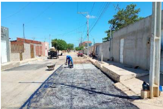
JARDIM PRIMAWEIRA - APLICAÇÃO DE BGS
