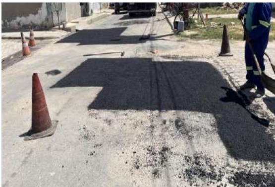
R RAUL ROSA - MAN. PAVIMENTO ASFÁLTICO
