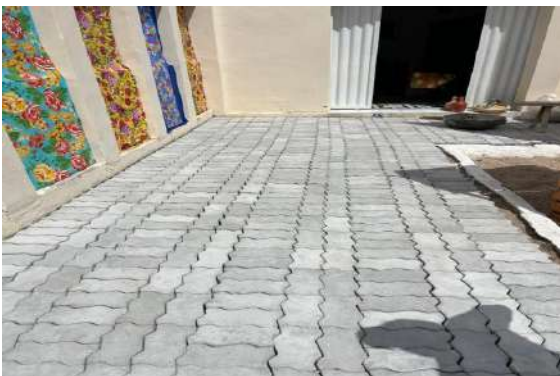
JUREMAL - MANUTENÇÃO PISO INTERTRAVADO
