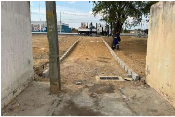
BA210 - ASSENTAMENTO DE MEIO FIO
