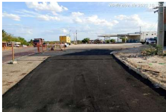
CARNAÍBA DO SERTÃO - MAN. PAVIMENTO ASFÁLTICO
