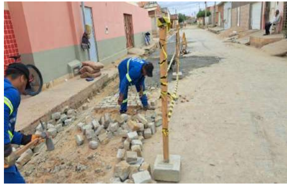
R. MIGUEL SILVA - MAN. PAV PARALELEPÍPEDO
