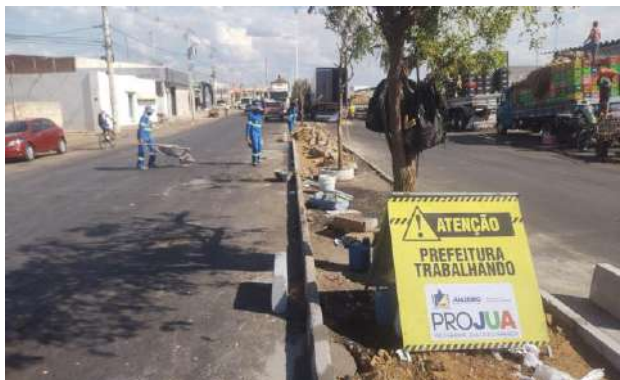
CEASA - ASSENTAMENTO DE MEIO FIO
