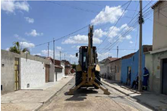
R. RAUL ROSA - ESCAVAÇÃO MECANIZADA
