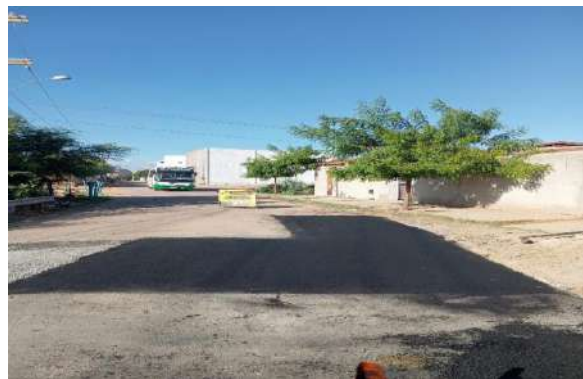
AV MARIA DA GLÓRIA - MAN. PAVIMENTO ASFÁLTICO
