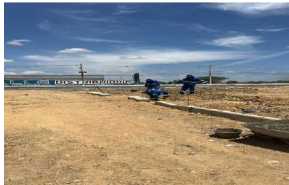
BA210 - ASSENTAMENTO DE MEIO FIO
