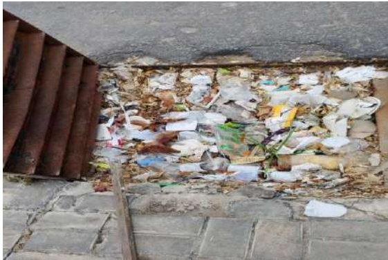
AV ADOLFO VIANA - DESOBSTRUÇÃO BOCA DE LOBO
