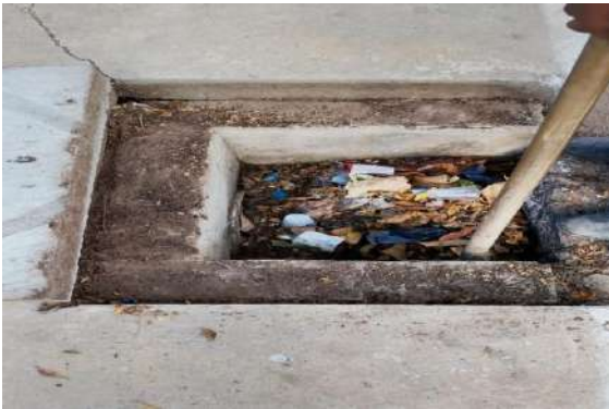
AV ANTONIO CARLOS - DESOBSTRUÇÃO BOCA DE LOBO
