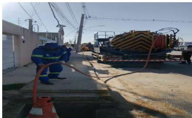
AV PEDRA DO LORD - SEWERJET
