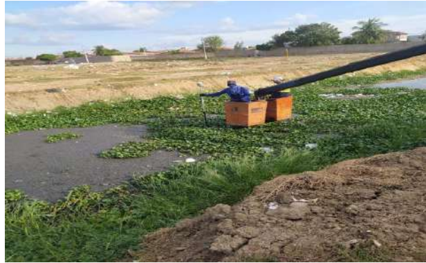
CANAL JUAZEIRO - SERVIÇO DE MUNCK
