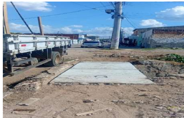
AV AMÉRICO TANURY - TAMPA DE CONCRETO ARMADO
