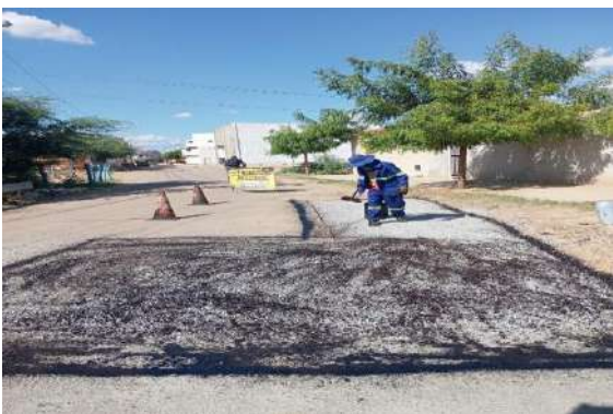
AV MARIA DA GLÓRIA - MAN. PAVIMENTO ASFÁLTICO
