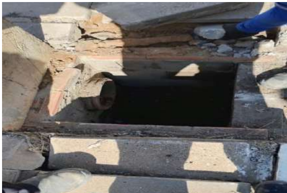
AV ANTONIO CARLOS - DESOBSTRUÇÃO BOCA DE LOBO
