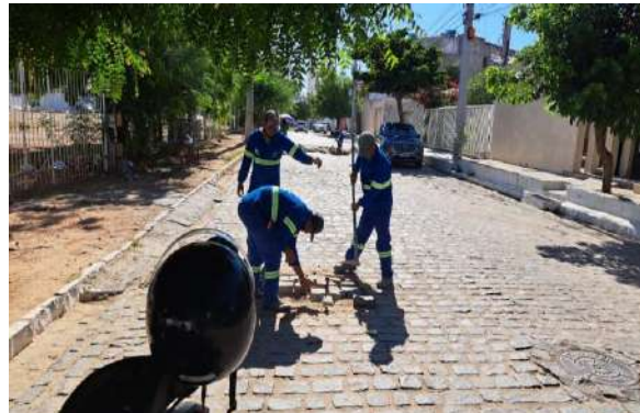
R ARGENTINA - MAN. PAV PARALELEPÍPEDO
