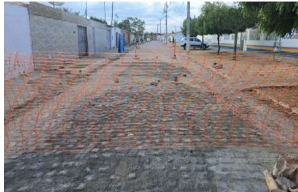
R DAS ALGAROBAS - MAN PAV PARALELEPÍPEDO
