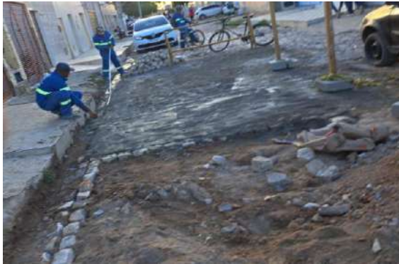
RUA ROTARY - MAN. PAV PARALELEPÍPEDO
