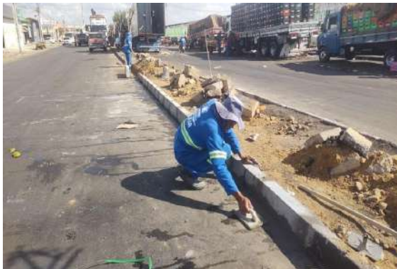
CEASA - ASSENTAMENTO DE MEIO FIO
