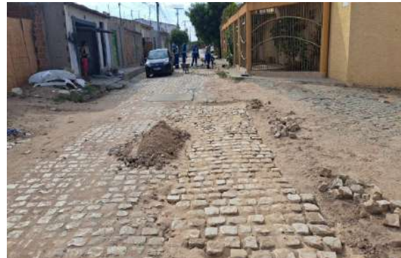
RUA ROTARY - MAN. PAV PARALELEPÍPEDO
