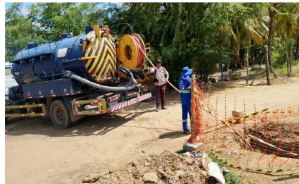
AV GIRASSOL - SEWERJET
