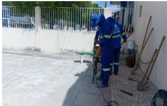
JUREMAL - DEMOLIÇÃO DE PISO DE CONCRETO
