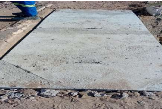
AV AMÉRICO TANURY - TAMPA DE CONCRETO ARMADO
