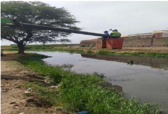
CANAL JUAZEIRO - SERVIÇO DE MUNCK
