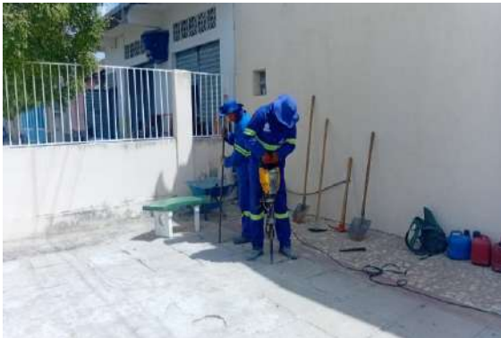
JUREMAL - DEMOLIÇÃO DE PISO DE CONCRETO
