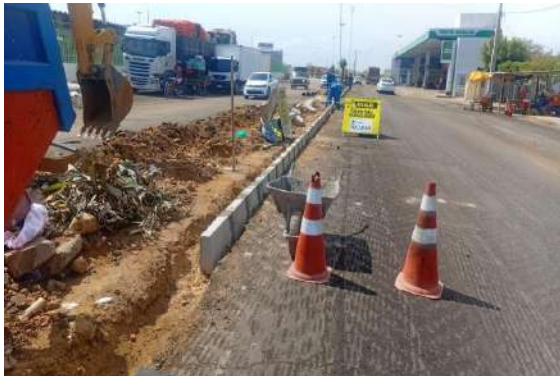
CEASA - ESCAVAÇÃO MECANIZADA
