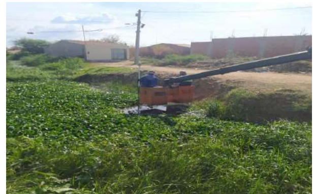
CANAL JUAZEIRO - SERVIÇO DE MUNCK
