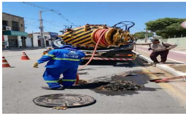
AV PEDRA DO LORD - SEWERJET
