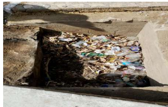
AV AMERICO TANURY - DESOBSTRUÇÃO DE BOCA DE LOBO
