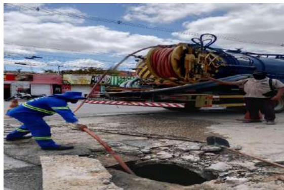
AV ADOLFO VIANA - DESOBSTRUÇÃO BOCA DE LOBO
