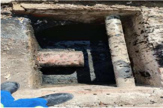
PIRANGA - DESOBSTRUÇÃO BOCA DE LOBO
