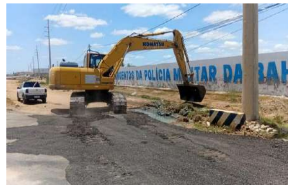
BA210 - DIÁRIA ESCAVADEIRA
