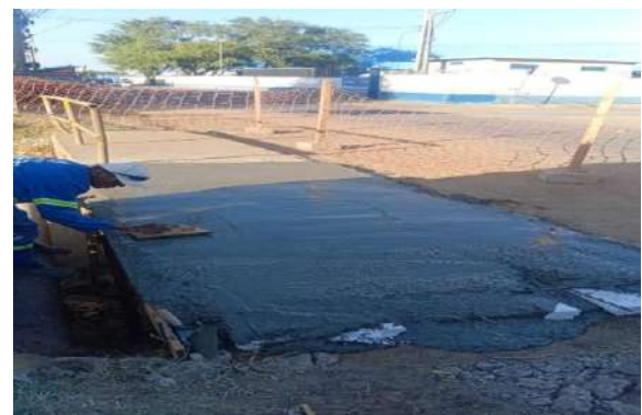
AV RAUL ALVES - LAJE DE CONCRETO ARMADO
