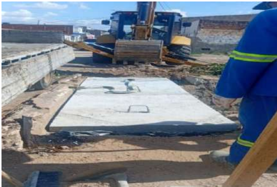
AV AMÉRICO TANURY - TAMPA DE CONCRETO ARMADO
