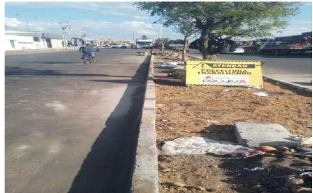
CEASA - ASSENTAMENTO DE MEIO FIO
