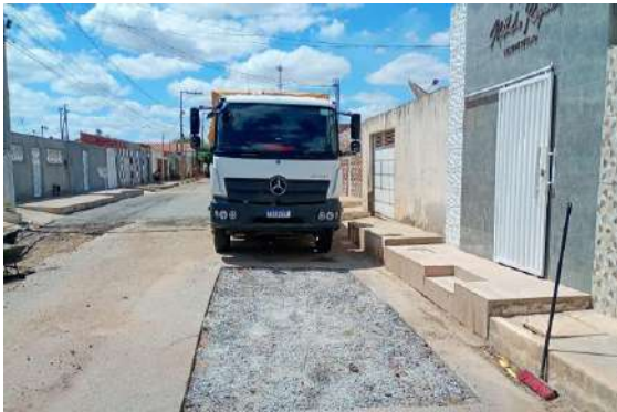
JARDIM PRIMAWEIRA - APLICAÇÃO DE BGS
