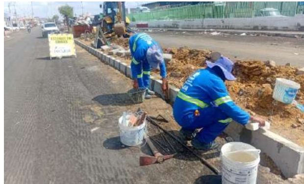
CEASA - ESCAVAÇÃO MECANIZADA
