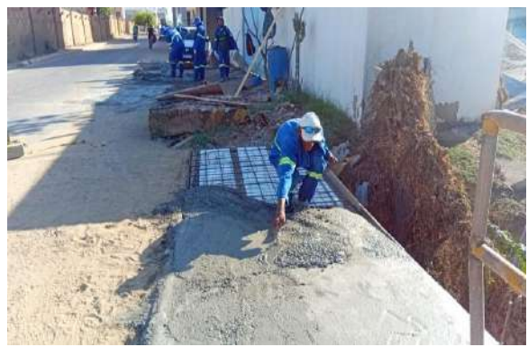
AV RAUL ALVES - LAJE DE CONCRETO ARMADO
