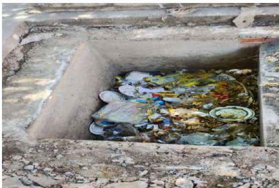
PIRANGA - DESOBSTRUÇÃO BOCA DE LOBO
