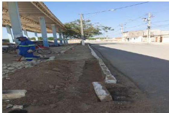
CARNAÍBA DO SERTÃO - REMOÇÃO DE MEIO FIO
