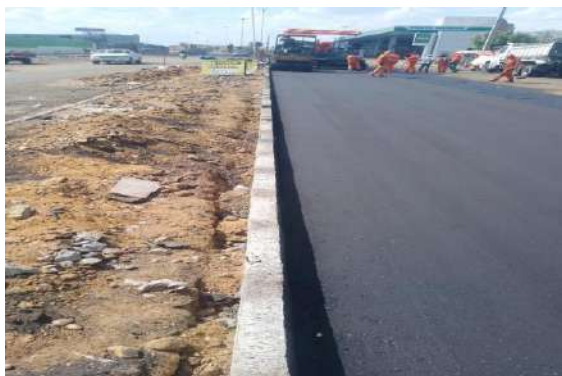
CEASA - ASSENTAMENTO DE MEIO FIO
