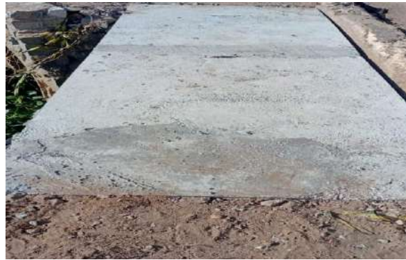
AV AMÉRICO TANURY - TAMPA DE CONCRETO ARMADO
