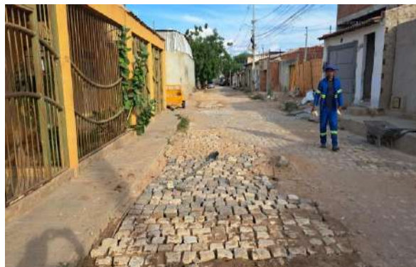
RUA ROTARY - MAN. PAV PARALELEPÍPEDO
