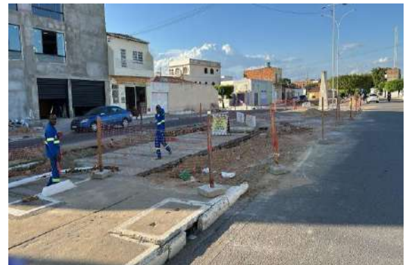
AV LUIZ INÁCIO - SINALIZAÇÃO DE ÁREA
