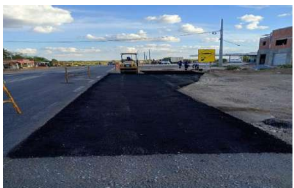
CARNAÍBA DO SERTÃO - MAN. PAVIMENTO ASFÁLTICO
