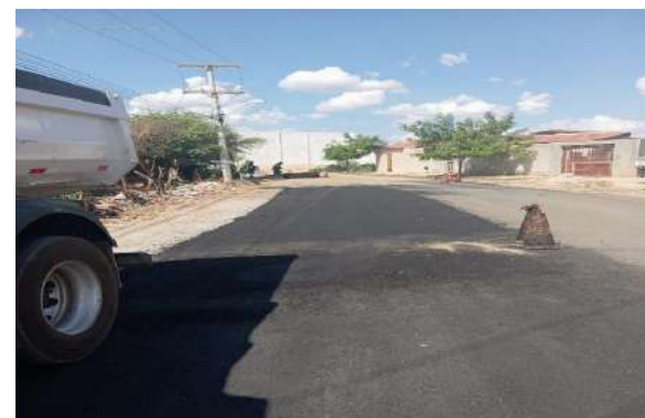
AV MARIA DA GLÓRIA - MAN. PAVIMENTO ASFÁLTICO
