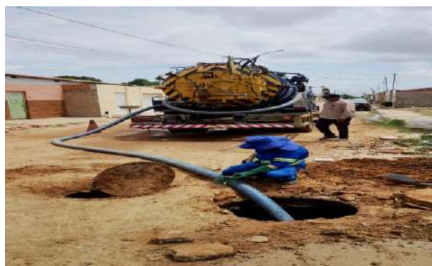
AV GIRASSOL - SEWERJET
