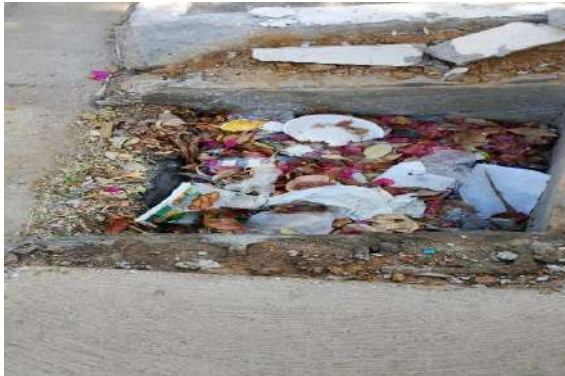
R MANOEL SEVERO - DESOBSTRUÇÃO BOCA DE LOBO
