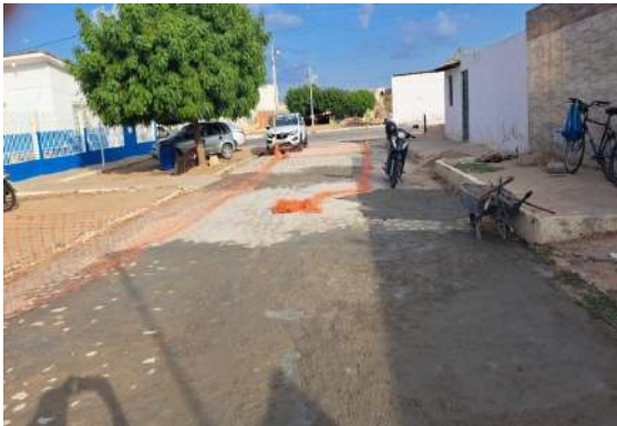
R DAS ALGAROBAS - MAN PAV PARALELEPÍPEDO
