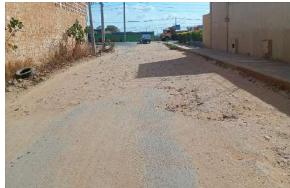
DISTRITO INDUSTRIAL - LIMPEZA
