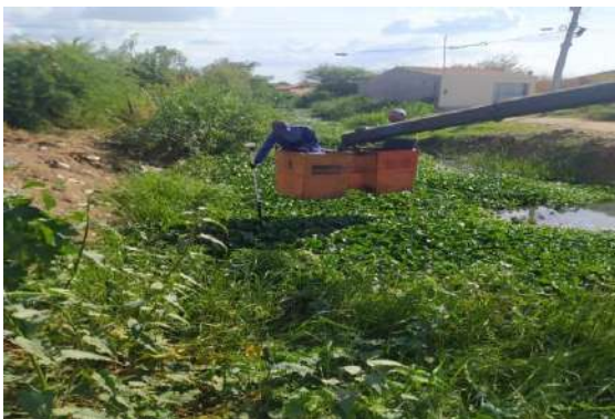
CANAL JUAZEIRO - SERVIÇO DE MUNCK
