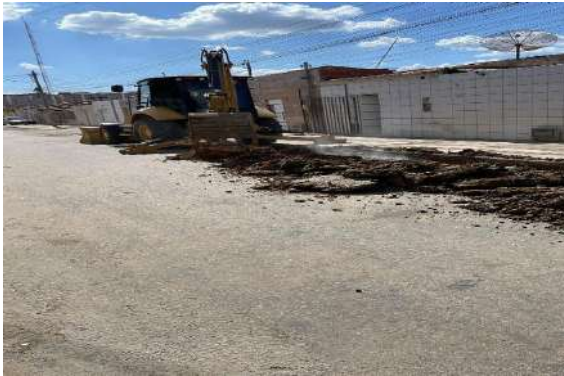
R. BENTO GONÇALVES - ESCAVAÇÃO MECANIZADA
