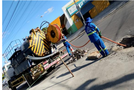
PRAÇA PEDRO PRIMO - SEWERJET
