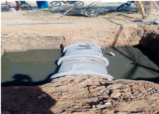
AV PROPRIÁ - TUBO DE CONCRETO
