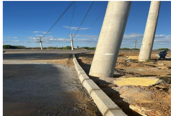
BA210 - ASSENTAMENTO DE MEIO FIO
