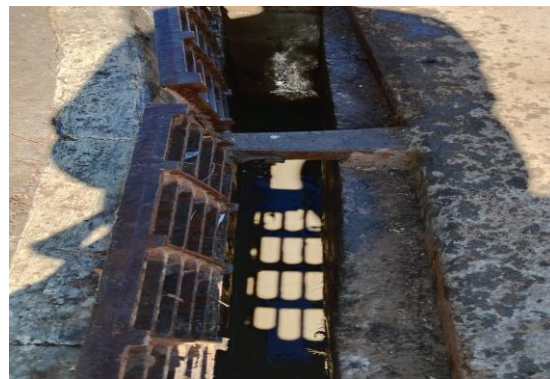
RESIDENCIAL MAIRI - DESOBSTRUÇÃO
