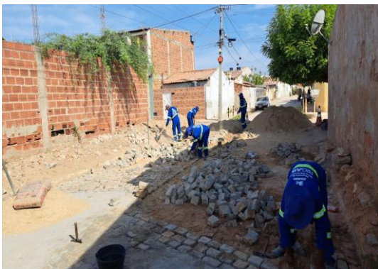
R PADRE FEIJÓ - MANUTENÇÃO EM PARALELEPÍPEDO
