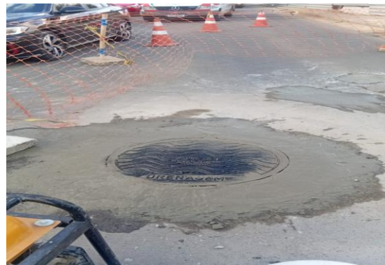
AV RAUL ALVES - SUBSTITUIÇÃO DE TAMPA
