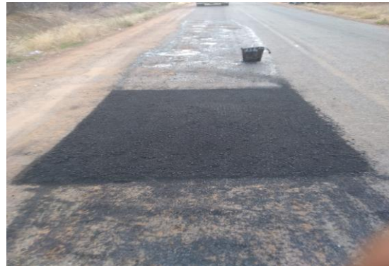
NH1 ITAMOTINGA - MANUTENÇÃO PAV ASFÁLTICA
