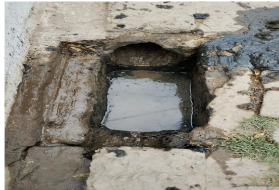
R DA SÍRIA - SEWERJET
