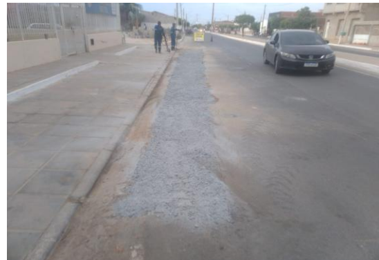
AV QUIDÉ - MANUTENÇÃO PAV ASFÁLTICA
