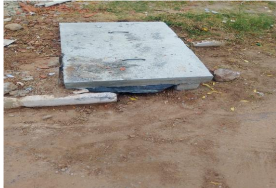
AV GIUSSEP MUCINI - TAMPA CONCRETO ARMADO
