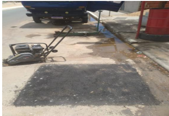
AV MARIA DA GLÓRIA - MANUTENÇÃO PAV ASFÁLTICA
