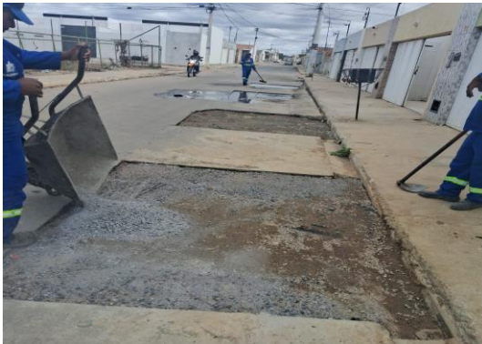
AV LUDGERO ALVES - MANUTENÇÃO PAV ASFÁLTICA
