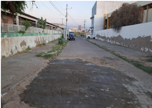
RUA DA CAIXA - MAN. EM PARALELEPÍPEDO
