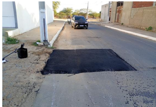
R BOA VISTA - MANUTENÇÃO PAV ASFÁLTICA
