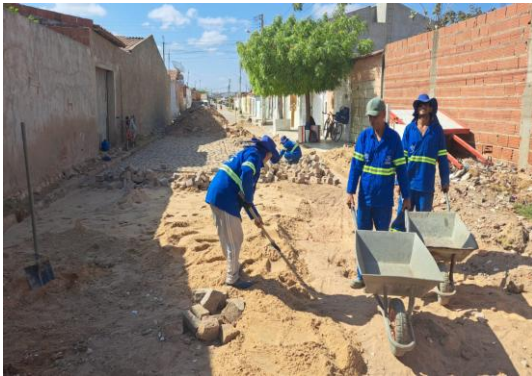
R PADRE FEIJÓ - MANUTENÇÃO EM PARALELEPÍPEDO
