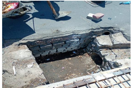
TRAV MARAVILHA - DESOBSTRUÇÃO BOCA DE LOBO
