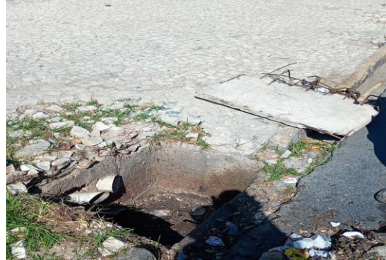
TRAV MARAVILHA - DESOBSTRUÇÃO BOCA DE LOBO
