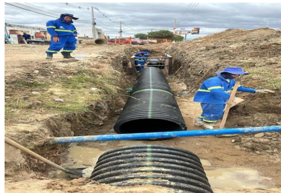
BA210 - ESCORAMENTO METÁLICO
