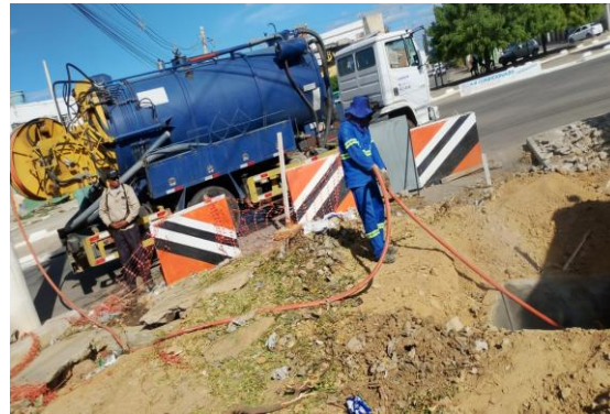
AV LUIS INÁCIO - SEWERJET
