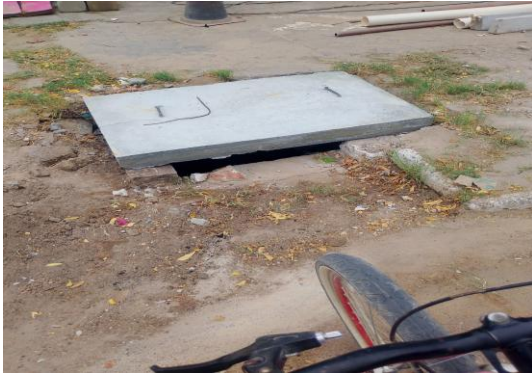
AV GIUSSEP MUCINI - TAMPA CONCRETO ARMADO
