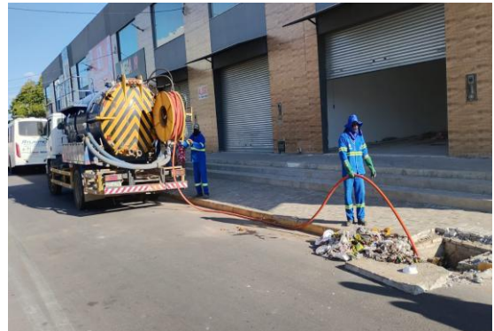
PRAÇA PEDRO PRIMO - SEWERJET
