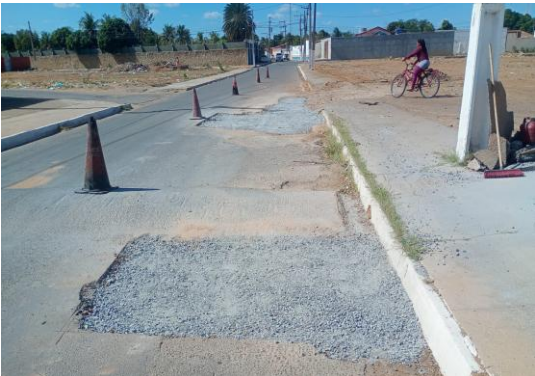
R BOA VISTA - MANUTENÇÃO PAV ASFÁLTICA
