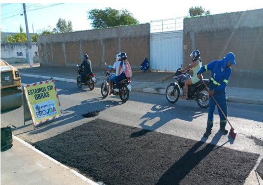
R BOA VISTA - MANUTENÇÃO PAV ASFÁLTICA
