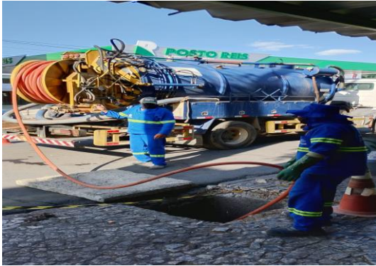
PRAÇA PEDRO PRIMO - SEWERJET
