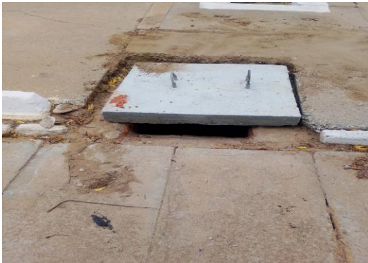
AV GIUSSEP MUCINI - TAMPA CONCRETO ARMADO
