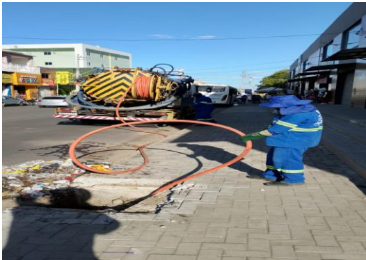
PRAÇA PEDRO PRIMO - SEWERJET
