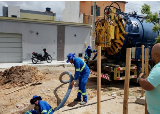
AV PROPRIÁ - SEWERJET
