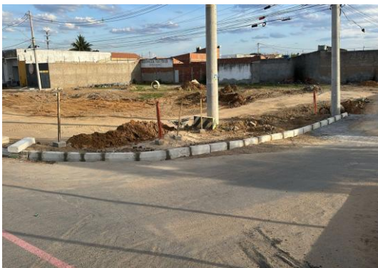
BA210 - ASSENTAMENTO DE MEIO FIO
