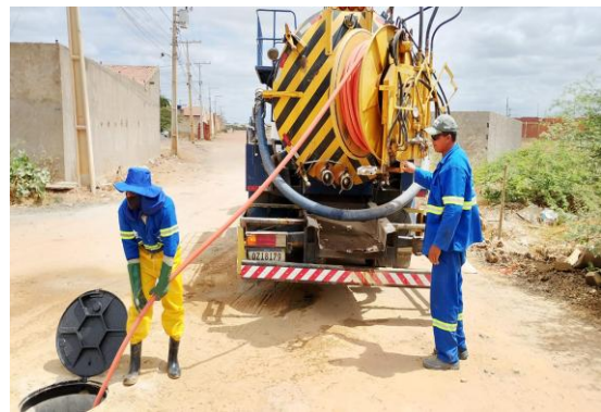
AV PROPRIÁ - SEWERJET
