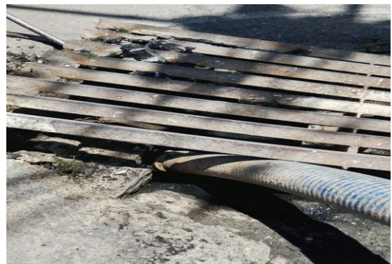
AV OSCAR RIBEIRO - DESOBSTRUÇÃO
