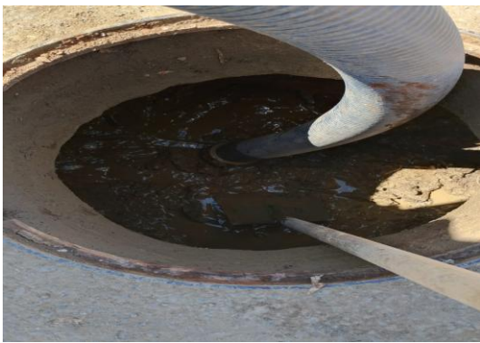
RESIDENCIAL MAIRI - DESOBSTRUÇÃO
