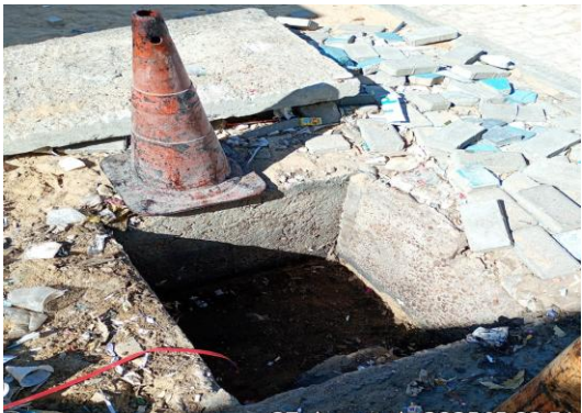
TRAV MARAVILHA - DESOBSTRUÇÃO BOCA DE LOBO
