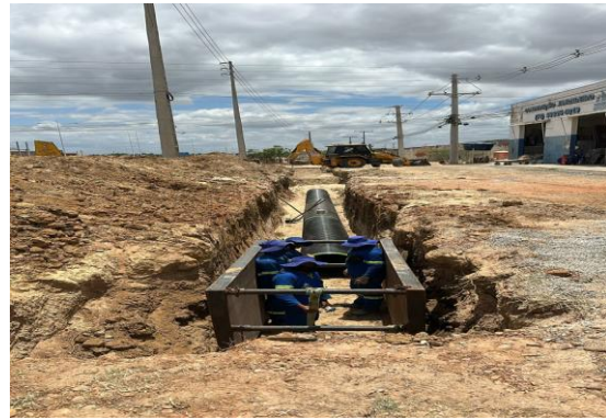
BA210 - ESCORAMENTO METÁLICO
