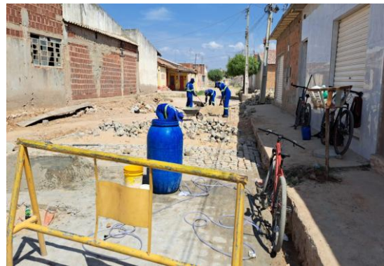
R MIGUEL ALVES - MANUTENÇÃO PARALELEPÍEDO
