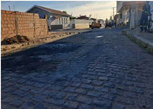
RUA DA CAIXA - MAN. EM PARALELEPÍPEDO
