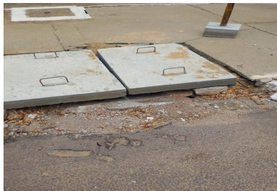
AV GIUSSEP MUCINI - TAMPA CONCRETO ARMADO
