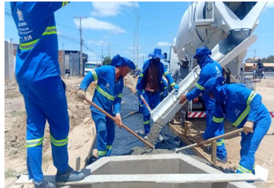
BA210 - CONCRETO USINADO
