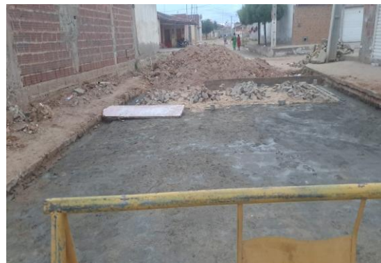
R MIGUEL ALVES - MANUTENÇÃO PARALELEPÍEDO
