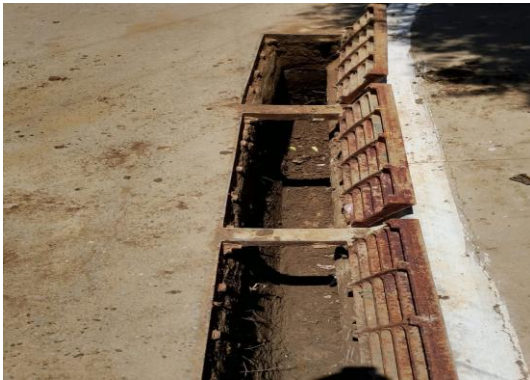
RESIDENCIAL MAIRI - SEWERJET
