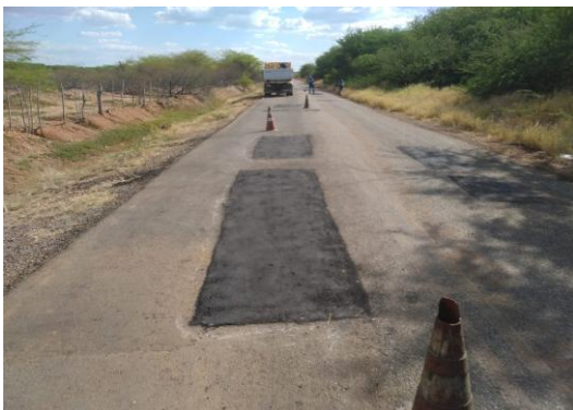
NH1 ITAMOTINGA - MANUTENÇÃO PAV ASFÁLTICA
