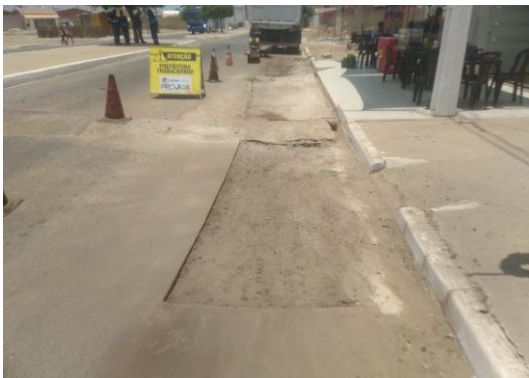
AV QUIDÉ - MANUTENÇÃO PAV ASFÁLTICA
