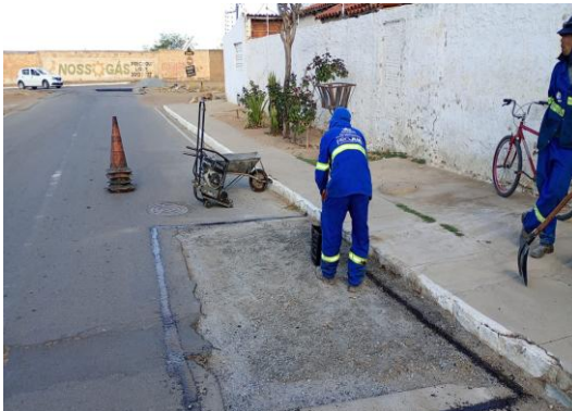
R ANTONIO CONSELHEIRO - MANUTENÇÃO PAV ASF
