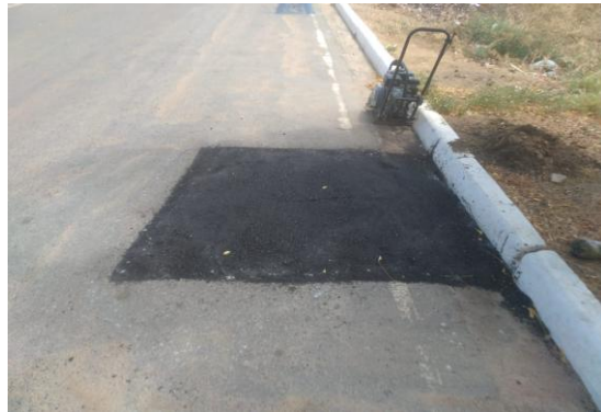
AV MARIA DA GLÓRIA - MANUTENÇÃO PAV ASFÁLTICA
