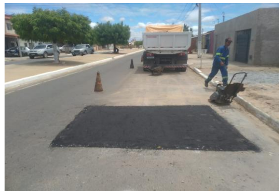
AV QUIDÉ - MANUTENÇÃO PAV ASFÁLTICA
