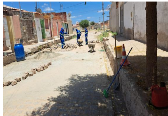
R MIGUEL ALVES - MANUTENÇÃO PARALELEPÍPEDO
