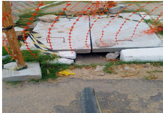
AV GIUSSEP MUCINI - TAMPA CONCRETO ARMADO
