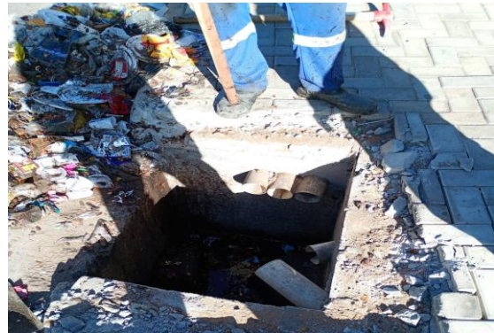
TRAV MARAVILHA - DESOBSTRUÇÃO BOCA DE LOBO
