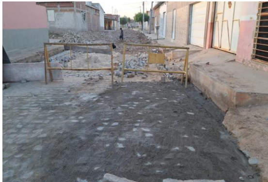
R MIGUEL ALVES - MANUTENÇÃO PARALELEPÍEDO
