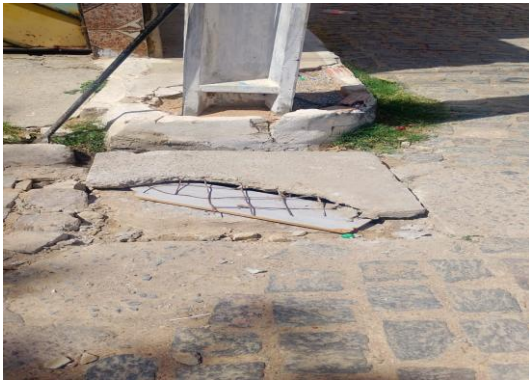
RUA DO AVELOZ - SUBSTITUIÇÃO DE TAMPA
