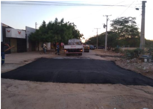
AV IRMÃ DULCE - MANUTENÇÃO PAV ASFÁLTICA
