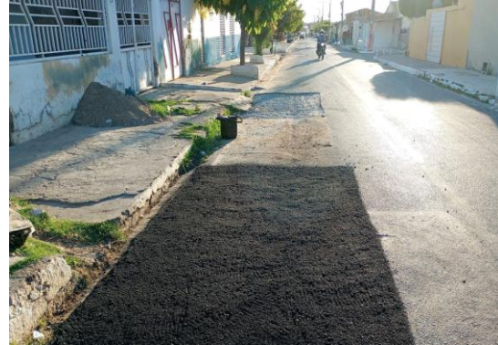
R ANTONIO CONSELHEIRO - MANUTENÇÃO PAV ASF
