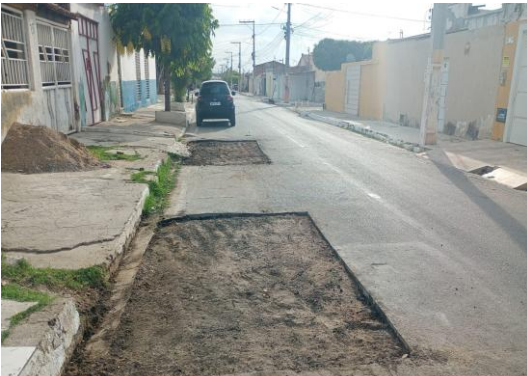
AV MARIA DA GLÓRIA - MANUTENÇÃO PAV ASFÁLTICA
