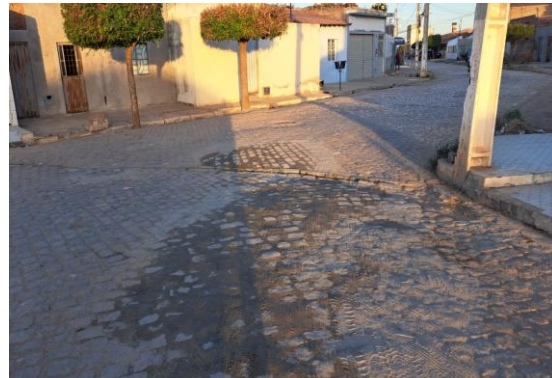
RUA DA CAIXA - MAN. EM PARALELEPÍPEDO
