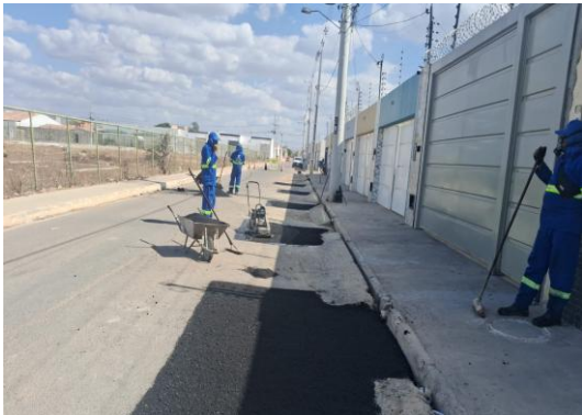
AV LUDGERO ALVES - MANUTENÇÃO PAV ASFÁLTICA
