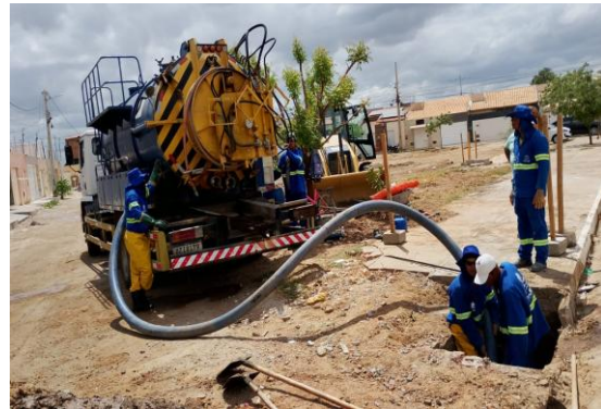
AV PROPRIÁ - SEWERJET
