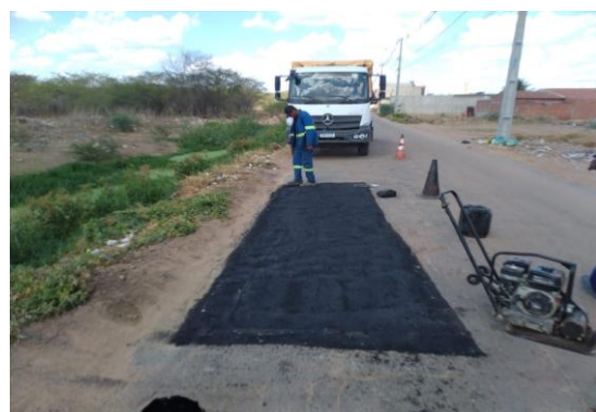
AV IRMÃ DULCE - MANUTENÇÃO PAV ASFÁLTICA
