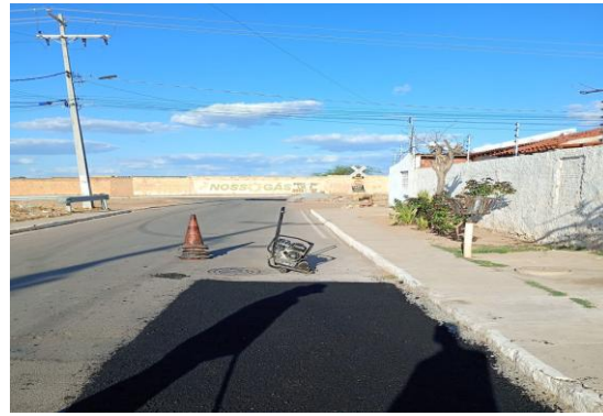
R ANTONIO CONSELHEIRO - MANUTENÇÃO PAV ASF
