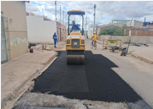
AV LUDGERO ALVES - MANUTENÇÃO PAV ASFÁLTICA
