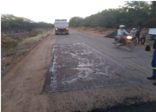
NH1 ITAMOTINGA - MANUTENÇÃO PAV ASFÁLTICA
