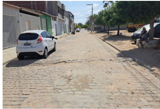
RUA DA CAIXA - MAN. EM PARALELEPÍPEDO
