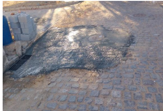
RUA DO AVELOZ - SUBSTITUIÇÃO DE TAMPA
