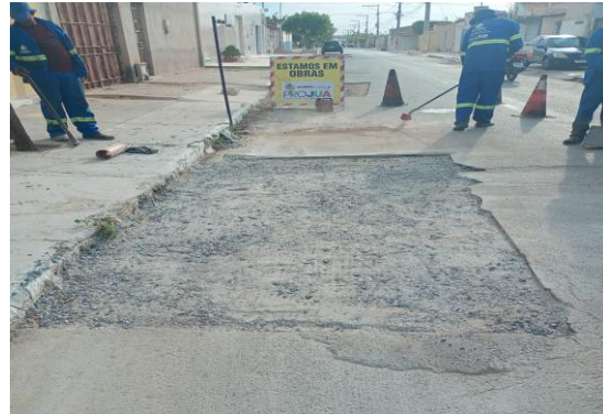
AV MARIA DA GLÓRIA - MANUTENÇÃO PAV ASFÁLTICA
