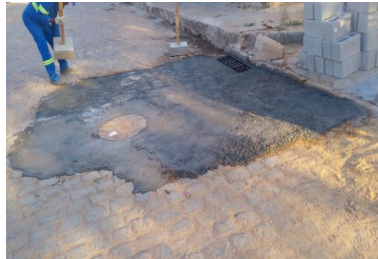
RUA DO AVELOZ - SUBSTITUIÇÃO DE TAMPA
