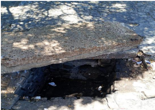
TRAV MARAVILHA - DESOBSTRUÇÃO BOCA DE LOBO
