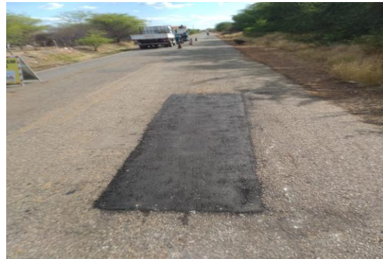
NH1 ITAMOTINGA - MANUTENÇÃO PAV ASFÁLTICA
