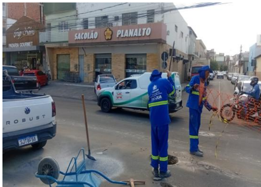
AV RAUL ALVES - SUBSTITUIÇÃO DE TAMPA
