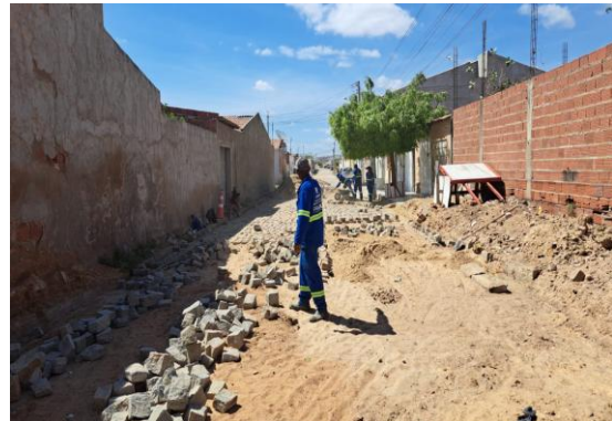
R PADRE FEIJÓ - MANUTENÇÃO EM PARALELEPÍPEDO
