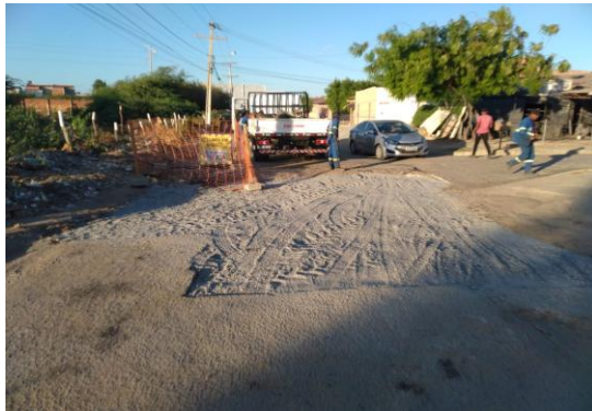
AV IRMÃ DULCE - MANUTENÇÃO PAV ASFÁLTICA
