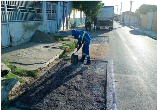
R ANTONIO CONSELHEIRO - MANUTENÇÃO PAV ASF
