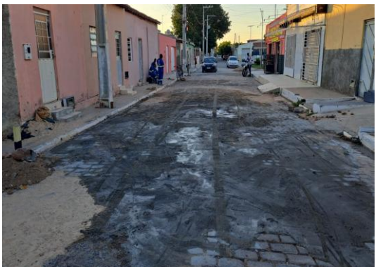
RUA I - MANUTENÇÃO PARALELEPÍPEDO
