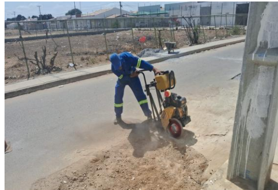
AV LUDGERO ALVES - MANUTENÇÃO PAV ASFÁLTICA
