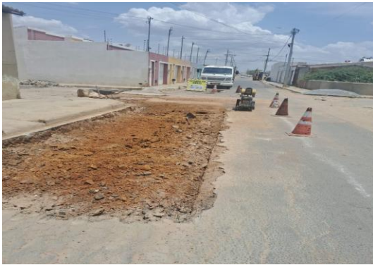
AV LUDGERO ALVES - ESCAVAÇÃO MECANIZADA
