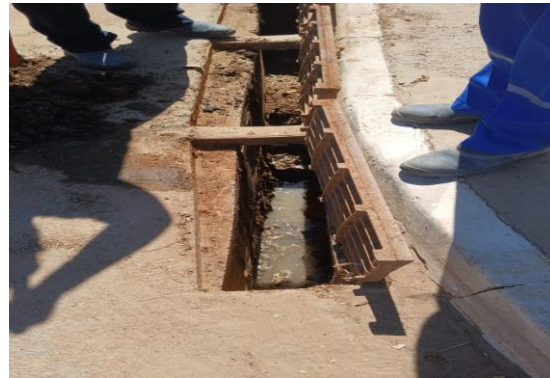
RESIDENCIAL MAIRI - DESOBSTRUÇÃO
