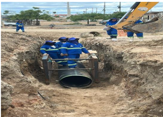
BA210 - ESCORAMENTO METÁLICO
