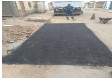
AV QUIDÉ - MANUTENÇÃO PAV ASFÁLTICA
