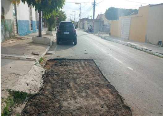
AV MARIA DA GLÓRIA - MANUTENÇÃO PAV ASFÁLTICA
