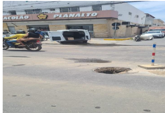
AV RAUL ALVES - SUBSTITUIÇÃO DE TAMPA
