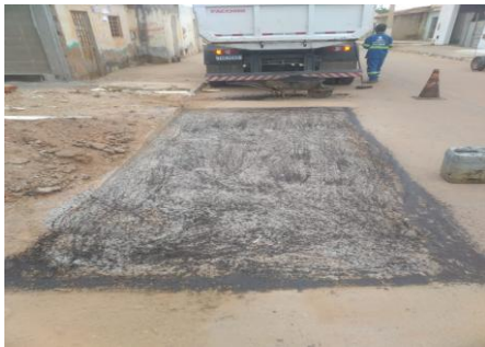
AV QUIDÉ - MANUTENÇÃO PAV ASFÁLTICA
