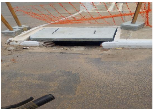
AV GIUSSEP MUCINI - TAMPA CONCRETO ARMADO
