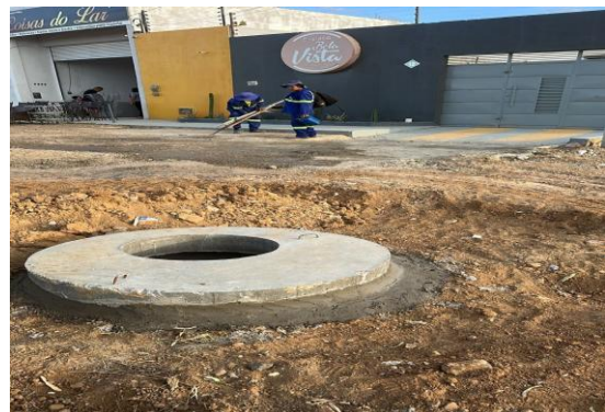
BA210 - NIVELAMENTO DE PV
