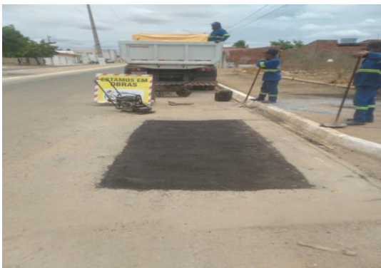
AV QUIDÉ - MANUTENÇÃO PAV ASFÁLTICA
