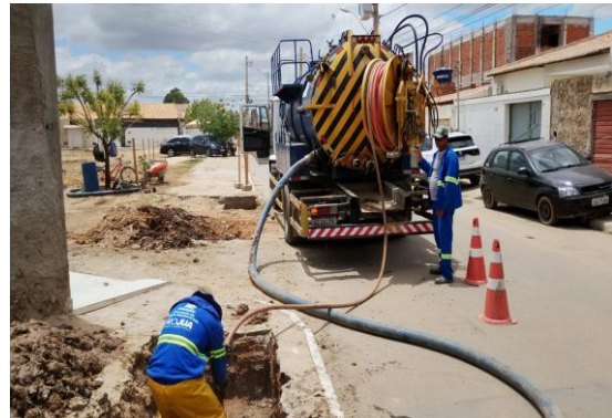
AV PROPRIÁ - SEWERJET
