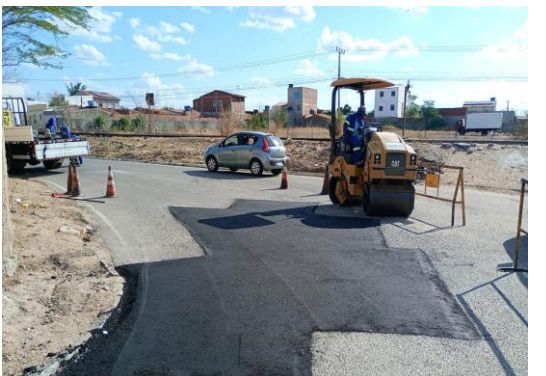
R BOA VISTA - MANUTENÇÃO PAV ASFÁLTICA
