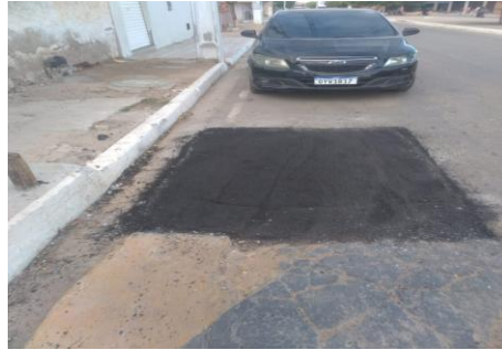
AV QUIDÉ - MANUTENÇÃO PAV ASFÁLTICA
