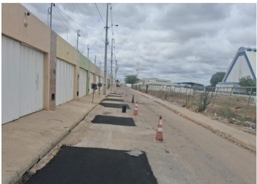
AV LUDGERO ALVES - MANUTENÇÃO PAV ASFÁLTICA
