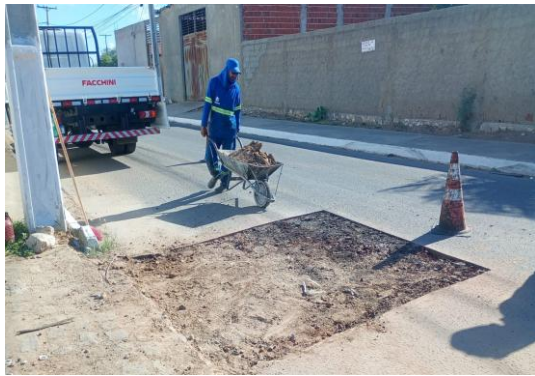
R BOA VISTA - MANUTENÇÃO PAV ASFÁLTICA
