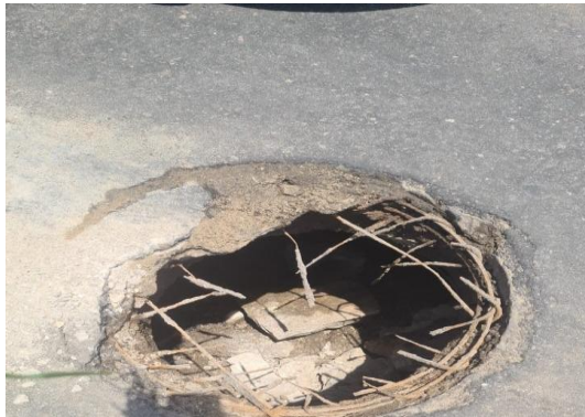
AV RAUL ALVES - SUBSTITUIÇÃO DE TAMPA
