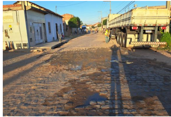
RUA DA CAIXA - MAN. EM PARALELEPÍPEDO
