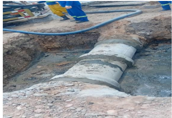
AV PROPRIÁ - TUBO DE CONCRETO
