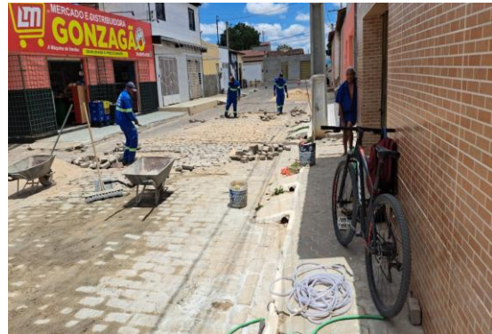
RUA I - MANUTENÇÃO PARALELEPÍPEDO
