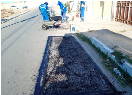
R ANTONIO CONSELHEIRO - MANUTENÇÃO PAV ASF
