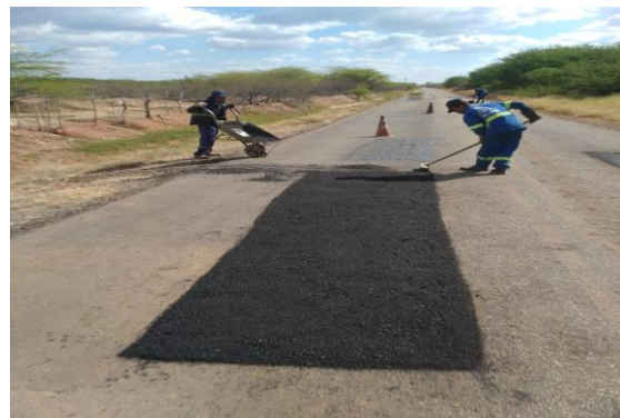
NH1 ITAMOTINGA - MANUTENÇÃO PAV ASFÁLTICA
