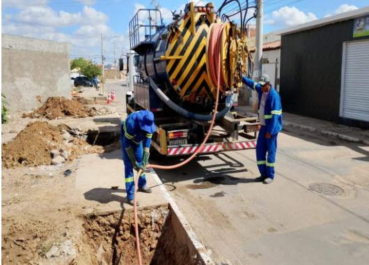
AV PROPRIÁ - SEWERJET
