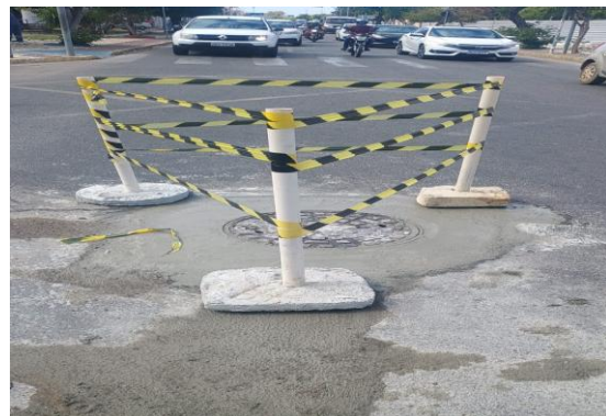
AV RAUL ALVES - SUBSTITUIÇÃO DE TAMPA
