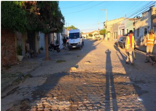
RUA DA CAIXA - MAN. EM PARALELEPÍPEDO
