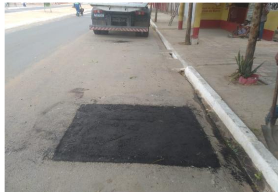
AV QUIDÉ - MANUTENÇÃO PAV ASFÁLTICA
