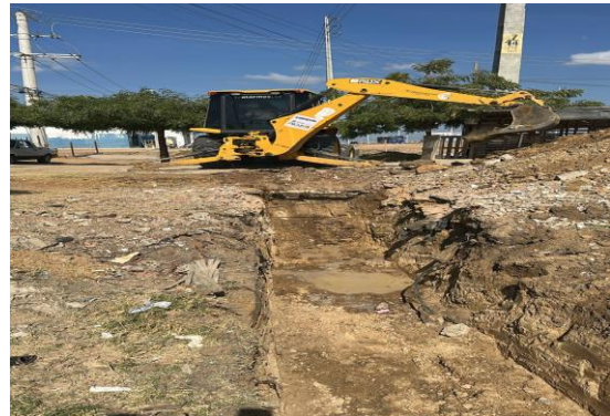
BA210 - ESCAVAÇÃO MECANIZADA
