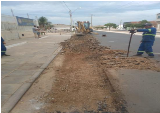
AV QUIDÉ - MANUTENÇÃO PAV ASFÁLTICA
