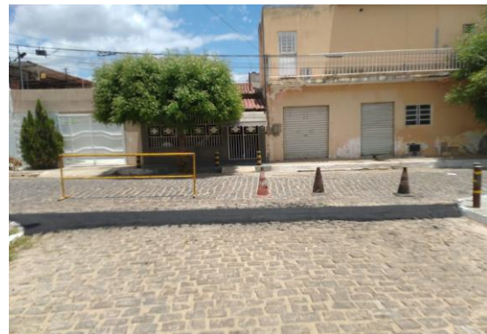
AV IRMÃ DULCE - MANUTENÇÃO PAV ASFÁLTICA
