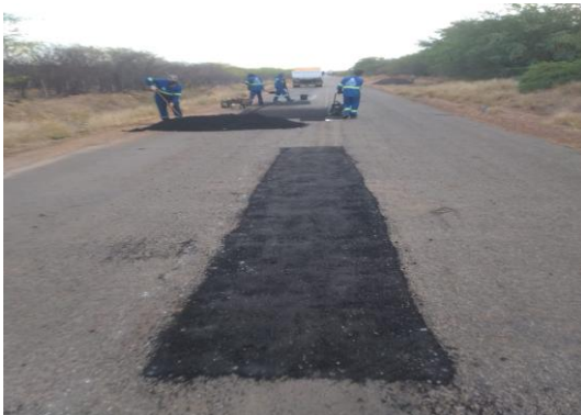
NH1 ITAMOTINGA - MANUTENÇÃO PAV ASFÁLTICA
