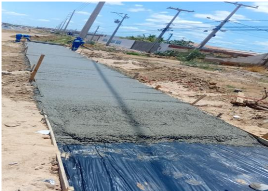
BA210 - CONCRETO USINADO
