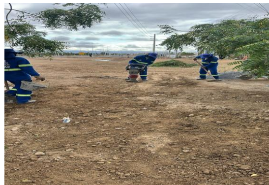
BA210 - COMPACTAÇÃO DE VALA
