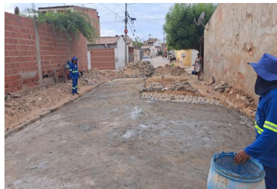
R PADRE FEIJÓ - MANUTENÇÃO EM PARALELEPÍPEDO
