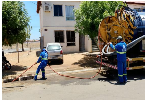
RESIDENCIAL MAIRI - SEWERJET
