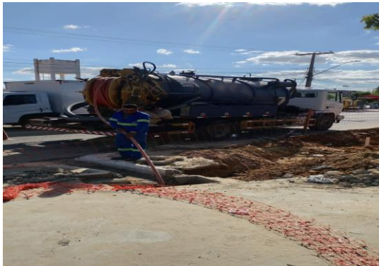
AV LUIS INÁCIO - SEWERJET
