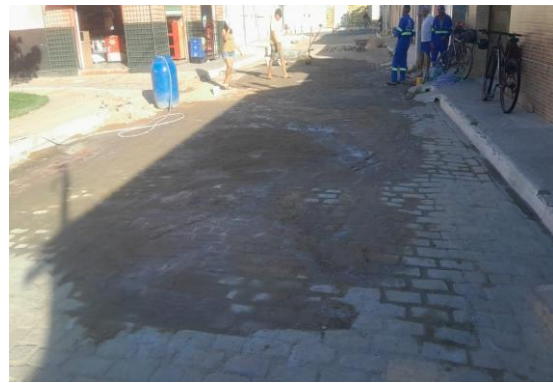
RUA I - MANUTENÇÃO PARALELEPÍPEDO
