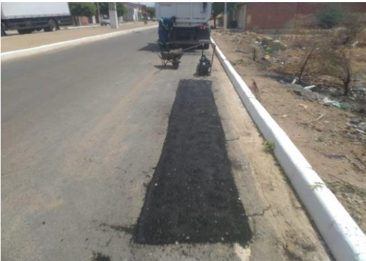
AV MARIA DA GLÓRIA - MANUTENÇÃO PAV ASFÁLTICA
