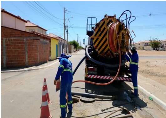
RESIDENCIAL MAIRI - SEWERJET
