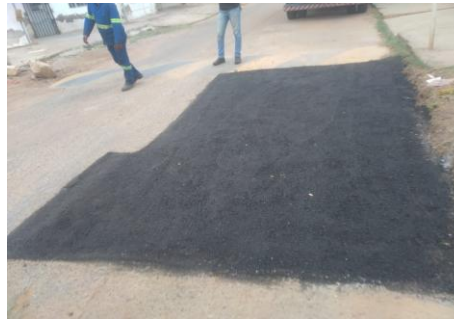
AV QUIDÉ - MANUTENÇÃO PAV ASFÁLTICA
