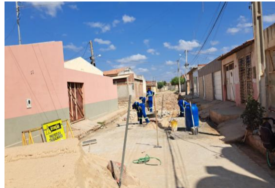
R MIGUEL ALVES - MANUTENÇÃO PARALELEPÍEDO
