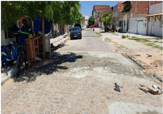
R M. CRISÓSTOMO - MAN. PARALELEPÍPEDO
