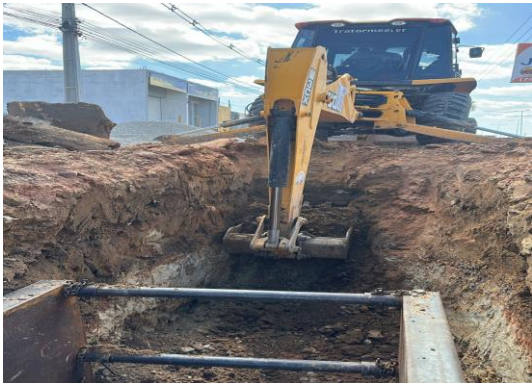
BA210 - ESCAVAÇÃO DE VALA
