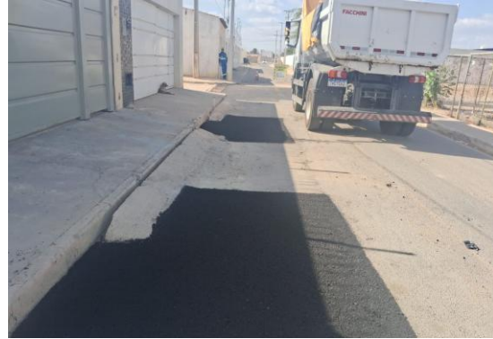
AV LUDGERO ALVES - MANUTENÇÃO PAV ASFÁLTICA
