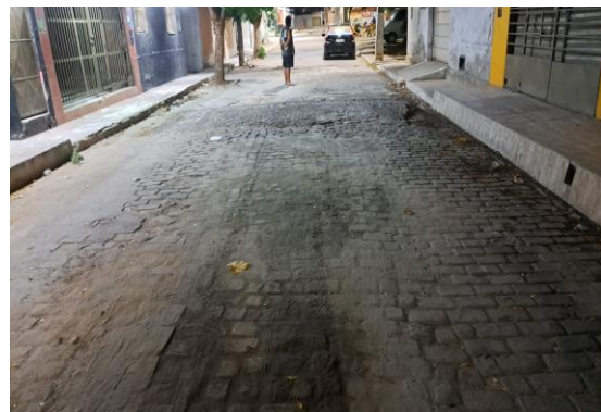
RUA I - MANUTENÇÃO PARALELEPÍPEDO
