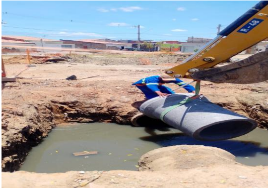
AV PROPRIÁ - TUBO DE CONCRETO
