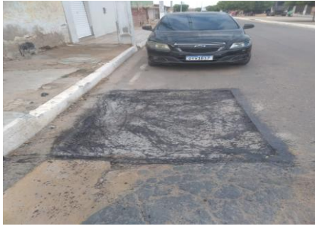
AV QUIDÉ - MANUTENÇÃO PAV ASFÁLTICA
