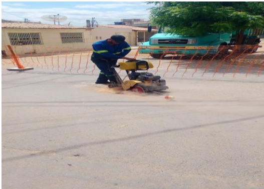
FEIRA DO ALENCAR - CORTE DE ASFALTO
