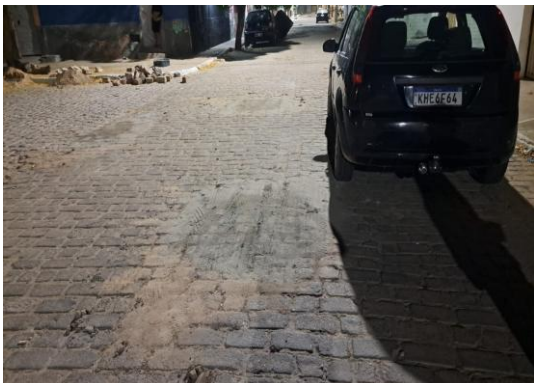
RUA I - MANUTENÇÃO PARALELEPÍPEDO
