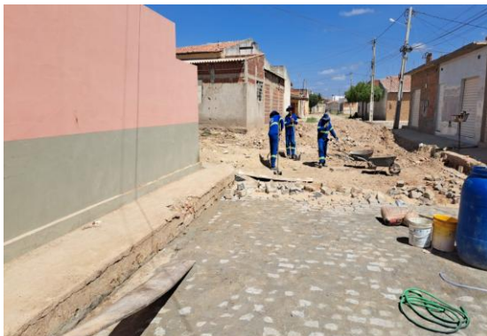
R MIGUEL ALVES - MANUTENÇÃO PARALELEPÍEDO
