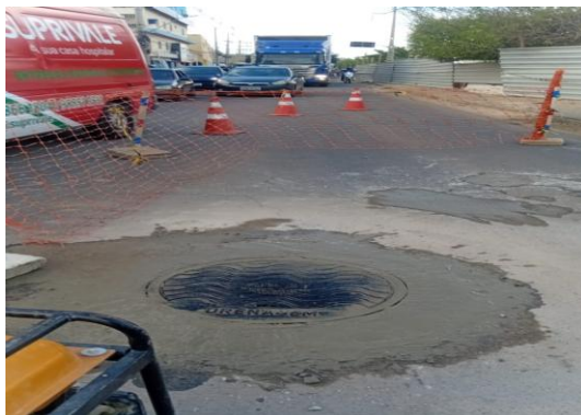
AV RAUL ALVES - SUBSTITUIÇÃO DE TAMPA
