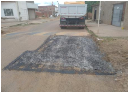
AV QUIDÉ - MANUTENÇÃO PAV ASFÁLTICA
