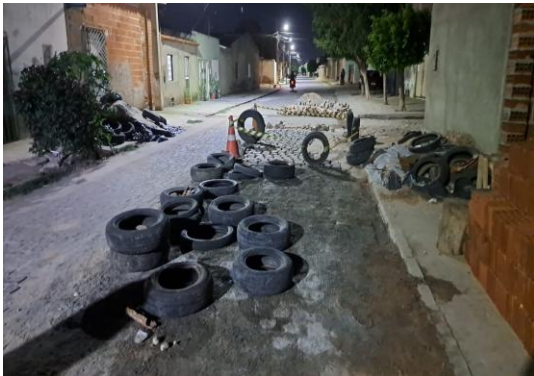
RUA I - MANUTENÇÃO PARALELEPÍPEDO
