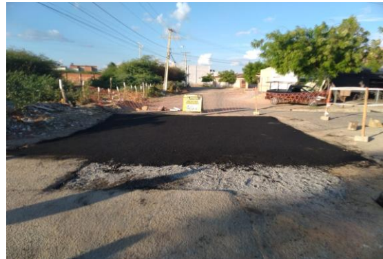
AV IRMÃ DULCE - MANUTENÇÃO PAV ASFÁLTICA
