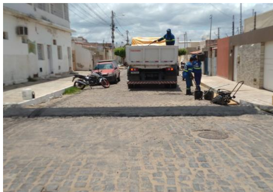
AV IRMÃ DULCE - MANUTENÇÃO PAV ASFÁLTICA
