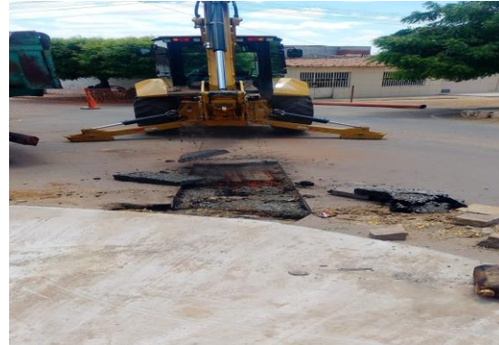
FEIRA DO ALENCAR - ESCAVAÇÃO MECANIZADA
