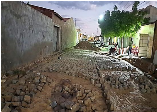
R PADRE FEIJÓ - MANUTENÇÃO EM PARALELEPÍPEDO
