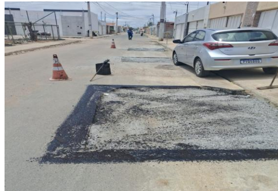
AV LUDGERO ALVES - MANUTENÇÃO PAV ASFÁLTICA
