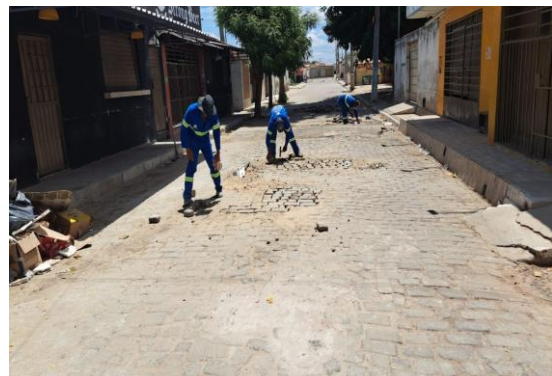
R M. CRISÓSTOMO - MAN. PARALELEPÍPEDO
