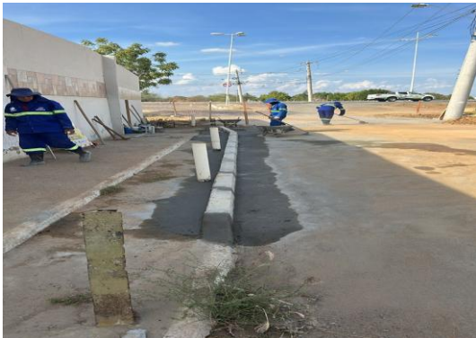
BA210 - ASSENTAMENTO DE MEIO FIO
