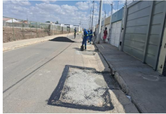
AV LUDGERO ALVES - MANUTENÇÃO PAV ASFÁLTICA
