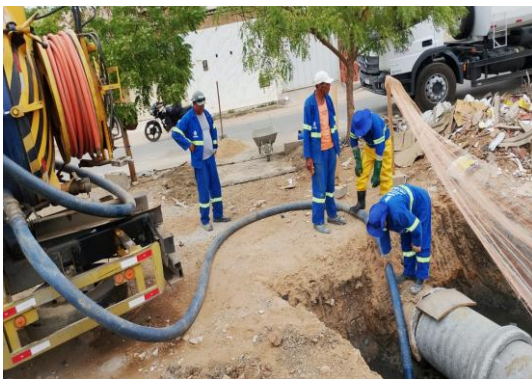
AV PROPRIÁ - SEWERJET
