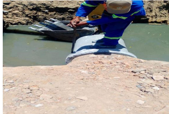
AV PROPRIÁ - TUBO DE CONCRETO
