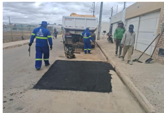
AV LUDGERO ALVES - MANUTENÇÃO PAV ASFÁLTICA
