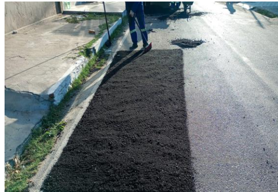
R ANTONIO CONSELHEIRO - MANUTENÇÃO PAV ASF
