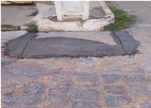
RUA DO AVELOZ - SUBSTITUIÇÃO DE TAMPA
