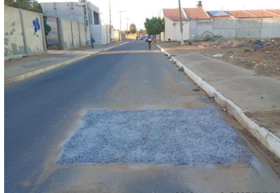
R BOA VISTA - MANUTENÇÃO PAV ASFÁLTICA
