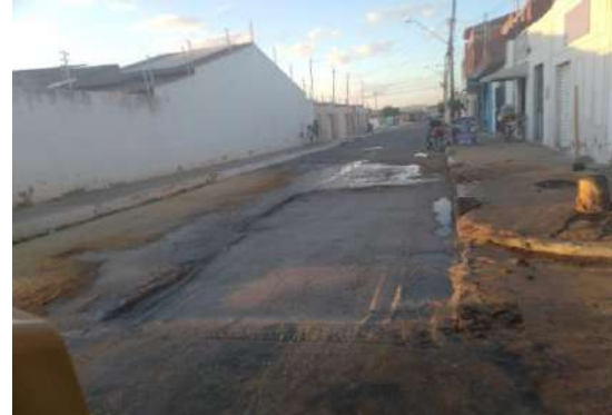
AV AIRTON SENA - APLICAÇÃO DE BRITA GRADUADA
