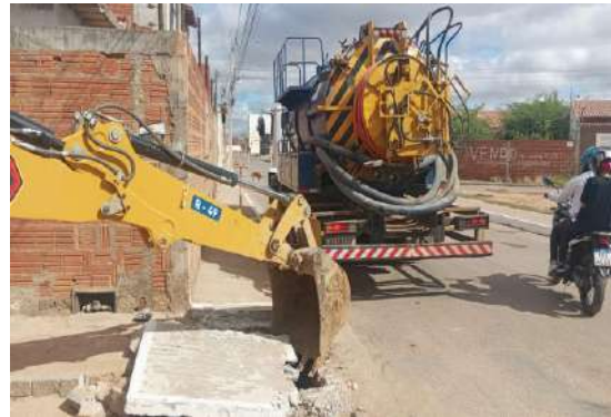
AV PROPRIÁ - ABERTURA DE TAMPA CONCRETO
