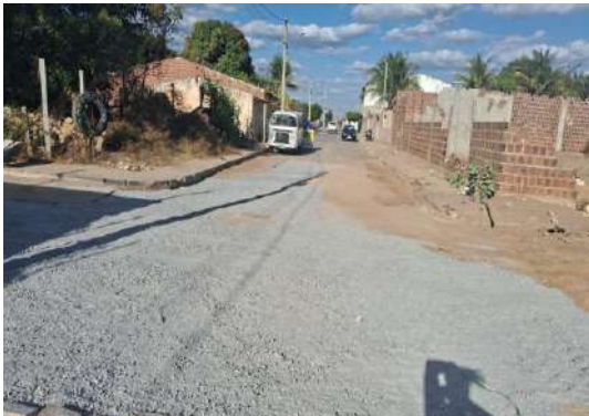
AV LUDGERO ALVES - APLICAÇÃO DE BRITA GRADUADA
