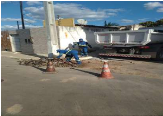
AV GIRASSOL - CORTE DE ASFALTO
