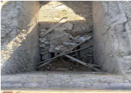
R PADRE CLEMENTE - DESOBSTRUÇÃO BOCA DE LOBO
