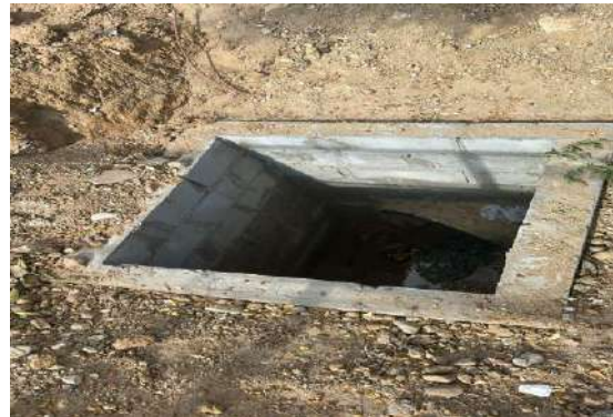
BA210 - EXECUÇÃO DE CAIXA
