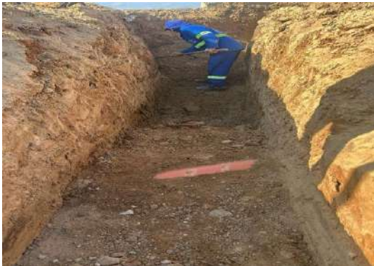
BA210 - REGULARIZAÇÃO FUNDO DE VALA
