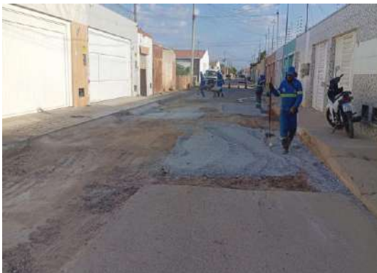
AV LUDGERO ALVES - APLICAÇÃO DE BRITA GRADUADA
