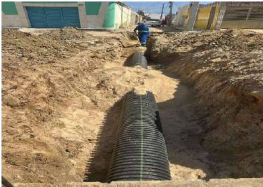
BA210 - ASSENTAMENTO TUBO PEAD 450MM
