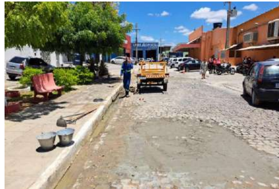
R MANOEL CRISOSTOMO - TAPA BURACO PARALELO
