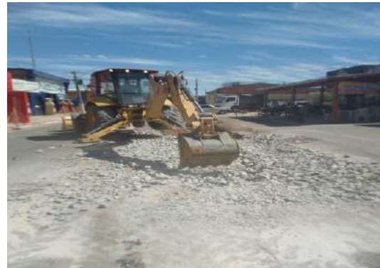
AV SÃO JOÃO - REFORÇO DE SUBLEITO COM PEDRA
