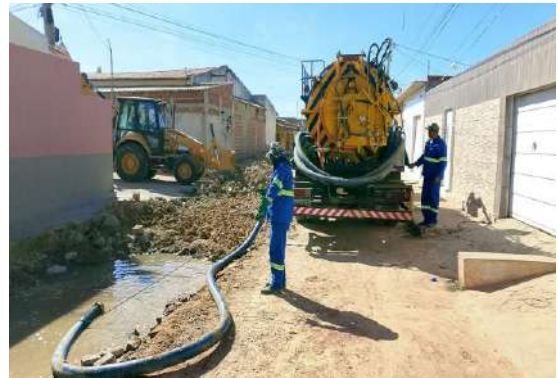
AV MIGUEL ALVES - SEWERJET
