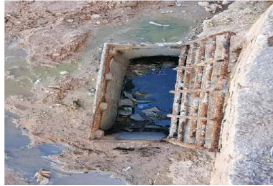
AV MIGUEL SILVA SOUZA - DESOBSTRUÇÃO CAIXA
