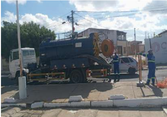
AV LUIZ INÁCIO DA SILVA - LIMPEZA COM HIDROJATO
