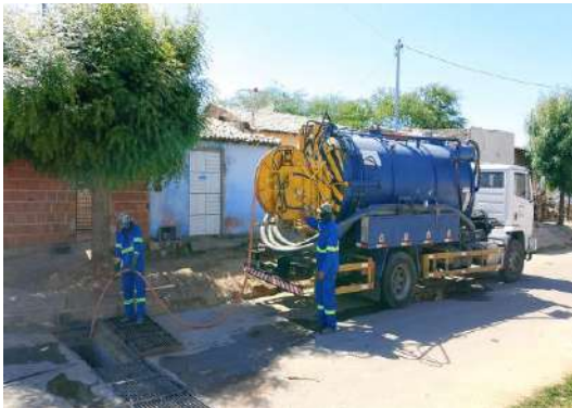
R PADRE CLEMENTE - DESOBSTRUÇÃO BOCA DE LOBO
