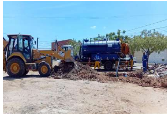
AV PROPRIÁ - SEWERJET
