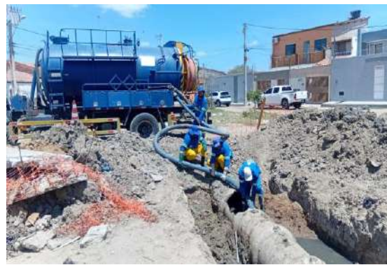
AV PROPRIÁ - SEWERJET
