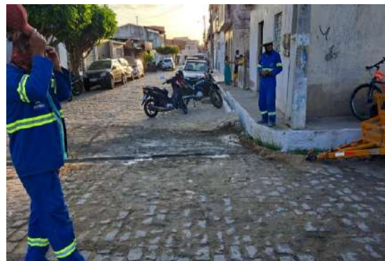
TRAVESSA MATATU - TAPA BURACO PARALELO
