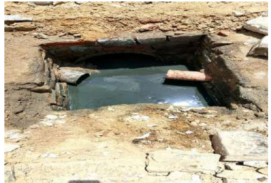
R TEREZINHA DANTAS - DESOBSTRUÇÃO BOCA DE LOBO
