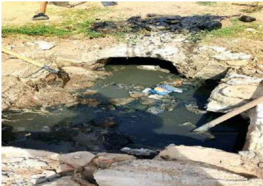
R TEREZINHA DANTAS - DESOBSTRUÇÃO BOCA DE LOBO
