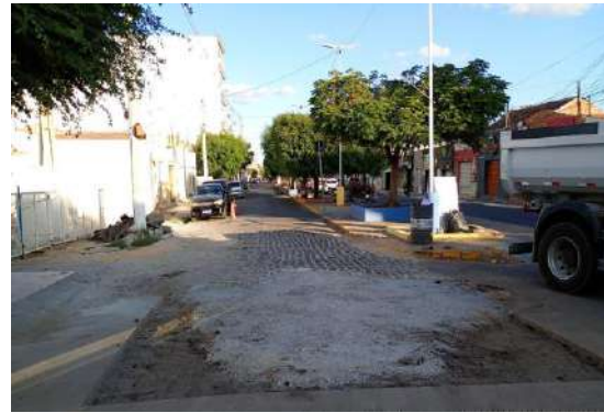
AV FLAVIANO GUIMARÃES - CORTE DE ASFALTO
