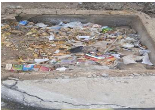
AV GIUSSEP MUCCINI - DESOBSTRUÇÃO BOCA DE LOBO
