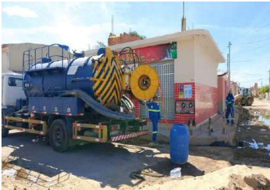
AV MIGUEL ALVES - SEWERJET
