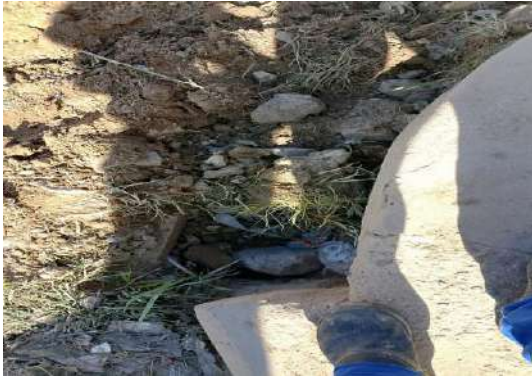
AV MIGUEL SILVA SOUZA - DESOBSTRUÇÃO CAIXA
