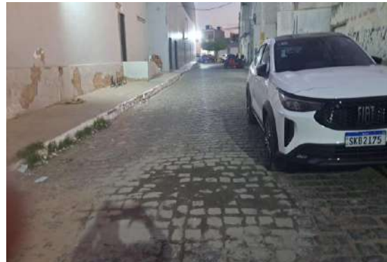
TRAVESSA MATATU - TAPA BURACO PARALELO
