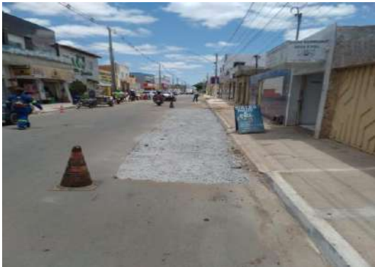
AV GIRASSOL - APLICAÇÃO DE BRITA GRADUADA
