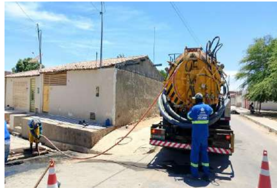
R PADRE CLEMENTE - DESOBSTRUÇÃO BOCA DE LOBO
