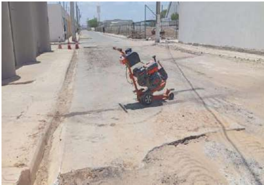
AV LUDGERO ALVES - CORTE DE ASFALTO
