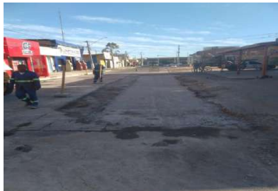
AV SÃO JOÃO - APLICAÇÃO BRITA GRADUADA SIMPLES
