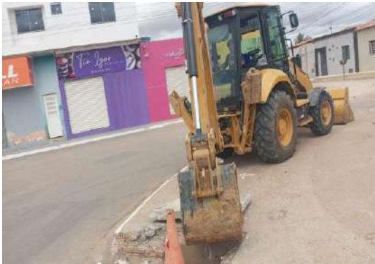
AV PROPRIÁ - ABERTURA DE TAMPA CONCRETO
