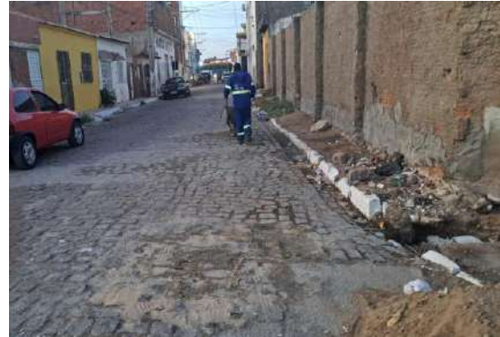
TRAVESSA MATATU - TAPA BURACO PARALELO
