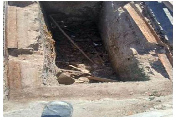
R PADRE CLEMENTE - DESOBSTRUÇÃO BOCA DE LOBO
