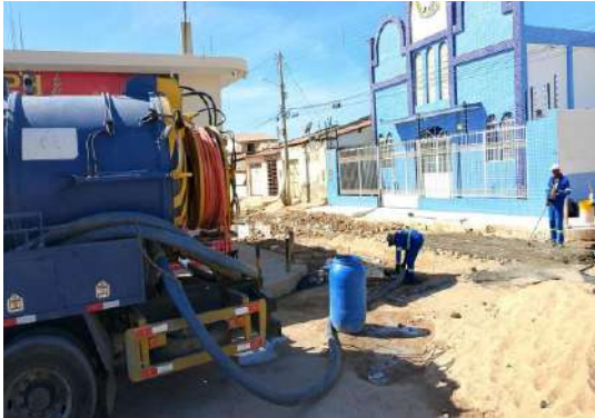
AV MIGUEL ALVES - SEWERJET
