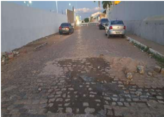
TRAVESSA MATATU - TAPA BURACO PARALELO
