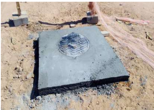
AV PROPRIÁ - INSTALAÇÃO TAMPÃO REDONDO
