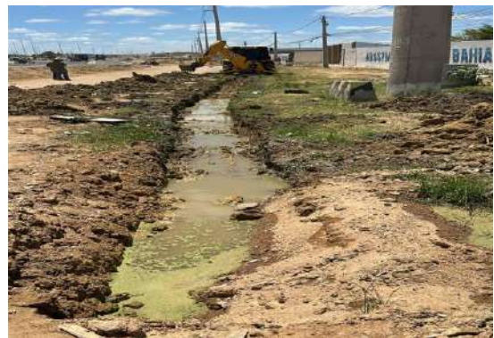
BA210 - ESCAVAÇÃO MECANIZADA
