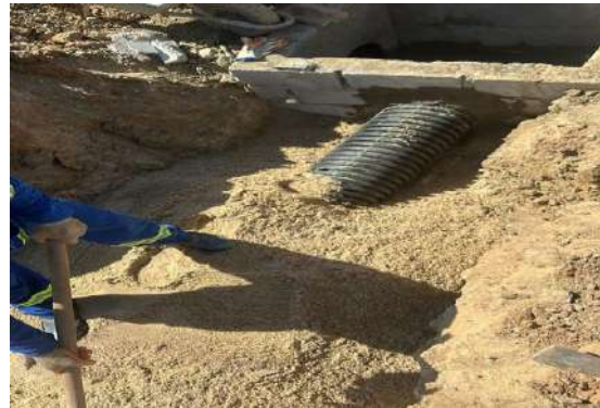
BA210 - ASSENTAMENTO TUBO PEAD 450MM
