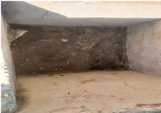
AV GIUSSEP MUCCINI - DESOBSTRUÇÃO BOCA DE LOBO
