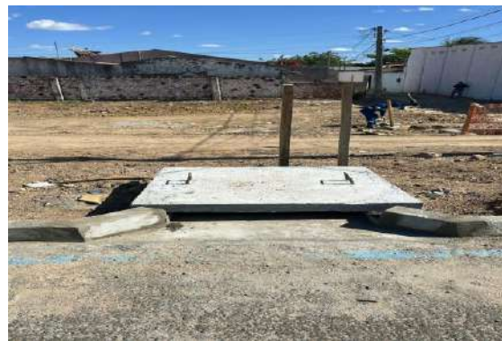
BA210 - TAMPA DE CONCRETO
