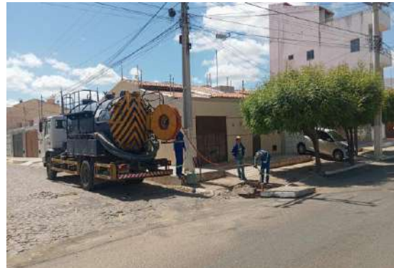
AV LUIZ INÁCIO DA SILVA - LIMPEZA COM HIDROJATO
