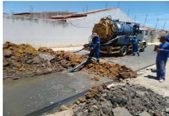
AV AIRTON SENA - SUCÇÃO COM SEWERJET
