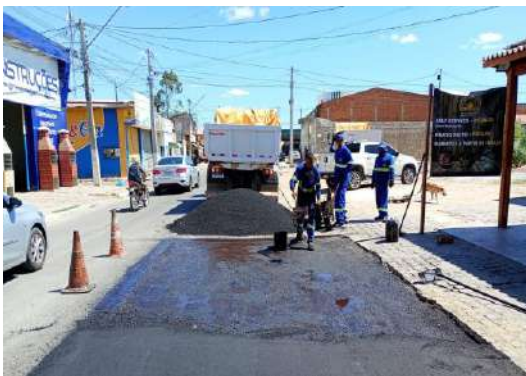
AV SÃO JOÃO - TAPA BURACO CBUQ
