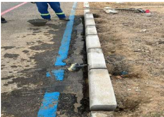
BA210 - ASSENTAMENTO DE MEIO FIO
