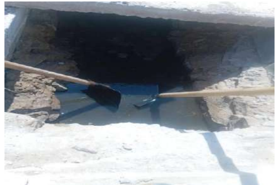
R TEREZINHA DANTAS - DESOBSTRUÇÃO BOCA DE LOBO
