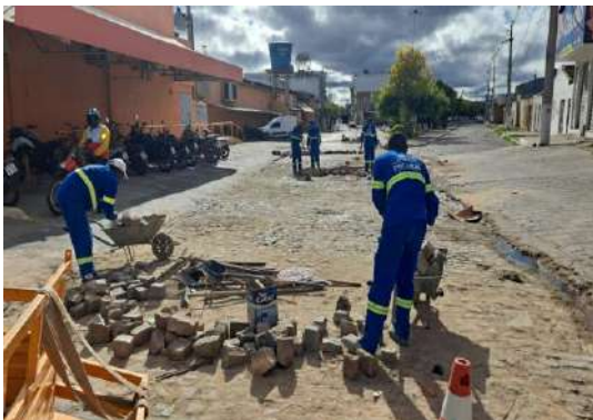
R MANOEL CRISOSTOMO - TAPA BURACO PARALELO
