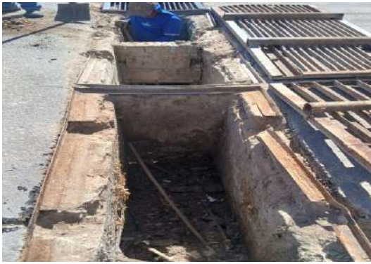
R PADRE CLEMENTE - DESOBSTRUÇÃO BOCA DE LOBO
