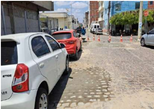
TRAVESSA MATATU - TAPA BURACO PARALELO
