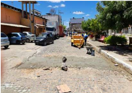
R MANOEL CRISOSTOMO - TAPA BURACO PARALELO
