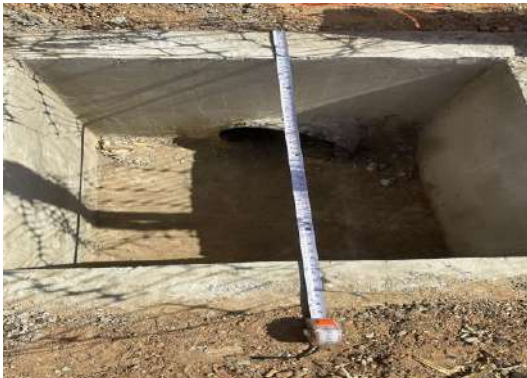
BA210 - EXECUÇÃO DE CAIXA
