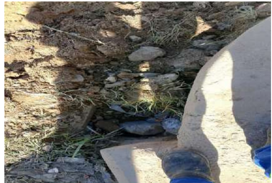
AV MIGUEL ALVES - SEWERJET
