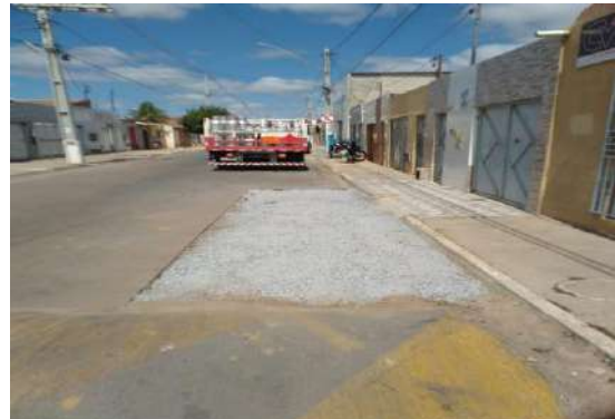
AV GIRASSOL - APLICAÇÃO DE BRITA GRADUADA
