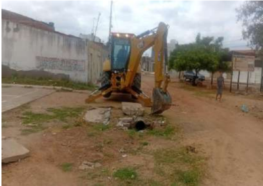
R TEREZINHA DANTAS - DESOBSTRUÇÃO BOCA DE LOBO
