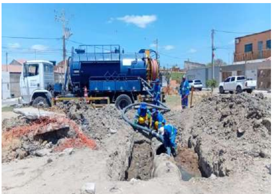
AV PROPRIÁ - SEWERJET
