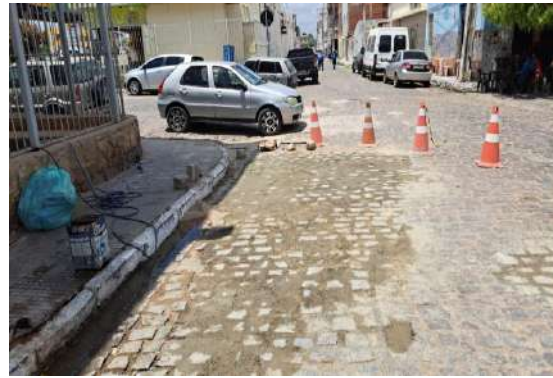
TRAVESSA MATATU - TAPA BURACO PARALELO
