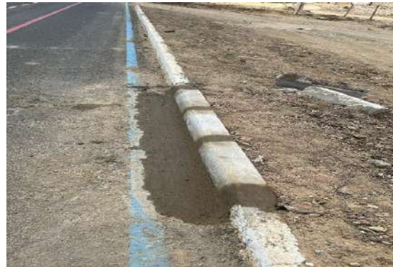
BA210 - ASSENTAMENTO DE MEIO FIO
