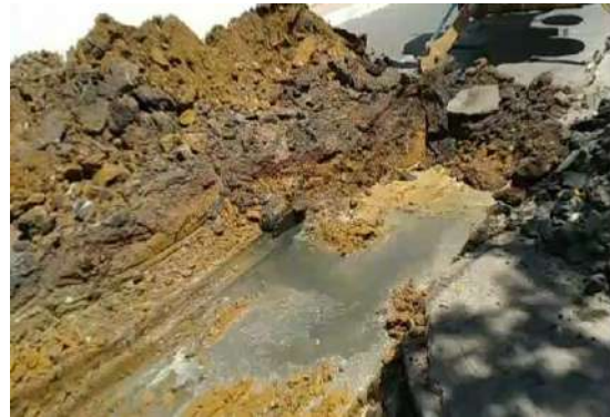
AV AIRTON SENA - ESCAVAÇÃO MECANIZADA
