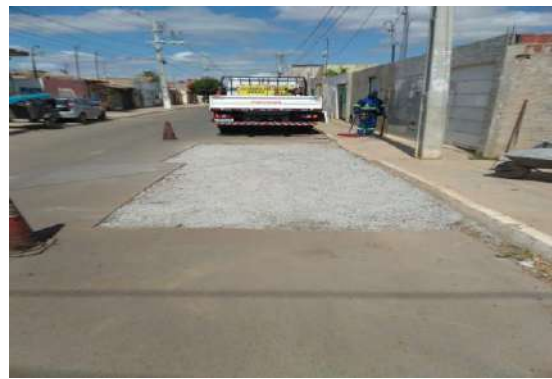
AV GIRASSOL - APLICAÇÃO DE BRITA GRADUADA
