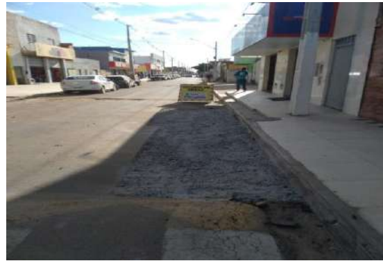
AV GIRASSOL - CORTE DE ASFALTO
