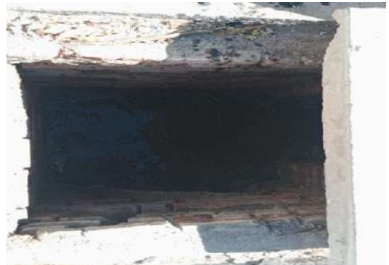
AV MIGUEL SILVA SOUZA - DESOBSTRUÇÃO CAIXA
