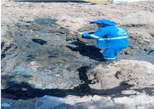
AV PROPRIÁ - SEWERJET
