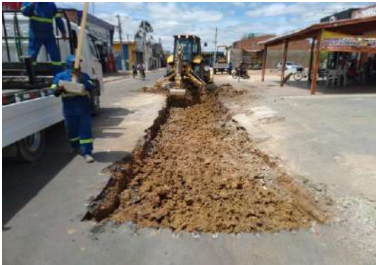
AV SÃO JOÃO - ESCAVAÇÃO MECANIZADA
