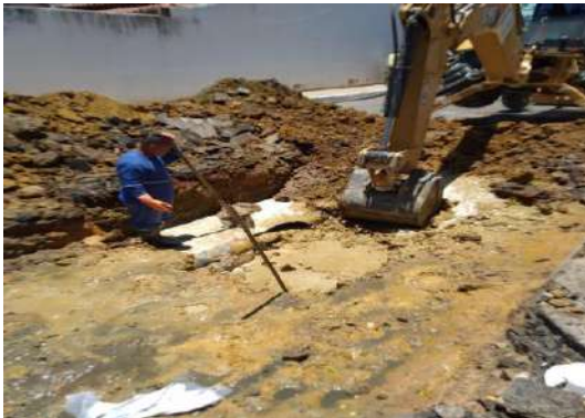
AV AIRTON SENA - ESCAVAÇÃO
