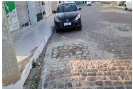
TRAVESSA MATATU - TAPA BURACO PARALELO
