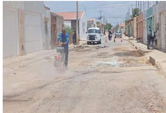
AV LUDGERO ALVES - CORTE DE ASFALTO
