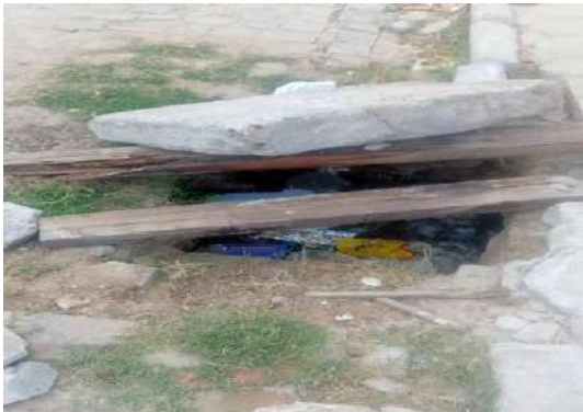
R TEREZINHA DANTAS - DESOBSTRUÇÃO BOCA DE LOBO
