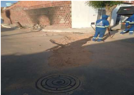
R CARLOS DRUMOND - PREPARAÇÃO DE TRECHO
