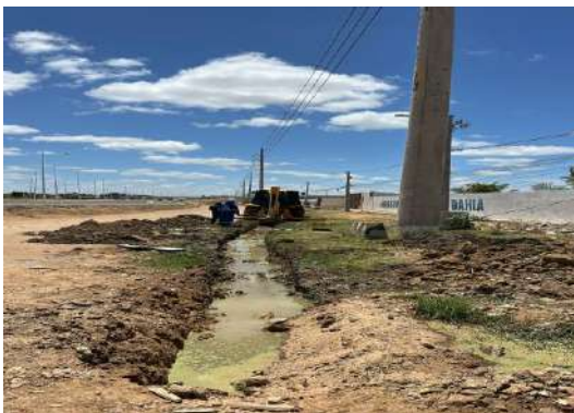
BA210 - ESCAVAÇÃO MECANIZADA
