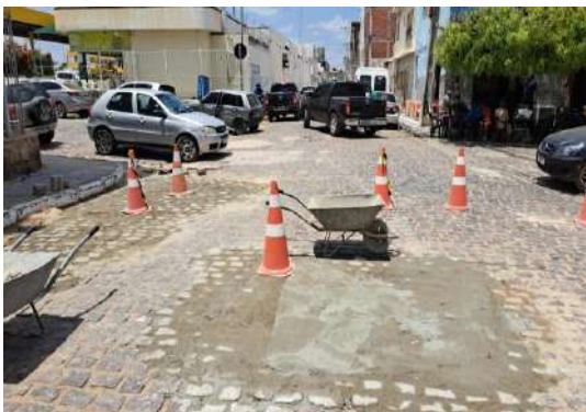
TRAVESSA MATATU - TAPA BURACO PARALELO
