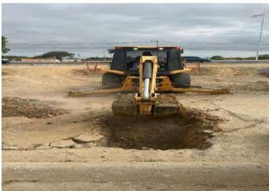
BA210 - ESCAVAÇÃO MECANIZADA
