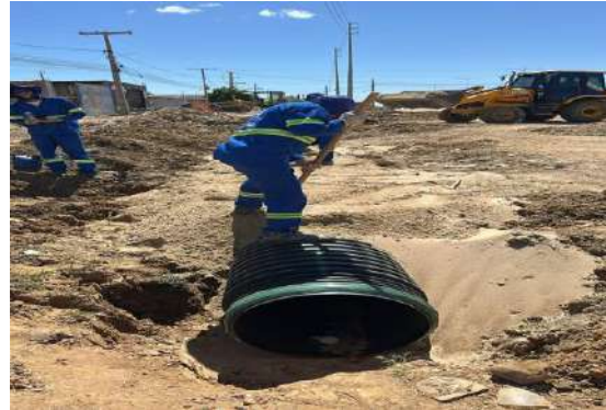
BA210 - ATERRO COM AREIA EM TUBO 600mm
