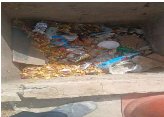
AV CRISTALINA - DESOBSTRUÇÃO BOCA DE LOBO
