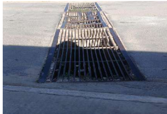
R PADRE CLEMENTE - DESOBSTRUÇÃO BOCA DE LOBO
