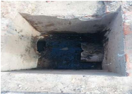
AV PROPRIÁ - LIMPEZA DE CAIXA
