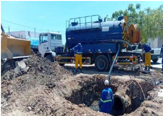
AV PROPRIÁ - SEWERJET
