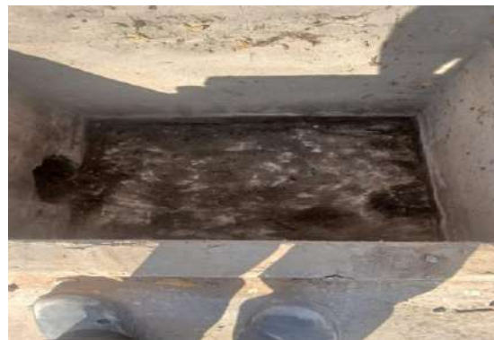
AV CRISTALINA - DESOBSTRUÇÃO BOCA DE LOBO
