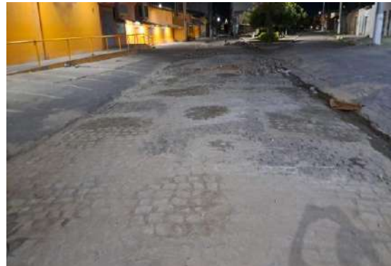
R MANOEL CRISOSTOMO - TAPA BURACO PARALELO
