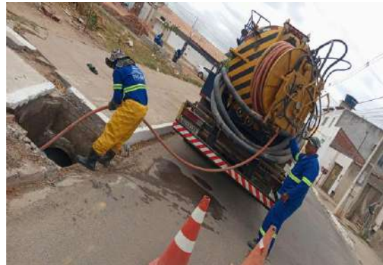
AV PROPRIÁ - SEWERJET
