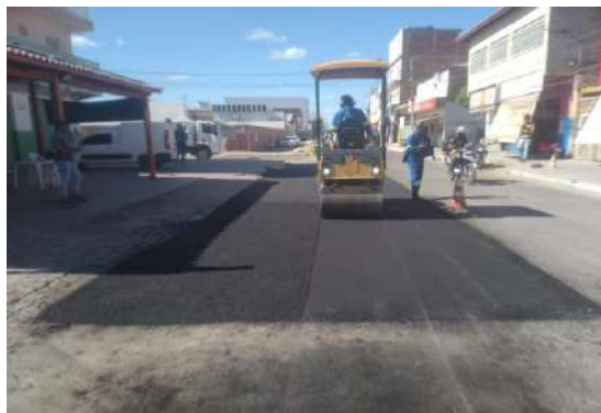
AV SÃO JOÃO - TAPA BURACO CBUQ
