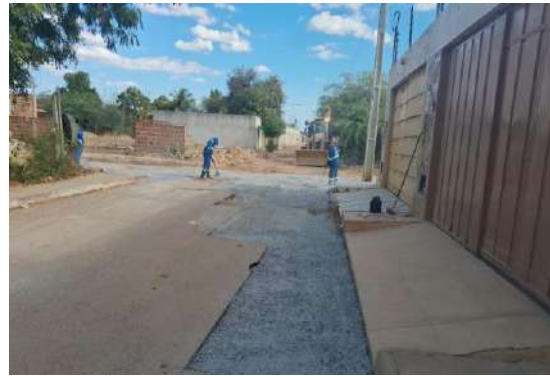
AV LUDGERO ALVES - APLICAÇÃO DE BRITA GRADUADA
