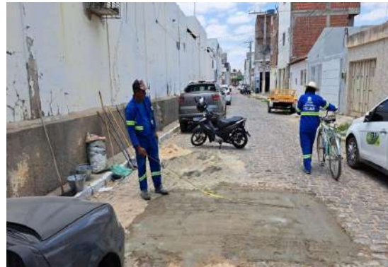
TRAVESSA MATATU - TAPA BURACO PARALELO
