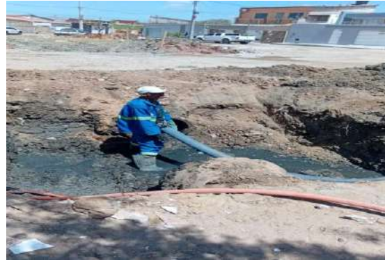
AV PROPRIÁ - SEWERJET
