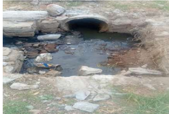
R TEREZINHA DANTAS - DESOBSTRUÇÃO BOCA DE LOBO
