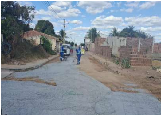
AV LUDGERO ALVES - APLICAÇÃO DE BRITA GRADUADA
