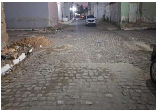
TRAVESSA MATATU - TAPA BURACO PARALELO
