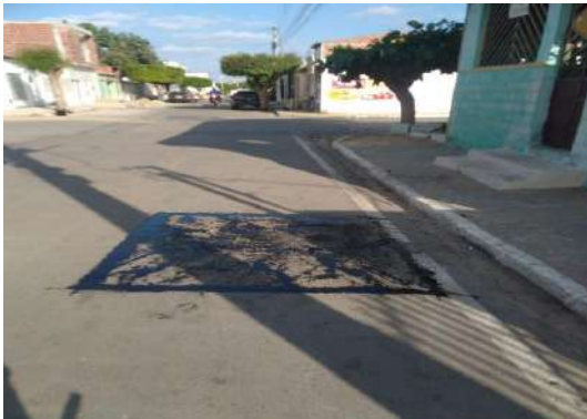
R CARLOS DRUMOND - PREPARAÇÃO DE TRECHO
