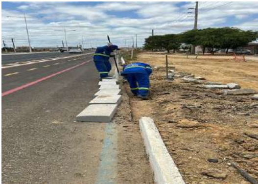
BA210 - ASSENTAMENTO DE MEIO FIO
