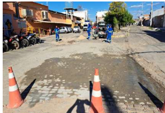
R MANOEL CRISOSTOMO - TAPA BURACO PARALELO
