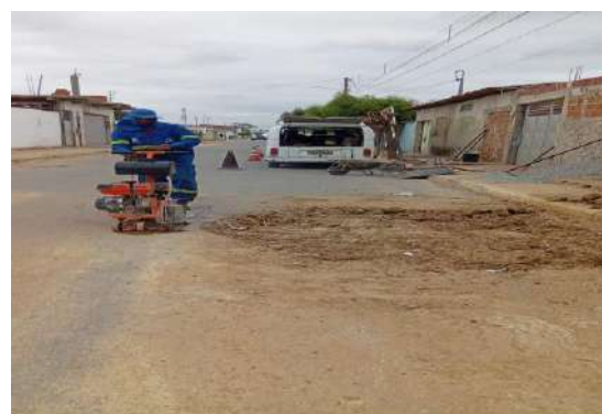
R DAS ALGAROBAS - CORTE DE ASFALTO
