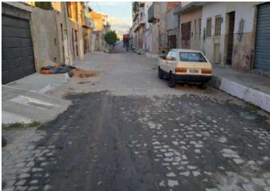
R MANOEL CRISOSTOMO - TAPA BURACO PARALELO
