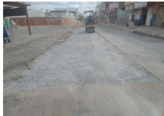
AV SÃO JOÃO - COMPACTAÇÃO COM ROLO
