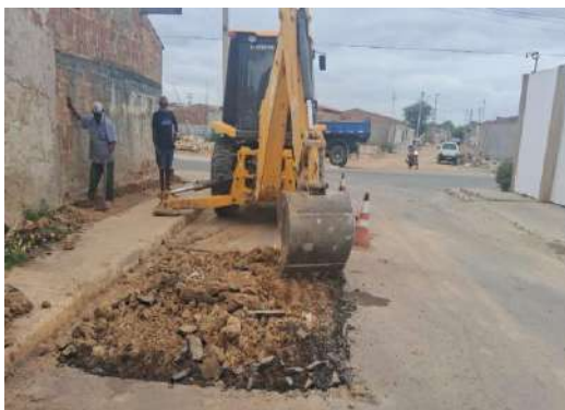
R DAS ALGAROBAS - ESCAVAÇÃO MECANIZADA
