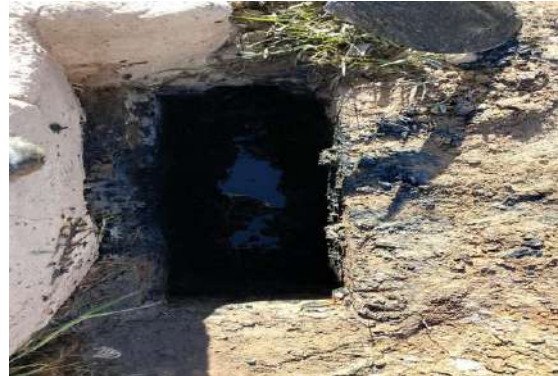
AV MIGUEL ALVES - SEWERJET
