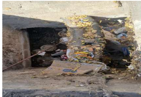
AV GIUSSEP MUCCINI - DESOBSTRUÇÃO BOCA DE LOBO
