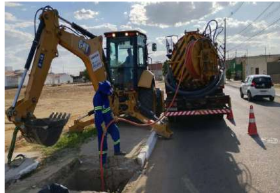
AV GIUSSEP MUCCINI - SERVIÇO DE SEWERJET
