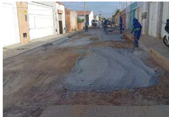
AV LUDGERO ALVES - APLICAÇÃO DE BRITA GRADUADA
