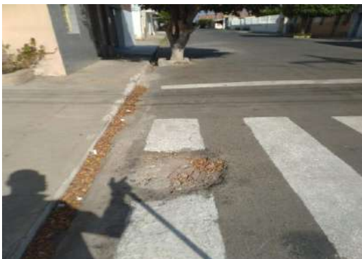
R CARLOS DRUMOND - PREPARAÇÃO DE TRECHO
