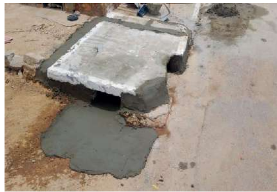
AV PROPRIÁ - RECUPERAÇÃO DE TAMPA
