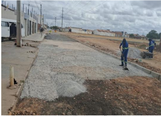
AV CRISTALINA - APLICAÇÃO DE BGS
