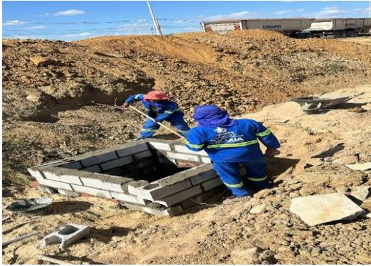
AV BANDEIRA - EXECUÇÃO POÇO DE VISITA
