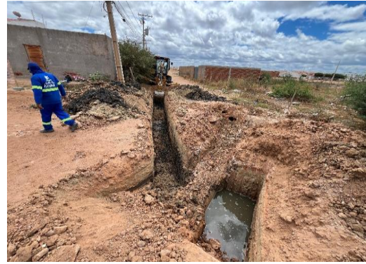
AV PROPRIÁ - ESCAVAÇÃO MECANIZADA
