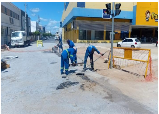
AV ADOLFO VIANA - DEMOLIÇÃO ASFÁLTICA
