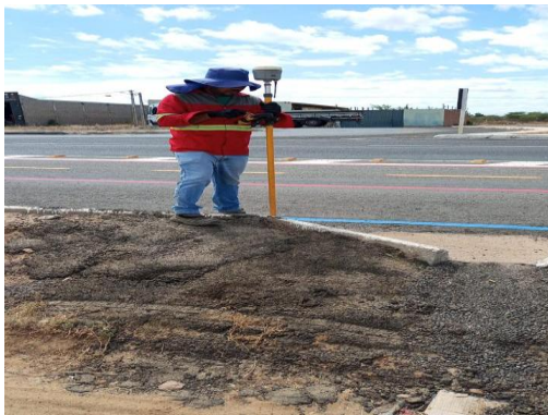
BA210 - EXECUÇÃO DE TOPOGRAFIA
