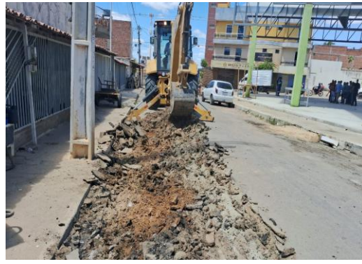
AV MACHADO DE ASSIS - CORTE DE TRECHO
