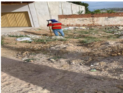
BA210 - EXECUÇÃO DE TOPOGRAFIA
