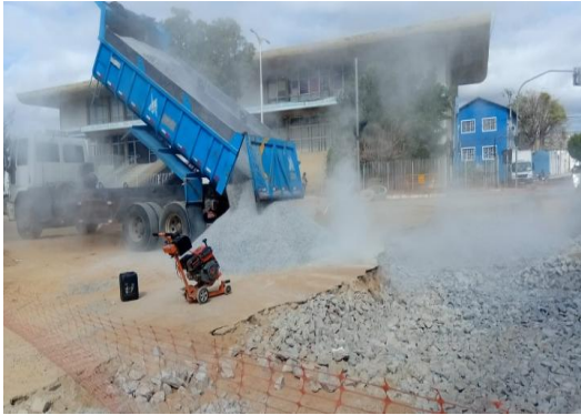
AV ADOLFO VIANA - APLICAÇÃO DE BGS
