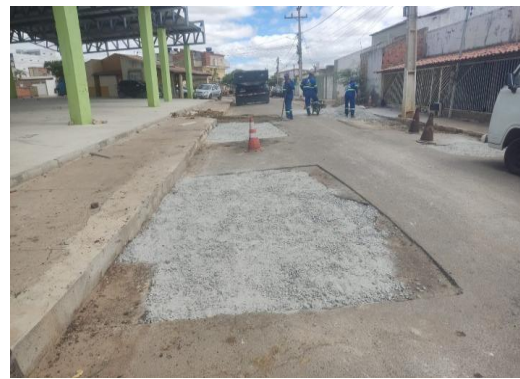
AV MACHADO DE ASSIS - APLICAÇÃO DE BGS
