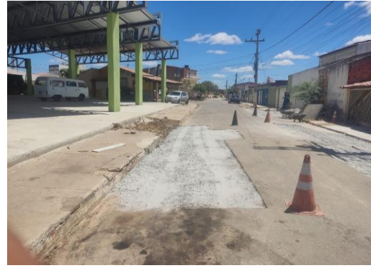
AV MACHADO DE ASSIS - APLICAÇÃO DE BGS
