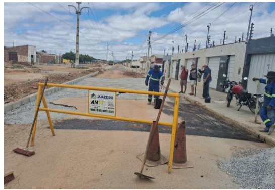
AV CRISTALINA - ESCAVAÇÃO MECANIZADA
