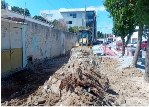
PRAÇA ALFREDO ALVES - LIMPEZA DE ÁREA
