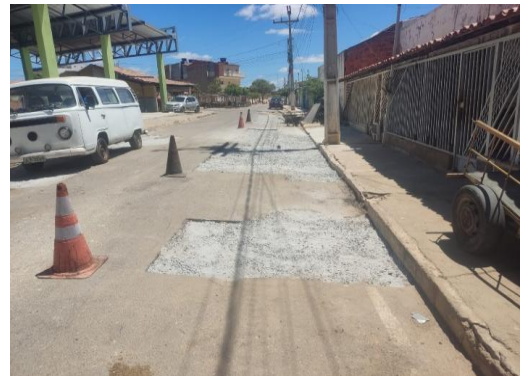
AV MACHADO DE ASSIS - APLICAÇÃO DE BGS
