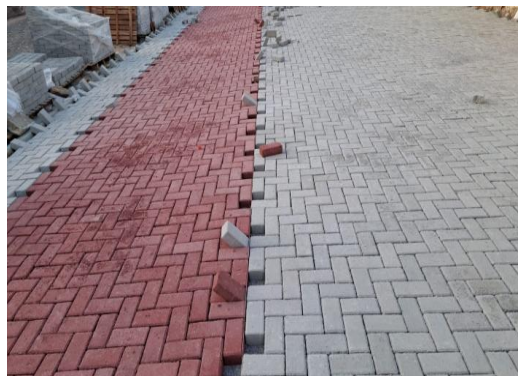
PRAÇA ALFREDO ALVES - PISO INTERTRAVADO
