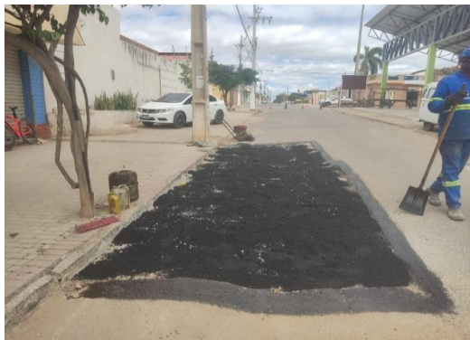
AV MACHADO DE ASSIS - APLICAÇÃO DE CBUQ
