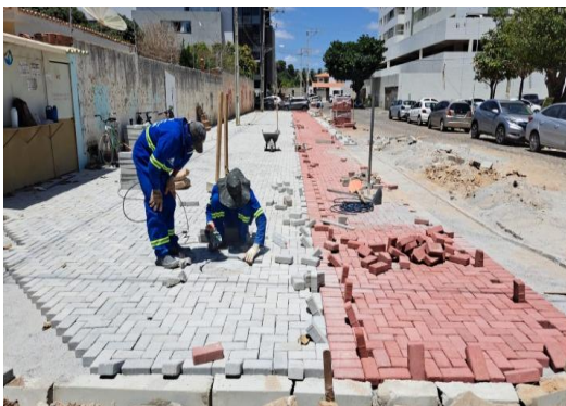
PRAÇA ALFREDO ALVES - PISO INTERTRAVADO
