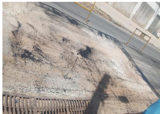
RUA MATATU - PREPARAÇÃO DE TRECHO
