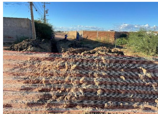
AV PROPRIÁ - ISOLAMENTO COM TELA
