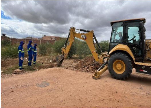
AV PROPRIÁ - ESCAVAÇÃO MECANIZADA
