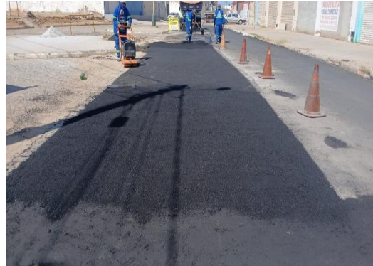
RUA MATATU - TAPA BURACO COM CBUQ
