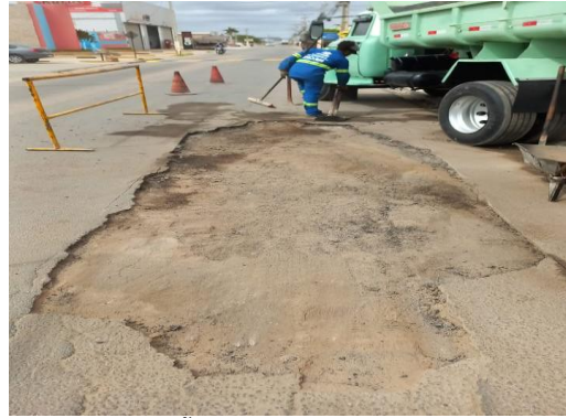
AV IRMÃ DULCE - CORTE DE ASFALTO
