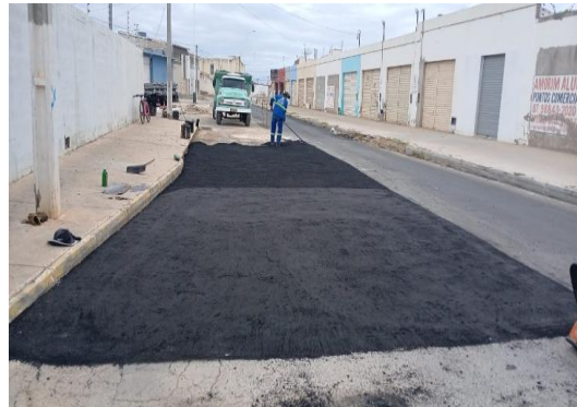
RUA MATATU - TAPA BURACO COM CBUQ
