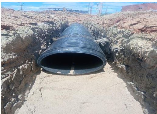
AV PROPRIÁ - ASSENTAMENTO DE TUBO
