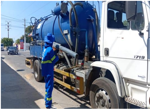
AV CRISTALINA - SERVIÇO DE SEWERJET
