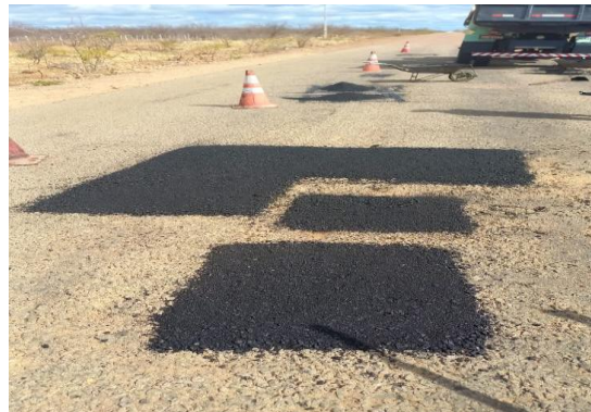
JUNCO - APLICAÇÃO DE CBUQ
