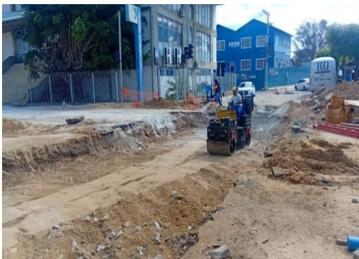
AV ADOLFO VIANA - COMPACTAÇÃO COM ROLO
