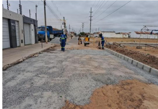
AV CRISTALINA - APLICAÇÃO DE BGS
