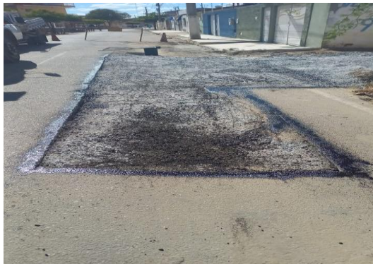
AV MACHADO DE ASSIS - APLICAÇÃO DE EMULSÃO
