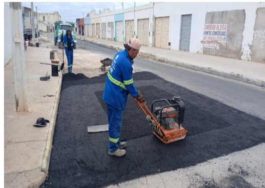
RUA MATATU - TAPA BURACO COM CBUQ
