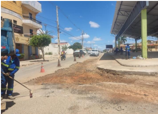
AV MACHADO DE ASSIS - CORTE DE TRECHO
