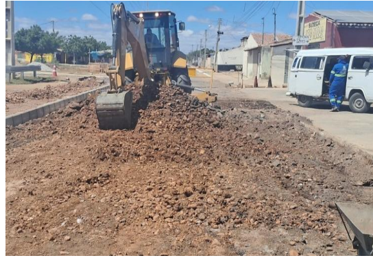
AV CRISTALINA - PREPARAÇÃO DE TRECHO
