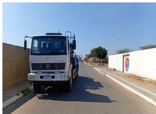
AV LUDGERO ALVES - SERVIÇO DE SEWERJET
