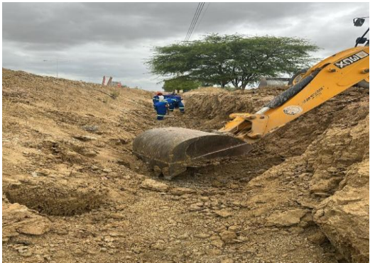
AV BANDEIRA - ESCAVAÇÃO MECANIZADA
