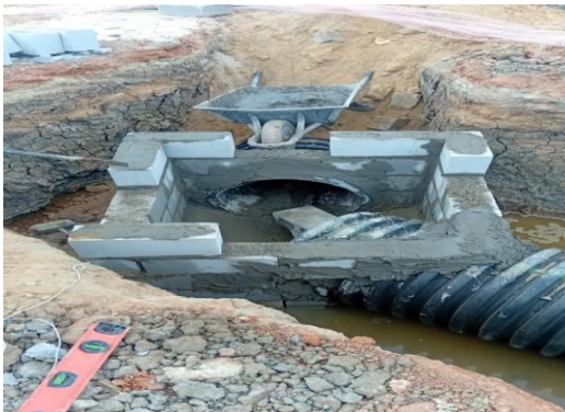
AV PROPRIÁ - EXECUÇÃO DE CAIXA
