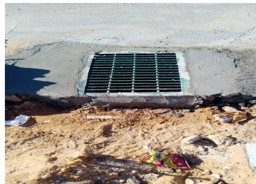
ESTACIONAMENTO - INSTALAÇÃO DE GRELHA
