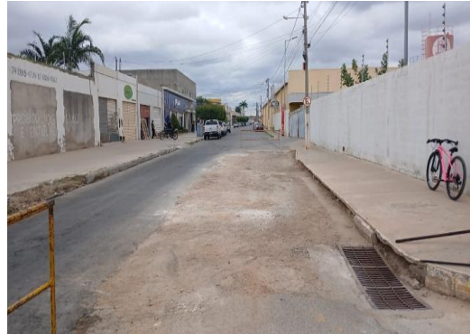
RUA MATATU - TAPA BURACO COM CBUQ
