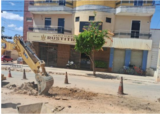
AV MACHADO DE ASSIS - CORTE DE ASFALTO
