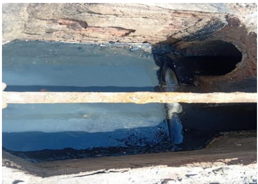
AV RAUL ALVES - LIMPEZA DE CAIXAS
