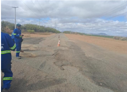
JUNCO - PREPARAÇÃO DE TRECHO
