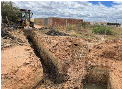
AV PROPRIÁ - ESCAVAÇÃO MECANIZADA
