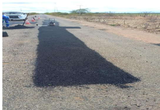
JUNCO - APLICAÇÃO DE CBUQ
