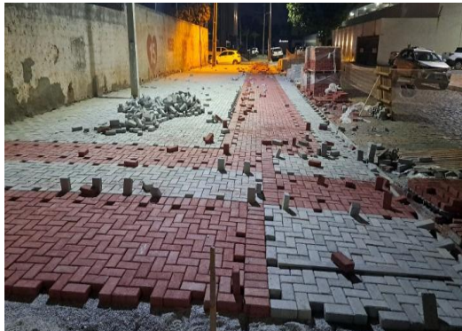
PRAÇA ALFREDO ALVES - REDE DE DRENAGEM
