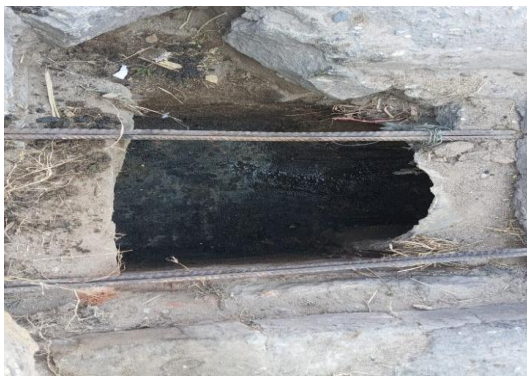
AV RAUL ALVES - LIMPEZA DE CAIXAS
