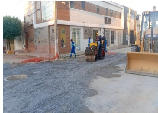
AV ADOLFO VIANA - COMPACTAÇÃO DE SOLO
