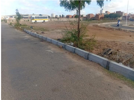
AV LUIS INÁCIO LULA - ASSENTAMENTO DE MEIO FIO
