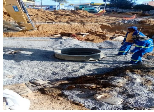
AV ADOLFO VIANA - APLICAÇÃO ANEL DE CONCRETO
