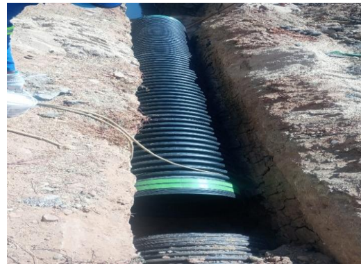
AV PROPRIÁ - ASSENTAMENTO DE TUBO
