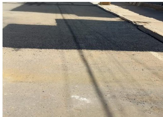
AV MACHADO DE ASSIS - APLICAÇÃO DE CBUQ
