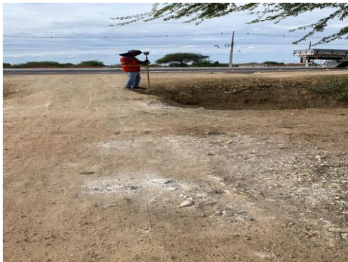
BA210 - EXECUÇÃO DE TOPOGRAFIA
