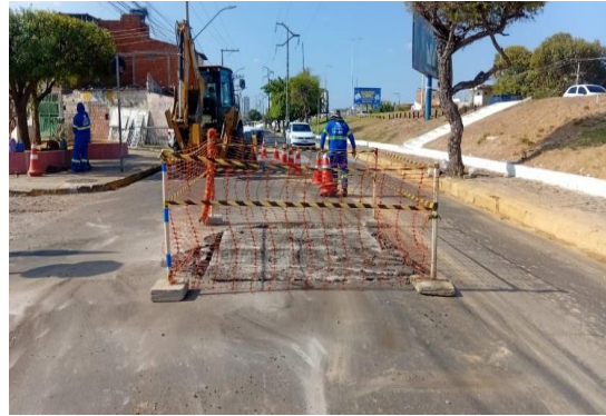
AV RAUL ALVES - LIMPEZA DE CAIXAS
