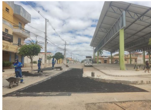
AV MACHADO DE ASSIS - APLICAÇÃO DE CBUQ
