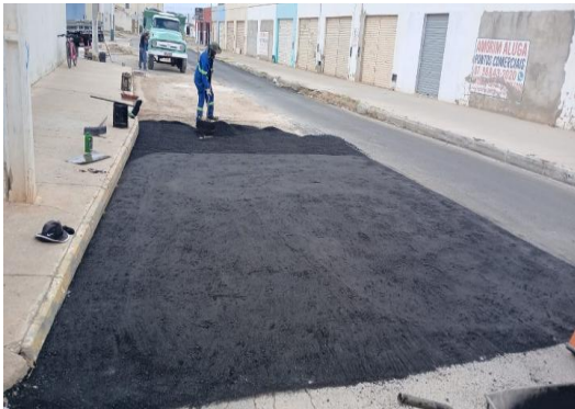
RUA MATATU - TAPA BURACO COM CBUQ
