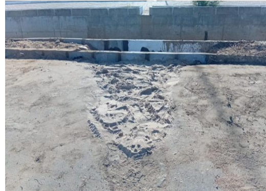
AV PARQUE DA CIDADE - ASSENTAMENTO DE MEIO
