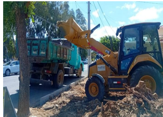
PRAÇA ALFREDO ALVES - LIMPEZA DE ÁREA
