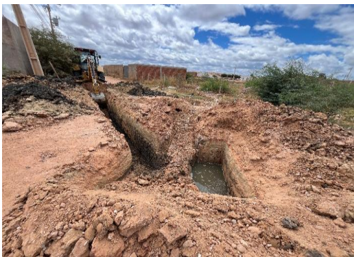
AV PROPRIÁ - ESCAVAÇÃO MECANIZADA
