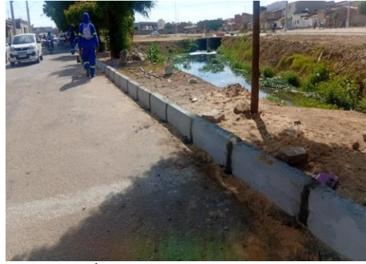
AV LUIS INÁCIO LULA - ASSENTAMENTO DE MEIO FIO
