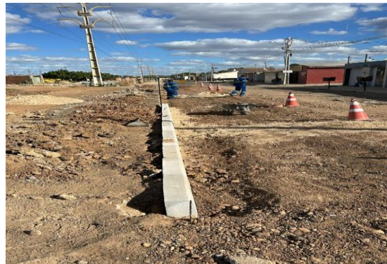
AV CRISTALINA - ASSENTAMENTO DE MEIO FIO
