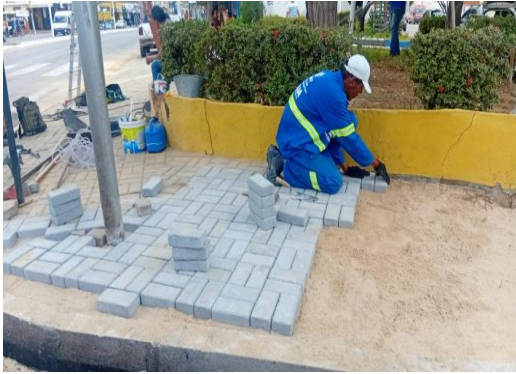
AV ADOLFO VIANA - APLICAÇÃO DE INTERTRAVADO
