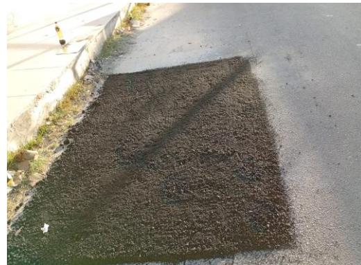
AV PARQUE DA CIDADE - APLICAÇÃO DE CBUQ
