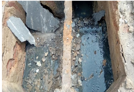
AV RAUL ALVES - LIMPEZA DE CAIXAS
