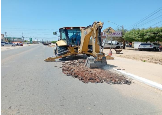
AV GIUSSEP MUCCINI - ESCAVAÇÃO MECANIZADA
