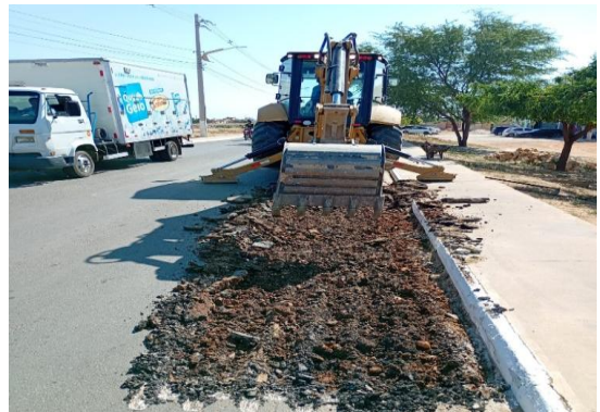
AV GIUSSEP MUCCINI - ESCAVAÇÃO MECANIZADA
