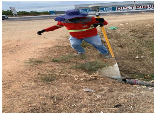
BA210 - EXECUÇÃO DE TOPOGRAFIA
