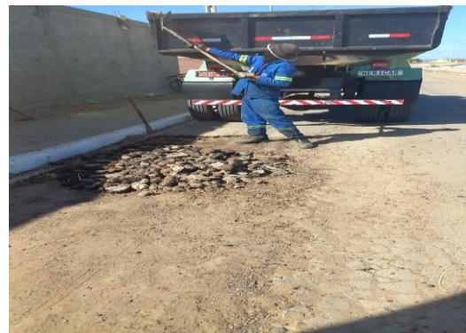
AV PARQUE DA CIDADE - LIMPEZA DE TRECHO
