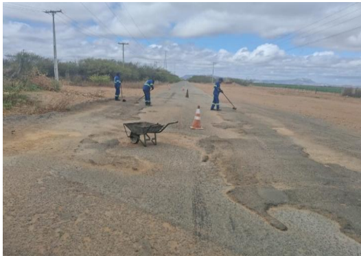
JUNCO - PREPARAÇÃO DE TRECHO
