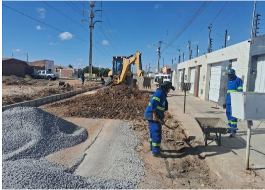
AV CRISTALINA - ESCAVAÇÃO MECANIZADA
