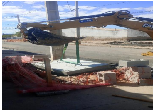
AV PROPRIÁ - ASSENTAMENTO DE TAMPA
