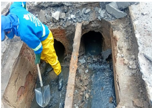
AV RAUL ALVES - LIMPEZA DE CAIXAS
