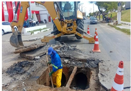
AV RAUL ALVES - LIMPEZA DE CAIXAS
