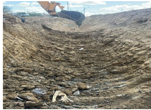
AV BANDEIRA - ESCAVAÇÃO MECANIZADA
