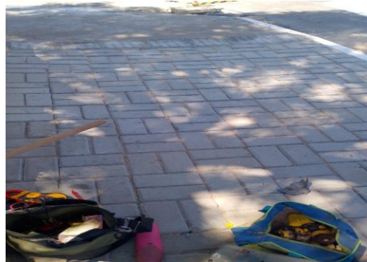
AV ADOLFO VIANA - APLICAÇÃO DE INTERTRAVADO
