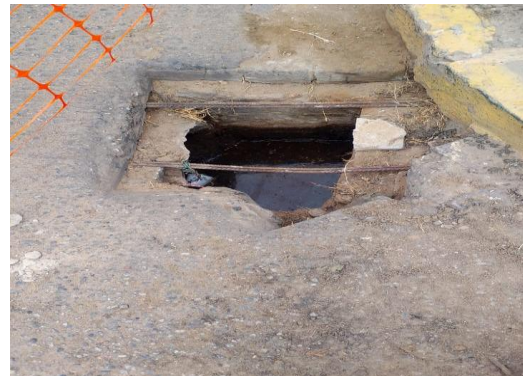
INSTALAÇÃO DE GRELHA DE FERRO ARTIC
