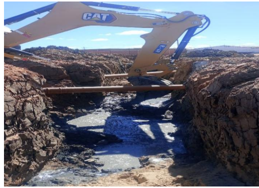
AV PROPRIÁ - ESCAVAÇÃO
