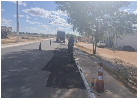
AV GIUSSEP MUCCINI - PREPARAÇÃO DE TRECHO
