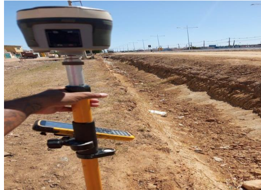
BA210 - EXECUÇÃO DE TOPOGRAFIA
