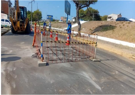
AV RAUL ALVES - LIMPEZA DE CAIXAS
