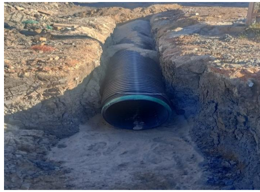
AV PROPRIÁ - ASSENTAMENTO DE TUBO
