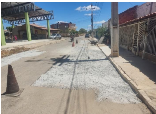
AV MACHADO DE ASSIS - APLICAÇÃO DE BGS
