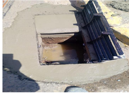
INSTALAÇÃO DE GRELHA DE FERRO ARTIC
