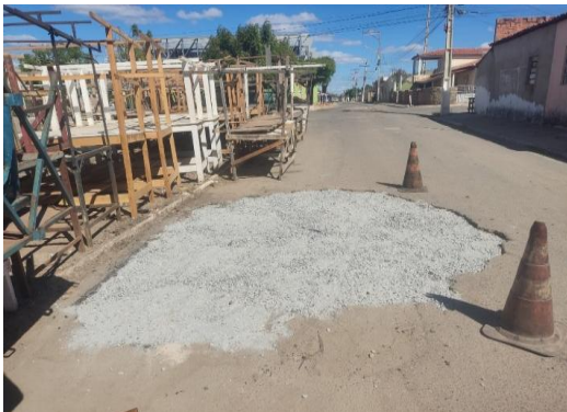
AV MACHADO DE ASSIS - APLICAÇÃO DE BGS
