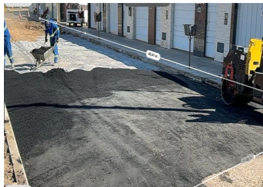
AV CRISTALINA - ESCAVAÇÃO DE TRECHO
