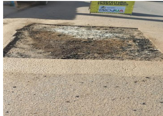
AV PARQUE DA CIDADE - CORTE DE ASFALTO
