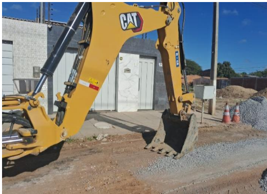
AV CRISTALINA - APLICAÇÃO DE BGS
