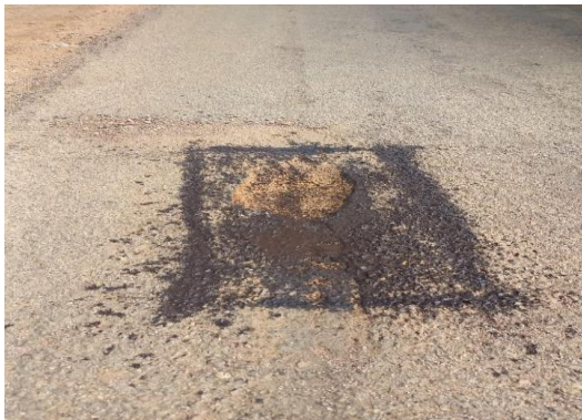
JUNCO - PREPARAÇÃO DE TRECHO
