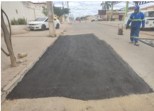
AV MACHADO DE ASSIS - APLICAÇÃO DE CBUQ
