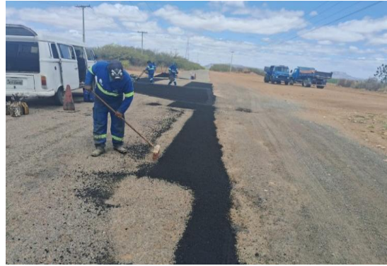
JUNCO - APLICAÇÃO DE CBUQ
