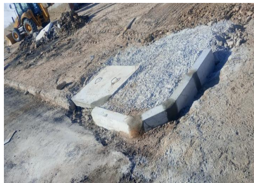
AV PROPRIÁ - ASSENTAMENTO DE MEIO FIO
