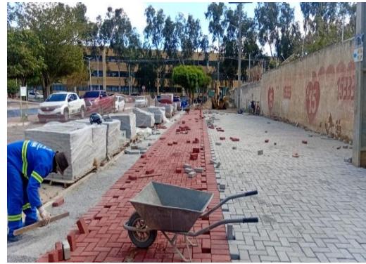
PRAÇA ALFREDO ALVES - PISO INTERTRAVADO
