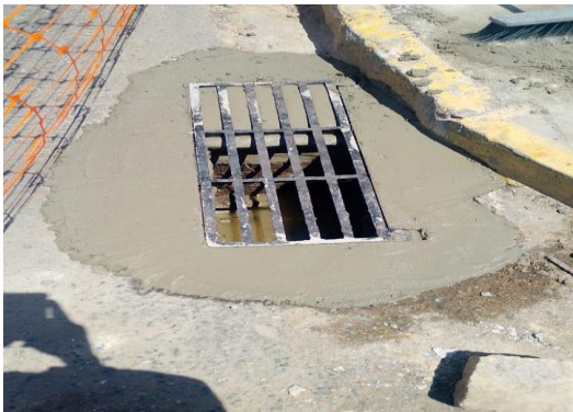
INSTALAÇÃO DE GRELHA DE FERRO ARTIC
