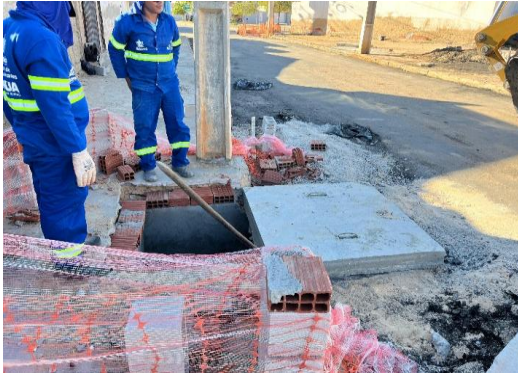
AV PROPRIÁ - APLICAÇÃO DE TAMPAS DE CONCRETO
