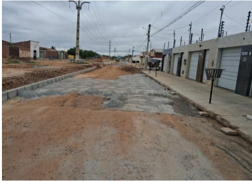
AV CRISTALINA - APLICAÇÃO DE BGS
