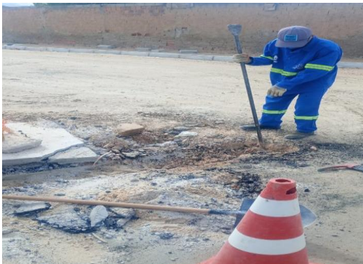
AV PROPRIÁ - ESCAVAÇÃO DE VALA
