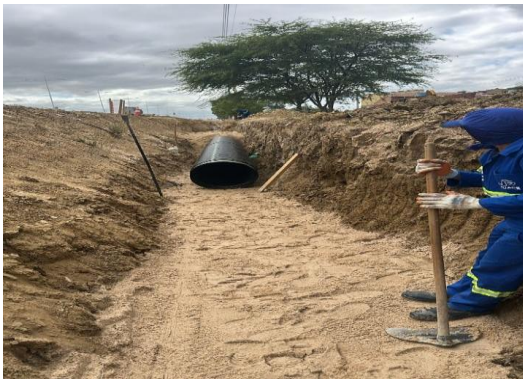
AV BANDEIRA - ASSENTAMENTO TUBOS PEAD 600mm
