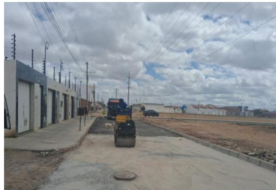
AV CRISTALINA - COMPACTAÇÃO COM ROLO
