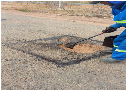
JUNCO - PREPARAÇÃO DE TRECHO
