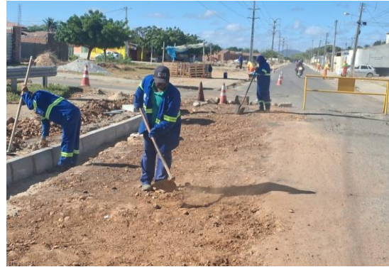
AV CRISTALINA - PREPARAÇÃO DE TRECHO
