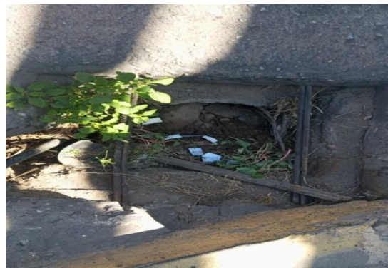
AV RAUL ALVES - LIMPEZA DE CAIXAS
