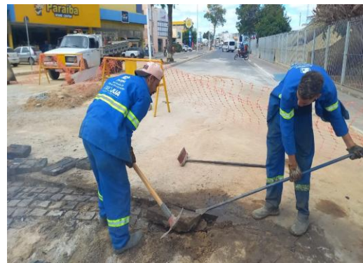
AV ADOLFO VIANA - DEMOLIÇÃO ASFÁLTICA
