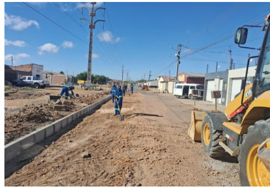
AV CRISTALINA - PREPARAÇÃO DE TRECHO
