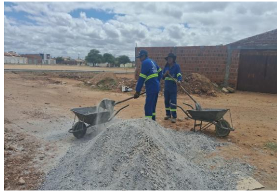
AV CRISTALINA - APLICAÇÃO DE BGS
