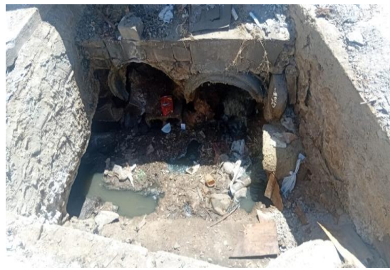
AV RAUL ALVES - LIMPEZA DE CAIXAS
