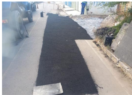
AV MACHADO DE ASSIS - APLICAÇÃO DE CBUQ
