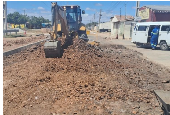
AV CRISTALINA - ESCAVAÇÃO MECANIZADA
