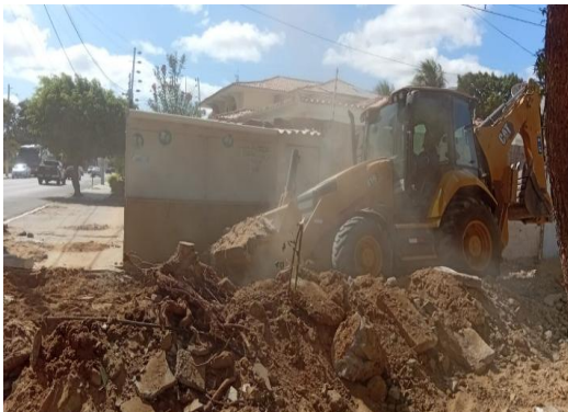
PRAÇA ALFREDO ALVES - LIMPEZA DE ÁREA
