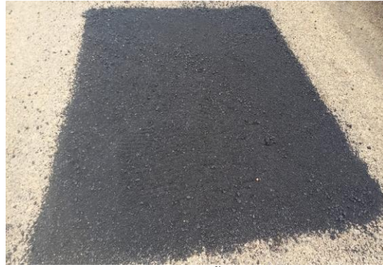
JUNCO - APLICAÇÃO DE CBUQ
