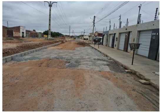
AV CRISTALINA - PREPARAÇÃO DE TRECHO
