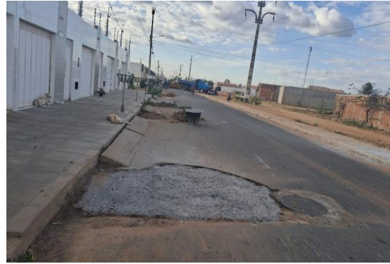
AV CRISTALINA - PREPARAÇÃO DE TRECHO
