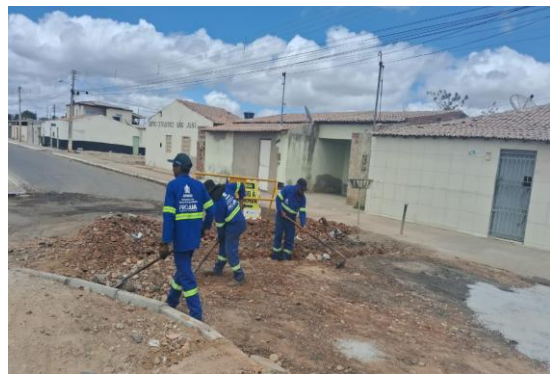
AV CRISTALINA - ESCAVAÇÃO MANUAL
