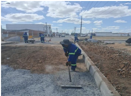
AV CRISTALINA - APLICAÇÃO DE BGS
