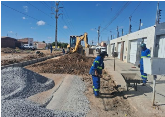
AV CRISTALINA - APLICAÇÃO DE BGS
