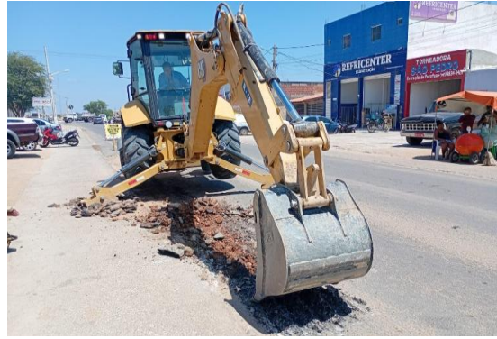
AV GIUSSEP MUCCINI - ESCAVAÇÃO MECANIZADA
