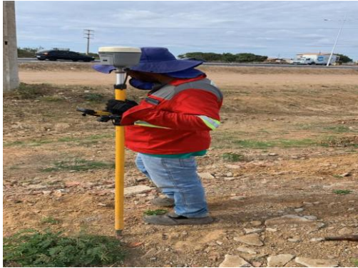
BA210 - EXECUÇÃO DE TOPOGRAFIA
