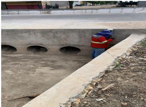
BA210 - EXECUÇÃO DE TOPOGRAFIA
