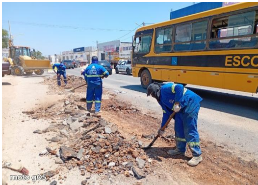
AV GIUSSEP MUCCINI - PREPARAÇÃO DE TRECHO
