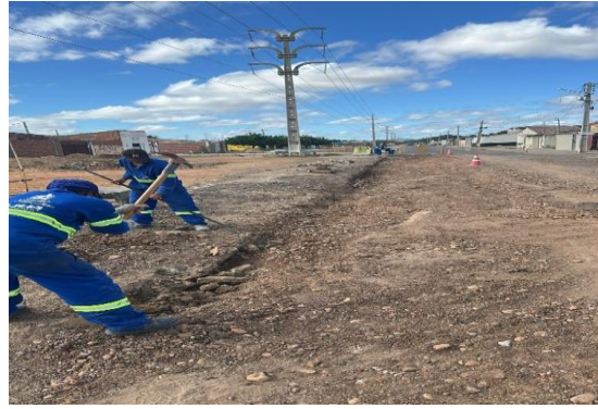
AV CRISTALINA - ESCAVAÇÃO DE VALA
