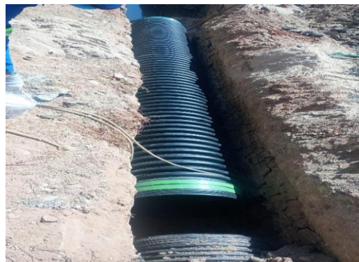
AV PROPRIÁ - ASSENTAMENTO DE TUBO
