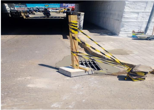
INSTALAÇÃO DE GRELHA DE FERRO ARTIC
