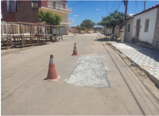
AV MACHADO DE ASSIS - APLICAÇÃO DE BGS
