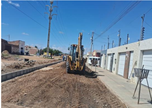
AV CRISTALINA - ESCAVAÇÃO MECANIZADA
