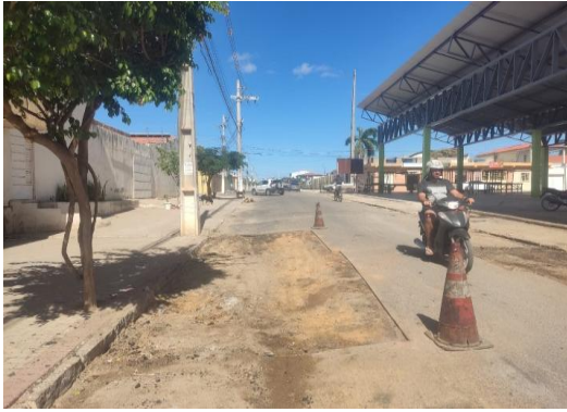
AV MACHADO DE ASSIS - CORTE DE ASFALTO
