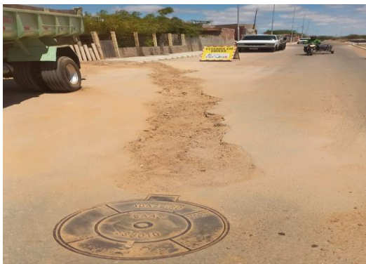
AV PARQUE DA CIDADE - LIMPEZA DE TRECHO
