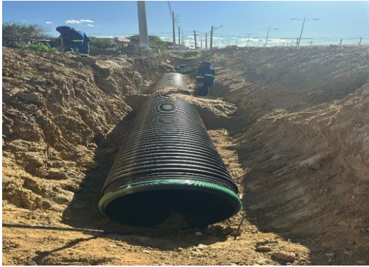
AV BANDEIRA - ASSENTAMENTO TUBOS PEAD 600mm
