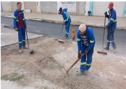
RUA MATATU - PREPARAÇÃO DE TRECHO
