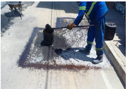
AV MACHADO DE ASSIS - APLICAÇÃO DE EMULSÃO
