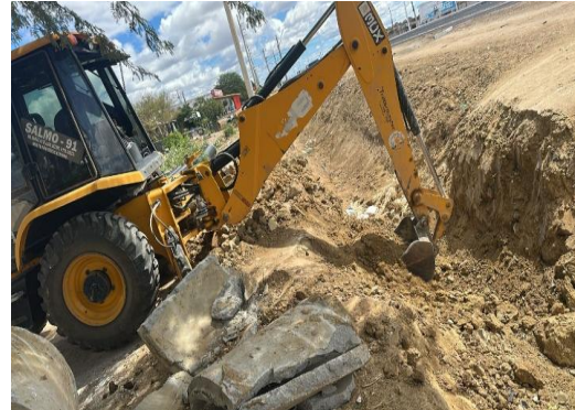
AV BANDEIRA - ESCAVAÇÃO MECANIZADA
