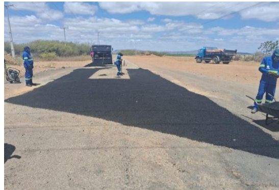
JUNCO - APLICAÇÃO DE CBUQ
