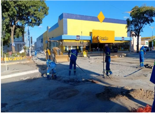
AV ADOLFO VIANA - APLICAÇÃO DE BGS
