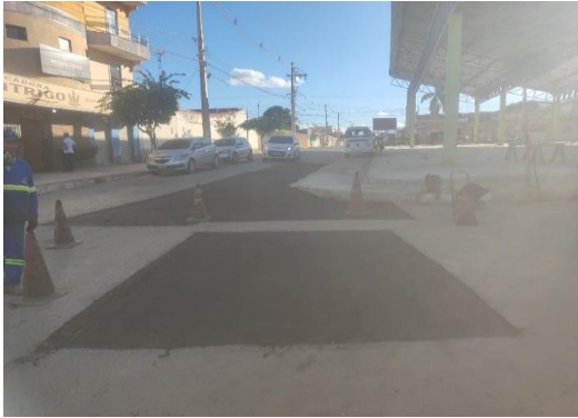
AV MACHADO DE ASSIS - APLICAÇÃO DE CBUQ
