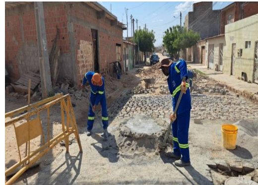
AV VALE DO CANELA - ISOLAMENTO COM TELA
