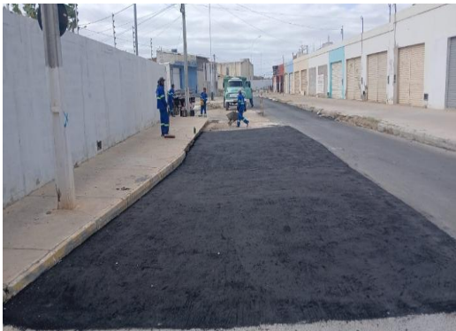
RUA MATATU - TAPA BURACO COM CBUQ
