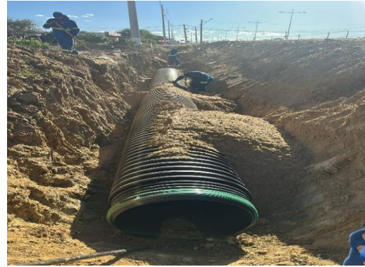
AV BANDEIRA - ASSENTAMENTO TUBOS PEAD 600mm
