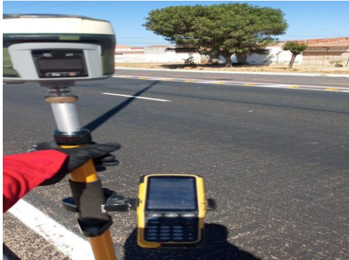
BA210 - EXECUÇÃO DE TOPOGRAFIA
