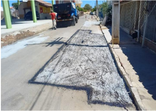
AV MACHADO DE ASSIS - APLICAÇÃO DE EMULSÃO
