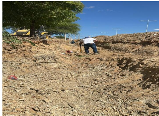
AV BANDEIRA - MARCAÇÃO DE COTAS DE NÍVEL
