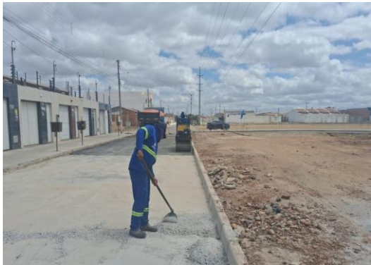
AV CRISTALINA - APLICAÇÃO DE BGS
