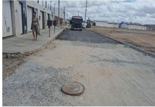
AV CRISTALINA - APLICAÇÃO DE BGS
