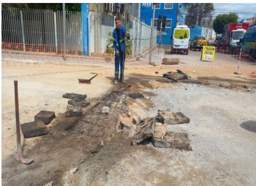
AV ADOLFO VIANA - DEMOLIÇÃO ASFÁLTICA
