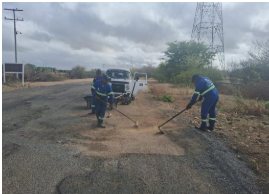
JUNCO - PREPARAÇÃO DE TRECHO
