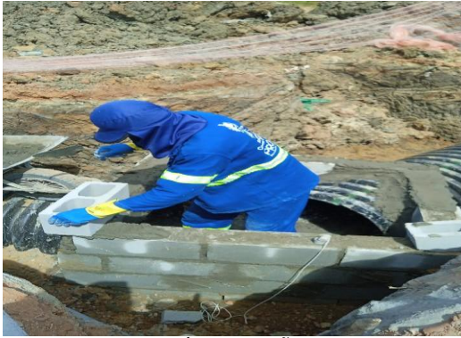
AV PROPRIÁ - EXECUÇÃO DE CAIXA
