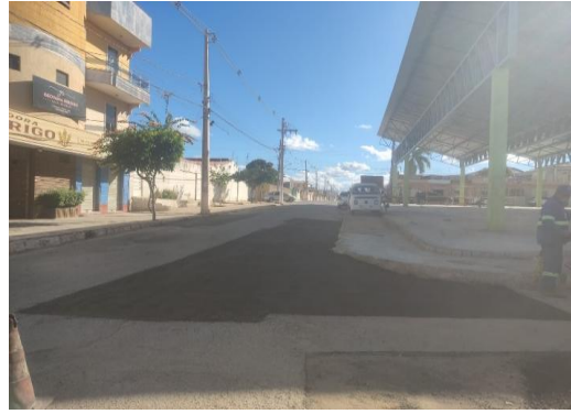
AV MACHADO DE ASSIS - APLICAÇÃO DE CBUQ
