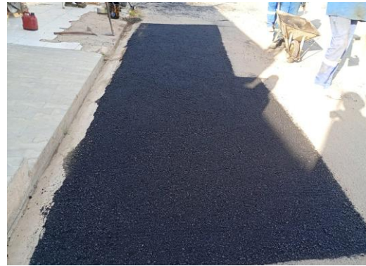
AV PARQUE DA CIDADE - APLICAÇÃO DE CBUQ
