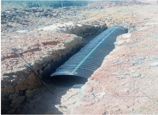
AV PROPRIÁ - ASSENTAMENTO DE TUBO
