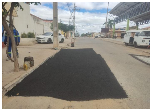
AV MACHADO DE ASSIS - APLICAÇÃO DE CBUQ
