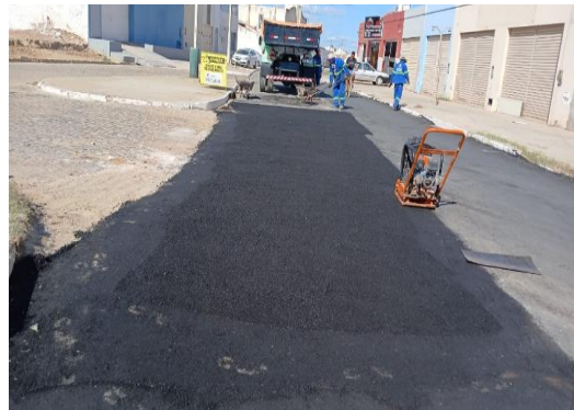
RUA MATATU - TAPA BURACO COM CBUQ
