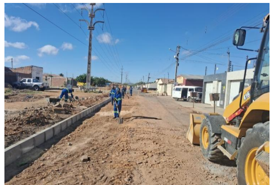
AV CRISTALINA - ESCAVAÇÃO MECANIZADA
