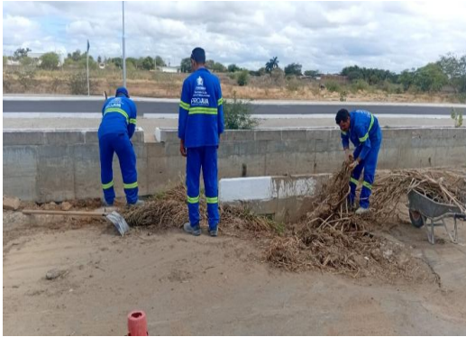
AV PARQUE DA CIDADE - ESCAVAÇÃO MANUAL
