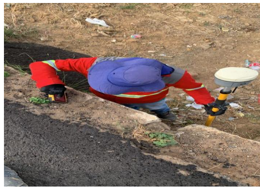
BA210 - EXECUÇÃO DE TOPOGRAFIA
