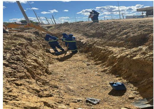
AV BANDEIRA - ESCAVAÇÃO MECANIZADA
