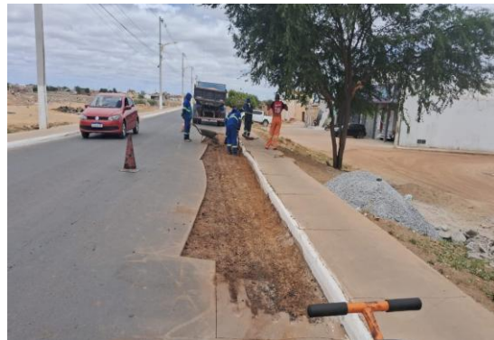
AV GIUSSEP MUCCINI - PREPARAÇÃO DE TRECHO
