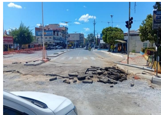
AV ADOLFO VIANA - DEMOLIÇÃO ASFÁLTICA
