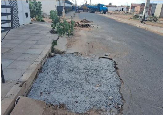
AV CRISTALINA - ESCAVAÇÃO MECANIZADA
