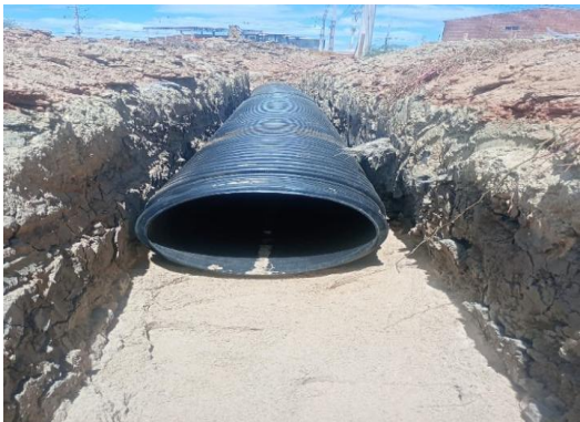
AV PROPRIÁ - ASSENTAMENTO DE TUBO
