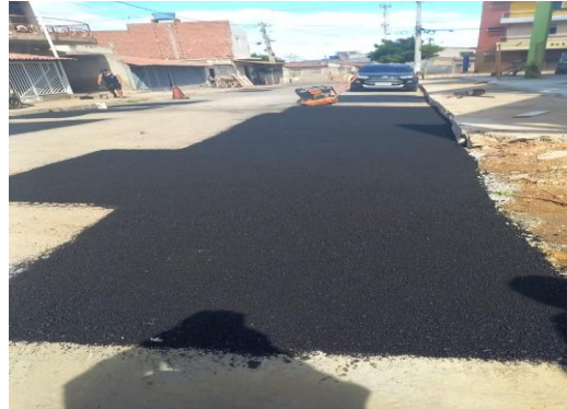
AV MACHADO DE ASSIS - APLICAÇÃO DE CBUQ
