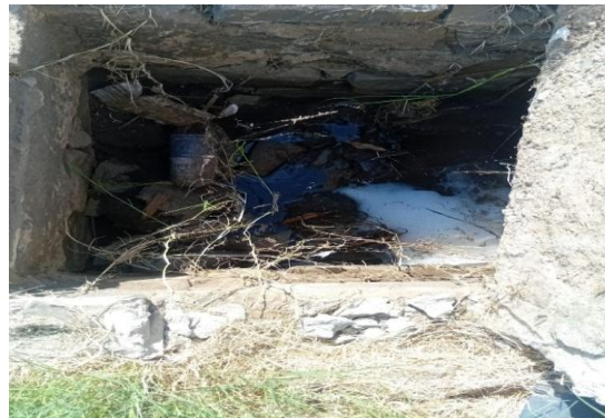
AV RAUL ALVES - LIMPEZA DE CAIXAS
