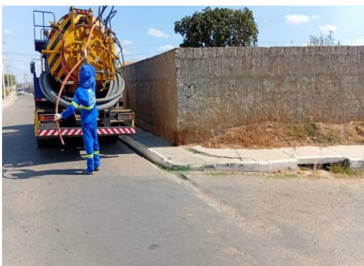
AV LUDGERO ALVES - SERVIÇO DE SEWERJET
