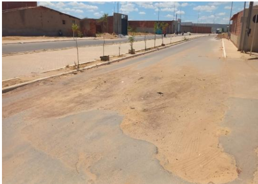
AV PARQUE DA CIDADE - LIMPEZA DE TRECHO
