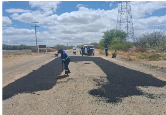
JUNCO - APLICAÇÃO DE CBUQ
