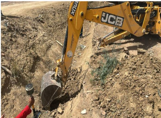
AV BANDEIRA - ESCAVAÇÃO MECANIZADA
