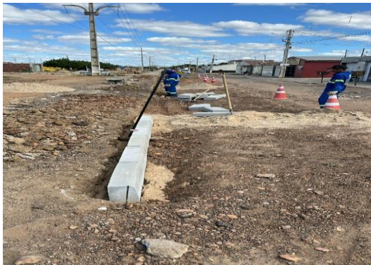
AV CRISTALINA - ASSENTAMENTO DE MEIO FIO
