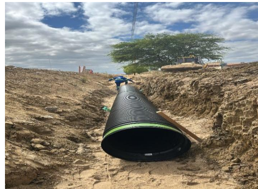
AV BANDEIRA - ASSENTAMENTO TUBOS PEAD 600mm
