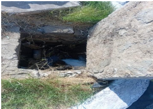
AV RAUL ALVES - LIMPEZA DE CAIXAS
