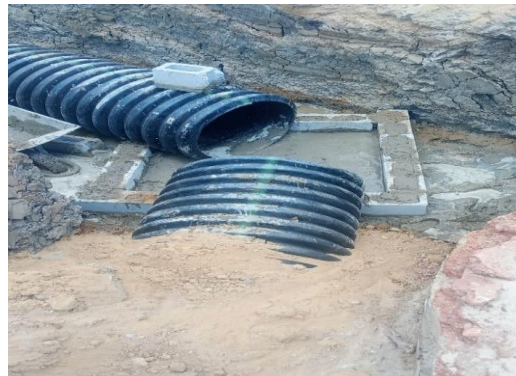
AV PROPRIÁ - EXECUÇÃO DE CAIXA
