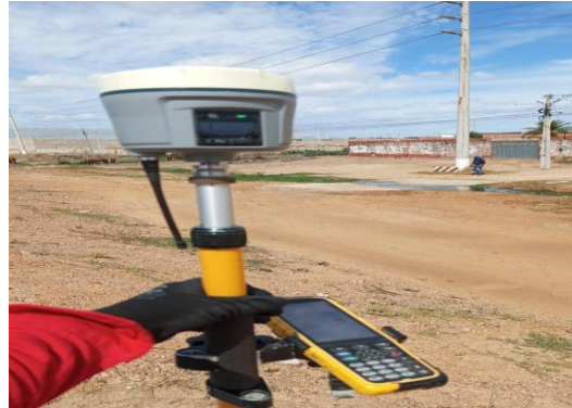
BA210 - EXECUÇÃO DE TOPOGRAFIA
