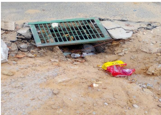
ESTACIONAMENTO - INSTALAÇÃO DE GRELHA
