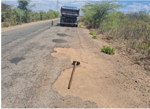
JUNCO - PREPARAÇÃO DE TRECHO
