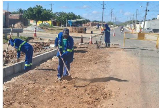
AV CRISTALINA - PREPARAÇÃO DE TRECHO
