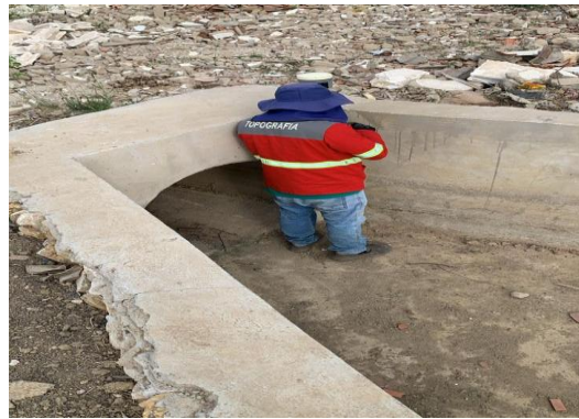
BA210 - EXECUÇÃO DE TOPOGRAFIA
