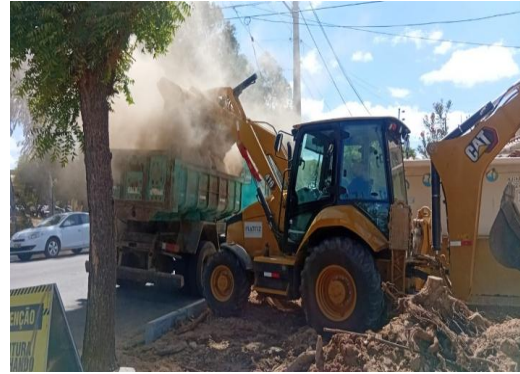
PRAÇA ALFREDO ALVES - LIMPEZA DE ÁREA
