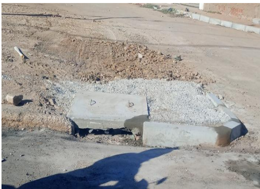
AV PROPRIÁ - ASSENTAMENTO DE MEIO FIO
