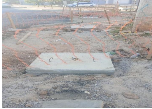
AV PROPRIÁ - APLICAÇÃO DE TAMPA
