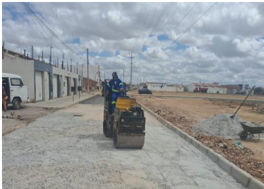
AV CRISTALINA - COMPACTAÇÃO COM ROLO
