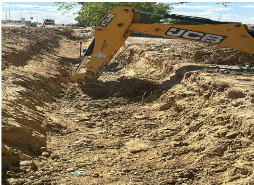
AV BANDEIRA - ESCAVAÇÃO MECANIZADA
