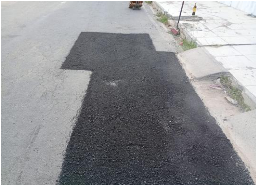
AV PARQUE DA CIDADE - APLICAÇÃO DE CBUQ
