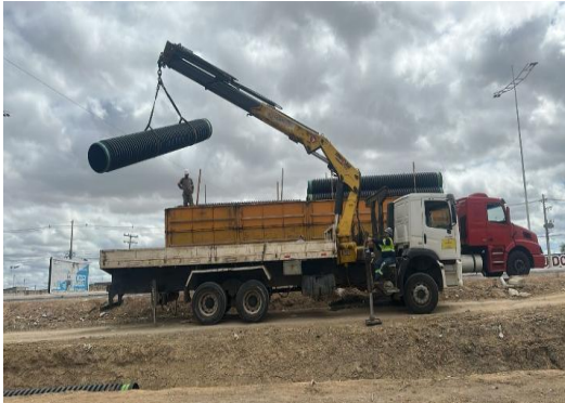
AV BANDEIRA - CHEGADA TUBOS PEAD 600mm
