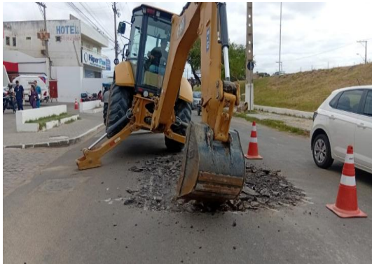
AV RAUL ALVES - LIMPEZA DE CAIXAS
