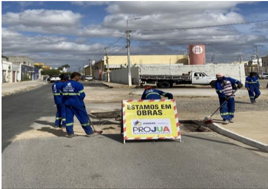
RUA MATATU - TAPA BURACO COM CBUQ
