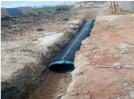
AV PROPRIÁ - ASSENTAMENTO DE TUBO
