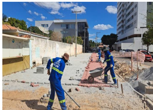
PRAÇA ALFREDO ALVES - PISO INTERTRAVADO
