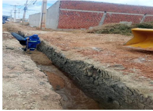
AV PROPRIÁ - ASSENTAMENTO DE TUBO
