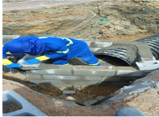
AV PROPRIÁ - EXECUÇÃO DE CAIXA
