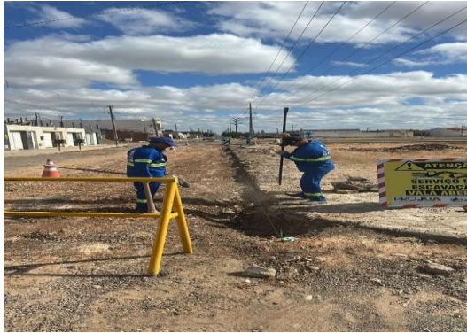
AV CRISTALINA - ESCAVAÇÃO DE VALA
