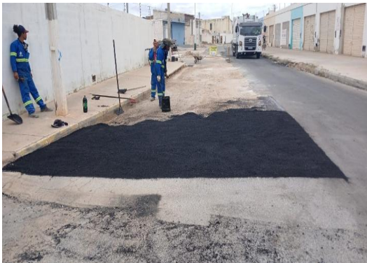
RUA MATATU - TAPA BURACO COM CBUQ
