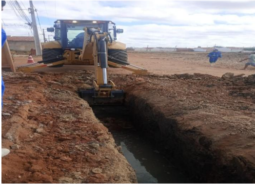
AV PROPRIÁ - ESCAVAÇÃO MECANIZADA
