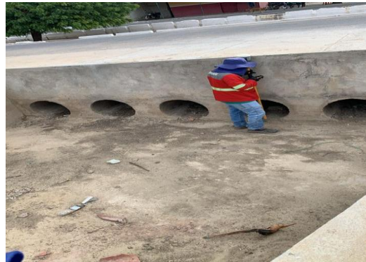
BA210 - EXECUÇÃO DE TOPOGRAFIA
