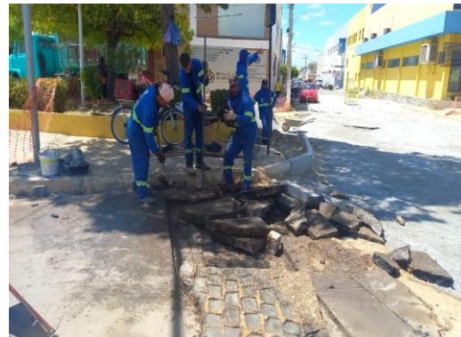
AV ADOLFO VIANA - DEMOLIÇÃO ASFÁLTICA
