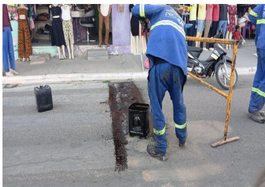
RUA MATATU - APLICAÇÃO DE EMULSÃO
