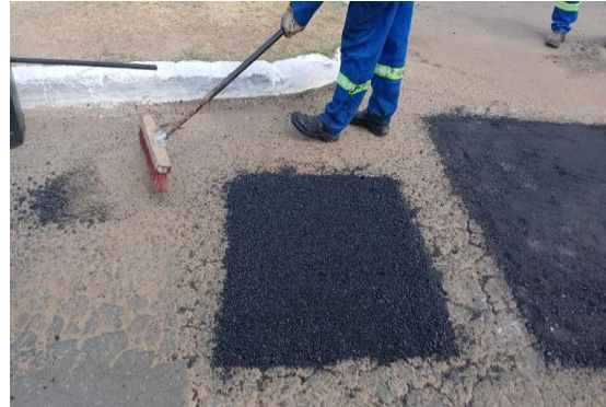
AV RAUL NEVES - PREPARAÇÃO DE CBUQ
