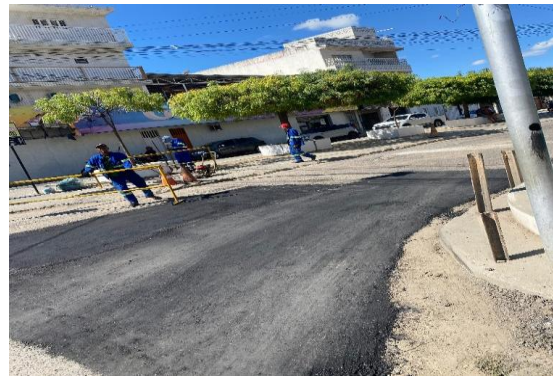
AV PAULO AFONSO - APLICAÇÃO DE CBUQ
