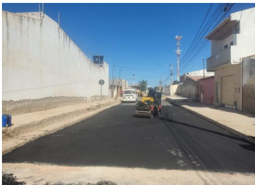
AV PROPRIÁ - APLICAÇÃO DE CBUQ
