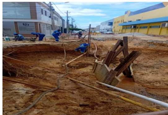
AV ADOLFO VIANA - INSTALAÇÃO DE BOMBAS DE REBAIX
