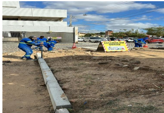
RUA PEDRO BANDURA - APLICAÇÃO DE MEIO FIO
