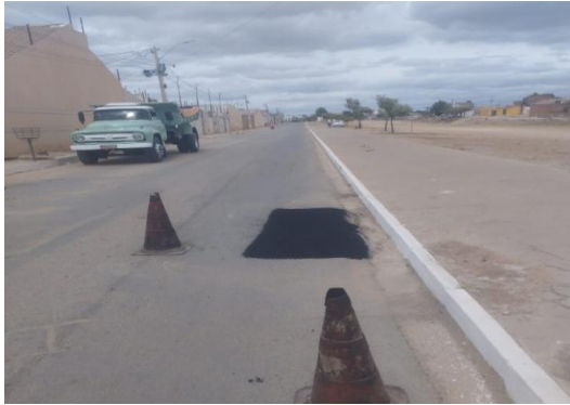
AV PROPRIÁ - APLICAÇÃO DE CBUQ
