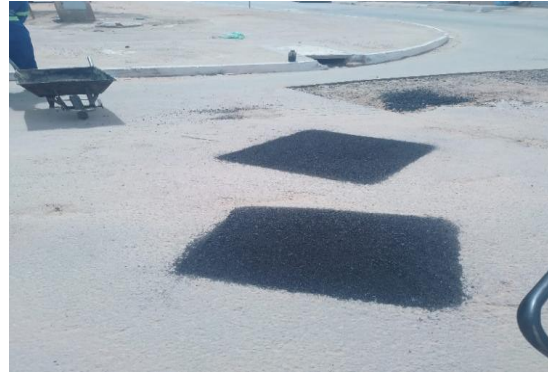
AV PROPRIÁ - APLICAÇÃO DE CBUQ
