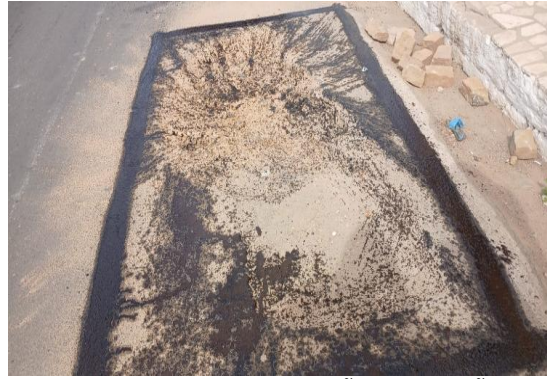
AV PAULO AFONSO - APLICAÇÃO DE EMULSÃO
