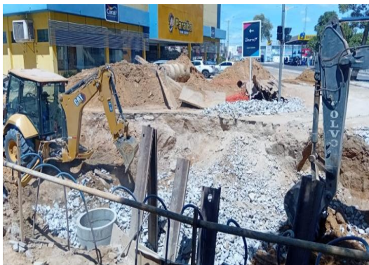
AV ADOLFO VIANA - ESPALHAMENTO PEDRA RACHINHINHA
