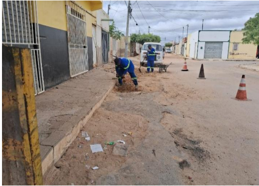
AV ENG MANOEL BORGES - PREPARAÇÃO DE TRECHO
