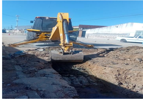
AV PROPRIÁ - ESCAVAÇÃO DE VALA
