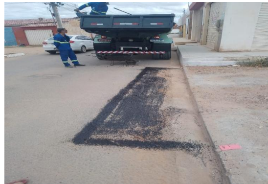
AV PROPRIÁ - APLICAÇÃO DE CBUQ
