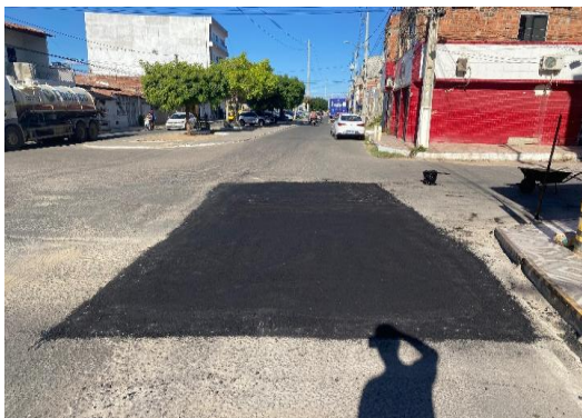
AV PAULO AFONSO - APLICAÇÃO DE CBUQ
