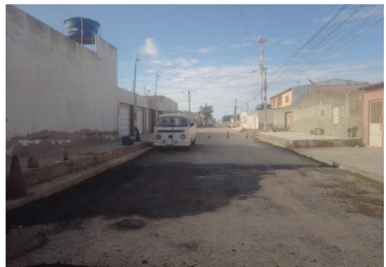
AV PROPRIÁ - APLICAÇÃO DE CBUQ
