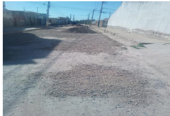
RUA SÃO JOÃO - APLICAÇÃO DE BGS
