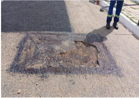
AV RAUL NEVES - PREPARAÇÃO DE TRECHO
