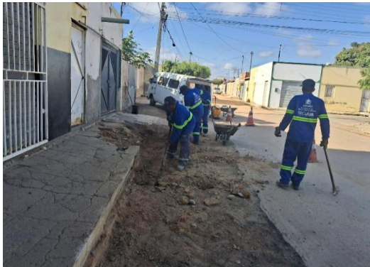
AV ENG MANOEL BORGES - PREPARAÇÃO DE TRECHO
