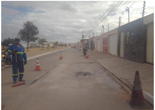
AV PROPRIÁ - APLICAÇÃO DE BGS
