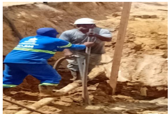
AV ADOLFO VIANA - MICROESTACA DE CONCRETO
