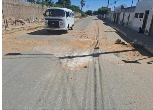
AV JOÃO PAULO II - PREPARAÇÃO DE TRECHO
