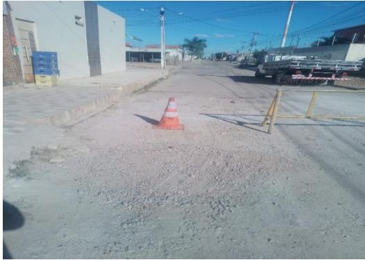
RUA SÃO JOÃO - APLICAÇÃO DE BGS
