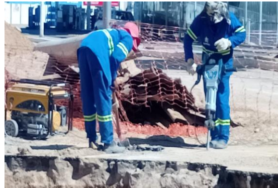
AV ADOLFO VIANA - MICROESTACA DE CONCRETO
