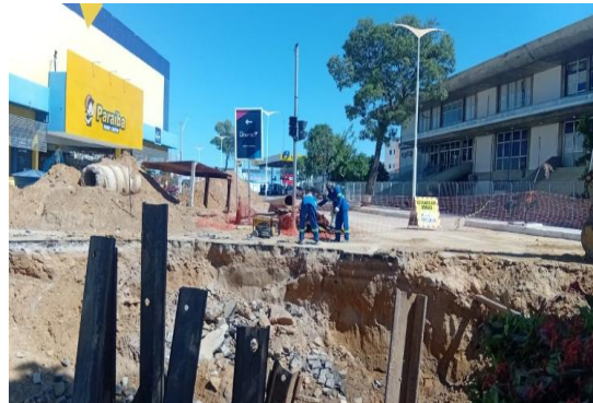
AV ADOLFO VIANA - MANUTENÇÃO DE REDE
