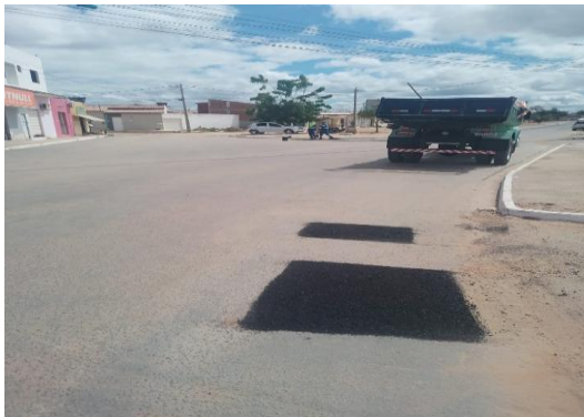
AV PROPRIÁ - APLICAÇÃO DE CBUQ
