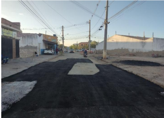
AV PROPRIÁ - APLICAÇÃO DE CBUQ
