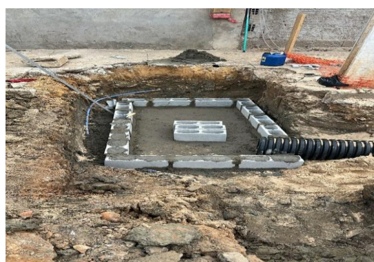
AV PROPRIÁ - EXECUÇÃO DE CAIXA
