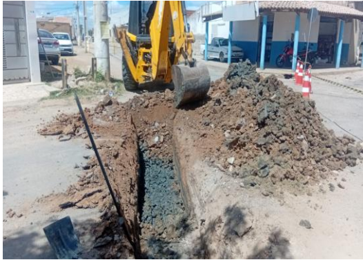
AV PROPRIÁ - ESCAVAÇÃO DE VALA
