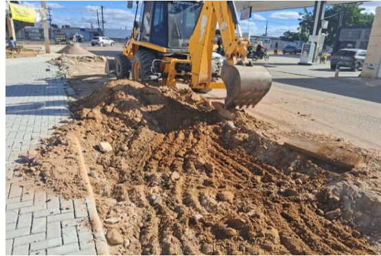
AV CHEFIC KHOURY - ESCAVAÇÃO MECANIZADA
