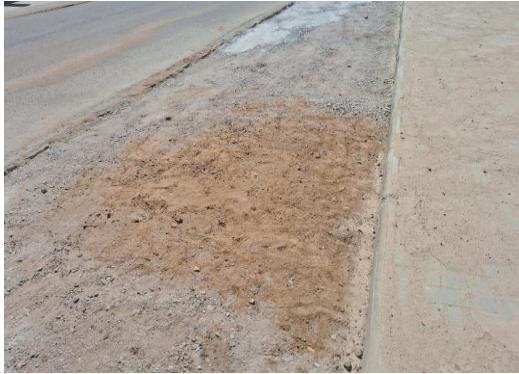
AV JOÃO PAULO II - PREPARAÇÃO DE TRECHO
