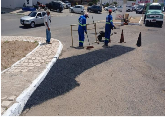
AV RAUL NEVES - APLICAÇÃO DE CBUQ
