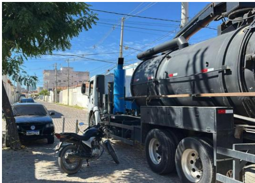
RUA JOALINA - LIMPEZA COM SEWERJET
