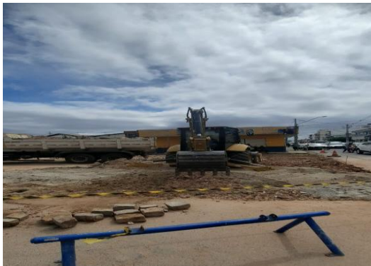
RUA ADOALTO MATOS - APLICAÇÃO DE BGS
