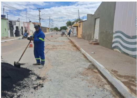
AV ENG MANOEL BORGES - APLICAÇÃO DE BGS
