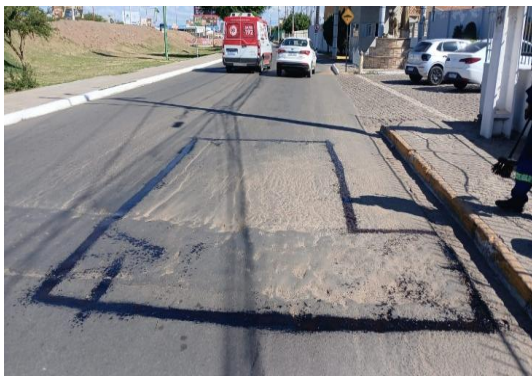
AV RAUL NEVES - APLICAÇÃO DE CBUQ
