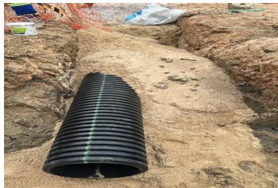
AV PROPRIÁ - ATERRO COM AREIA
