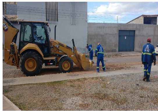
RUA MATATU - LIMPEZA DE ÁREA
