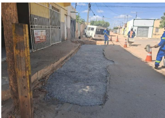
AV ENG MANOEL BORGES - APLICAÇÃO DE BGS
