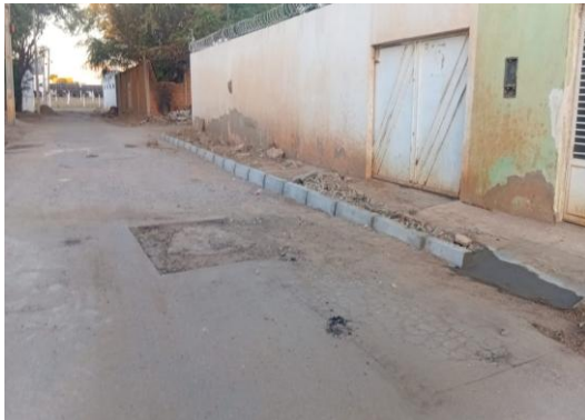
RUA SÃO JOÃO - ASSENTAMENTO DE MEIO FIO
