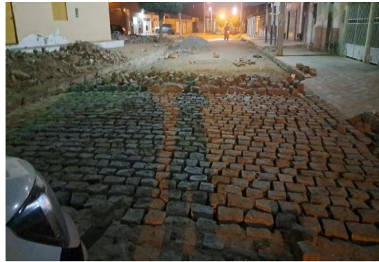
PINHÕES - PAVIMENTAÇÃO DE RUA EM PARALELO
