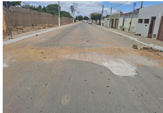
AV ENG MANOEL BORGES - PREPARAÇÃO DE TRECHO
