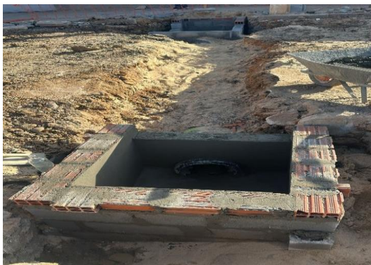
AV PROPRIÁ - EXECUÇÃO DE CAIXA
