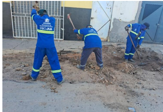
AV ENG MANOEL BORGES - ESCAVAÇÃO MANUAL
