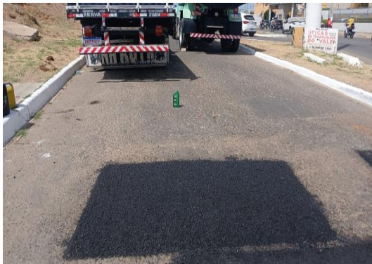
AV RAUL NEVES - APLICAÇÃO DE CBUQ
