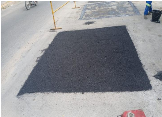
AV PAULO AFONSO - APLICAÇÃO DE CBUQ
