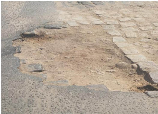
AV SANTOS DUMONT - LIMPEZA DE ÁREA
