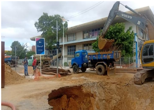
AV ADOLFO VIANA - MANUTENÇÃO DE DRENAGEM
