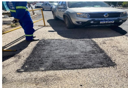
AV PAULO AFONSO - APLICAÇÃO DE CBUQ
