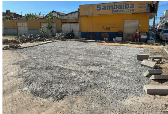
RUA ADOALTO MATOS - APLICAÇÃO DE BGS
