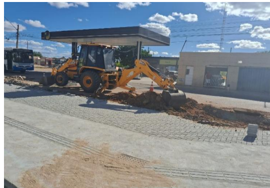
AV CHEFIC KHOURY - ESCAVAÇÃO MECANIZADA
