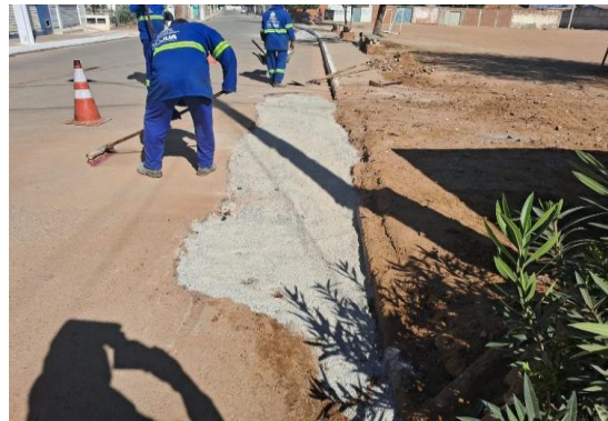
AV ENG MANOEL BORGES - APLICAÇÃO DE BGS
