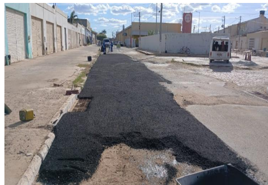
RUA MATATU - APLICAÇÃO DE CBUQ
