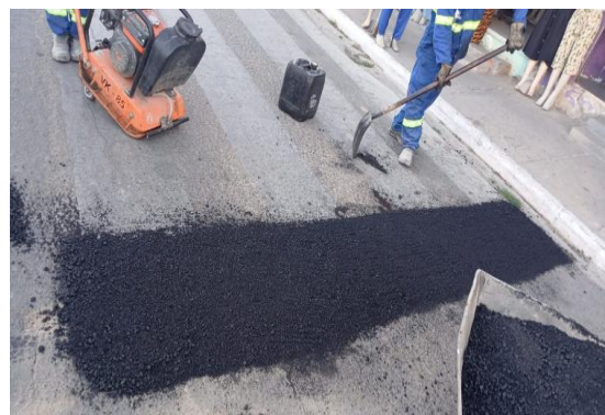
RUA MATATU - APLICAÇÃO DE CBUQ
