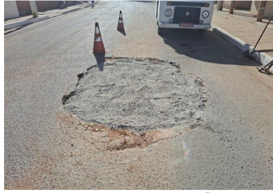
AV ENG MANOEL BORGES - APLICAÇÃO DE BGS
