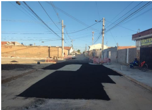
AV PROPRIÁ - APLICAÇÃO DE CBUQ
