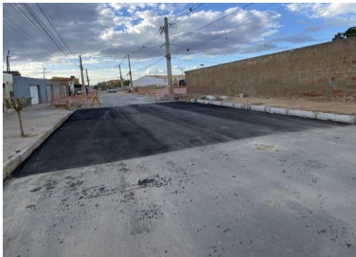
AV PROPRIÁ - APLICAÇÃO DE CBUQ
