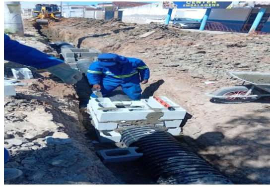
AV PROPRIÁ - EXECUÇÃO DE CAIXA
