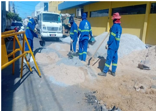
AV ADOLFO VIANA - FABRICAÇÃO DE CONCRETO
