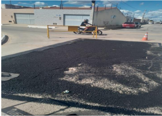
AV PROPRIÁ - APLICAÇÃO DE CBUQ
