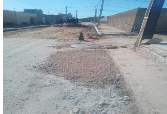
RUA SÃO JOÃO - APLICAÇÃO DE BGS
