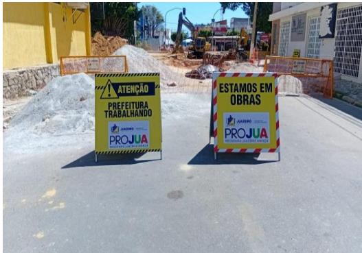
AV ADOLFO VIANA - SINALIZAÇÃO COM PLACAS
