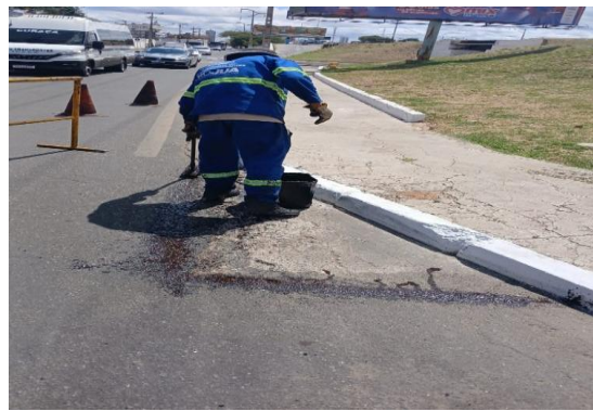
AV RAUL NEVES - APLICAÇÃO DE CBUQ
