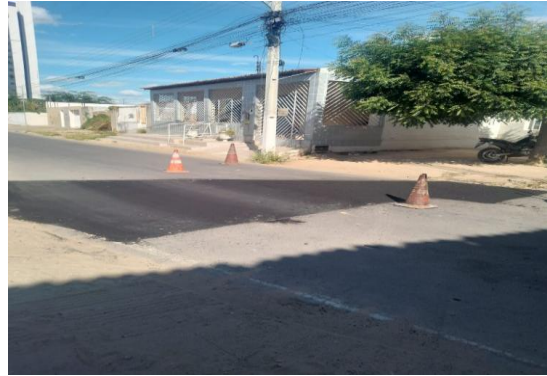
RUA SÃO JOÃO - TAPA BURACO CBUQ
