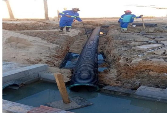
AV PROPRIÁ - EXECUÇÃO DE REDE
