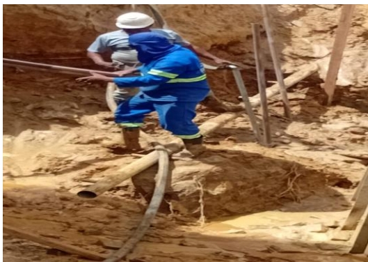
AV ADOLFO VIANA - MICROESTACA DE CONCRETO
