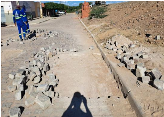
PINHÕES - PAVIMENTAÇÃO DE RUA EM PARALELO
