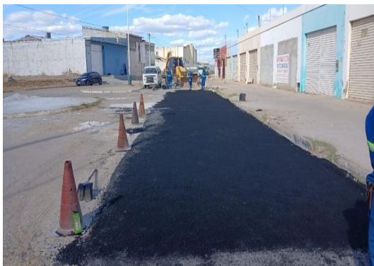
RUA MATATU - APLICAÇÃO DE CBUQ
