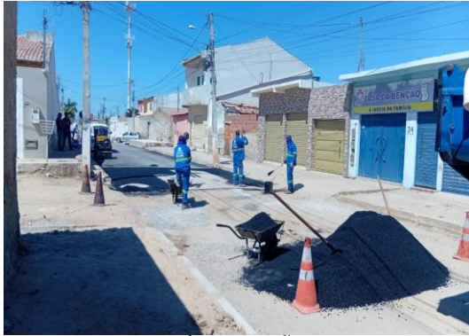
AV PROPRIÁ - APLICAÇÃO DE CBUQ
