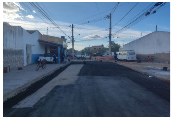
AV PROPRIÁ - APLICAÇÃO DE CBUQ
