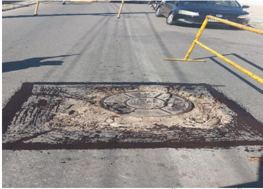
AV SANTOS DUMONT - APLICAÇÃO DE EMULSÃO
