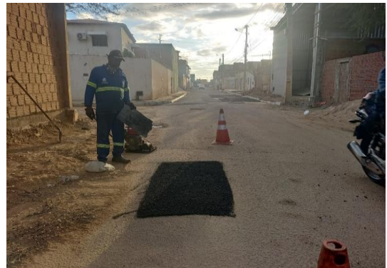
RUA SÃO JOÃO - TAPA BURACO CBUQ
