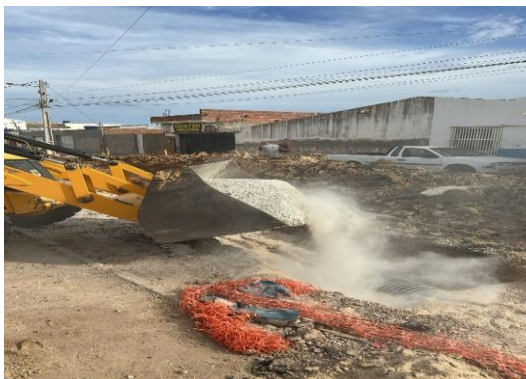
AV PROPRIÁ - APLICAÇÃO DE BGS
