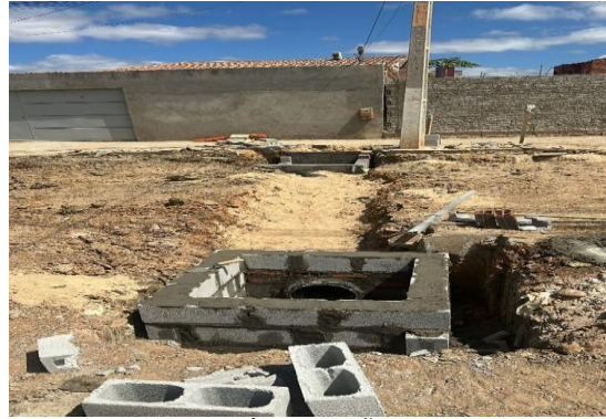
AV PROPRIÁ - EXECUÇÃO DE CAIXA
