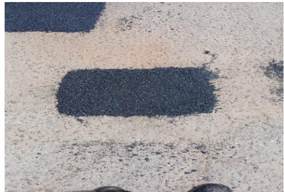
AV RAUL NEVES - APLICAÇÃO DE CBUQ
