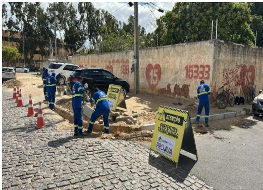
RUA PEDRO BANDURA - APLICAÇÃO DE MEIO FIO
