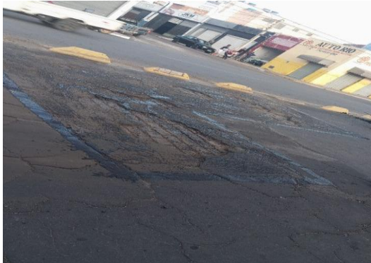
AV SANTOS DUMONT - APLICAÇÃO DE EMULSÃO
