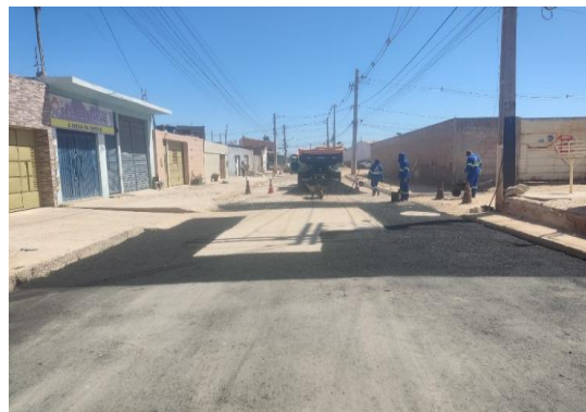
AV PROPRIÁ - APLICAÇÃO DE CBUQ
