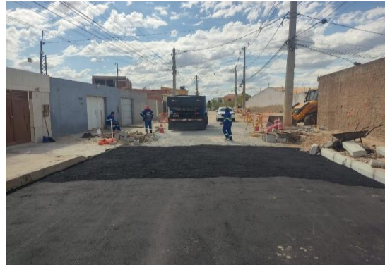
AV PROPRIÁ - APLICAÇÃO DE CBUQ
