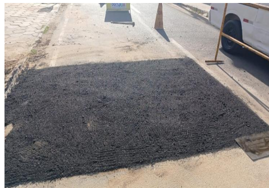
RUA MATATU - APLICAÇÃO DE CBUQ
