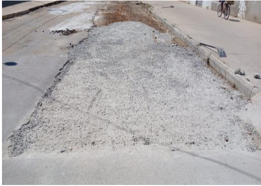
RUA MATATU - APLICAÇÃO DE BGS
