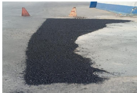
AV RAUL NEVES - APLICAÇÃO DE CBUQ
