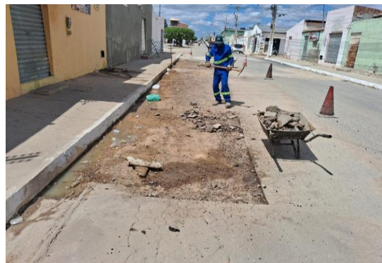
AV ENG MANOEL BORGES - PREPARAÇÃO DE TRECHO
