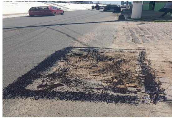
AV SANTOS DUMONT - APLICAÇÃO DE EMULSÃO
