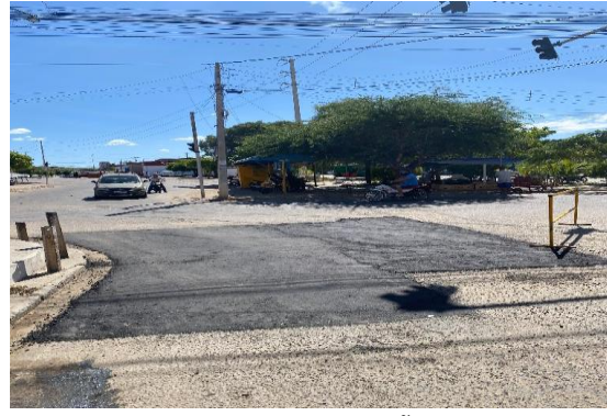
AV PAULO AFONSO - APLICAÇÃO DE CBUQ
