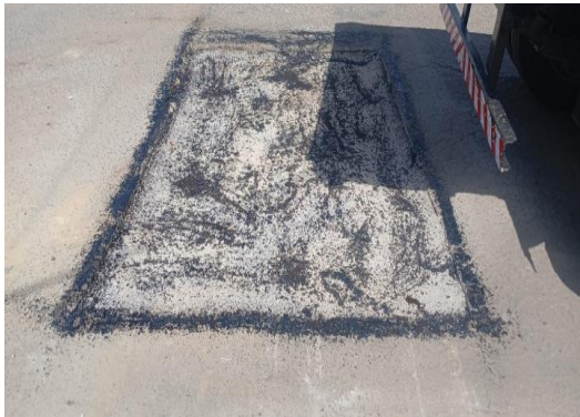
RUA MATATU - APLICAÇÃO DE EMULSÃO
