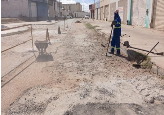
RUA MATATU - LIMPEZA DE ÁREA
