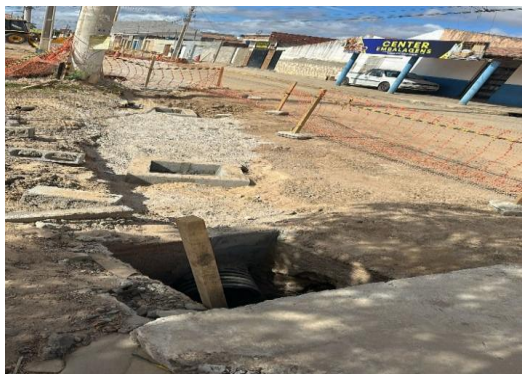
AV PROPRIÁ - ISOLAMENTO COM TELA
