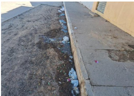
AV ENG MANOEL BORGES - LIMPEZA DE TRECHO
