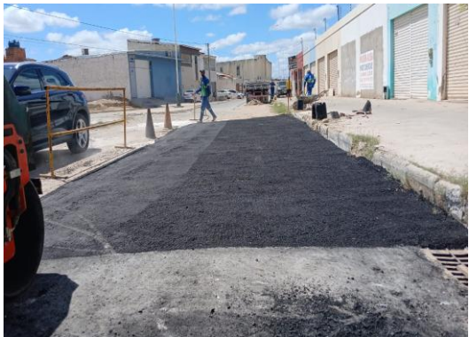
RUA MATATU - APLICAÇÃO DE CBUQ
