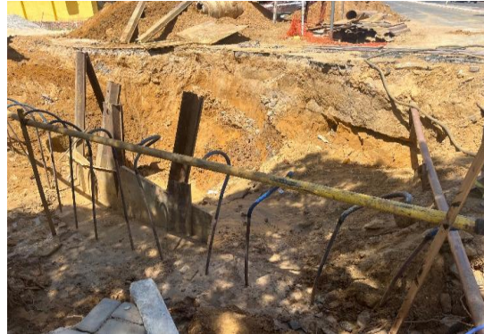
AV ADOLFO VIANA - MANUTENÇÃO DE REDE
