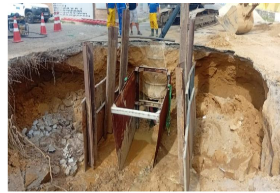
AV ADOLFO VIANA - MANUTENÇÃO DE DRENAGEM
