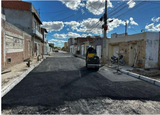
RUA SÃO JOÃO - TAPA BURACO CBUQ
