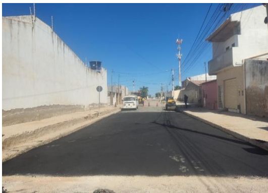
AV PROPRIÁ - APLICAÇÃO DE CBUQ
