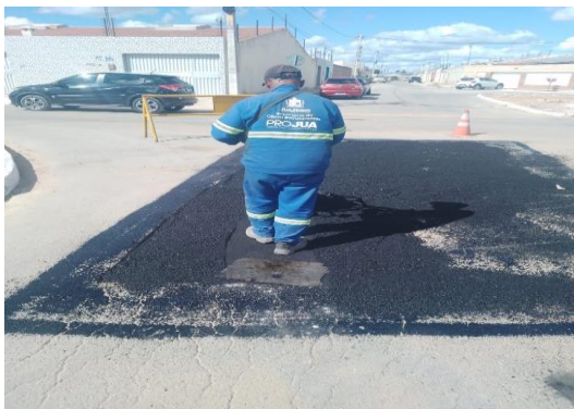
AV PROPRIÁ - APLICAÇÃO DE CBUQ
