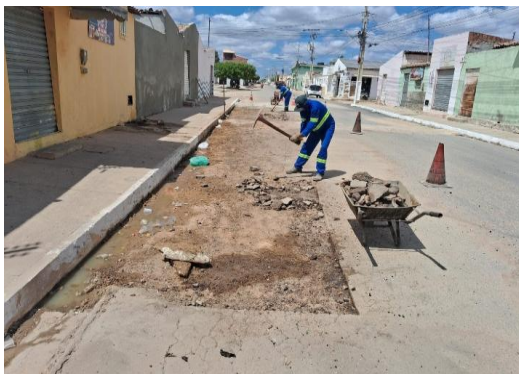
AV ENG MANOEL BORGES - PREPARAÇÃO DE TRECHO
