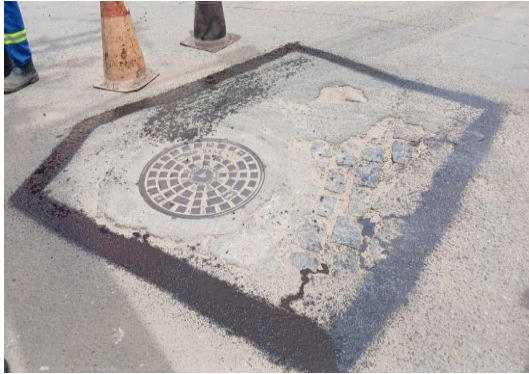
RUA MATATU - APLICAÇÃO DE EMULSÃO
