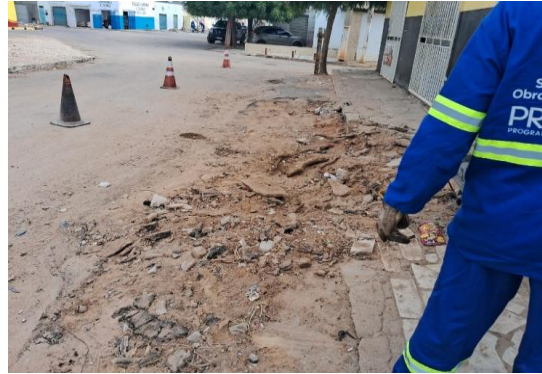
AV ENG MANOEL BORGES - PREPARAÇÃO DE TRECHO
