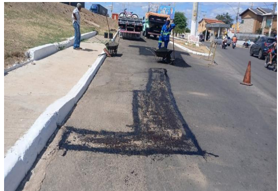
AV RAUL NEVES - APLICAÇÃO DE EMULSÃO
