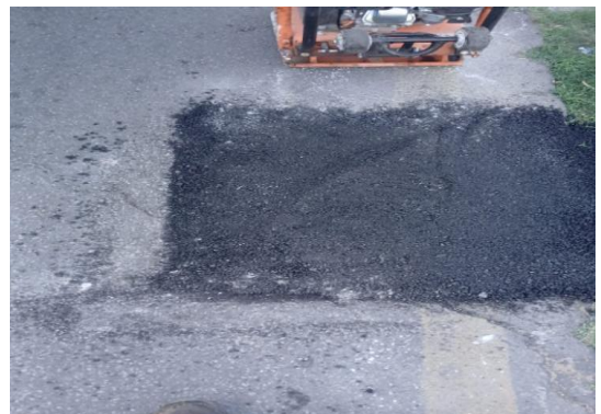
AV RAUL NEVES - APLICAÇÃO DE CBUQ
