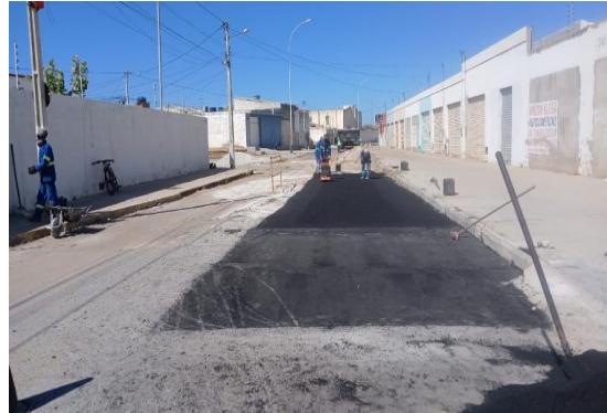
RUA MATATU - APLICAÇÃO DE CBUQ
