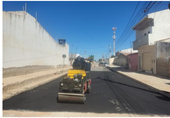
AV PROPRIÁ - ROLO COMPACTADOR
