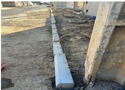
RUA SÃO JOÃO - ASSENTAMENTO DE MEIO FIO
