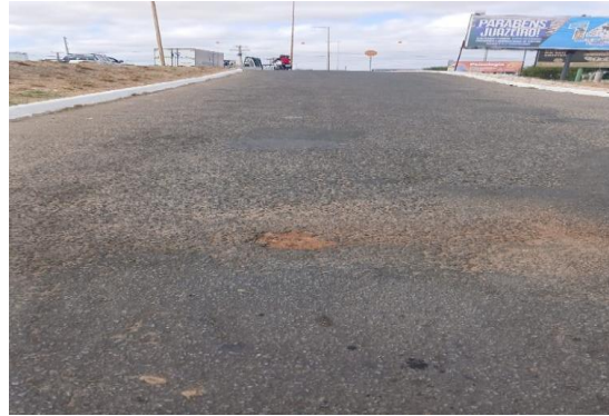
AV RAUL NEVES - PREPARAÇÃO DE TRECHO
