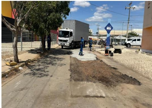
RUA MATATU - CORTE E PREPARAÇÃO DE TRECHO
