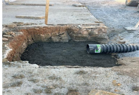
AV PROPRIÁ - EXECUÇÃO DE REDE
