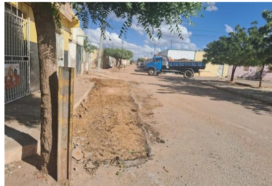
AV ENG MANOEL BORGES - LIMPEZA DE TRECHO
