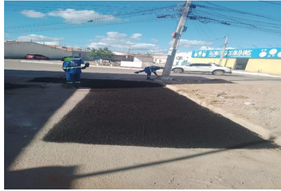
AV PROPRIÁ - APLICAÇÃO DE CBUQ
