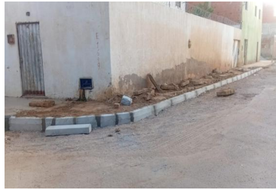
RUA SÃO JOÃO - ASSENTAMENTO DE MEIO FIO
