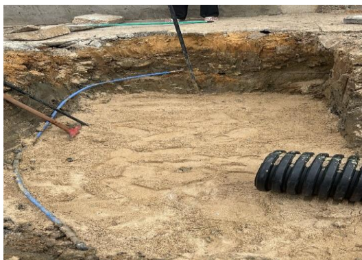
AV PROPRIÁ - REGULARIZAÇÃO DE VALA
