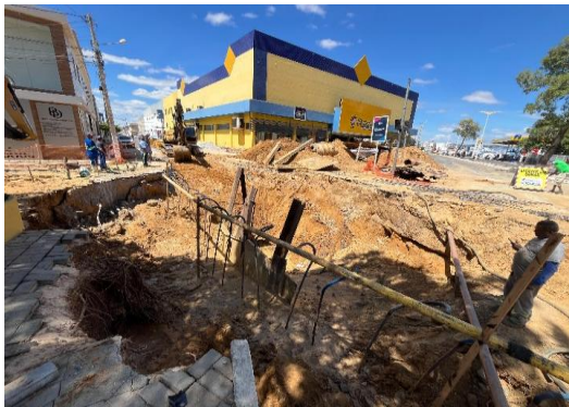
V ADOLFO VIANA - INSTALAÇÃO DE BOMBAS DE REBAIX
