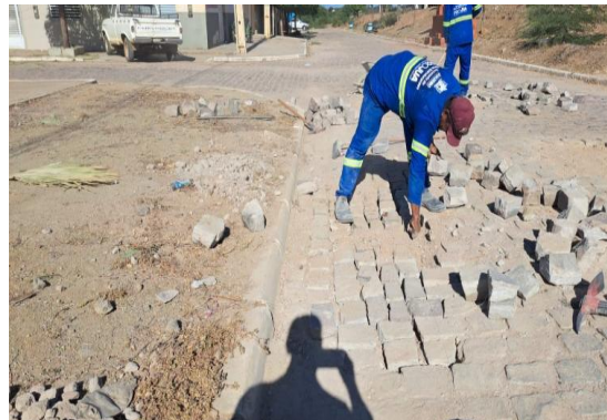
PINHÕES - PAVIMENTAÇÃO DE RUA EM PARALELO
