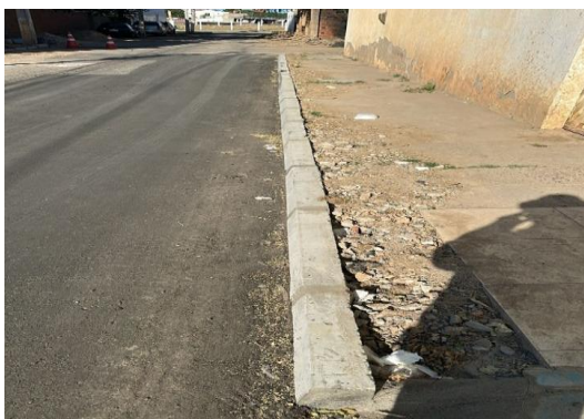
RUA SÃO JOÃO - ASSENTAMENTO DE MEIO FIO
