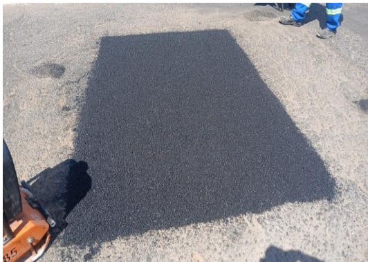
AV RAUL NEVES - APLICAÇÃO DE CBUQ
