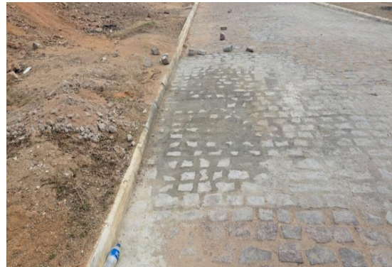
PINHÕES - EXECUÇÃO DE RUA EM PARALELO
