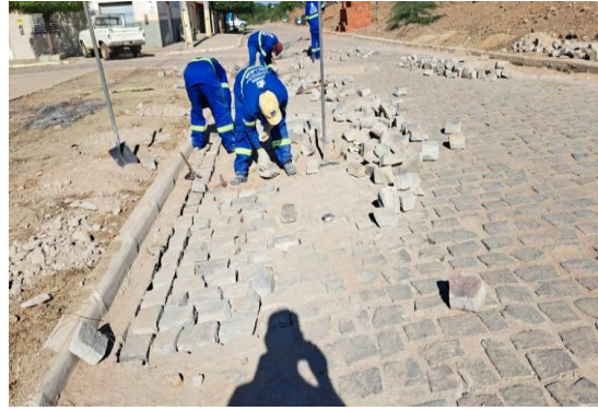
PINHÕES - PAVIMENTAÇÃO DE RUA EM PARALELO
