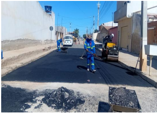
AV PROPRIÁ - ROLO COMPACTADOR
