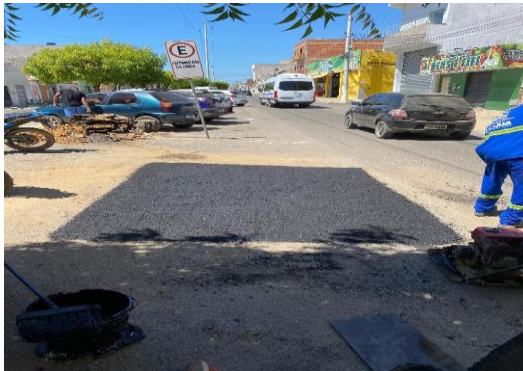
AV PAULO AFONSO - APLICAÇÃO DE CBUQ
