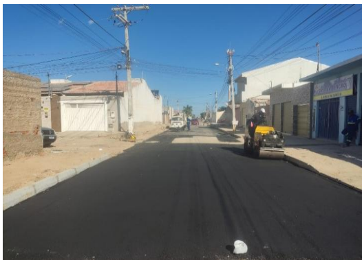
AV PROPRIÁ - ROLO COMPACTADOR
