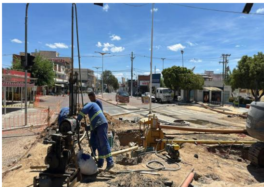
AV ADOLFO VIANA - MICROESTACA DE CONCRETO
