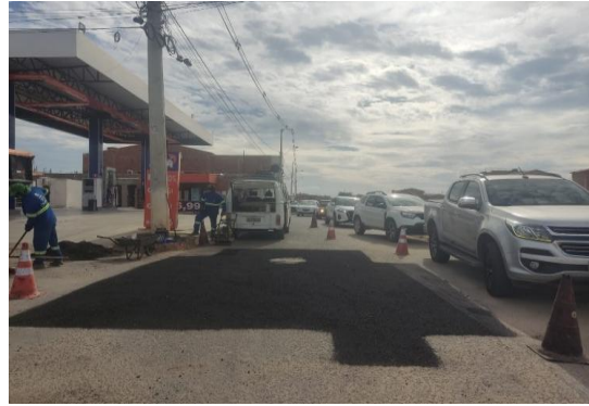
AV PROPRIÁ - APLICAÇÃO DE CBUQ
