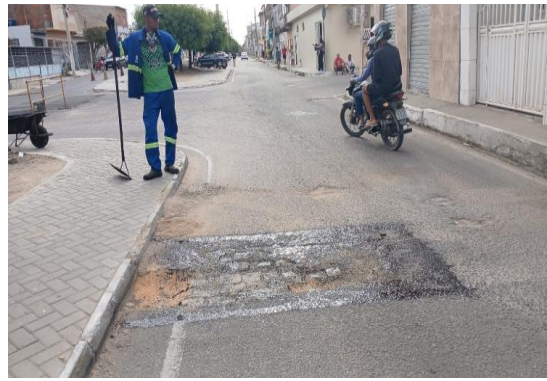
AV PAULO AFONSO - APLICAÇÃO DE EMULSÃO
