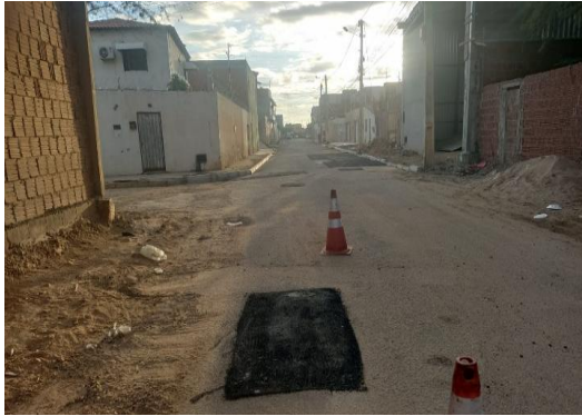
RUA SÃO JOÃO - TAPA BURACO CBUQ
