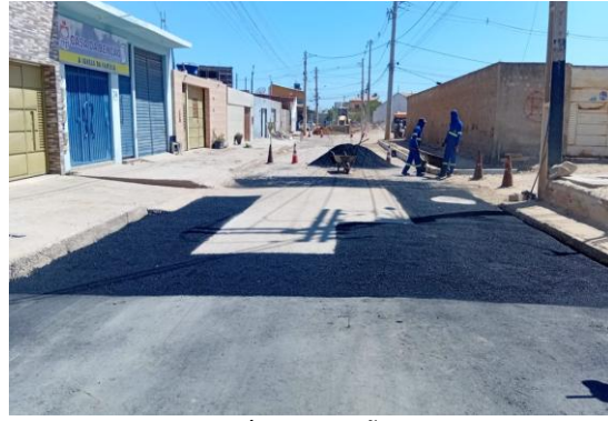
AV PROPRIÁ - APLICAÇÃO DE CBUQ
