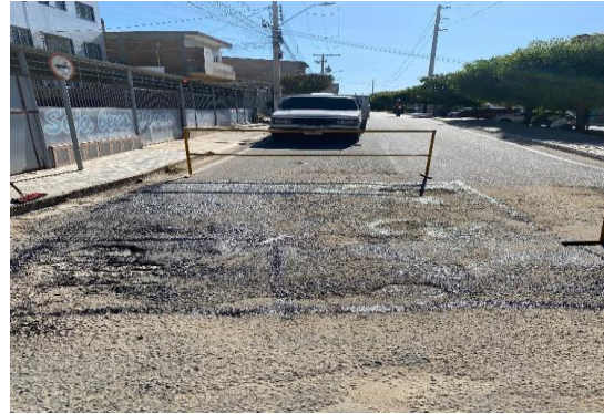
AV PAULO AFONSO - APLICAÇÃO DE EMULSÃO
