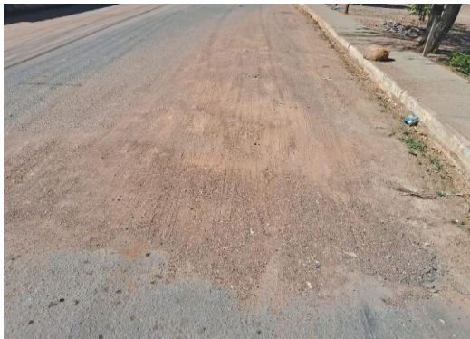
AV JOÃO PAULO II - PREPARAÇÃO DE TRECHO
