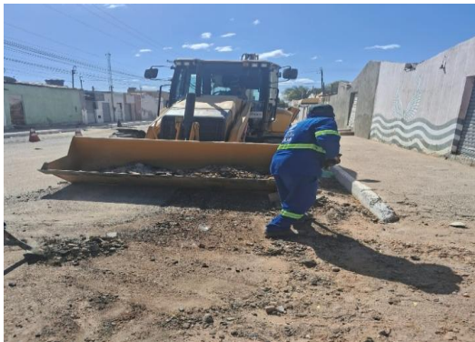
AV ENG MANOEL BORGES - LIMPEZA DE TRECHO
