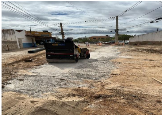
AV PROPRIÁ - COMPACTAÇÃO DE BGS
