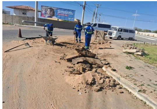
AV JOÃO PAULO II - PREPARAÇÃO DE TRECHO
