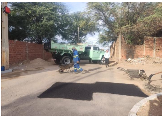
RUA SÃO JOÃO - TAPA BURACO CBUQ
