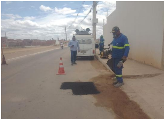
AV PROPRIÁ - APLICAÇÃO DE CBUQ
