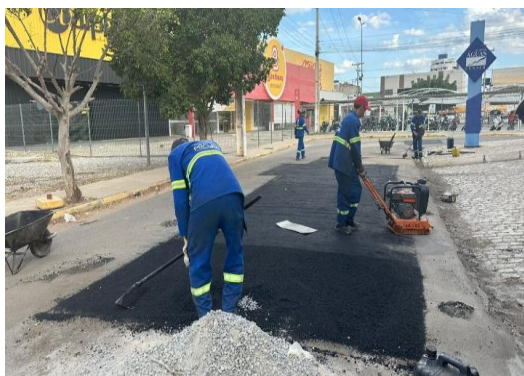
RUA MATATU - APLICAÇÃO DE CBUQ
