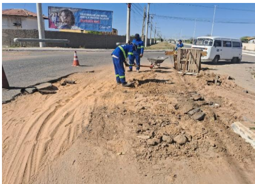
AV JOÃO PAULO II - PREPARAÇÃO DE TRECHO
