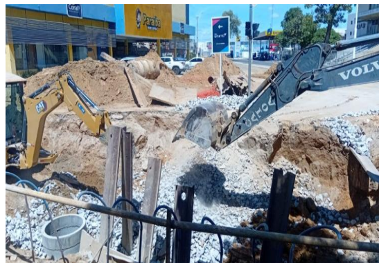
AV ADOLFO VIANA - ESPALHAMENTO PEDRA RACHINHA
