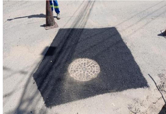
RUA MATATU - APLICAÇÃO DE CBUQ
