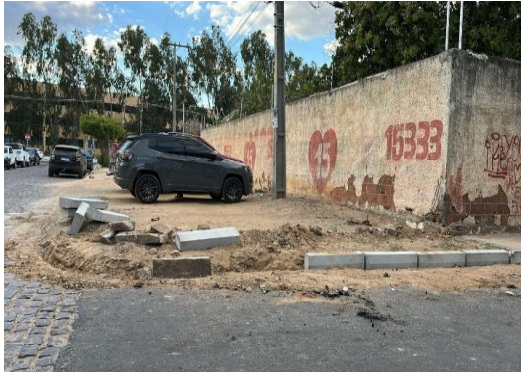
RUA PEDRO BANDURA - APLICAÇÃO DE MEIO FIO
