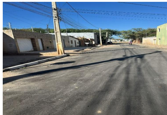
RUA SÃO JOÃO - ASSENTAMENTO DE MEIO FIO
