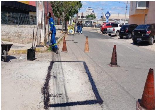
RUA MATATU - APLICAÇÃO DE EMULSÃO
