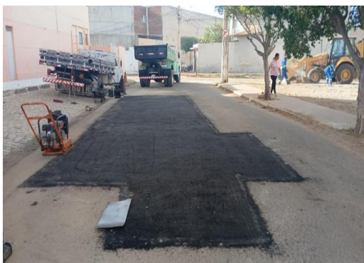
RUA MATATU - APLICAÇÃO DE CBUQ
