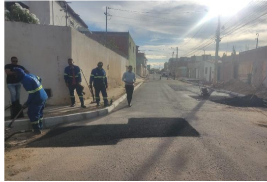
RUA SÃO JOÃO - TAPA BURACO CBUQ
