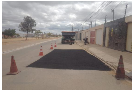
AV PROPRIÁ - APLICAÇÃO DE CBUQ
