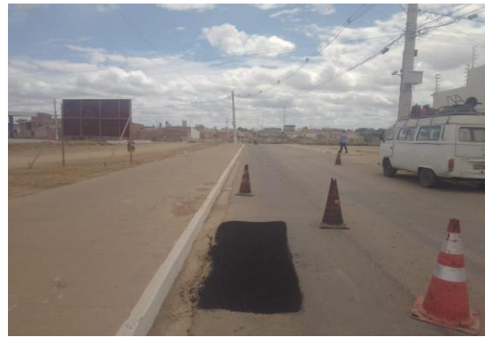
AV PROPRIÁ - APLICAÇÃO DE CBUQ
