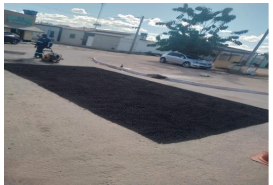
AV PROPRIÁ - APLICAÇÃO DE CBUQ
