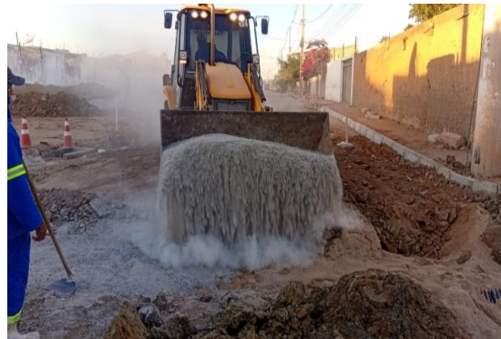
AV PROPRIÁ - APLICAÇÃO DE BGS
