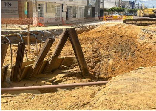
AV ADOLFO VIANA - SINALIZAÇÃO COM PLACAS
