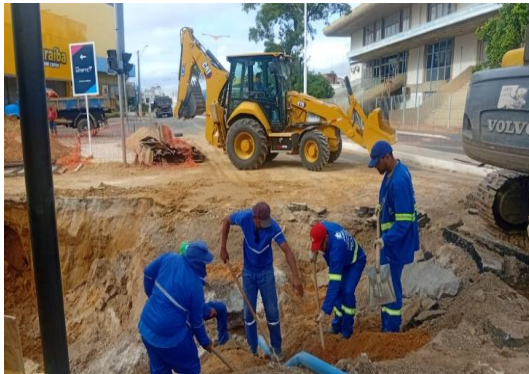
AV ADOLFO VIANA - MICROESTACA DE CONCRETO
