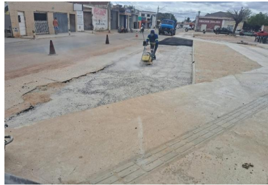
AV CHEFIC KHOURY - COMPACTAÇÃO DE TRECHO
