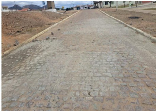
PINHÕES - EXECUÇÃO DE RUA EM PARALELO
