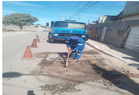
AV PROPRIÁ - PREPARAÇÃO DE TRECHO
