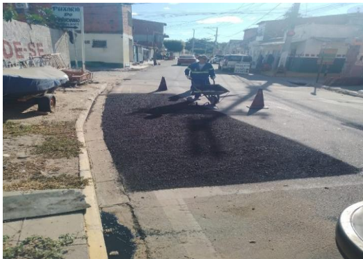
RUA SÃO JOÃO - TAPA BURACO CBUQ
