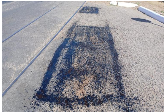
AV RAUL NEVES - APLICAÇÃO DE EMULSÃO
