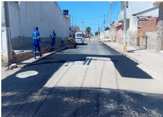
AV PROPRIÁ - APLICAÇÃO DE CBUQ
