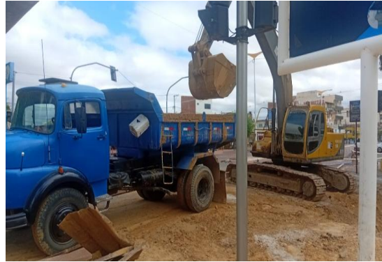
AV ADOLFO VIANA - MANUTENÇÃO DE DRENAGEM
