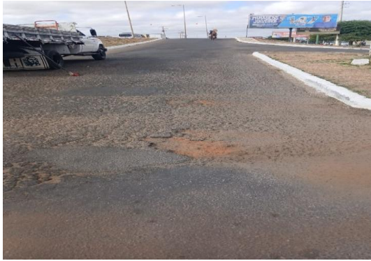
AV RAUL NEVES - PREPARAÇÃO DE TRECHO
