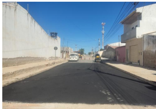
AV PROPRIÁ - APLICAÇÃO DE CBUQ
