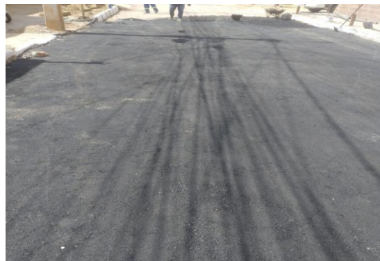
RUA SÃO JOÃO - TAPA BURACO CBUQ
