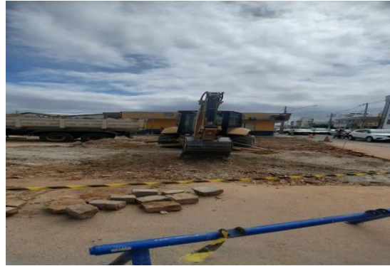
RUA ADOALTO MATOS - ESCAVAÇÃO MECANIZADA
