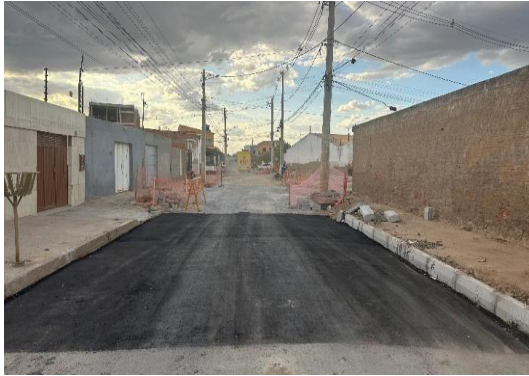
AV PROPRIÁ - APLICAÇÃO DE CBUQ
