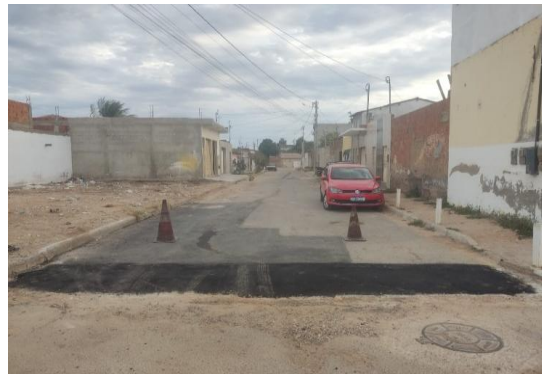
AV PROPRIÁ - APLICAÇÃO DE CBUQ
