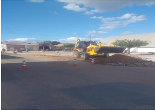
AV CHEFIC KHOURY - ESCAVAÇÃO MECANIZADA
