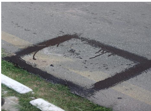
AV RAUL NEVES - APLICAÇÃO DE EMULSÃO
