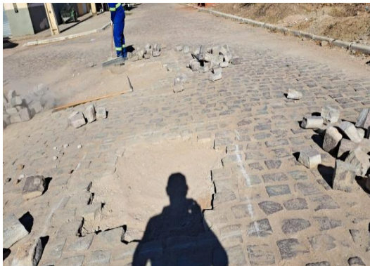
PINHÕES - PAVIMENTAÇÃO DE RUA EM PARALELO
