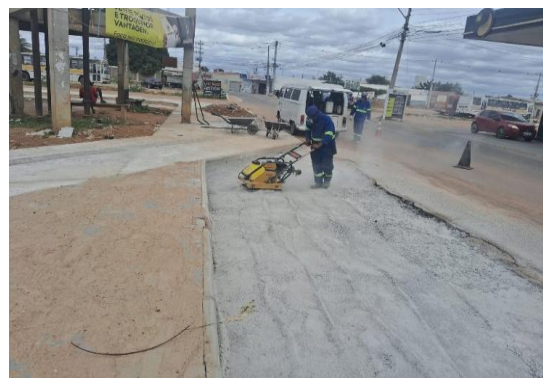
AV CHEFIC KHOURY - COMPACTAÇÃO DE TRECHO
