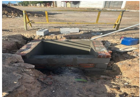
AV PROPRIÁ - EXECUÇÃO DE CAIXA
