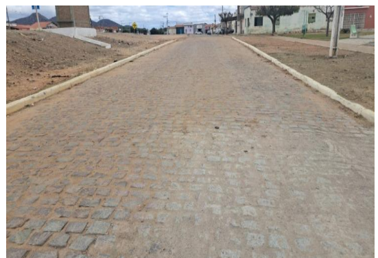
PINHÕES - EXECUÇÃO DE RUA EM PARALELO
