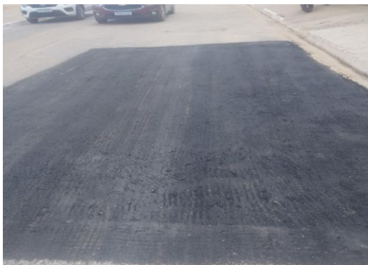
AV PROPRIÁ - APLICAÇÃO DE CBUQ
