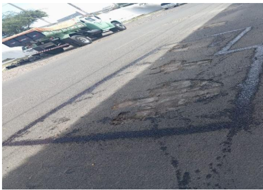
AV SANTOS DUMONT - APLICAÇÃO DE EMULSÃO
