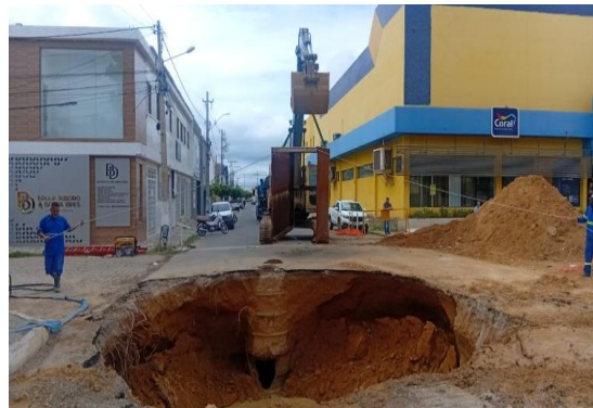
AV ADOLFO VIANA - MANUTENÇÃO DE DRENAGEM
