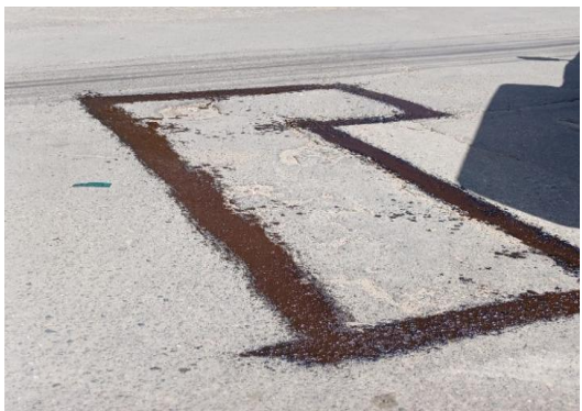
RUA MATATU - APLICAÇÃO DE EMULSÃO
