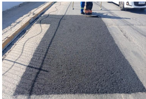
AV RAUL NEVES - APLICAÇÃO DE CBUQ
