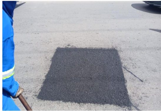
AV RAUL NEVES - APLICAÇÃO DE CBUQ
