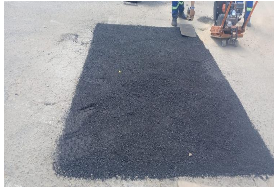
RUA MATATU - APLICAÇÃO DE CBUQ
