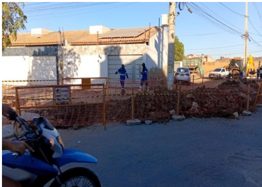
AV PROPRIÁ - ISOLAMENTO COM TELA TAPUME
