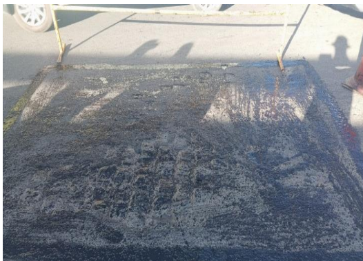
AV SANTOS DUMONT - APLICAÇÃO DE EMULSÃO
