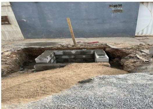
AV PROPRIÁ - EXECUÇÃO DE REDE
