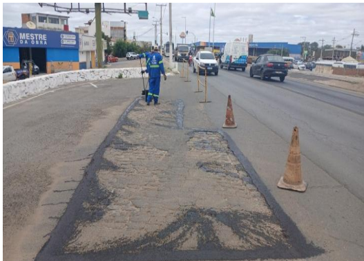
AV SANTOS DUMONT - APLICAÇÃO DE EMULSÃO
