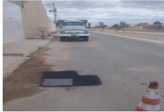
AV PROPRIÁ - APLICAÇÃO DE CBUQ
