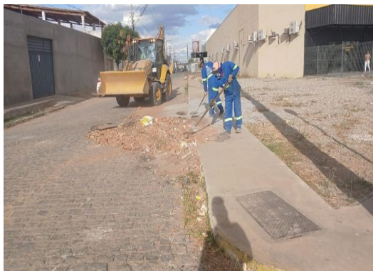
RUA MATATU - LIMPEZA DE ÁREA
