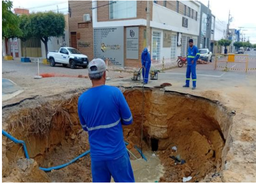
AV ADOLFO VIANA - MANUTENÇÃO DE DRENAGEM
