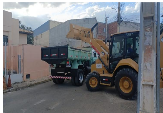
RUA MATATU - LIMPEZA DE ÁREA
