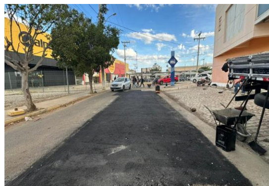
RUA MATATU - APLICAÇÃO DE CBUQ
