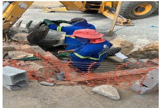
AV PROPRIÁ - APLICAÇÃO DE BGS
