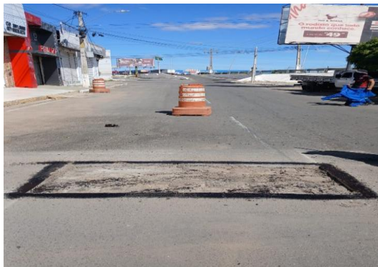
AV SANTOS DUMONT - APLICAÇÃO DE EMULSÃO
