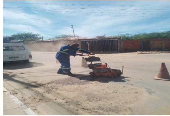
AV PROPRIÁ - CORTE DE TRECHO
