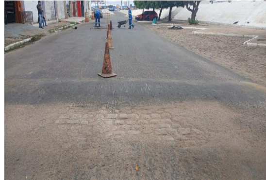
AV SANTOS DUMONT - LIMPEZA DE ÁREA
