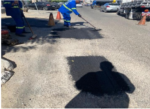
AV PAULO AFONSO - APLICAÇÃO DE CBUQ
