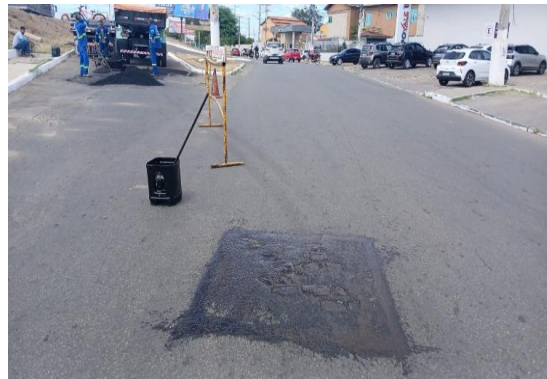
AV RAUL NEVES - APLICAÇÃO DE CBUQ
