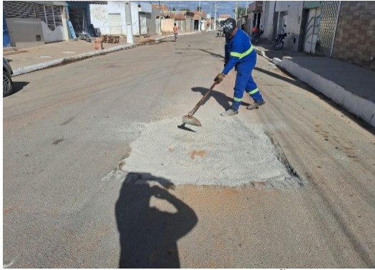
AV ENG MANOEL BORGES - APLICAÇÃO DE BGS
