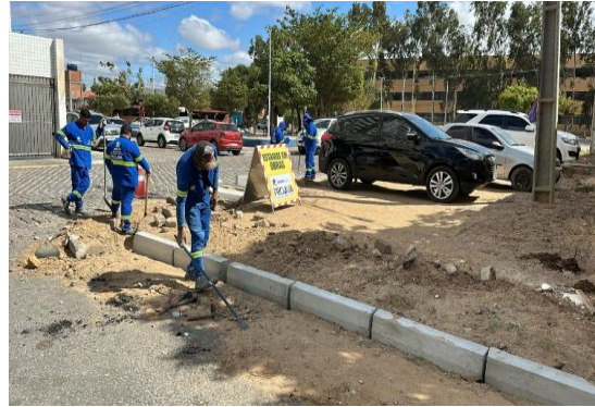
RUA PEDRO BANDURA - APLICAÇÃO DE MEIO FIO
