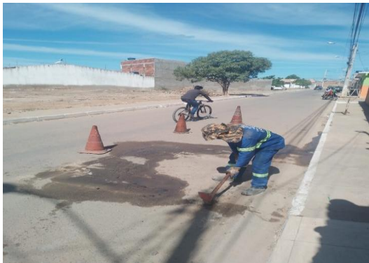
AV PROPRIÁ - PREPARAÇÃO DE TRECHO
