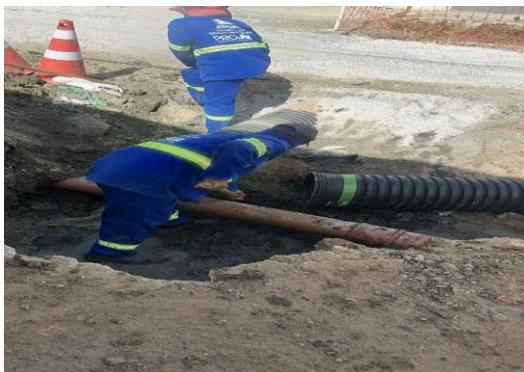
AV PROPRIÁ - EXECUÇÃO DE REDE
