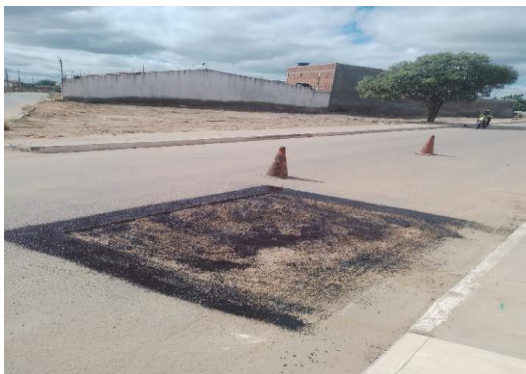
AV PROPRIÁ - APLICAÇÃO DE CBUQ
