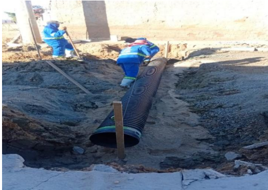
AV PROPRIÁ - EXECUÇÃO DE REDE
