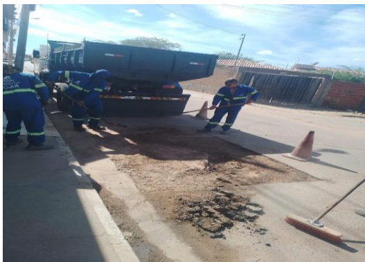
AV PROPRIÁ - APLICAÇÃO DE BGS
