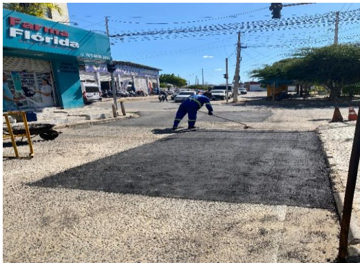
AV PAULO AFONSO - APLICAÇÃO DE CBUQ
