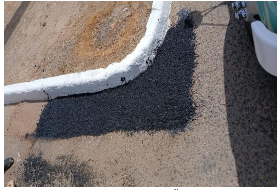
AV RAUL NEVES - APLICAÇÃO DE CBUQ
