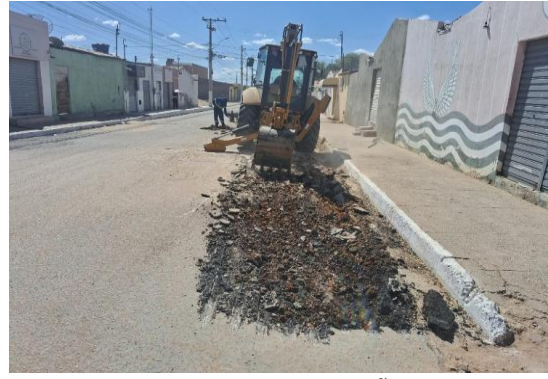
AV ENG MANOEL BORGES - ESCAVAÇÃO MECANIZADA
