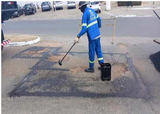
AV RAUL NEVES - APLICAÇÃO DE EMULSÃO
