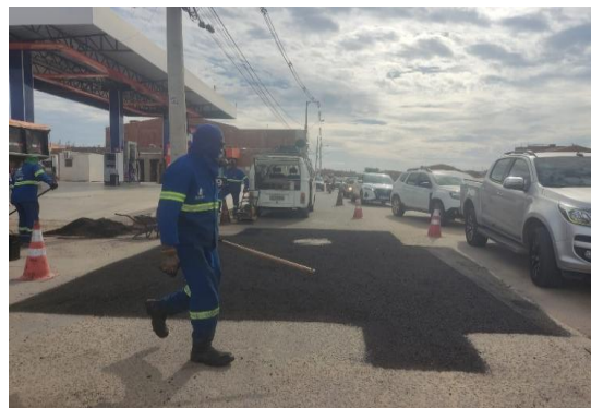
AV PROPRIÁ - APLICAÇÃO DE CBUQ
