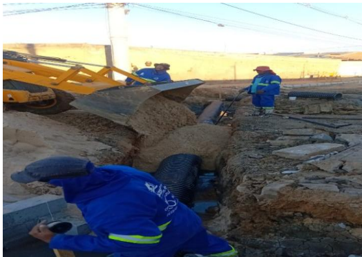
AV PROPRIÁ - ATERRO COM AREIA
