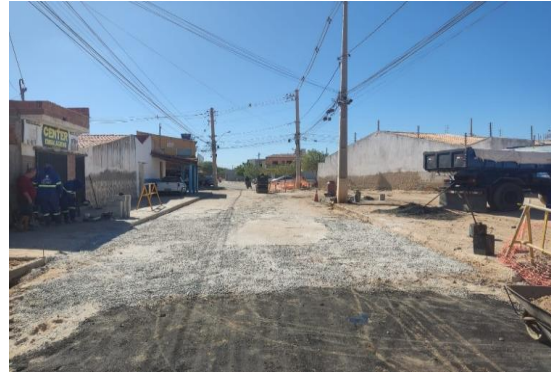
AV PROPRIÁ - APLICAÇÃO DE BGS
