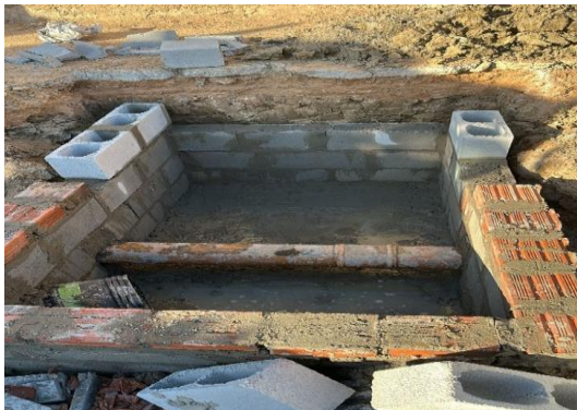
AV PROPRIÁ - EXECUÇÃO DE CAIXA
