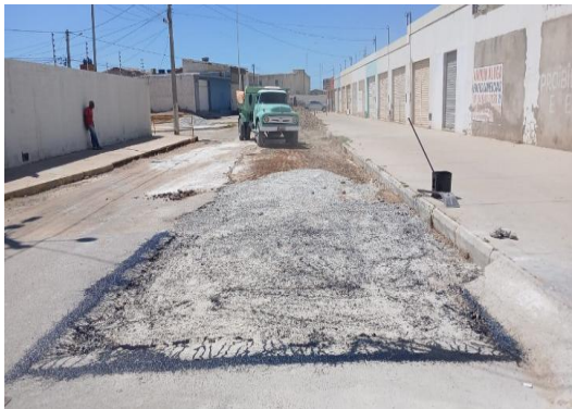
RUA MATATU - APLICAÇÃO DE EMULSÃO
