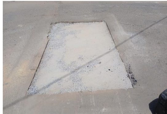
RUA MATATU - APLICAÇÃO DE BGS
