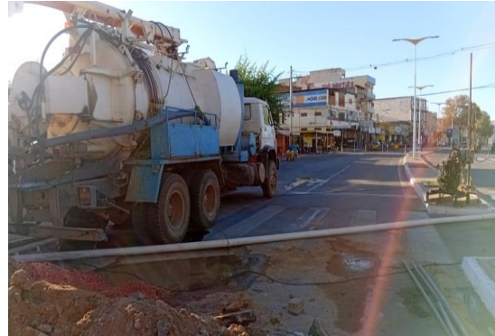
AV ADOLFO VIANA - LIMPEZA COM SEWERJET
