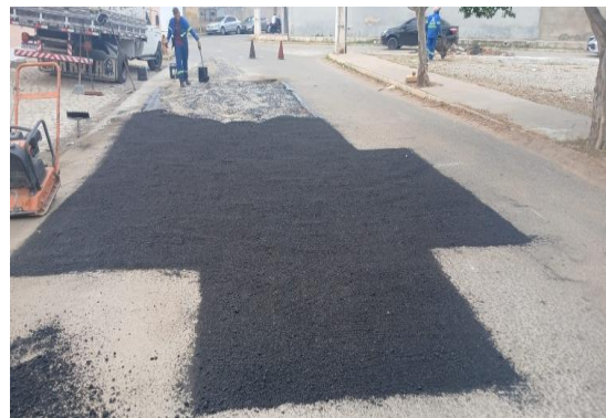
RUA MATATU - APLICAÇÃO DE CBUQ
