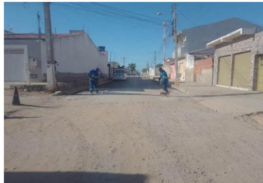
AV PROPRIÁ - APLICAÇÃO DE CBUQ
