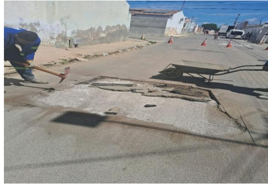
AV JOÃO PAULO II - PREPARAÇÃO DE TRECHO
