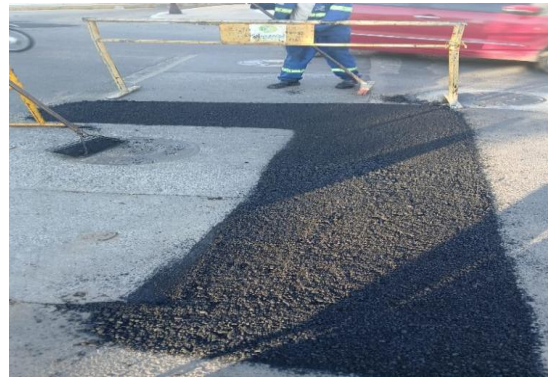
AV RAUL NEVES - APLICAÇÃO COM CBUQ
