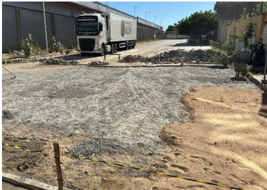
RUA ADOALTO MATOS - APLICAÇÃO DE BGS
