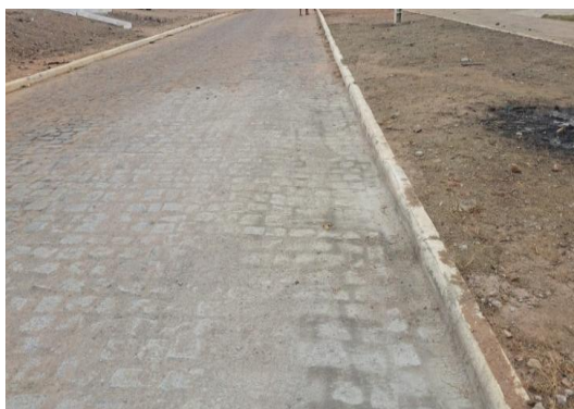
PINHÕES - EXECUÇÃO DE RUA EM PARALELO
