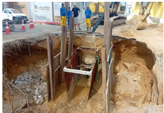
AV ADOLFO VIANA - MANUTENÇÃO DE DRENAGEM
