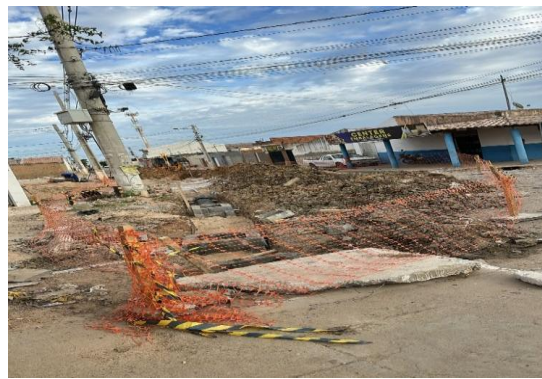
AV PROPRIÁ - ISOLAMENTO COM TELA
