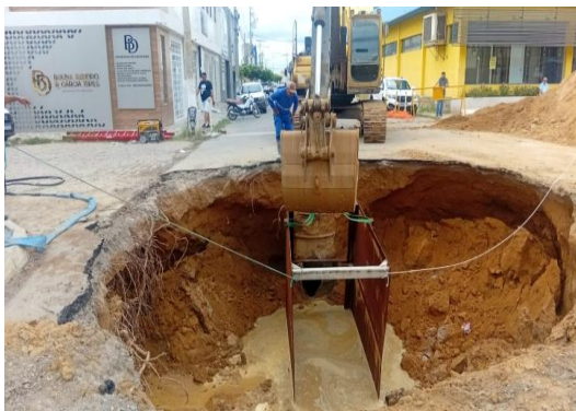
AV ADOLFO VIANA - MANUTENÇÃO DE DRENAGEM
