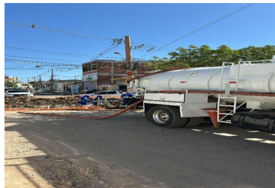
AV PROPRIÁ - LIMPEZA COM SEWERJET
