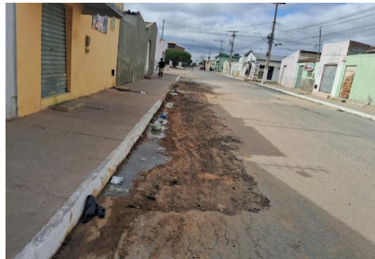
AV ENG MANOEL BORGES - PREPARAÇÃO DE TRECHO
