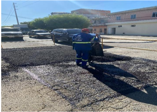
AV PAULO AFONSO - APLICAÇÃO DE CBUQ
