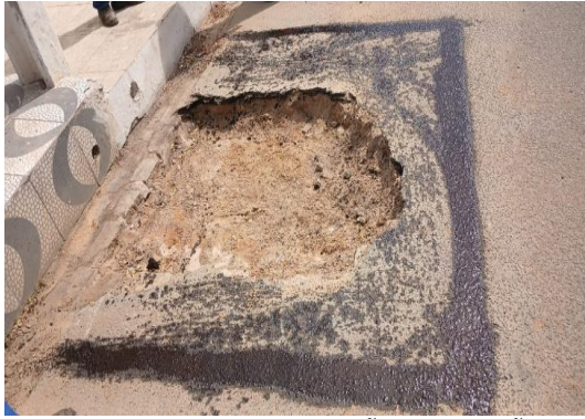
AV PAULO AFONSO - APLICAÇÃO DE EMULSÃO
