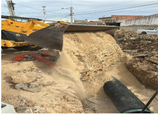
AV PROPRIÁ - ATERRO COM AREIA
