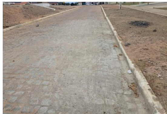
PINHÕES - EXECUÇÃO DE RUA EM PARALELO
