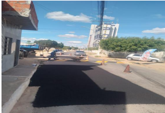
RUA SÃO JOÃO - TAPA BURACO CBUQ
