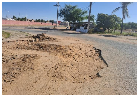
AV JOÃO PAULO II - PREPARAÇÃO DE TRECHO
