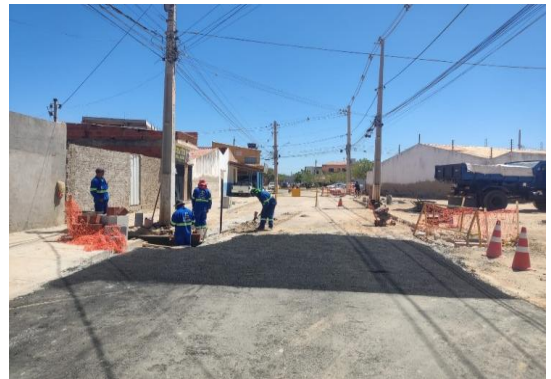
AV PROPRIÁ - APLICAÇÃO DE CBUQ
