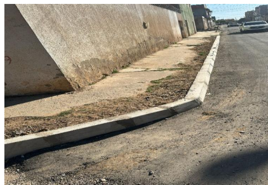
RUA SÃO JOÃO - ASSENTAMENTO DE MEIO FIO
