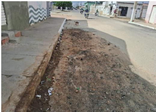
AV ENG MANOEL BORGES - PREPARAÇÃO DE TRECHO
