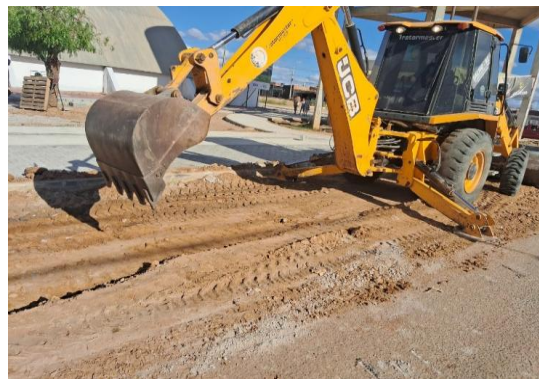
AV CHEFIC KHOURY - ESCAVAÇÃO MECANIZADA
