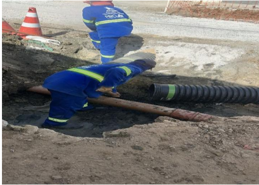
AV PROPRIÁ - EXECUÇÃO DE REDE
