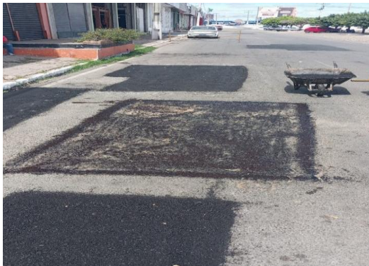
AV SANTOS DUMONT - APLICAÇÃO DE EMULSÃO
