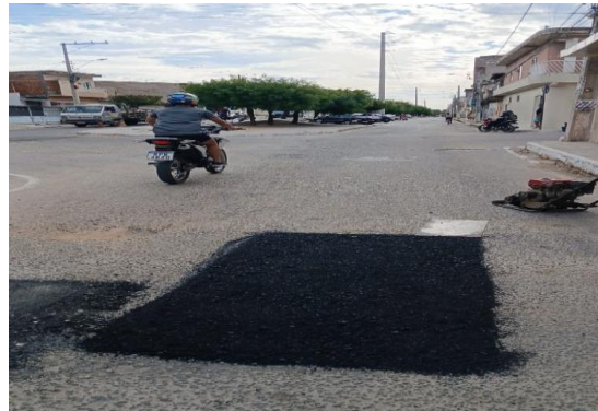
AV PAULO AFONSO - APLICAÇÃO DE CBUQ
