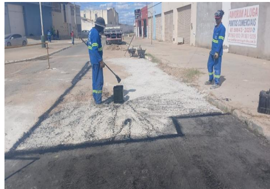
RUA MATATU - APLICAÇÃO DE EMULSÃO
