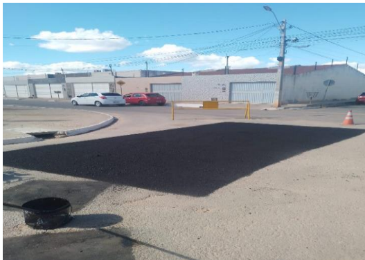
AV PROPRIÁ - APLICAÇÃO DE CBUQ
