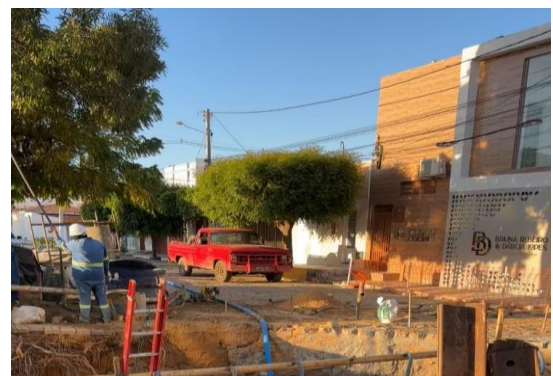
AV ADOLFO VIANA - MICROESTACA DE CONCRETO
