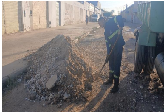
RUA MATATU - LIMPEZA DE ÁREA
