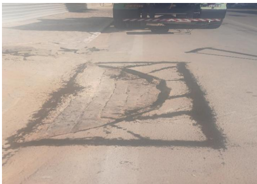
AV SANTOS DUMONT - APLICAÇÃO DE EMULSÃO
