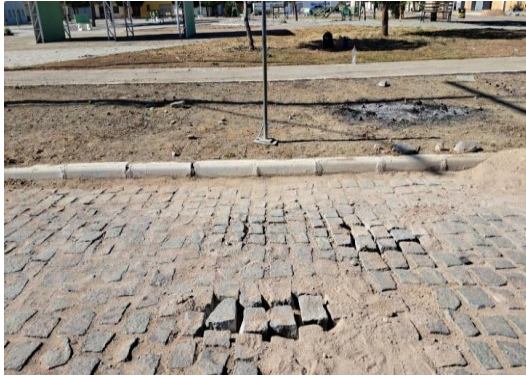
PINHÕES - PAVIMENTAÇÃO DE RUA EM PARALELO
