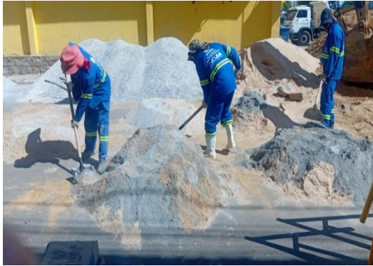
AV ADOLFO VIANA - FABRICAÇÃO DE CONCRETO
