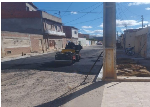
RUA SÃO JOÃO - TAPA BURACO CBUQ
