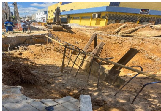
AV ADOLFO VIANA - INSTALAÇÃO DE BOMBAS DE REBAIX
