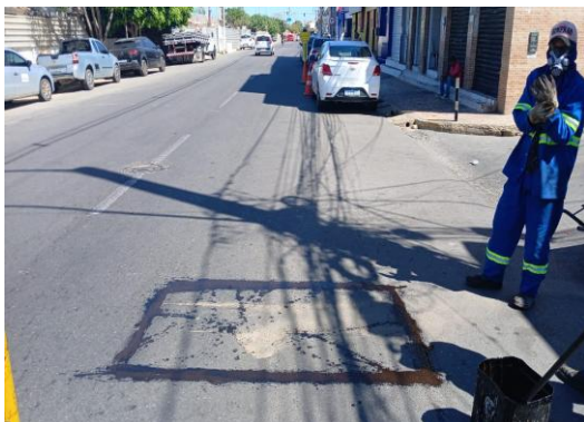
AV SANTOS DUMONT - APLICAÇÃO DE EMULSÃO
