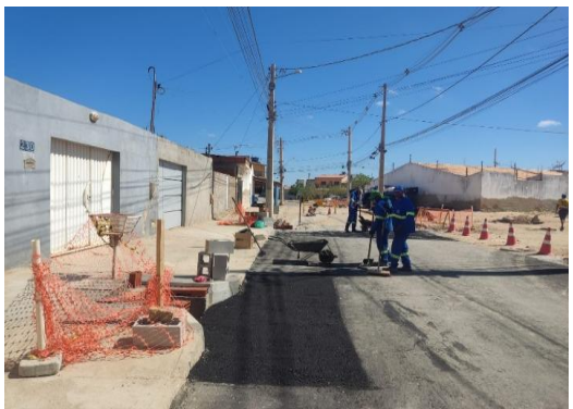
AV PROPRIÁ - APLICAÇÃO DE CBUQ
