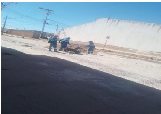
RUA SÃO JOÃO - APLICAÇÃO DE BGS
