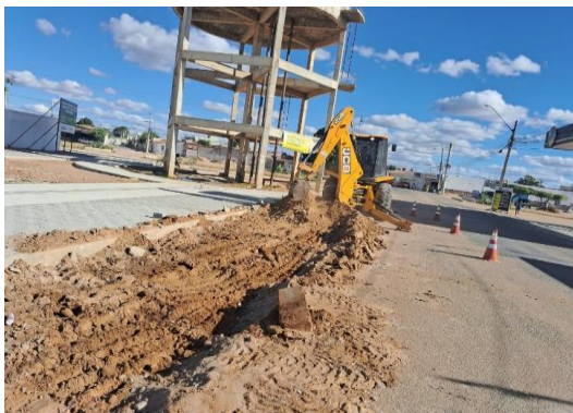
AV CHEFIC KHOURY - ESCAVAÇÃO MECANIZADA
