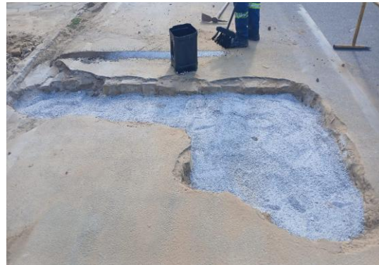
RUA MATATU - APLICAÇÃO DE BGS
