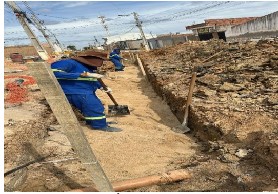
AV PROPRIÁ - ATERRO COM AREIA
