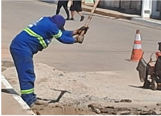
AV ENG MANOEL BORGES - PREPARAÇÃO DE TRECHO
