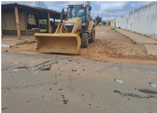
AV ENG MANOEL BORGES - PREPARAÇÃO DE TRECHO
