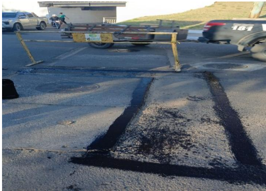
AV RAUL NEVES - APLICAÇÃO DE EMULSÃO
