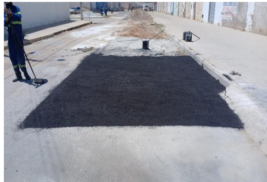
RUA MATATU - APLICAÇÃO DE CBUQ
