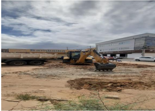
RUA ADOALTO MATOS - ESCAVAÇÃO MECANIZADA
