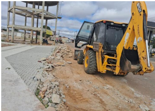
AV CHEFIC KHOURY - ESCAVAÇÃO MECANIZADA
