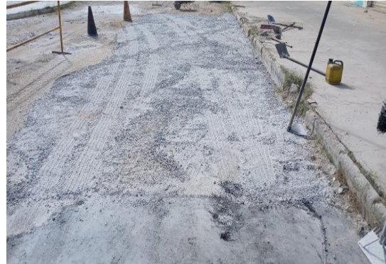
RUA MATATU - APLICAÇÃO DE BGS
