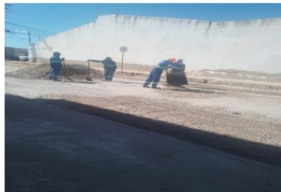
RUA SÃO JOÃO - APLICAÇÃO DE BGS
