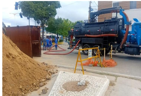
AV ADOLFO VIANA - LIMPEZA COM SEWERJET
