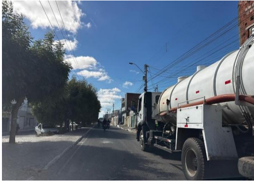
ALTO DA MARAVILHA - LIMPEZA COM SEWERJET
