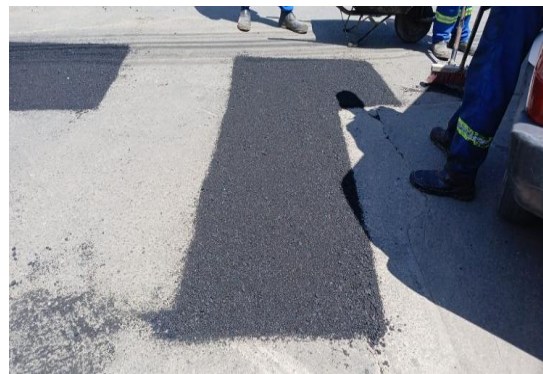
RUA MATATU - APLICAÇÃO DE CBUQ
