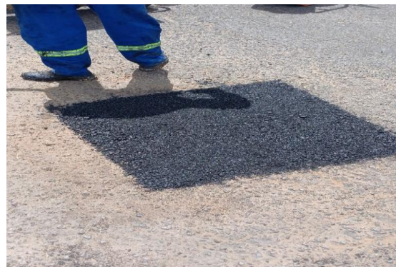
AV RAUL NEVES - APLICAÇÃO DE CBUQ
