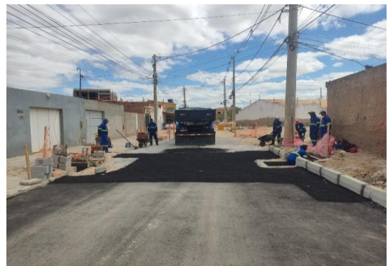
AV PROPRIÁ - APLICAÇÃO DE CBUQ
