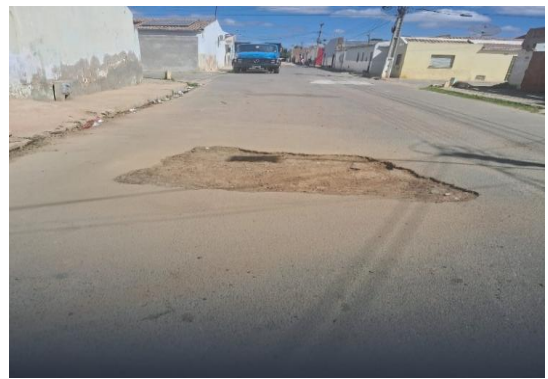
AV PROPRIÁ - APLICAÇÃO DE BGS
