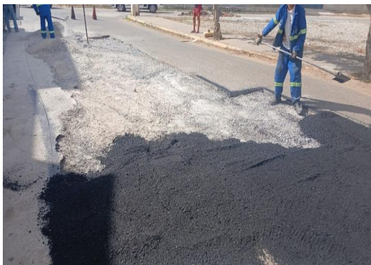
RUA MATATU - APLICAÇÃO DE CBUQ
