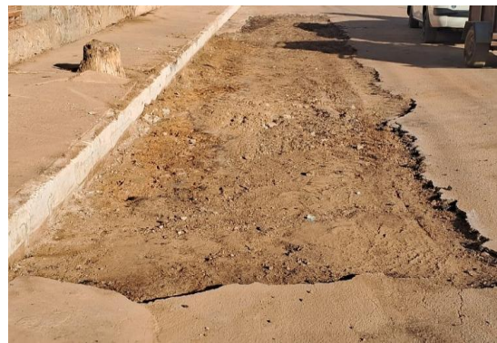
AV ENG MANOEL BORGES - PREPARAÇÃO DE TRECHO
