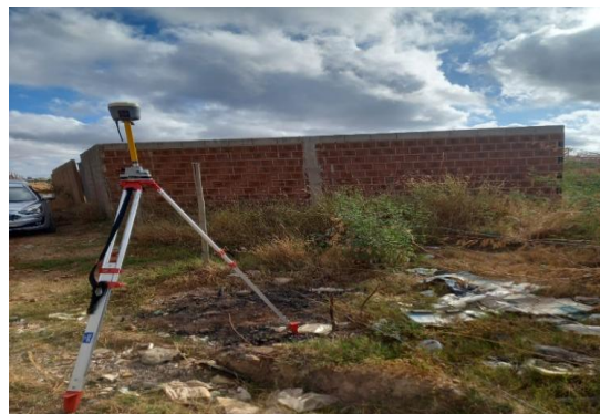
AV PROPRIÁ - LEVANTAMENTO TOPOGRÁFICO
