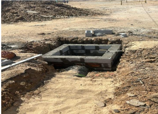
AV PROPRIÁ - EXECUÇÃO DE CAIXA
