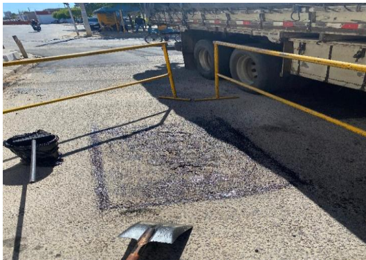
AV PAULO AFONSO - APLICAÇÃO DE EMULSÃO
