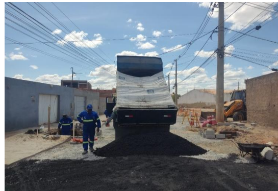
AV PROPRIÁ - APLICAÇÃO DE CBUQ
