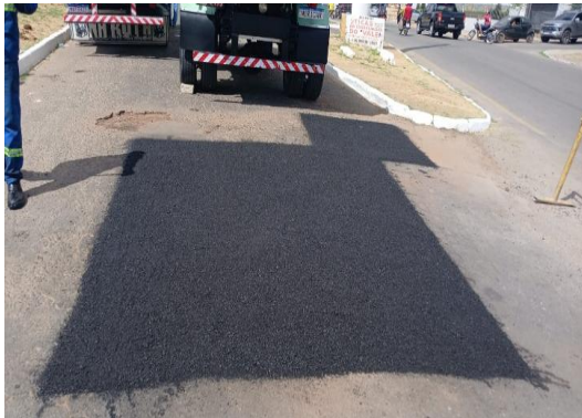
AV RAUL NEVES - APLICAÇÃO DE CBUQ
