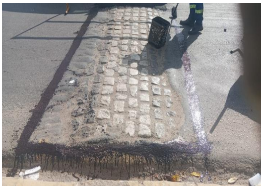
AV SANTOS DUMONT - APLICAÇÃO DE EMULSÃO
