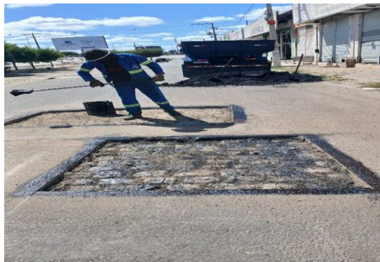
AV SANTOS DUMONT - APLICAÇÃO DE EMULSÃO
