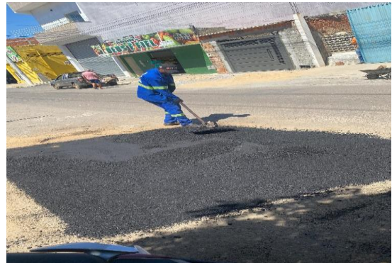
AV PAULO AFONSO - APLICAÇÃO DE CBUQ
