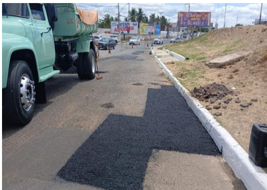
AV RAUL NEVES - APLICAÇÃO DE CBUQ
