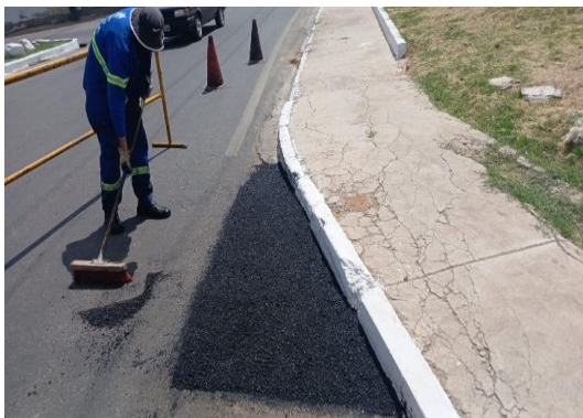
AV RAUL NEVES - APLICAÇÃO DE CBUQ
