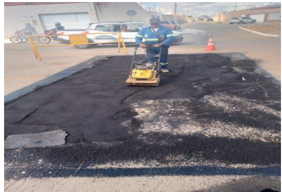
AV PROPRIÁ - APLICAÇÃO DE CBUQ
