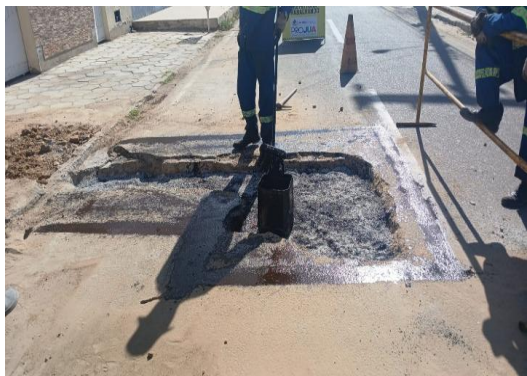
RUA MATATU - APLICAÇÃO DE EMULSÃO
