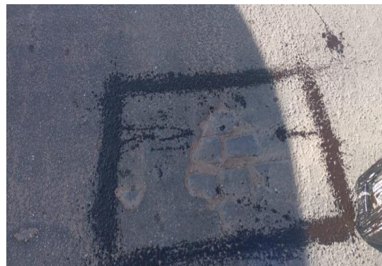
AV SANTOS DUMONT - APLICAÇÃO DE EMULSÃO
