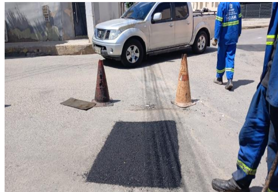
RUA MATATU - APLICAÇÃO DE CBUQ
