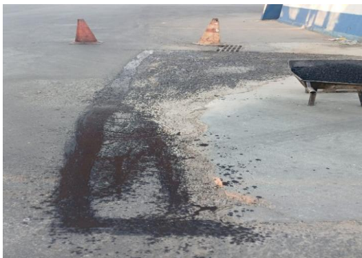
AV RAUL NEVES - APLICAÇÃO DE CBUQ
