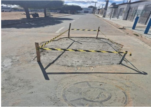
AV JOÃO PAULO II - PREPARAÇÃO DE TRECHO
