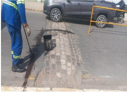
AV SANTOS DUMONT - APLICAÇÃO DE EMULSÃO
