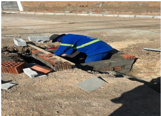
AV PROPRIÁ - EXECUÇÃO DE CAIXA
