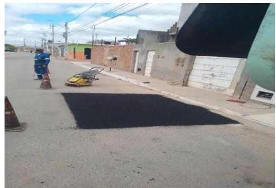
AV PROPRIÁ - APLICAÇÃO DE CBUQ
