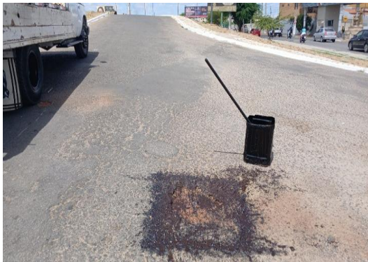
AV RAUL NEVES - APLICAÇÃO DE EMULSÃO
