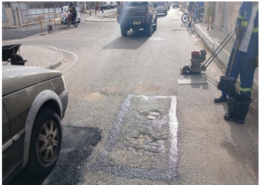
AV PAULO AFONSO - APLICAÇÃO DE EMULSÃO
