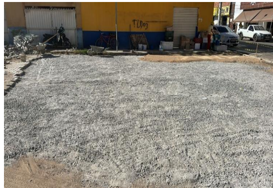
RUA ADOALTO MATOS - APLICAÇÃO DE BGS
