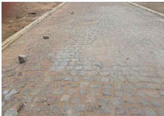
PINHÕES - EXECUÇÃO DE RUA EM PARALELO
