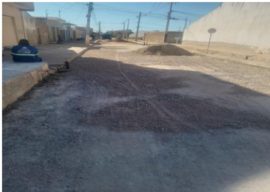
RUA SÃO JOÃO - APLICAÇÃO DE BGS
