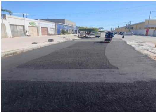
RUA MATATU - APLICAÇÃO DE CBUQ
