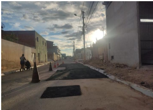
RUA SÃO JOÃO - TAPA BURACO CBUQ
