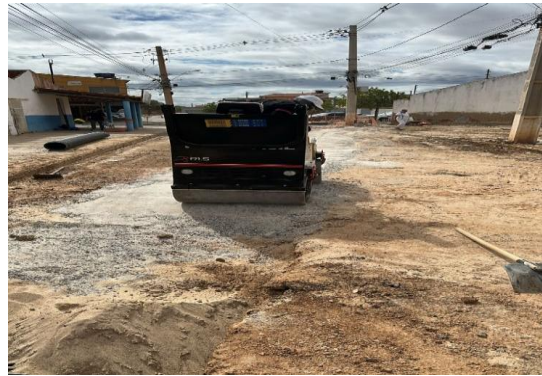
AV PROPRIÁ - COMPACTAÇÃO DE BGS
