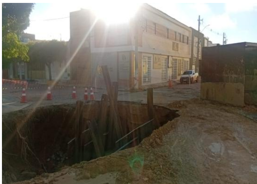
AV ADOLFO VIANA - MANUTENÇÃO DE DRENAGEM
