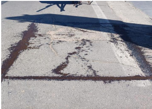
AV SANTOS DUMONT - APLICAÇÃO DE EMULSÃO
