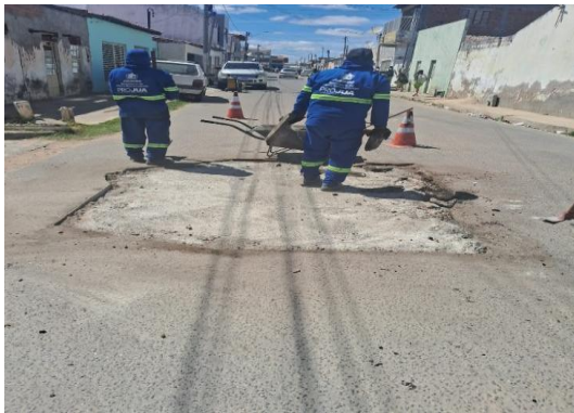
AV JOÃO PAULO II - PREPARAÇÃO DE TRECHO
