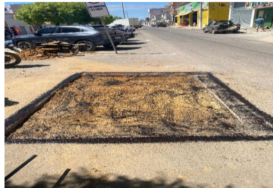
AV PAULO AFONSO - APLICAÇÃO DE EMULSÃO
