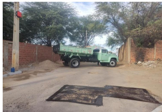
RUA SÃO JOÃO - TAPA BURACO CBUQ
