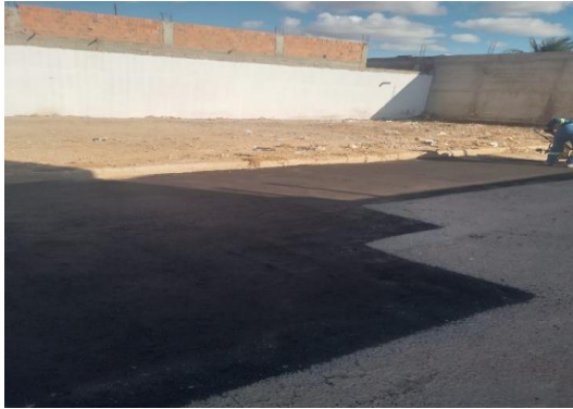
AV PROPRIÁ - APLICAÇÃO DE CBUQ
