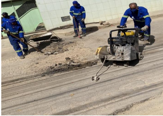
RUA SÃO JOÃO - CORTE DE PAVIMENTO
