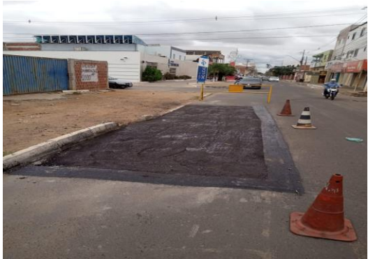
RUA SÃO JOÃO - APLICAÇÃO DE CBUQ
