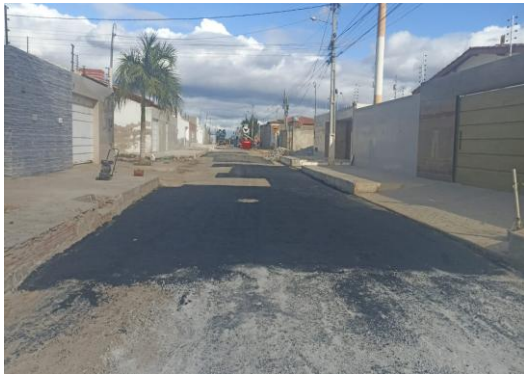
AV PROPRIÁ - APLICAÇÃO DO CBUQ
