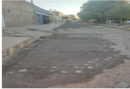
AV BAHIA - PAVIMENTAÇÃO EM PARALELO
