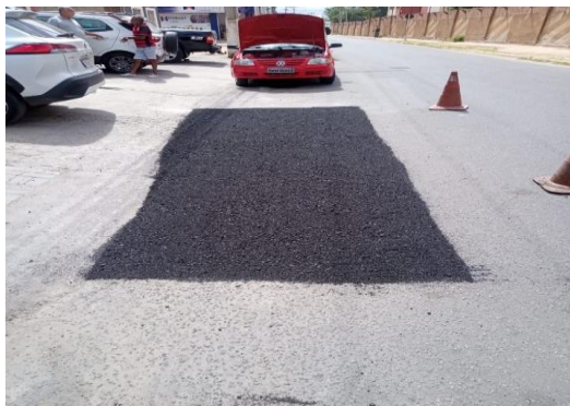
RUA SÃO JOÃO - APLICAÇÃO DE CBUQ
