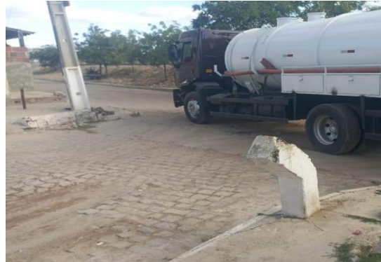
RUA CARDEAL ARCOVERDE - DESOBSTRUÇÃO COM
