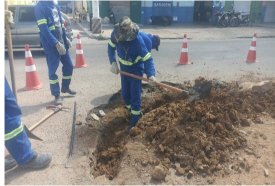
AV SÃO JOÃO - CORTE PARA MEIO FIO
