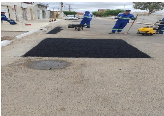
RUA BELA VISTA - APLICAÇÃO DE CBUQ
