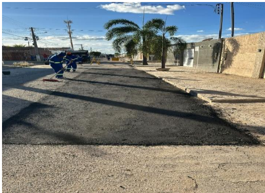
AV PROPRIÁ - APLICAÇÃO DO CBUQ
