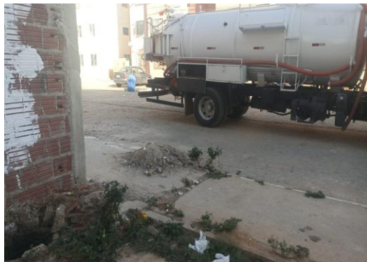
RUA DOS LIMOEIROS - DESOBSTRUÇÃO COM SEWER
