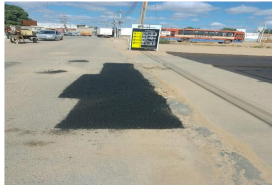
R. PRINCIPAL - APLICAÇÃO DE CBUQ
