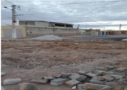
AV BAHIA - PAVIMENTAÇÃO EM PARALELO
