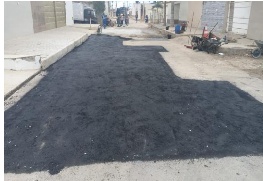
AV PROPRIÁ - APLICAÇÃO DO CBUQ
