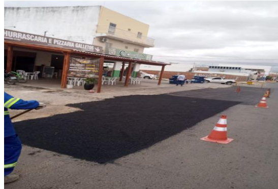
RUA SÃO JOÃO - APLICAÇÃO DE CBUQ
