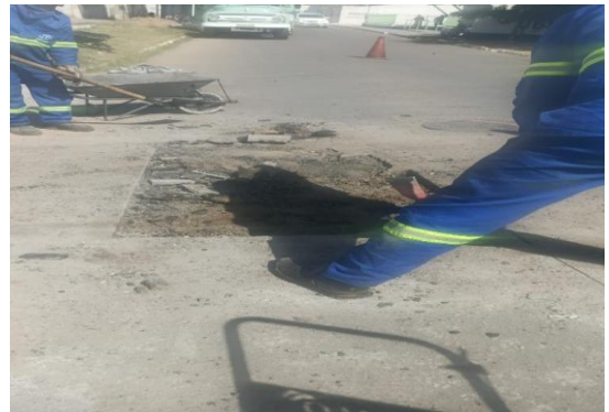
AV AIRTON SENA - PAVIMENTAÇÃO COM CBUQ
