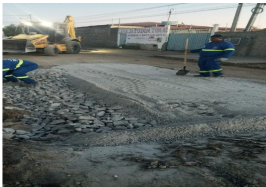
AV PROPRIÁ - APLICAÇÃO DE BGS
