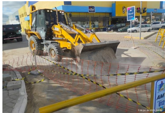
AV ADOLFO VIANA - SERVIÇO DE DRENAGEM
