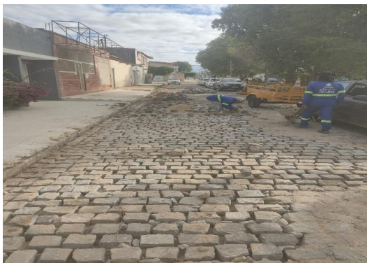
AV BAHIA - PAVIMENTAÇÃO EM PARALELO
