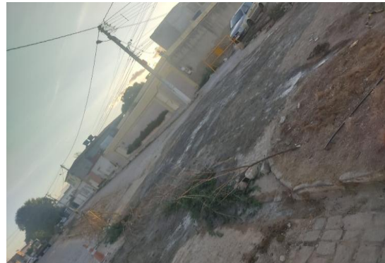
AV BAHIA - PAVIMENTAÇÃO EM PARALELO
