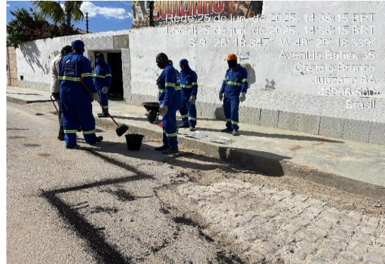
AV PROPRIÁ - IMPRIMAÇÃO COM EMULSÃO ASFAL
