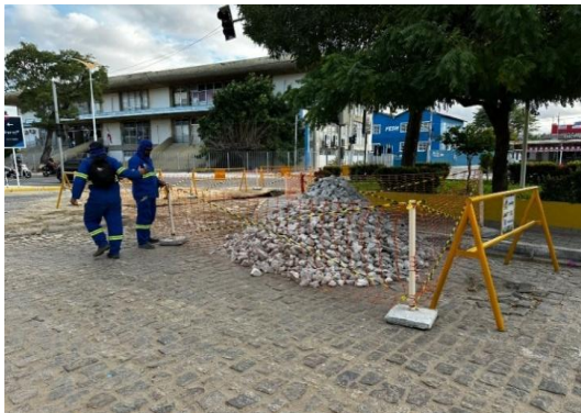
AV ADOLFO VIANA - SERVIÇO DE DRENAGEM
