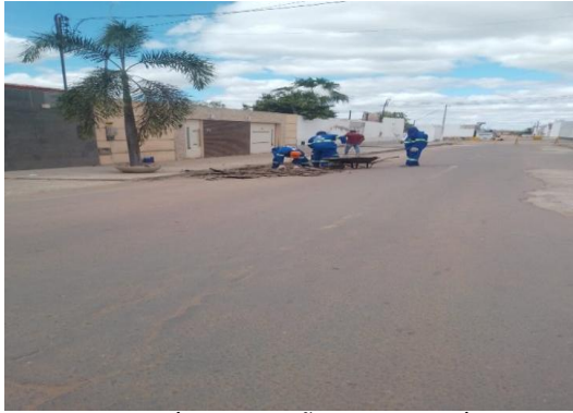
AV PROPRIÁ - DEMOLIÇÃO DE PAV ASFÁLTICO
