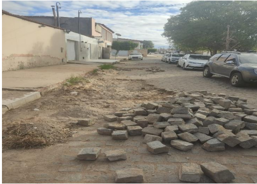
AV BAHIA - PAVIMENTAÇÃO EM PARALELO
