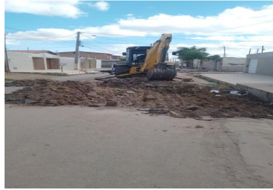
AV PROPRIÁ - ESCAVAÇÃO MECANIZADA
