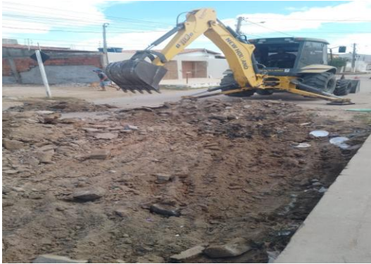
AV PROPRIÁ - ESCAVAÇÃO MECANIZADA
