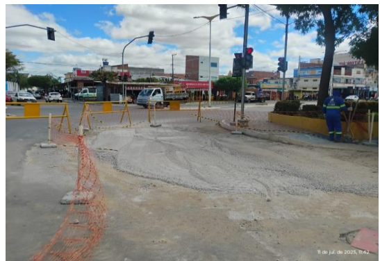
AV ADOLFO VIANA - SERVIÇO DE DRENAGEM
