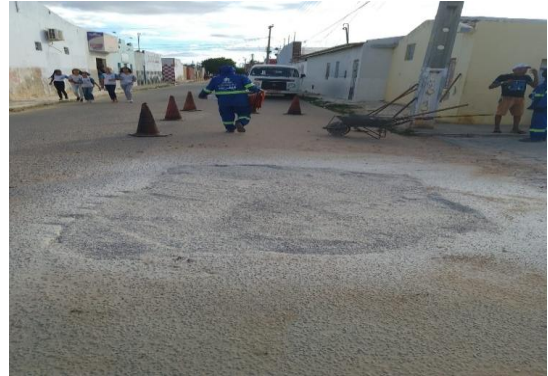
AV SÃO JOÃO - APLICAÇÃO DE BGS
