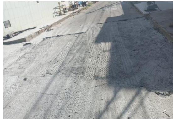
RUA SÃO JOÃO - APLICAÇÃO DE BGS
