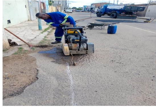
RUA DA CRECHE - CORTE DE ASFALTO
