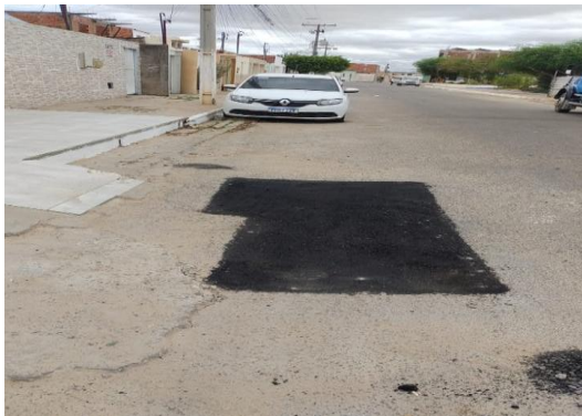
RUA BELA VISTA - APLICAÇÃO DE CBUQ
