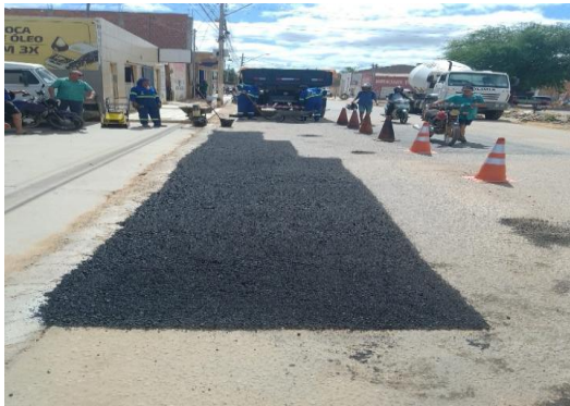
R. PRINCIPAL - APLICAÇÃO DE CBUQ
