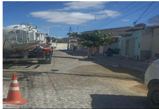
RUA RAUL SEIXAS - DESOBSTRUÇÃO COM SEWER JET
