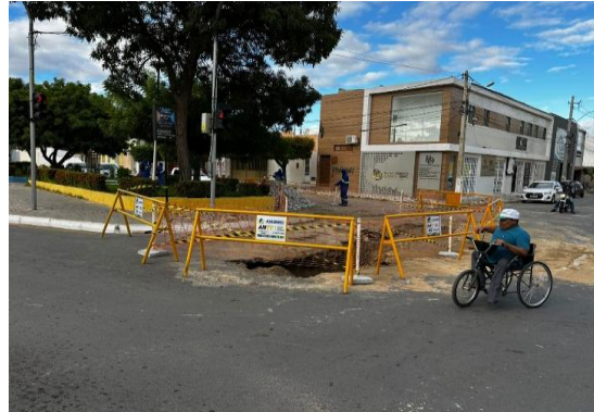
AV ADOLFO VIANA - SERVIÇO DE DRENAGEM
