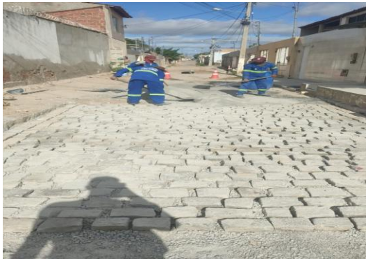
RUA SÃO LUIZ - PAVIMENTAÇÃO EM PARALELO
