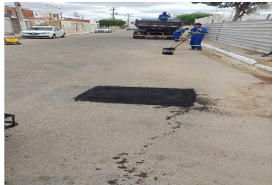
RUA BELA VISTA - APLICAÇÃO DE CBUQ
