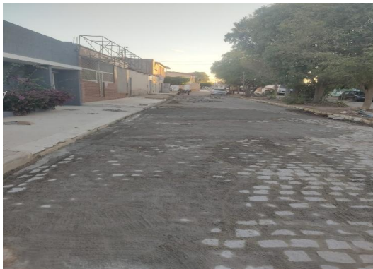
AV BAHIA - PAVIMENTAÇÃO EM PARALELO
