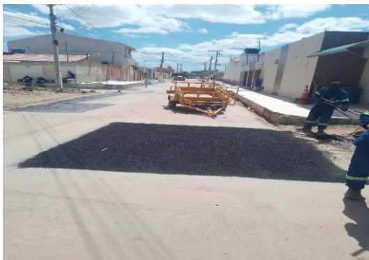
RUA PROPRIÁ - APLICAÇÃO DE CBUQ
