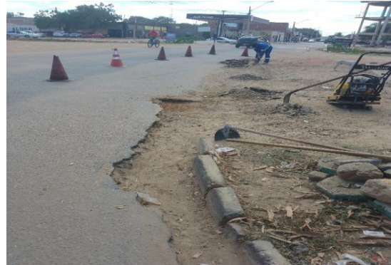
R. PRINCIPAL - APLICAÇÃO DE CBUQ
