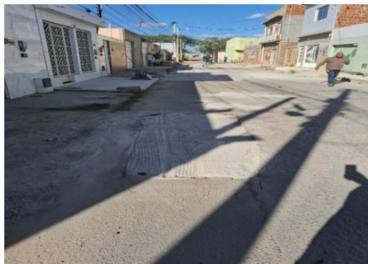
RUA SÃO JOÃO - APLICAÇÃO DE BGS
