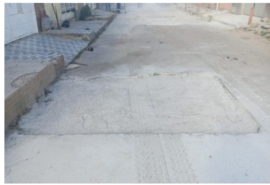
RUA SÃO JOÃO - APLICAÇÃO DE BGS
