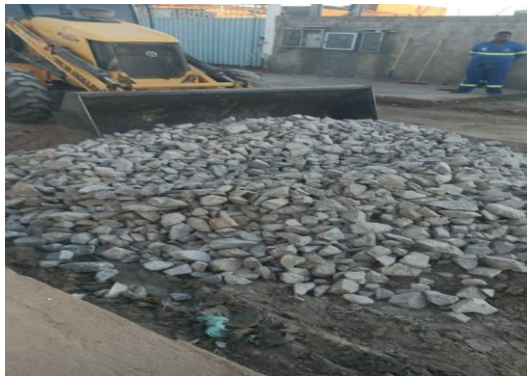
AV PROPRIÁ - REFORÇO DE BASE COM PEDRA
