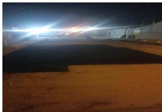
AV PROPRIÁ - APLICAÇÃO DO CBUQ
