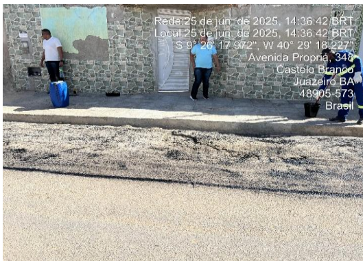
AV PROPRIÁ - IMPRIMAÇÃO COM EMULSÃO ASFAL
