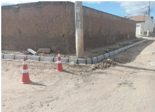
AV PROPRIÁ - ASSENTAMENTO DE MEIO FIO
