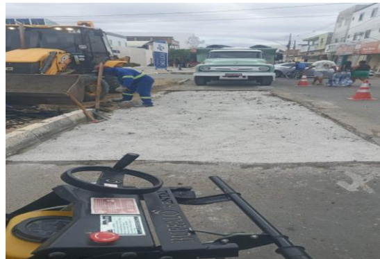
RUA SÃO JOÃO - APLICAÇÃO DE CBUQ
