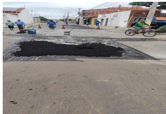
AV AIRTON SENA - PAVIMENTAÇÃO COM CBUQ
