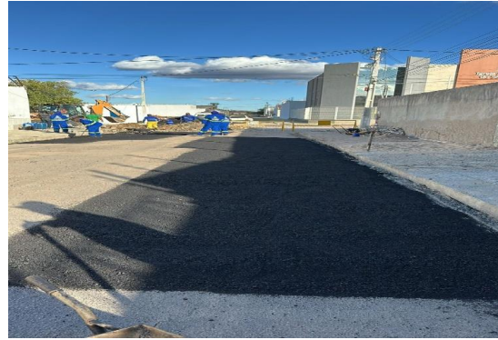
AV PROPRIÁ - APLICAÇÃO DO CBUQ
