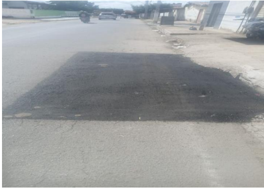
AV AIRTON SENA - PAVIMENTAÇÃO COM CBUQ
