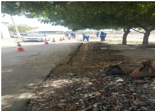
AV LUIZ INACIO - APLICAÇÃO DE MEIO FIO
