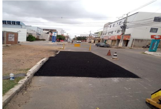
RUA SÃO JOÃO - APLICAÇÃO DE CBUQ
