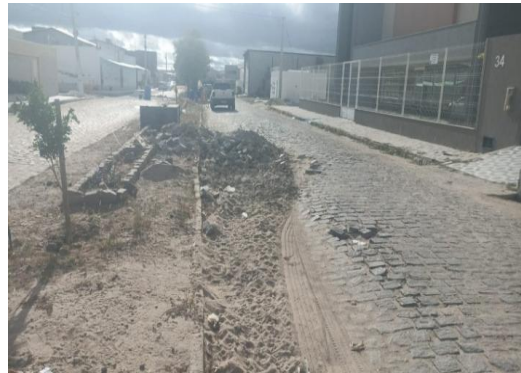
AV BAHIA - PAVIMENTAÇÃO EM PARALELO
