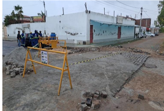
AV BAHIA - PAVIMENTAÇÃO EM PARALELO
