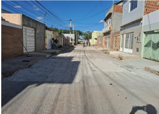
RUA SÃO JOÃO - CORTE DE PAVIMENTO
