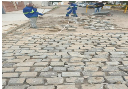
AV BAHIA - PAVIMENTAÇÃO EM PARALELO
