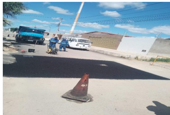
RUA PROPRIÁ - APLICAÇÃO DE CBUQ
