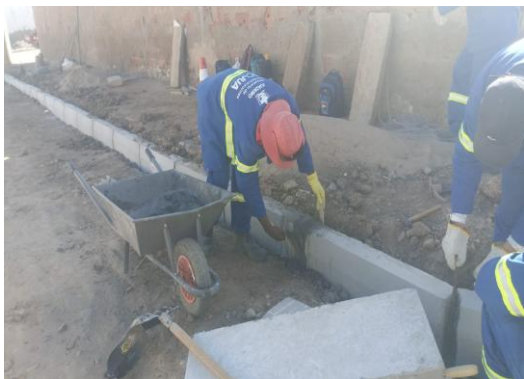
AV PROPRIÁ - ASSENTAMENTO DE MEIO FIO
