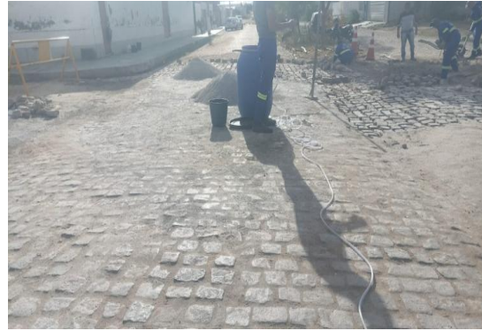
AV BAHIA - PAVIMENTAÇÃO EM PARALELO
