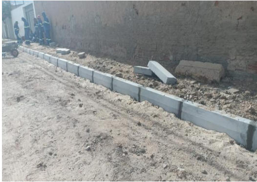
AV PROPRIÁ - ASSENTAMENTO DE MEIO FIO
