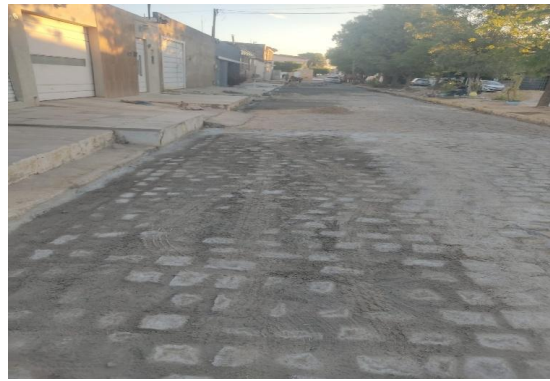
AV BAHIA - PAVIMENTAÇÃO EM PARALELO
