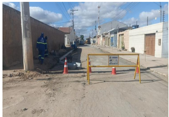
AV PROPRIÁ - ASSENTAMENTO DE MEIO FIO
