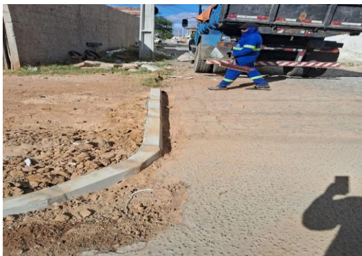
AV SÃO JOÃO - APLICAÇÃO DE MEIO FIO
