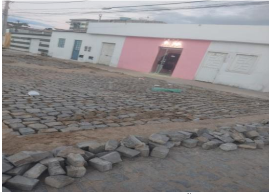
RUA TOBIAS BARRETO - PAVIMENTAÇÃO EM PARALELO
