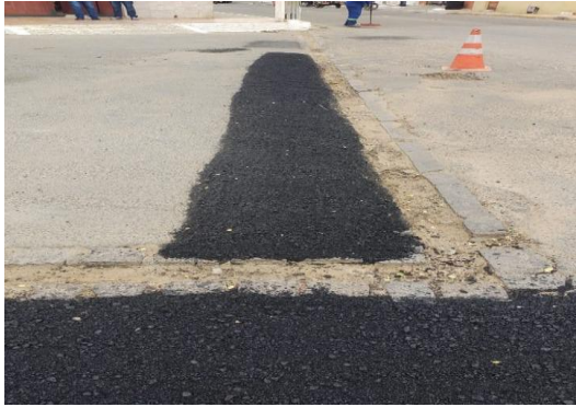
RUA BELA VISTA - APLICAÇÃO DE CBUQ
