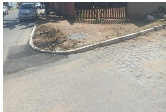
AV SÃO JOÃO - APLICAÇÃO DE MEIO FIO
