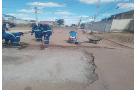
AV PROPRIÁ - CORTE DE PAVIMENTO
