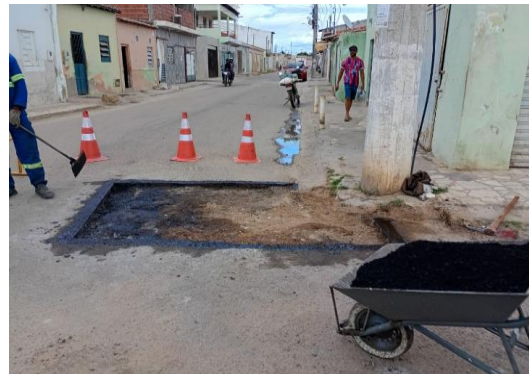
RUA DA CRECHE - APLICAÇÃO DE CBUQ
