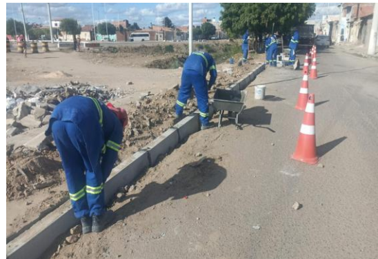
AV LUIZ INACIO - APLICAÇÃO DE MEIO FIO
