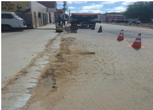
R. PRINCIPAL - APLICAÇÃO DE CBUQ
