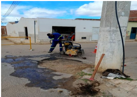
RUA DA CRECHE - CORTE DE ASFALTO
