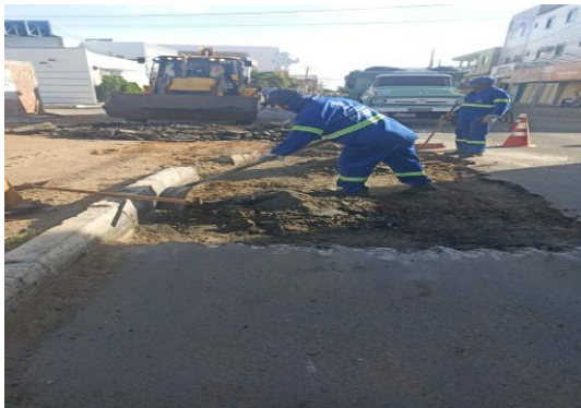
RUA SÃO JOÃO - APLICAÇÃO DE CBUQ
