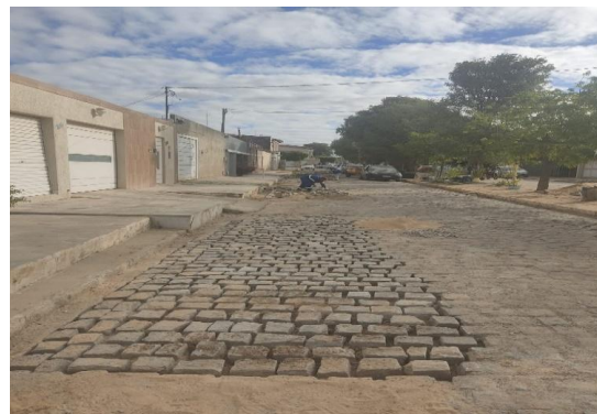
AV BAHIA - PAVIMENTAÇÃO EM PARALELO
