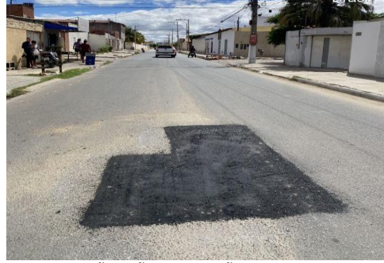
AV SÃO JOÃO - APLICAÇÃO DE ASFALTO
