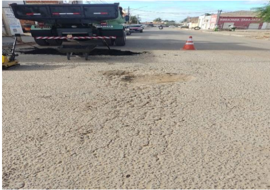
R. PRINCIPAL - APLICAÇÃO DE CBUQ
