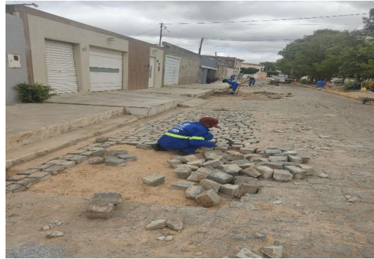
AV BAHIA - PAVIMENTAÇÃO EM PARALELO
