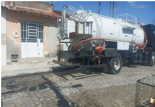
RUA RAUL SEIXAS - DESOBSTRUÇÃO COM SEWER JET
