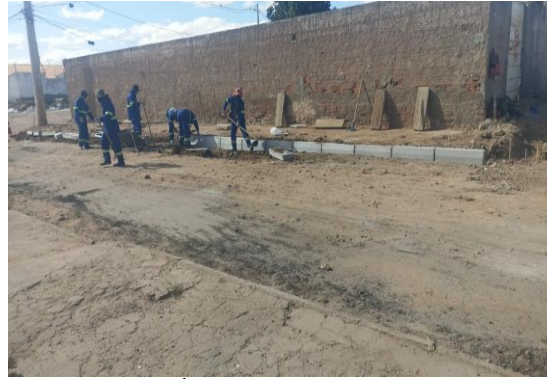
AV PROPRIÁ - ASSENTAMENTO DE MEIO FIO
