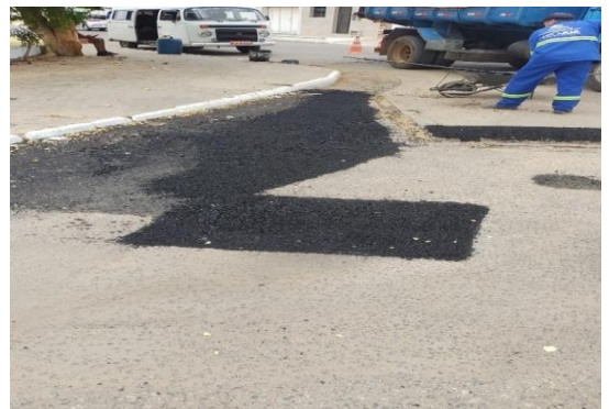
RUA BELA VISTA - APLICAÇÃO DE CBUQ
