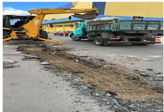
AV ADOLFO VIANA - SERVIÇO DE DRENAGEM
