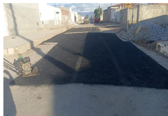
AV PROPRIÁ - APLICAÇÃO DO CBUQ
