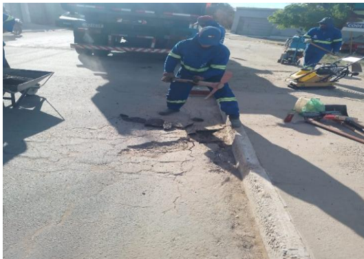
RUA PROPRIÁ - APLICAÇÃO DE CBUQ
