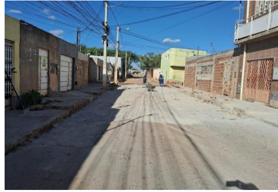
RUA SÃO JOÃO - APLICAÇÃO DE BGS
