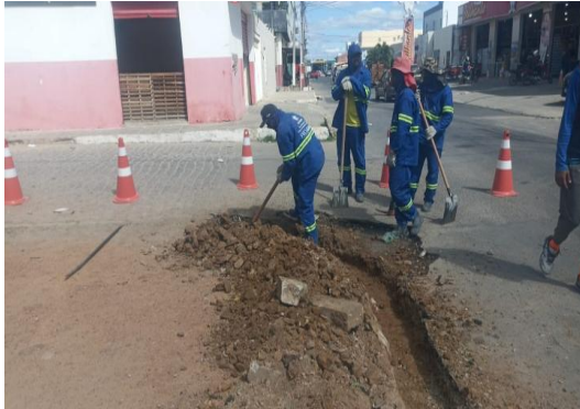
AV SÃO JOÃO - CORTE PARA MEIO FIO
