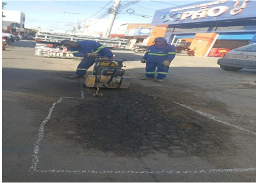
AV AIRTON SENA - DEMOLIÇÃO ASFÁLTICA
