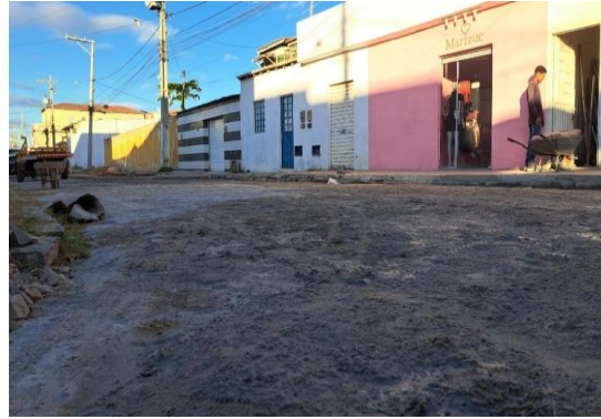
RUA TOBIAS BARRETO - PAVIMENTAÇÃO EM PARALELO
