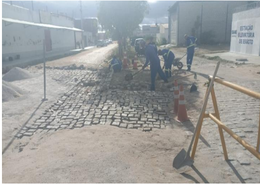
AV BAHIA - PAVIMENTAÇÃO EM PARALELO
