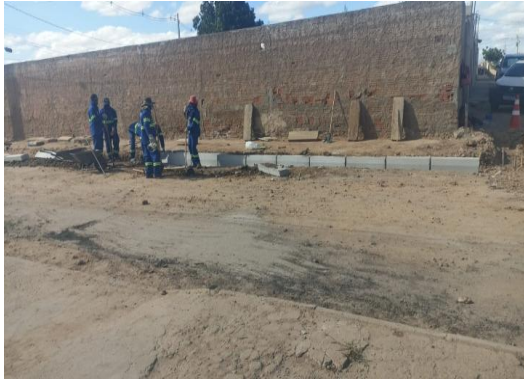
AV PROPRIÁ - ASSENTAMENTO DE MEIO FIO
