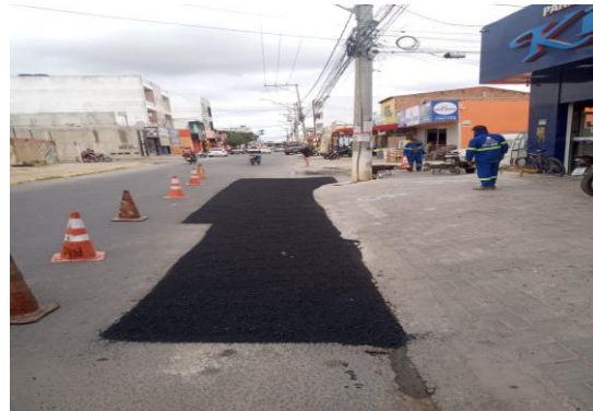
RUA SÃO JOÃO - APLICAÇÃO DE CBUQ
