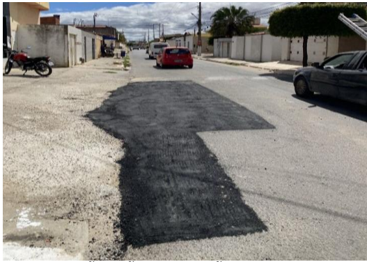
AV SÃO JOÃO - APLICAÇÃO DE ASFALTO
