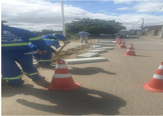
AV LUIZ INACIO - APLICAÇÃO DE MEIO FIO
