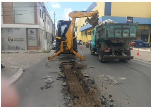
AV ADOLFO VIANA - SERVIÇO DE DRENAGEM
