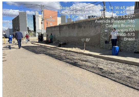
AV PROPRIÁ - IMPRIMAÇÃO COM EMULSÃO ASFAL
