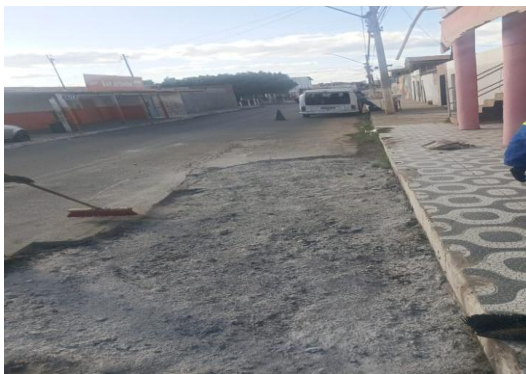
AV AIRTON SENA - PAVIMENTAÇÃO COM CBUQ
