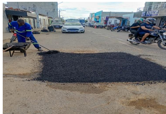
AV AIRTON SENA - DEMOLIÇÃO ASFÁLTICA
