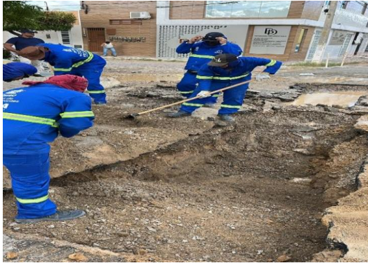
AV ADOLFO VIANA - SERVIÇO DE DRENAGEM
