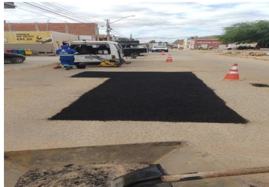
R. PRINCIPAL - APLICAÇÃO DE CBUQ
