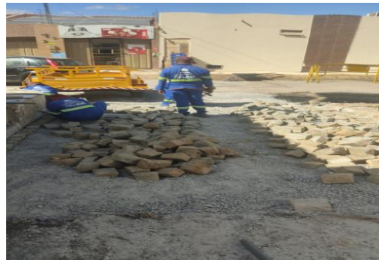
RUA SÃO LUIZ - PAVIMENTAÇÃO EM PARALELO
