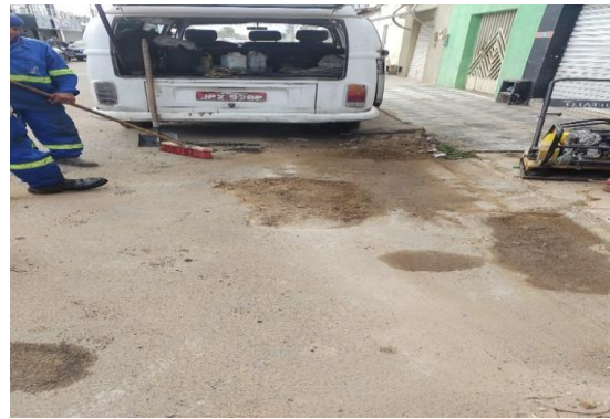
RUA DA CRECHE - CORTE DE ASFALTO
