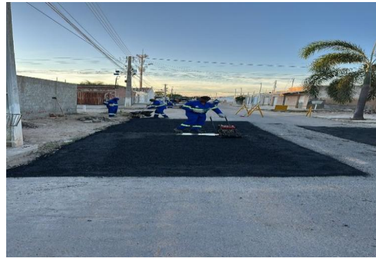
AV PROPRIÁ - APLICAÇÃO DO CBUQ
