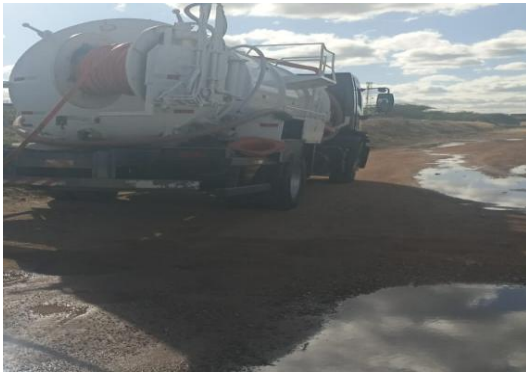
RUA EPITÁCIO PESSOA - DESOBSTRUÇÃO COM SEWER
