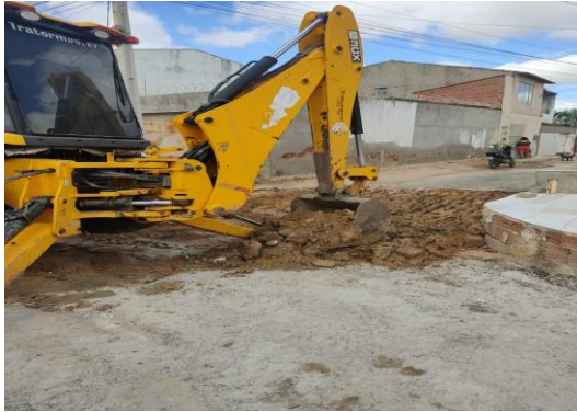
RUA SÃO LUIZ - ESCAVAÇÃO MECANIZADA
