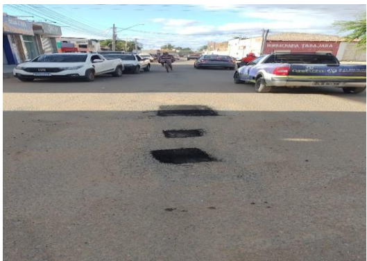
R. PRINCIPAL - APLICAÇÃO DE CBUQ
