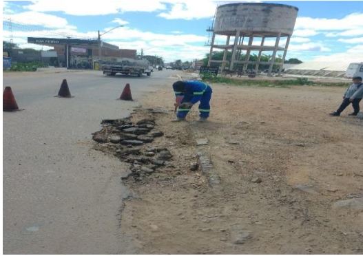
R. PRINCIPAL - APLICAÇÃO DE CBUQ
