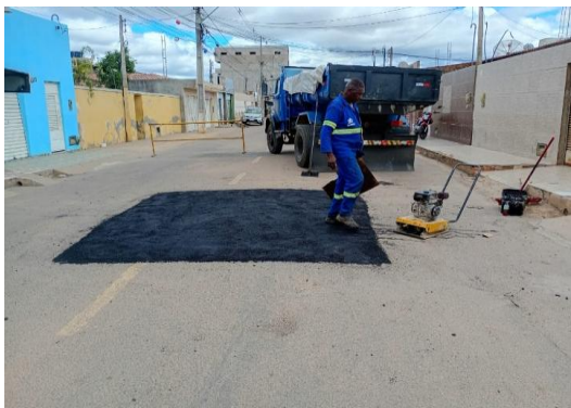
AV AIRTON SENA - DEMOLIÇÃO ASFÁLTICA
