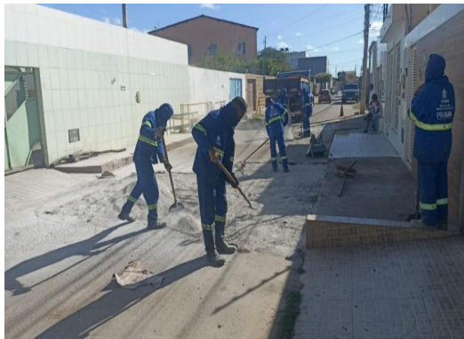
RUA SÃO JOÃO - APLICAÇÃO DE BGS
