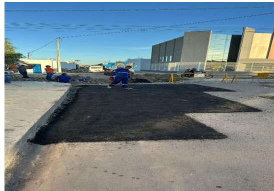
AV PROPRIÁ - APLICAÇÃO DO CBUQ
