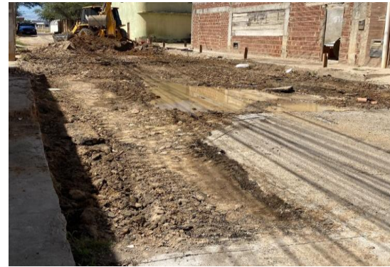
RUA SÃO JOÃO - ESCAVAÇÃO MECANIZADA
