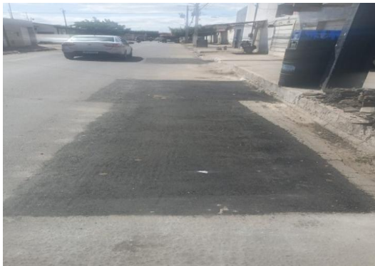
AV AIRTON SENA - PAVIMENTAÇÃO COM CBUQ
