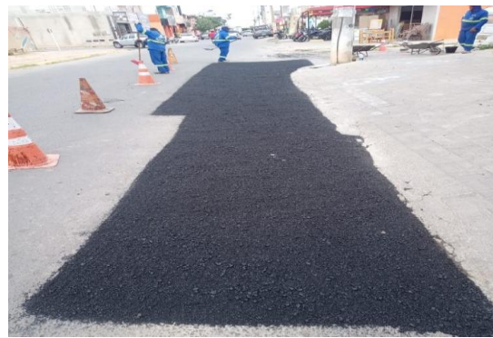
RUA SÃO JOÃO - APLICAÇÃO DE CBUQ
