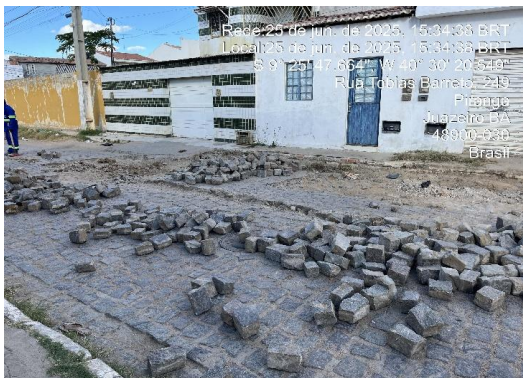
RUA TOBIAS BARRETO - PAVIMENTAÇÃO EM PARALELO
