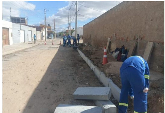
AV PROPRIÁ - ASSENTAMENTO DE MEIO FIO
