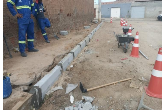
AV PROPRIÁ - ASSENTAMENTO DE MEIO FIO
