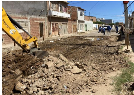
RUA SÃO JOÃO - ESCAVAÇÃO MECANIZADA
