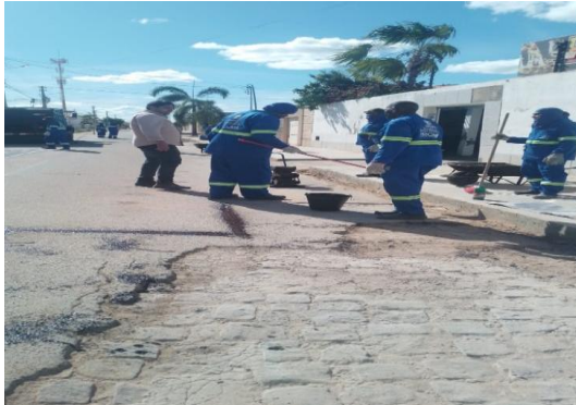
AV PROPRIÁ - IMPRIMAÇÃO COM EMULSÃO ASFAL
