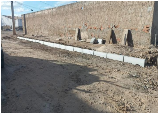
AV PROPRIÁ - ASSENTAMENTO DE MEIO FIO
