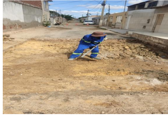
RUA SÃO LUIZ - ESCAVAÇÃO MECANIZADA
