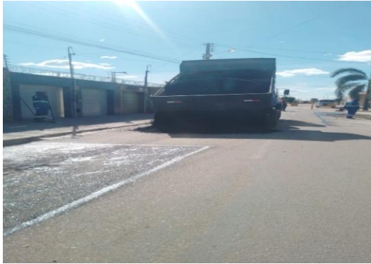
AV PROPRIÁ - APLICAÇÃO DO CBUQ
