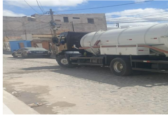
RUA JOÃO FERREIRA - DESOBSTRUÇÃO COM SEWER JET
