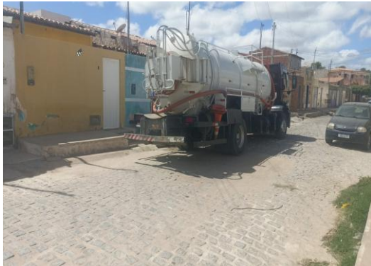
RUA JOB MARQUES - DESOBSTRUÇÃO COM SEWER
