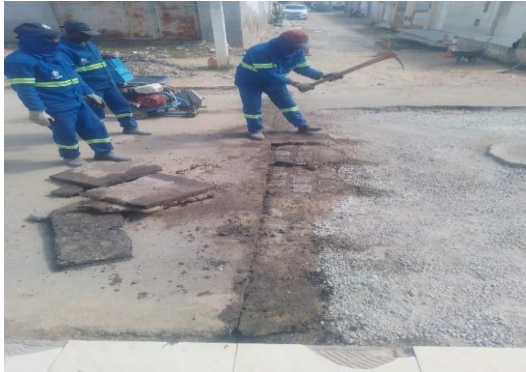
AV PROPRIÁ - CORTE DE PAVIMENTO
