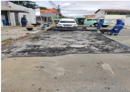
AV AIRTON SENA - DEMOLIÇÃO ASFÁLTICA
