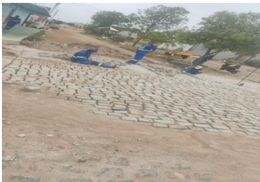
AV BAHIA - PAVIMENTAÇÃO EM PARALELO
