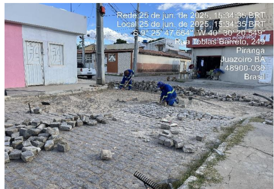
RUA TOBIAS BARRETO - PAVIMENTAÇÃO EM PARALELO
