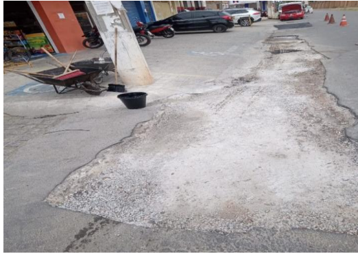
RUA SÃO JOÃO - APLICAÇÃO DE CBUQ
