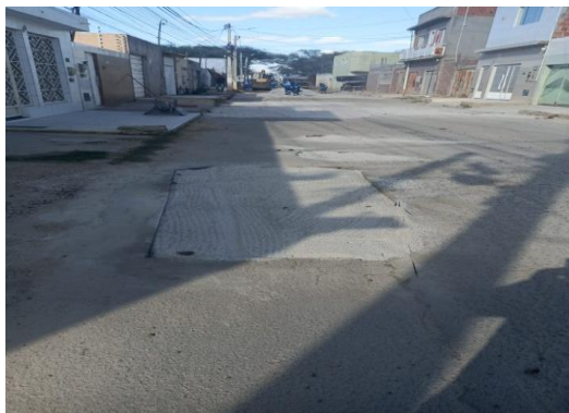
RUA SÃO JOÃO - APLICAÇÃO DE BGS
