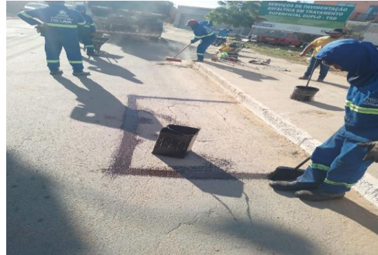
RUA PROPRIÁ - APLICAÇÃO DE CBUQ
