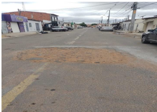
RUA DA CRECHE - CORTE DE ASFALTO
