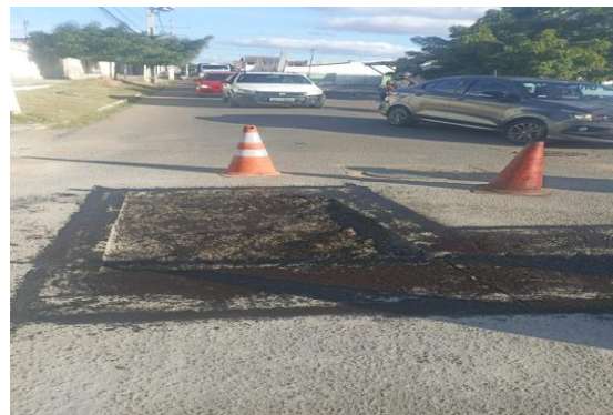
AV AIRTON SENA - PAVIMENTAÇÃO COM CBUQ
