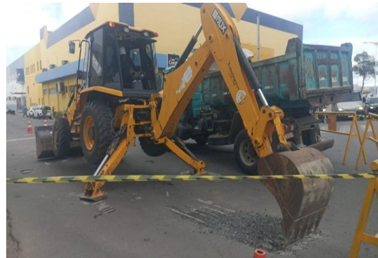
AV ADOLFO VIANA - SERVIÇO DE DRENAGEM
