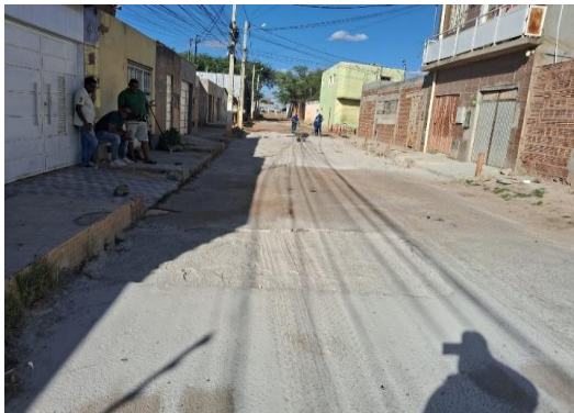
RUA SÃO JOÃO - APLICAÇÃO DE BGS
