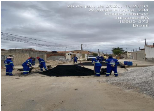
AV PROPRIA - APLICAÇÃO DE CBUQ
