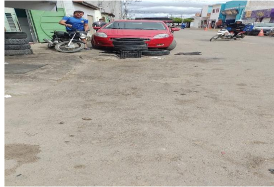
RUA DA CRECHE - CORTE DE ASFALTO
