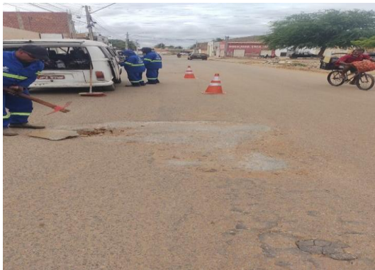
R. PRINCIPAL - APLICAÇÃO DE CBUQ
