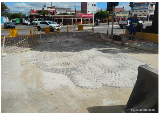
AV ADOLFO VIANA - SERVIÇO DE DRENAGEM
