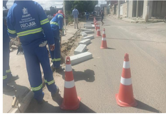
AV LUIZ INÁCIO - APLICAÇÃO DE MEIO FIO
