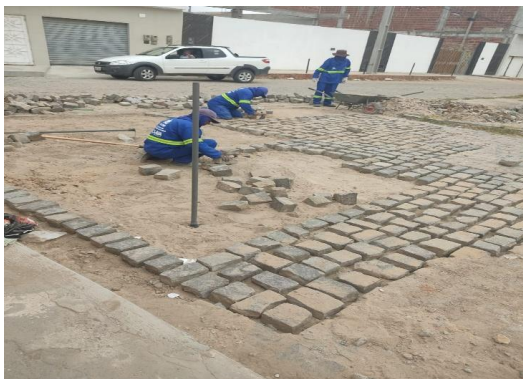
RUA TOBIAS BARRETO - PAVIMENTAÇÃO EM PARALELO
