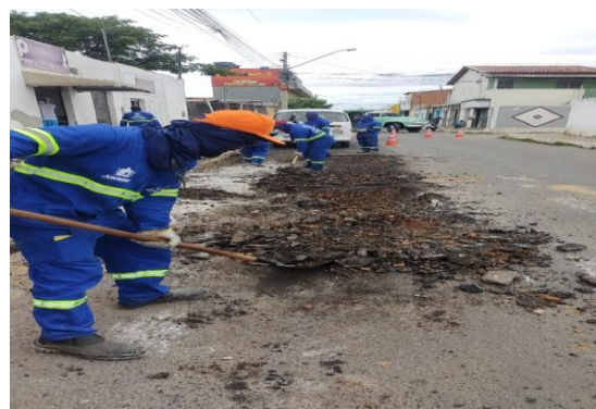
AV AIRTON SENA - DEMOLIÇÃO ASFÁLTICA
