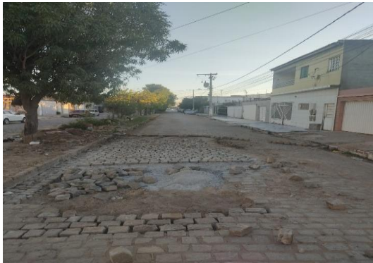
AV BAHIA - PAVIMENTAÇÃO EM PARALELO
