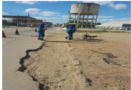
R. PRINCIPAL - APLICAÇÃO DE CBUQ
