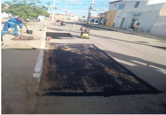
RUA PROPRIÁ - APLICAÇÃO DE CBUQ
