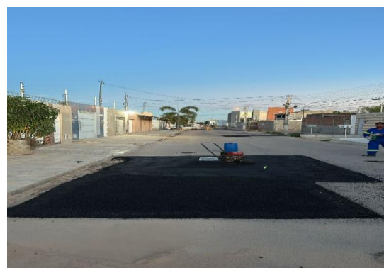
AV PROPRIÁ - APLICAÇÃO DO CBUQ
