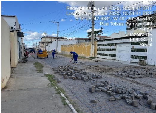
RUA TOBIAS BARRETO - PAVIMENTAÇÃO EM PARALELO
