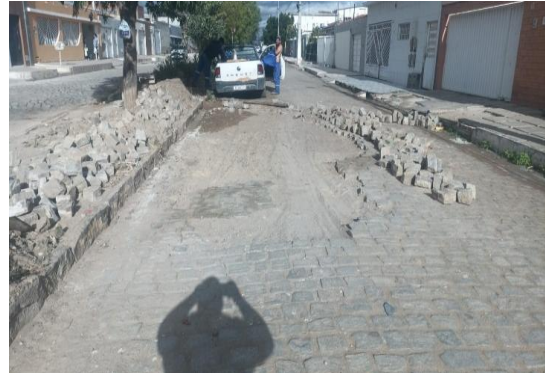
AV BAHIA - PAVIMENTAÇÃO EM PARALELO
