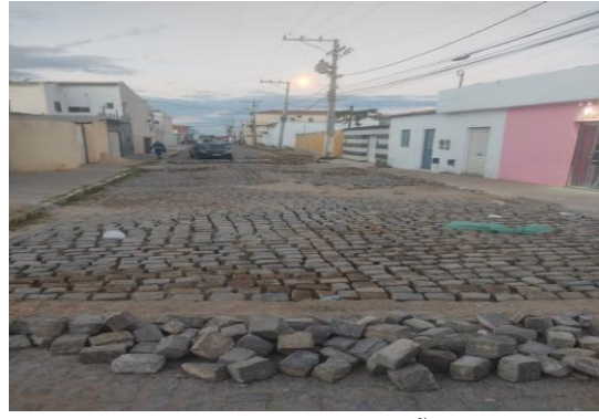
RUA TOBIAS BARRETO - PAVIMENTAÇÃO EM PARALELO
