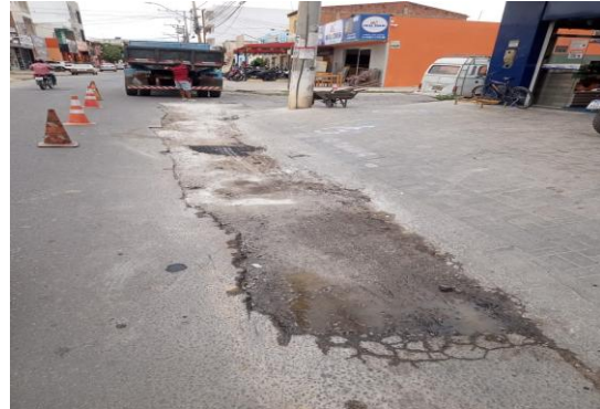
RUA SÃO JOÃO - APLICAÇÃO DE CBUQ
