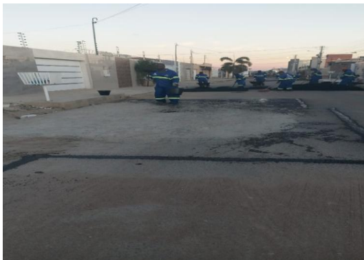
AV PROPRIÁ - APLICAÇÃO DO CBUQ
