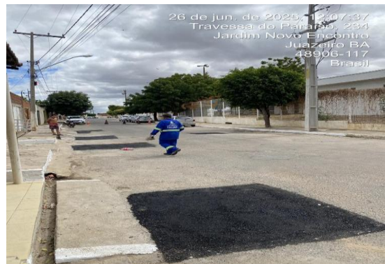
RUA BELA VISTA - APLICAÇÃO DO CBUQ
