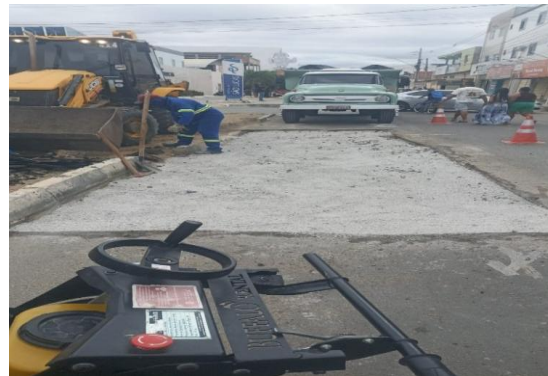
AV AIRTON SENA - PAVIMENTAÇÃO COM CBUQ
