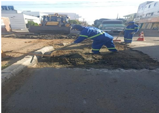
AV AIRTON SENA - PAVIMENTAÇÃO COM CBUQ
