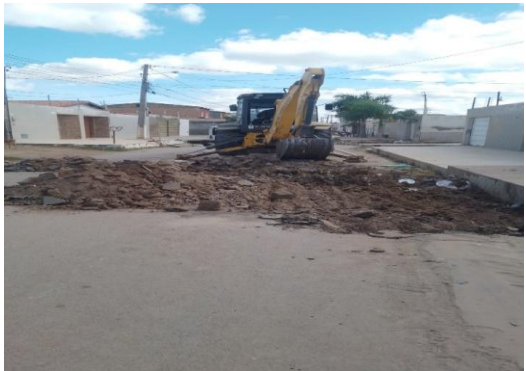
AV PROPRIÁ - ESCAVAÇÃO MECANIZADA
