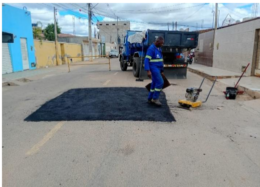
RUA DA CRECHE - APLICAÇÃO DE CBUQ
