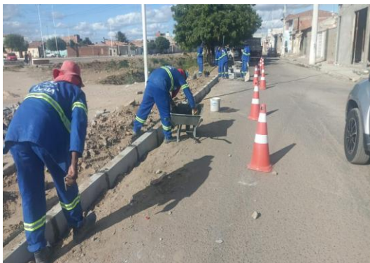
AV LUIZ INACIO - APLICAÇÃO DE MEIO FIO
