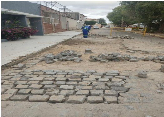
AV BAHIA - PAVIMENTAÇÃO EM PARALELO
