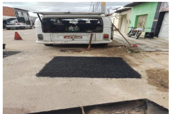
RUA DA CRECHE - APLICAÇÃO DE CBUQ
