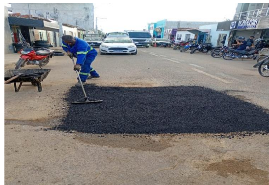
RUA DA CRECHE - APLICAÇÃO DE CBUQ
