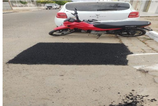
RUA BELA VISTA - APLICAÇÃO DE CBUQ
