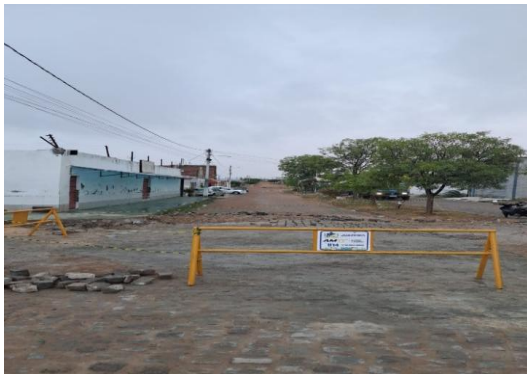
AV BAHIA - PAVIMENTAÇÃO EM PARALELO
