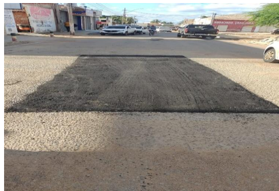
R. PRINCIPAL - APLICAÇÃO DE CBUQ
