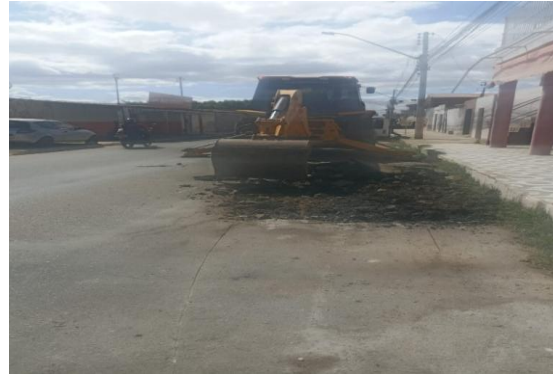
AV AIRTON SENA - PAVIMENTAÇÃO COM CBUQ
