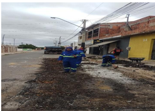
AV AIRTON SENA - DEMOLIÇÃO ASFÁLTICA
