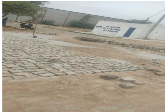
AV BAHIA - PAVIMENTAÇÃO EM PARALELO
