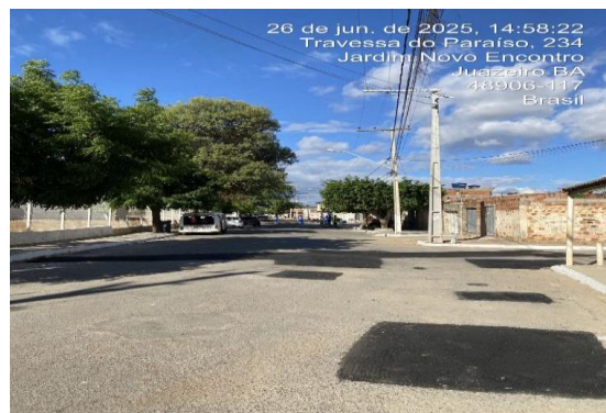
RUA BELA VISTA - APLICAÇÃO DO CBUQ
