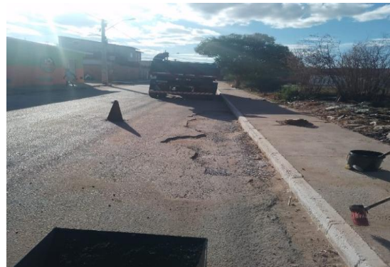
RUA PROPRIÁ - APLICAÇÃO DE CBUQ
