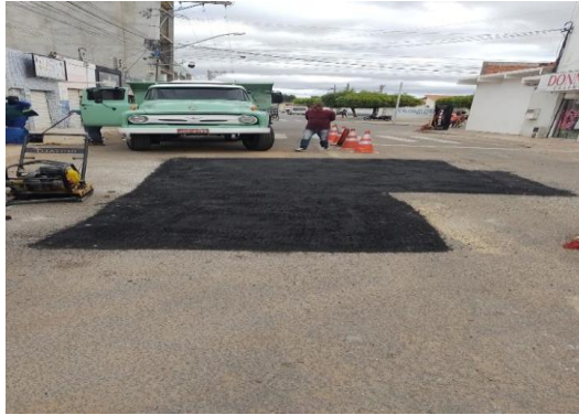
RUA DA CRECHE - APLICAÇÃO DE CBUQ
