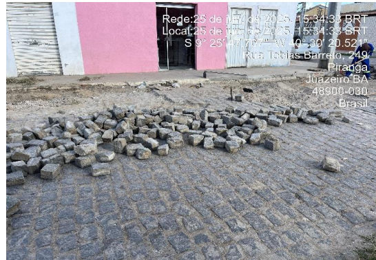
RUA TOBIAS BARRETO - PAVIMENTAÇÃO EM PARALELO
