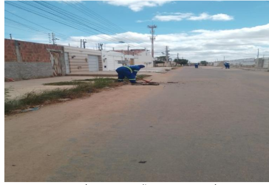
AV PROPRIÁ - DEMOLIÇÃO DE PAV ASFÁLTICO
