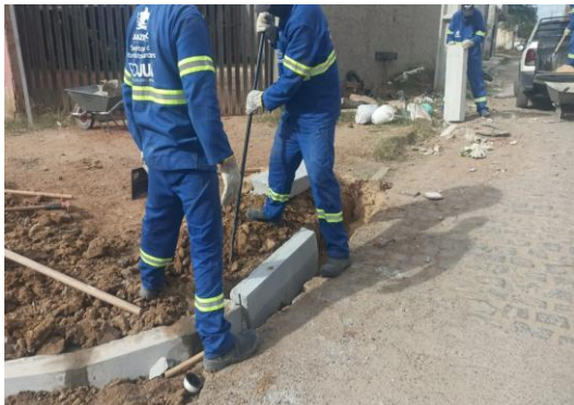
AV SÃO JOÃO - APLICAÇÃO DE MEIO FIO
