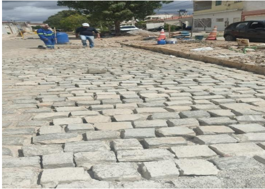
AV BAHIA - PAVIMENTAÇÃO EM PARALELO
