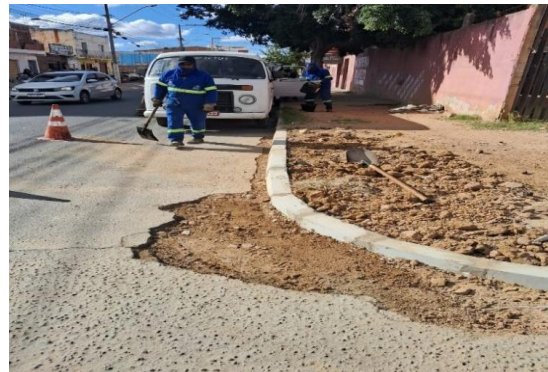
AV SÃO JOÃO - APLICAÇÃO DE MEIO FIO
