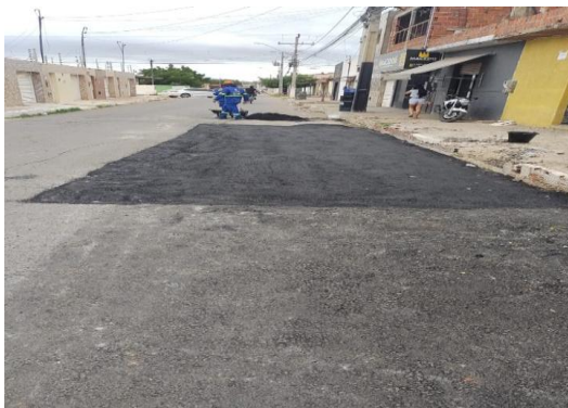
AV AIRTON SENA - PAVIMENTAÇÃO COM CBUQ
