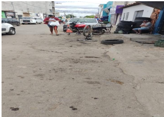
RUA DA CRECHE - CORTE DE ASFALTO
