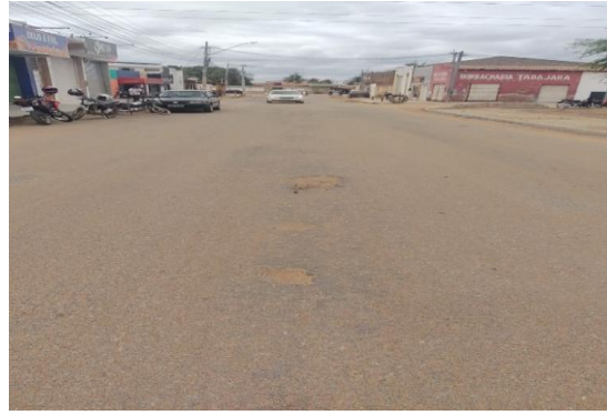
R. PRINCIPAL - APLICAÇÃO DE CBUQ
