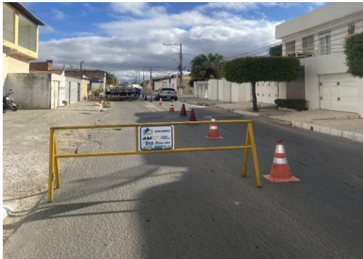
AV SÃO JOÃO - APLICAÇÃO DE BGS
