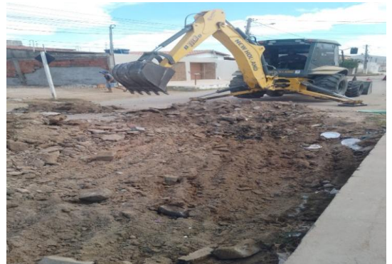
AV PROPRIÁ - ESCAVAÇÃO MECANIZADA
