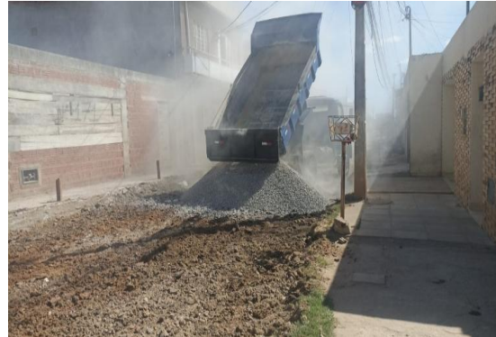
AV SÃO JOÃO - APLICAÇÃO DE BGS
