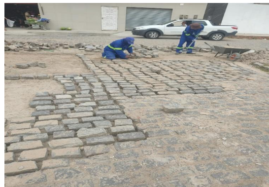
RUA TOBIAS BARRETO - PAVIMENTAÇÃO EM PARALELO
