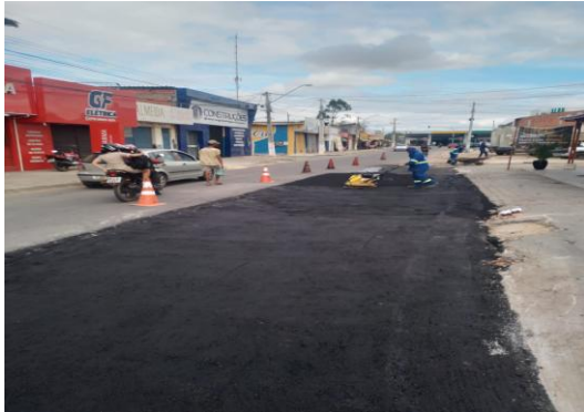
RUA SÃO JOÃO - APLICAÇÃO DE CBUQ
