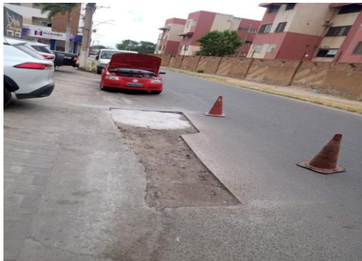
RUA SÃO JOÃO - APLICAÇÃO DE CBUQ
