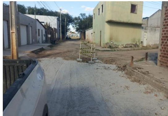
RUA SÃO JOÃO - APLICAÇÃO DE BGS
