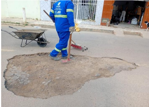
RUA DA CRECHE - CORTE DE ASFALTO
