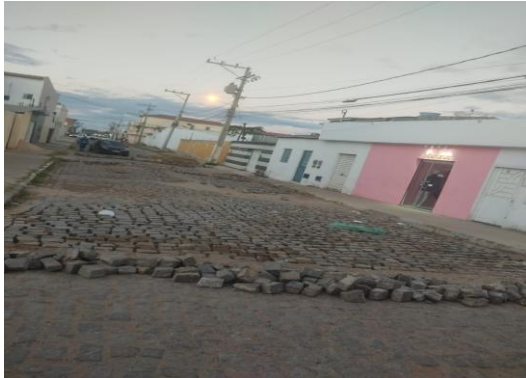
RUA TOBIAS BARRETO - PAVIMENTAÇÃO EM PARALELO
