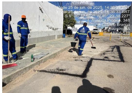
AV PROPRIÁ - IMPRIMAÇÃO COM EMULSÃO ASFAL
