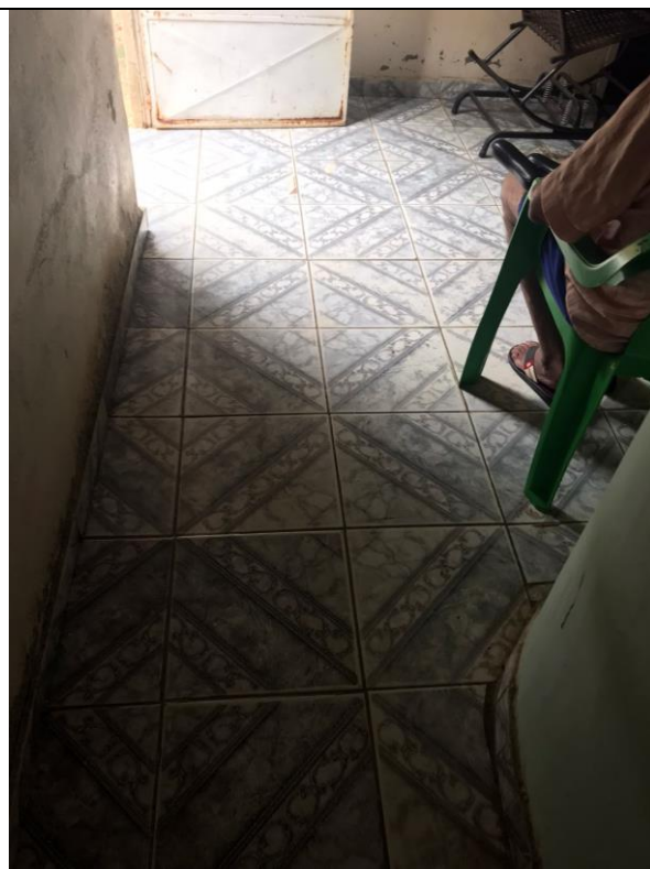
Detalhe- revestimento Cerâmico. OSMAR LEITE DE ANDRADE.
