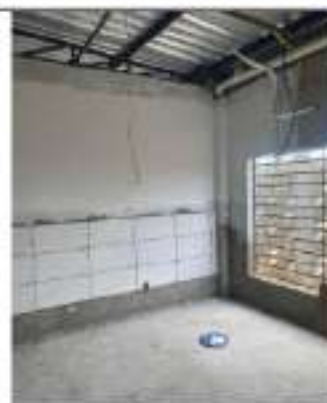
INSTALAÇÕES ELÉTRICAS / SELADOR E EMASSAMENTO DE PAREDES
