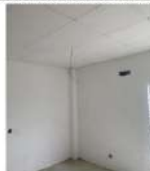
INSTALAÇÕES ELÉTRICAS / FORRO / EMASSAMENTO DE PAREDES
