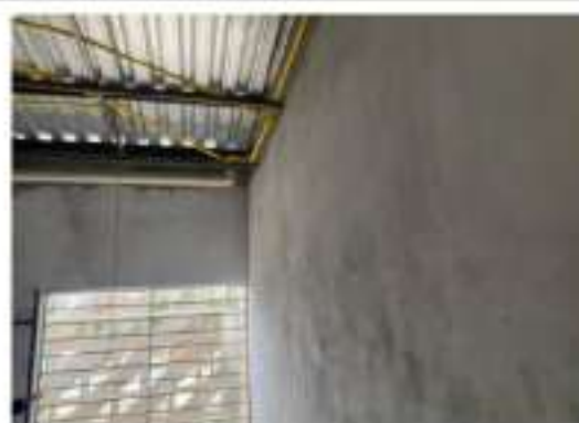
INSTALAÇÕES ELÉTRICAS / SELADOR DE PAREDES
