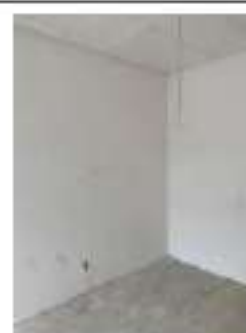
FORRO / EMASSAMENTO DE PAREDES
