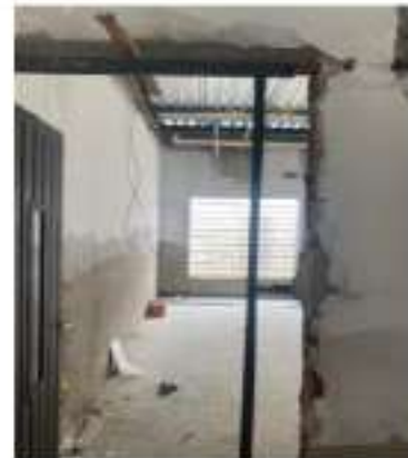
INSTALAÇÕES ELÉTRICAS / SELADOR E EMASSAMENTO DE PAREDES
