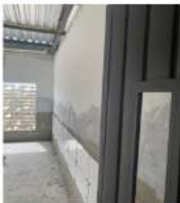
INSTALAÇÕES ELÉTRICAS / SELADOR E EMASSAMENTO DE PAREDES
