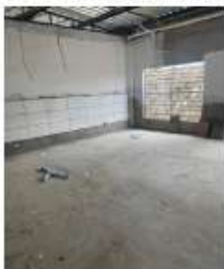
INSTALAÇÕES ELÉTRICAS / SELADOR E EMASSAMENTO DE PAREDES
