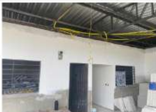
INSTALAÇÕES ELÉTRICAS / SELADOR E EMASSAMENTO DE PAREDES
