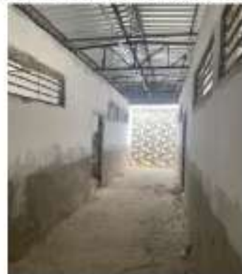
INSTALAÇÕES ELÉTRICAS / SELADOR E EMASSAMENTO DE PAREDES
