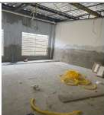
INSTALAÇÕES ELÉTRICAS / SELADOR E EMASSAMENTO DE PAREDES
