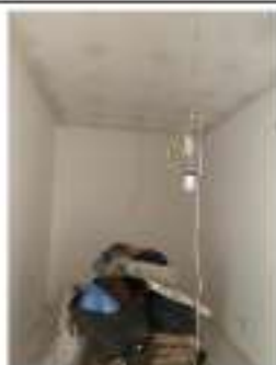
FORRO / EMASSAMENTO DE PAREDES E TETOS
