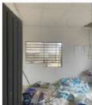
INSTALAÇÕES ELÉTRICAS / FORRO / EMASSAMENTO DE PAREDES
