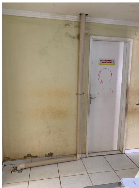
Foto 08 – Saída da calha do telhado
