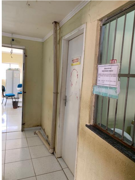
Foto 07 – Saída da calha do telhado
