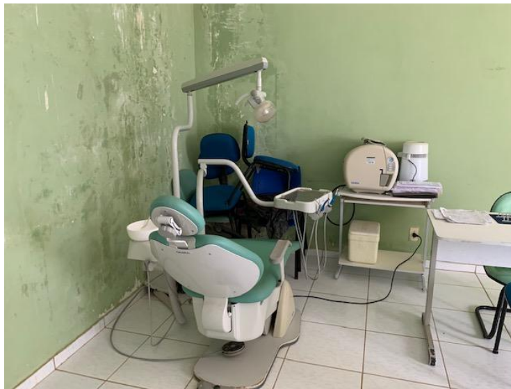
Foto 06 – Equipamwento e parede lateral
