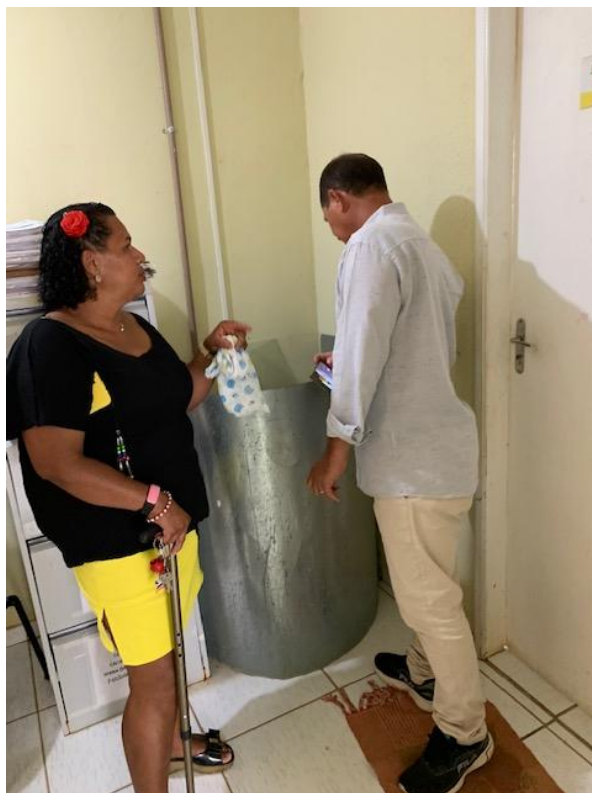
Foto 04 – Verificando a localização do compressor
